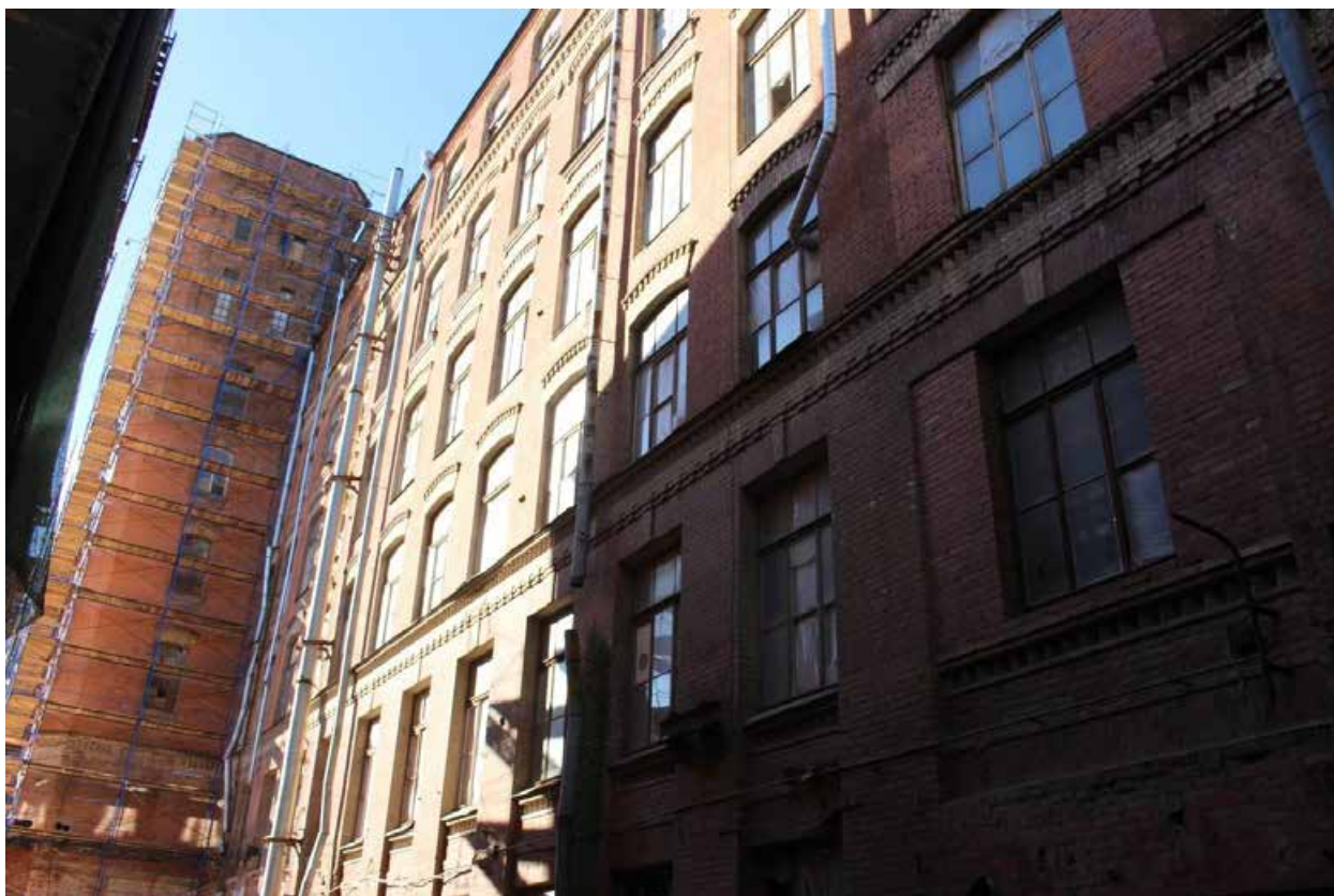
Фото 3. Вид на восточный фасад южного шестиэтажного корпуса с пристроенной восьмьюрусной водонапорной башней объекта культурного наследия регионального значения «Производственные корпуса обувной фабрики».
