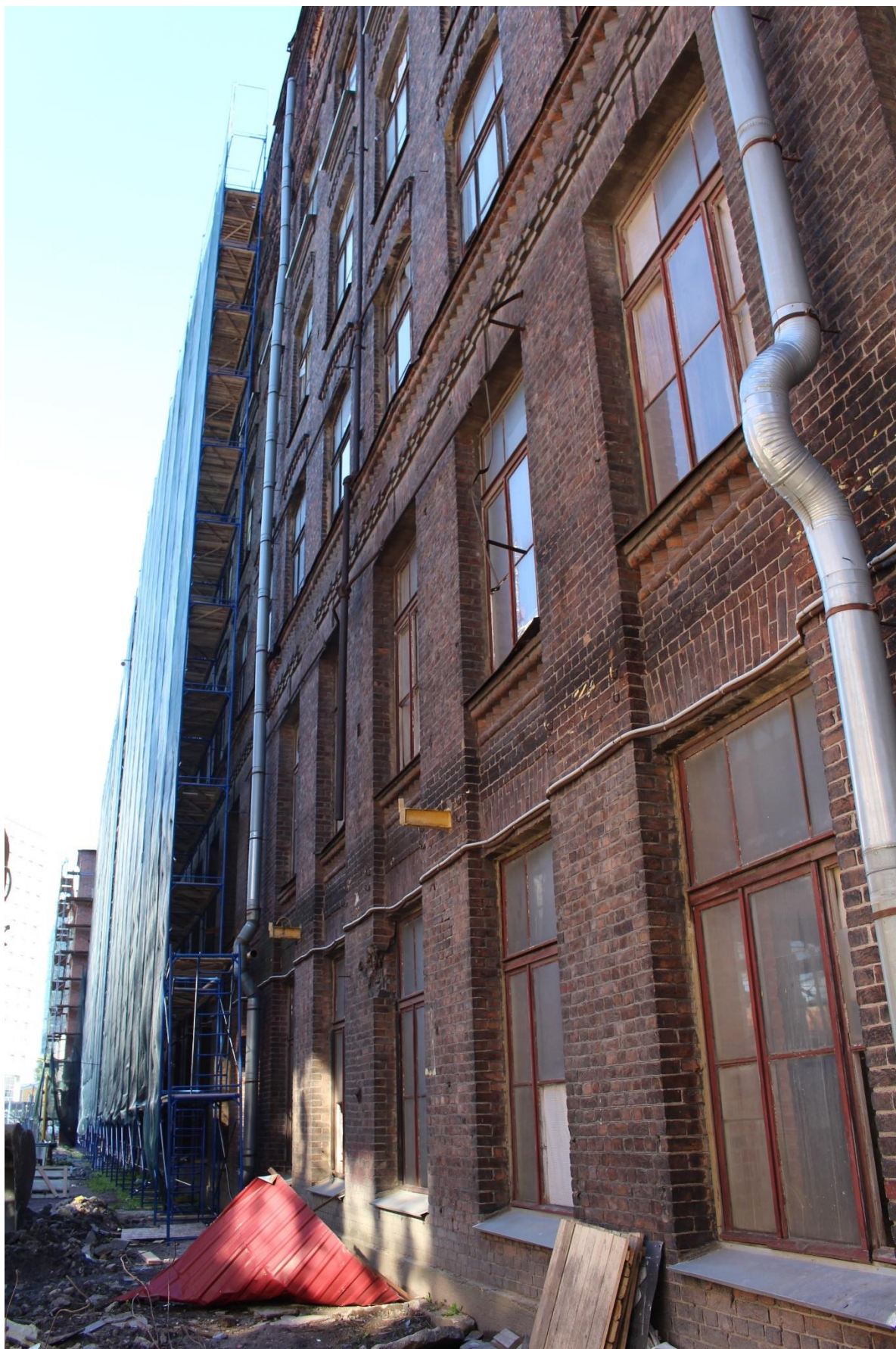
Фото 5. Вид на западный фасад южного шестиэтажного корпуса с пристроенной восьмьюрусной водонапорной башней объекта культурного наследия регионального значения «Производственные корпуса обувной фабрики».
