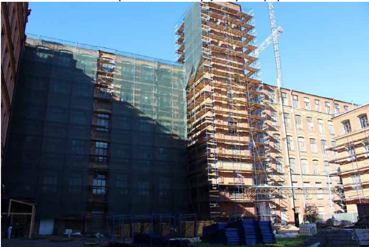
Фото 2. Вид на восточный фасад южного шестиэтажного корпуса с пристроенной восьмьюрусной водонапорной башней объекта культурного наследия регионального значения «Производственные корпуса обувной фабрики».
