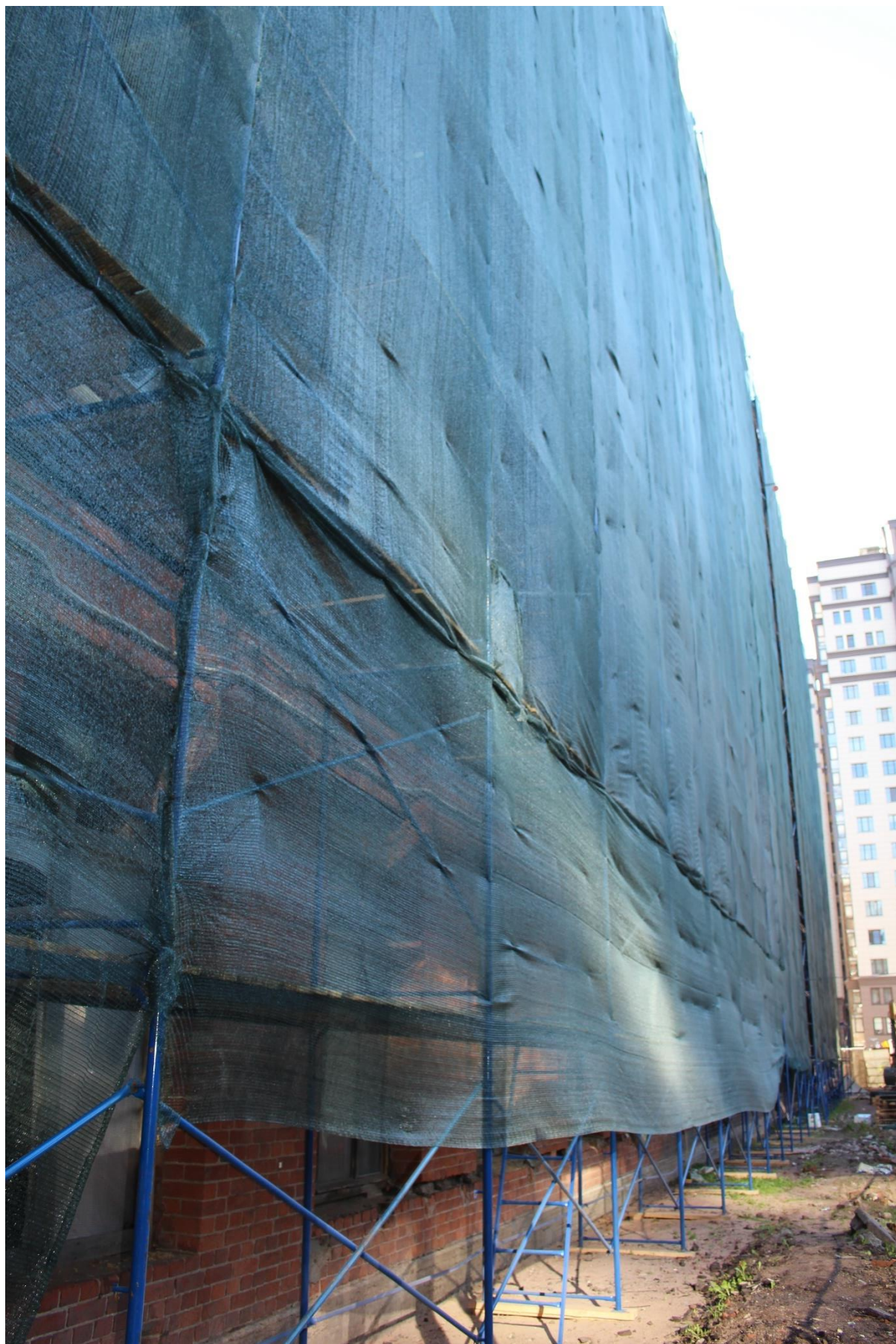
Фото 4. Вид на западный фасад южного шестиэтажного корпуса с пристроенной восьмьюрусной водонапорной башней объекта культурного наследия регионального значения «Производственные корпуса обувной фабрики».
