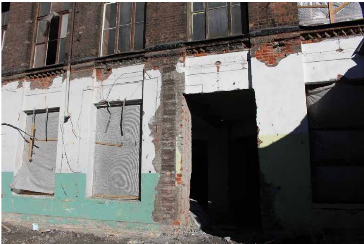
Фото 6. Вид на южный фасад южного шестиэтажного корпуса с пристроенной восьмьюрусной водонапорной башней объекта культурного наследия регионального значения «Производственные корпуса обувной фабрики».
