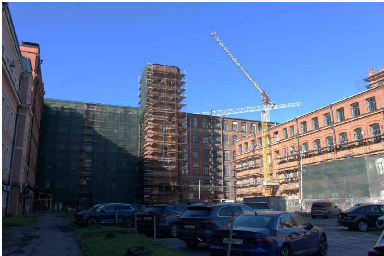
Фото 1. Вид на восточный фасад южного шестиэтажного корпуса с пристроенной восьмьюрусной водонапорной башней объекта культурного наследия регионального значения «Производственные корпуса обувной фабрики».
