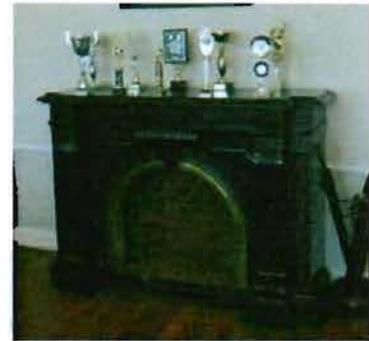
помещение 30-Н (пом. 2 (67,9 м<sup>2</sup>)): камин средистенный из полированного черного габбро; топка с полуциркульным завершением и стилизованным замковым камнем; стойки с волютообразным завершением и декором по обеим сторонам от топки; филенки под каминной полкой; каминная полка с профилировкой по краю;
