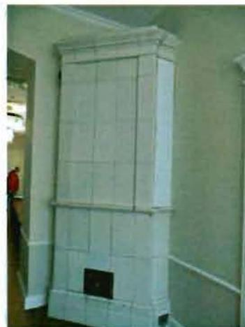
помещение 30-Н (пом. 1 (113,2 м<sup>2</sup>), пом. 14(13,5 м<sup>2</sup>), пом. 4 (36,3 м<sup>2</sup>)): три печи, облицованные белыми гладкими поливными изразцами, с профилированным венчающим карнизом, металлическими топочными дверцами.
