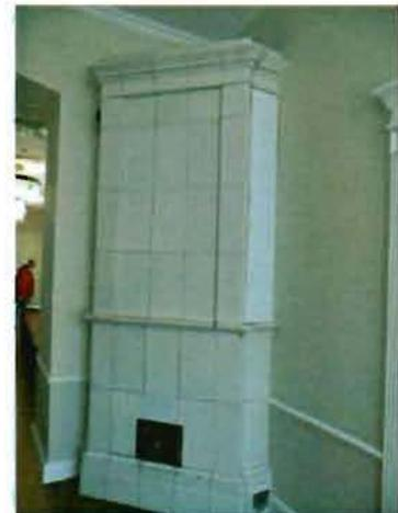
помещение 30-Н (пом. 1 (113,2 м<sup>2</sup>), пом. 14(13,5 м<sup>2</sup>), пом. 4 (36,3 м<sup>2</sup>)): три печи, облицованные белыми гладкими поливными изразцами, с профилированным венчающим карнизом, металлическими топочными дверцами.
