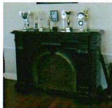
помещение 30-Н (пом. 2 (67,9 м<sup>2</sup>)): камин средистенный из полированного черного габбро; топка с полуциркульным завершением и стилизованным замковым камнем; стойки с волютообразным завершением и декором по обеим сторонам от топки; филенки под каминной полкой; каминная полка с профилировкой по краю;
