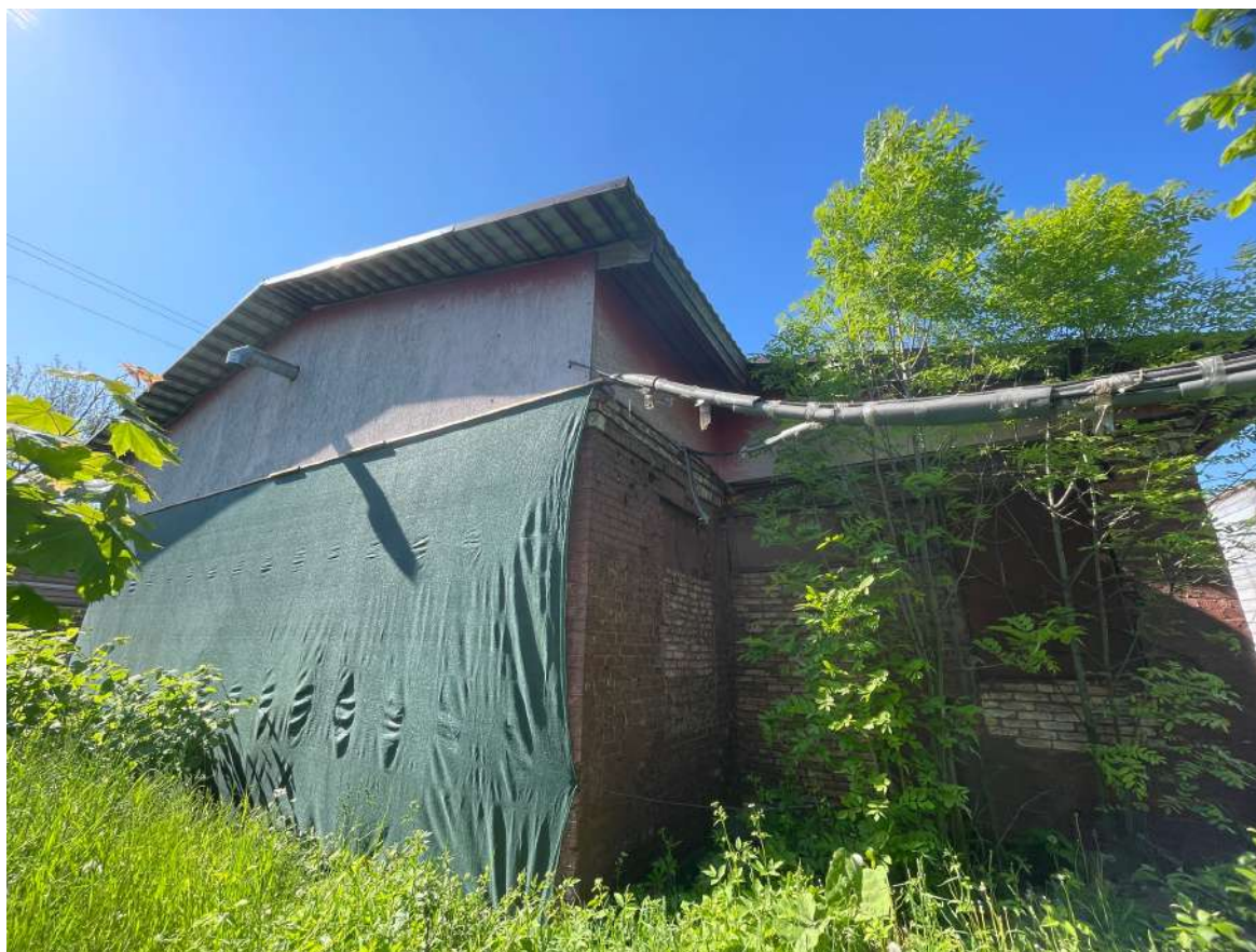
7. Вид на здание с юга
