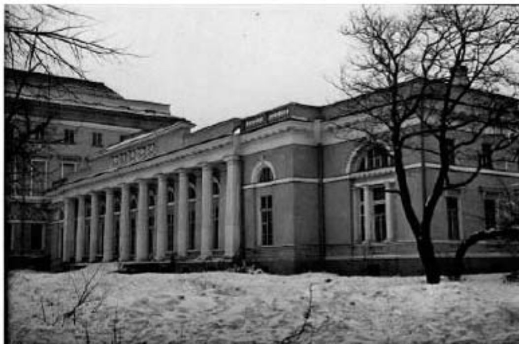
9. «Флигель служебный западный Михайловского дворца (в составе «Дворец Великого князя Михаила Павловича (Русский музей Императора Александра III)»)» (Инженерная ул., д. 2-4, лит. Г). Северный фасад здания со стороны Михайловского сада. Фото 1964 г. (Паспорт ОКН, инв. 166-1 183п).
