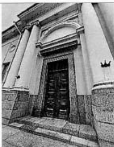
Фото 4. Фрагмент портала (по Инженерной ул.)
