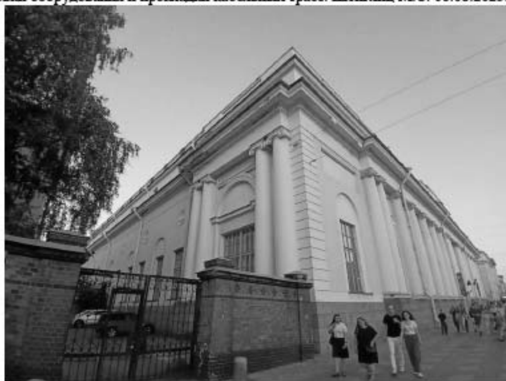
22. «Корпус западный Русского музея (в составе «Дворец Великого князя Михаила Павловича (Русский музей Императора Александра III)») (Инженерная ул., д. 2-4, лит. А). Лицевой фасад по наб. канала Грибоедова (фрагмент). Фото мест установки оборудования и прокладки кабельных трасс. Штиглиц М.С. 06.08.2025.
