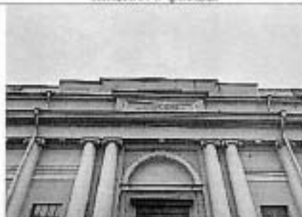
Фото 9. Фрагмент аттика лицевого фасада (по наб. к. Грибоедова)
