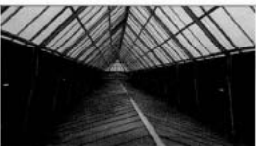
Фото 14. Фрагмент конструкций крыши (световой фонарь)
