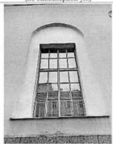
Фото 7. Оформление оконного проема лицевого фасада
