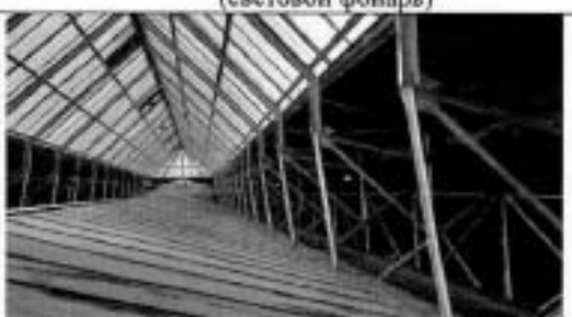
Фото 16. Фрагмент конструкций крыши (световой фонарь)
