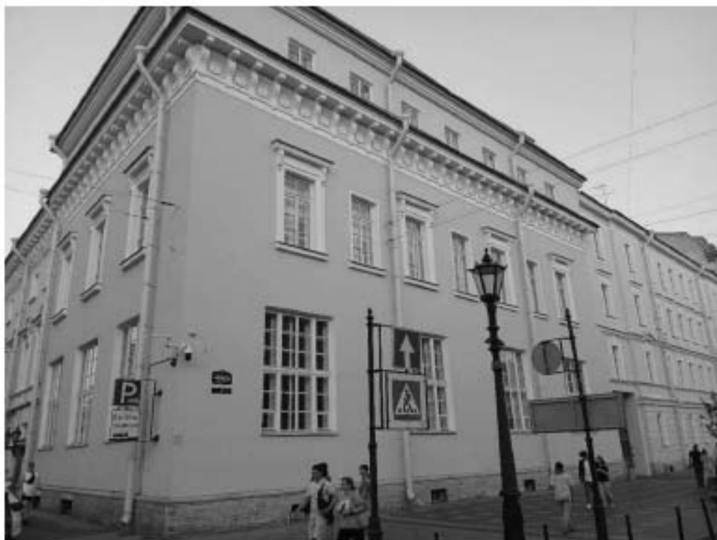
15. «Театр Михайловский» (пл. Искусств, д. 1, лит. А). Лицевой фасад по наб. канала Грибоедова (фрагмент). Фото мест установки оборудования и прокладки кабельных трасс. Штиглиц М.С. 06.08.2025.
