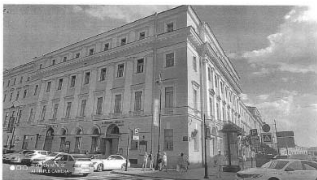
Лицевой фасад со стороны Итальянской улицы
