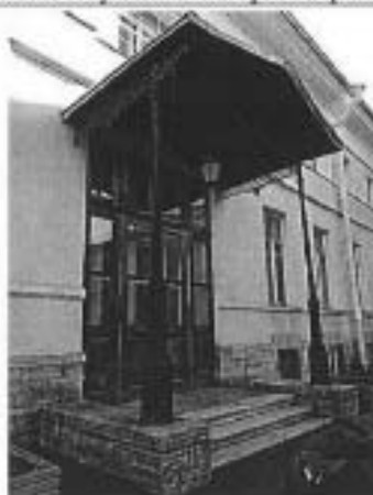
Фото 8. Фрагмент дворового фасада. Входная группа
