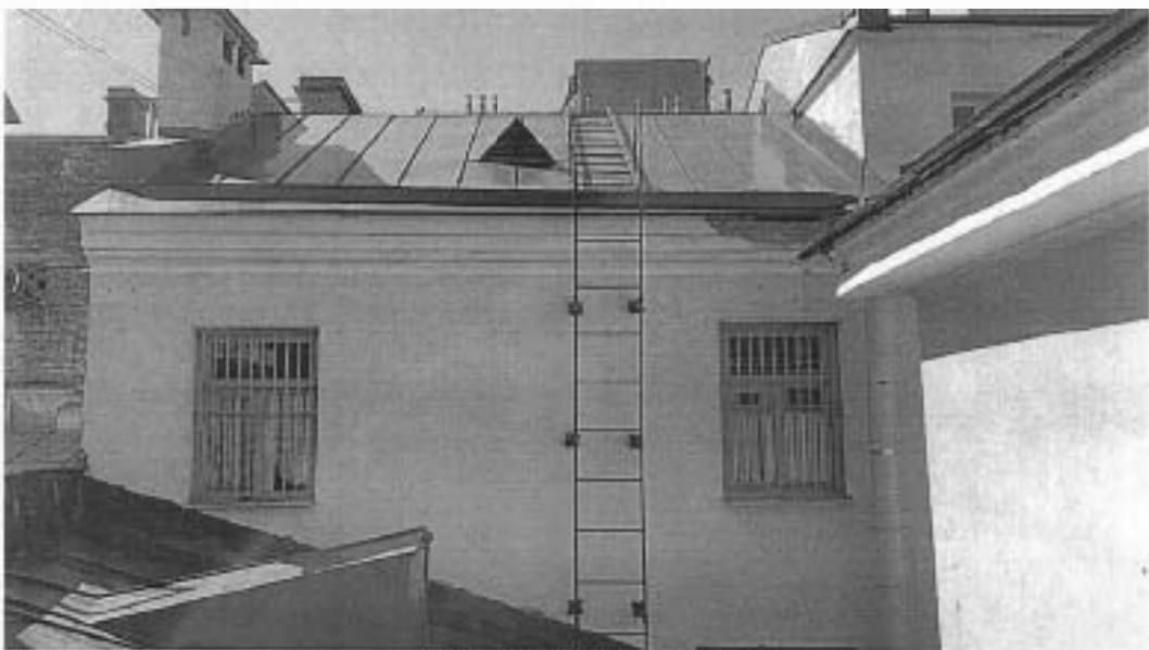
Фрагмент дворового фасада
