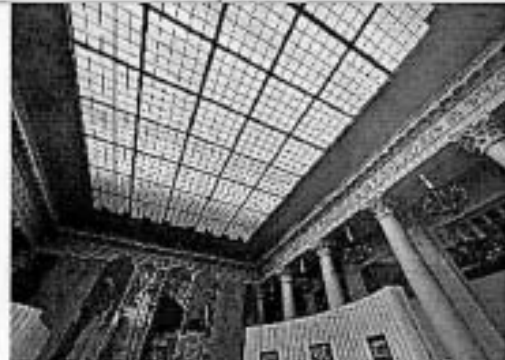
Фото 21. Фрагмент интерьера. Колонный зал. Световой фонарь в интерьере.
