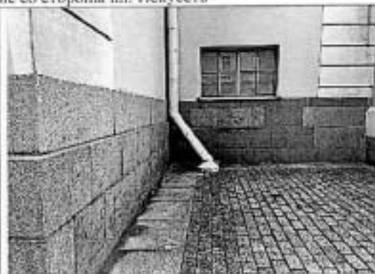
Фото 3. Фрагмент отделки фасада. Гранитный покотль, отмостка, элемент водосточной системы
