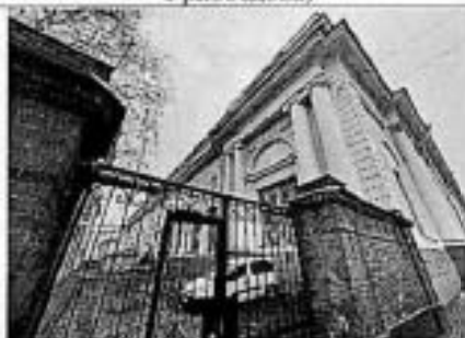
Фото 8. Фрагмент фасада во внутреннем дворе
