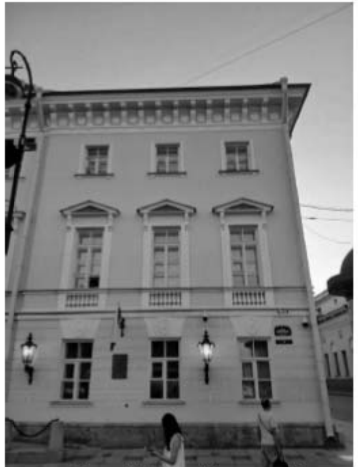
11. «Театр Михайловский» (пл. Искусств, д. 1, лит. А). Лицевой фасад с пл. Искусств (фрагмент). Фото мест установки оборудования и прокладки кабельных трасс. Штиглиц М.С. 06.08.2025.
