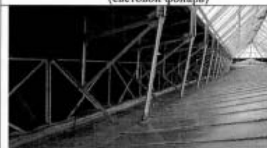
Фото 15. Фрагмент конструкций крыши (световой фонарь)
