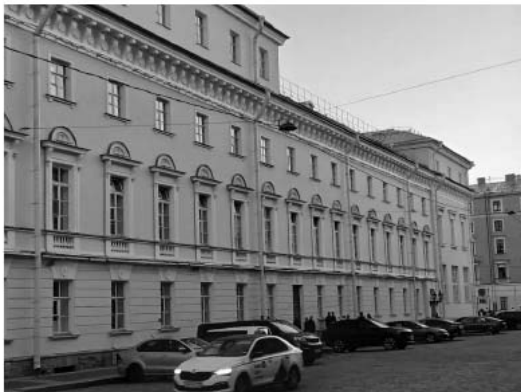
13. «Театр Михайловский» (пл. Искусств, д. 1, лит. А). Лицевой фасад по ул. Инженерная (фрагмент). Фото мест установки оборудования и прокладки кабельных трасс. Штиглиц М.С. 06.08.2025.
