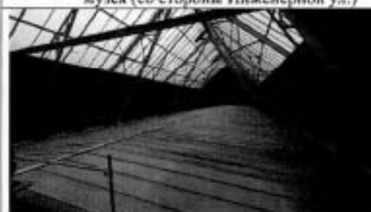
Фото 13. Фрагмент конструкций крыши (световой фонарь)
