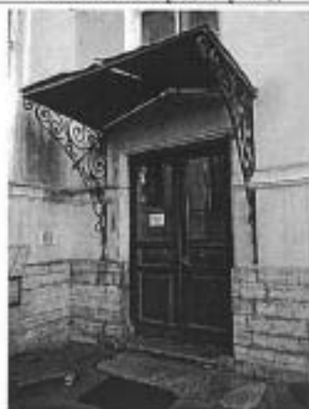
Фото 7. Фрагмент дворового фасада. Входная группа
