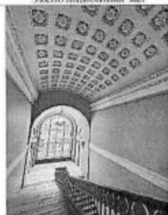
Фото 26. Фрагмент интерьера. Лестница
