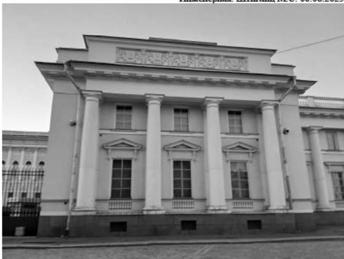
6. «Корпус Этнографического отдела Русского музея (Этнографический музей)» (в составе «Дворец Великого князя Михаила Павловича (Русский музей Императора Александра III)») (Инженерная ул., д. 4/1, лит. Е). Лицевой фасад по ул. Инженерная (фрагмент). Фото мест установки оборудования и прокладки кабельных трасс. Штиглиц М.С. 06.08.2025.
