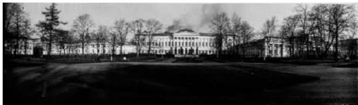
3. «Дворец Великого князя Михаила Павловича (Русский музей Императора Александра III)». Южный фасад. Фото 1947 г. (Паспорт ОКН, инв. 166-1 183п).
