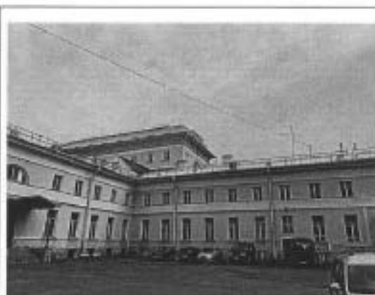
Фото 4. Фрагмент дворового фасада
