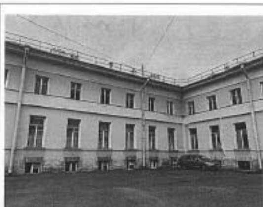
Фото 3. Фрагмент дворового фасада
