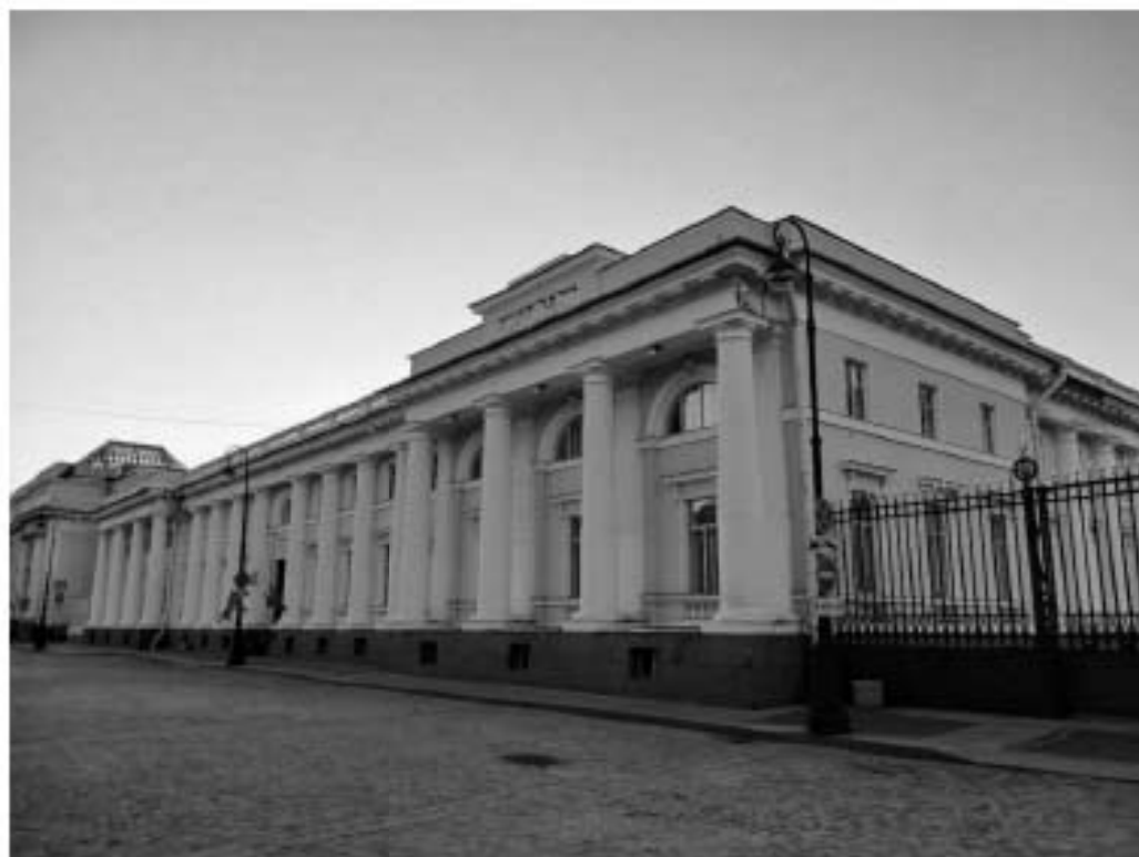
17. «Флигель служебный западный Михайловского дворца (в составе «Дворец Великого князя Михаила Павловича (Русский музей Императора Александра III)»)» (Инженерная ул., д. 2-4, лит. Г). Лицевой фасад по ул. Инженерная (фрагмент). Фото мест установки оборудования и прокладки кабельных трасс. Штиглиц М.С. 06.08.2025.
