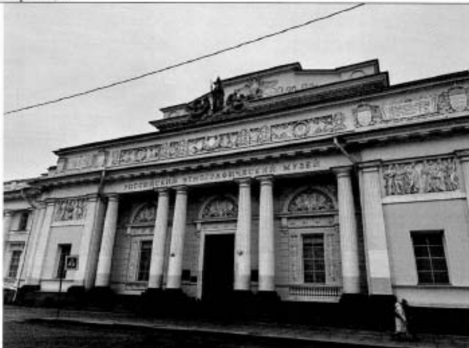
Фото 1. Лицевой фасад. Центральный ризалит
