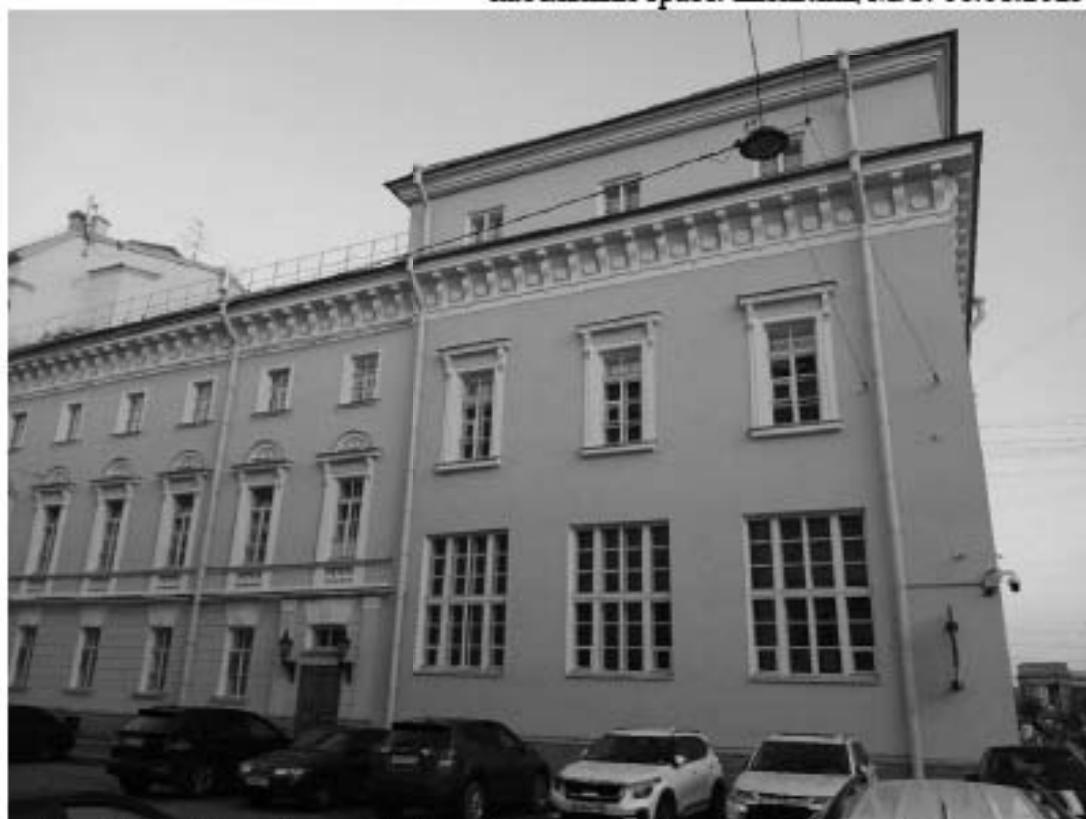
14. «Театр Михайловский» (пл. Искусств, д. 1, лит. А). Лицевой фасад по ул. Инженерная (фрагмент). Фото мест установки оборудования и прокладки кабельных трасс. Штиглиц М.С. 06.08.2025.
