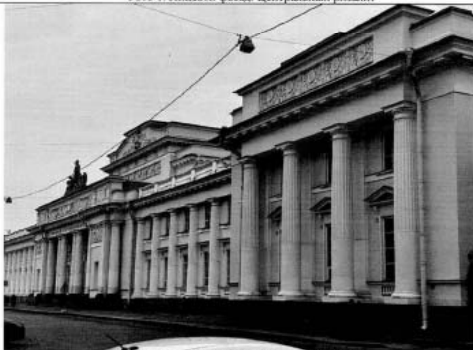
Фото 2. Лицевой фасад (по Инженерной ул.)
