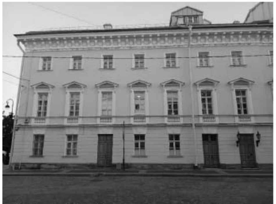
12. «Театр Михайловский» (пл. Искусств, д. 1, лит. А). Лицевой фасад по ул. Инженерная (фрагмент). Фото мест установки оборудования и прокладки кабельных трасс. Штиглиц М.С. 06.08.2025.
