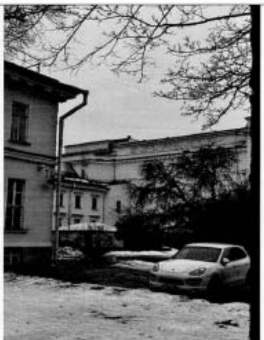
Фото 12. Фрагмент дворового фасада
