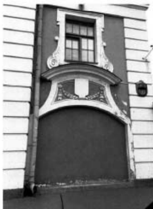
7. Фрагмент западного фасада объекта культурного наследия.
