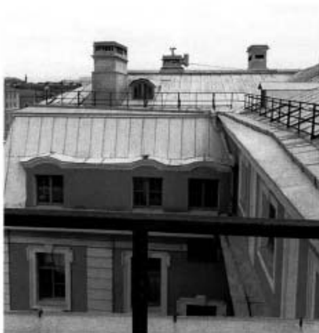
16. Кровля объекта культурного наследия.
