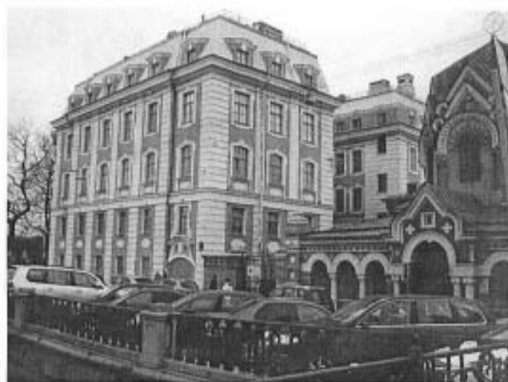
3. Лицевой фасад и часть дворового.
