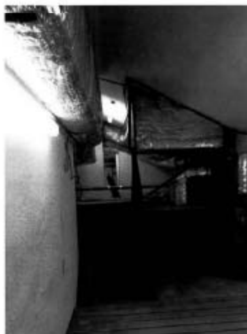
15. Чердачное пространство объекта культурного наследия.
