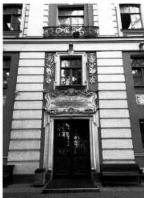
6. Фрагмент северного фасада объекта культурного наследия.
