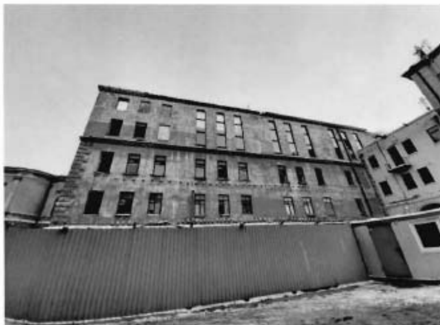
3. Вид на южный фасад объекта культурного наследия
