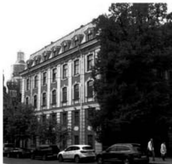
2. Общий вид восточного фасада объекта культурного наследия.
