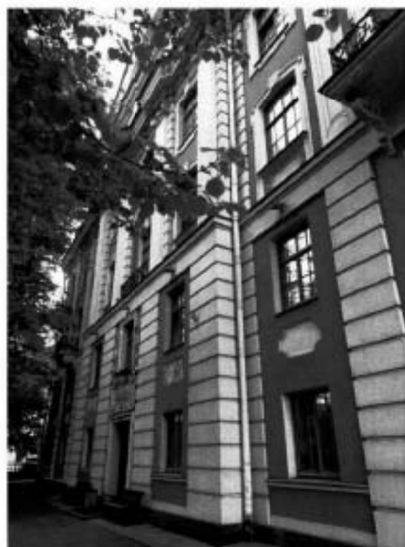
3. Общий вид северного фасада объекта культурного наследия.
