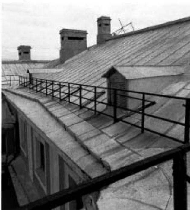
17. Кровля объекта культурного наследия.
