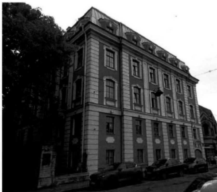
1. Общий вид западного фасада объекта культурного наследия.
