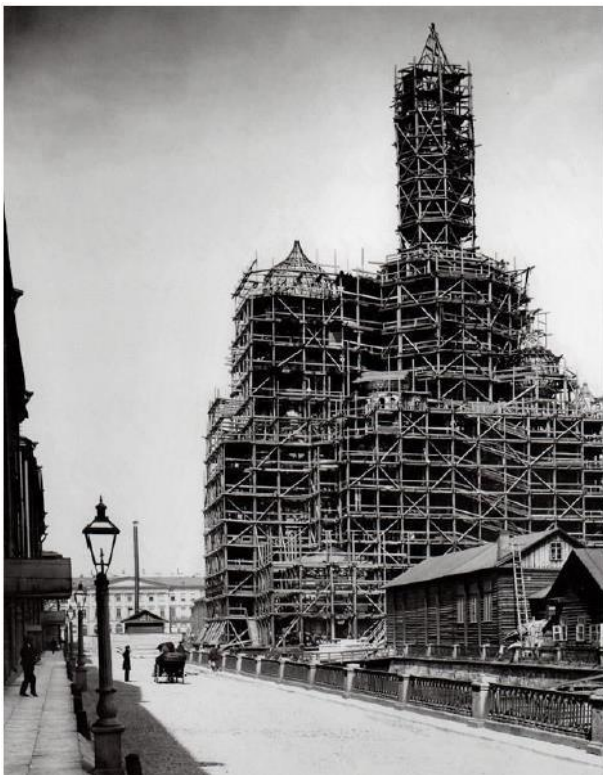
Фото 16. Строительство Спаса на крови. Вид с юго-запада. До 1897. Фотоателье К. Буллы. Источник - https://pressa.tv/sandbox/115238-ulicy-starogo-peterburga-ekaterinskiy-kanal.html .
