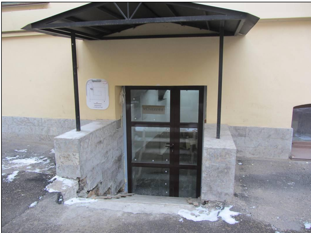
92. Выявленный ОКН «Дом Петерсона (Лобановых-Ростовских)». Внутренний двор. Фрагмент юго-восточного фасада. Вход в подвал.
