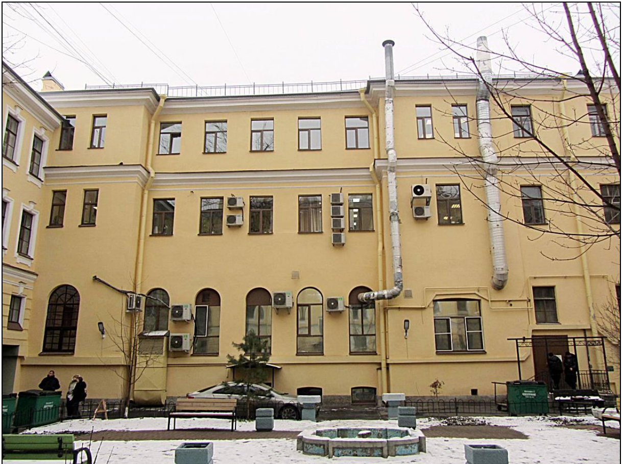
13. Выявленный ОКН «Дом Петерсона (Лобановых-Ростовских)». Внутренний двор. Общий вид юго-восточного фасада.
