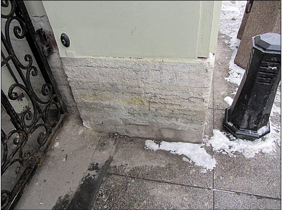
6. Выявленный ОКН «Дом Петерсона (Лобановых-Ростовских)». Фрагмент главного фасада со стороны Большой Морской улицы.
