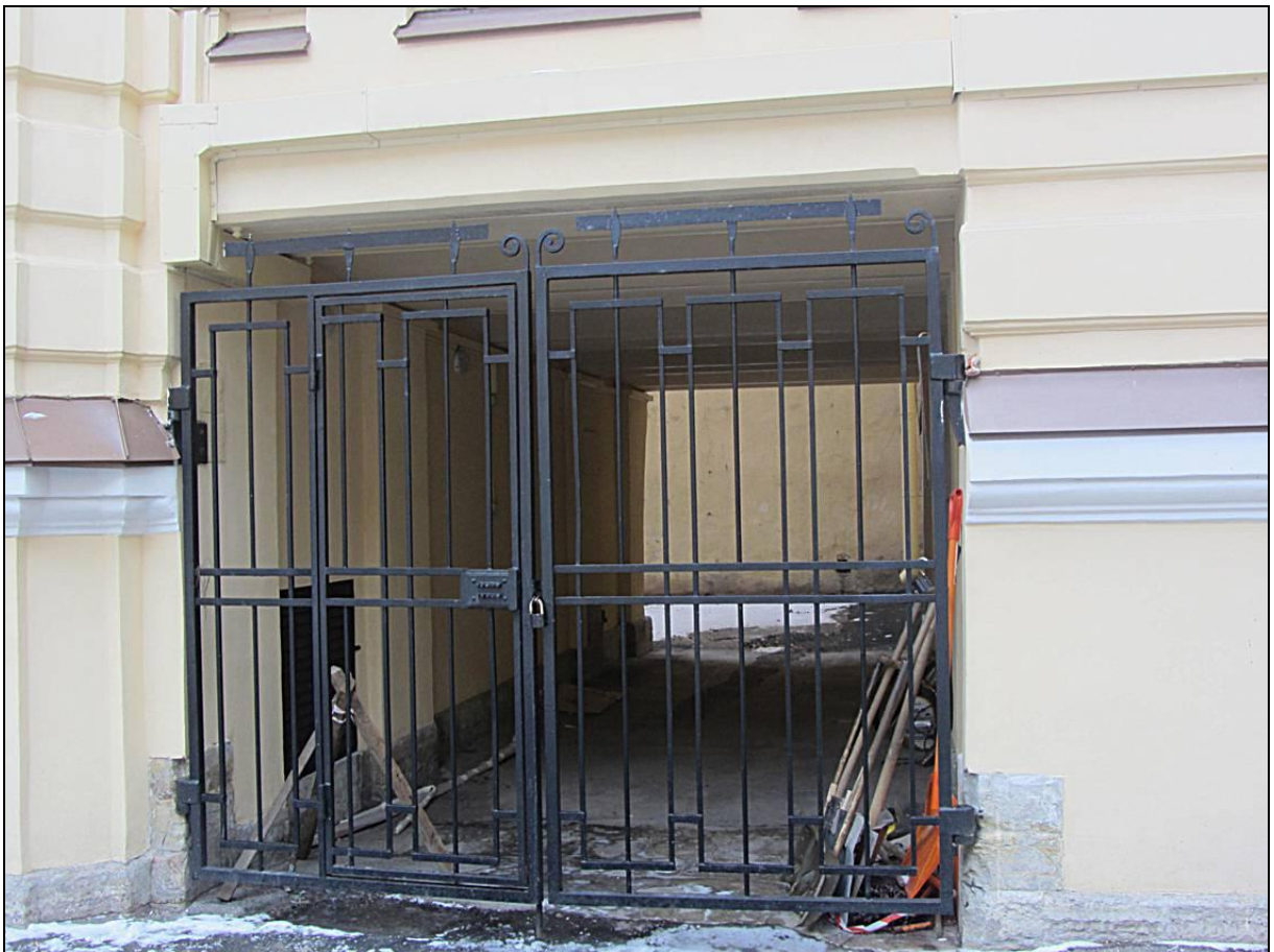
18. Выявленный ОКН «Дом Петерсона (Лобановых-Ростовских)». Внутренний двор. Фрагмент северо-западного фасада.
