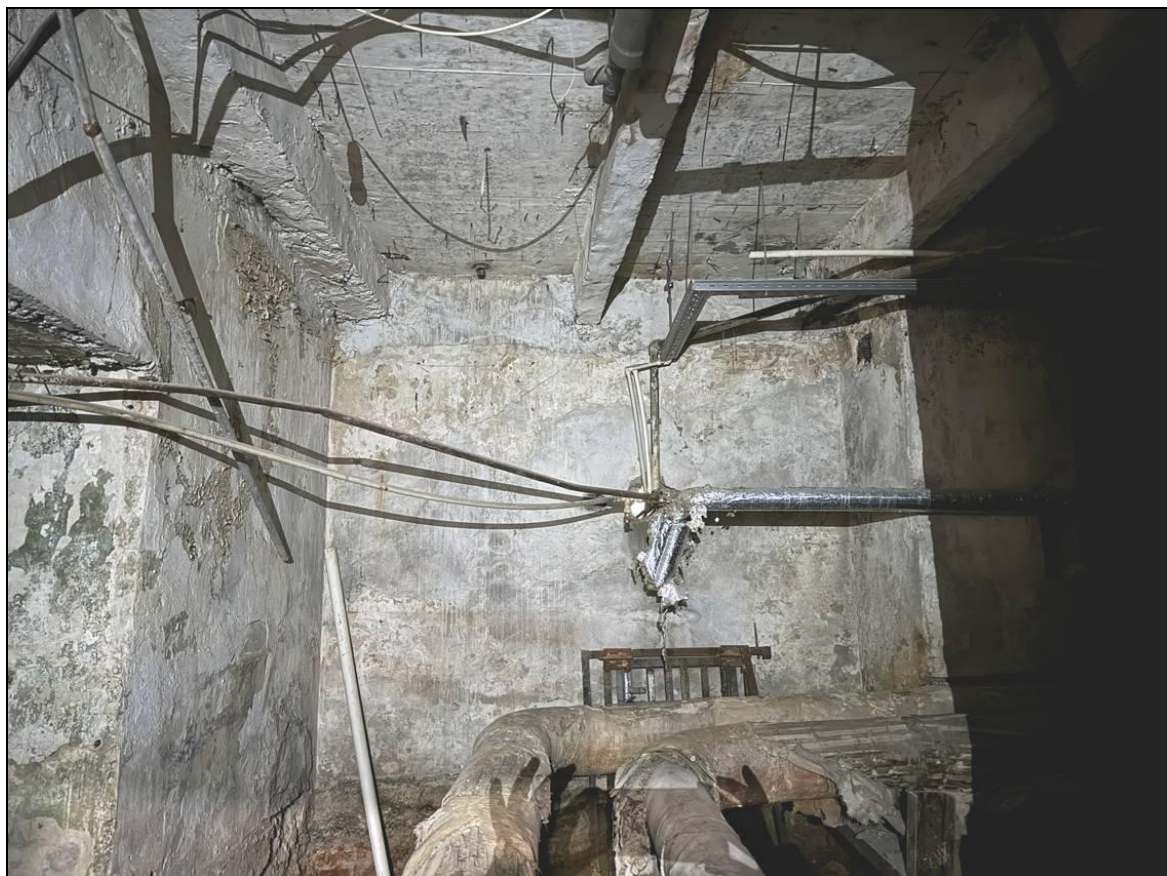
102. Выявленный ОКН «Дом Петерсона (Лобановых-Ростовских)». Фрагмент интерьера подвала.
