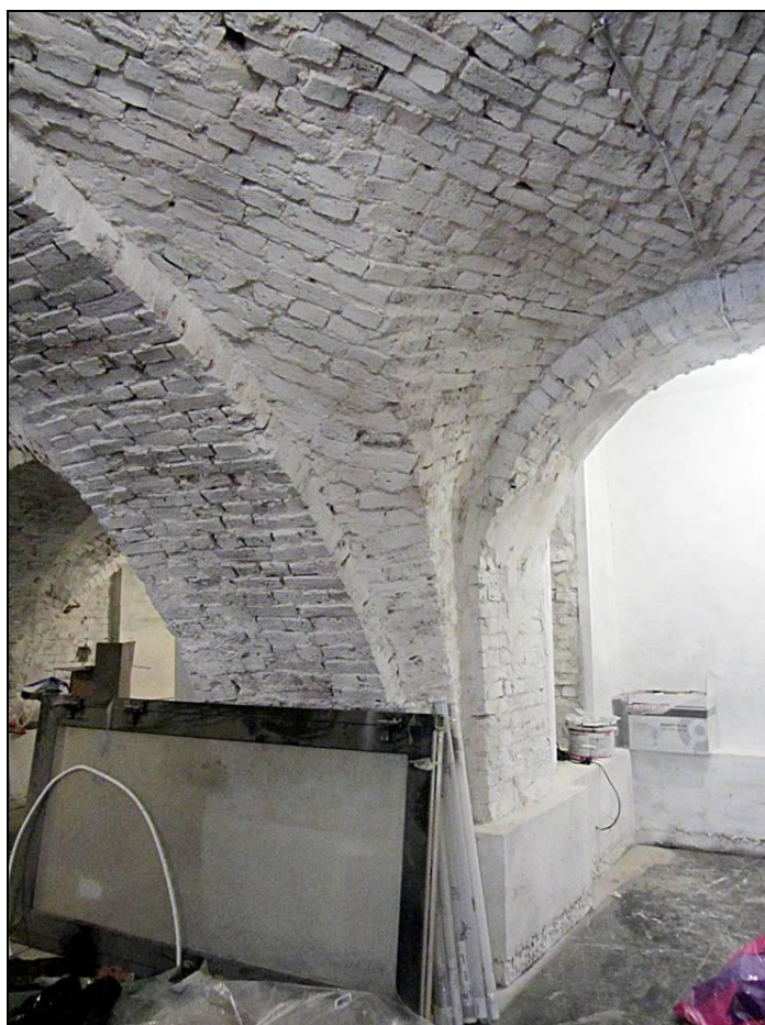
101. Выявленный ОКН «Дом Петерсона (Лобановых-Ростовских)». Фрагмент интерьера подвала.
