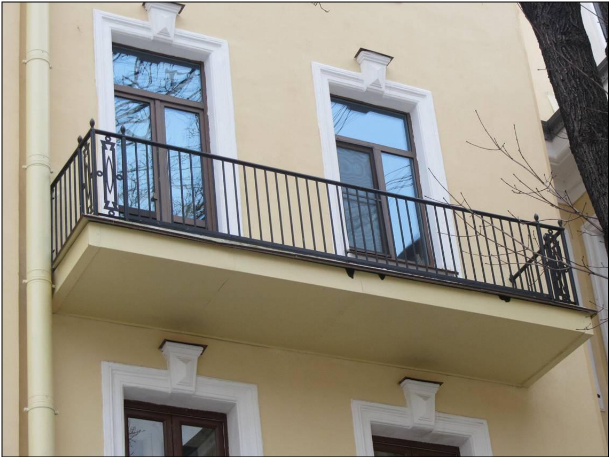
15. Выявленный ОКН «Дом Петерсона (Лобановых-Ростовских)». Внутренний двор. Фрагмент северо-западного фасада.
