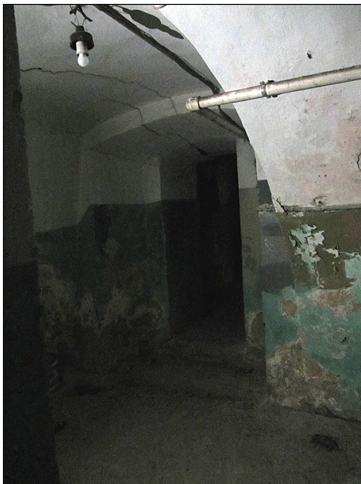
110. Выявленный ОКН «Дом Петерсона (Лобановых-Ростовских)». Фрагмент интерьера подвала.
