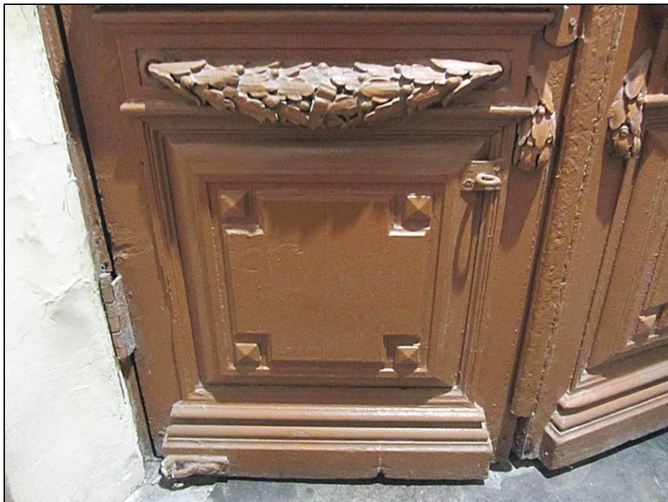
51, 52. Выявленный ОКН «Дом Петерсона (Лобановых-Ростовских)». Фрагмент интерьера. Вход на лестницу 3ЛК. Створки входной двери.
