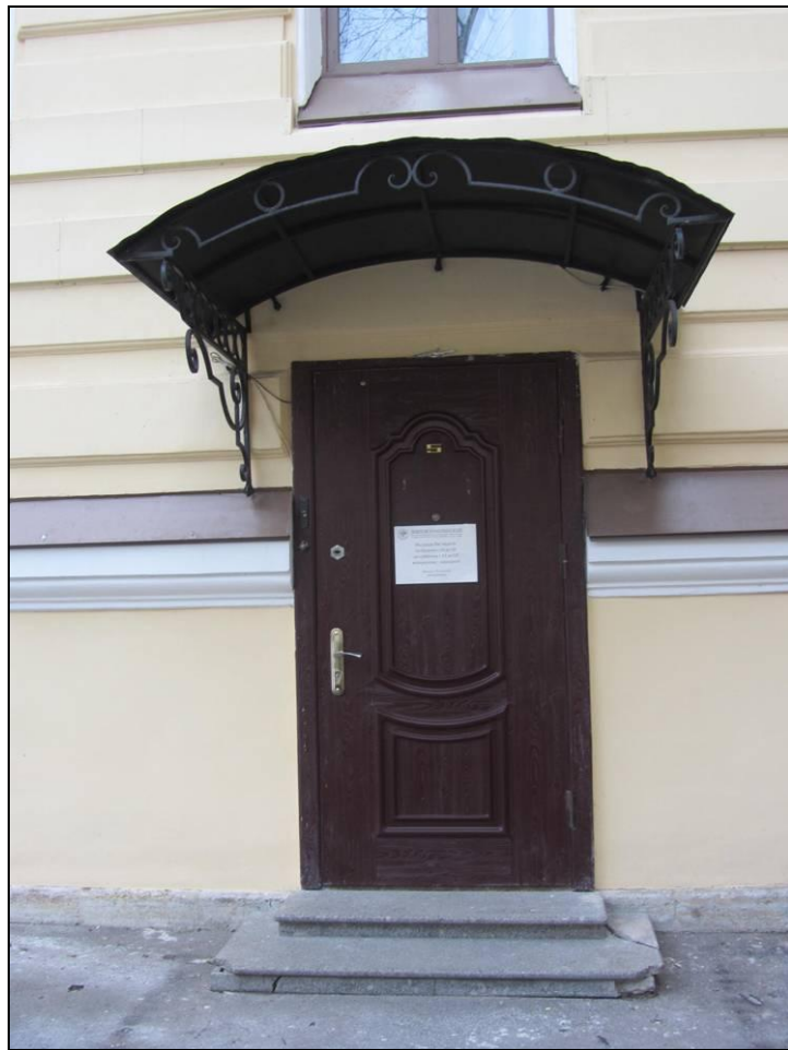
17. Выявленный ОКН «Дом Петерсона (Лобановых-Ростовских)». Внутренний двор. Фрагмент северо-западного фасада.
