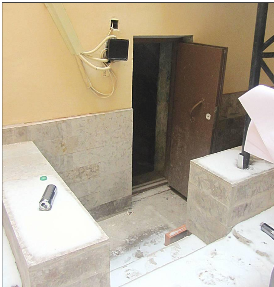
112. Выявленный ОКН «Дом Петерсона (Лобановых-Ростовских)». Вход в подвал из внутреннего двора.
