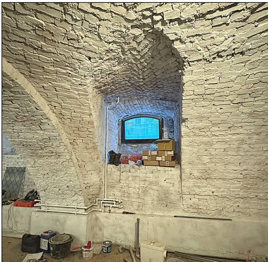
98. Выявленный ОКН «Дом Петерсона (Лобановых-Ростовских)». Фрагмент интерьера подвала.
