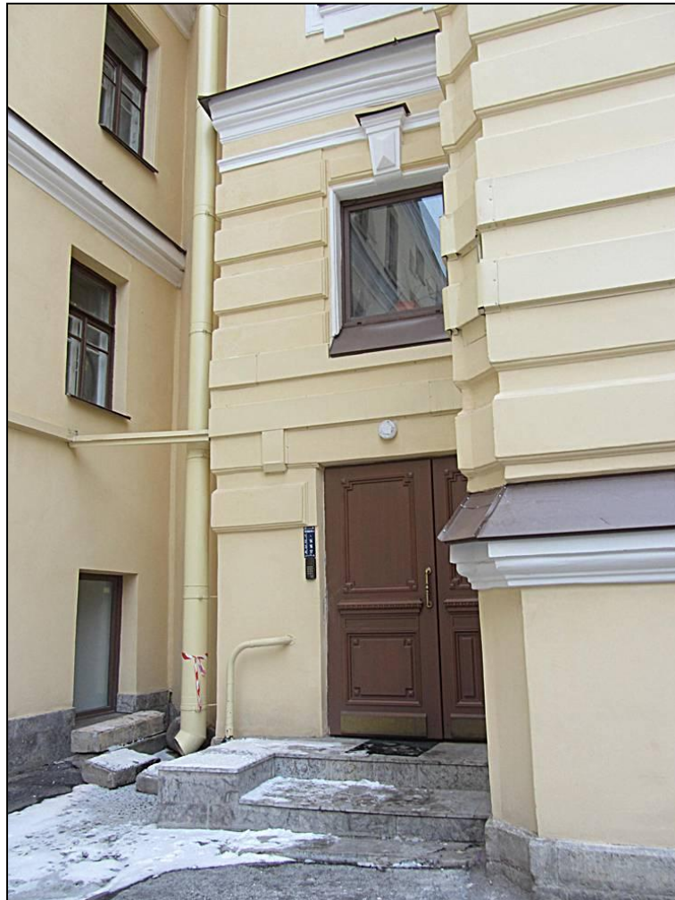
25. Выявленный ОКН «Дом Петерсона (Лобановых-Ростовских)». Внутренний двор. Фрагмент северо-западного фасада. Вход на лестницу 4ЛК.
