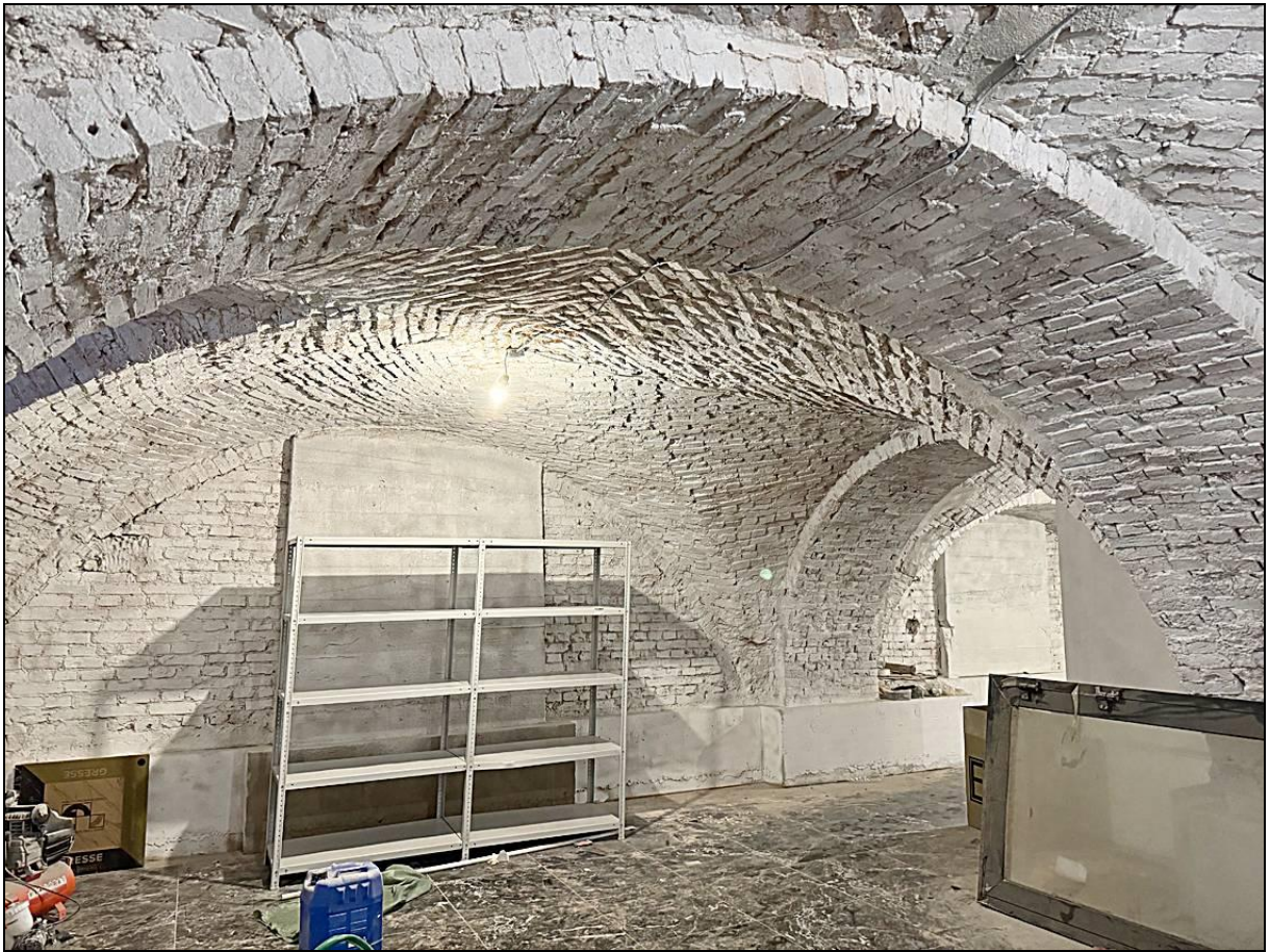
97. Выявленный ОКН «Дом Петерсона (Лобановых-Ростовских)». Фрагмент интерьера подвала.
