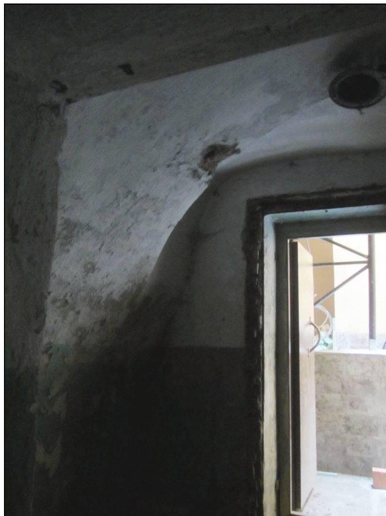
111. Выявленный ОКН «Дом Петерсона (Лобановых-Ростовских)». Фрагмент интерьера подвала.
