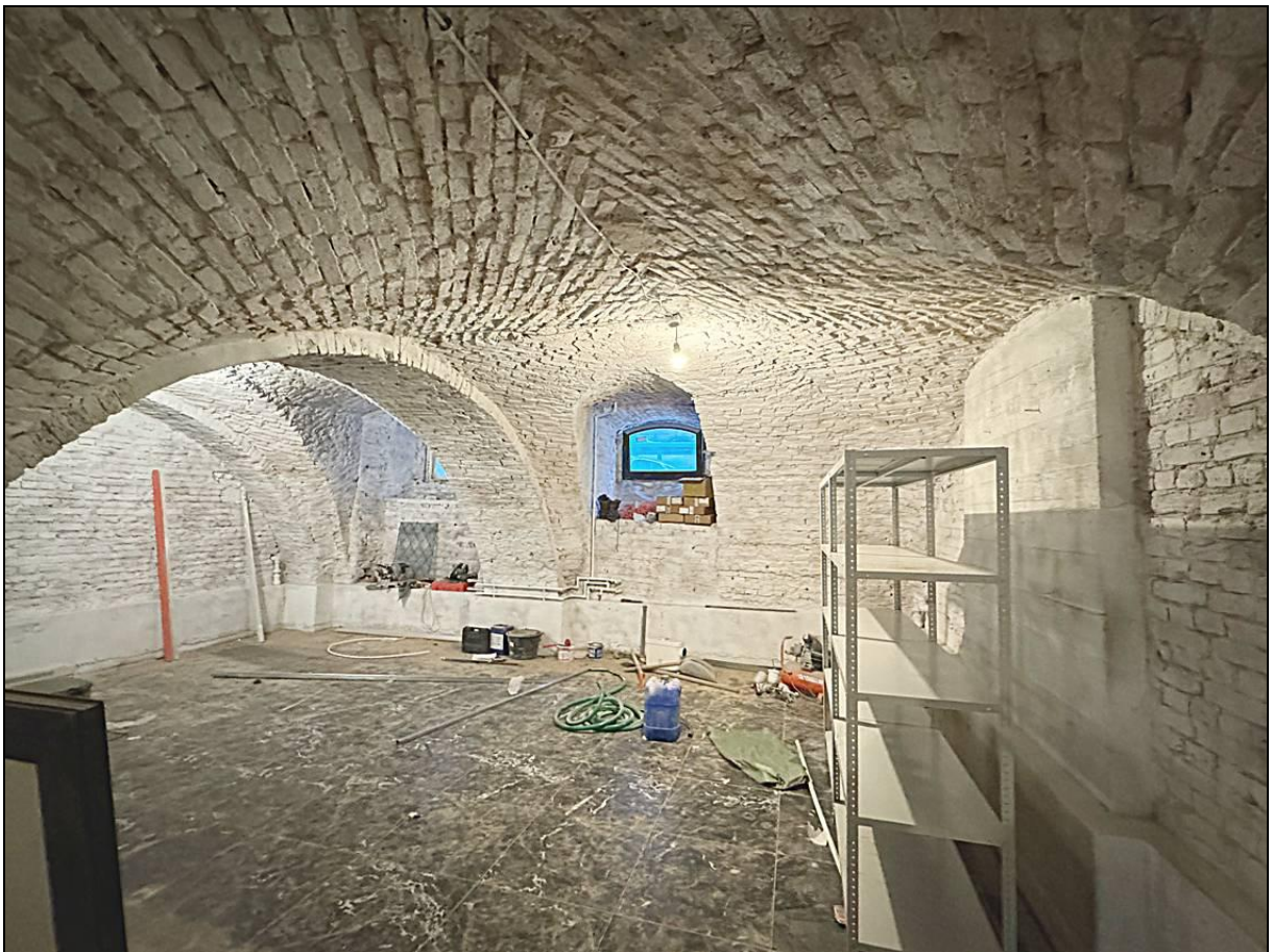
96. Выявленный ОКН «Дом Петерсона (Лобановых-Ростовских)». Фрагмент интерьера подвала.
