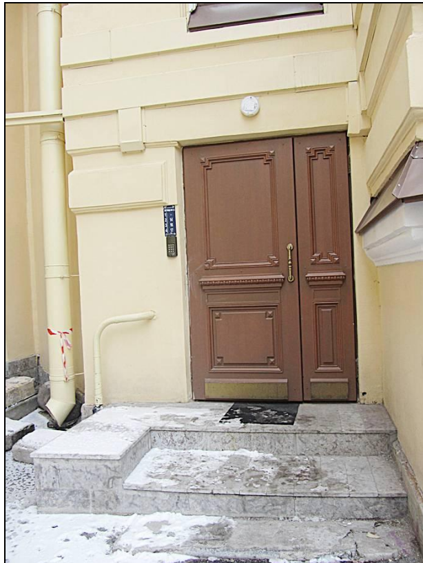
65. Выявленный ОКН «Дом Петерсона (Лобановых-Ростовских)». Внутренний двор. Фрагмент северо-западного фасада. Вход на лестницу 4ЛК.
