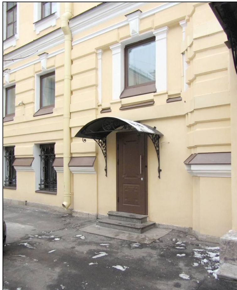
24. Выявленный ОКН «Дом Петерсона (Лобановых-Ростовских)». Внутренний двор. Фрагмент северо-западного фасада.
