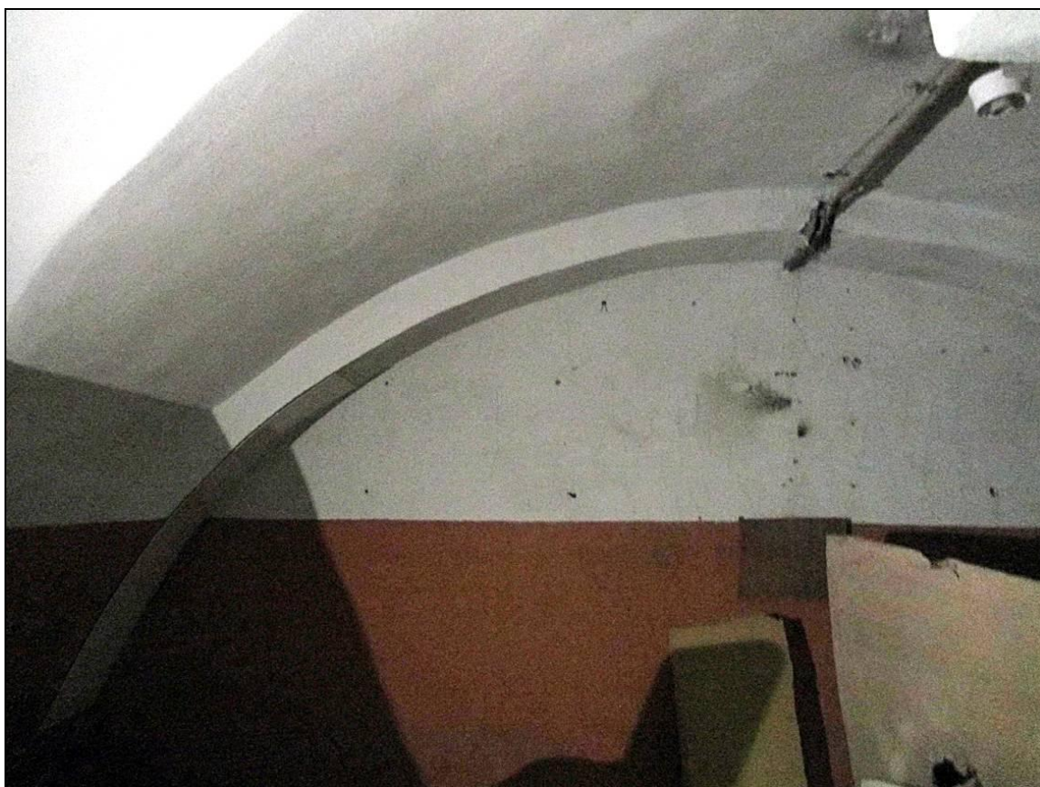
106. Выявленный ОКН «Дом Петерсона (Лобановых-Ростовских)». Фрагмент интерьера подвала.
