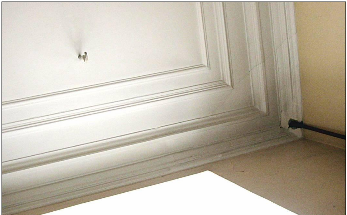
61, 62. Выявленный ОКН «Дом Петерсона (Лобановых-Ростовских)». Фрагмент интерьера. ЗЛК. Фрагмент лестничного ограждения. Фрагмент плафона верхнего этажа.
