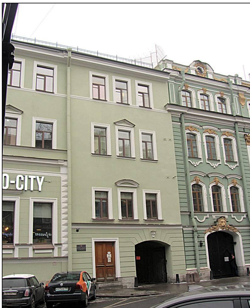
3. Выявленный ОКН «Дом Петерсона (Лобановых-Ростовских)». Фрагмент главного фасада со стороны Большой Морской улицы.
