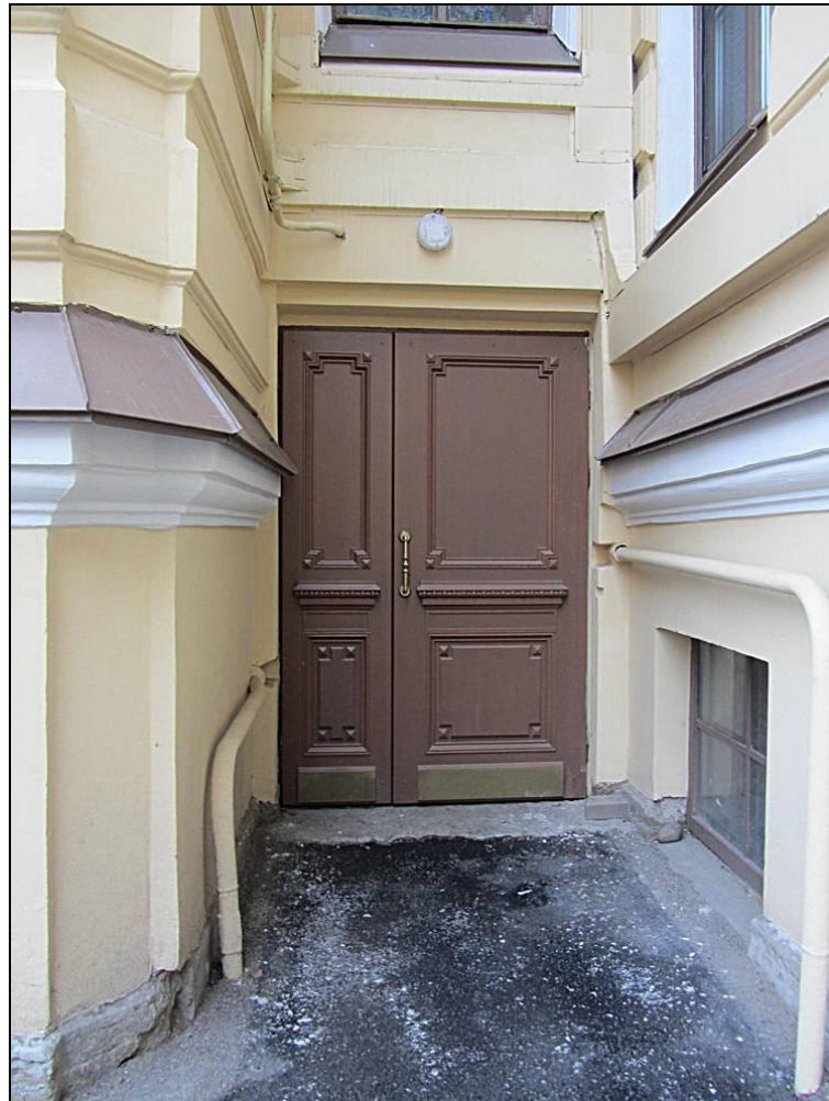
16. Выявленный ОКН «Дом Петерсона (Лобановых-Ростовских)». Внутренний двор. Фрагмент северо-западного фасада. Вход на лестницу 2ЛК.
