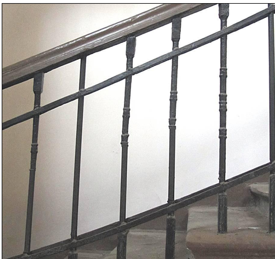
82, 83. Выявленный ОКН «Дом Петерсона (Лобановых-Ростовских)». Фрагмент интерьера лестницы БЛК. Фрагмент лестничного ограждения.
