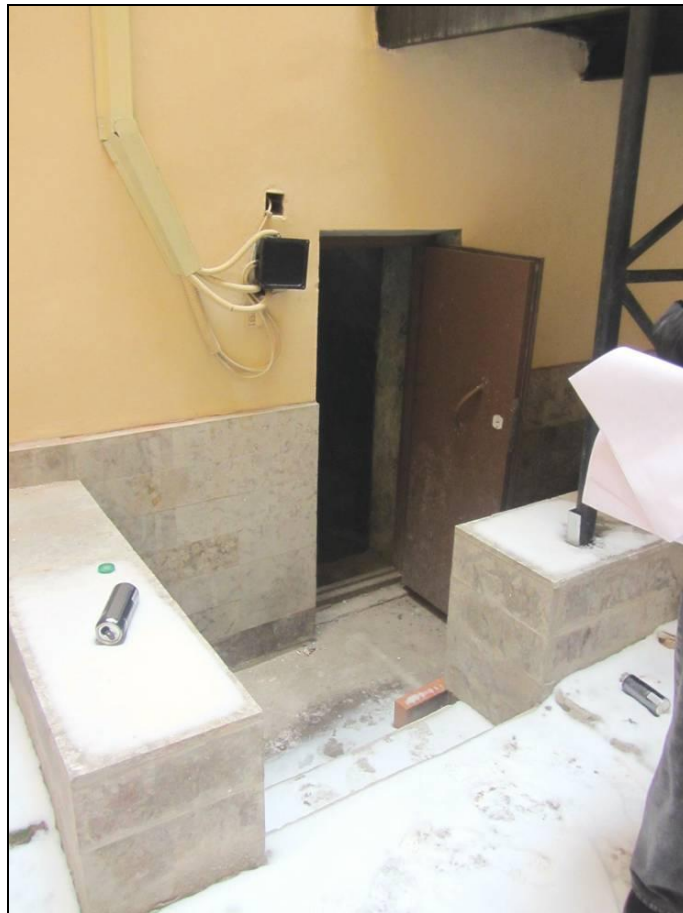
32. Выявленный ОКН «Дом Петерсона (Лобановых-Ростовских)». Вход в подвал из внутреннего двора.
