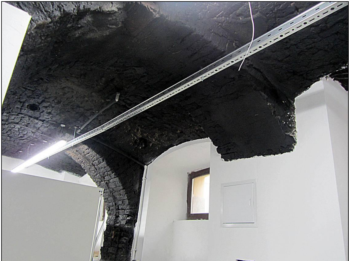
94. Выявленный ОКН «Дом Петерсона (Лобановых-Ростовских)». Фрагмент интерьера подвала.
