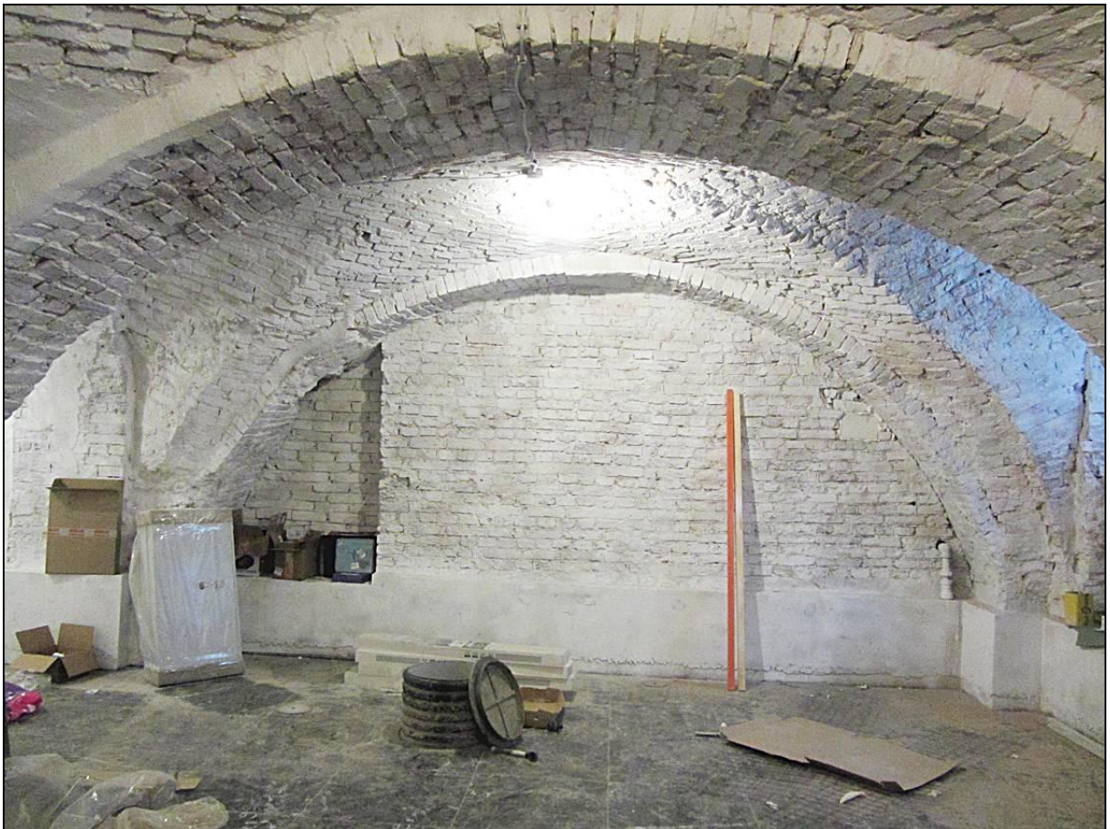
100. Выявленный ОКН «Дом Петерсона (Лобановых-Ростовских)». Фрагмент интерьера подвала.
