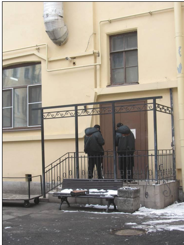
30. Выявленный ОКН «Дом Петерсона (Лобановых-Ростовских)». Внутренний двор. Фрагмент юго-восточного фасада. Вход на БЛК.
