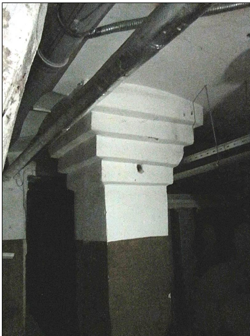
103. Выявленный ОКН «Дом Петерсона (Лобановых-Ростовских)». Фрагмент интерьера подвала.
