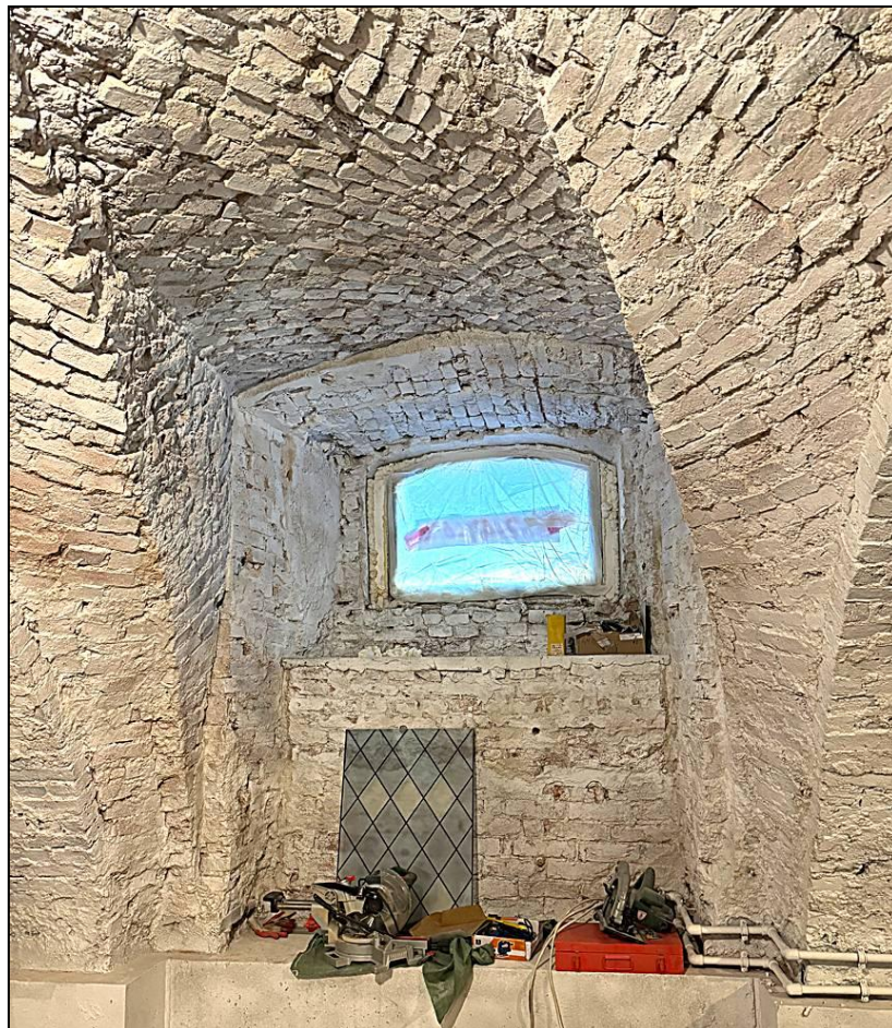
99. Выявленный ОКН «Дом Петерсона (Лобановых-Ростовских)». Фрагмент интерьера подвала.
