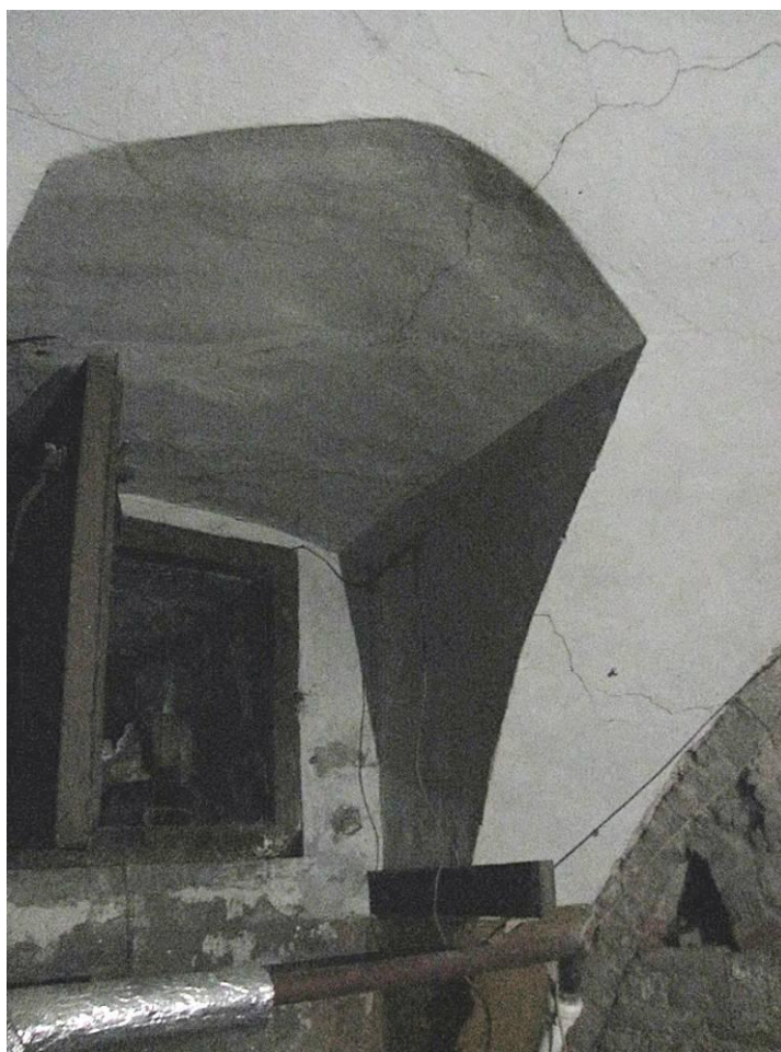
108. Выявленный ОКН «Дом Петерсона (Лобановых-Ростовских)». Фрагмент интерьера подвала.
