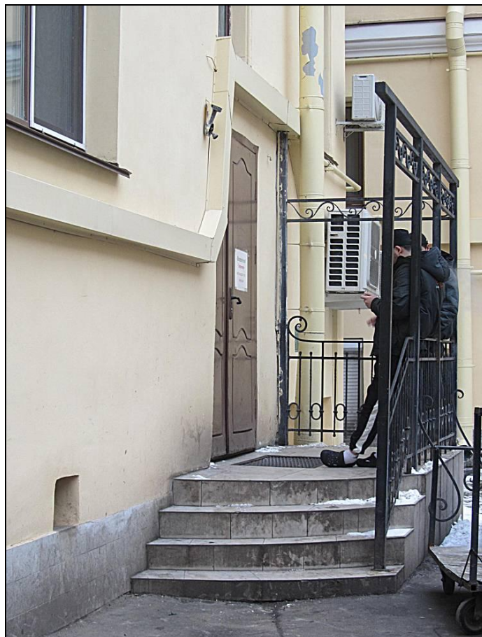
79. Выявленный ОКН «Дом Петерсона (Лобановых-Ростовских)». Внутренний двор. Фрагмент юго-восточного фасада. Вход на лестницу БЛК.
