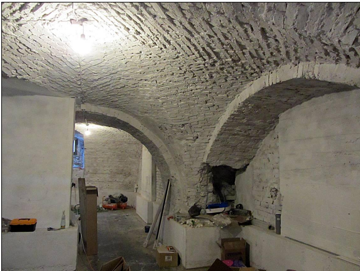
95. Выявленный ОКН «Дом Петерсона (Лобановых-Ростовских)». Фрагмент интерьера подвала.
