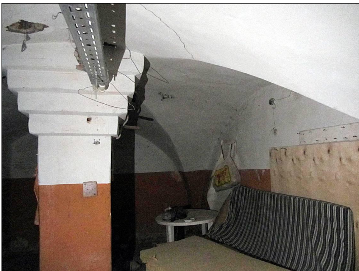
104. Выявленный ОКН «Дом Петерсона (Лобановых-Ростовских)». Фрагмент интерьера подвала.
