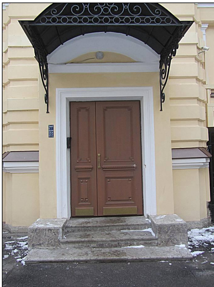
50. Выявленный ОКН «Дом Петерсона (Лобановых-Ростовских)». Внутренний двор. Фрагмент северо-западного фасада. Вход на лестницу 3ЛК.
