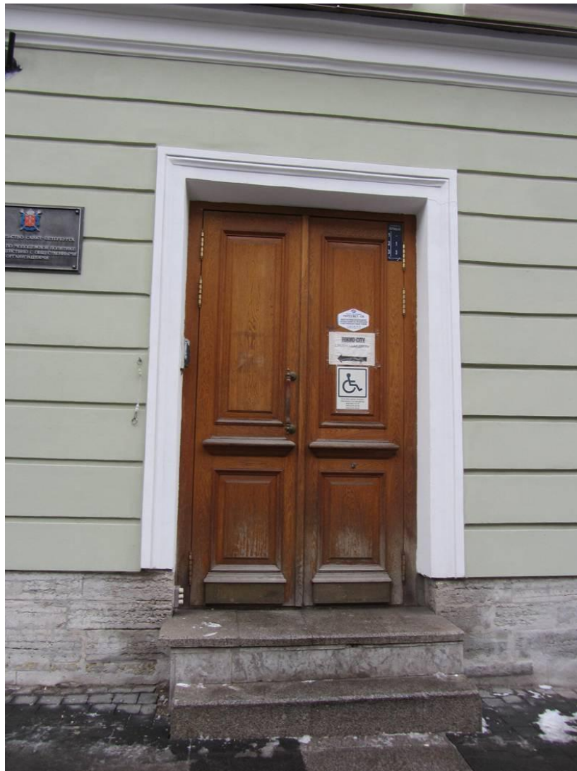
4. Выявленный ОКН «Дом Петерсона (Лобановых-Ростовских)». Фрагмент главного фасада со стороны Большой Морской улицы.
