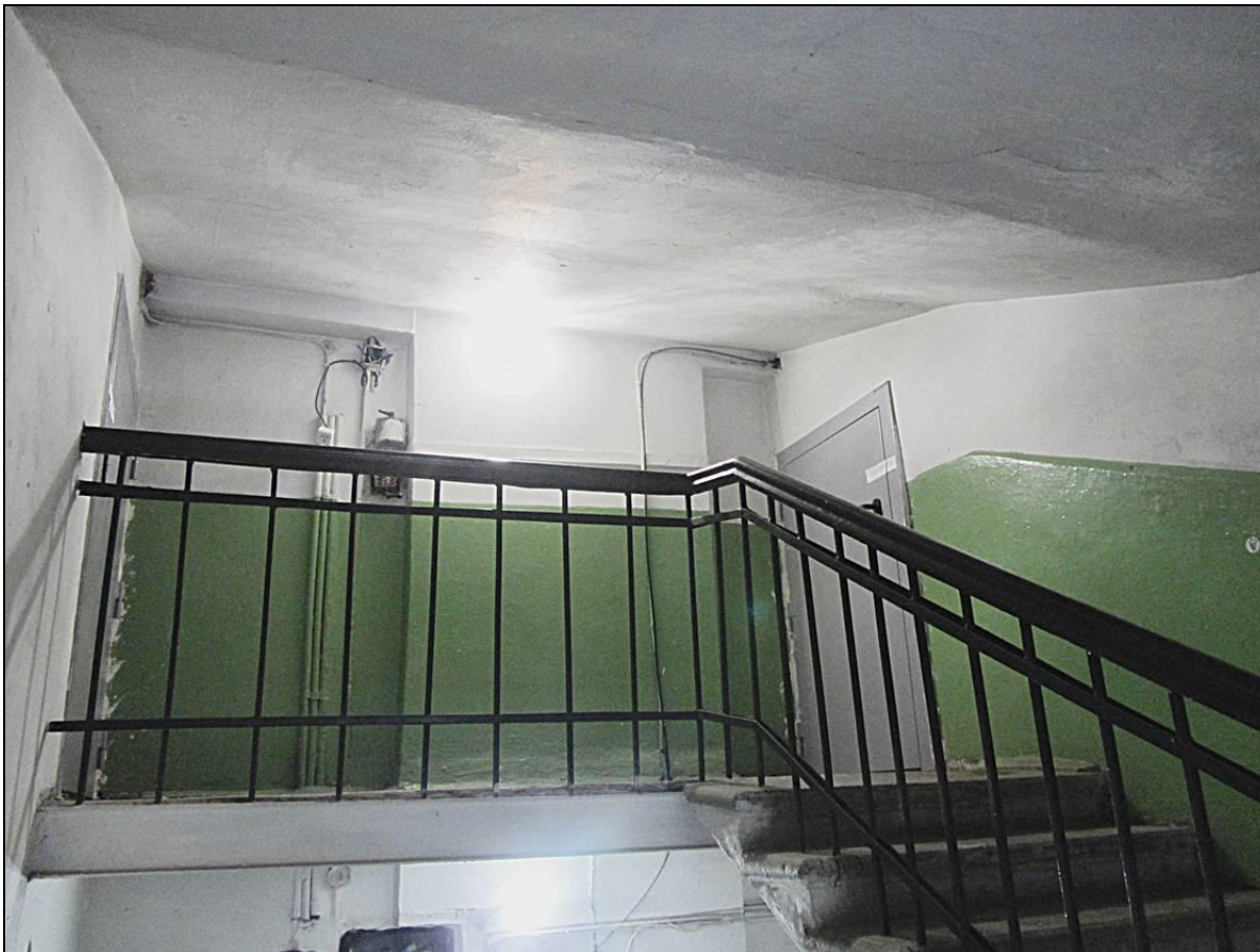
77. Выявленный ОКН «Дом Петерсона (Лобановых-Ростовских)». Фрагмент интерьера лестницы 5ЛК. Верхний этаж.
