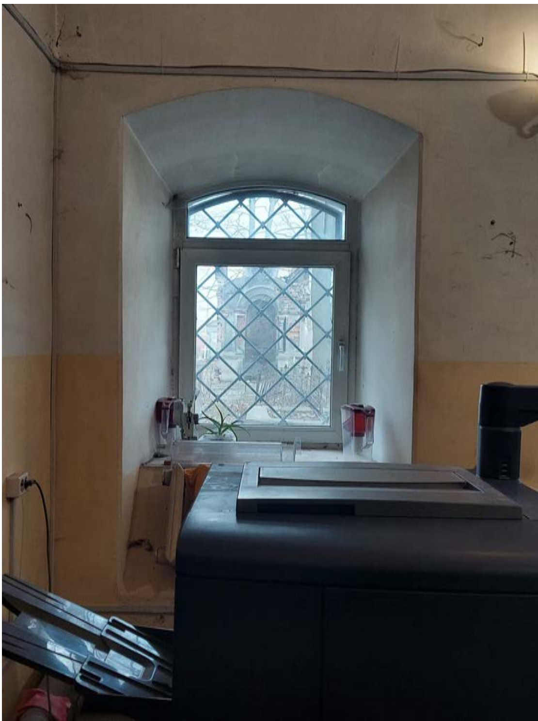
Фото21. Вид через окно цокольного этажа в сторону кладбища (на восточную сторону Ризницы)
