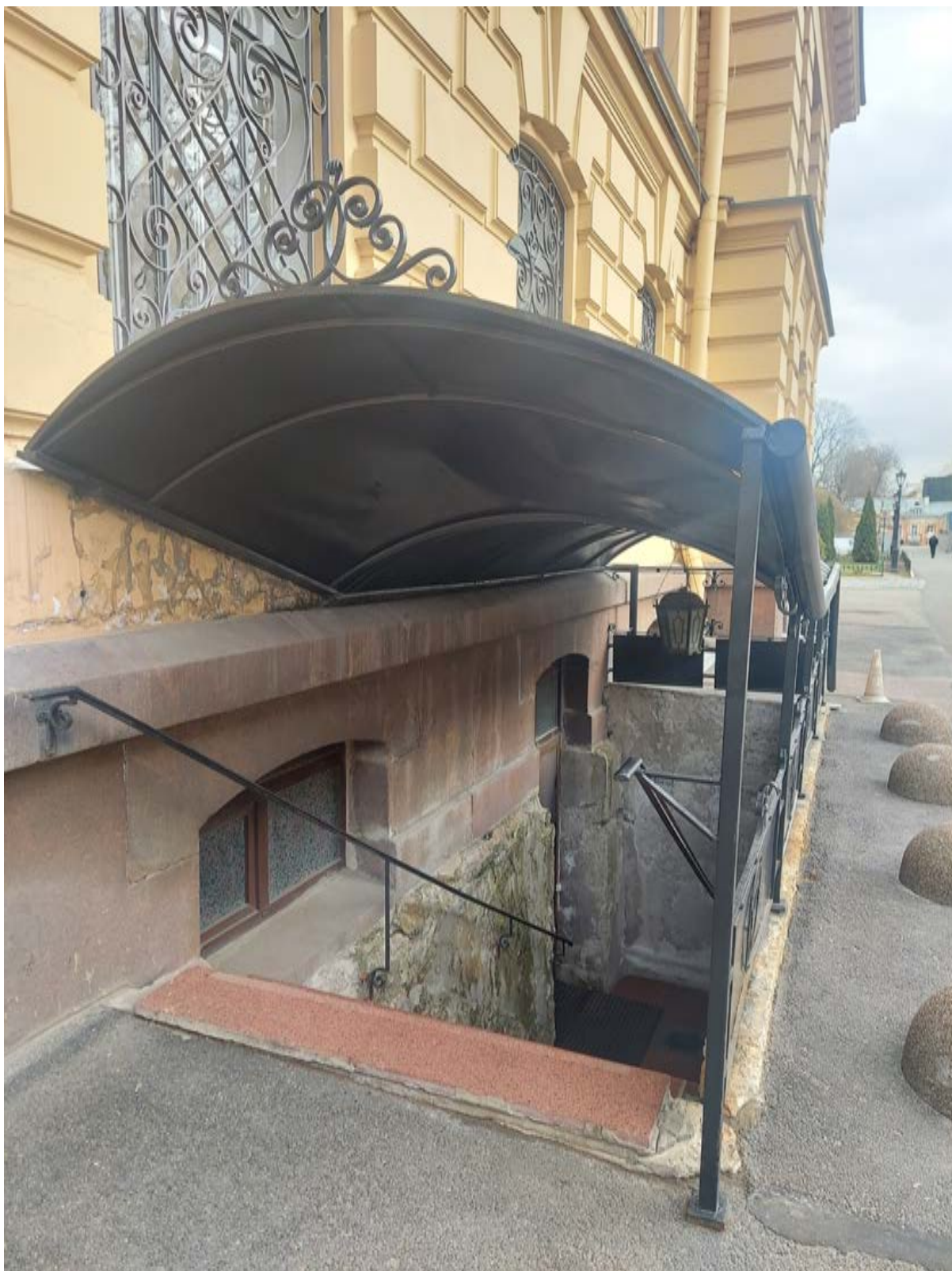
Фото 3. Прямок – спуск в подвальные помещения Ризницы.
