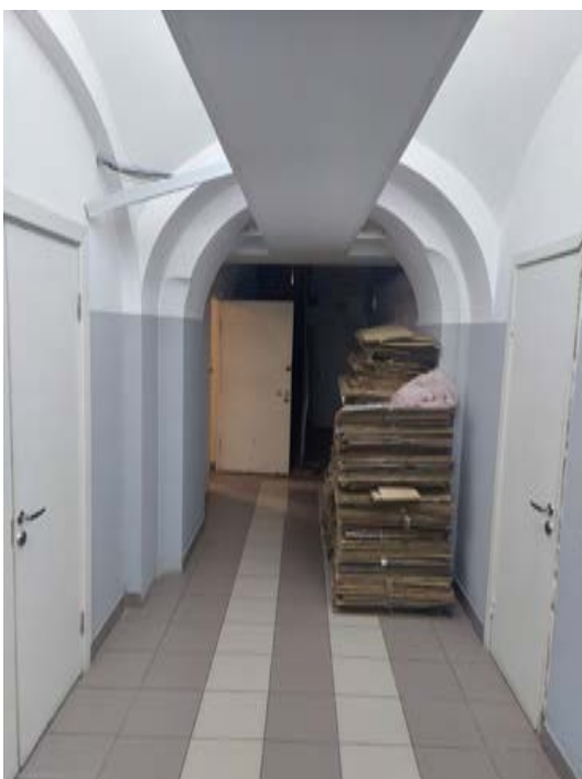
Фото 19. Коридор цокольного этажа.
