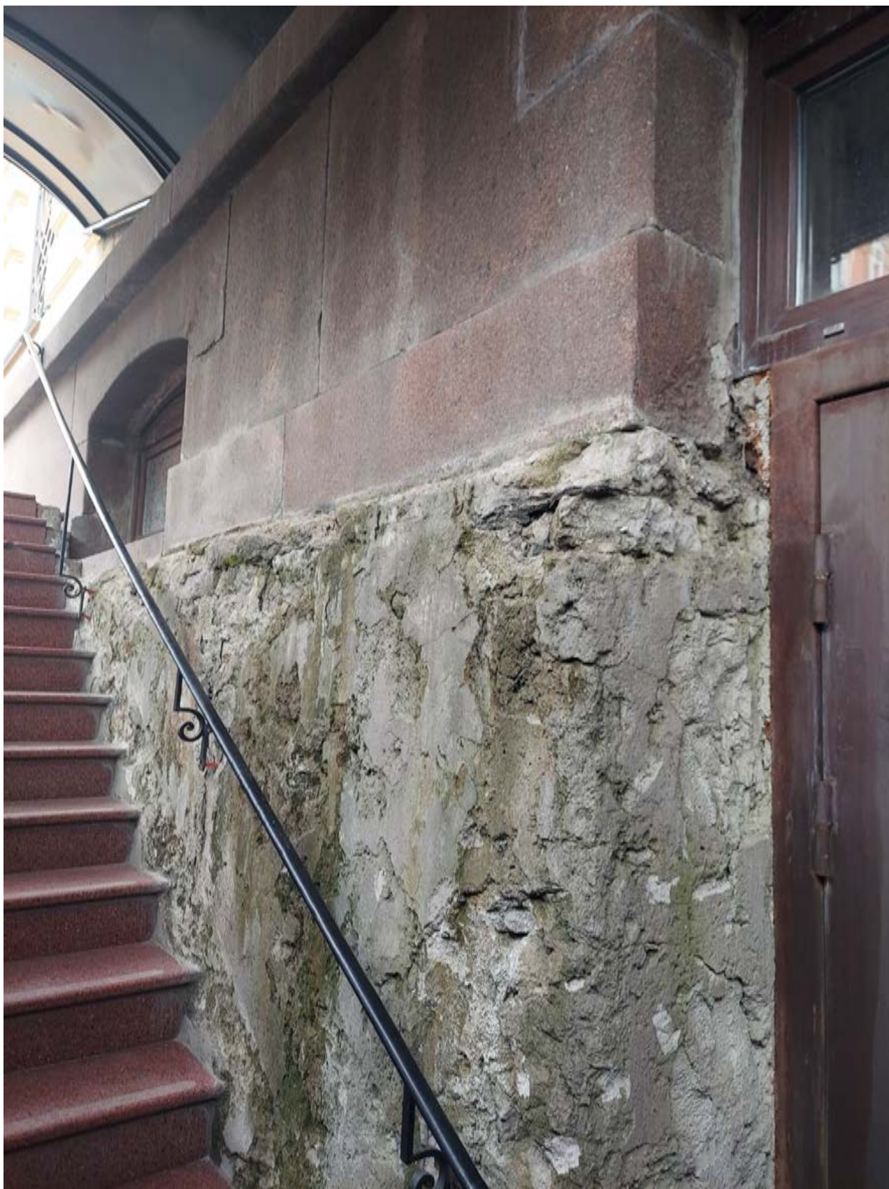
Фото 17. Вход в цокольный этаж Ризницы. Видна отделка цоколя и бутовый фундамент с обмазкой цементным раствором.
