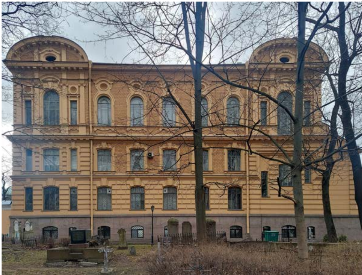
Фото 8. Восточный фасад Ризницы.
