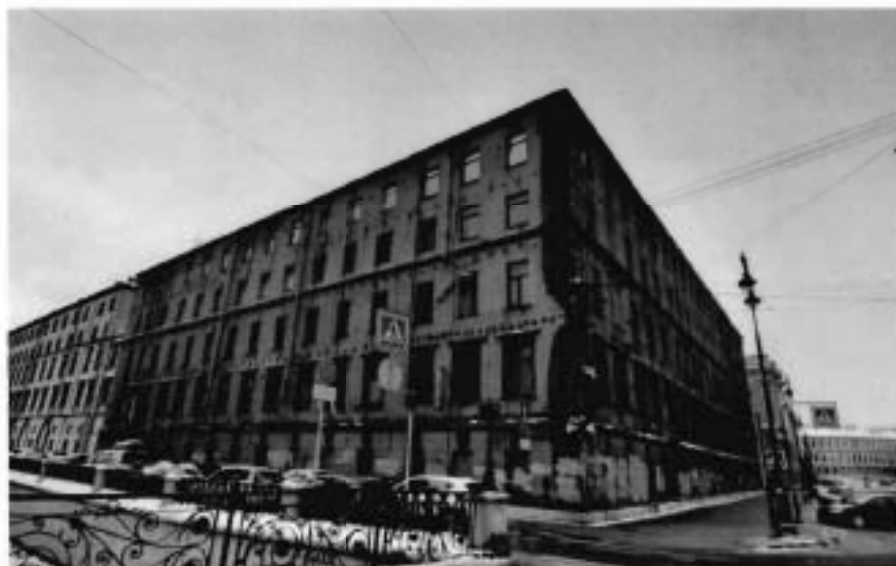
1. Общий вид на объект культурного наследия
