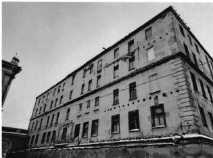
2. Вид на западный фасад объекта культурного наследия
