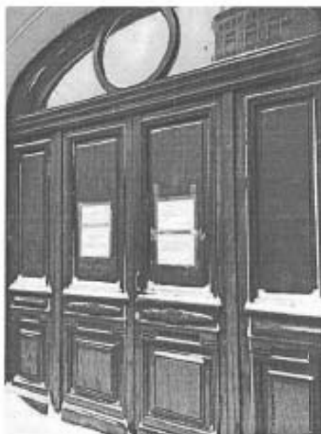
Дверное заполнение лестницы Л-1
