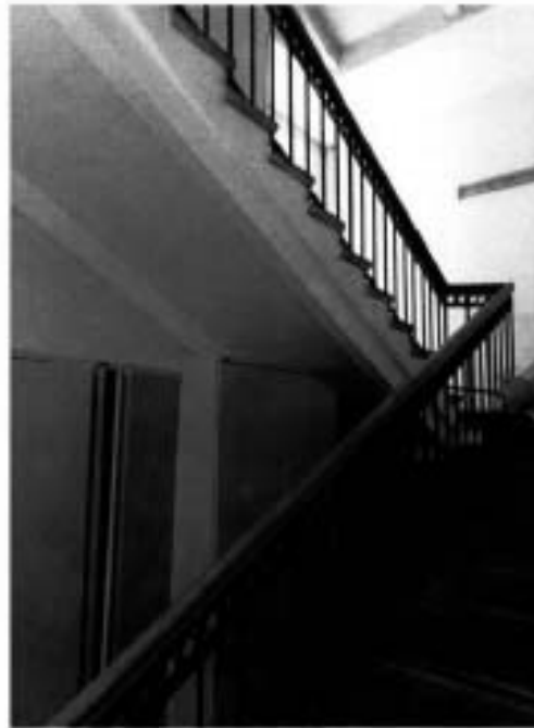
14. Интерьер объекта культурного наследия. Помещение № 2-Н(22).
