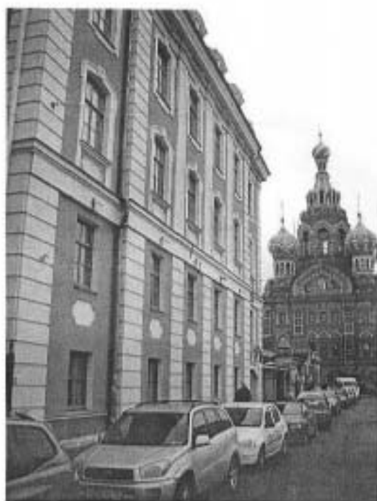
2. Лицевой фасад (вдоль канала Грибоедова).
