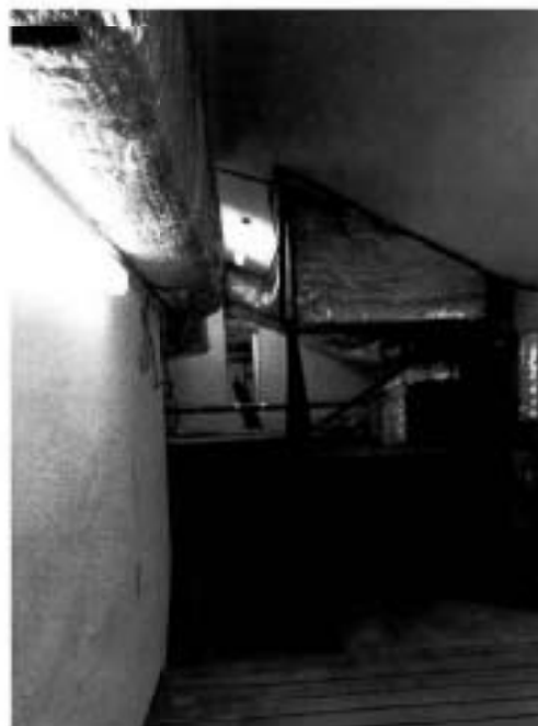
15. Чердачное пространство объекта культурного наследия.
