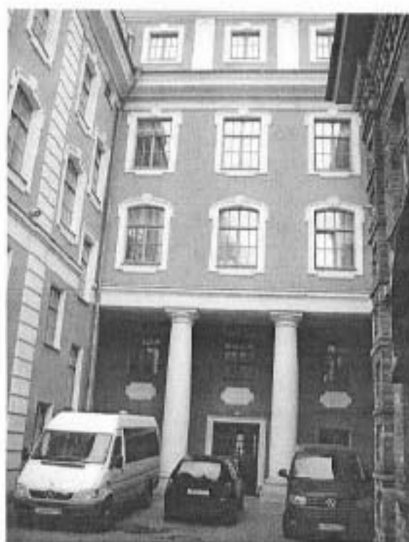
4. Дворовый фасад и выход во двор.
