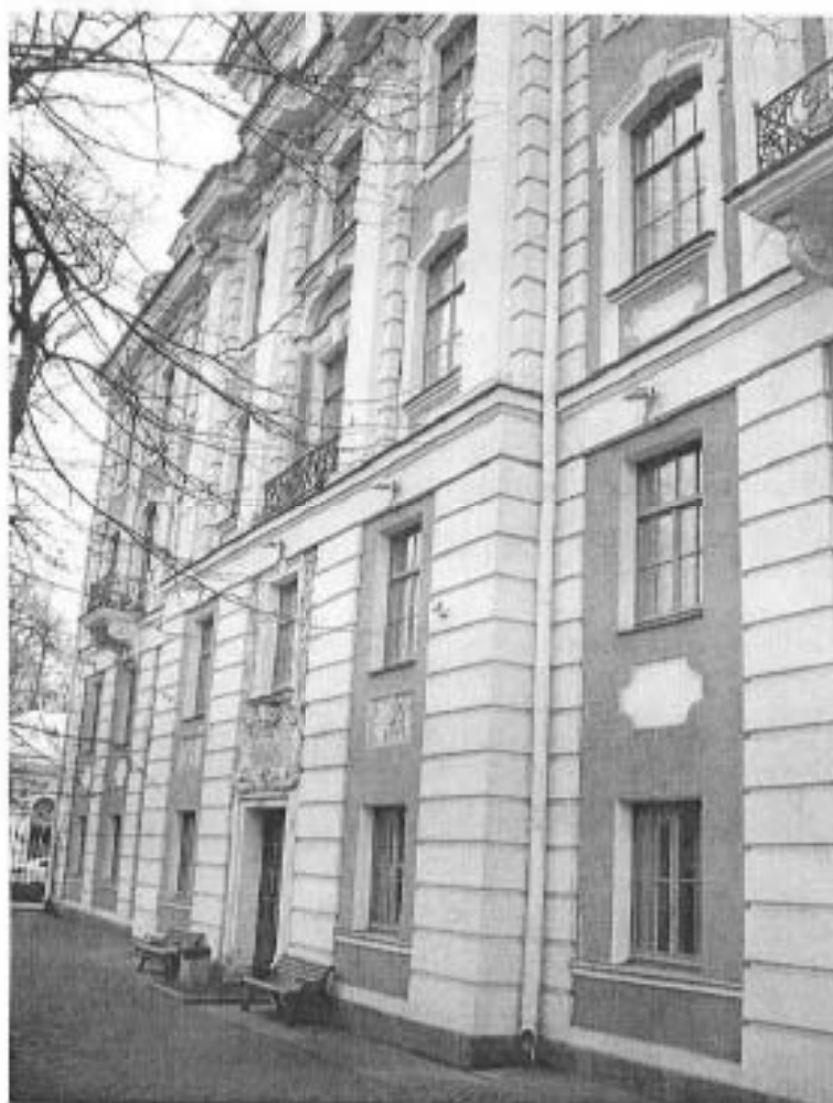
1. Лицевой фасад (вдоль реки Мойки).
