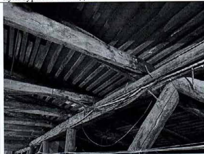
Фото 22. Фрагмент стропильной системы объекта культурного наследия.
