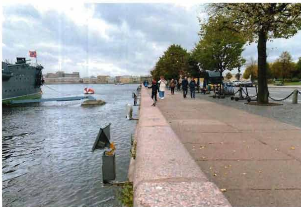
1. Общий вид на объект культурного наследия.
