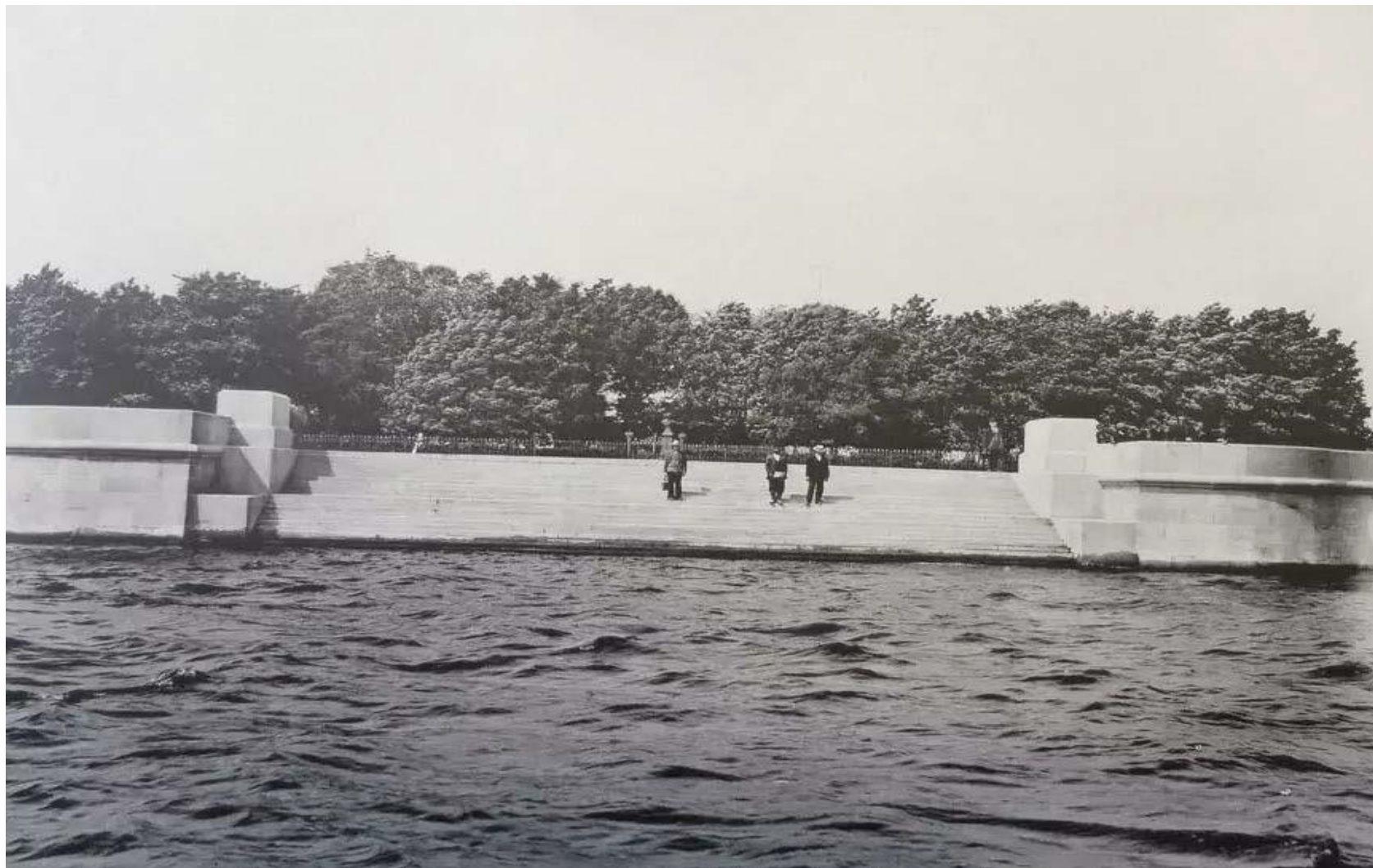
8. Петровская набережная. 1903 // "Альбом работ по постройке постоянного через р. Большую Неву Троицкого моста, дамбы и набережных между Кронверкским и Сампсониевским мостами, 1897-1903", СПб, "Т-во "Художественной Печати", Английский, 28.
