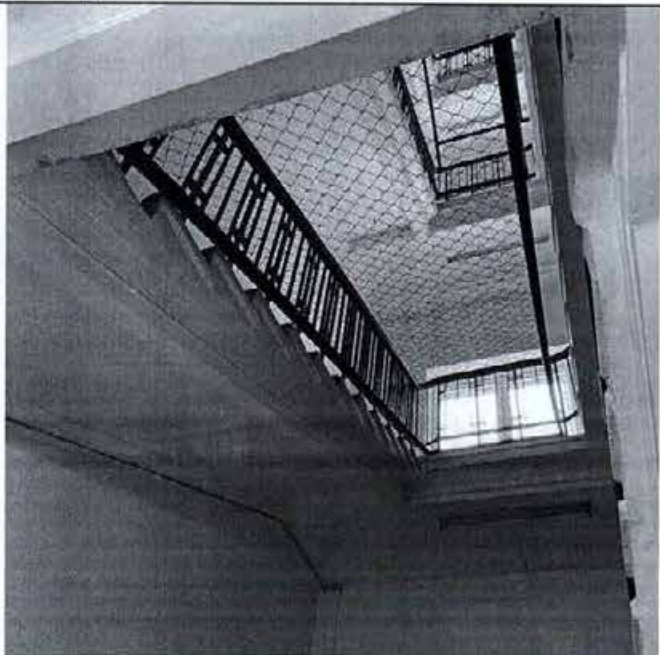
Фото 35. Лестница объекта культурного наследия.
