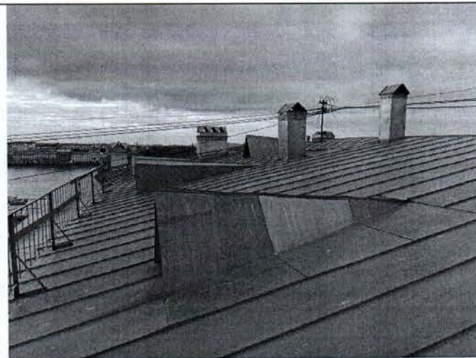
Фото 10. Фрагмент кровельного покрытия объекта культурного наследия.
