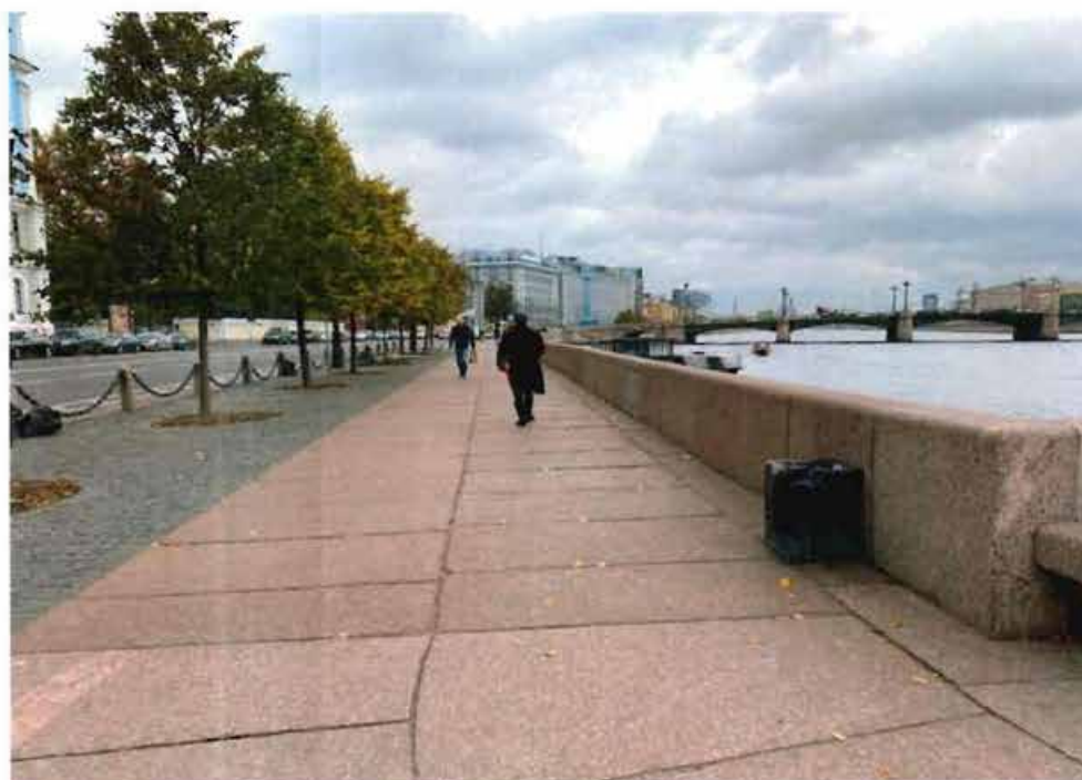
2. Общий вид на объект культурного наследия.
