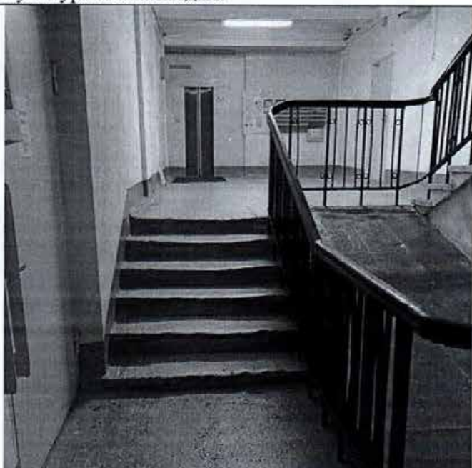
Фото 36. Лестница объекта культурного наследия.
