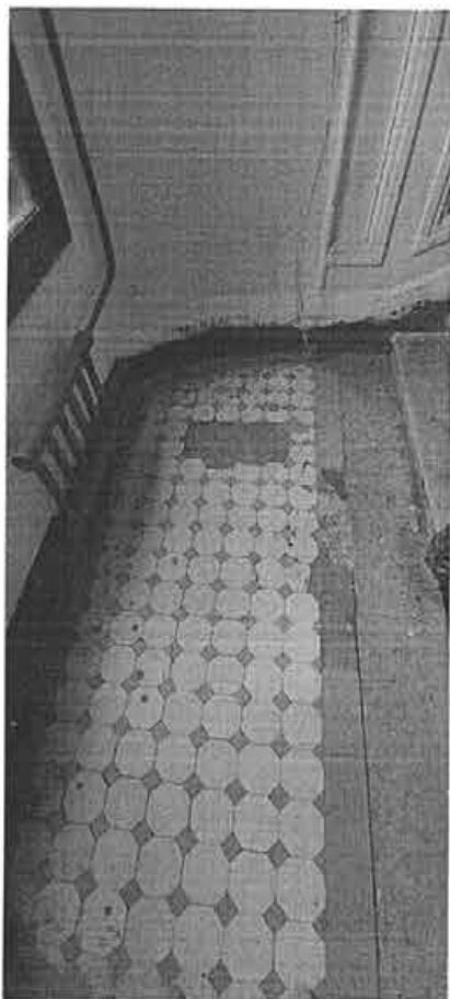
10. Состояние лестничной площадки
