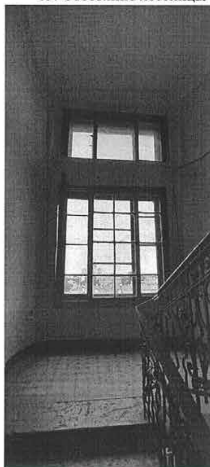
16. Состояние лестничной площадки
