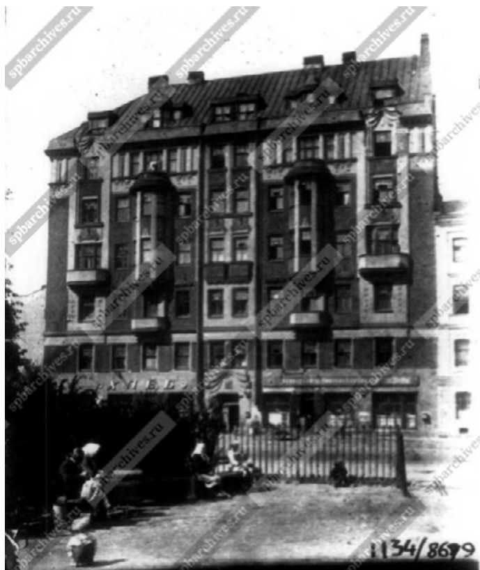
46. Общий вид жилого дома №21 на Измайловском проспекте. Дата съёмки: 1947 г. Архивный шифр: ЦГАКФФД СПб Вр 75084.
