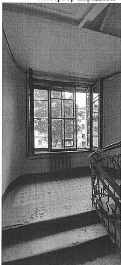
9. Состояние лестничной площадки
