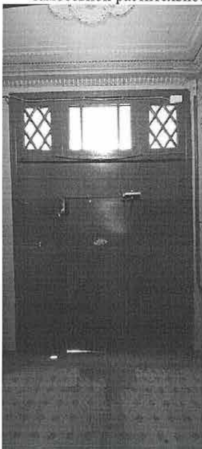
7. Входная дверь со стороны подъезда
