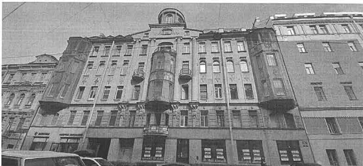
1. Общий вид лицевого фасада по 12-й Красноармейской ул.
