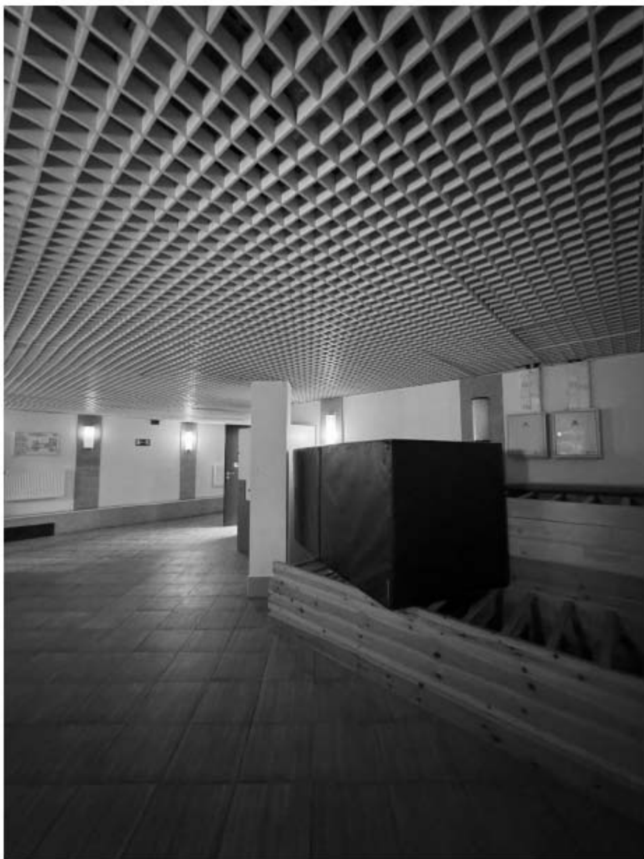
Фото 37. Вид на интерьер подвальных помещений объекта культурного наследия.
