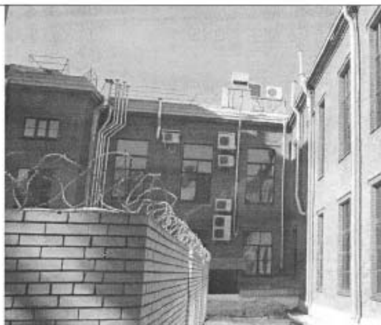
Фрагмент восточного фасада лицевого корпуса. Съёмка 21.03.2012, В.А. Матвеева.
