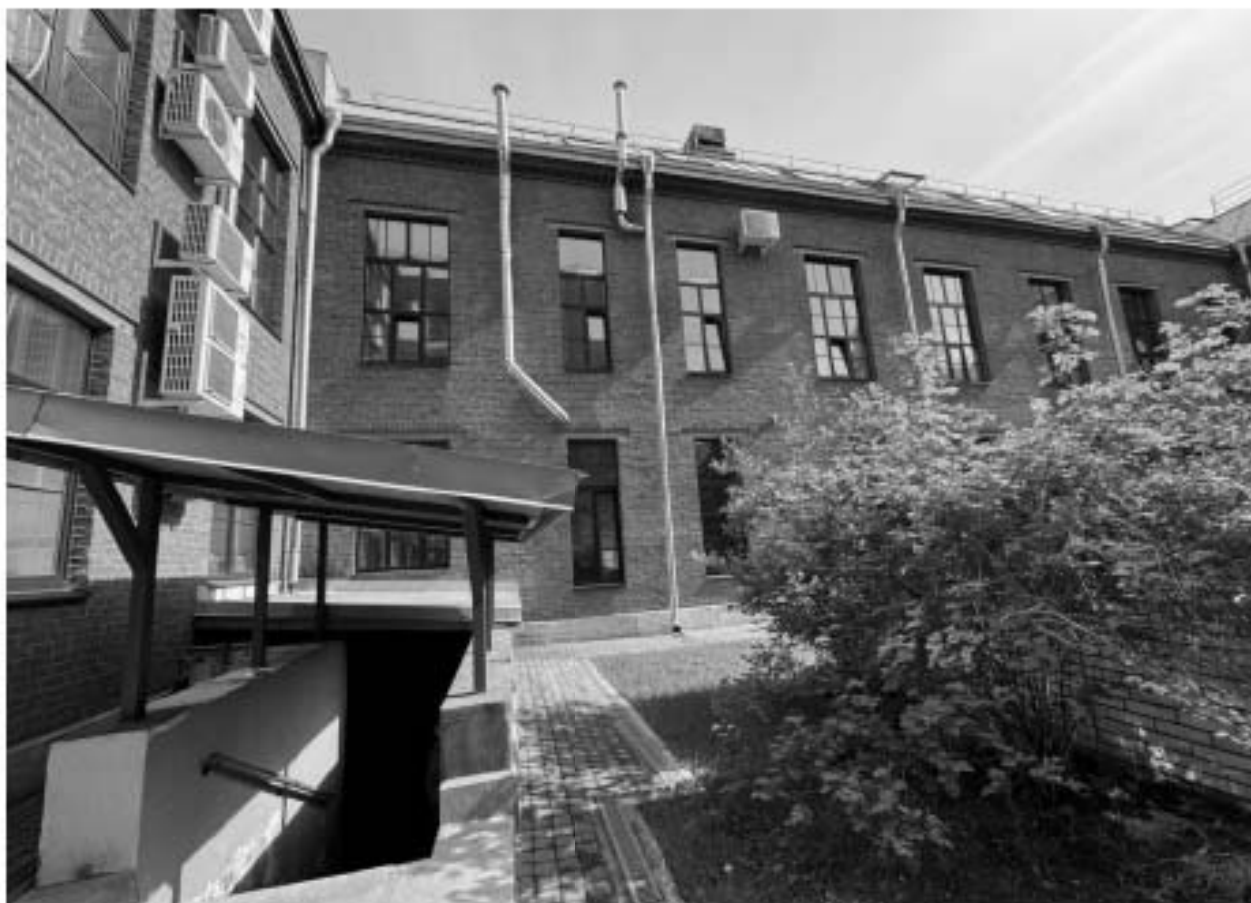
Фото 24. Общий вид дворовых фасадов объекта культурного наследия.
