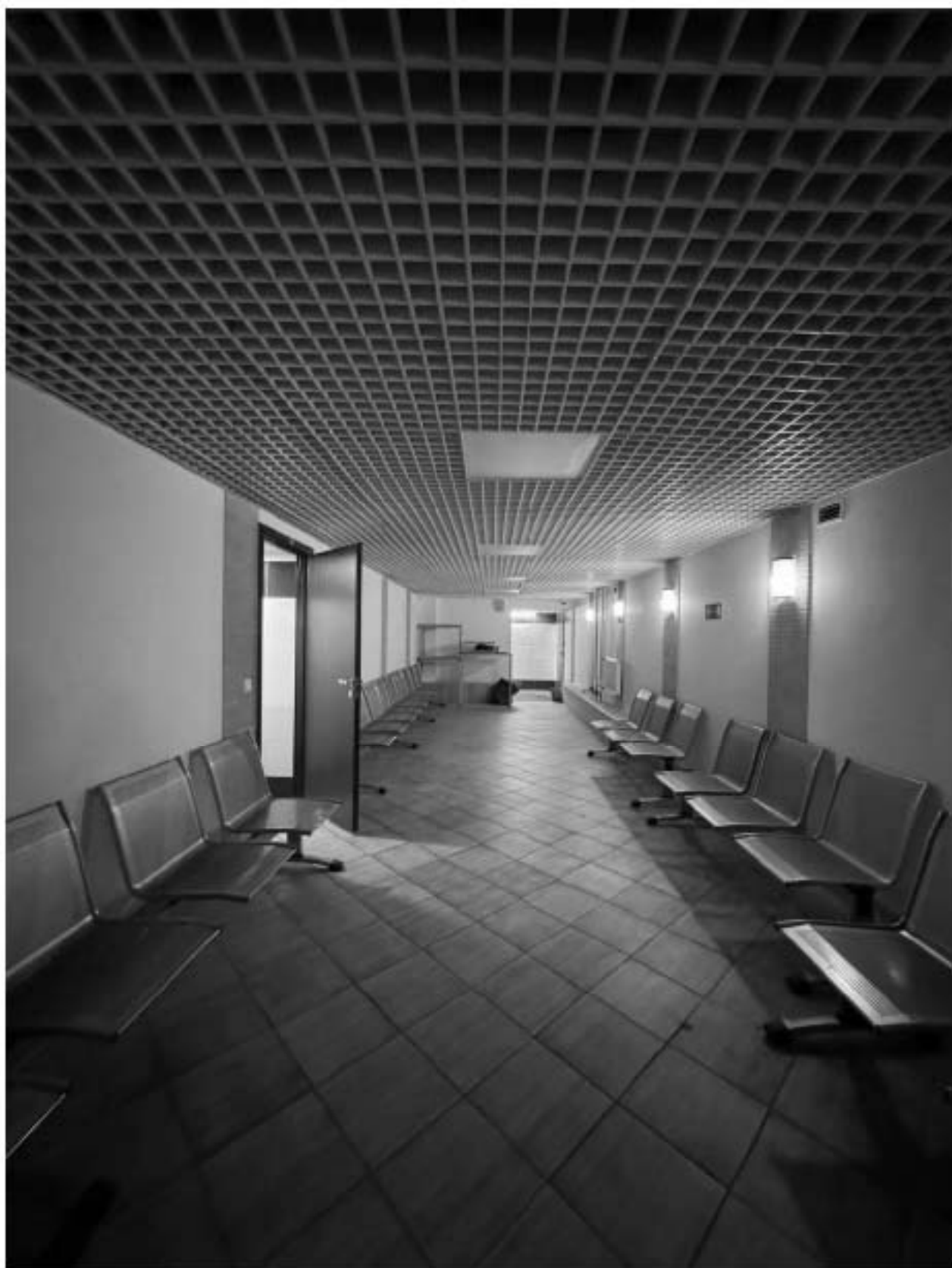
Фото 41. Вид на интерьер подвальных помещений объекта культурного наследия.
