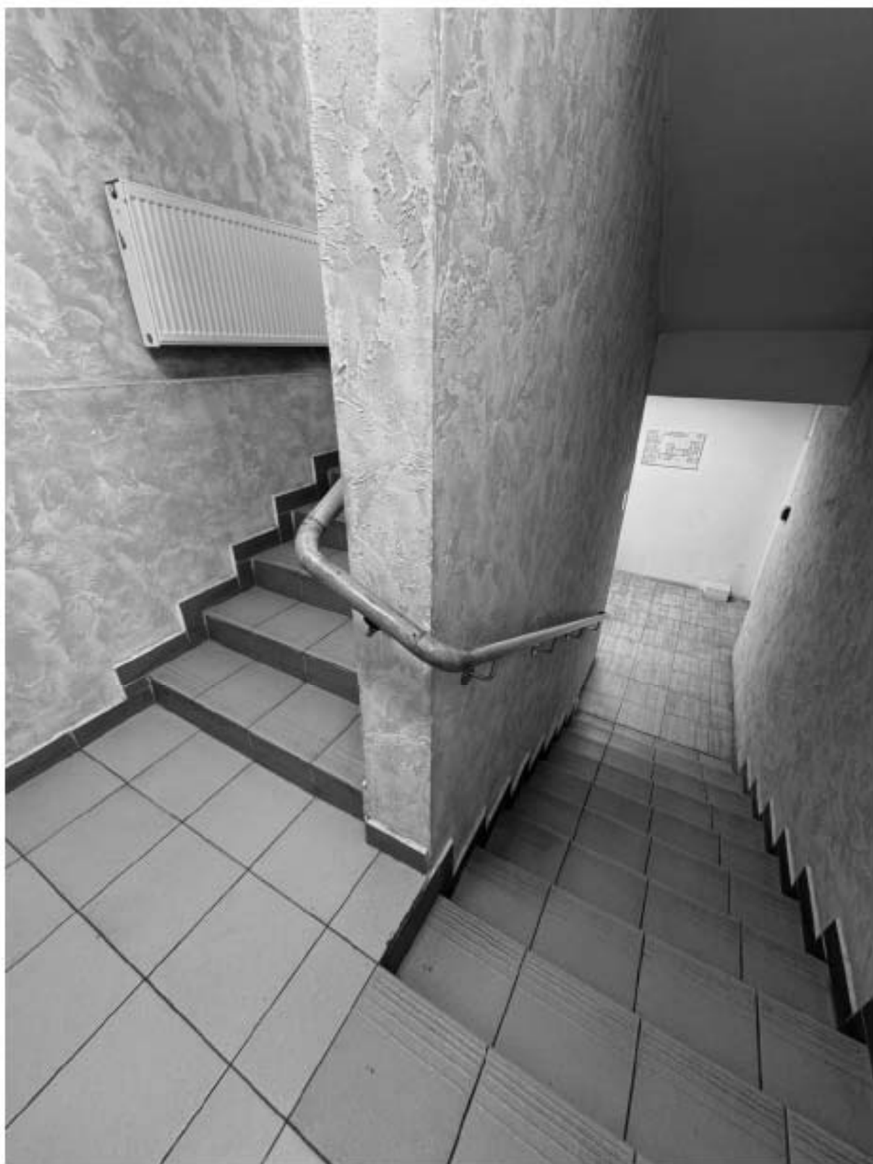
Фото 35. Вид на интерьер северо-восточной лестницы объекта культурного наследия.
