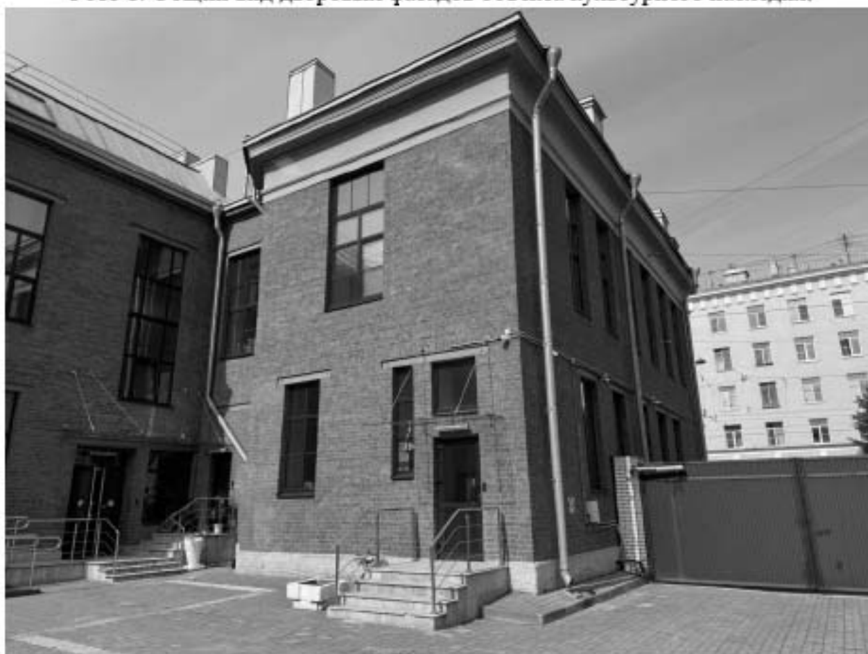
Фото 9. Общий вид дворовых фасадов объекта культурного наследия.
