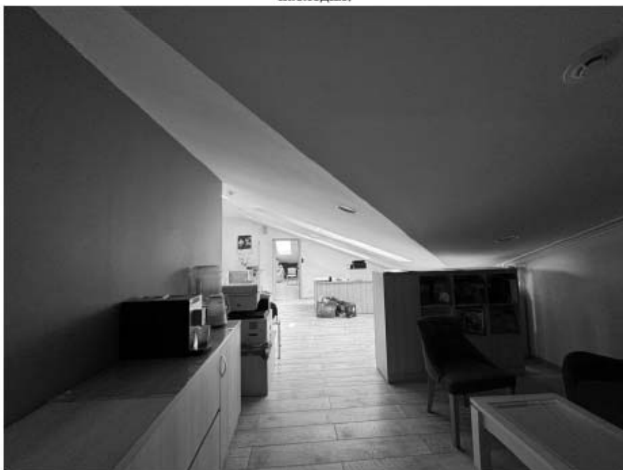
Фото 75. Вид на интерьер помещения мансардного этажа объекта культурного наследия.
