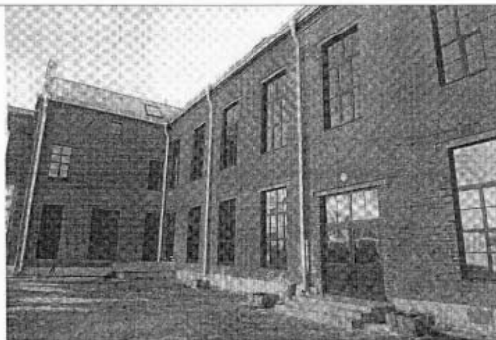
Северный фасад и южный фасад дворовых корпусов. Съёмка 21.03.2012, В.А. Матвеева.
