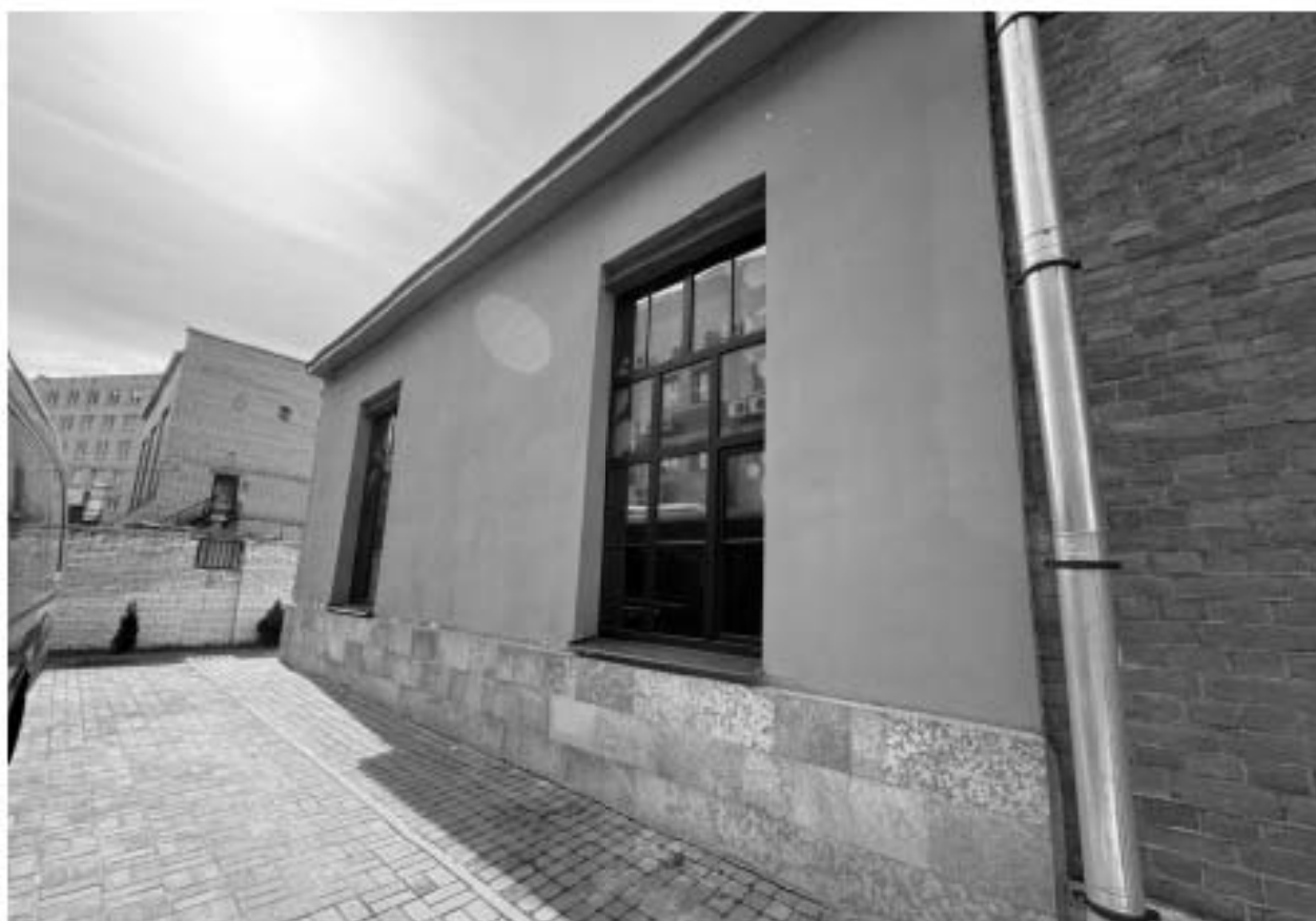
Фото 13. Общий вид пристройки к объекту культурного наследия.
