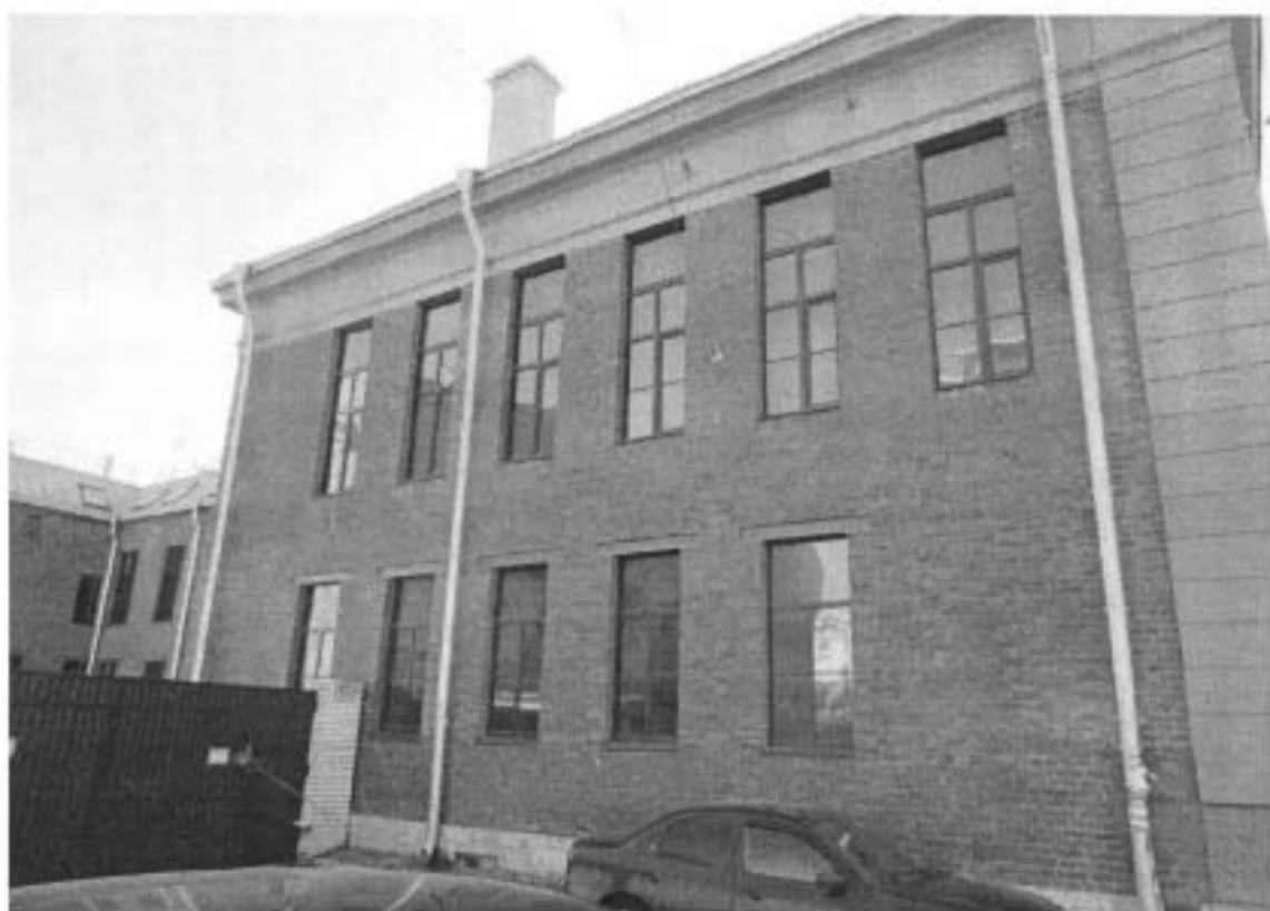
Северный фасад лицевого корпуса. Съемка 21.03.2012, В.А. Матвеева.
