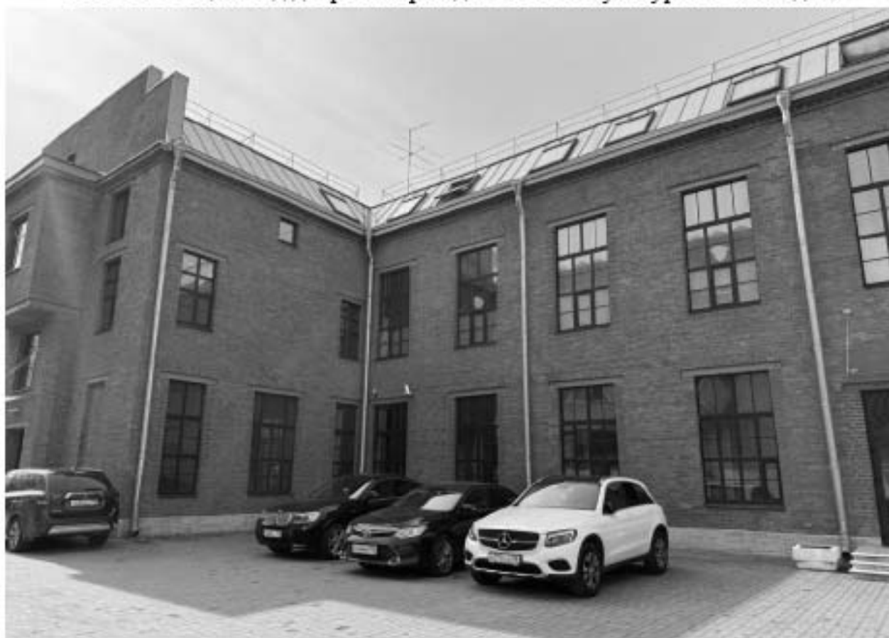
Фото 11. Общий вид дворовых фасадов объекта культурного наследия.
