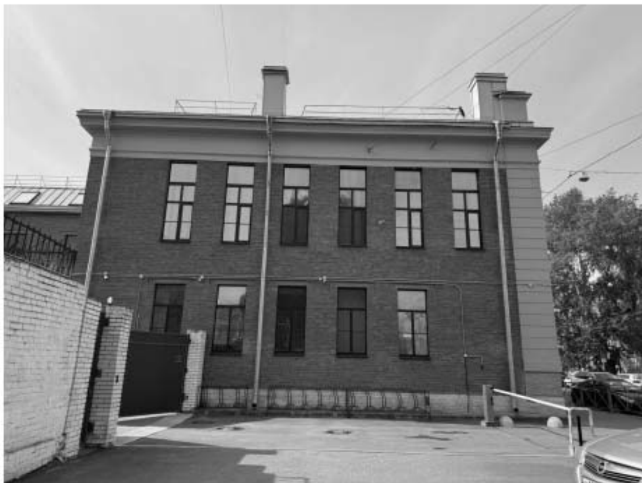
Фото 5. Общий вид бокового фасада объекта культурного наследия по Кондратьевскому проспекту.
