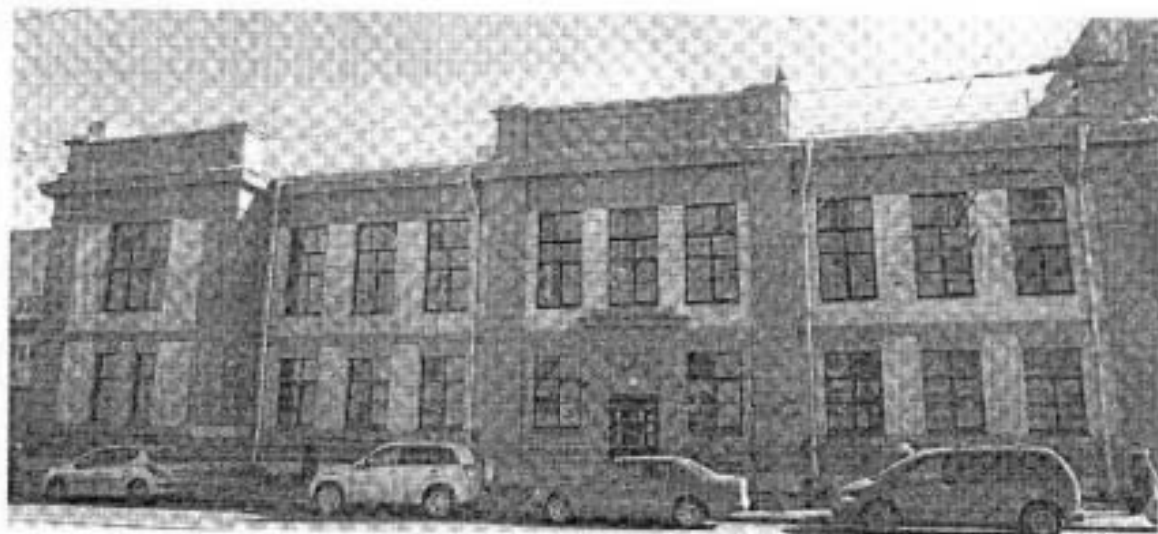
Западный лицевой фасад. Общий вид. Съёмка 21.03.2012, В.А. Матвеева.
