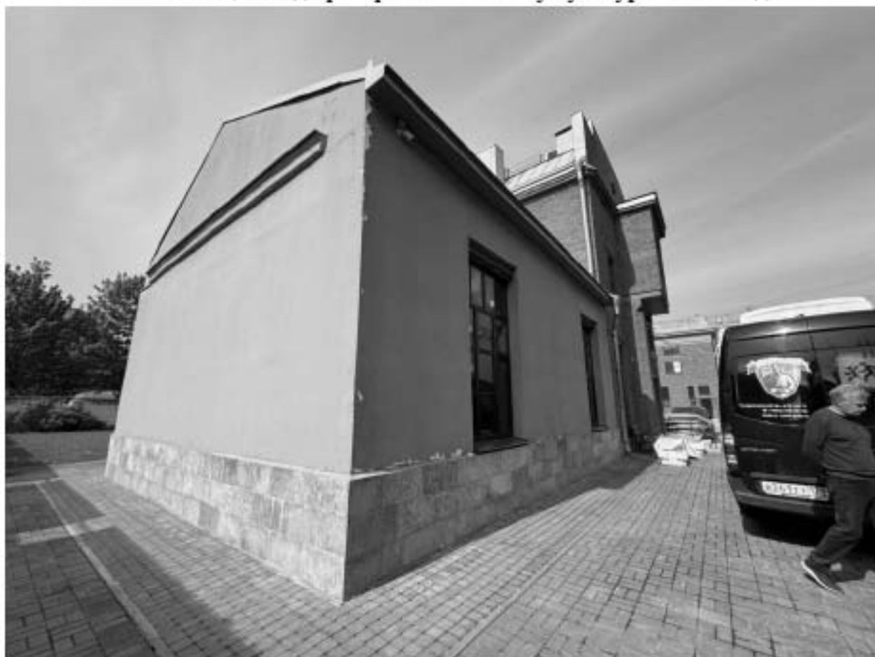
Фото 14. Общий вид пристройки к объекту культурного наследия.
