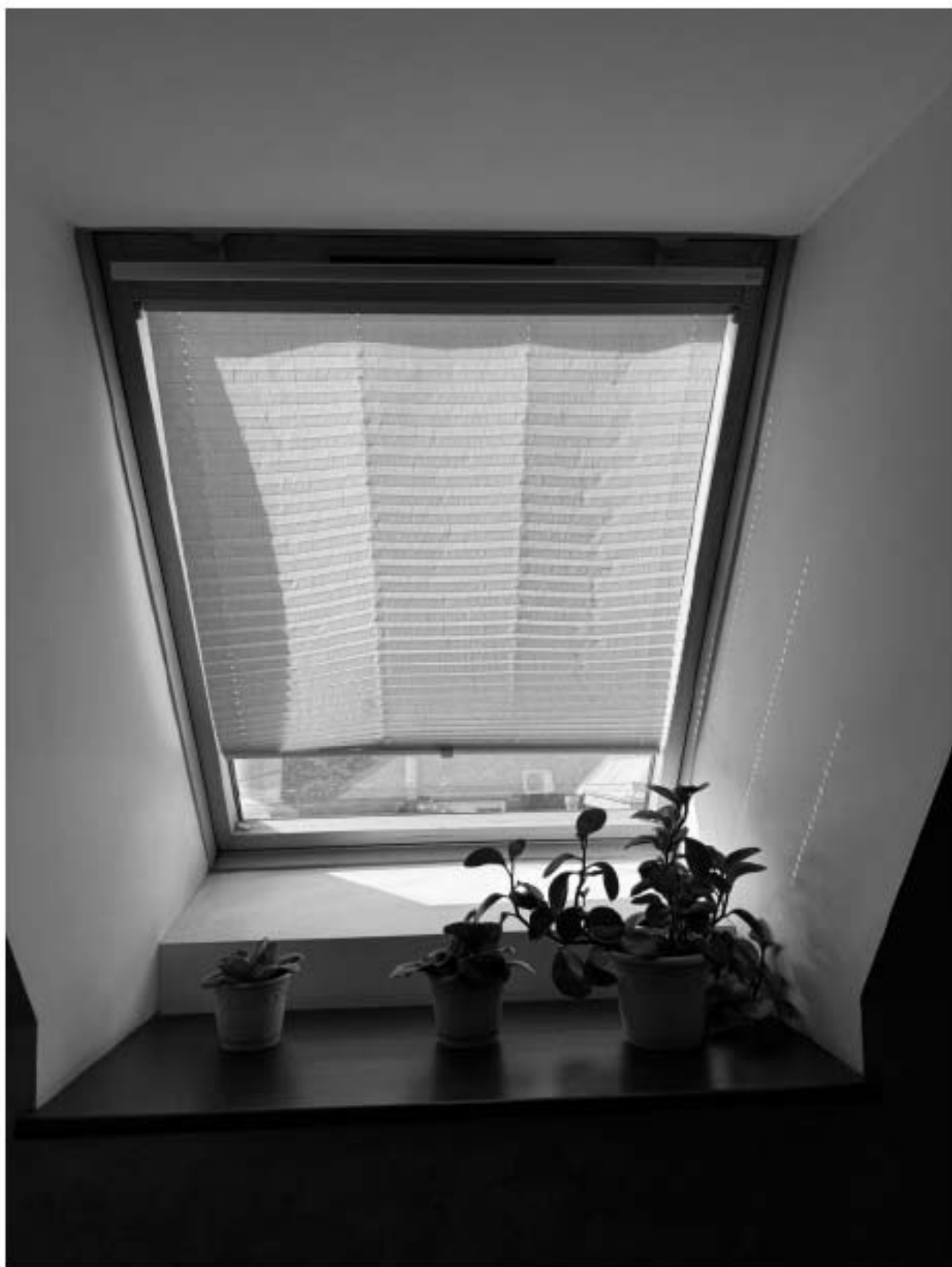
Фото 69. Вид на оконное заполнение помещения мансардного этажа объекта культурного наследия.
