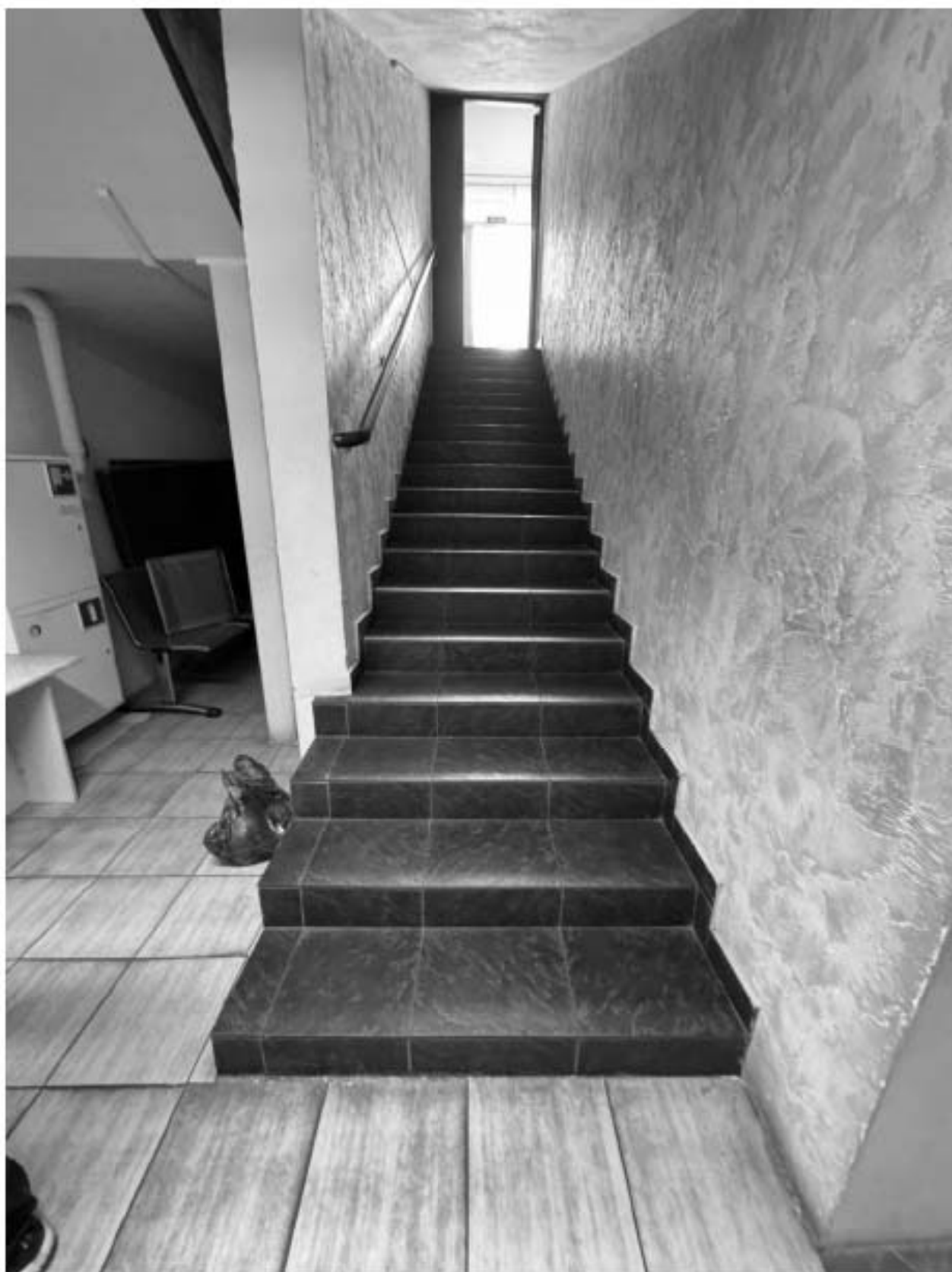
Фото 40. Вид на лестницу в части подвальных помещений объекта культурного наследия.
