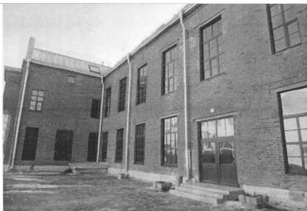
Северный фасад и южный фасад дворовых корпусов. Съемка 21.03.2012, В.А. Матвеева.
