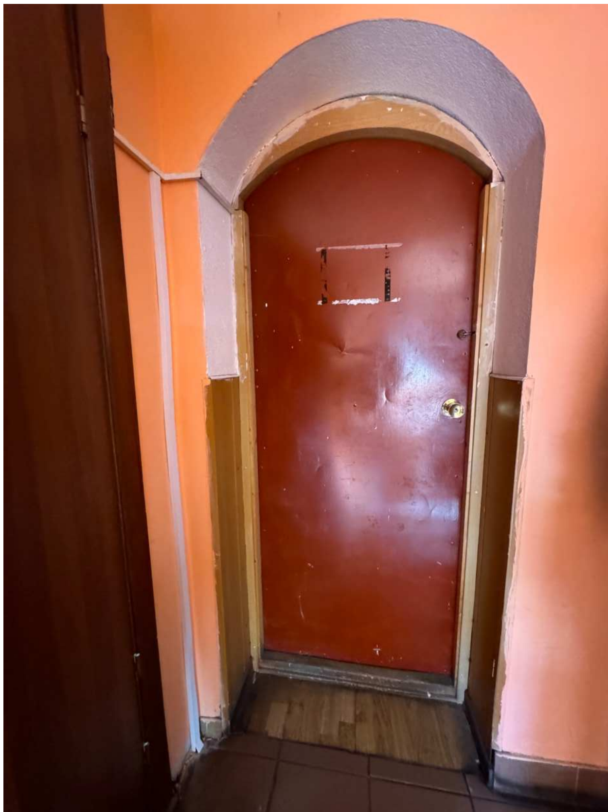
Фото 31. Вид на вход в помещения 8-Н.
