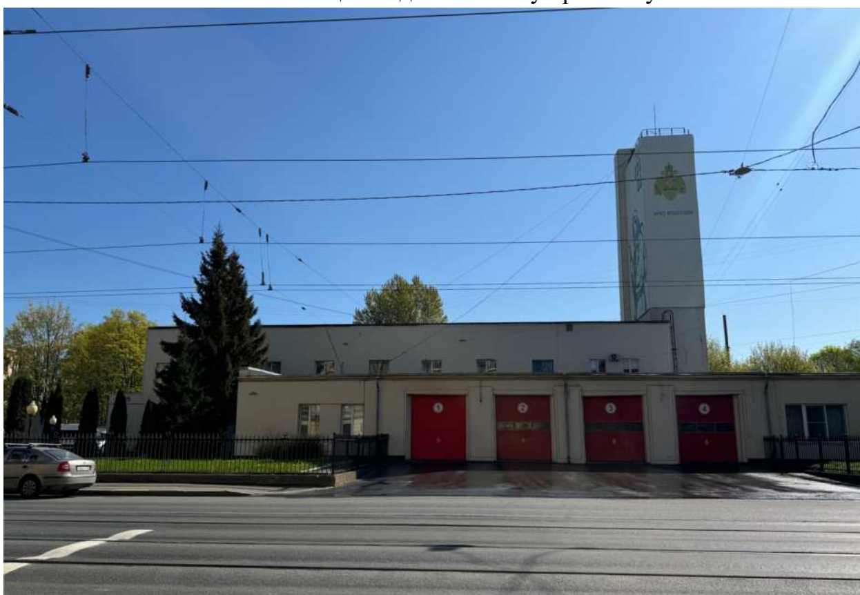
Фото 4. Фрагмент лицевого фасада с Лесного проспекта.
