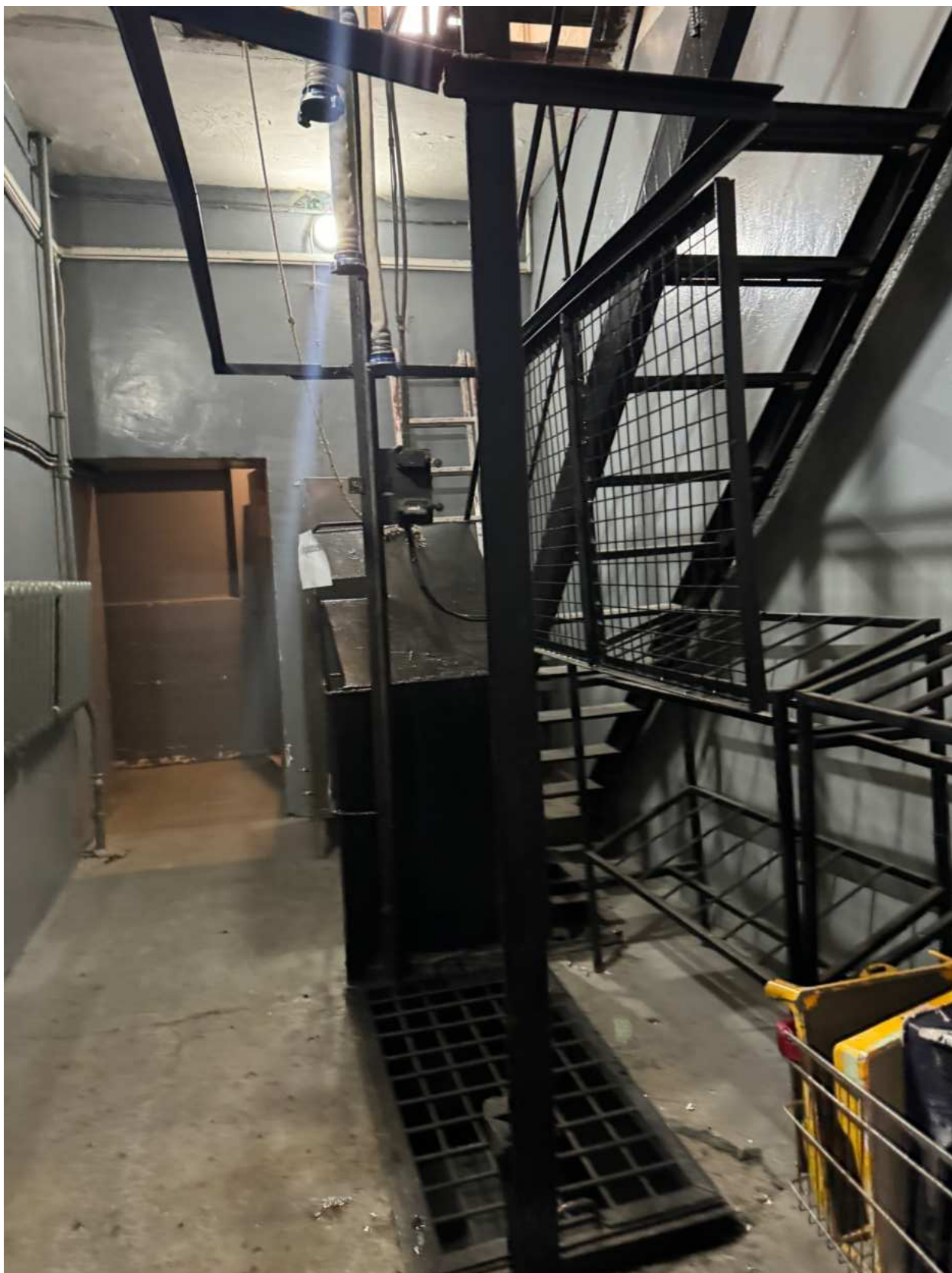
Фото 37. Вид на интерьер лестницы 2-ЛК.
