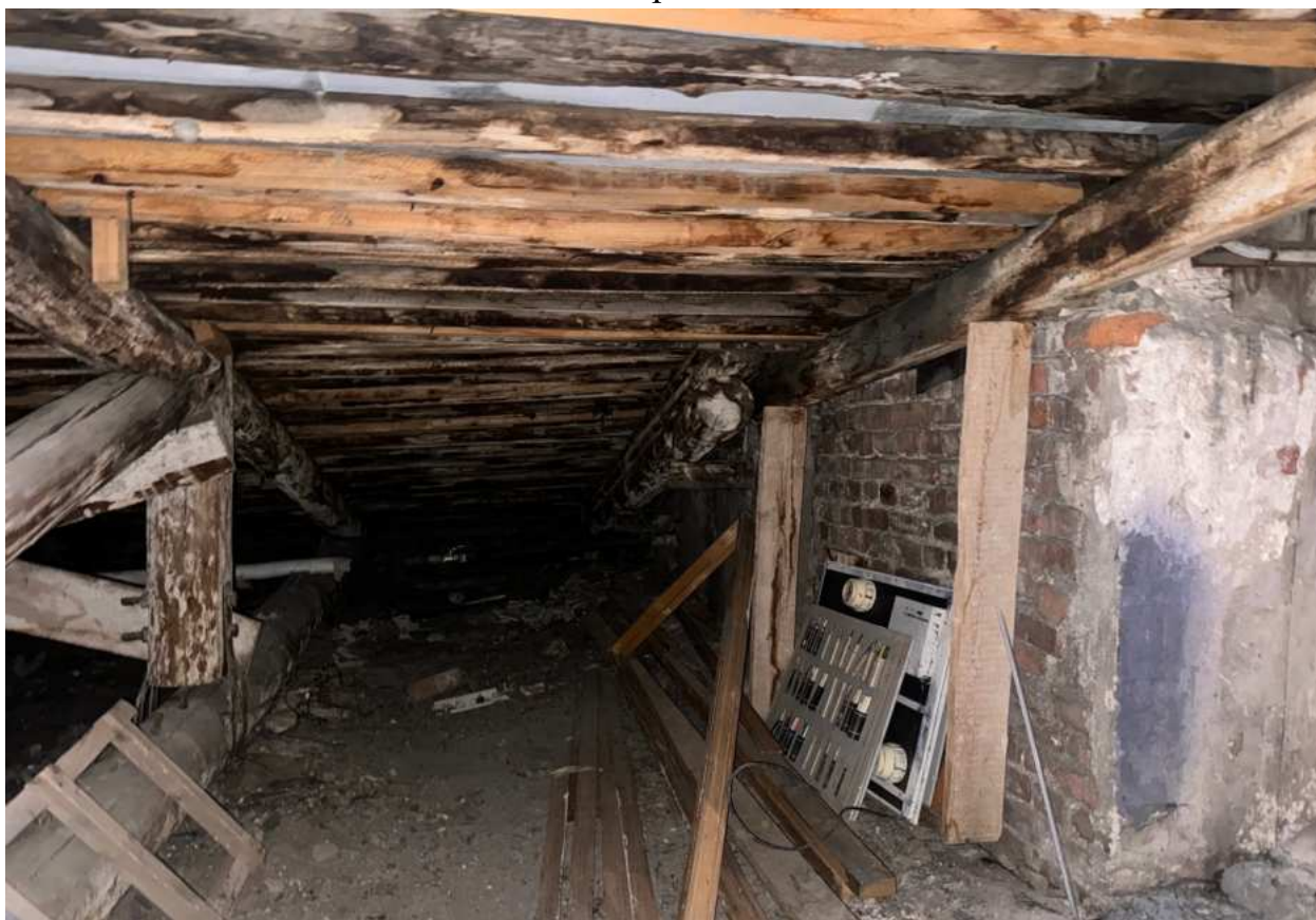
Фото 29. Вид на чердачное помещение.
