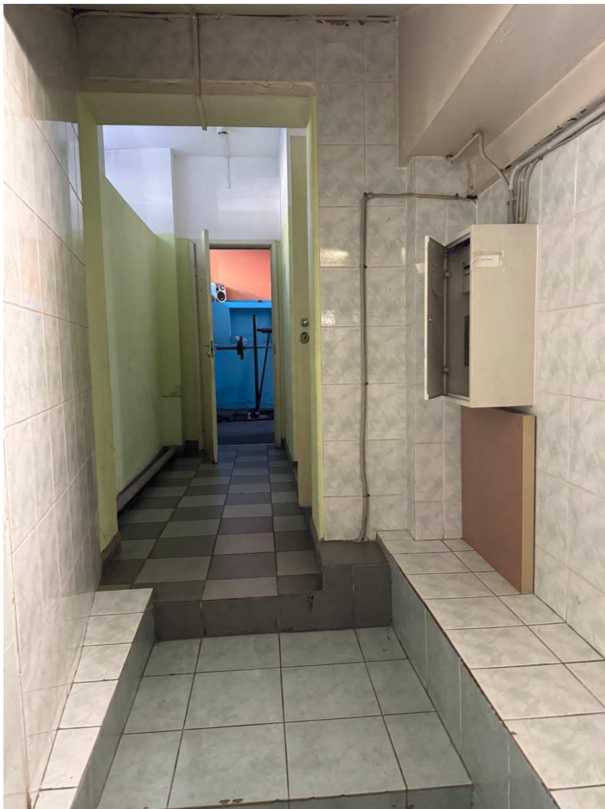
Фото 58. Вид на помещение 2-Н (1).
