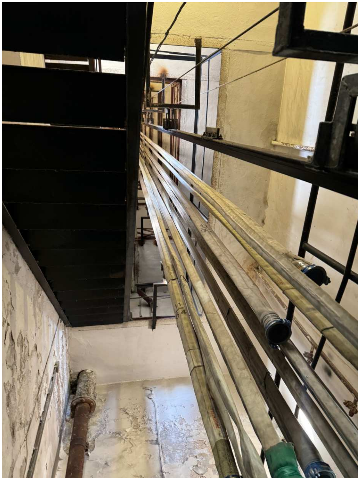
Фото 41. Вид на интерьер лестницы 2-ЛК.
