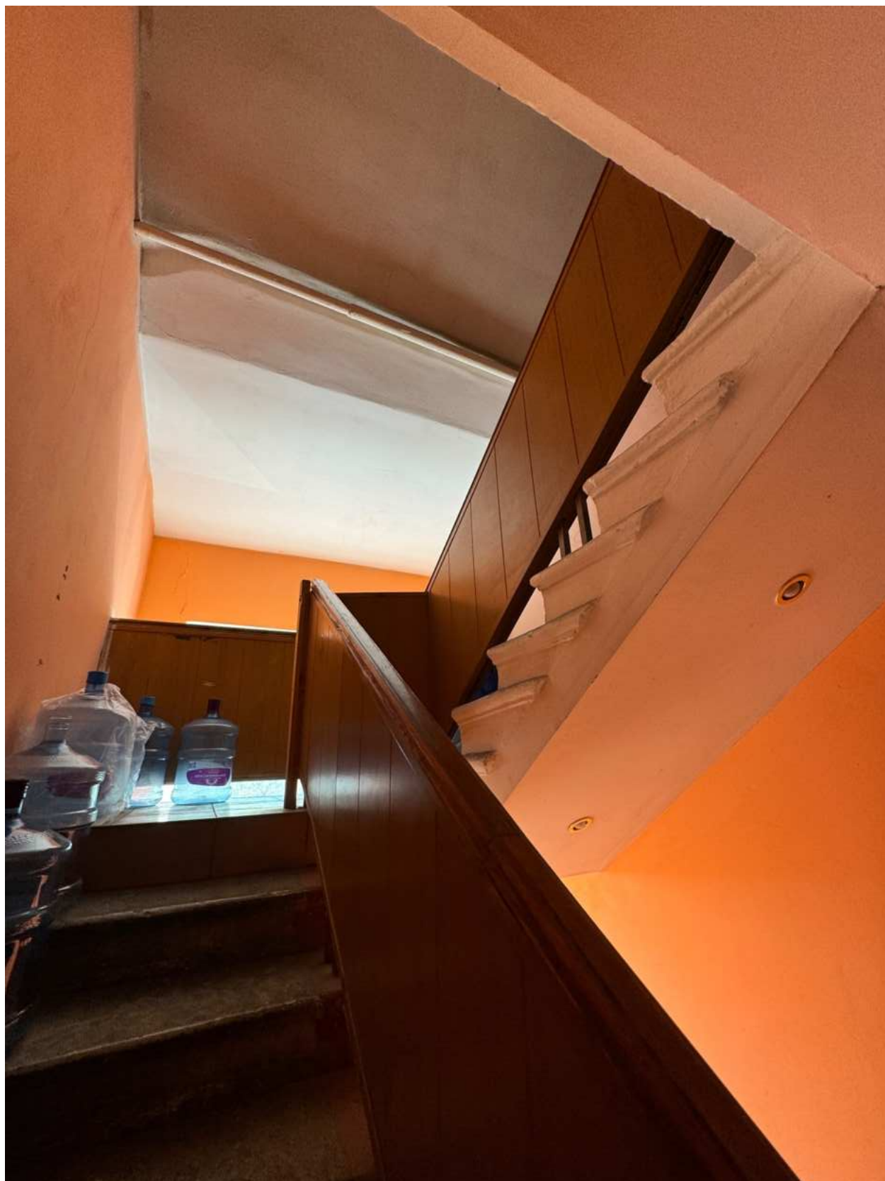
Фото 24. Помещение лестницы 1-ЛК.
