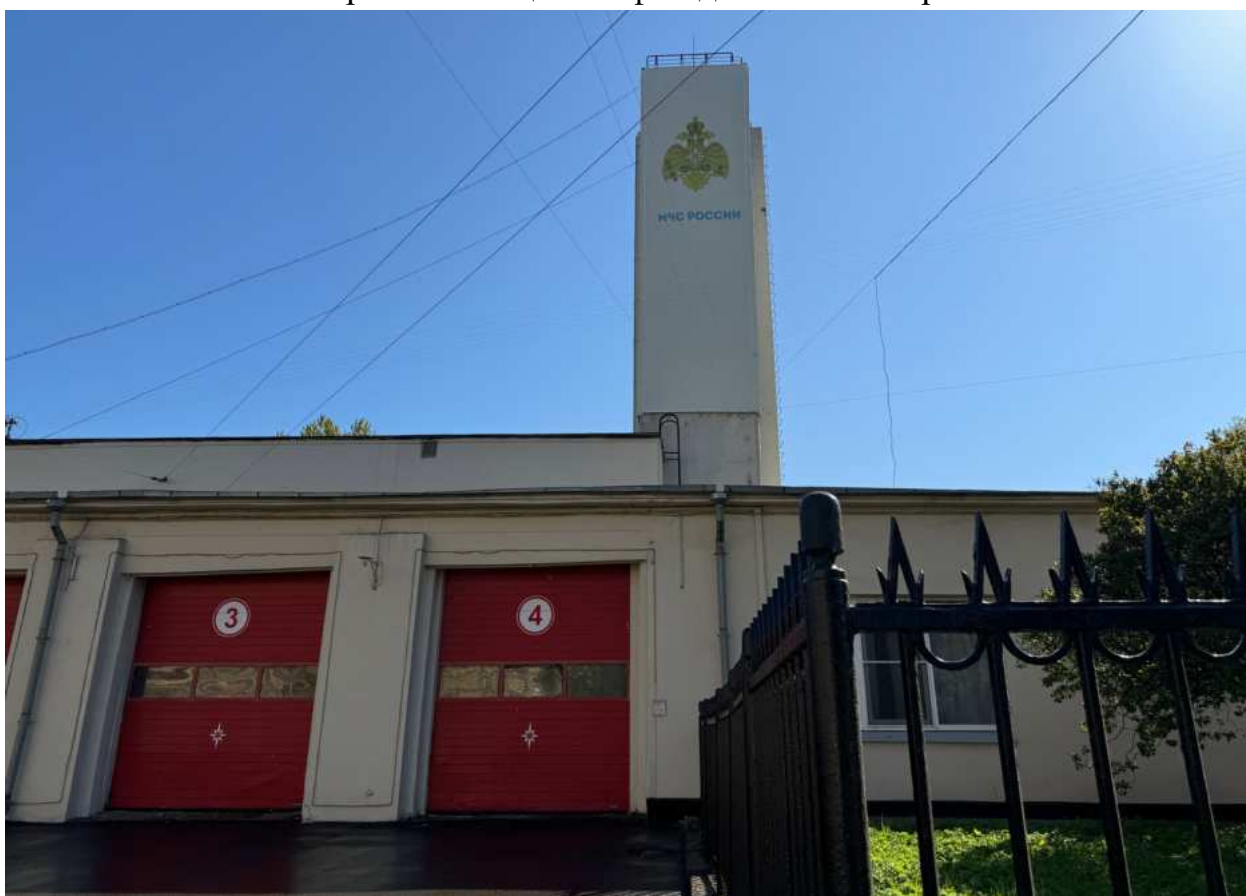
Фото 6. Фрагмент лицевого фасада с Лесного проспекта.
