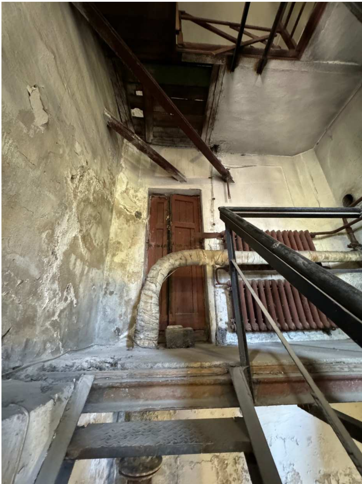
Фото 48. Вид на интерьер лестницы 2-ЛК.
