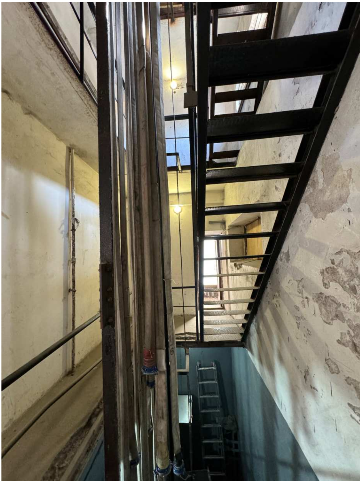
Фото 42. Вид на интерьер лестницы 2-ЛК.
