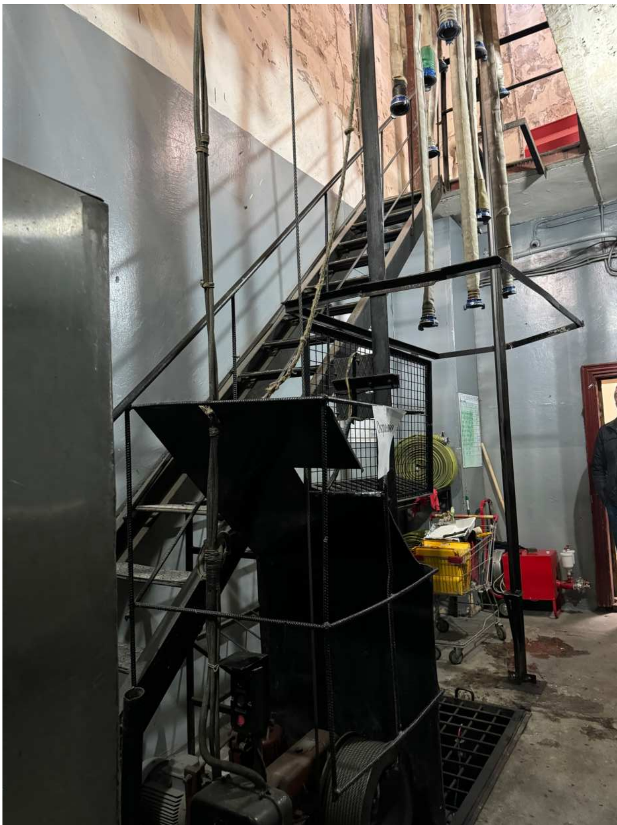
Фото 39. Вид на интерьер лестницы 2-ЛК.
