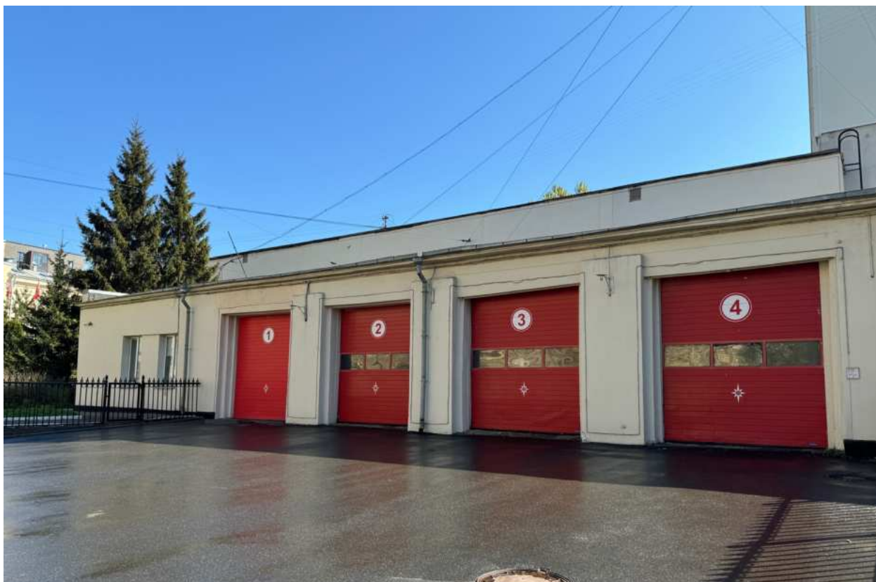
Фото 5. Фрагмент лицевого фасада с Лесного проспекта.
