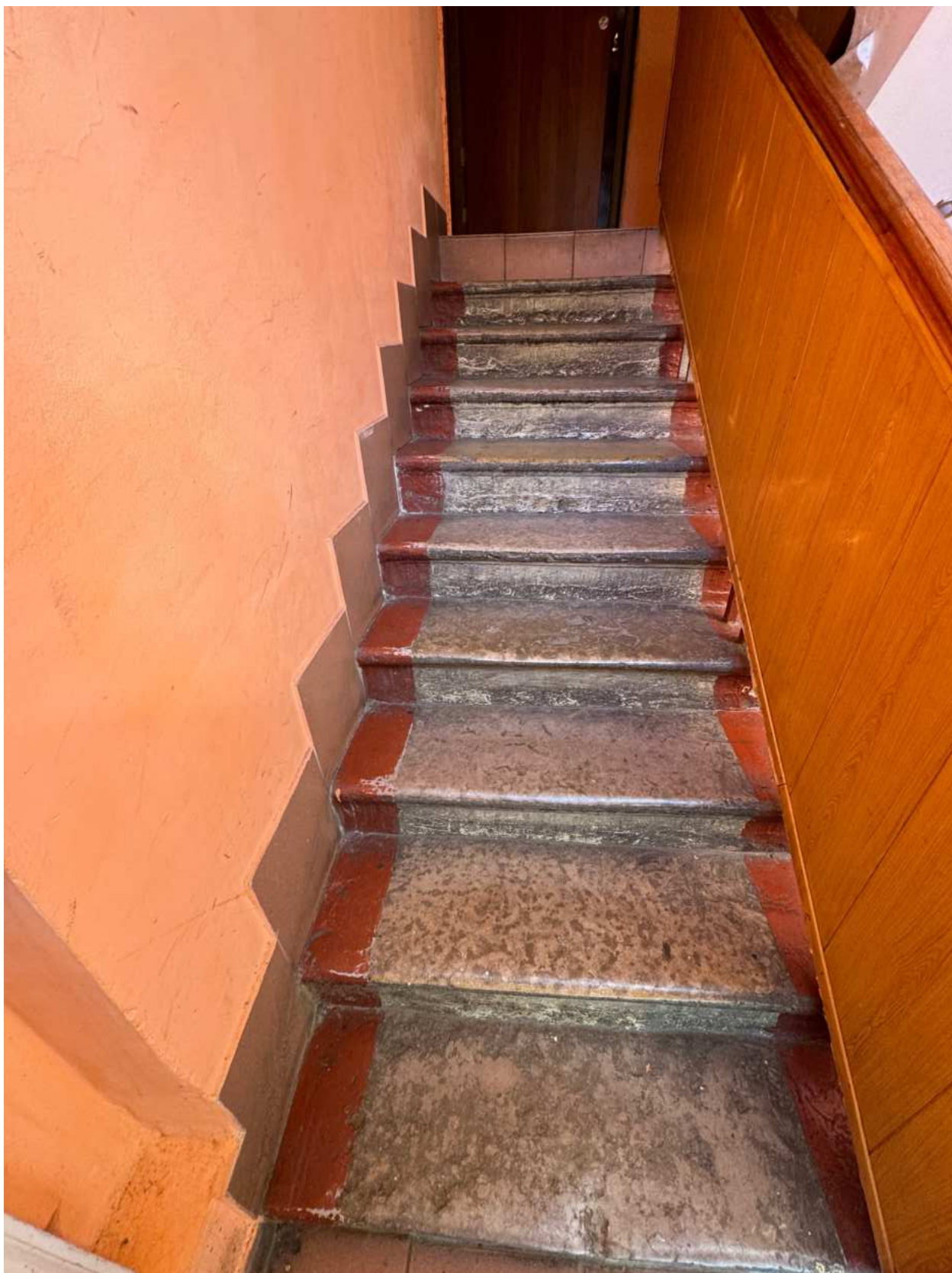
Фото 22. Помещение лестницы 1-ЛК.
