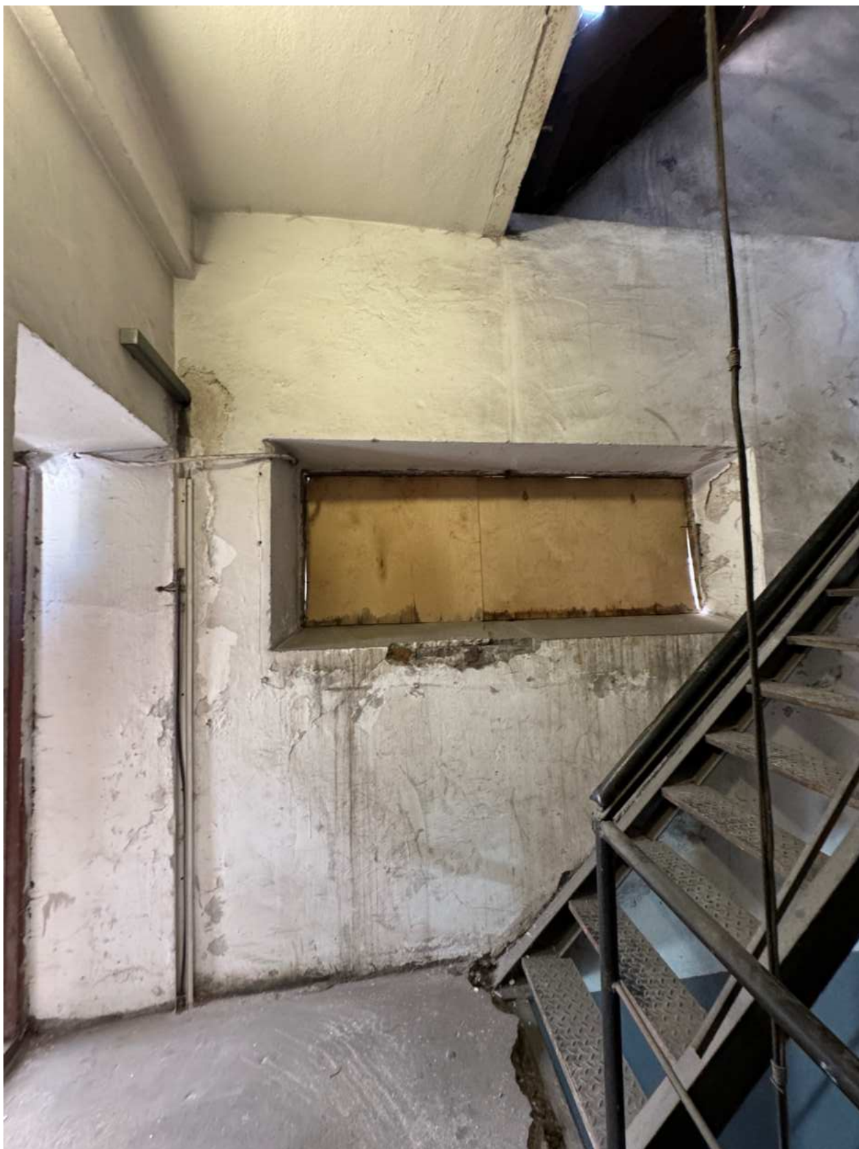
Фото 43. Вид на интерьер лестницы 2-ЛК.
