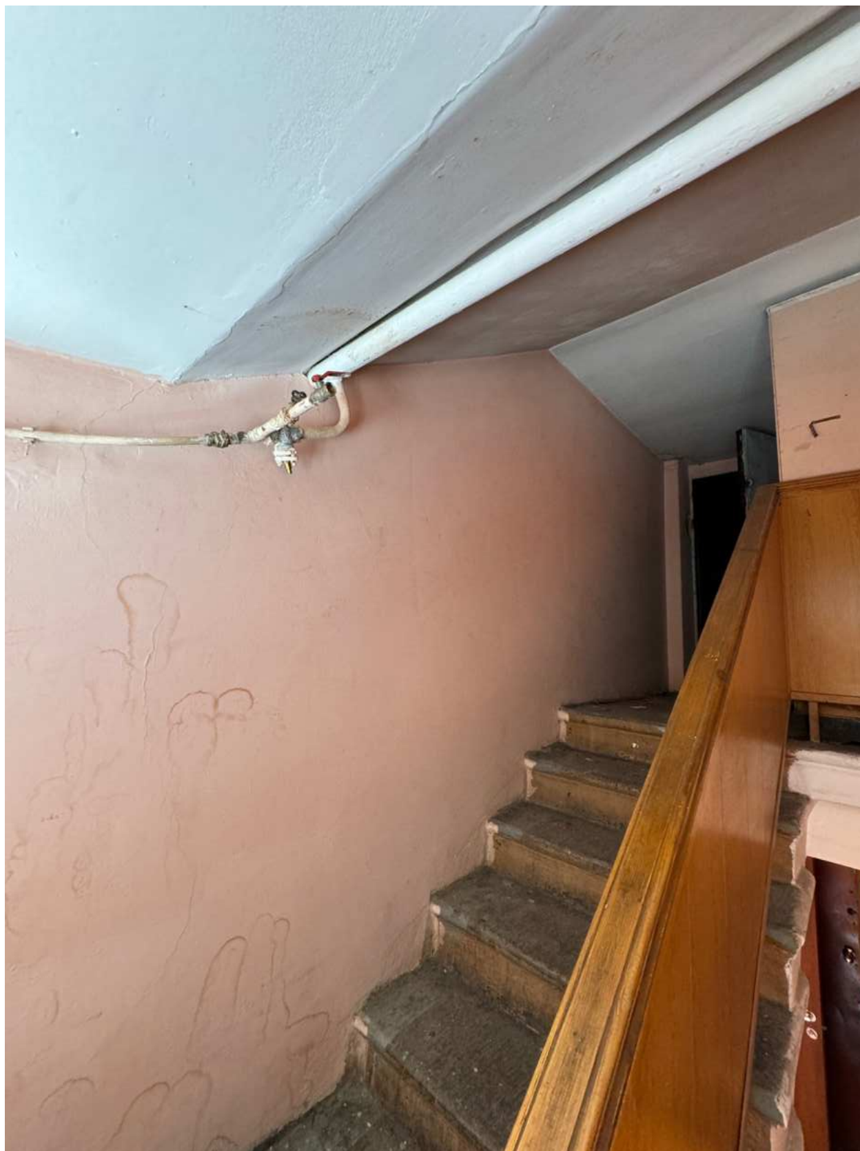
Фото 26. Помещение лестницы 1-ЛК.
