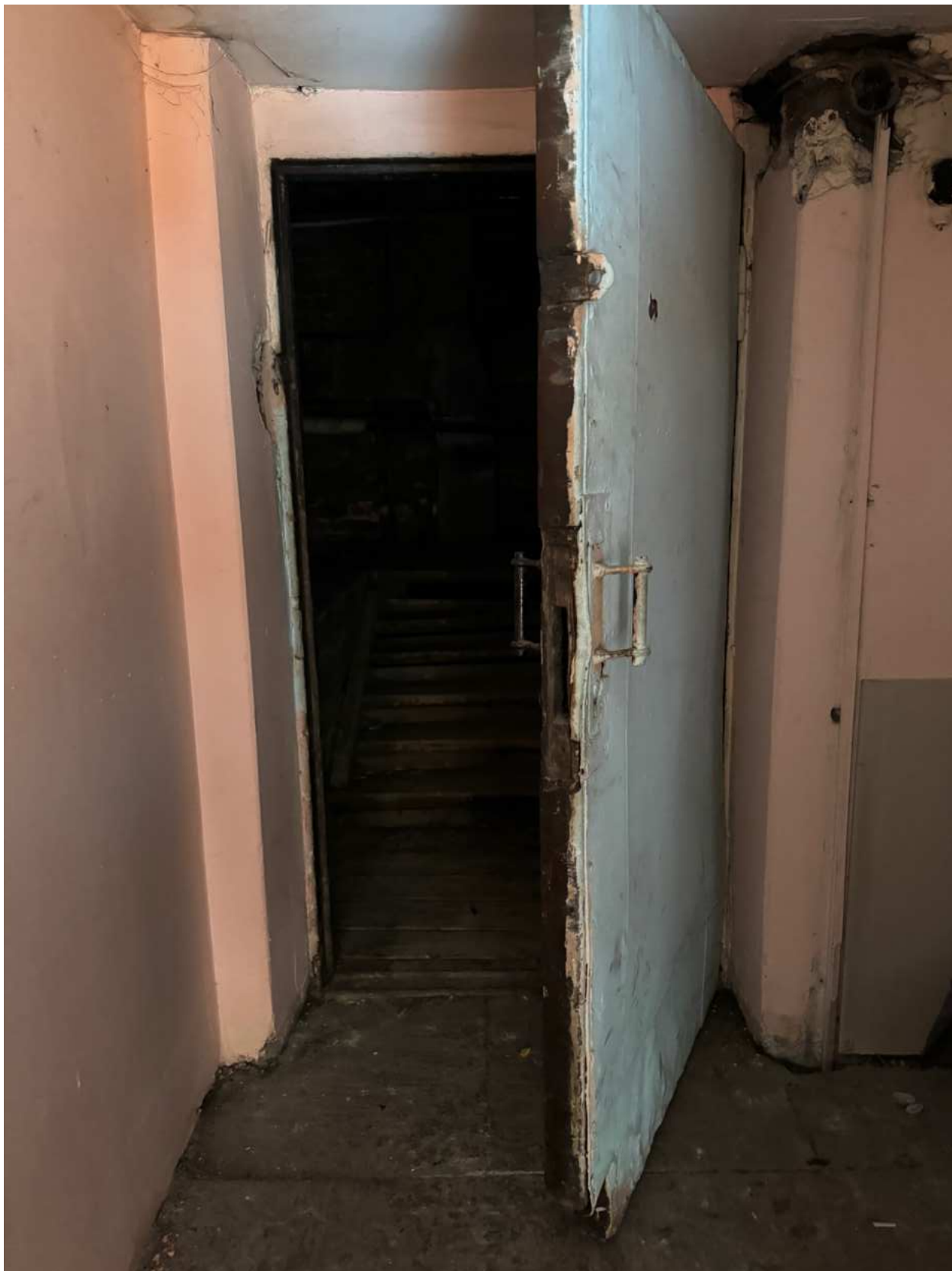
Фото 27. Вход на чердак.
