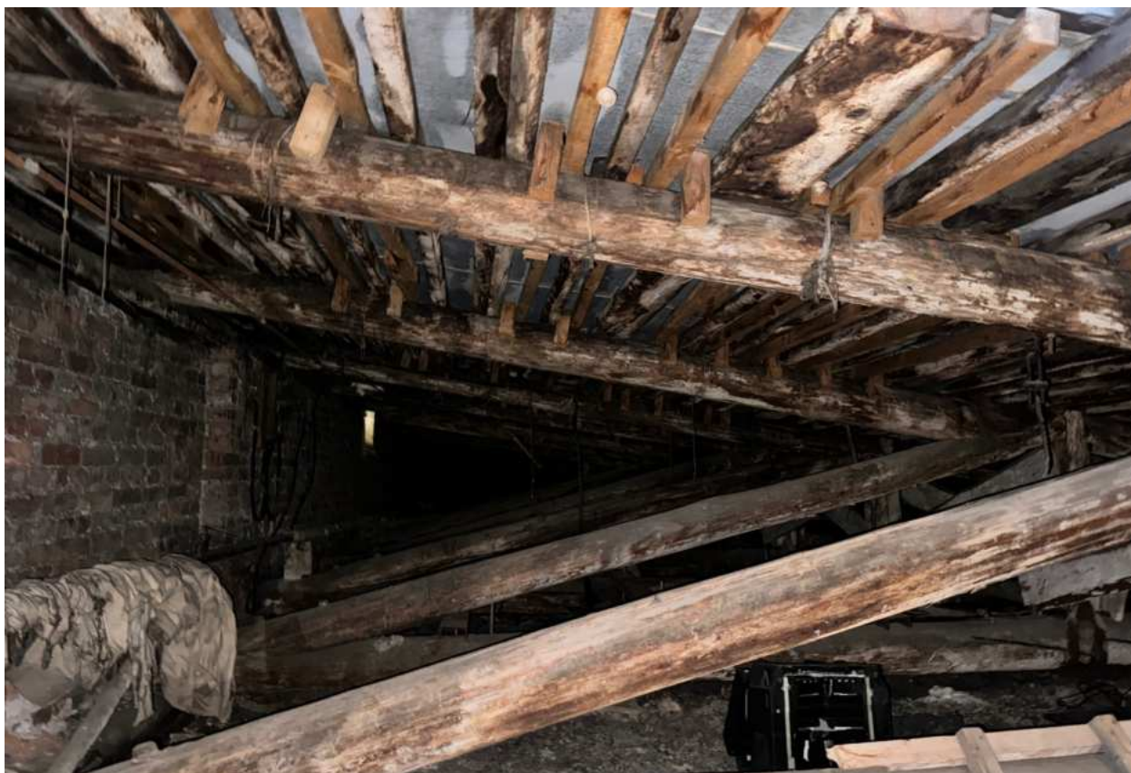
Фото 28. Вид на чердачное помещение.
