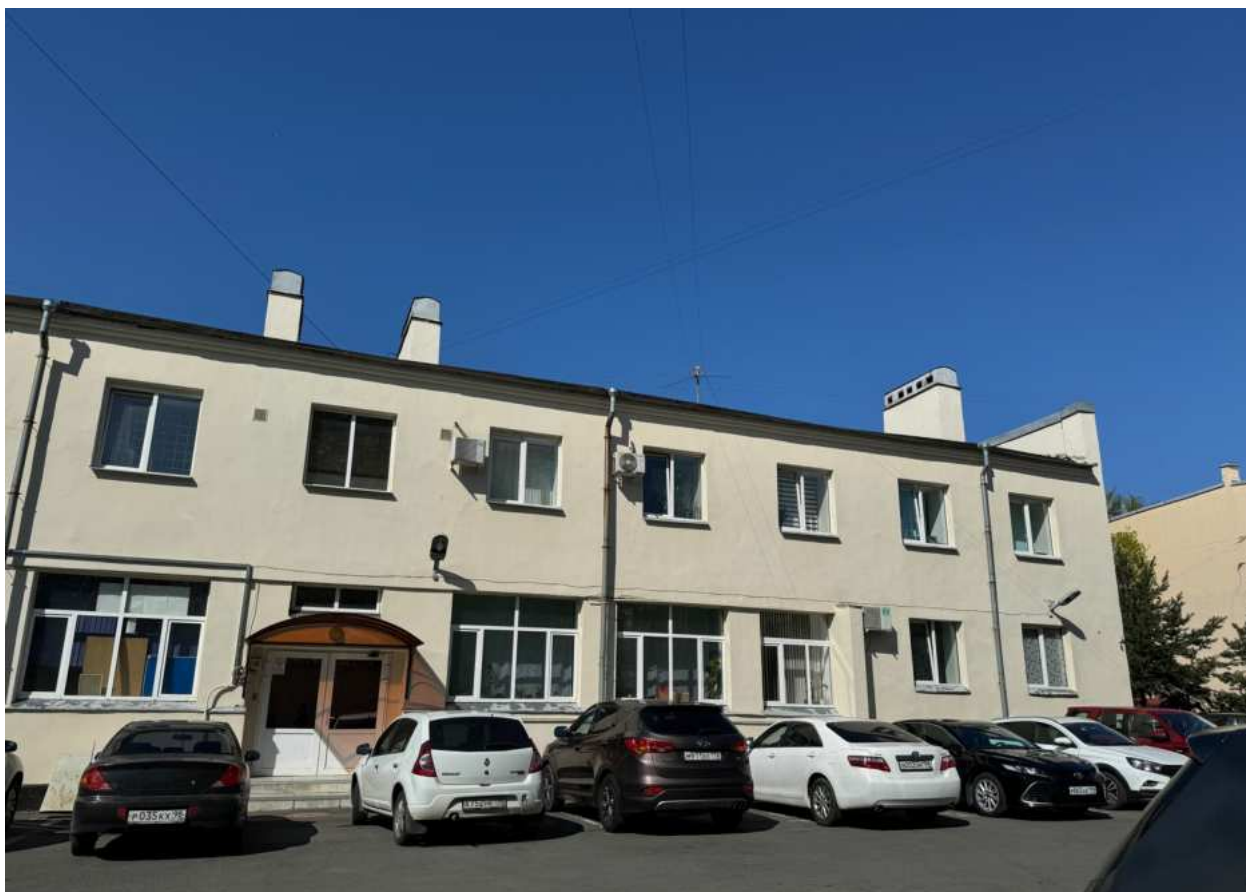
Фото 8. Фрагмент восточного дворового фасада.
