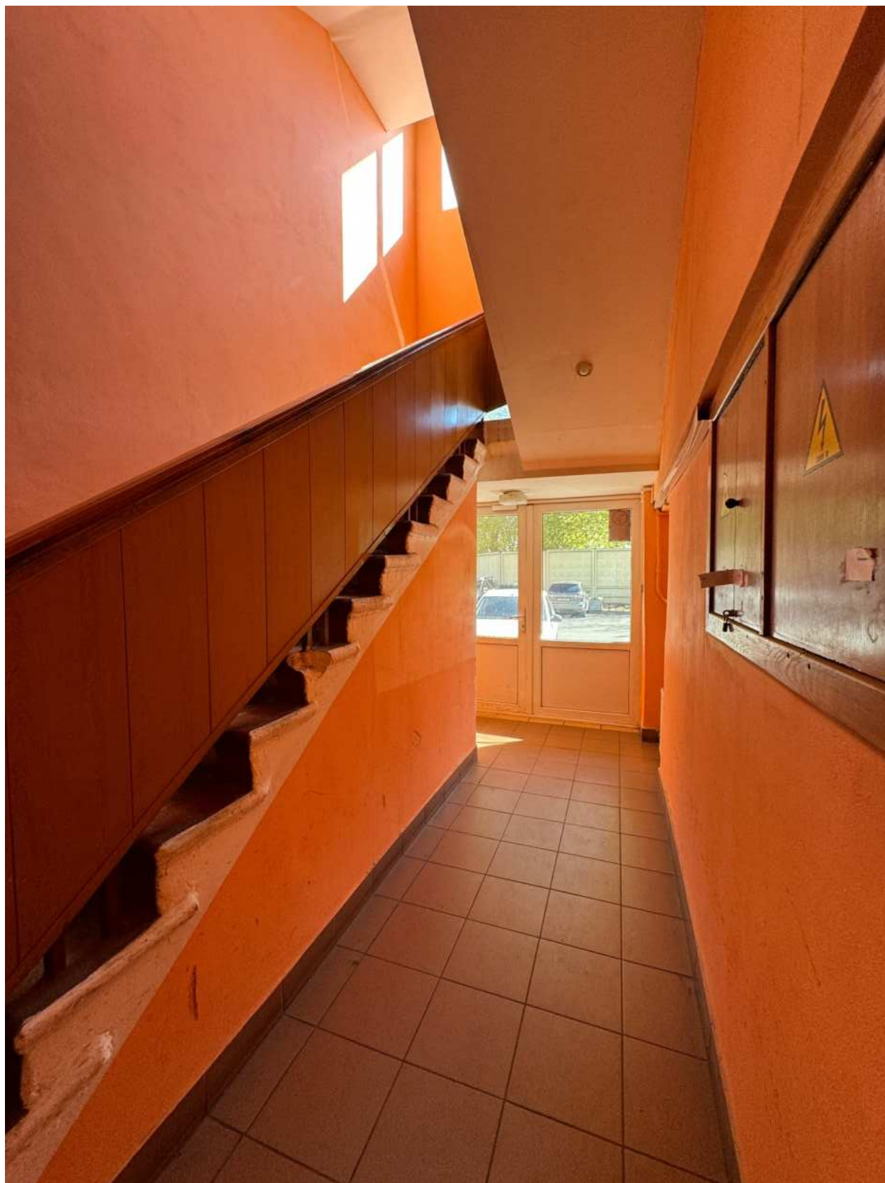
Фото 21. Помещение лестницы 1-ЛК.
