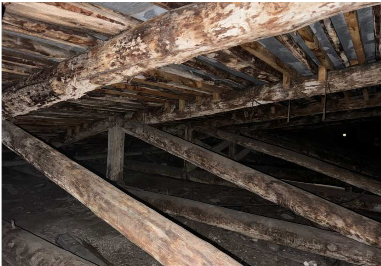
Фото 30. Вид на чердачное помещение.
