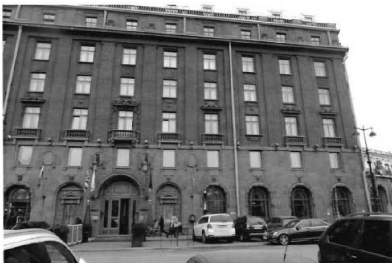
4. Фрагмент западного фасада.
