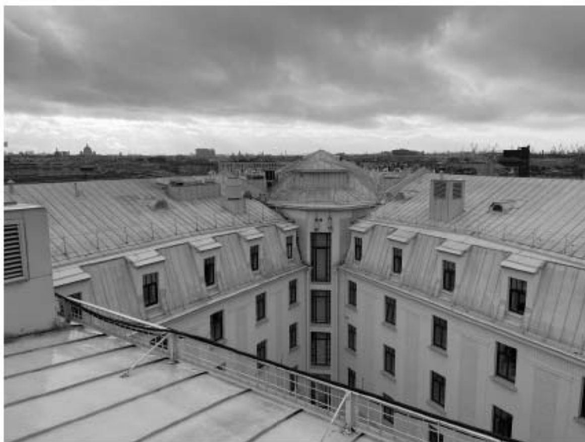
Фото 7. Вид на крышу объекта культурного наследия федерального значения «Гостиница «Астория»
