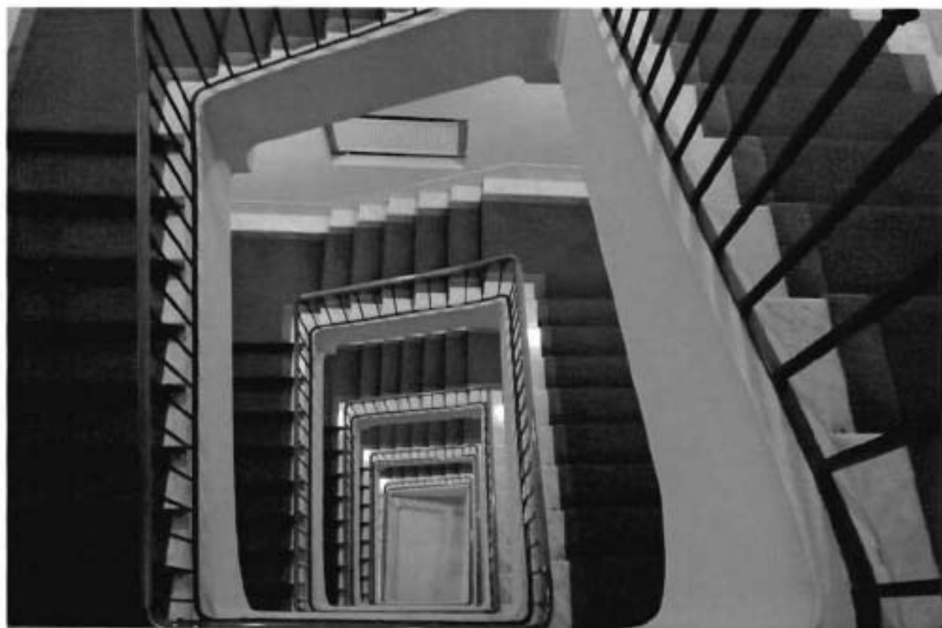
35. Лестница в юго-восточной части здания. Вид сверху.
