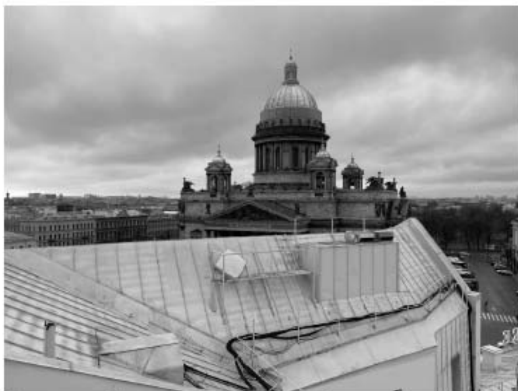
Фото 1. Вид на крышу объекта культурного наследия федерального значения «Гостиница «Астория»
