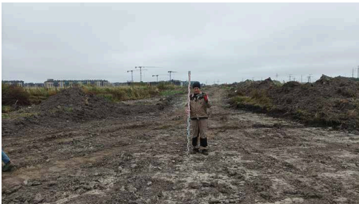
Рис. 37. Кокколевская ул.-2025, КН:78:42:1850206:4326; 4328; 8349. Точка фотофиксации 7, вид с запада.
