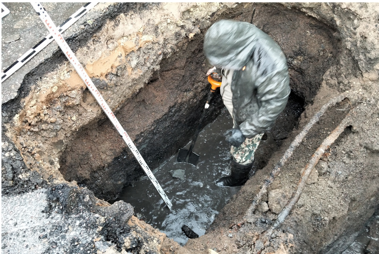
Рис. 30. Санкт-Петербург, Кузнецовская улица, дом 52, корпус 18, литера С, земельный участок с кадастровым номером: 78:14:0007622:5. Шурф 1. Прокопка материка. Рабочий момент. Вид с ЮВ.
