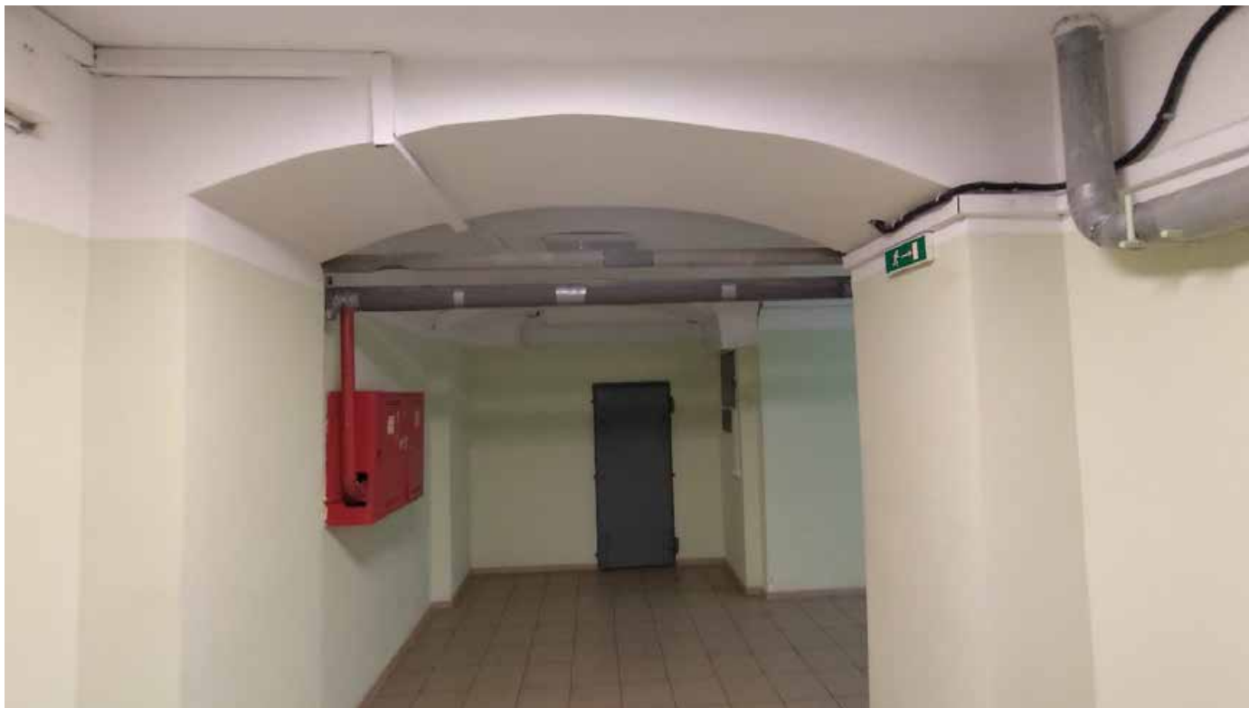
Фото 106. Помещение 1 (ЗЛК). Фрагмент. Дата фотофиксации: 07.10.25.
