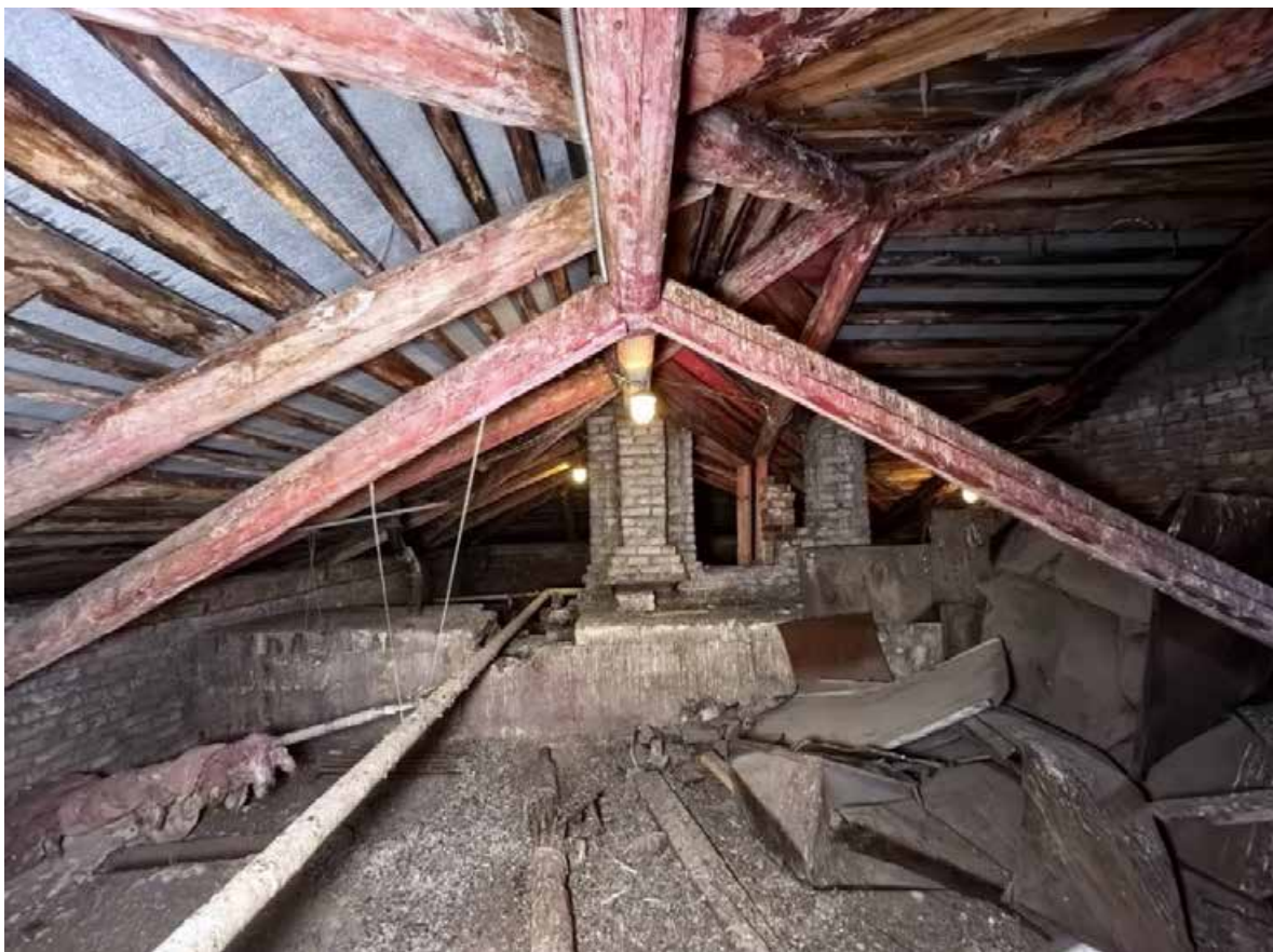
Фото 55. Стропила чердака административного здания. Фрагмент. Дата фотофиксации: 07.10.25.
