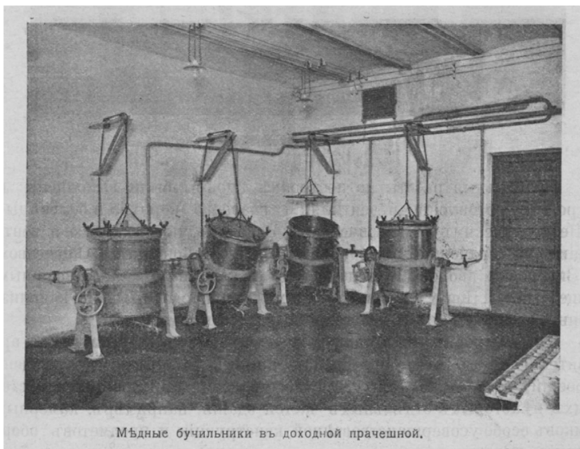
30. Фотография. Медные бучильники в доходной прачечной. 1912 г.
