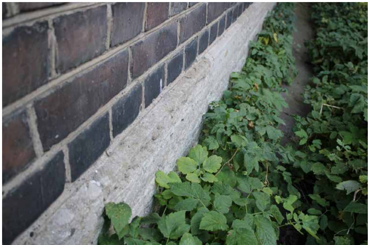
Фото 39. Материал отделки цоколя северо-западного фасада – известняк. Фрагмент. Дата фотофиксации: 07.10.25.
