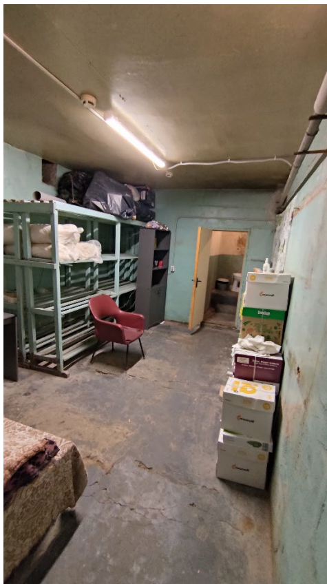
Фото 112. Помещение 23 (4-Н). Общий вид. Дата фотофиксации: 07.10.25.
