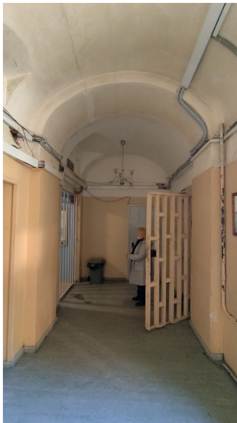
Фото 92. Объёмы помещений 44 и 43 (9-Н). Фрагмент. Дата фотофиксации: 07.10.25.
