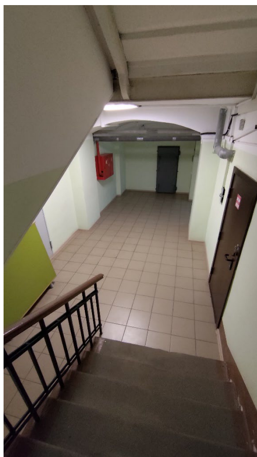
Фото 105. Помещение 1 (ЗЛК). Общий вид. Дата фотофиксации: 07.10.25.
