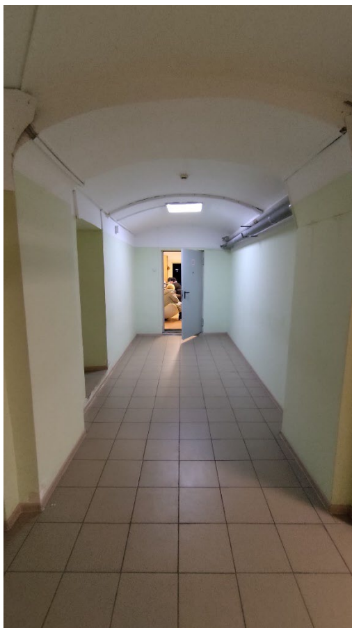
Фото 107. Помещение 15 (4-Н). Общий вид. Дата фотофиксации: 07.10.25.
