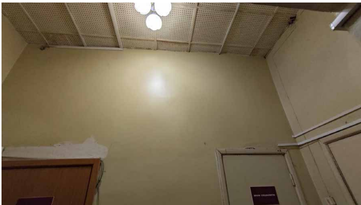
Фото 85. Помещение 24 (9-Н). Фрагмент. Дата фотофиксации: 07.10.25.
