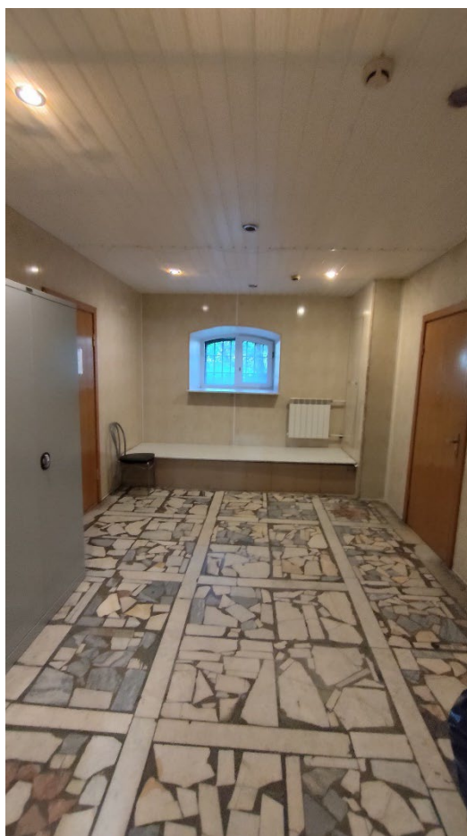
Фото 121. Помещение 13 (4-Н). Общий вид. Дата фотофиксации: 07.10.25.
