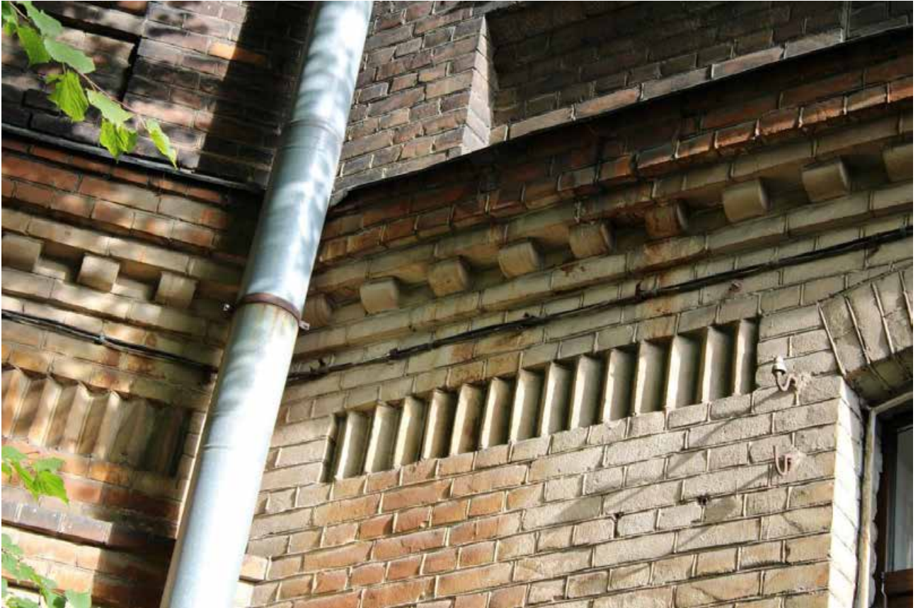
Фото 5. Межэтажный карниз. Фрагмент. Дата фотофиксации: 07.10.25.
