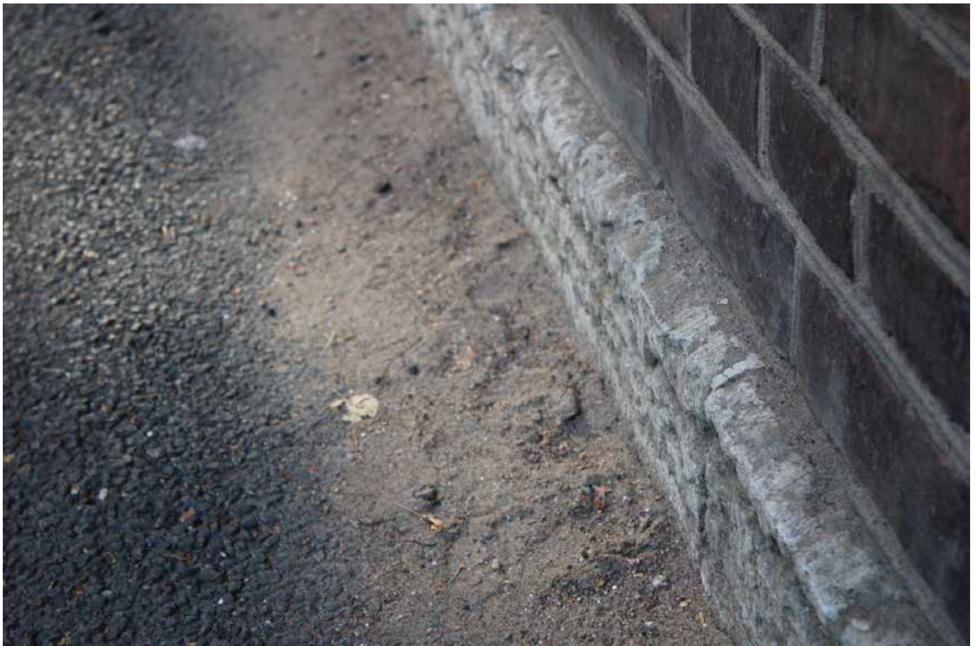
Фото 12. Материал отделки цоколя – известняк. Фрагмент. Дата фотофиксации: 07.10.25.
