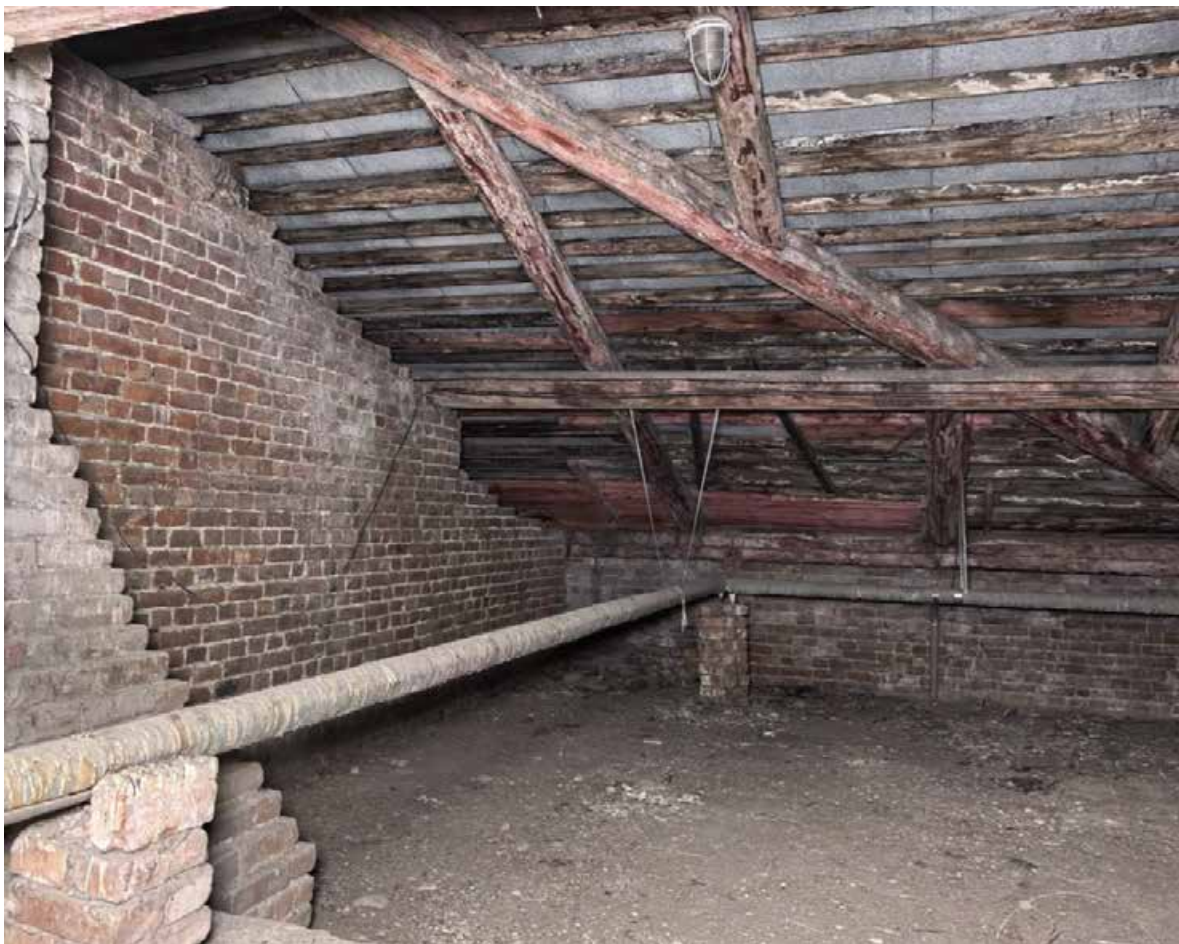
Фото 54. Объем чердака административного здания. Фрагмент. Дата фотофиксации: 07.10.25.
