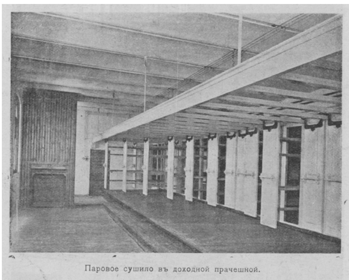
32. Фотография. Паровое сушило в доходной прачечной. 1912 г.
