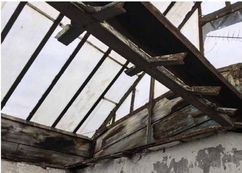
Фото 52. Фрагмент металлических конструкций оранжереи. Фрагмент. Дата фотофиксации: 07.10.25.
