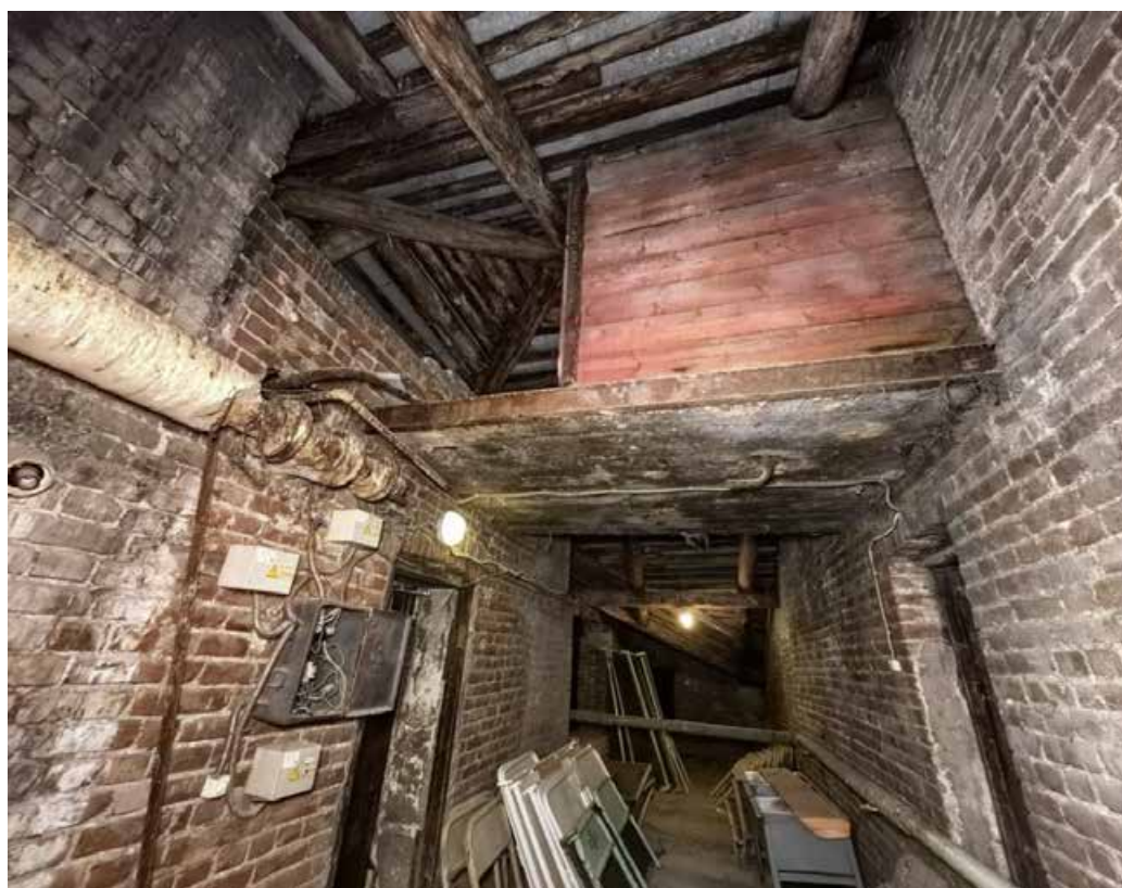
Фото 53. Объем чердака административного здания. Фрагмент. Дата фотофиксации: 07.10.25.
