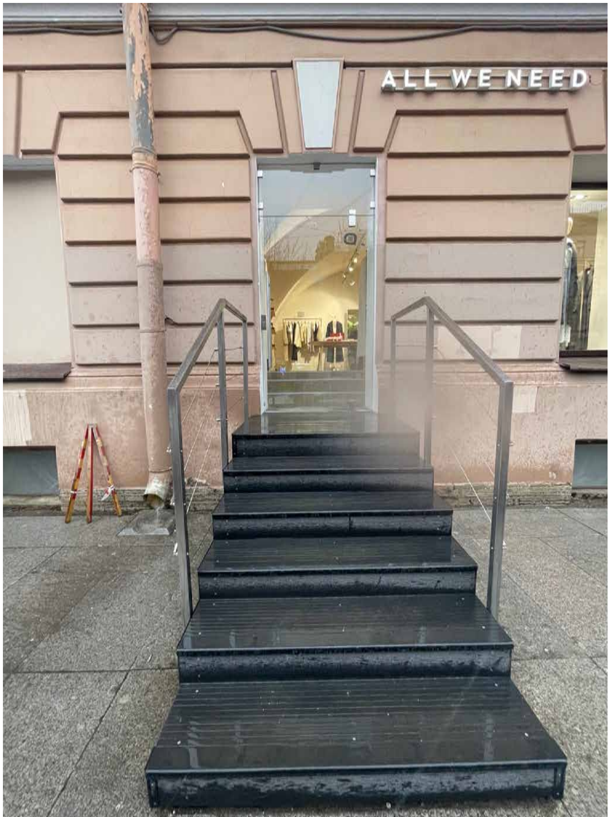
3. Вид на входную дверь в помещение 30-Н;
