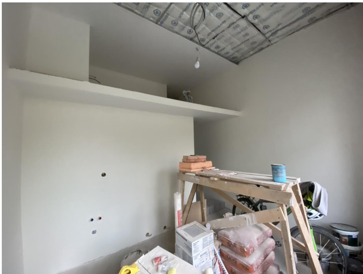
Фото.18. Вид на помещение № 7 со стороны оконных проемов.
