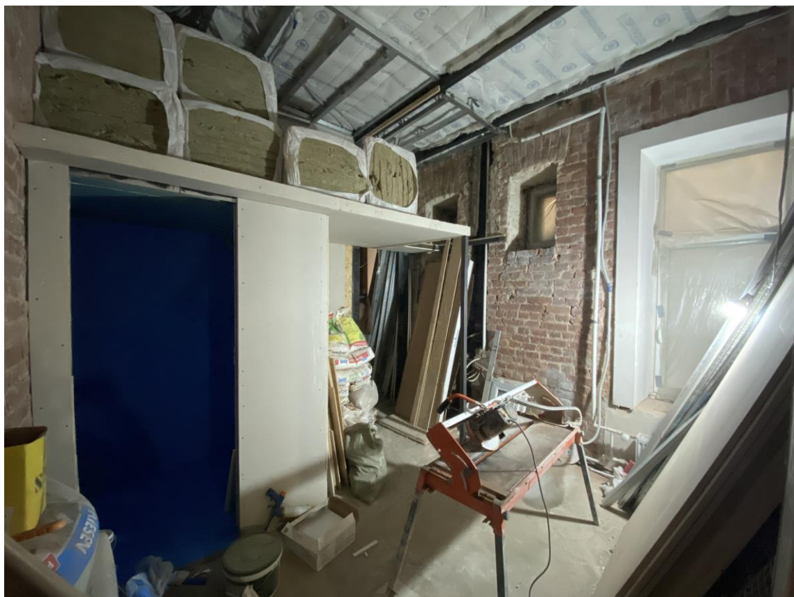
Фото.29. Вид на помещение № 20 со стороны входной двери.
