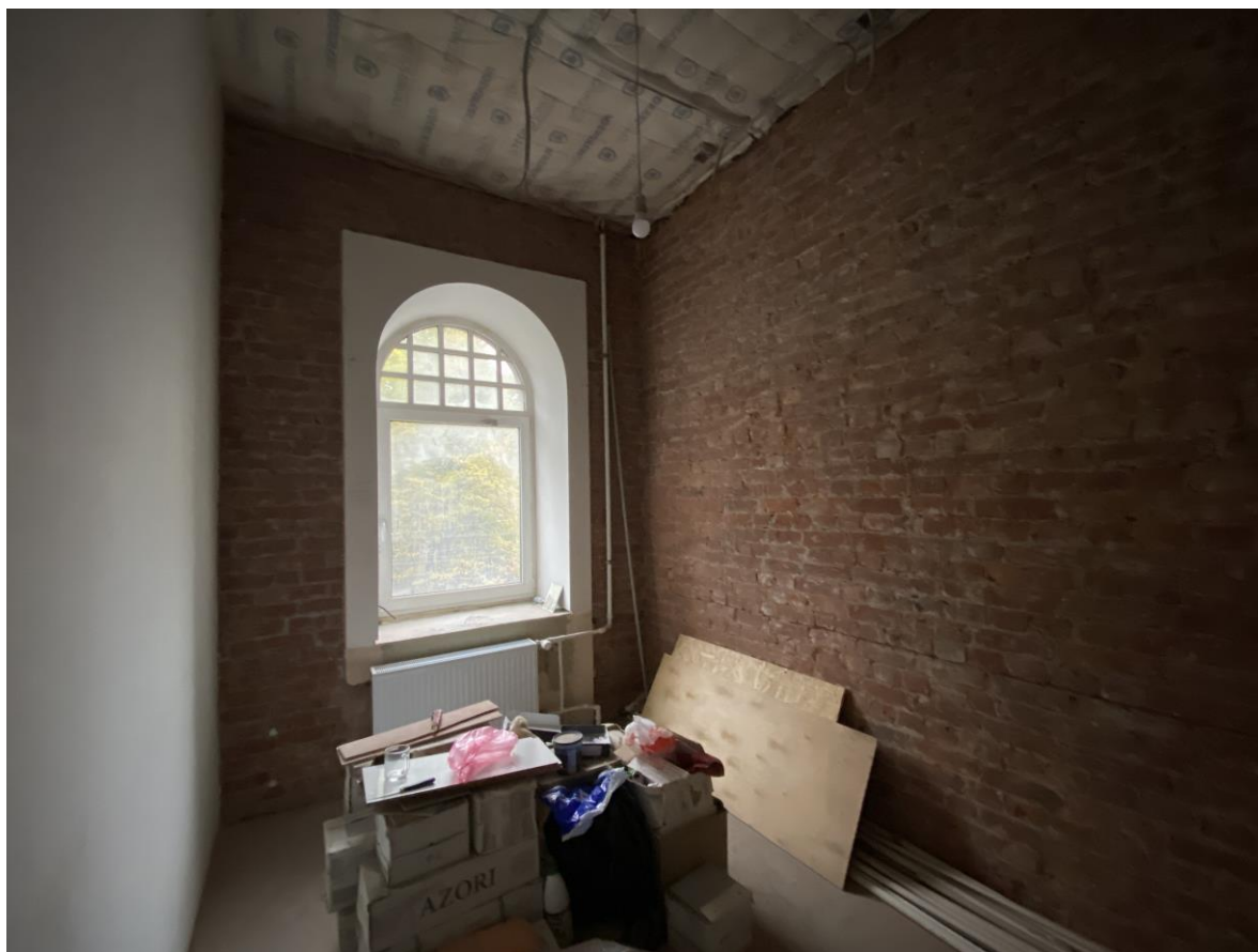
Фото.42. Вид на помещение № 15 со стороны входной двери.
