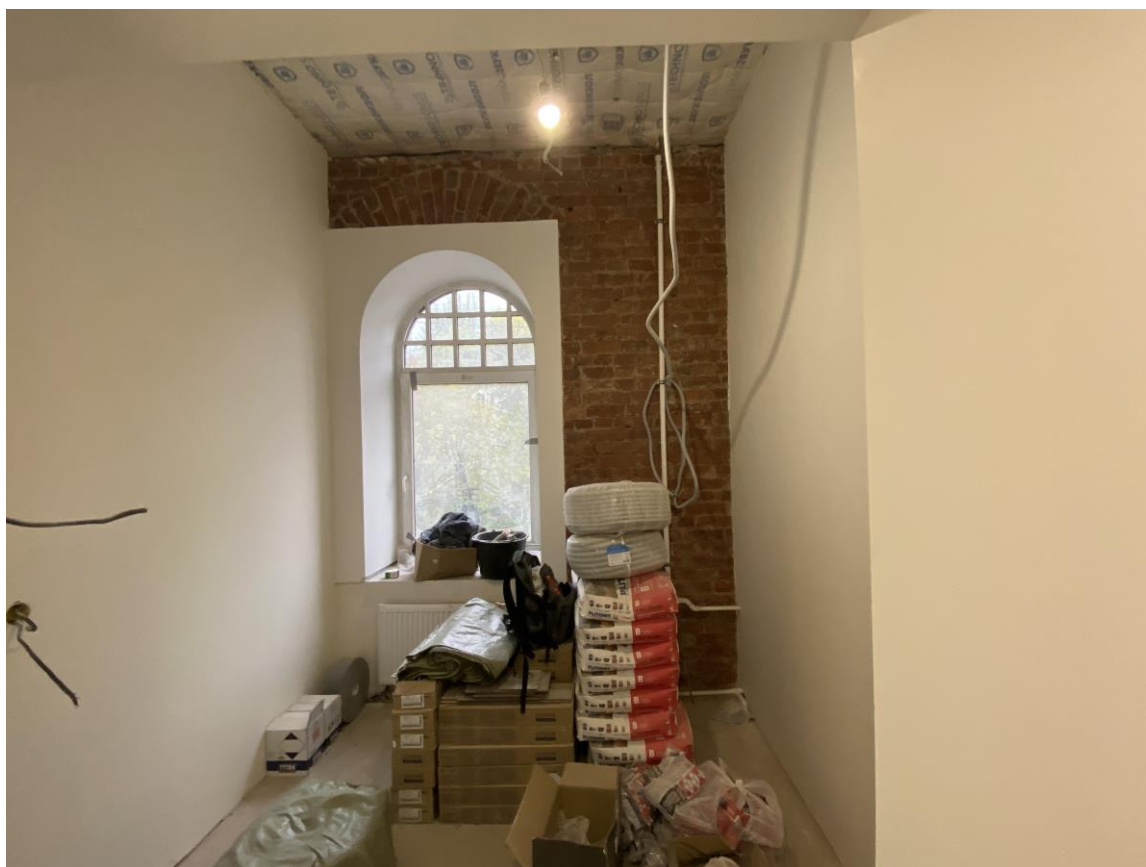
Фото.37. Вид на помещение № 11 со стороны входной двери.
