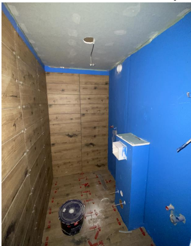
Фото.21. Вид на помещение № 8.
