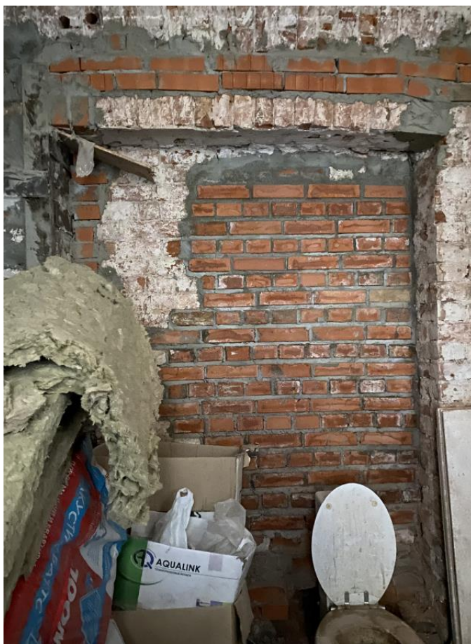
Фото.34. Вид на нишу в помещении № 18.
