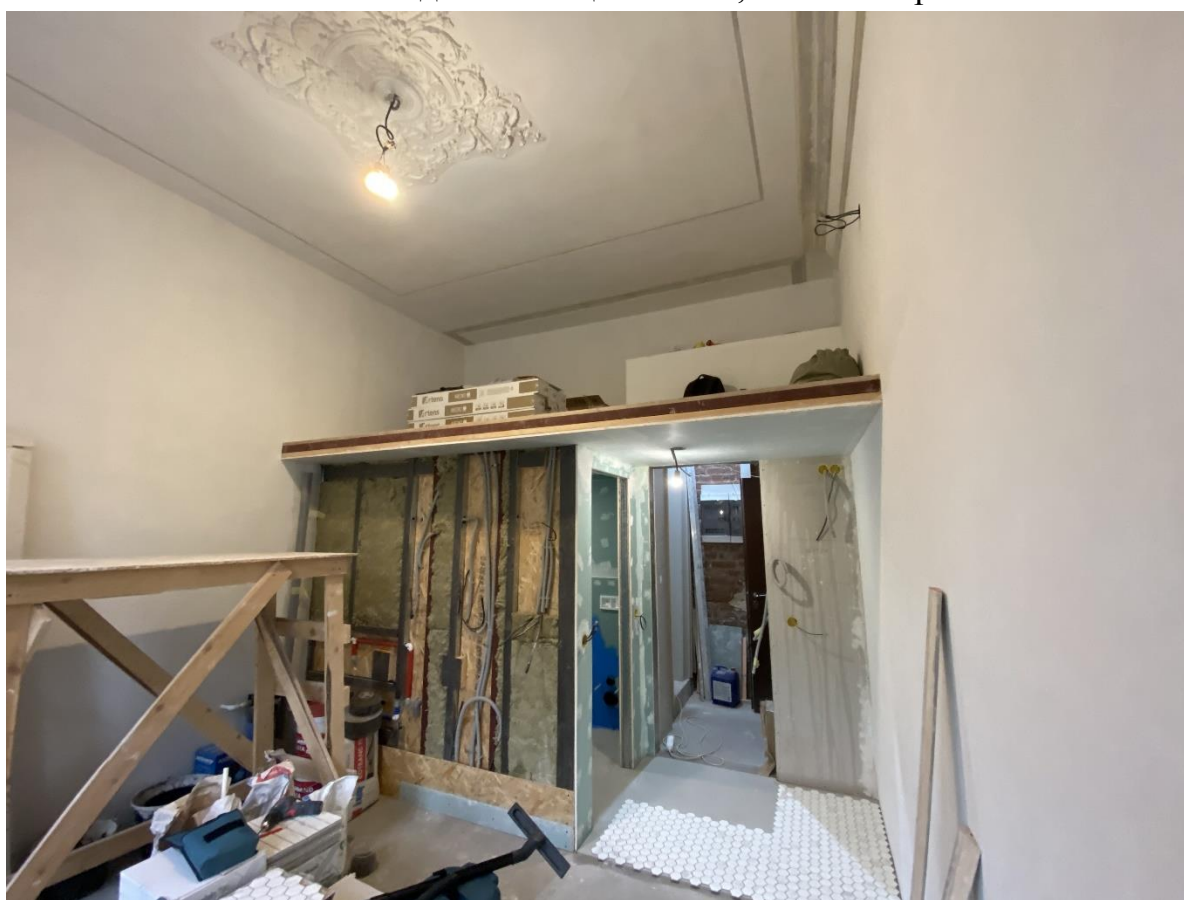
Фото.14. Вид на помещение № 5 со стороны оконных проемов.
