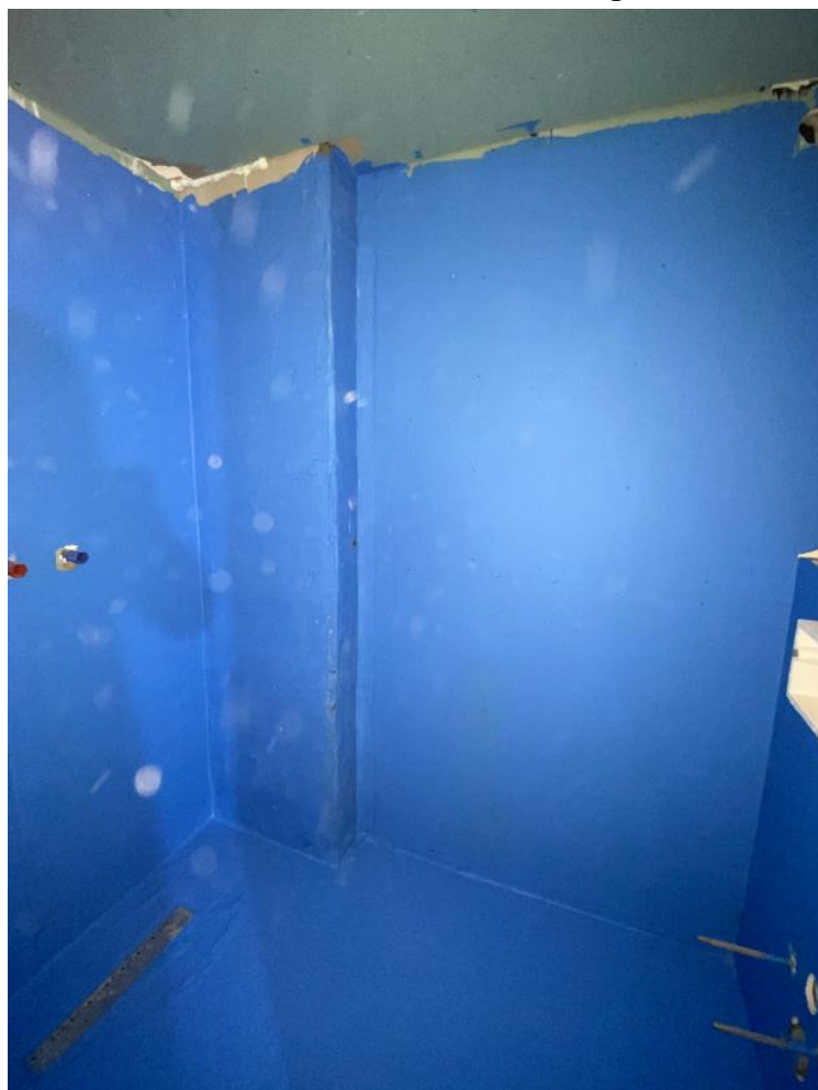
Фото.30. Вид на помещение № 19.
