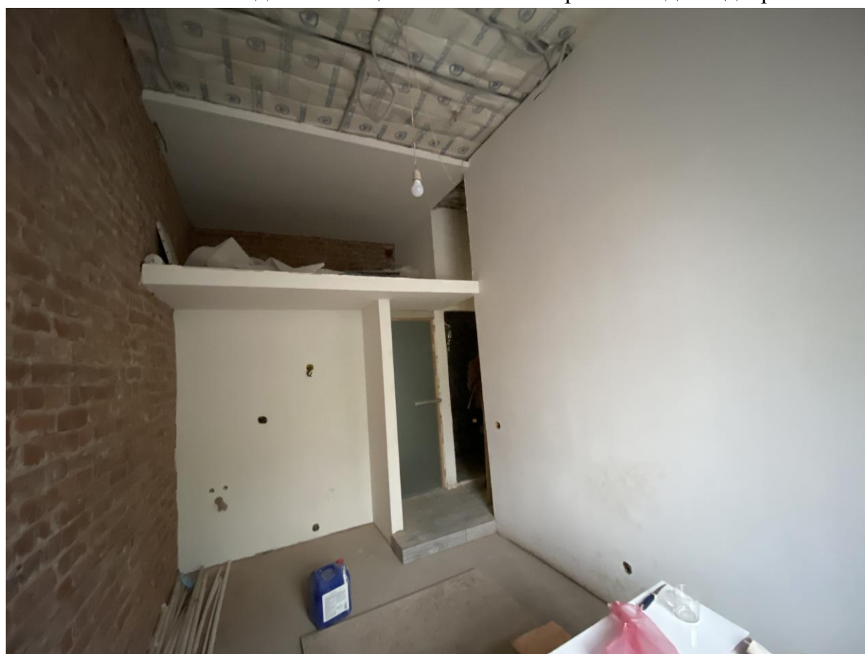
Фото.43. Вид на помещение № 15 со оконных проемов.
