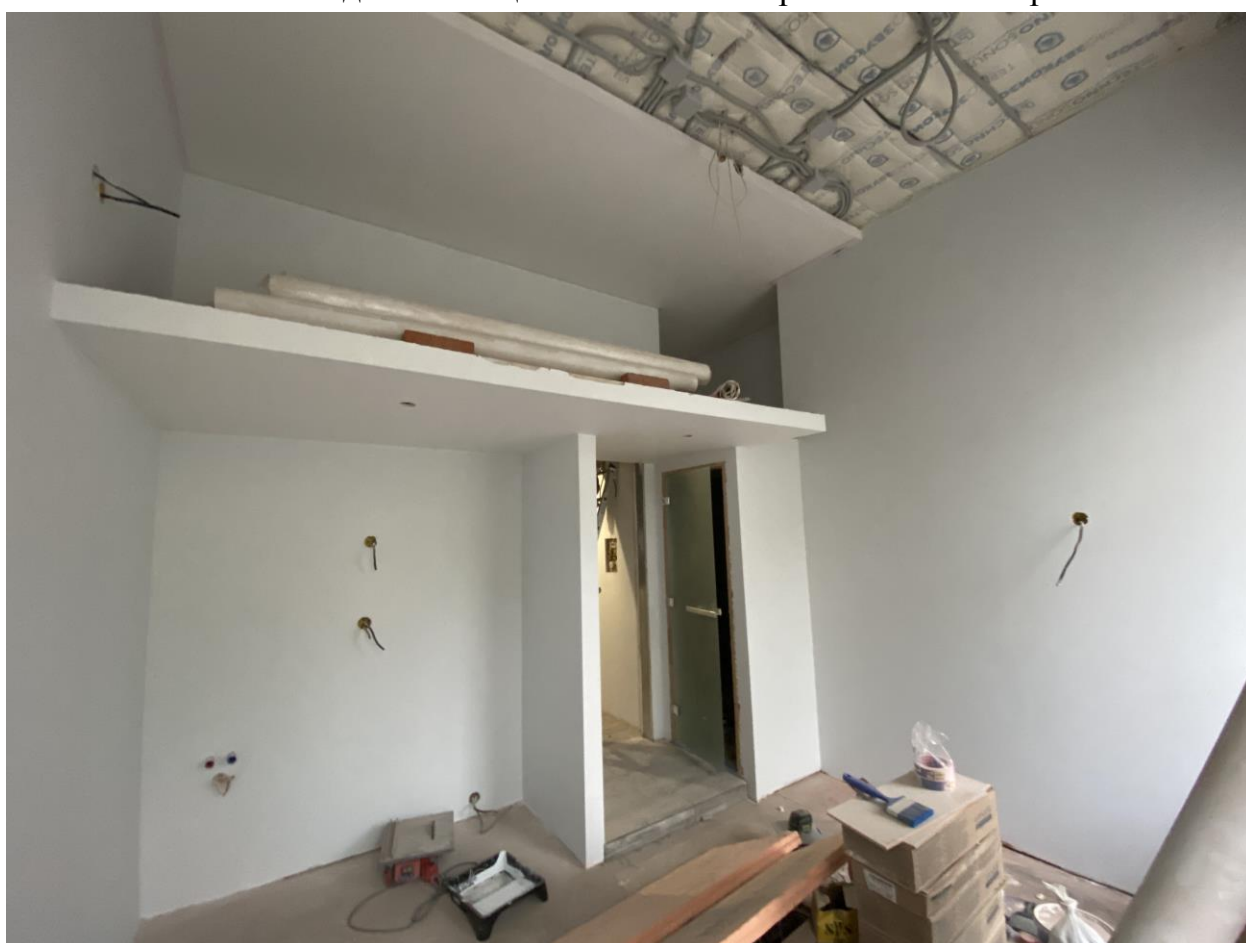
Фото.39. Вид на помещение № 13 со стороны оконных проемов
