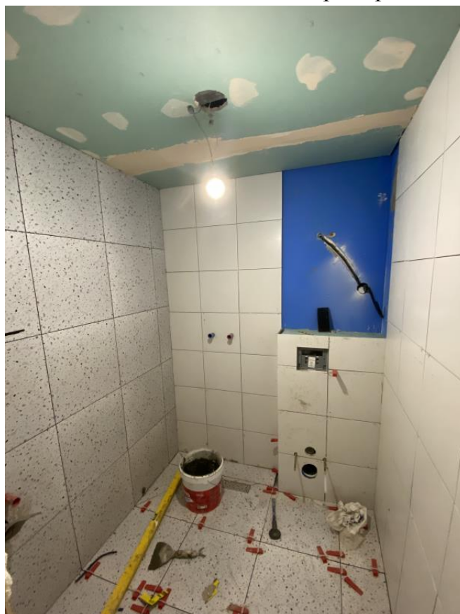
Фото.24. Вид на помещение № 9.
