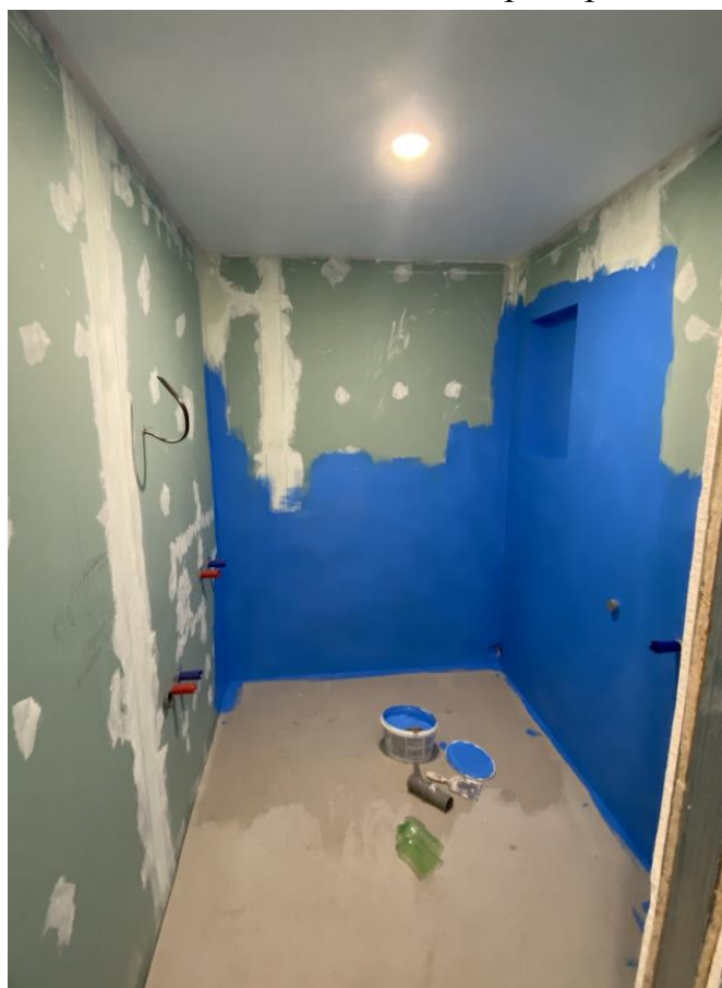
Фото.10. Вид на помещение № 6.
