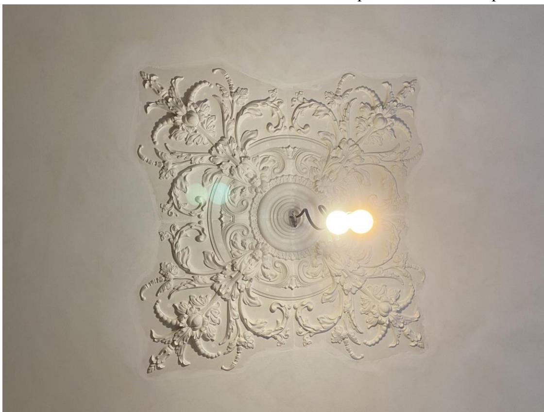
Фото.12. Вид на помещение № 5. Потолок.
