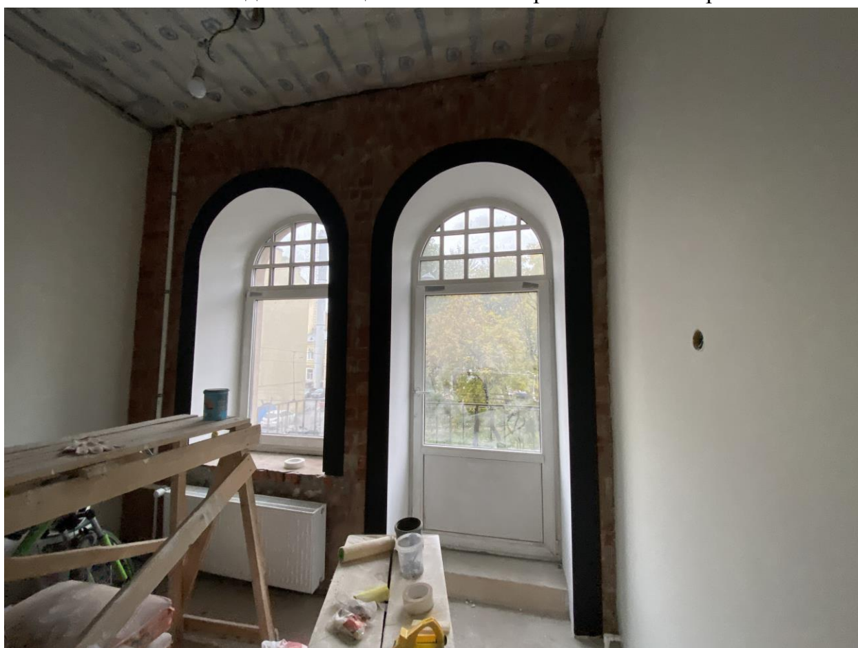
Фото.19. Вид на помещение № 7 на оконные проемы.
