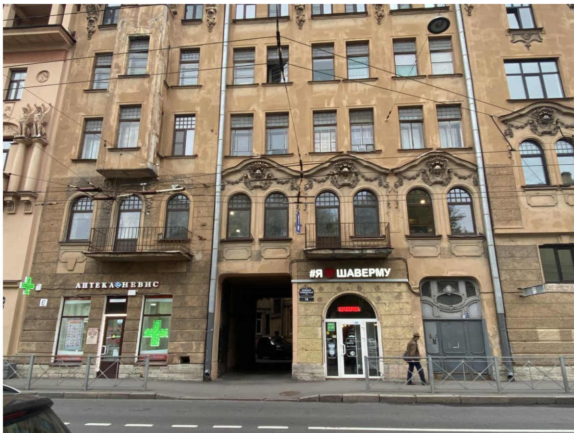
Фото.3. Общий вид на «Дом А.С. Савина». Северный лицевой фасад, въезд.
