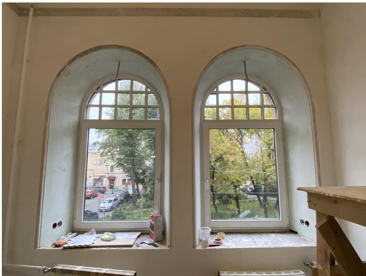
Фото.13. Вид на помещение № 5, оконные проемы.
