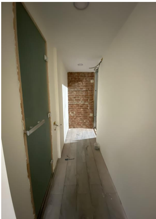
Фото.20. Вид на помещение № 7, коридор.
