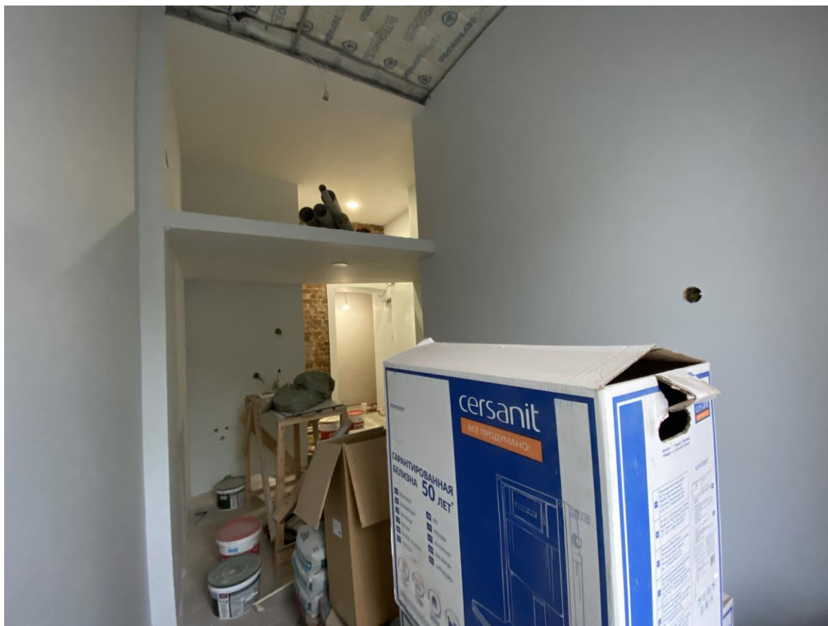
Фото.26. Вид на помещение № 10 со стороны оконных проемов.
