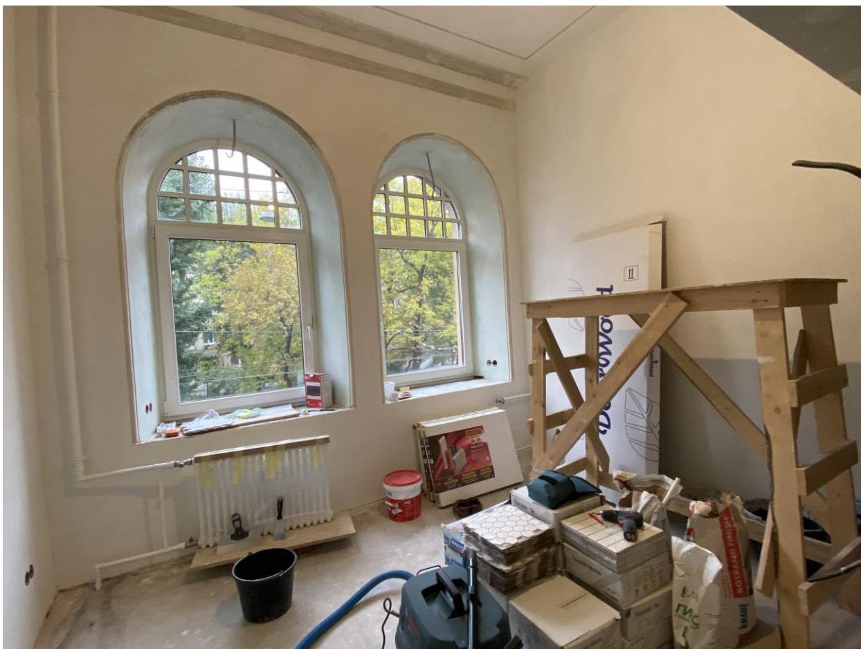
Фото.11. Вид на помещение № 5 со стороны входной двери.
