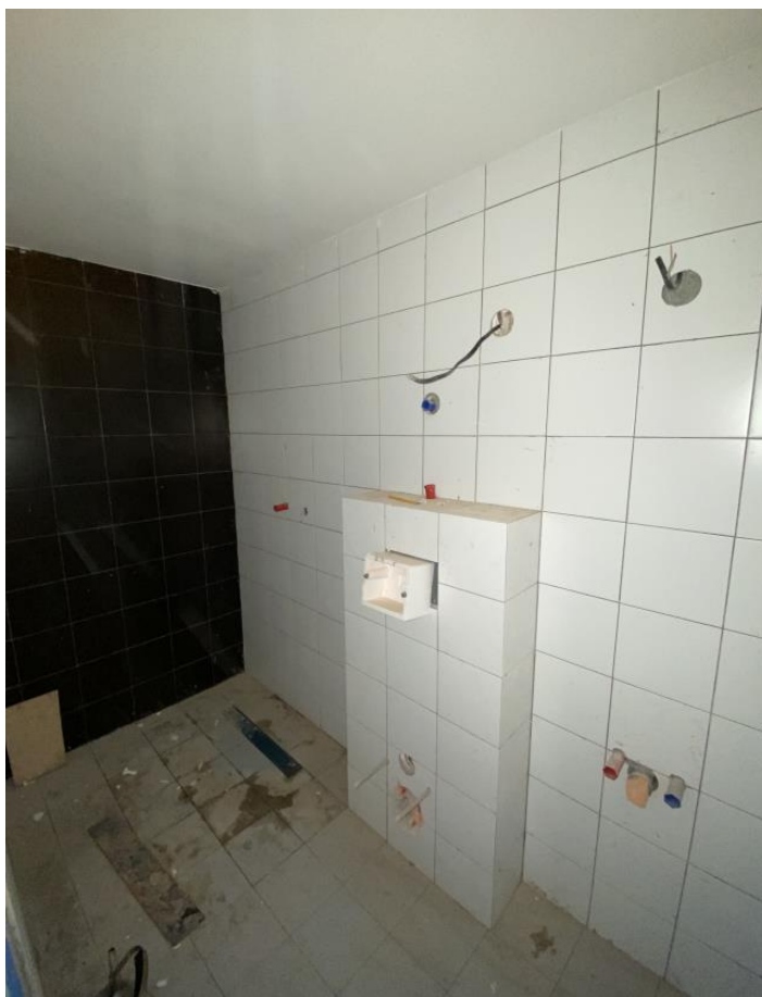
Фото.44. Вид на помещение санитарного узла.
