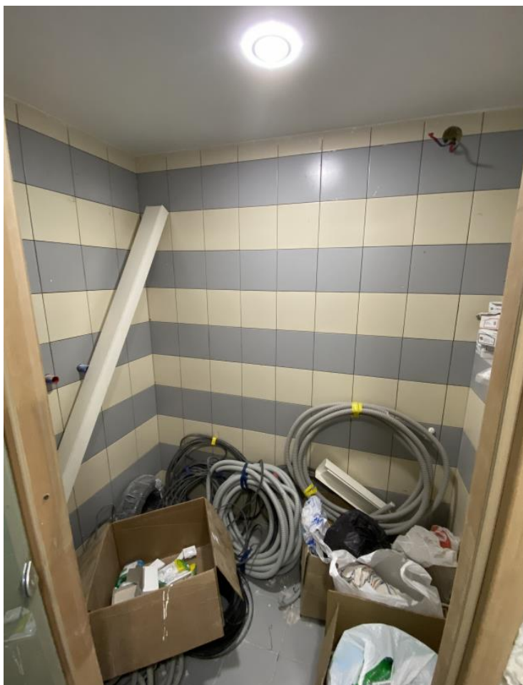
Фото.36. Вид на помещение № 12.
