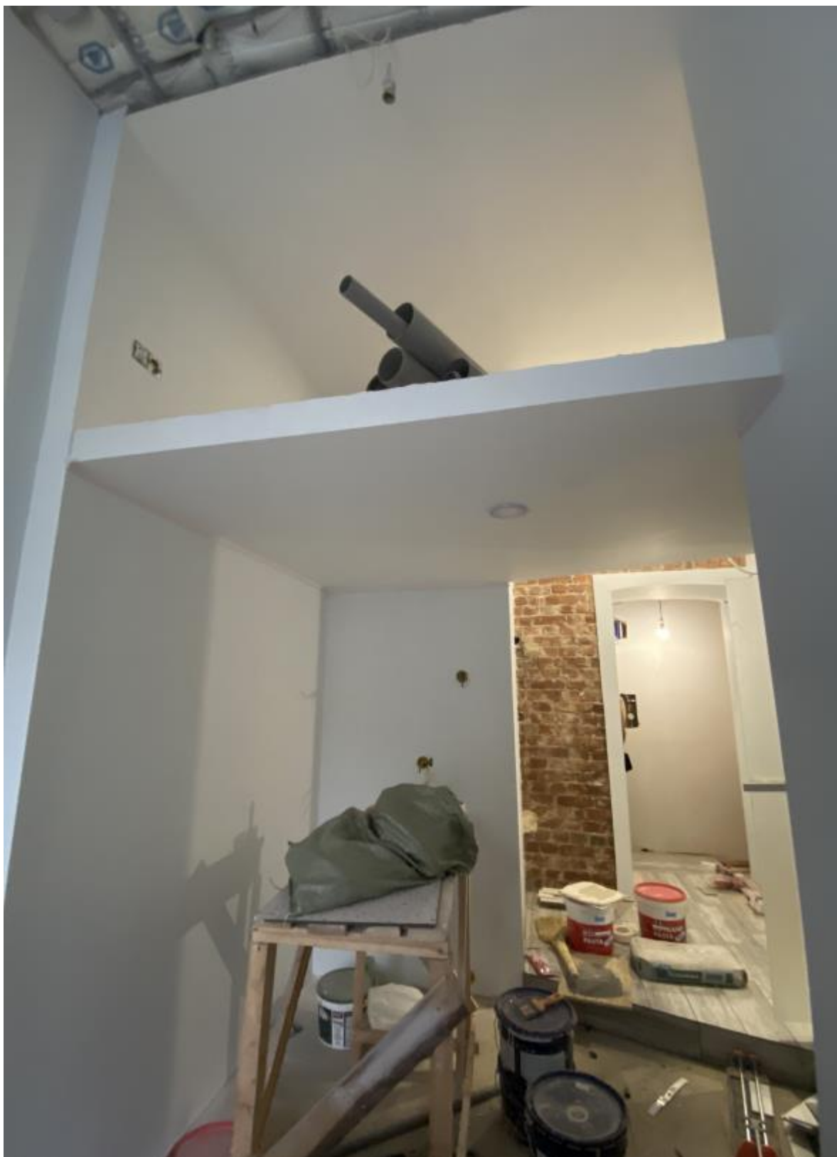
Фото.25. Вид на помещение № 10 со стороны оконных проемов.
