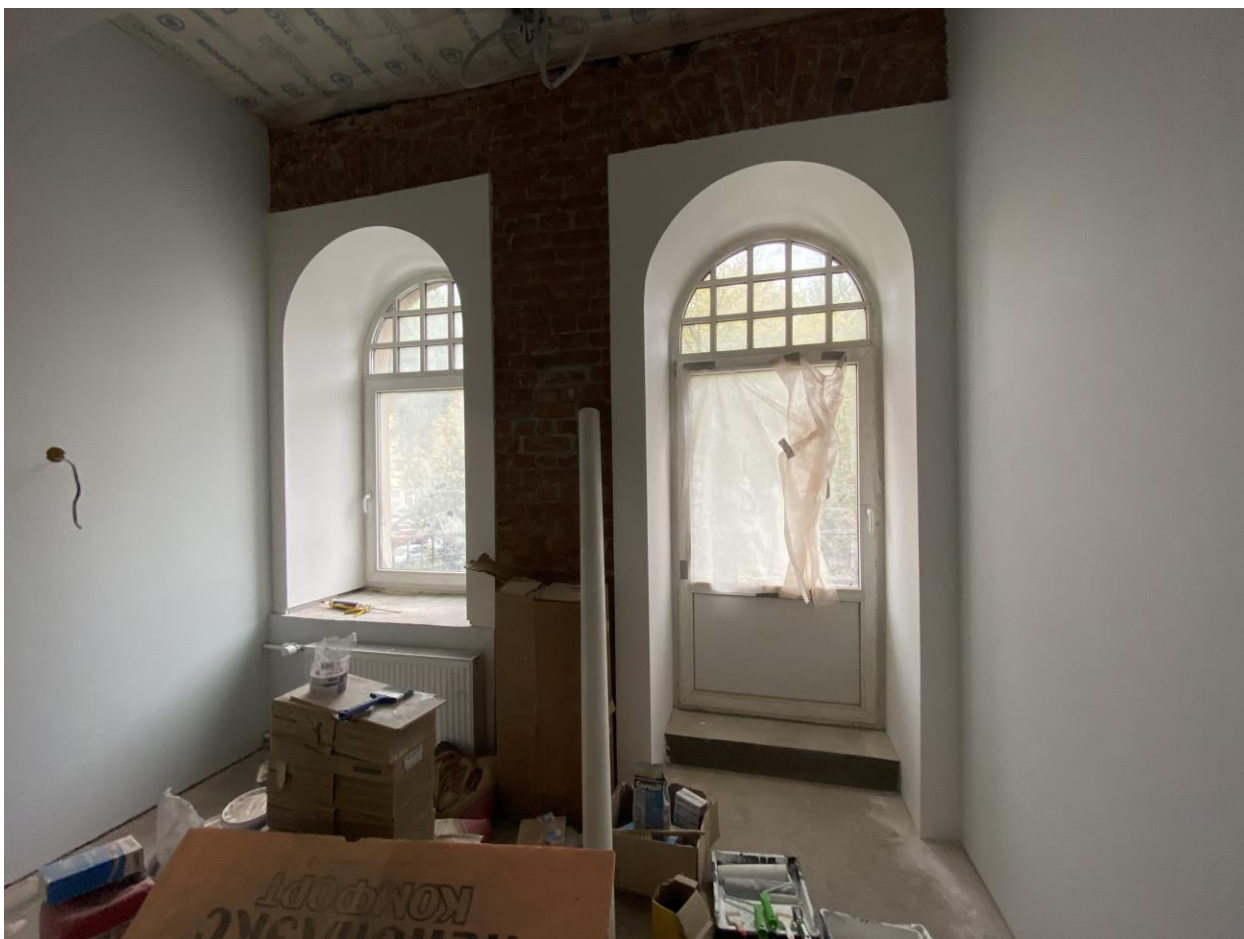
Фото.40. Вид на помещение № 13 со стороны входной двери.
