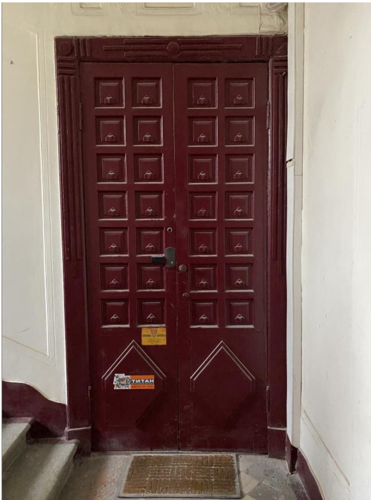
Фото.8. Вид на вход в квартиру №2 с парадной лестницы.
