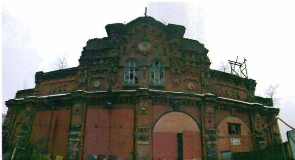
2. Северо-западный торцевой фасад.
