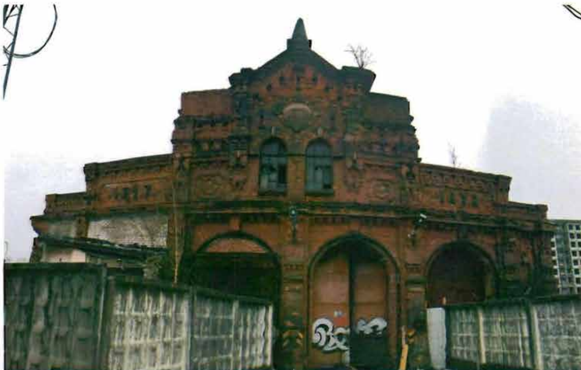
1. Юго-восточный торцевой фасад.
