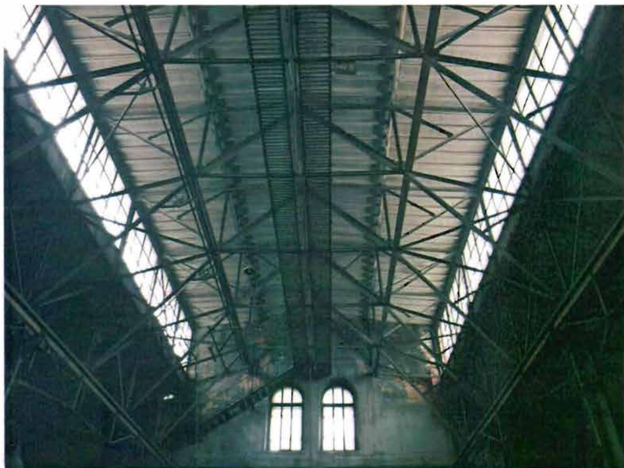
6. Металлические фермы перекрытия.
