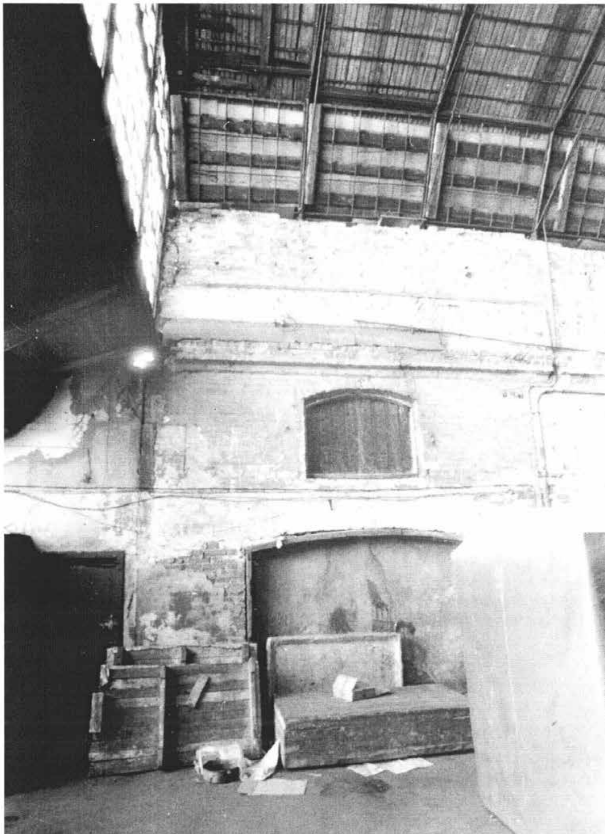
47. Фрагмент галереи пассажа Апраксина двора. Вид на стену корпуса № 38 со стороны галереи. Конец XX в.
