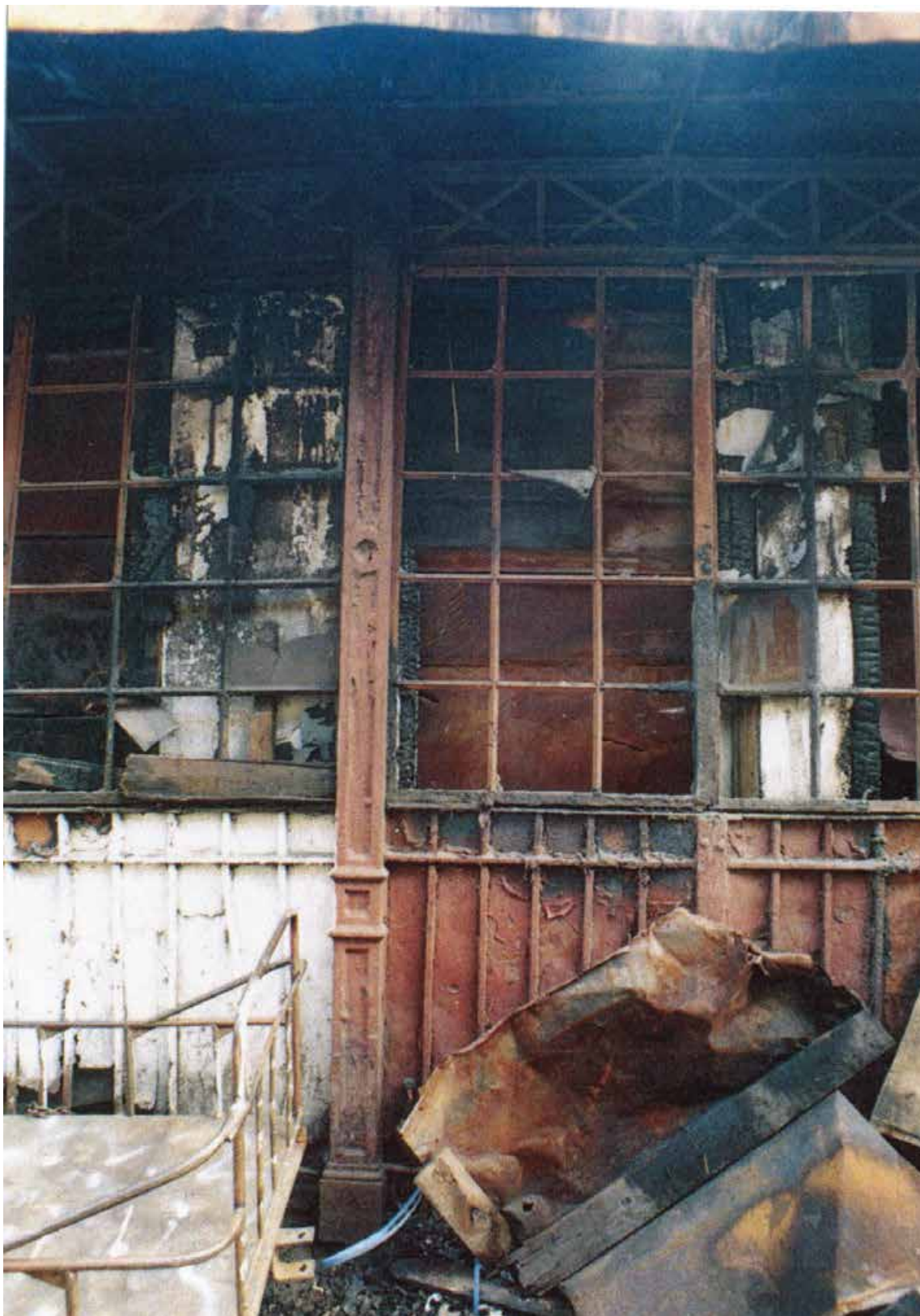
53. Фрагмент металлической галереи докового северо-восточного фасада корпуса № 38. Вид с северо-востока. 2001г.
