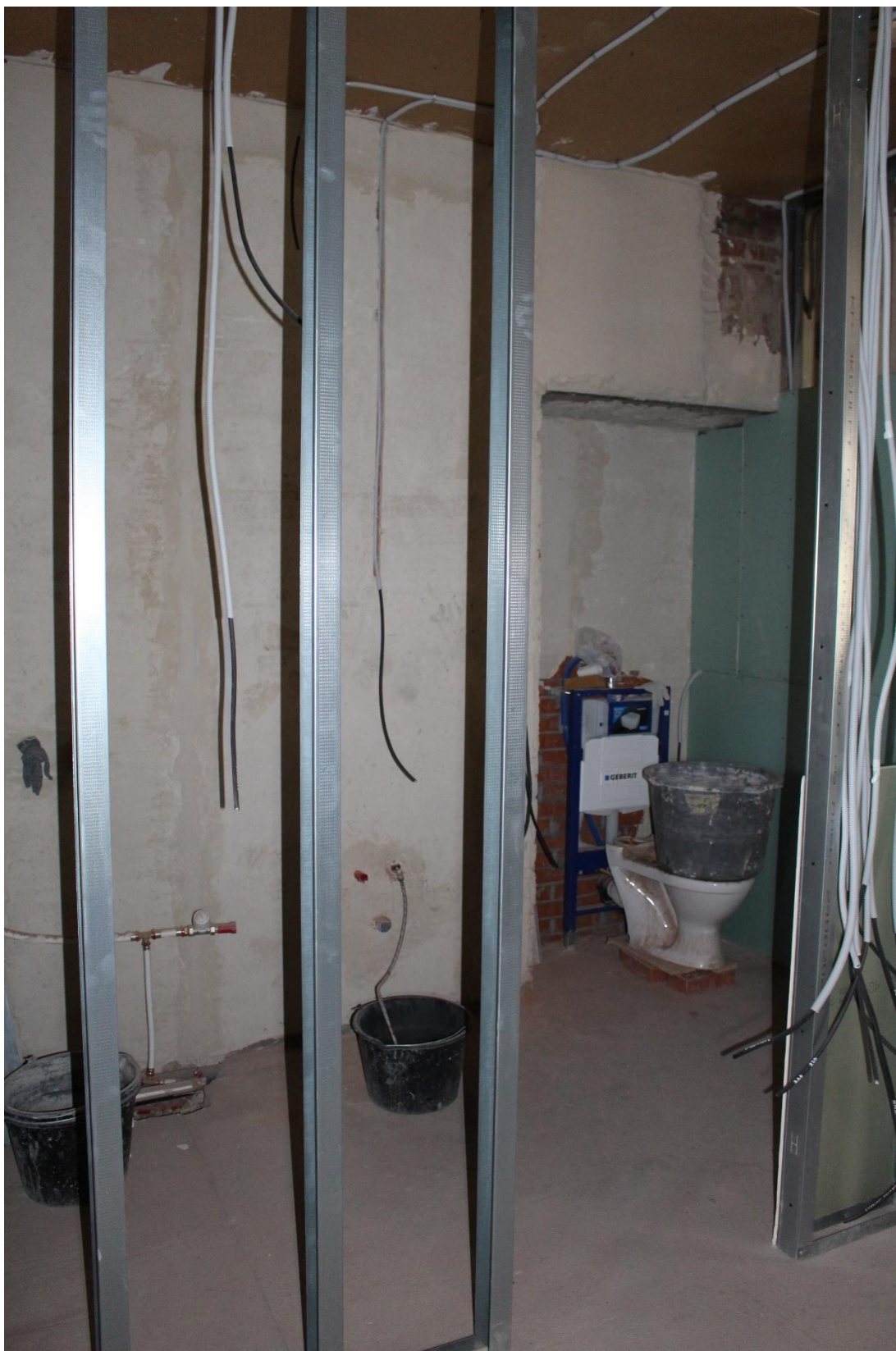
Фото 17. Выявленный объект культурного наследия «Дома И.В. Пospelова и К.В. Печаткиной». Внутренние помещения квартиры № 54. Вид на металлокаркас для новых перегородок в ч.п. 1, 3, 6.
