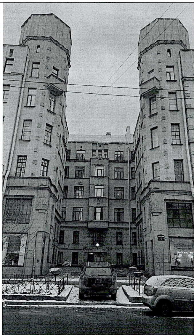
2. Фрагмент северо-западного фасада
