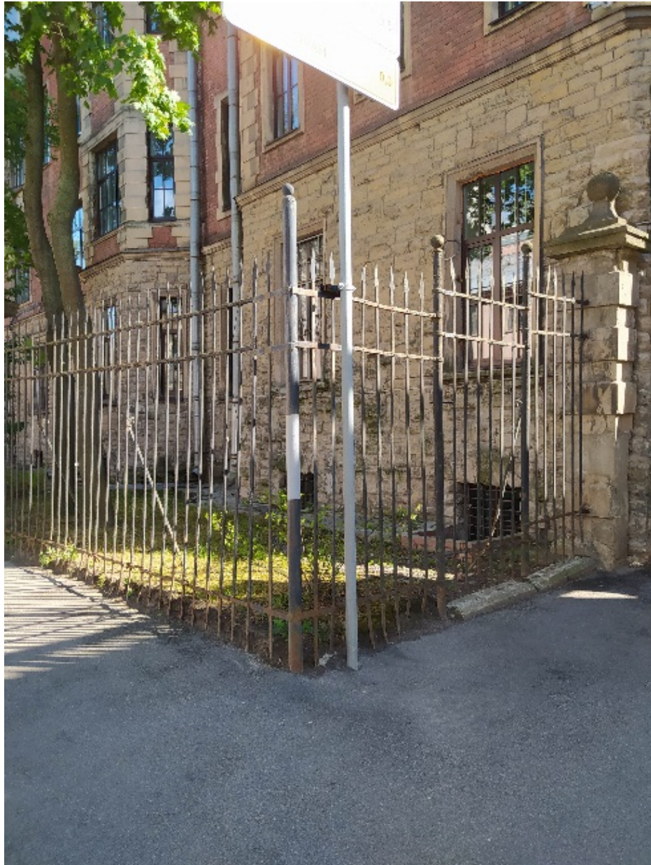
Общий вид со стороны Аптекарского пр. Муфтированная колонна разобрана, установлена временная металлическая стойка в виде трубы.
