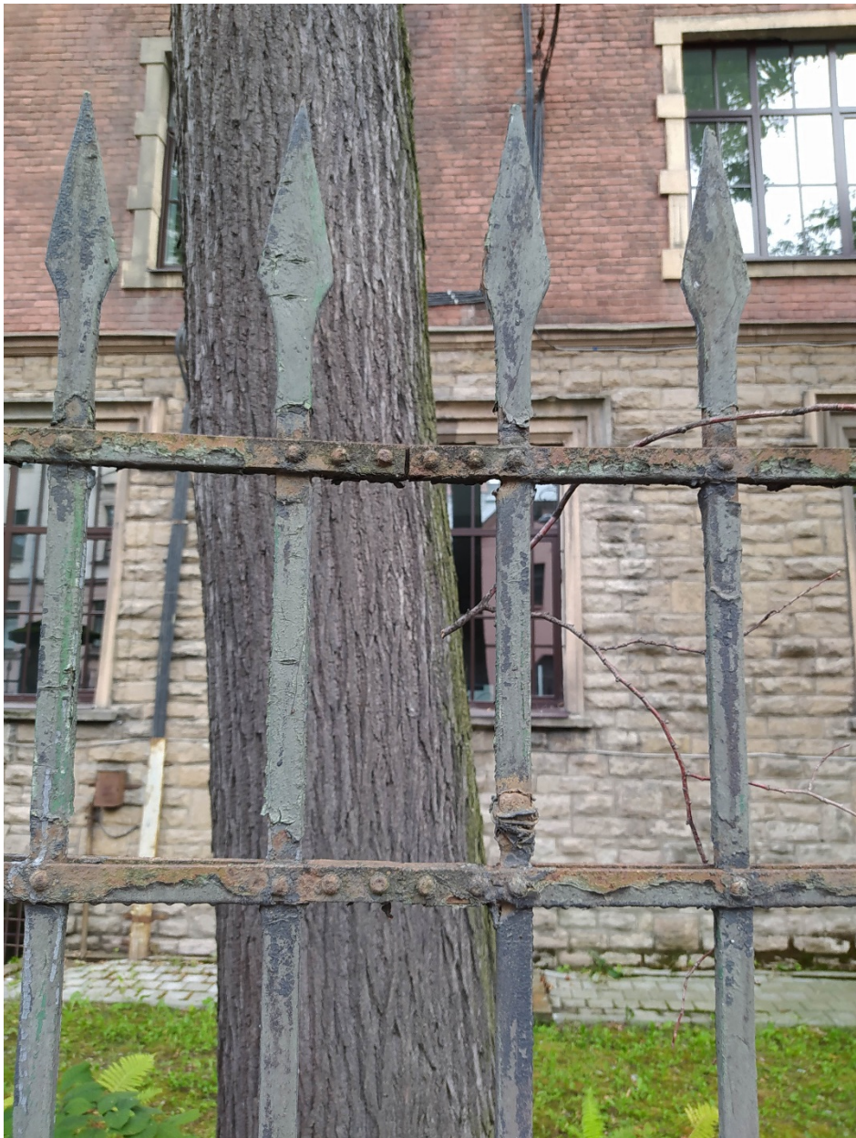
Фрагмент металлической ограды. Стойки с завершением в виде пик.
