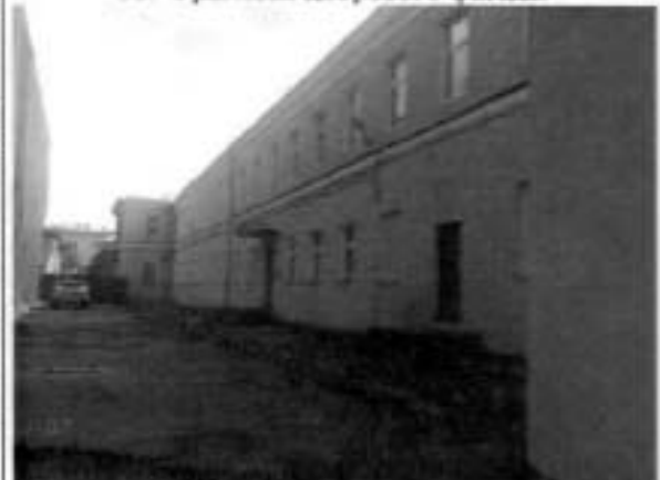
33. Фрагмент дворового фасада.
