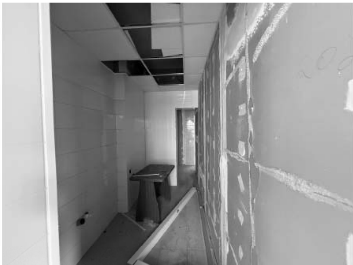
Фото 83. Помещение 6-Н. Комната.
