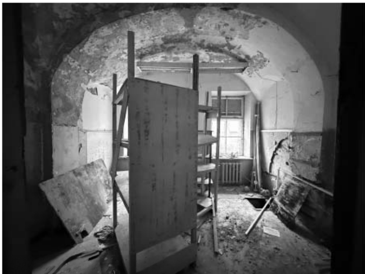
Фото 34. Помещение 5-Н. Комната.
