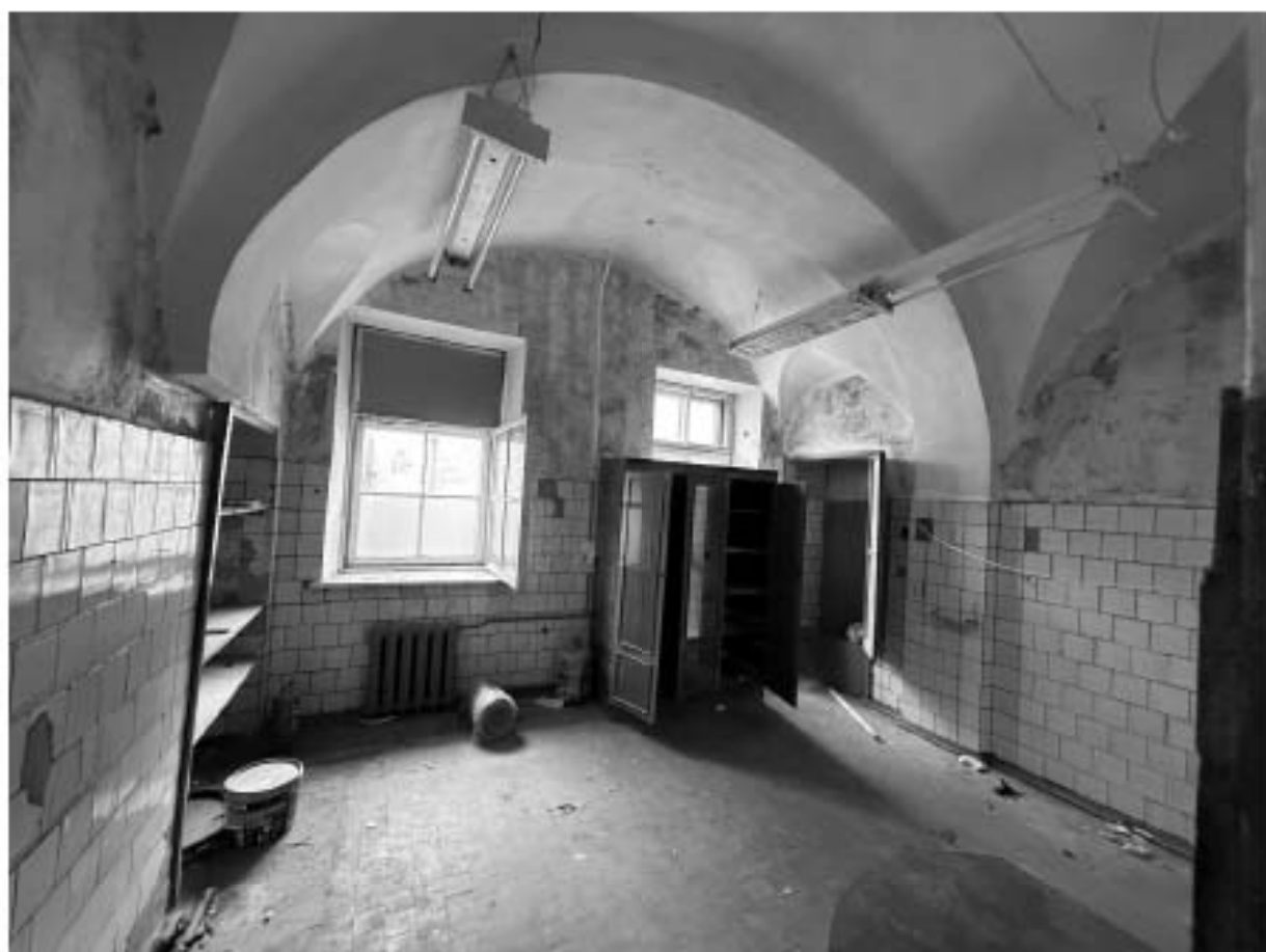
Фото 21. Помещение 5-Н. Комната.
