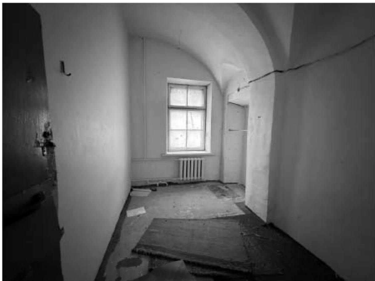
Фото 30. Помещение 5-Н. Комната.
