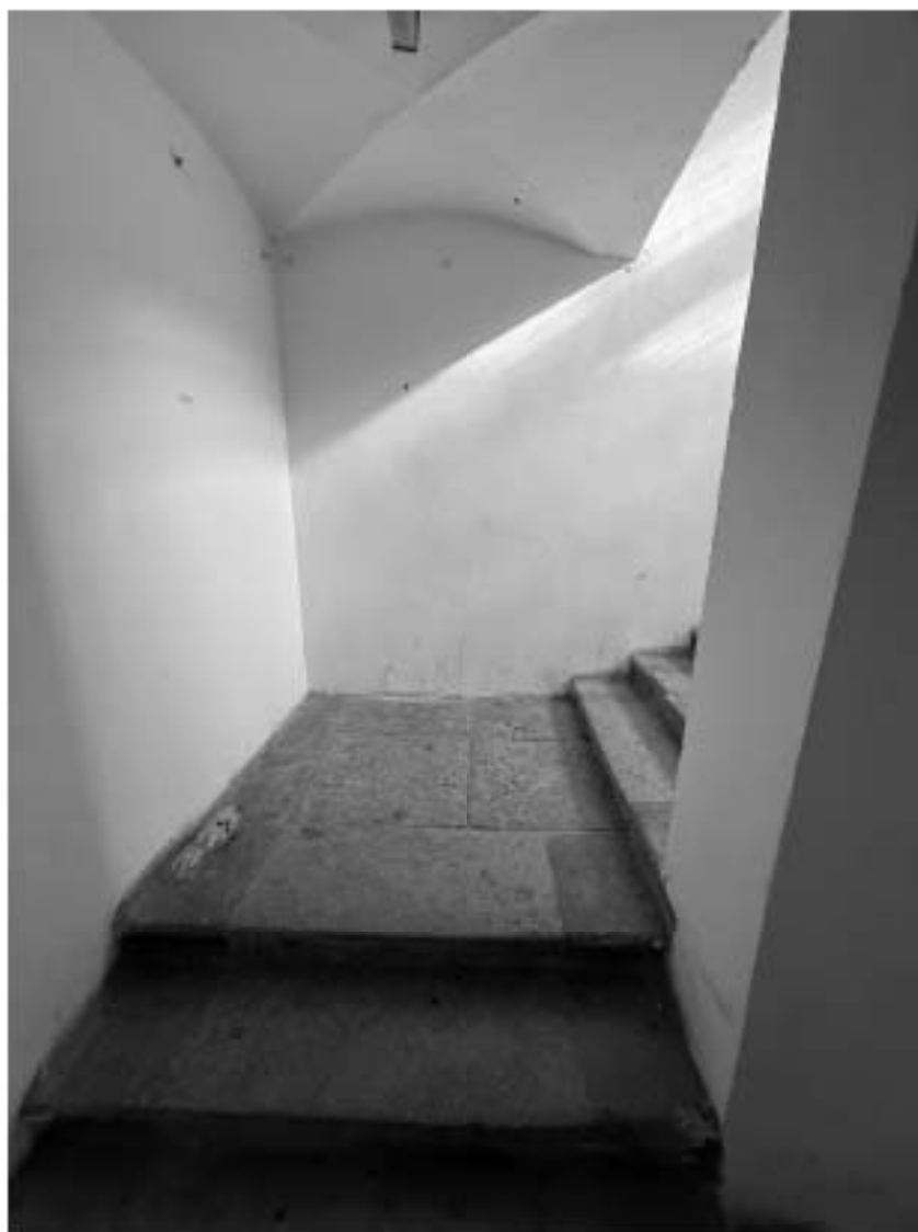
Фото 46. Помещение 6-Н. Площадка между 1 и 2 этажами.
