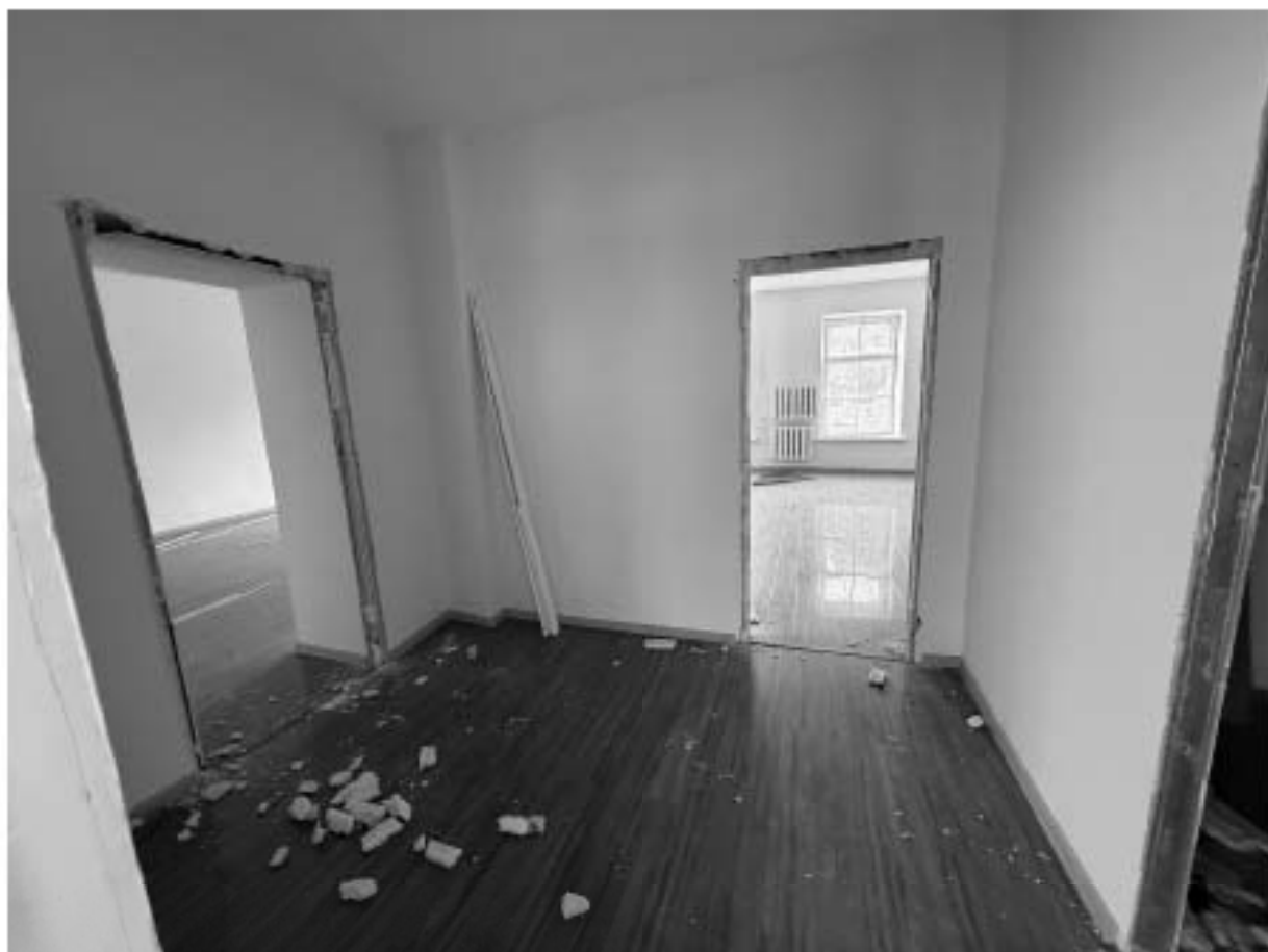
Фото 89. Помещение 6-Н. Комната.
