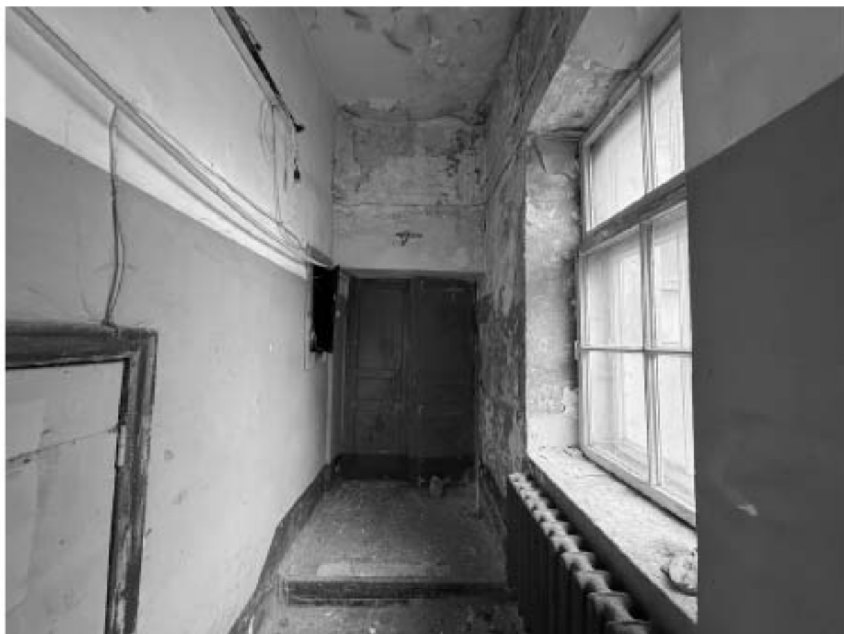
Фото 7. Помещение 5-Н. Тамбур.
