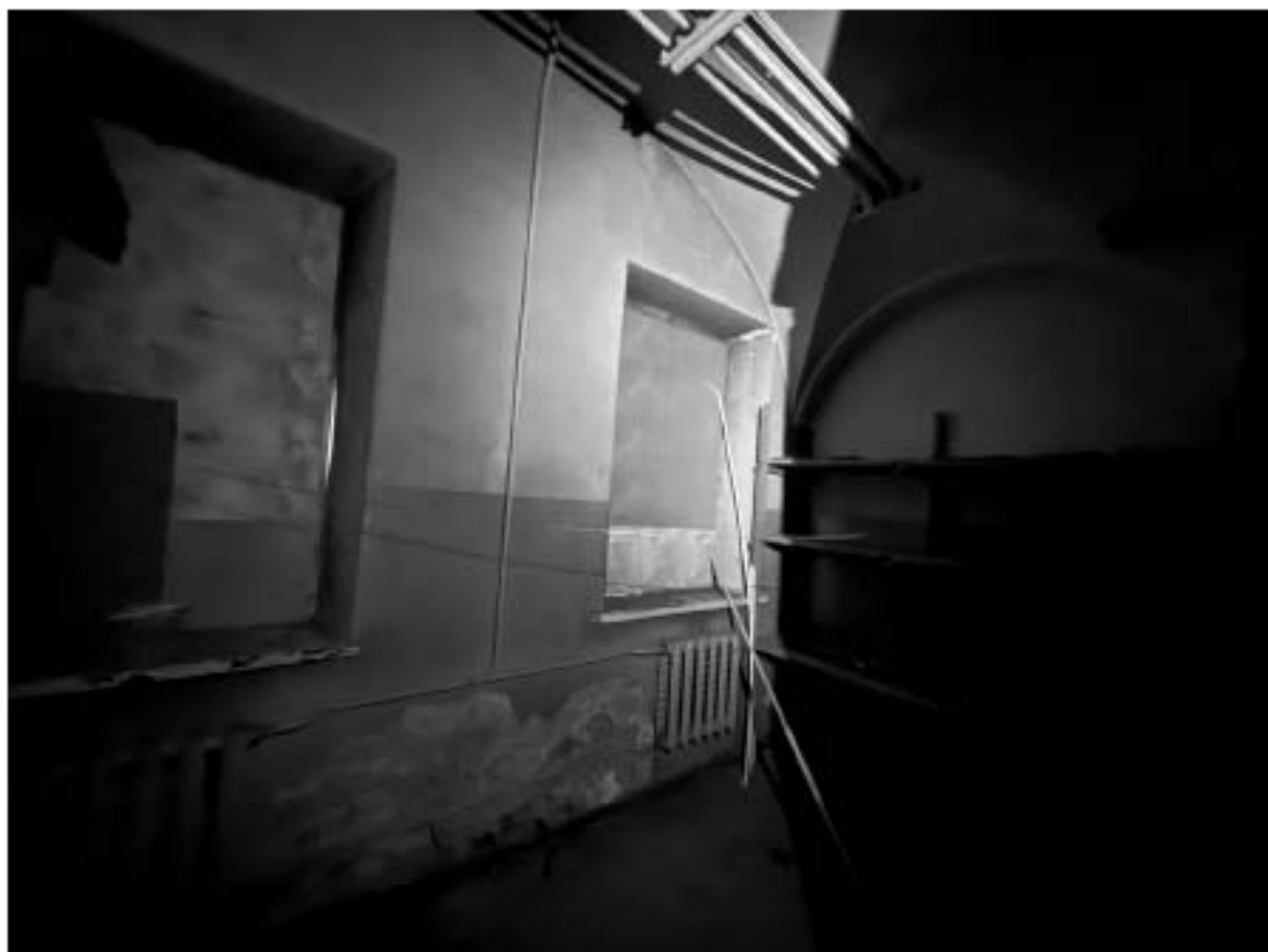
Фото 28. Помещение 5-Н. Комната.
