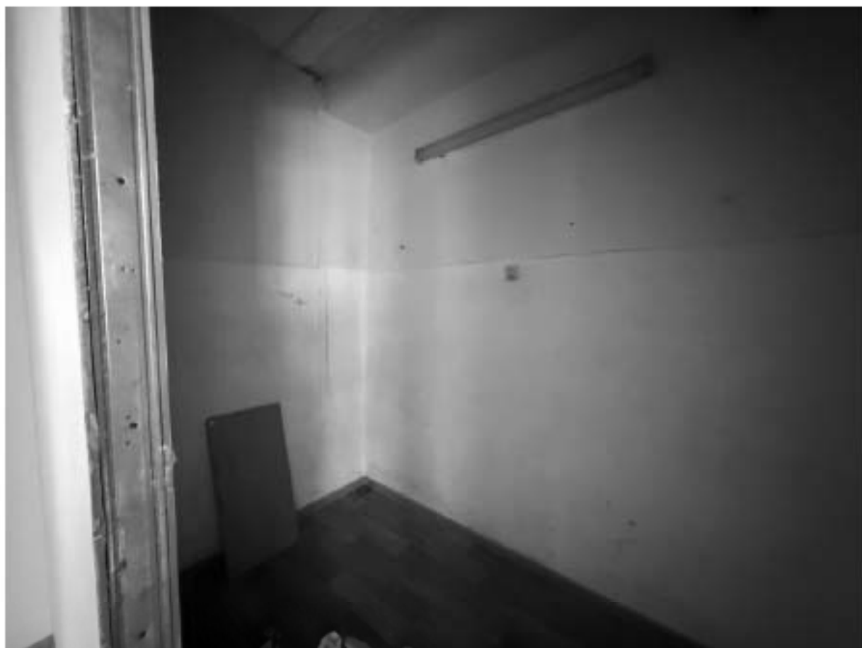
Фото 90. Помещение 6-Н. Комната.
