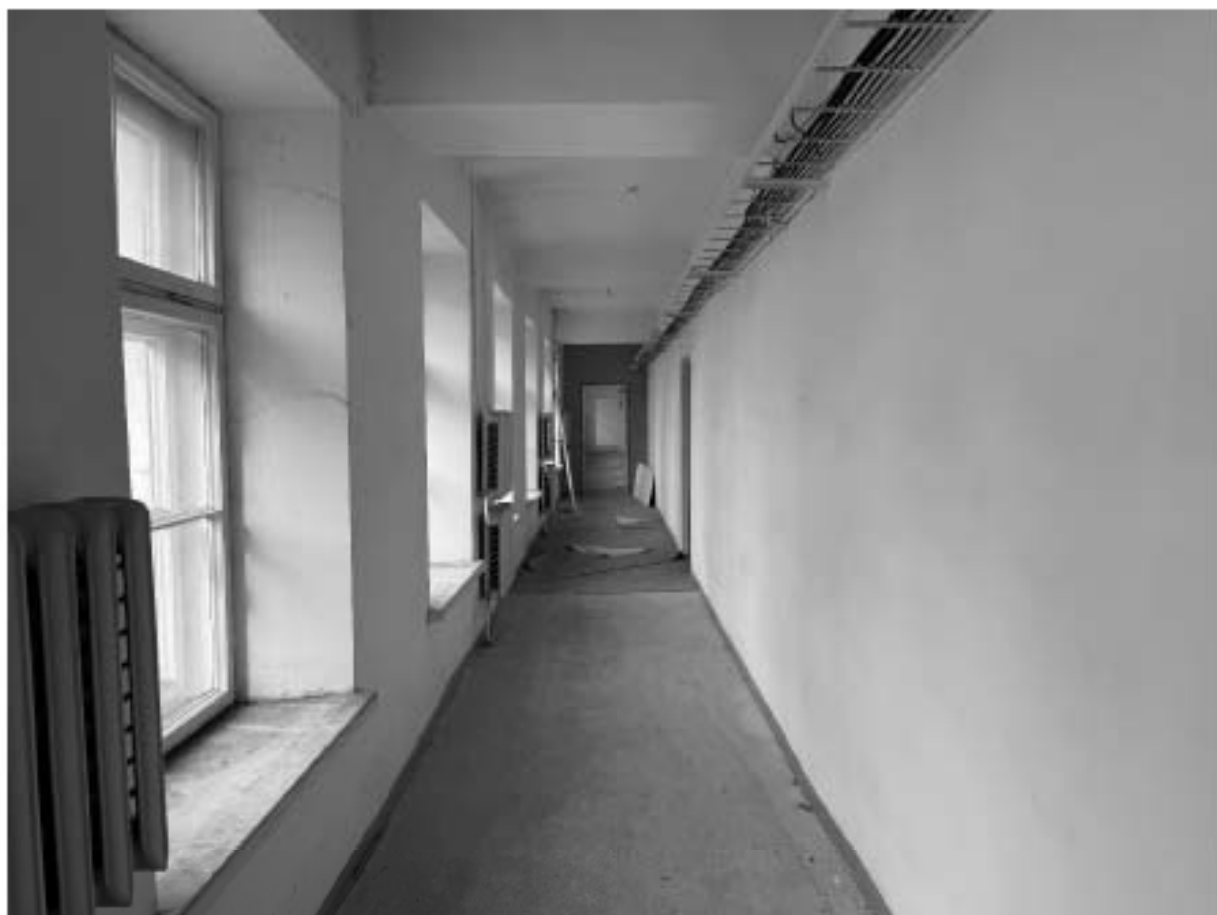
Фото 79. Помещение 6-Н. Коридор.
