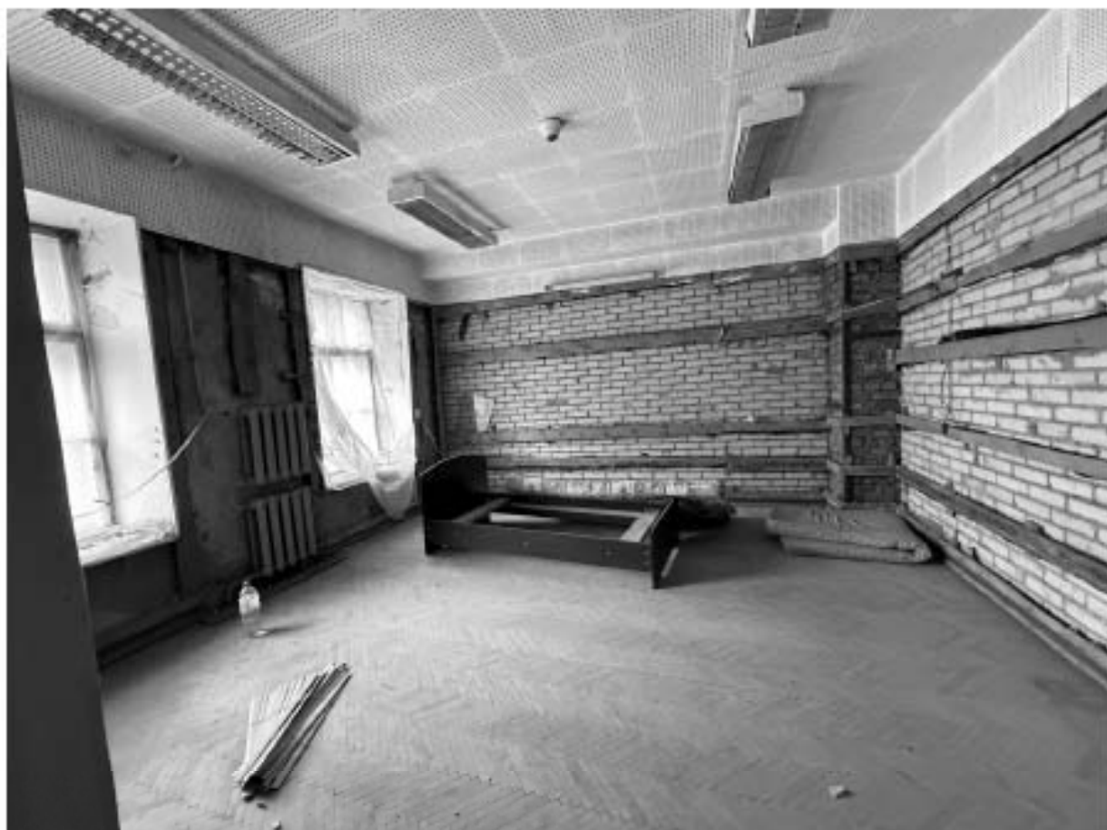
Фото 68. Помещение 6-Н. Комната.
