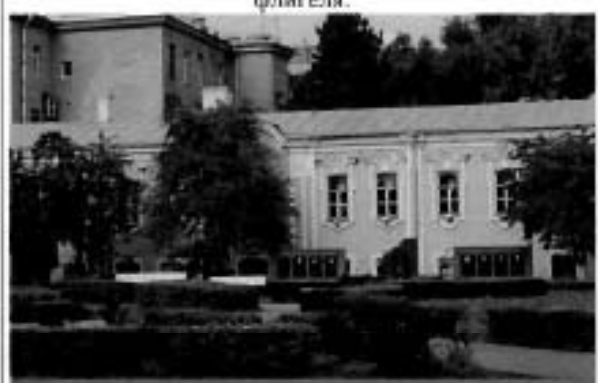
37. Фрагмент дворового фасада восточного флигеля.
