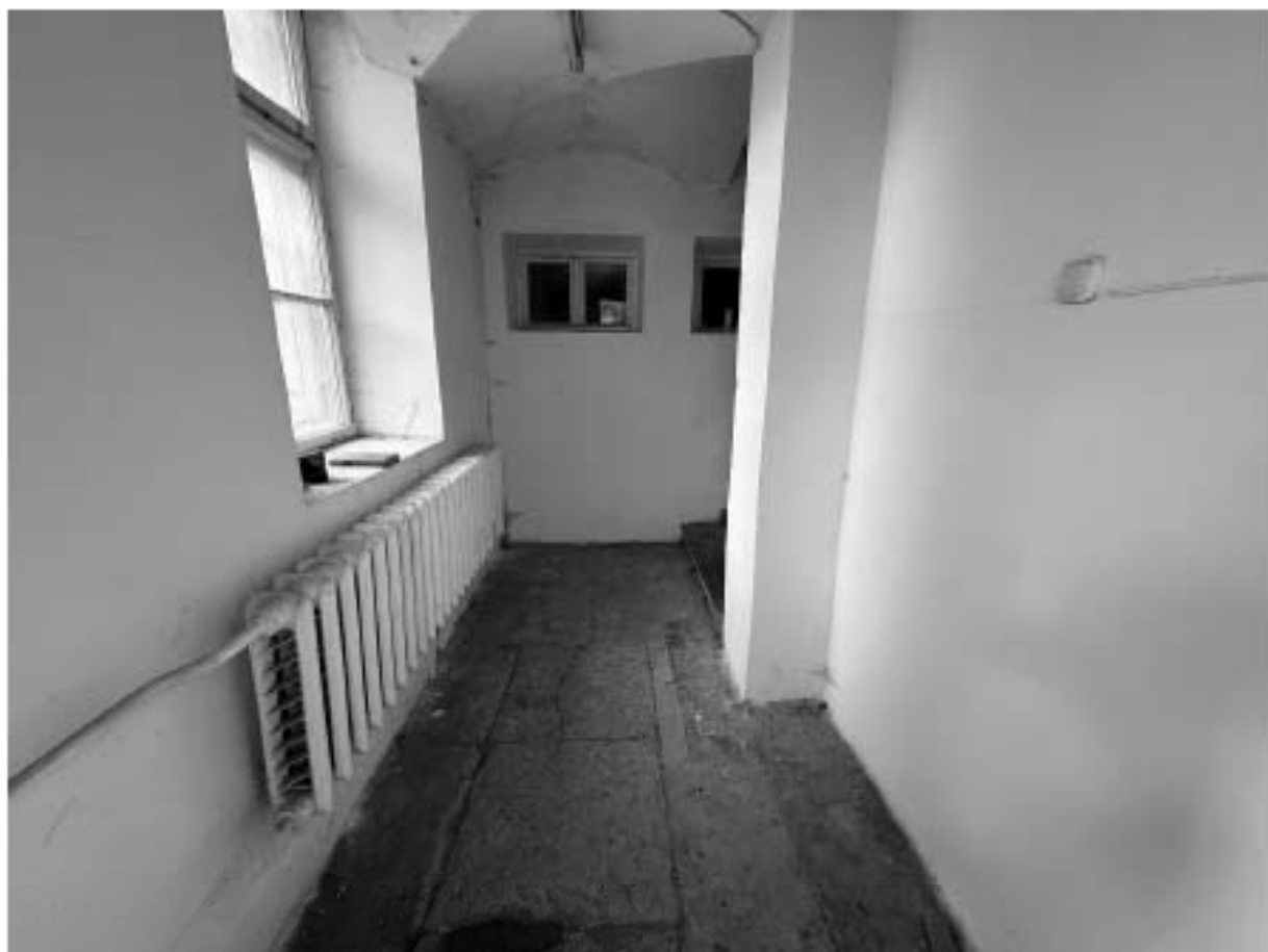
Фото 44. Помещение 6-Н. Лестничная клетка.
