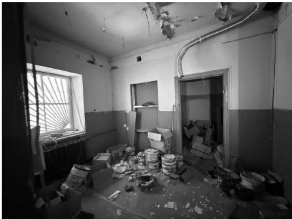
Фото 63. Помещение 6-Н. Комната.
