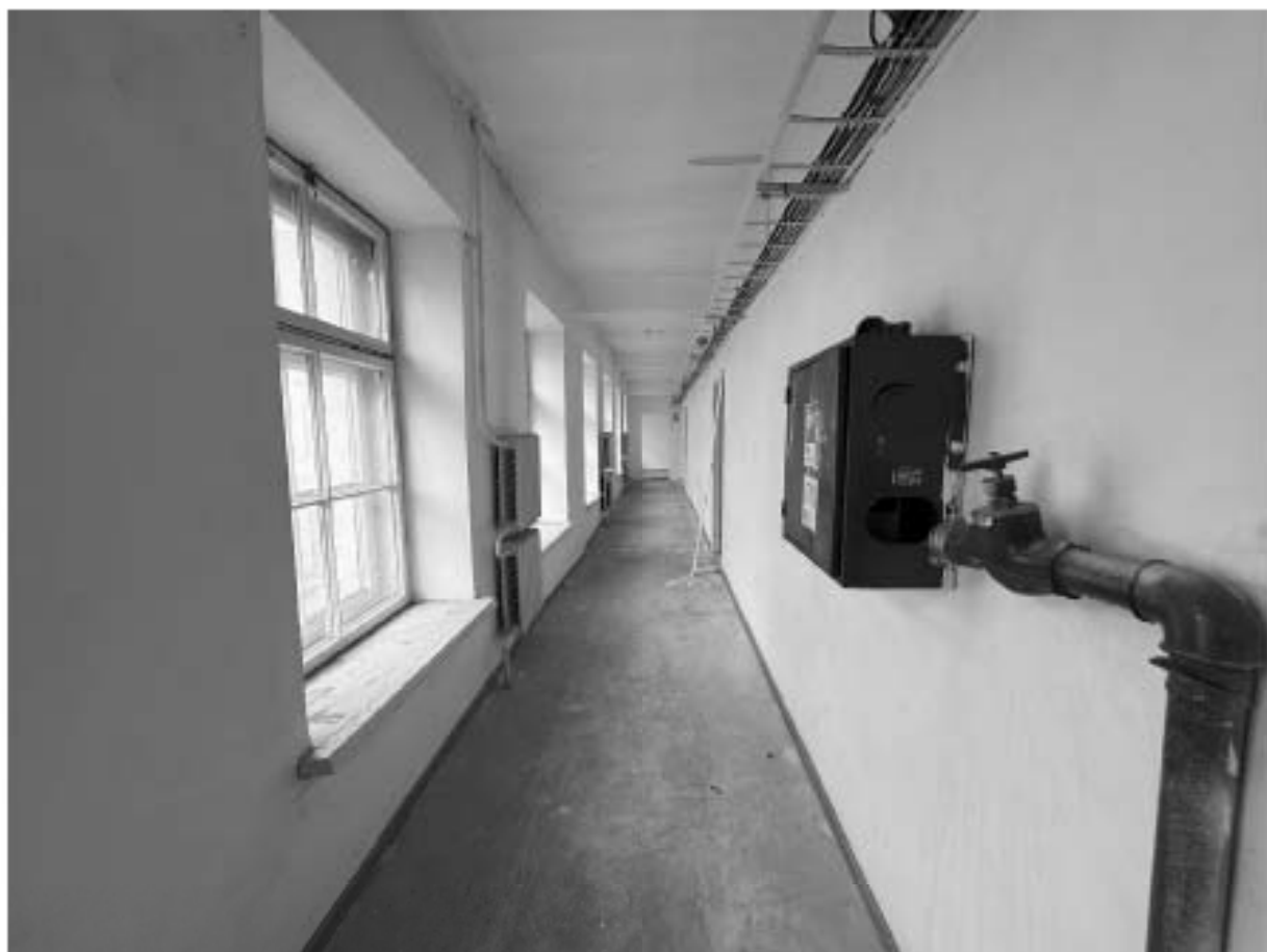
Фото 87. Помещение 6-Н. Коридор.
