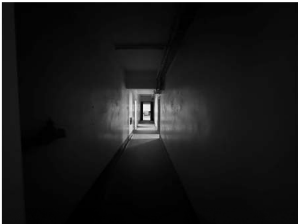
Фото 66. Помещение 6-Н. Коридор.
