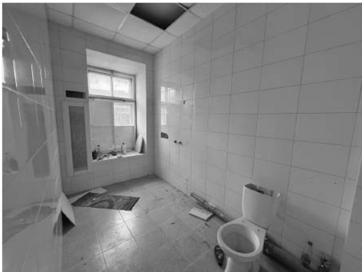
Фото 86. Помещение 6-Н. Санузел.
