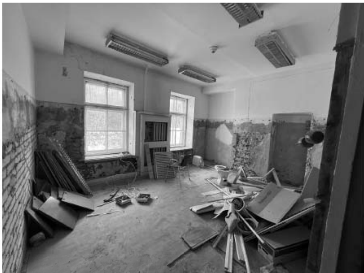
Фото 73. Помещение 6-Н. Комната.
