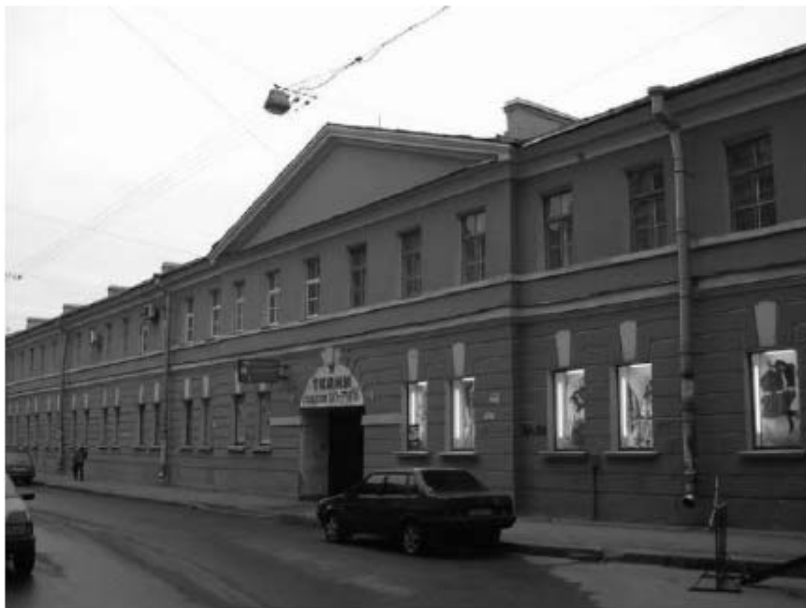
Илл. 23. Жилой флигель и службы Пажеского корпуса. Ул. Ломоносова 8-10. 2008 г. Citywalls: Архитектурный сайт Петербурга [Электронный ресурс] URL: https://www.citywalls.ru/photo14324.html
