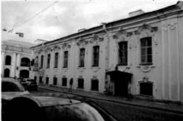
34. Фрагмент лицевого фасада западного флигеля.
