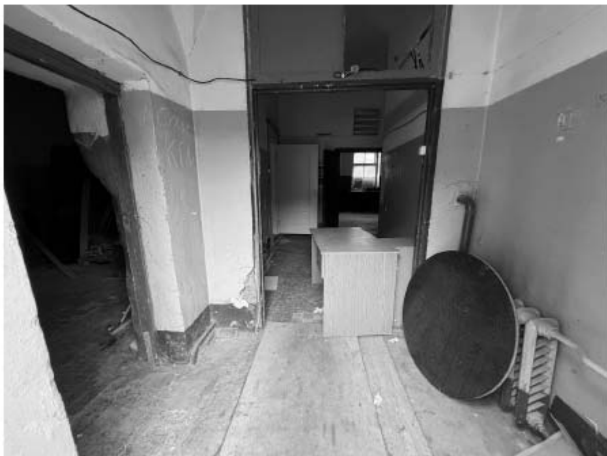
Фото 47. Помещение 5-Н. Коридор.
