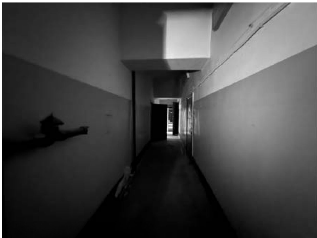
Фото 10. Помещение 5-Н. Коридор.
