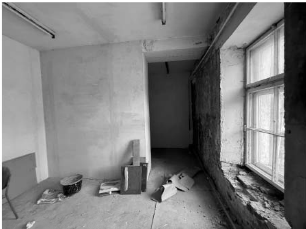
Фото 71. Помещение 6-Н. Комната.
