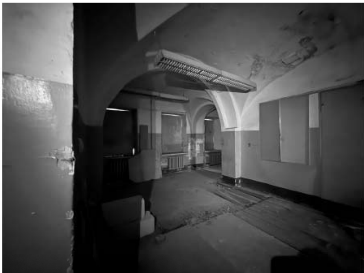
Фото 39. Помещение 5-Н. Комната.
