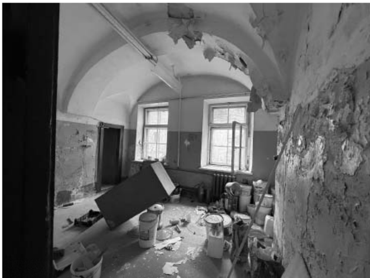
Фото 35. Помещение 5-Н. Комната.
