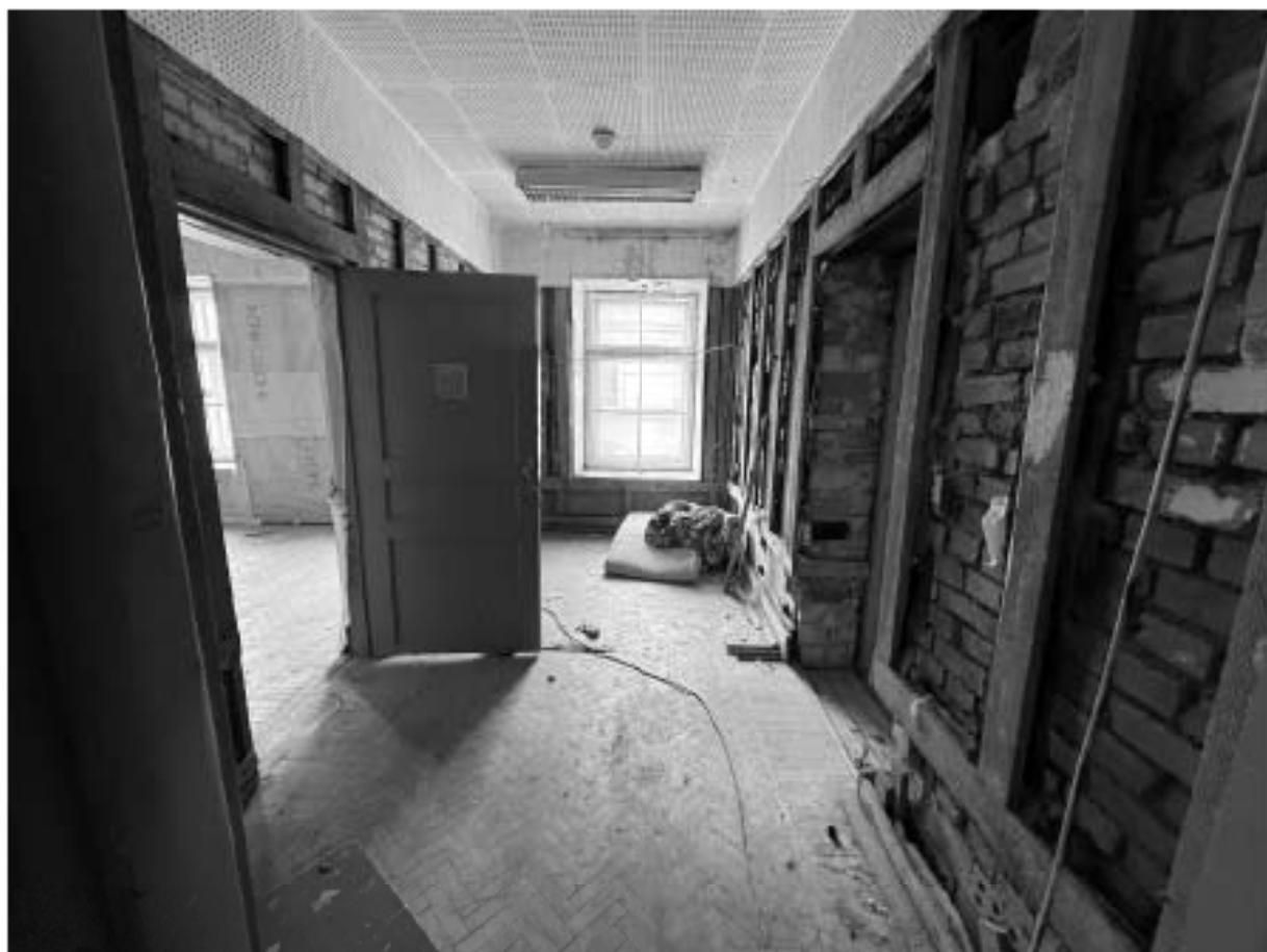
Фото 67. Помещение 6-Н. Комната.
