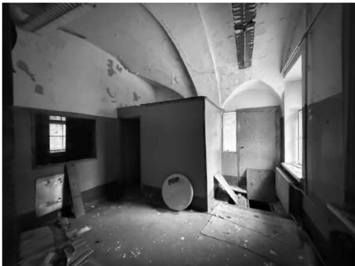
Фото 43. Помещение 5-Н. Комната.
