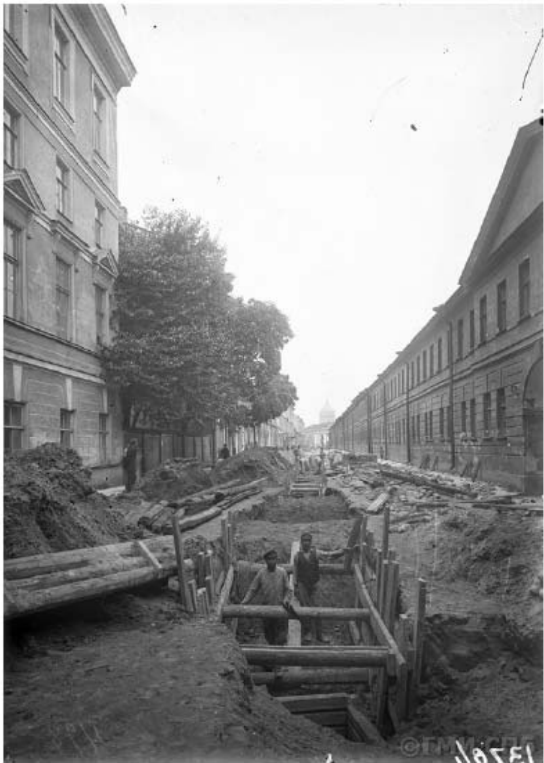
Илл. 17. Сооружение канализации. Траншейные работы на Чернышевском переулке (улице Ломоносова). 1920-е гг. СПб ГБУК «Государственный музей истории Санкт-Петербурга». ГМИ СПб Инв. №-П-А-848н.
