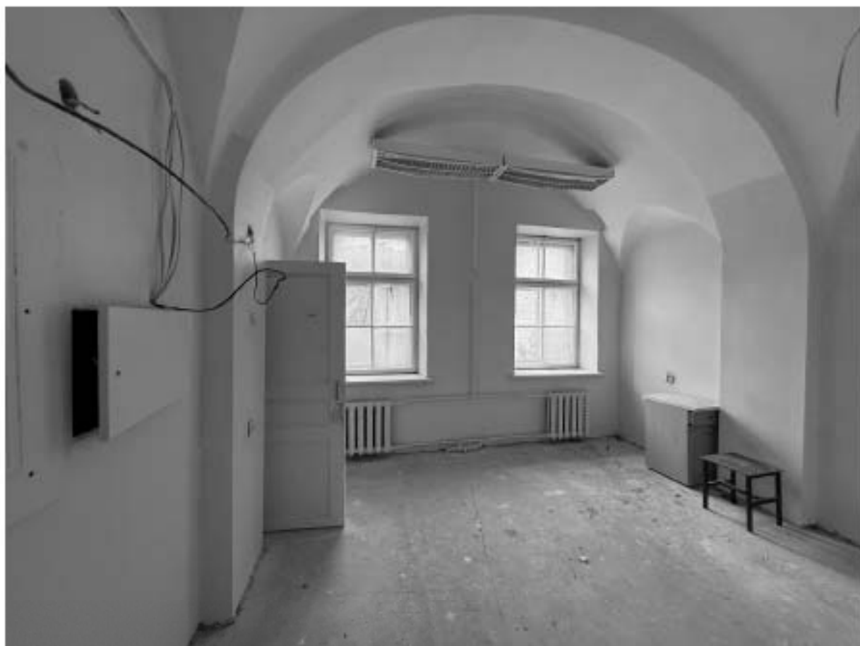
Фото 18. Помещение 5-Н. Комната.
