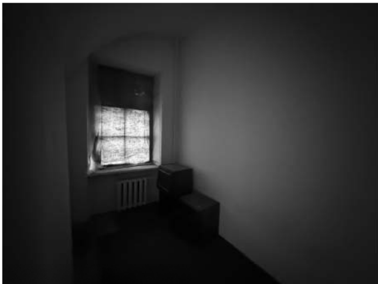
Фото 23. Помещение 5-Н. Комната.
