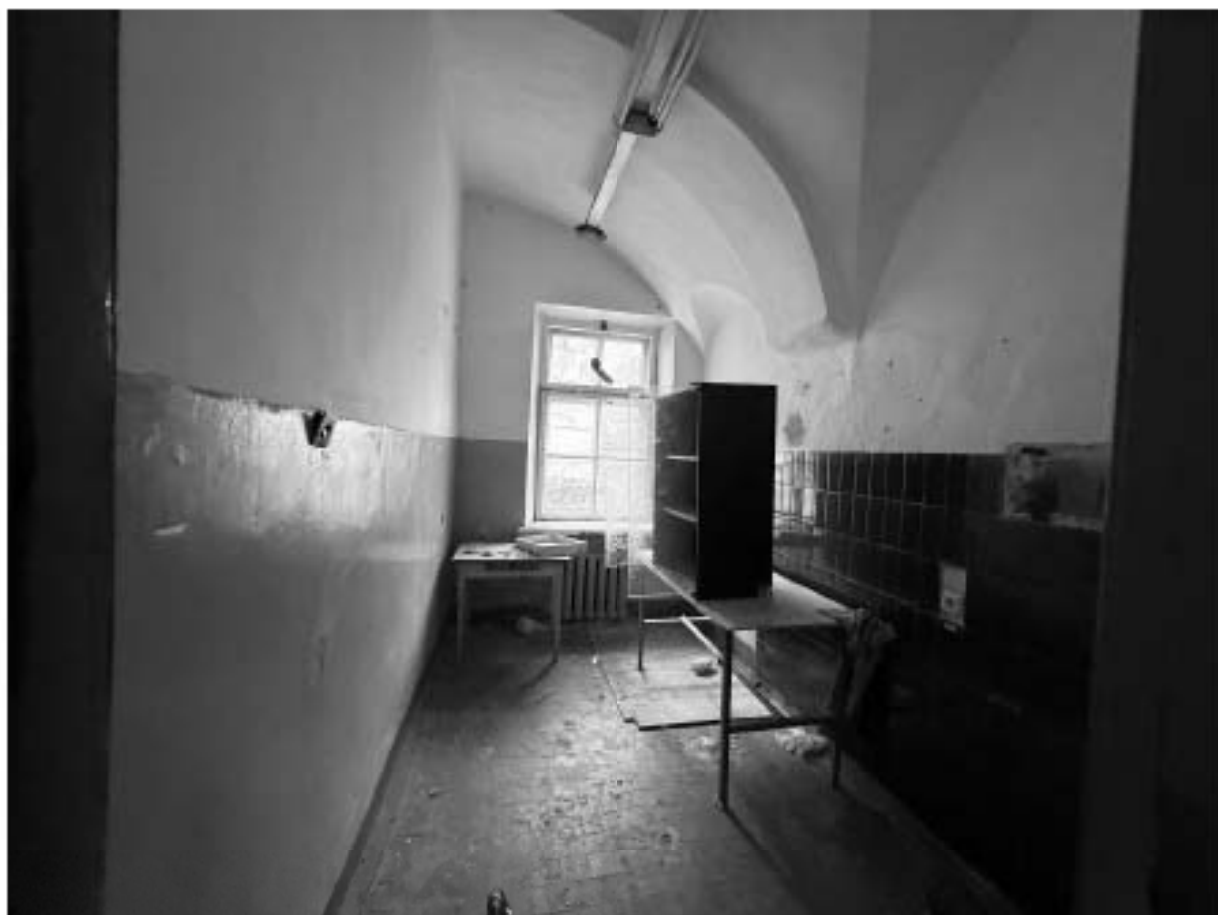
Фото 16. Помещение 5-Н. Комната.
