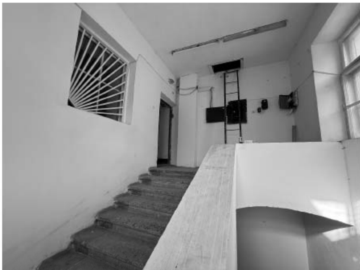
Фото 59. Помещение 6-Н. Лестница.
