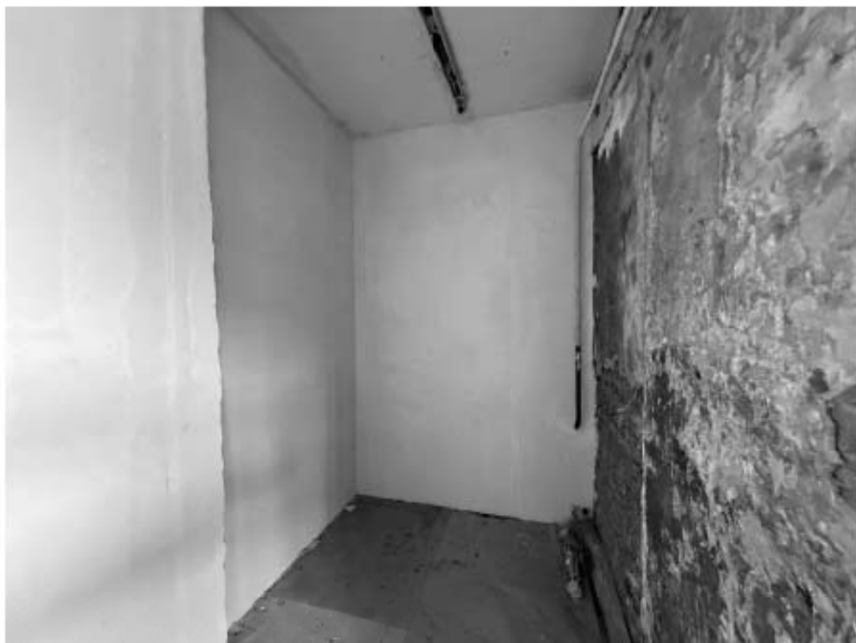
Фото 72. Помещение 6-Н. Комната.
