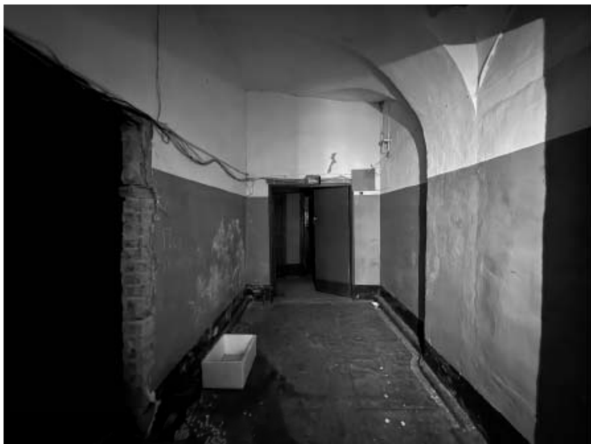
Фото 8. Помещение 5-Н. Коридор.
