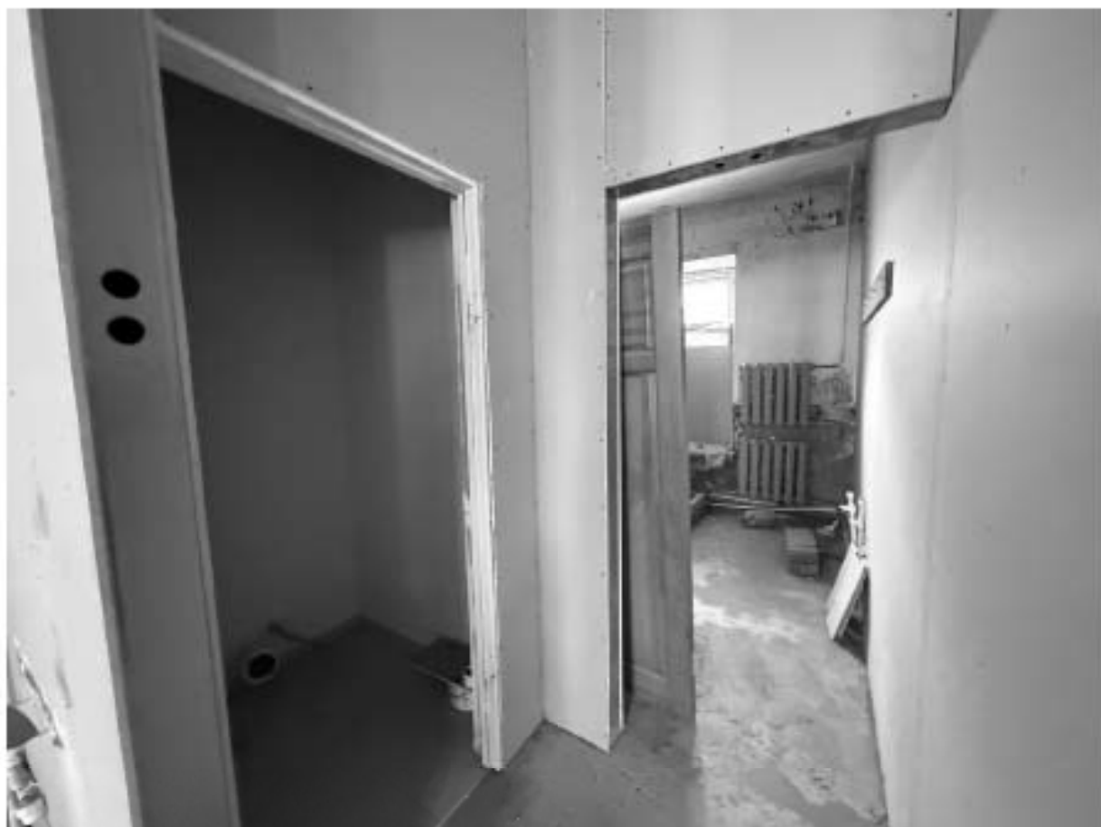
Фото 77. Помещение 6-Н. Комната.
