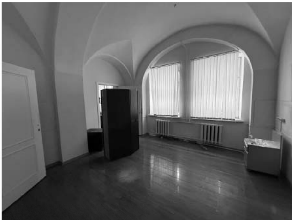
Фото 54. Помещение 7-Н. Комната.
