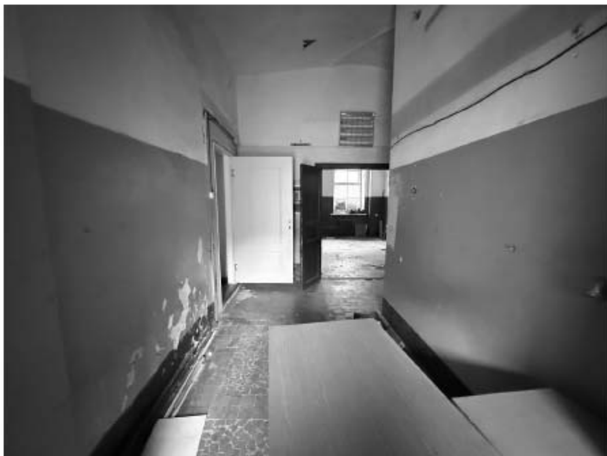
Фото 50. Помещение 5-Н. Коридор.
