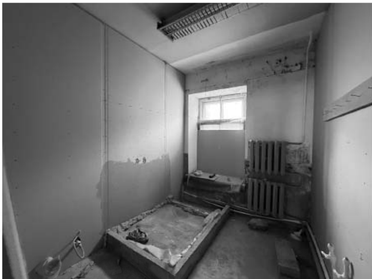
Фото 78. Помещение 6-Н. Комната.
