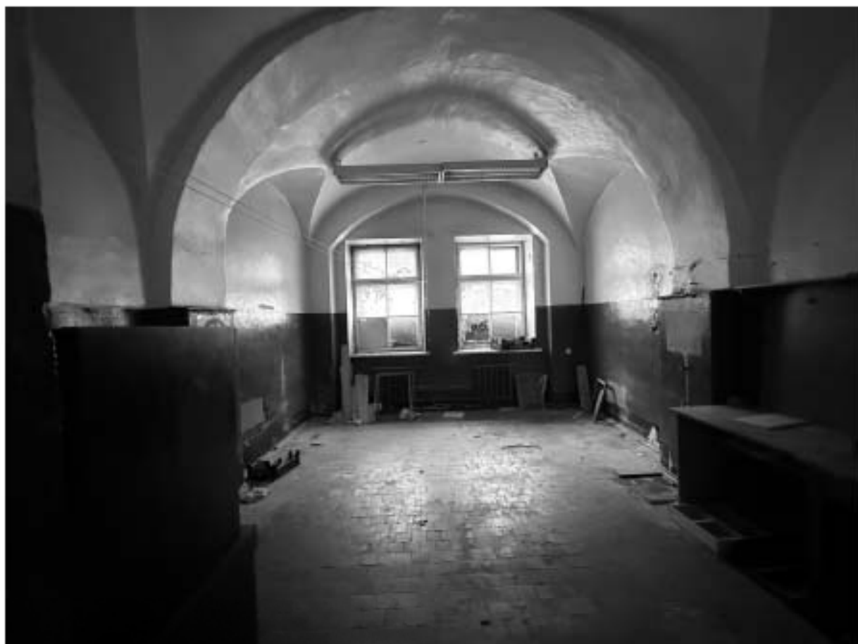
Фото 52. Помещение 5-Н. Комната.
