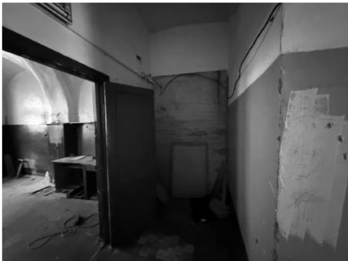
Фото 51. Помещение 5-Н. Коридор.
