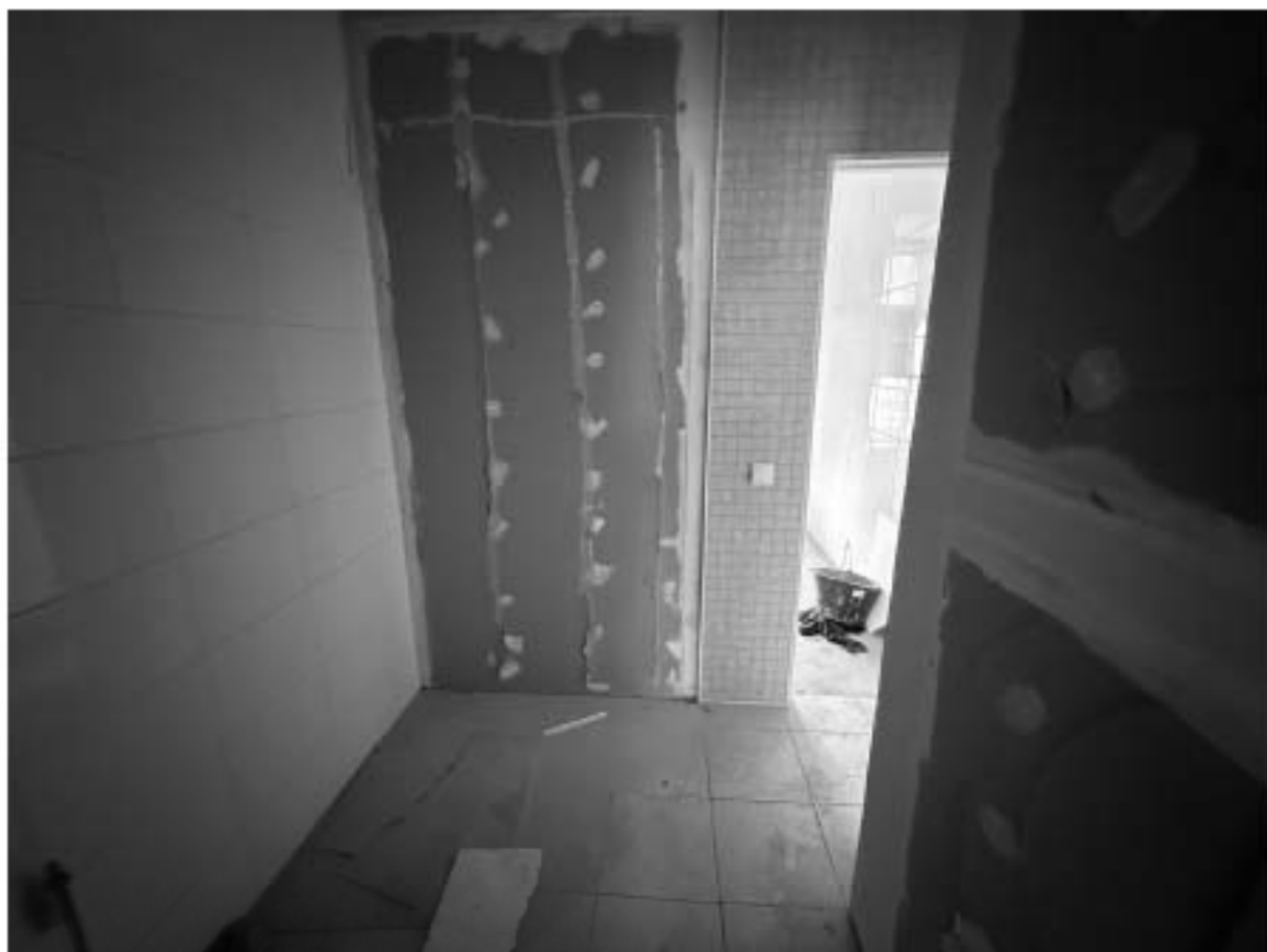
Фото 84. Помещение 6-Н. Комната.
