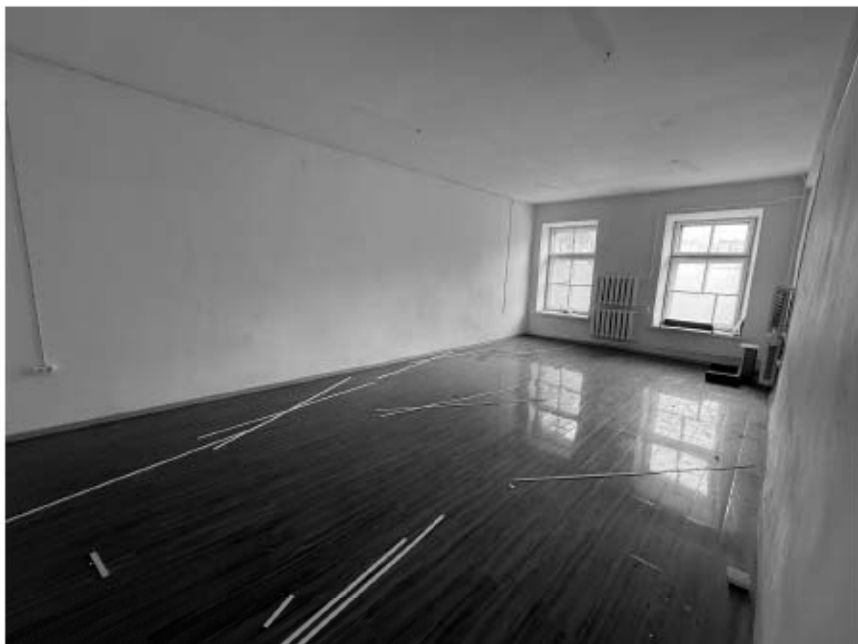
Фото 92. Помещение 6-Н. Комната.
