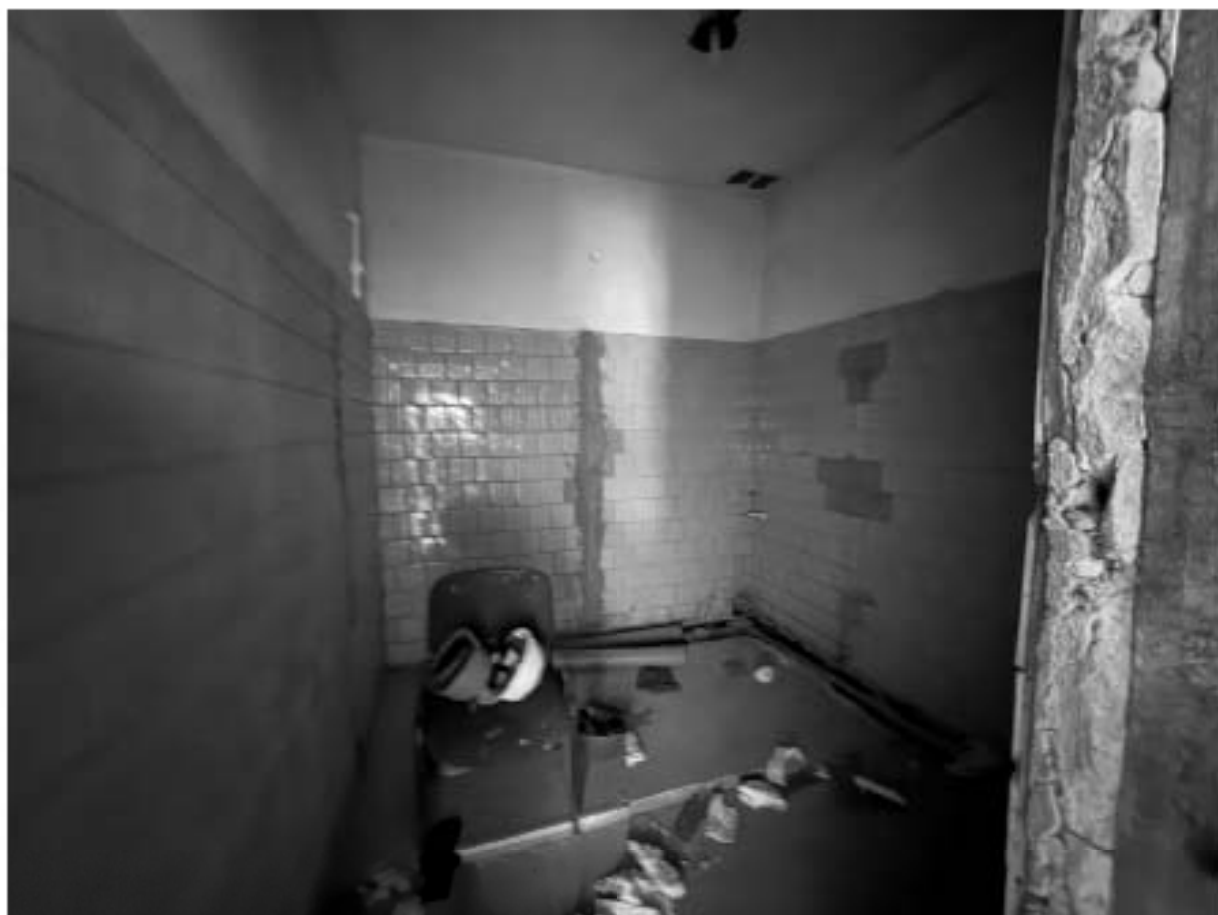
Фото 82. Помещение 6-Н. Комната.
