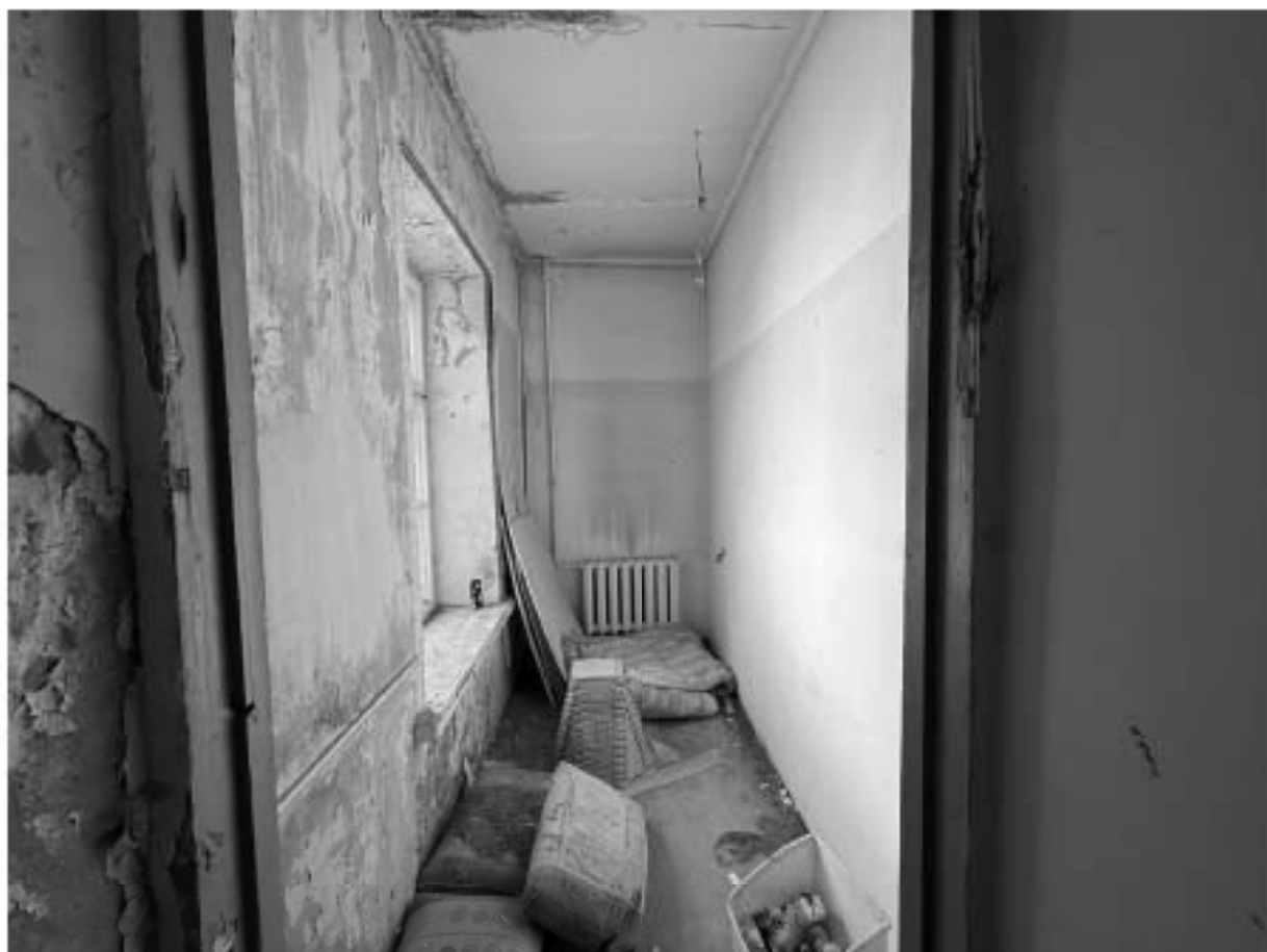
Фото 62. Помещение 6-Н. Комната.
