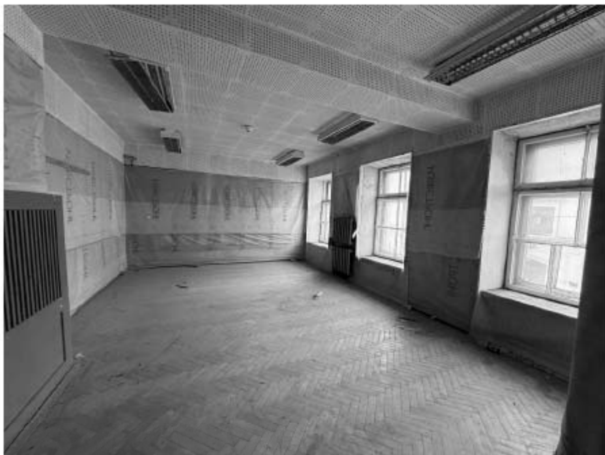
Фото 69. Помещение 6-Н. Комната.
