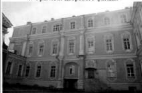
4. Фрагмент дворового фасада.
