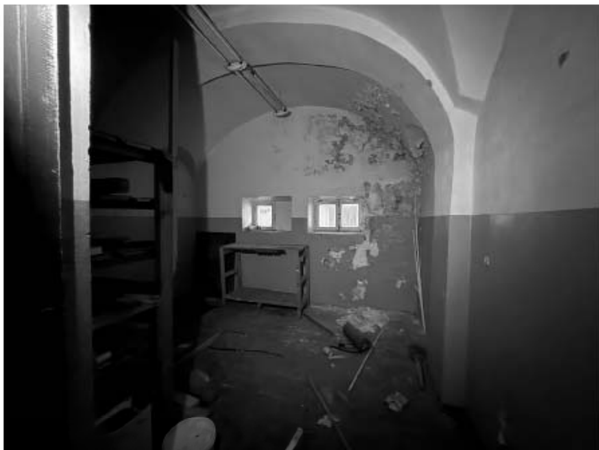
Фото 12. Помещение 5-Н. Комната.
