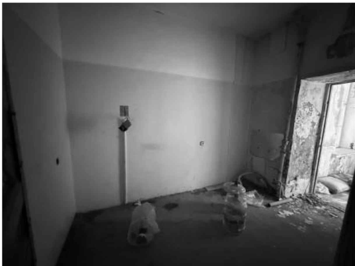
Фото 61. Помещение 6-Н. Комната.
