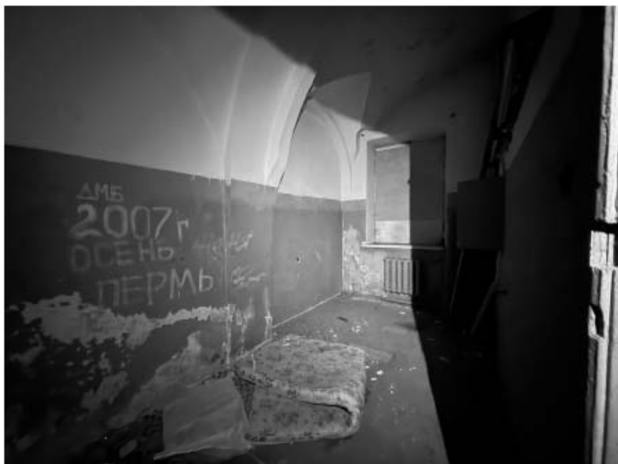
Фото 26. Помещение 5-Н. Комната.
