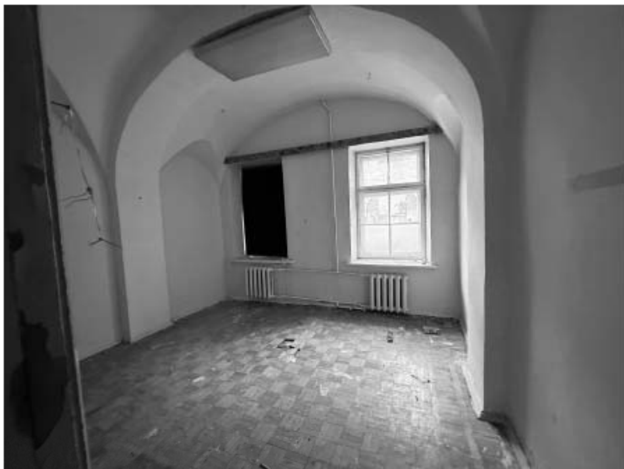
Фото 31. Помещение 5-Н. Комната.
