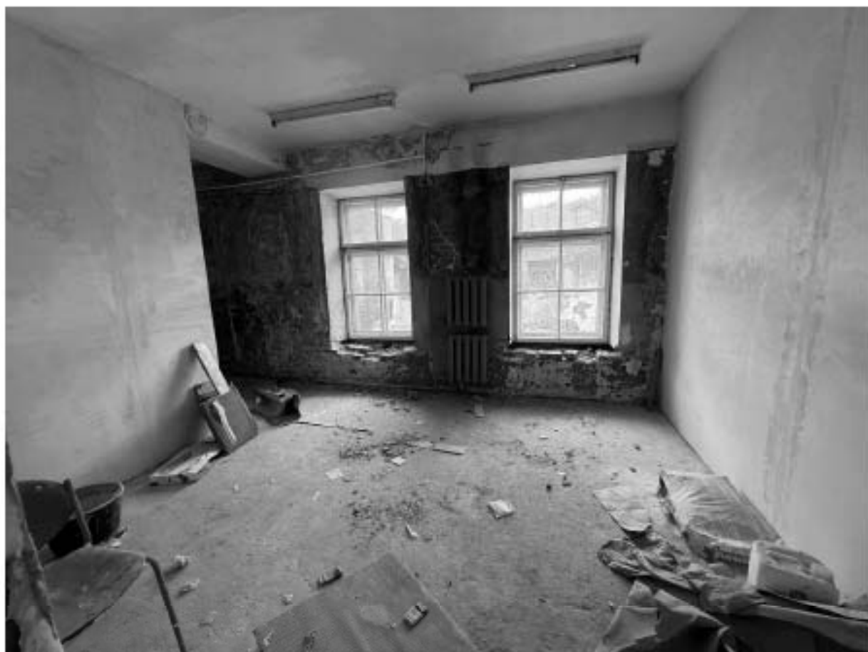
Фото 70. Помещение 6-Н. Комната.
