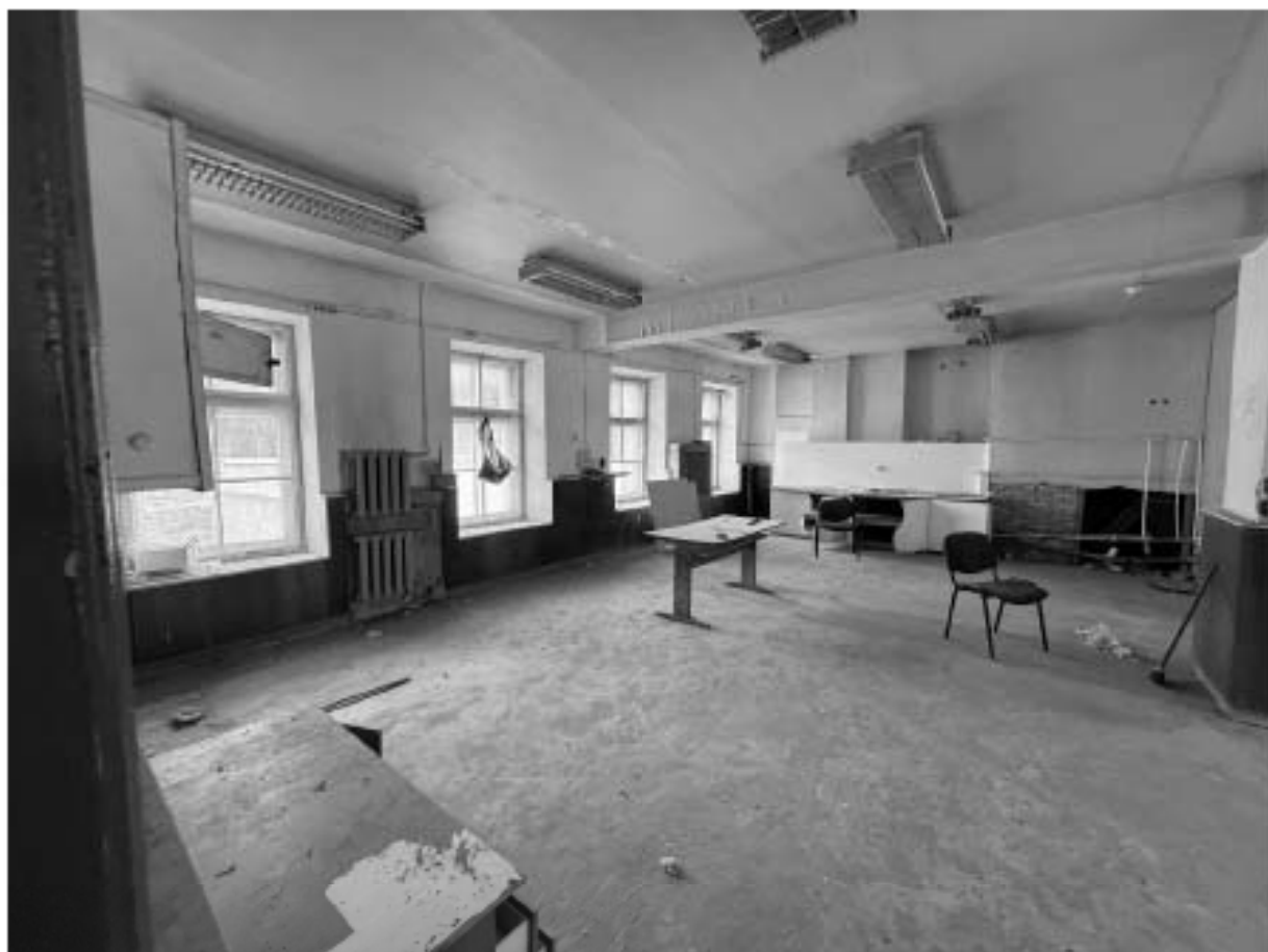
Фото 74. Помещение 6-Н. Комната.
