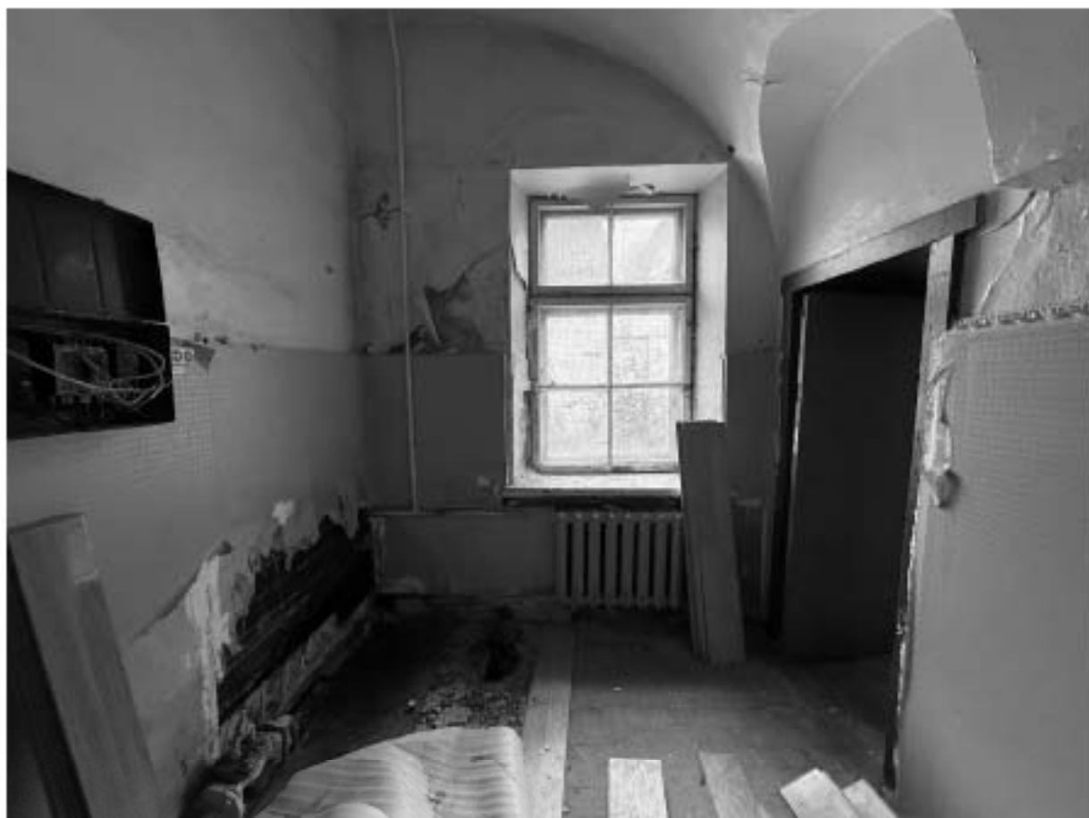
Фото 37. Помещение 5-Н. Комната.
