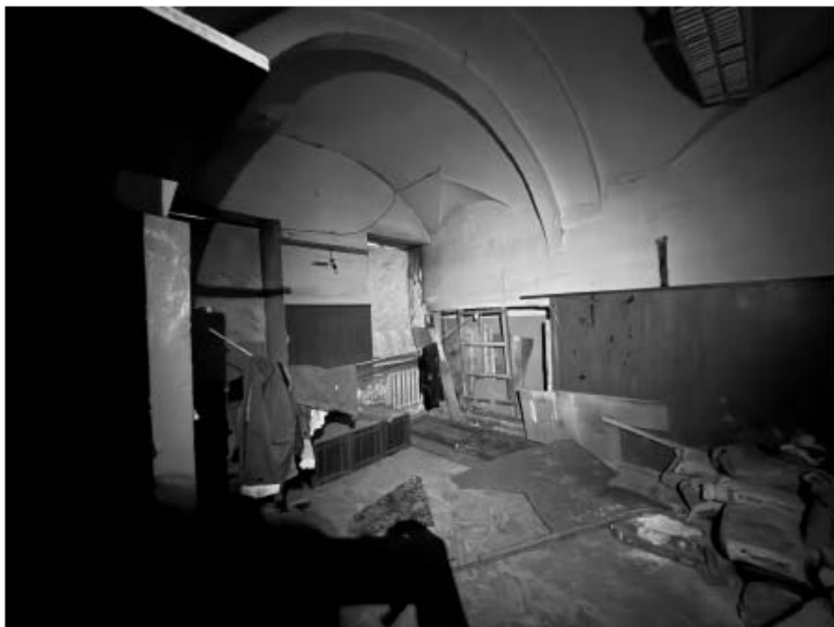
Фото 29. Помещение 5-Н. Комната.
