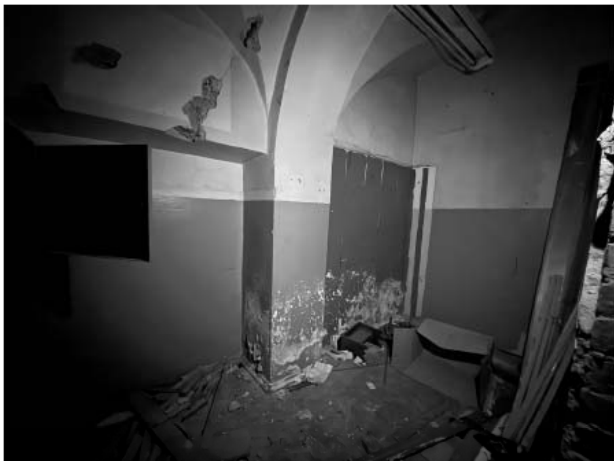
Фото 9. Помещение 5-Н. Комната, примыкающая к коридору.
