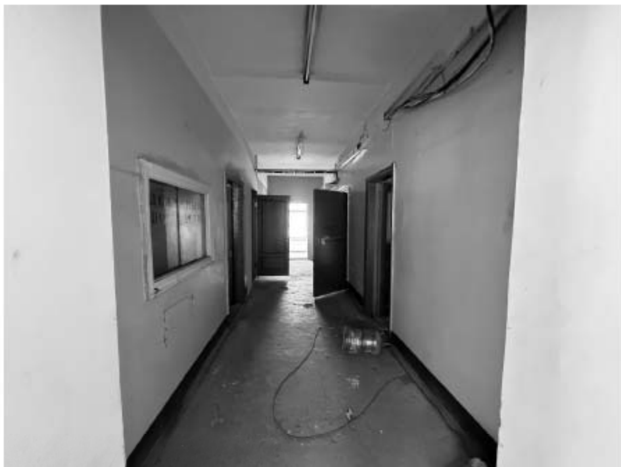
Фото 60. Помещение 6-Н. Коридор.
