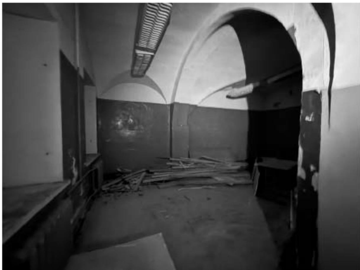
Фото 41. Помещение 5-Н. Коридор.
