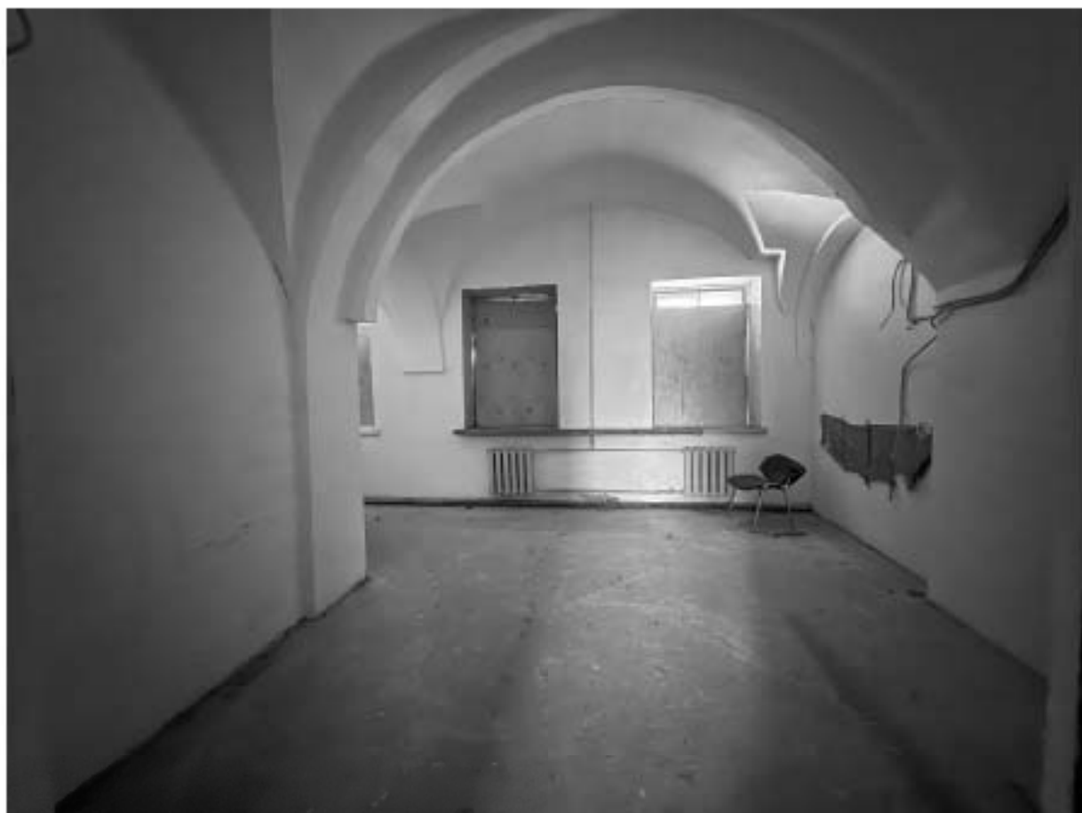
Фото 14. Помещение 5-Н. Комната.
