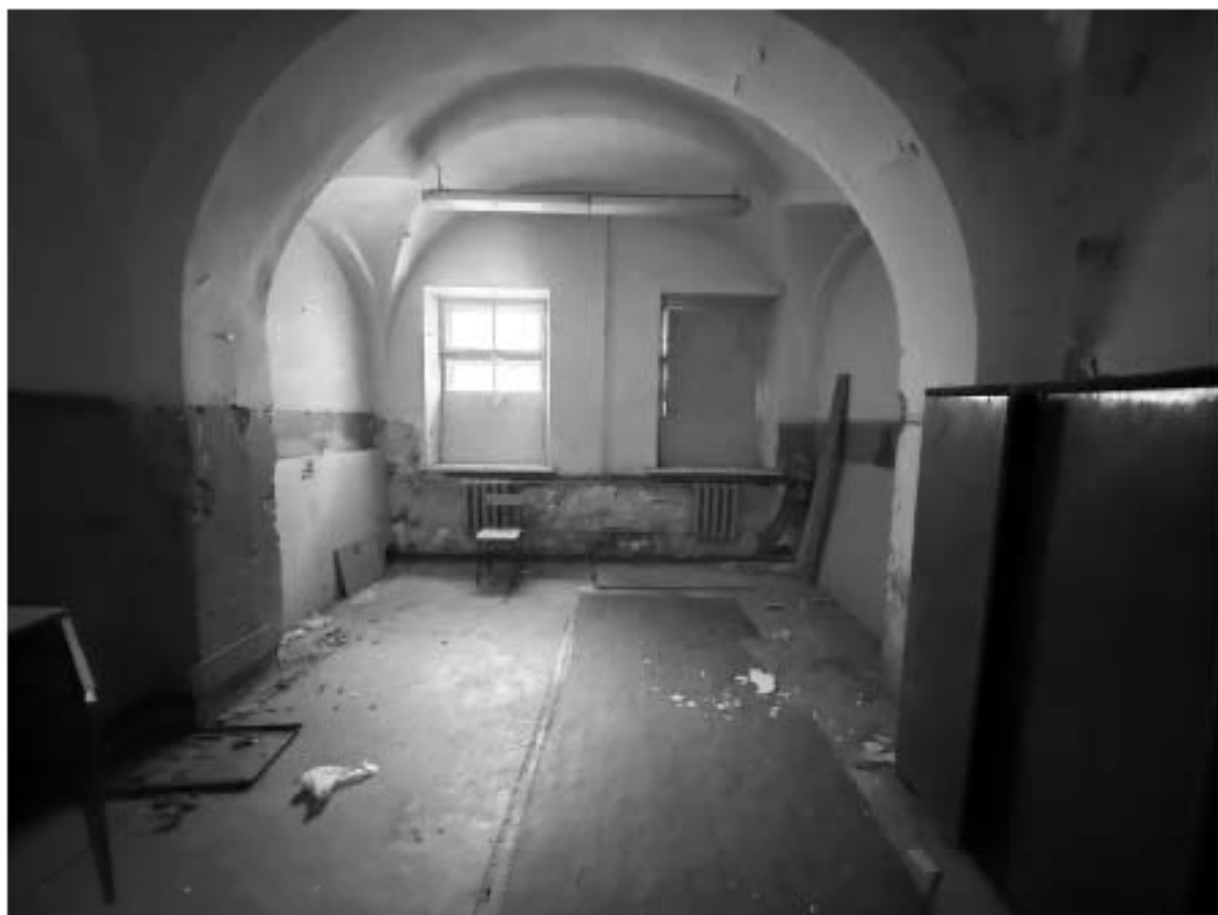
Фото 32. Помещение 5-Н. Комната.
