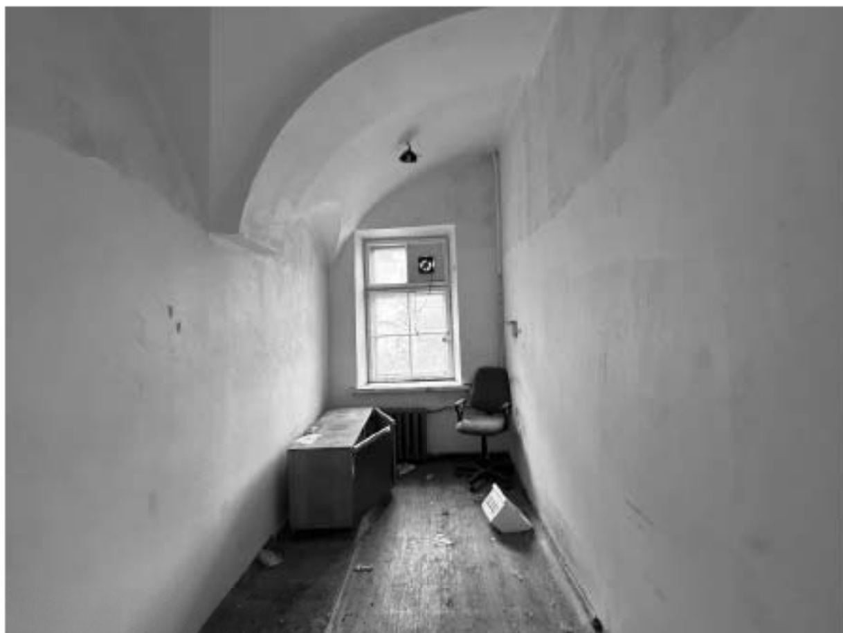
Фото 17. Помещение 5-Н. Комната.
