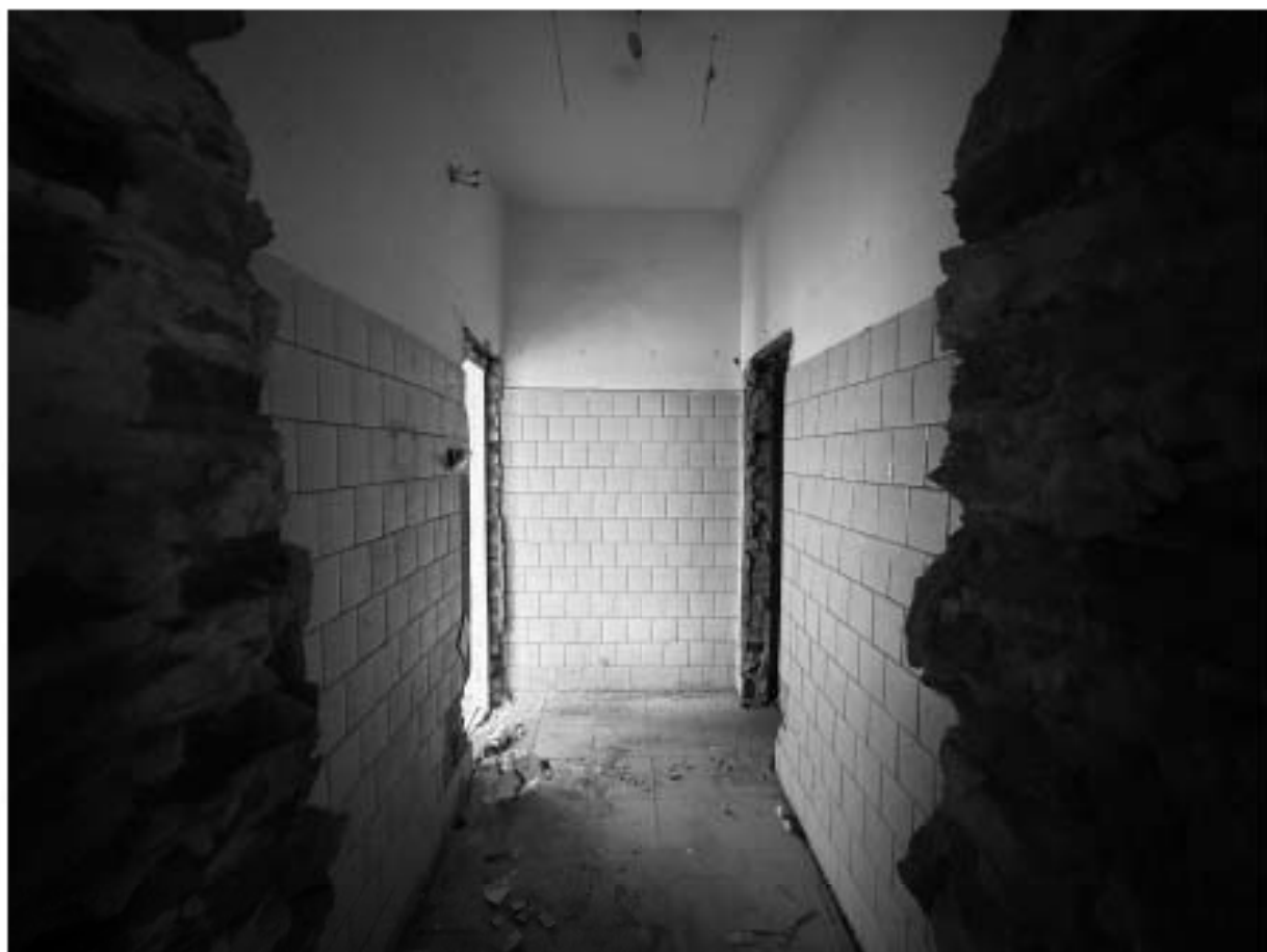
Фото 81. Помещение 6-Н. Комната.
