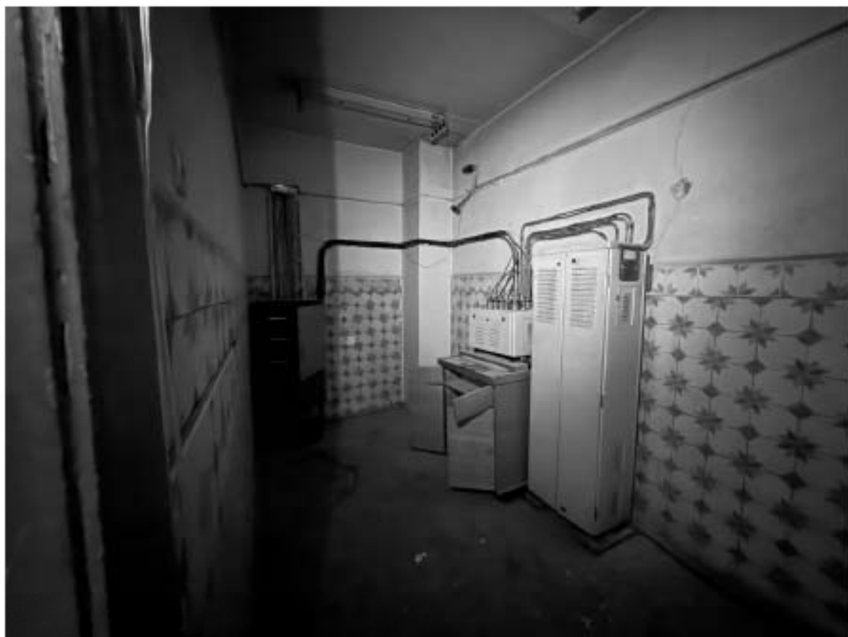
Фото 65. Помещение 6-Н. Комната.
