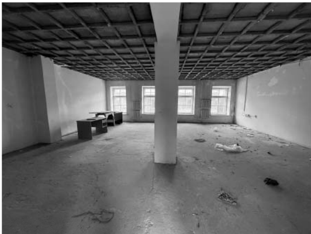
Фото 80. Помещение 6-Н. Комната.
