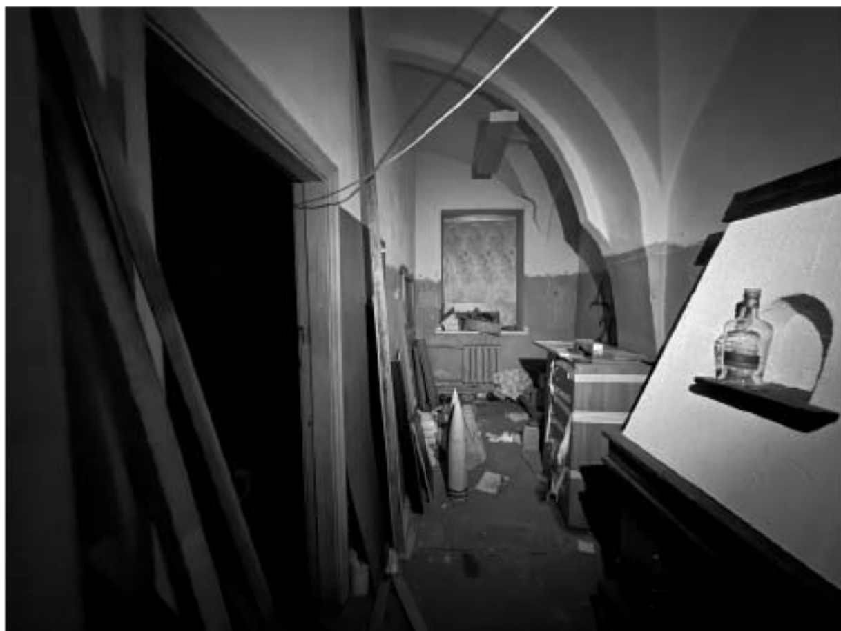
Фото 25. Помещение 5-Н. Комната.
