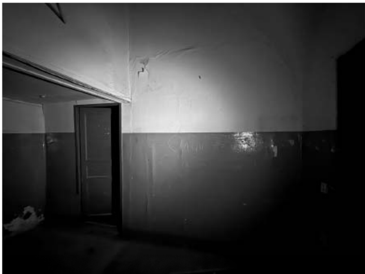
Фото 27. Помещение 5-Н. Комната.
