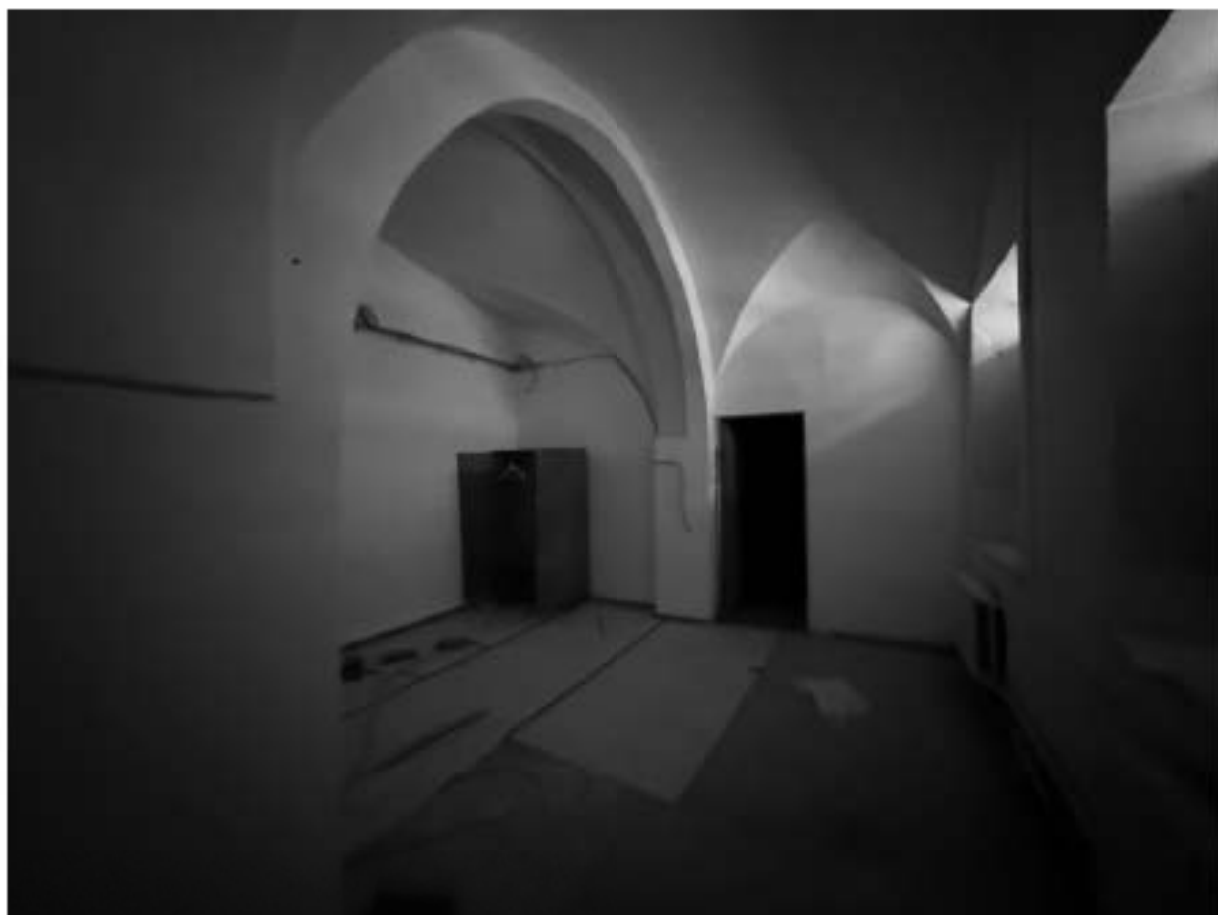
Фото 15. Помещение 5-Н. Комната.
