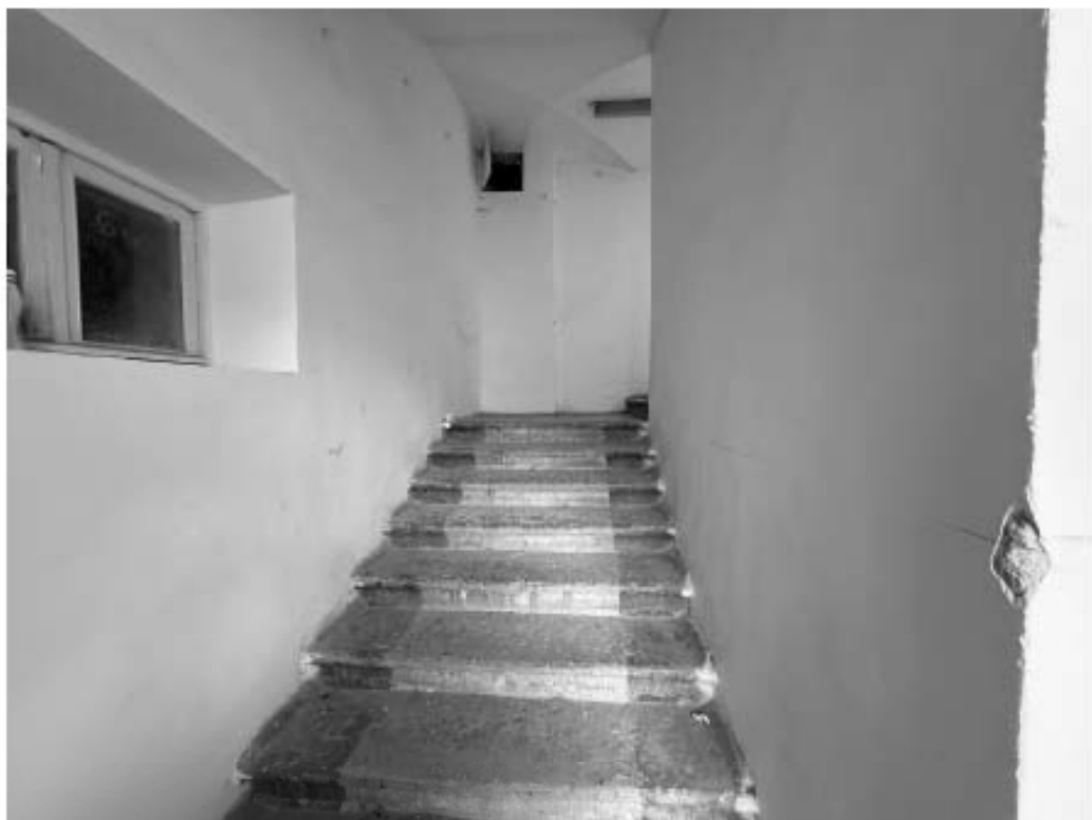
Фото 45. Помещение 6-Н. Лестничная клетка.
