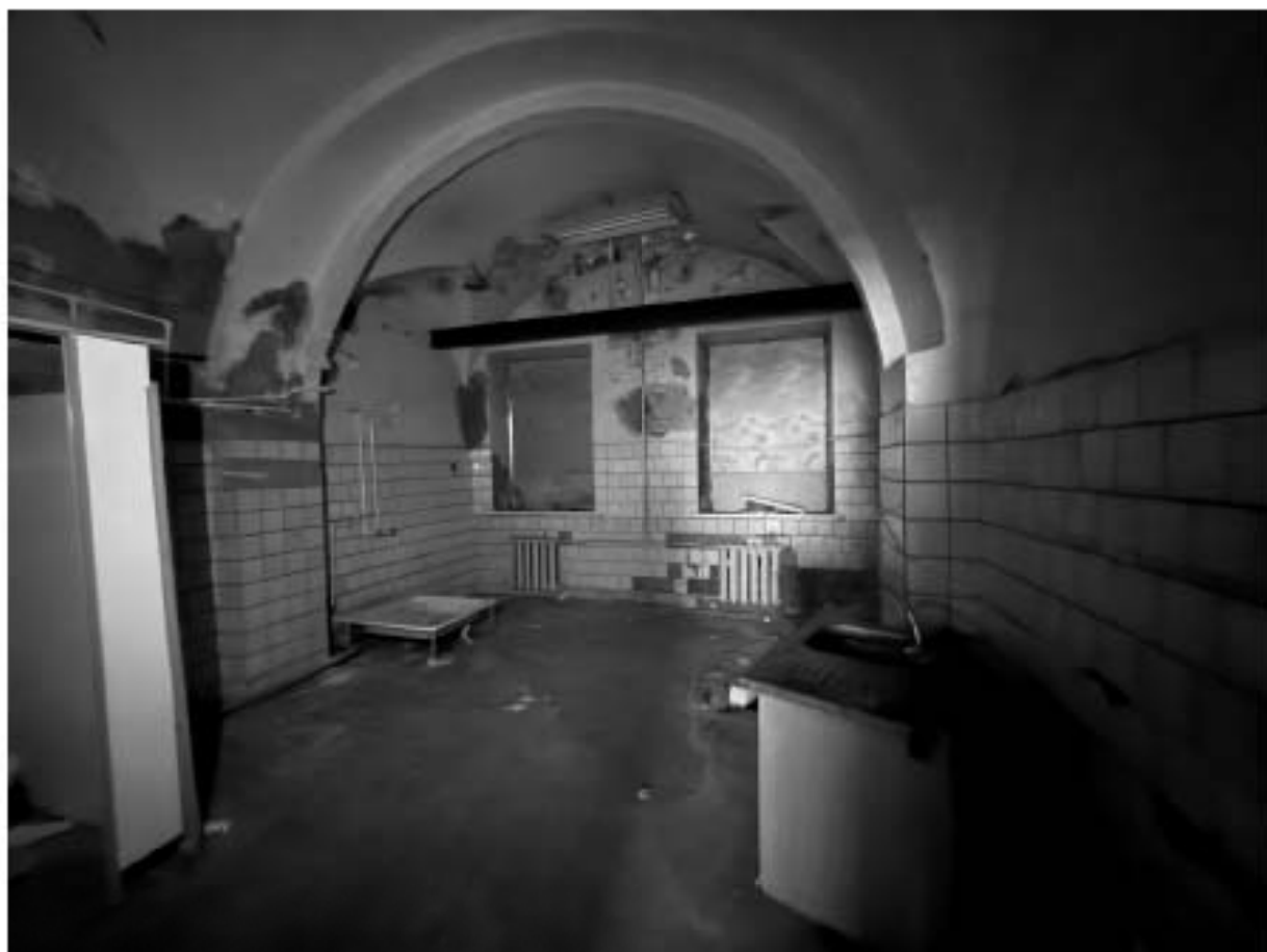
Фото 20. Помещение 5-Н. Комната.
