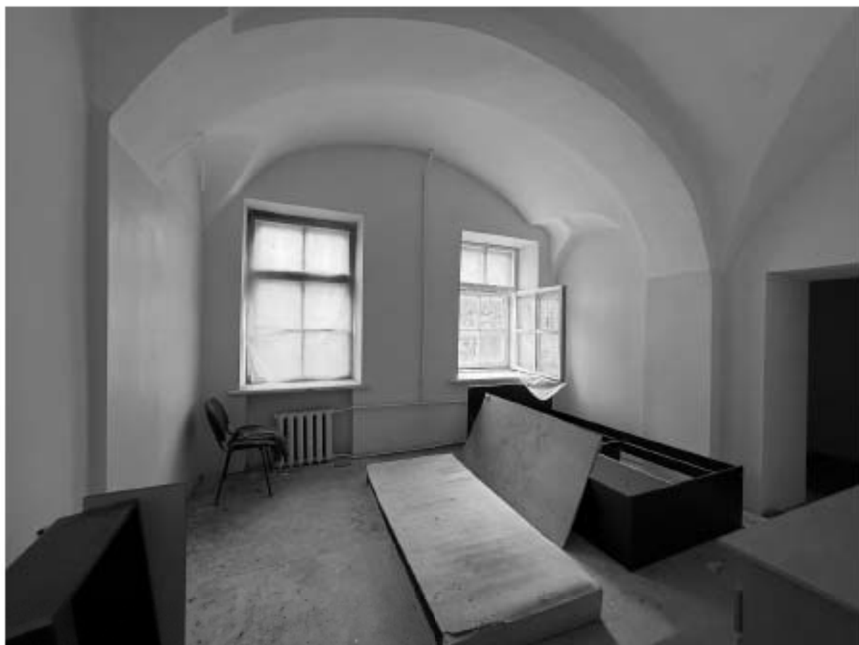
Фото 22. Помещение 5-Н. Комната.
