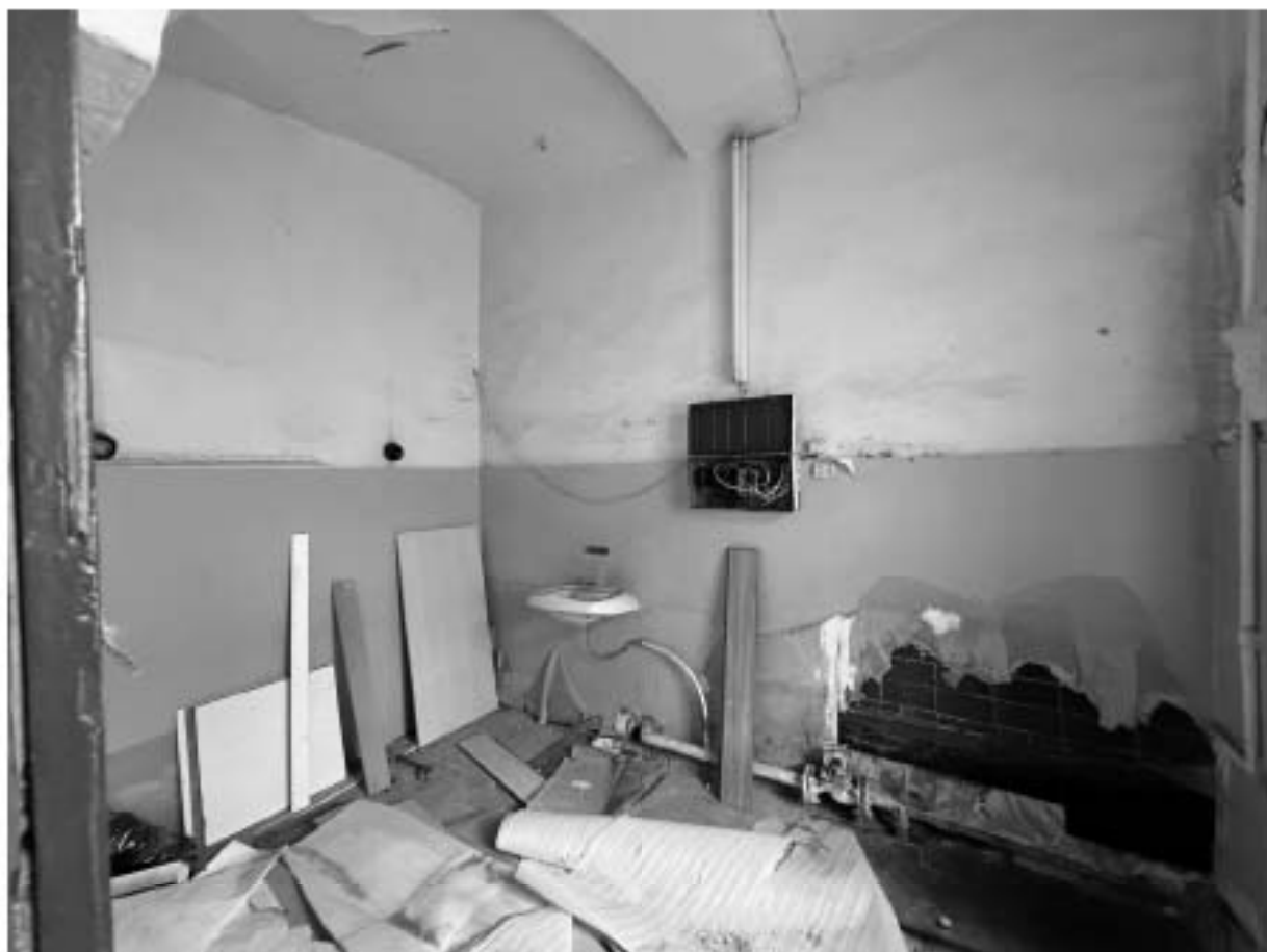
Фото 36. Помещение 5-Н. Комната.
