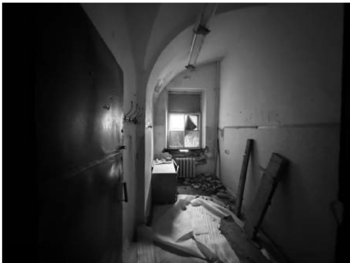
Фото 13. Помещение 5-Н. Комната.
