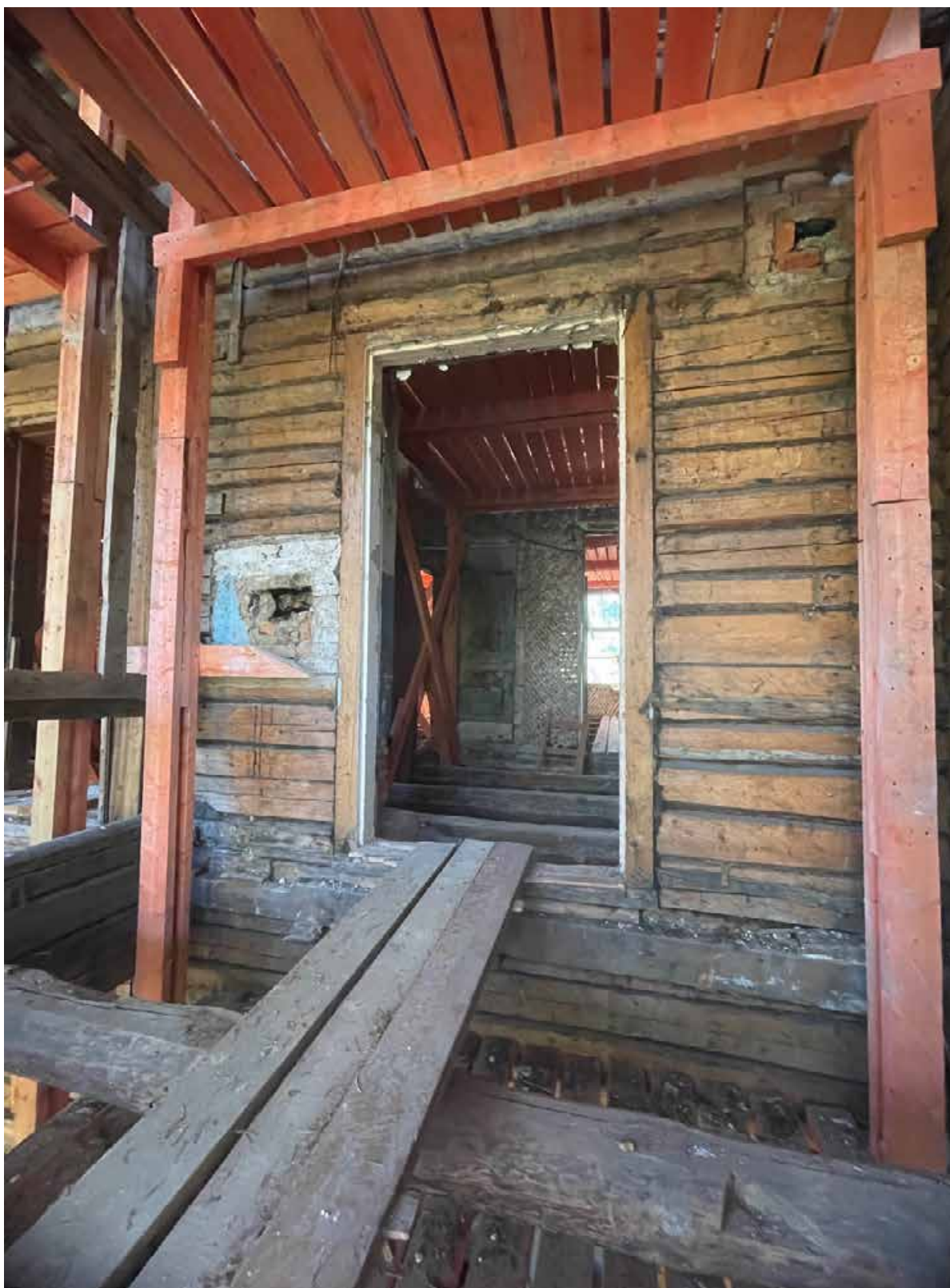
13. Вид интерьера здания
