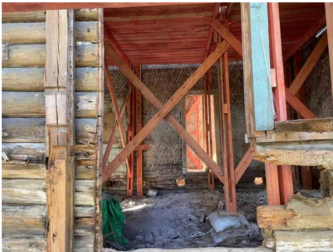
6. Вид интерьера здания
