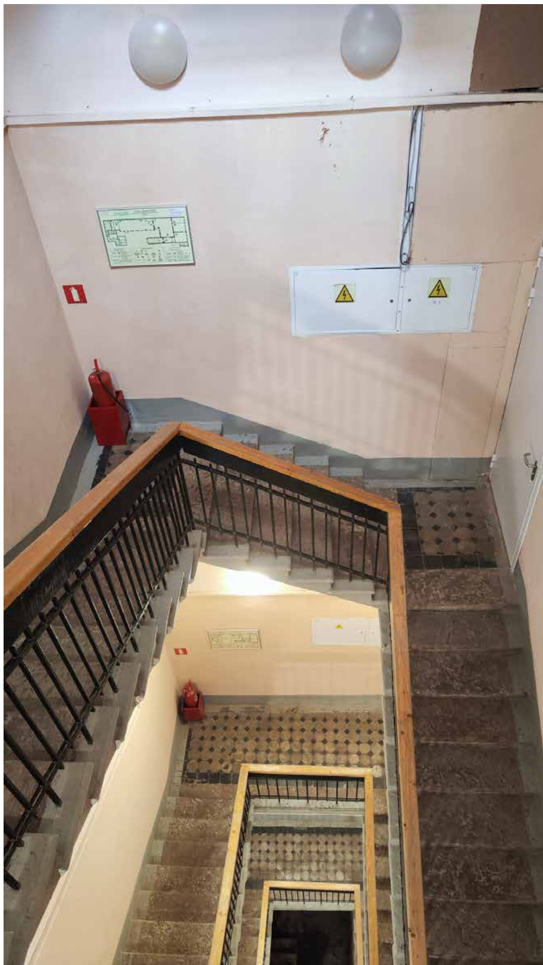
4. Вид на лестничную клетку
