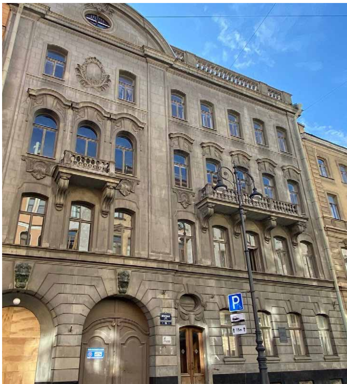
1. Вид на лицевой фасад здания №15
