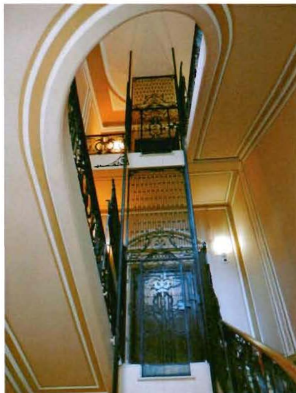
13. Кованое ограждение шахты лифта
