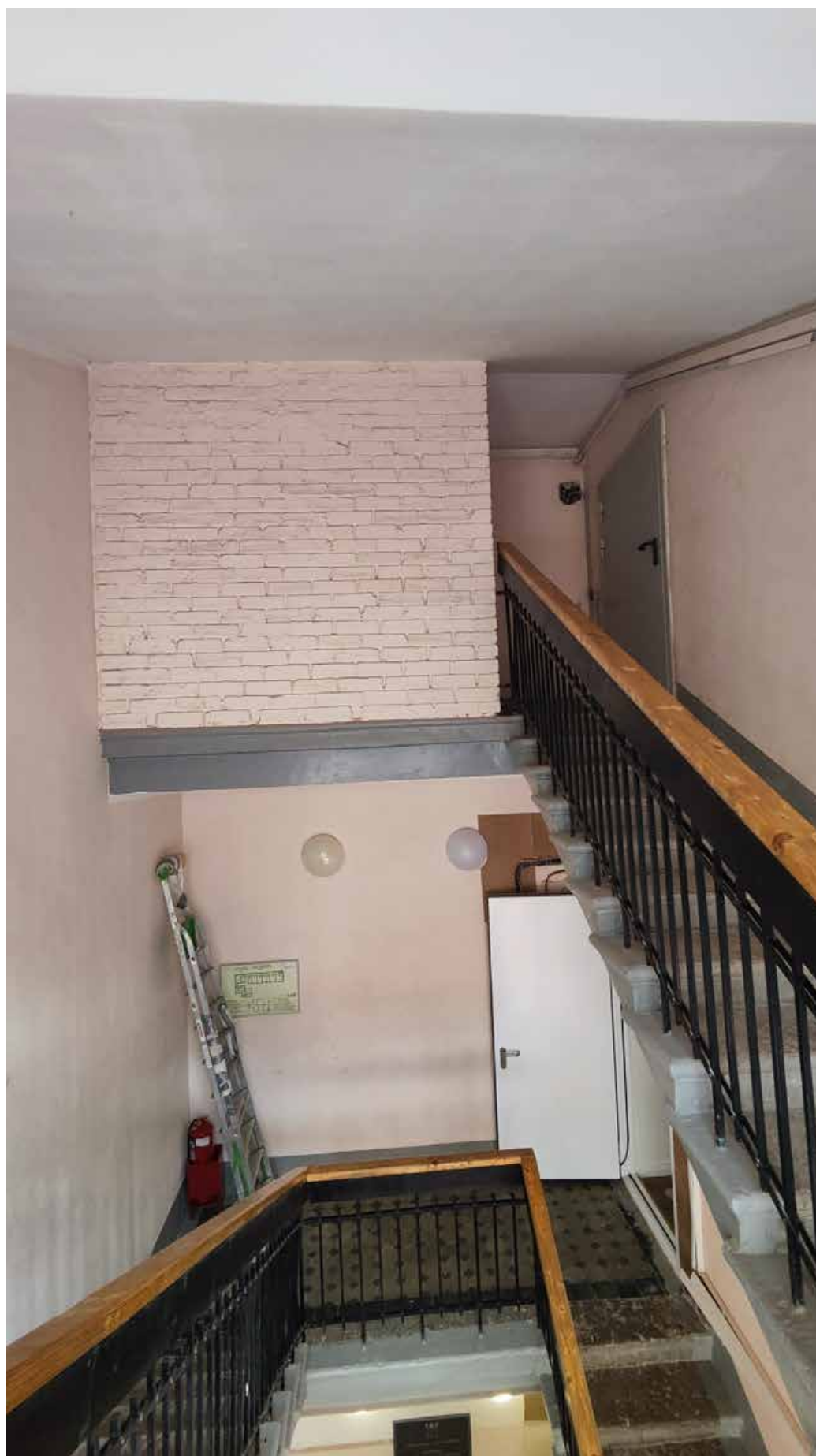
5. Вид на лестничную клетку
