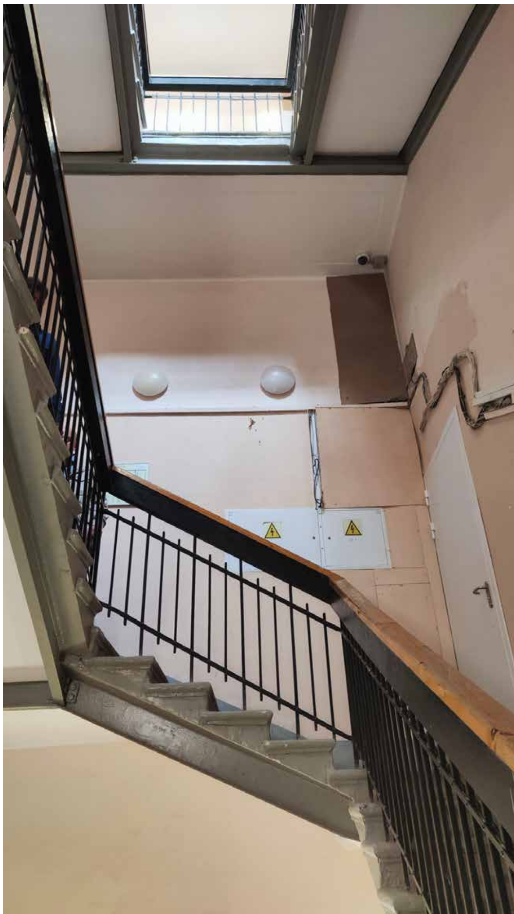
3. Вид на лестничную клетку
