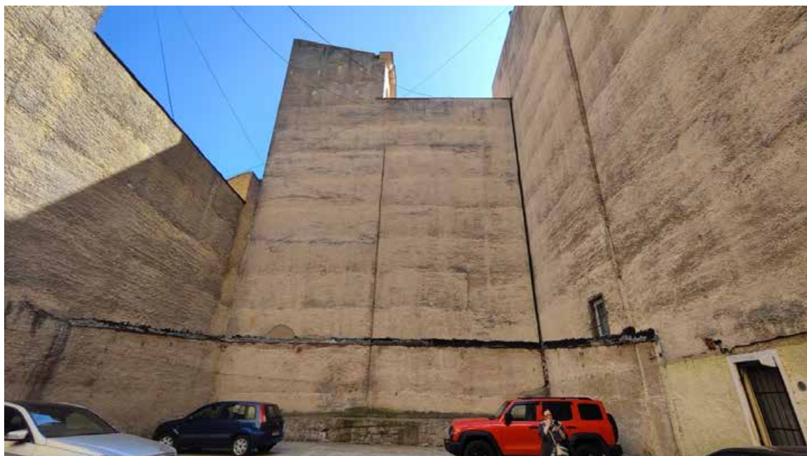
2. Вид на брандмауэрные стены здания
