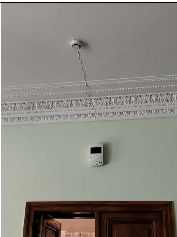
9. «Дом жилой с флигелями» (в составе «Дом Варгунина К.А.»). 1 этаж. Помещение 1-Н (3). Фрагмент
