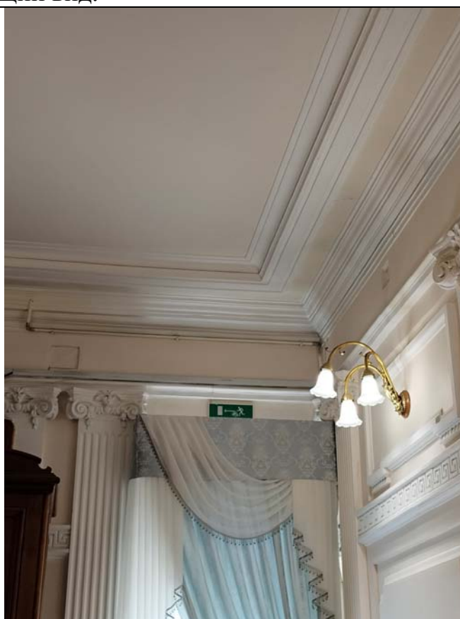
14. «Дом жилой с флигелями» (в составе «Дом Варгунина К.А.»). 1 этаж. Помещение 1-Н (2).
