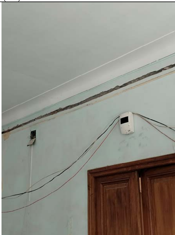
12. «Дом жилой с флигелями» (в составе «Дом Варгунина К.А.»). 1 этаж. Помещение 1-Н (15).
