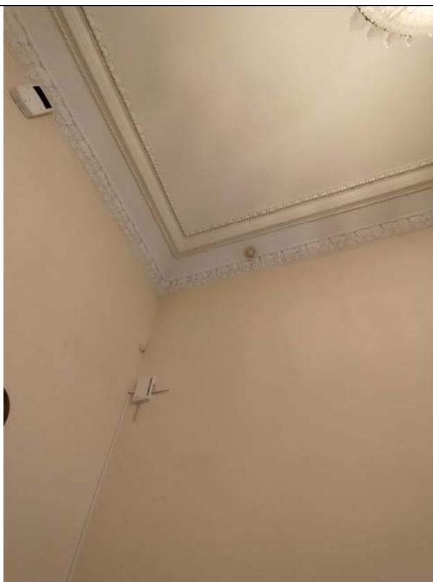
30. «Дом жилой с флигелями» (в составе «Дом Варгунина К.А.»). 2 этаж. Помещение 1-Н (19)
