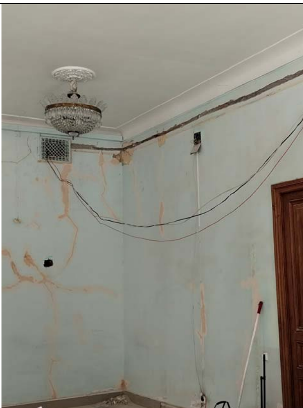
11. «Дом жилой с флигелями» (в составе «Дом Варгунина К.А.»). 1 этаж. Помещение 1-Н (15).
