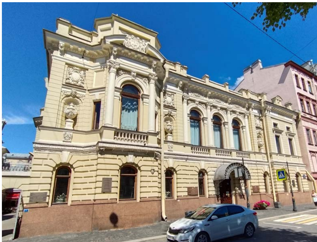
1. «Дом жилой с флигелями» (в составе «Дом Варгунина К.А.»). Лицевой фасад по Фурштатской ул.
