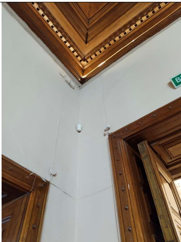
21. «Дом жилой с флигелями» (в составе «Дом Варгунина К.А.»). 2 этаж. Помещение 1-Н (42). Фрагмент.
