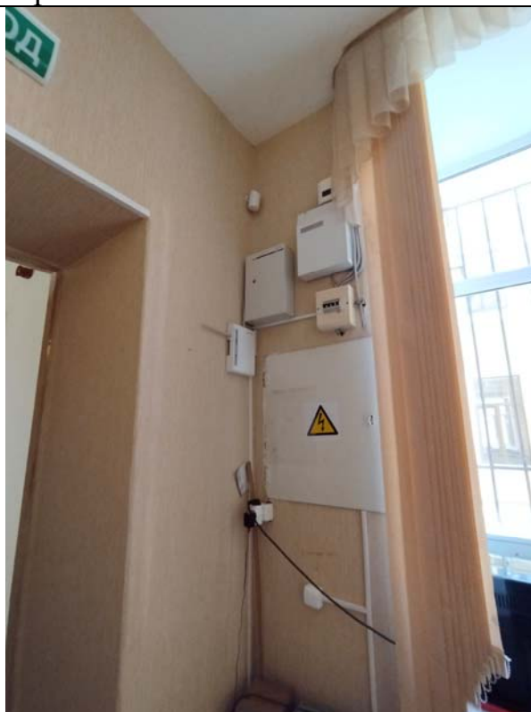
22. «Дом жилой с флигелями» (в составе «Дом Варгунина К.А.»). 2 этаж. Помещение 1-Н (18).
