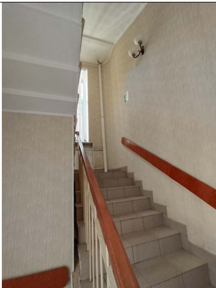
17. «Дом жилой с флигелями» (в составе «Дом Варгунина К.А.»). 1 этаж. Служебная лестница.
