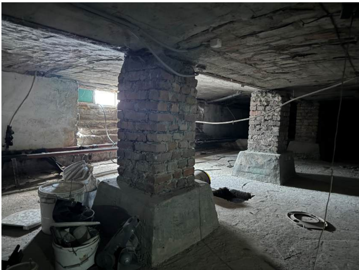
Фото 61. Вид на подвальные помещения.
