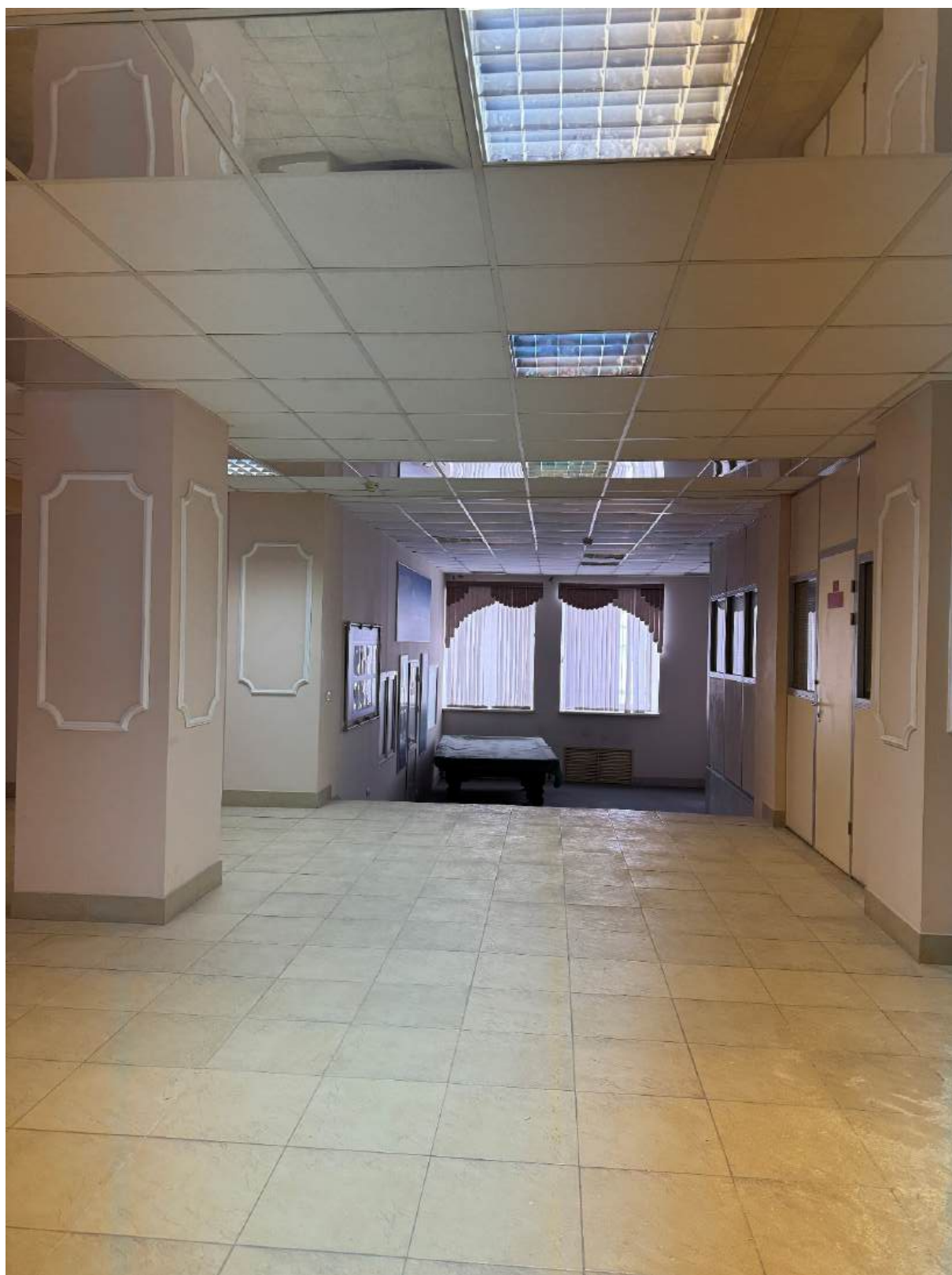
Фото 101. Вид на интерьер холла лестницы 3-ЛК.
