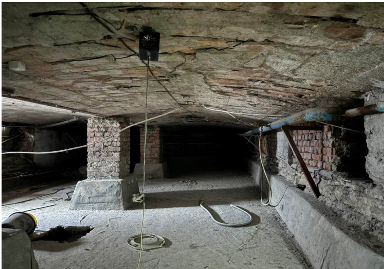
Фото 62. Вид на подвальные помещения.
