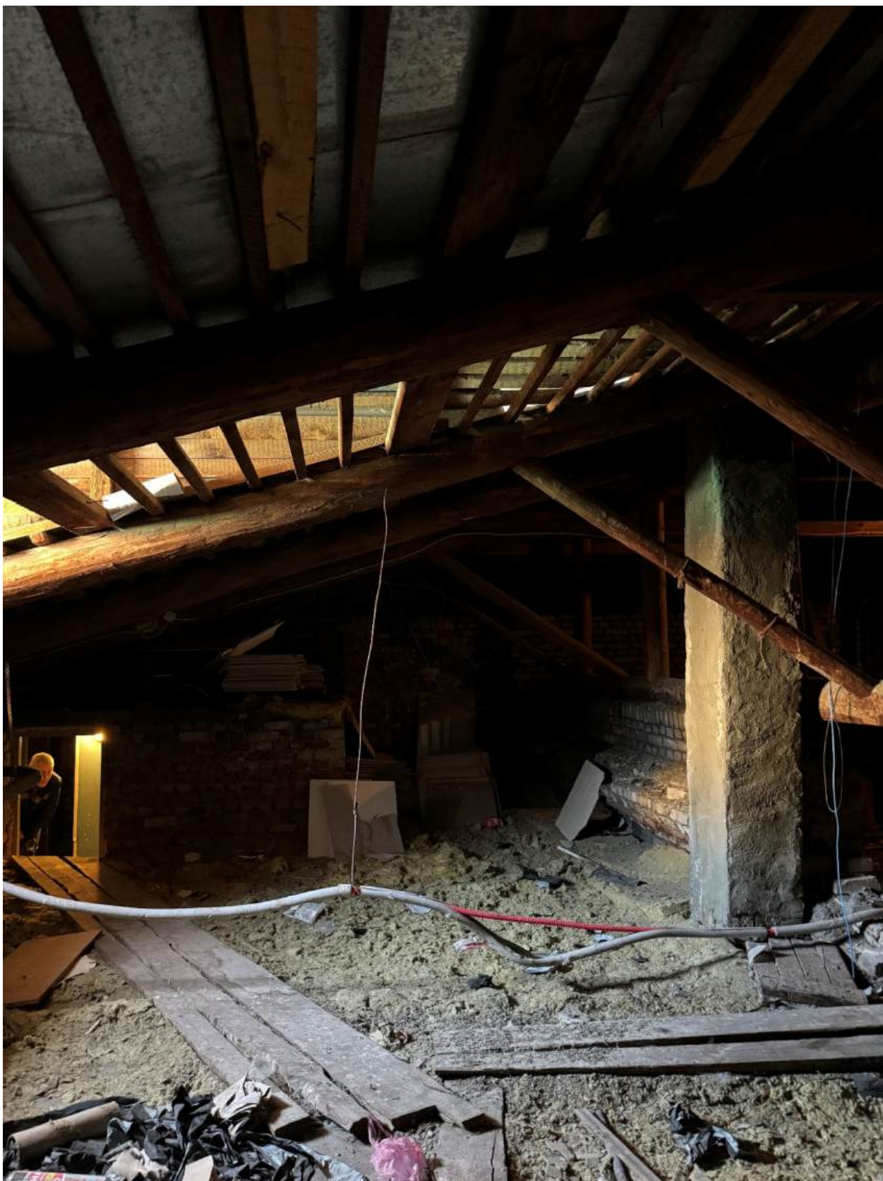
Фото 37. Вид на чердачные помещения.
