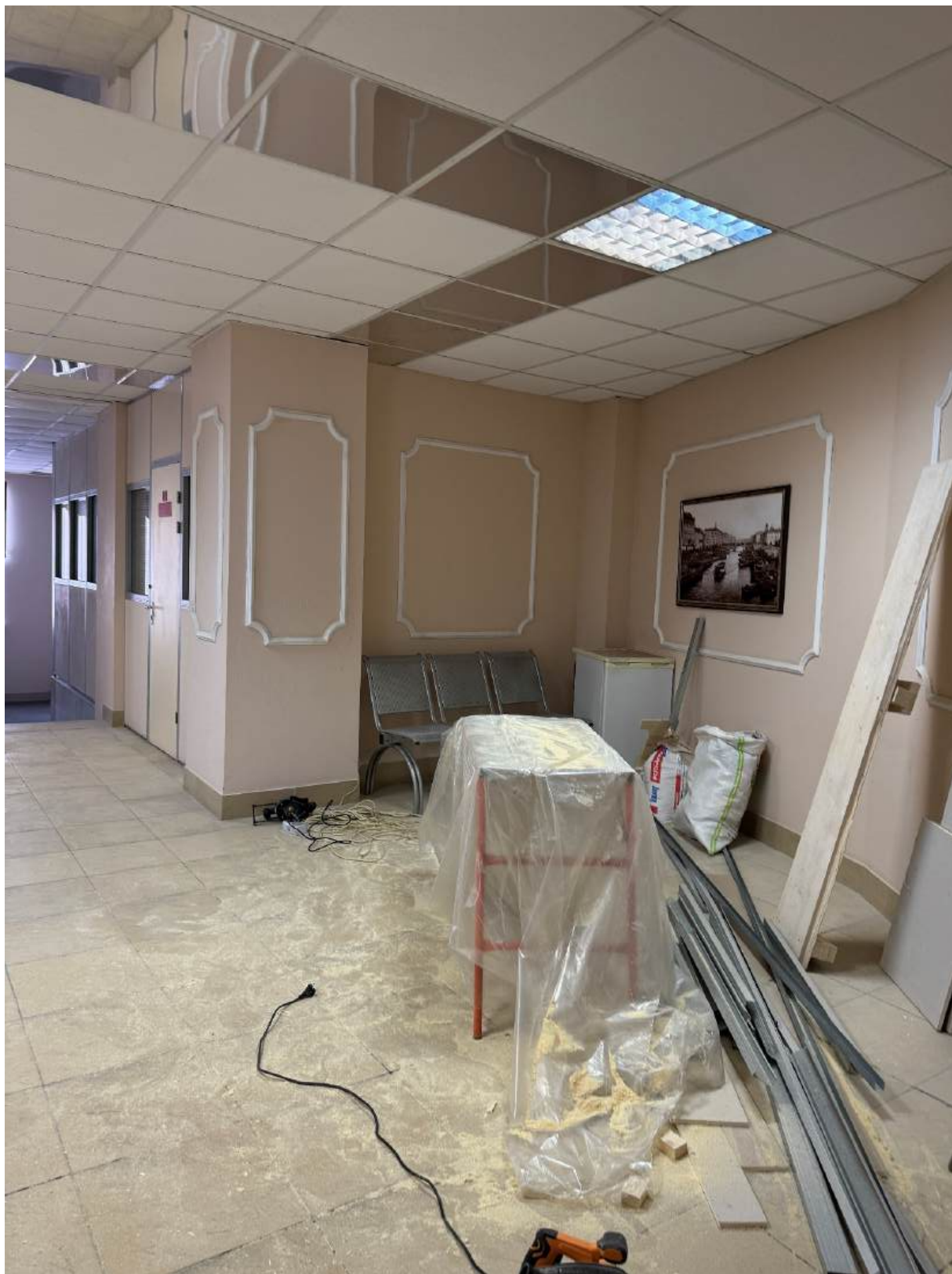
Фото 100. Вид на интерьер холла лестницы 3-ЛК.
