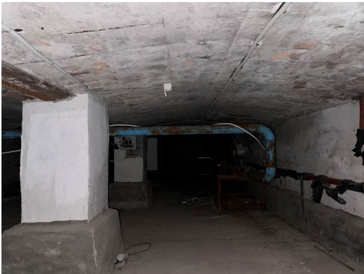
Фото 58. Вид на подвальные помещения.
