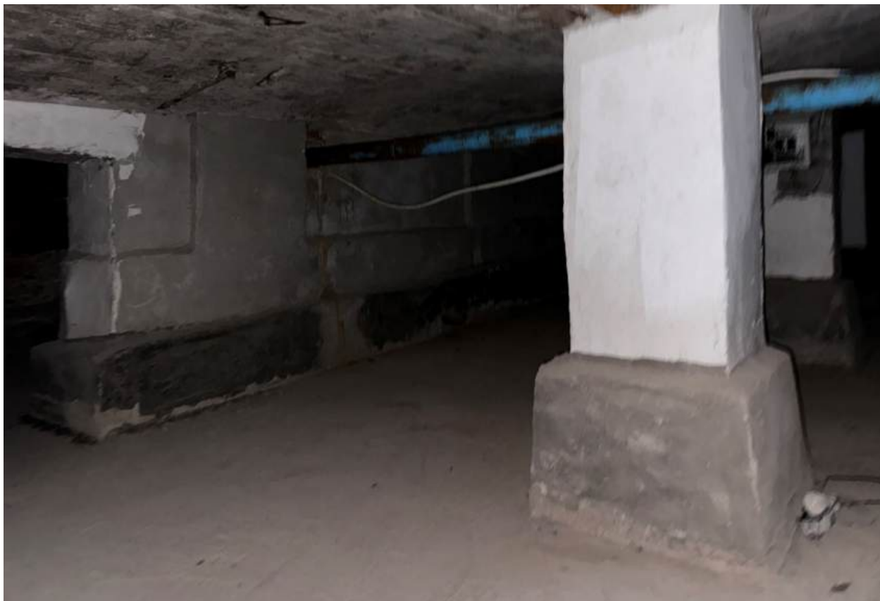
Фото 57. Вид на подвальные помещения.
