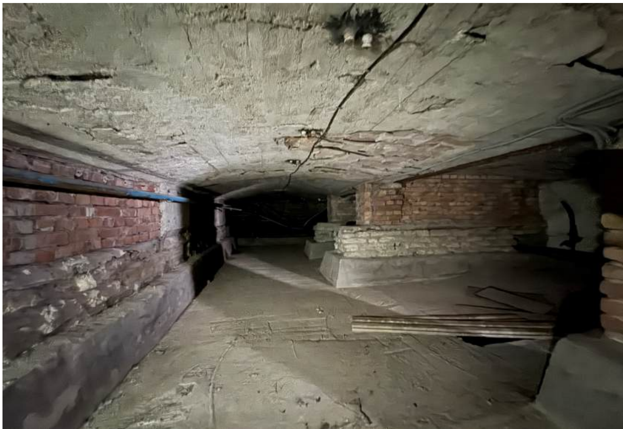
Фото 63. Вид на подвальные помещения.
