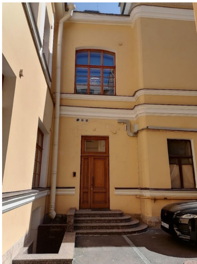
Фото 5. Фрагмент дворового фасада в осях 2/Е-Ж ОКН «Дома кн. Л.Д. Вяземского» двухэтажного корпуса по Английской набережной – служебный вход.
