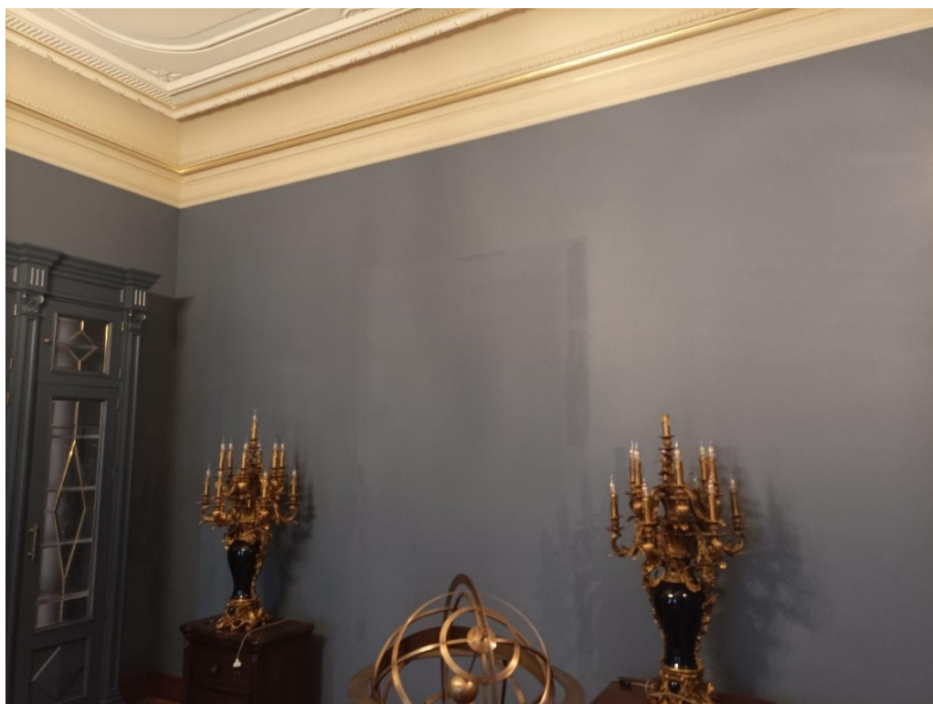
Фото 17. Стена кабинета 2-го этажа в восточной части северной анфилады объекта культурного наследия регионального значения «Дома кн. Л.Д. Вяземского»
