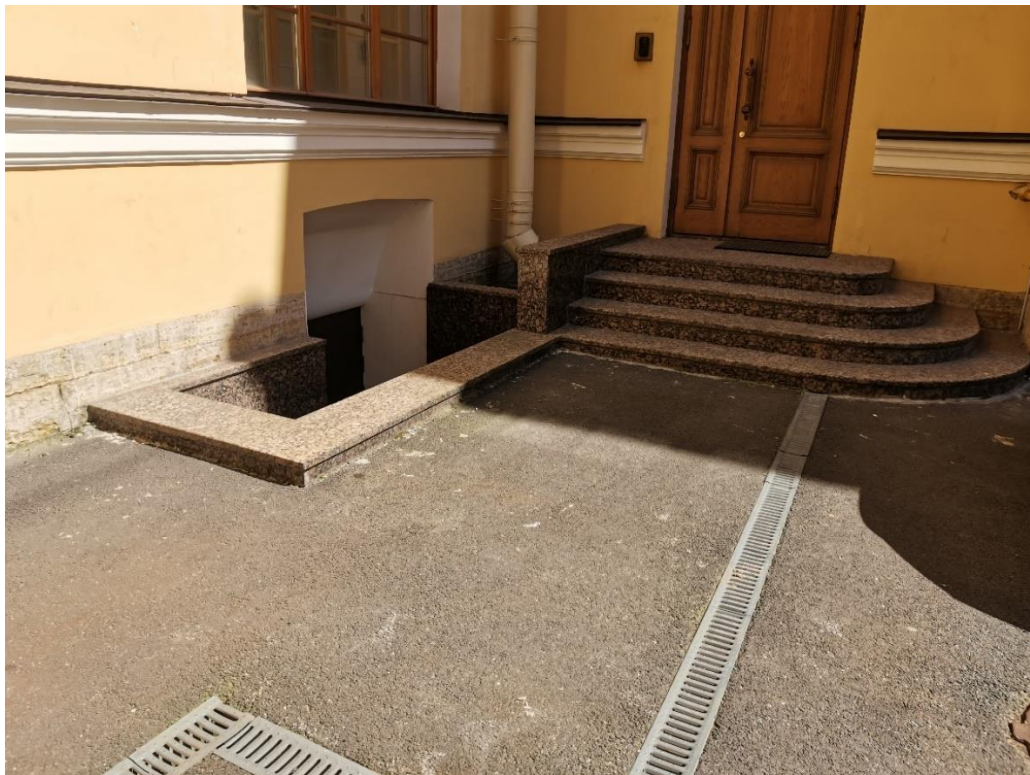
Фото 10. Прямок в подвал дворового фасада в осях 2-3/Е и водоотводящие лотки у служебного входа ОКН «Дома кн. Л.Д. Вяземского» двухэтажного корпуса по Английской набережной.
