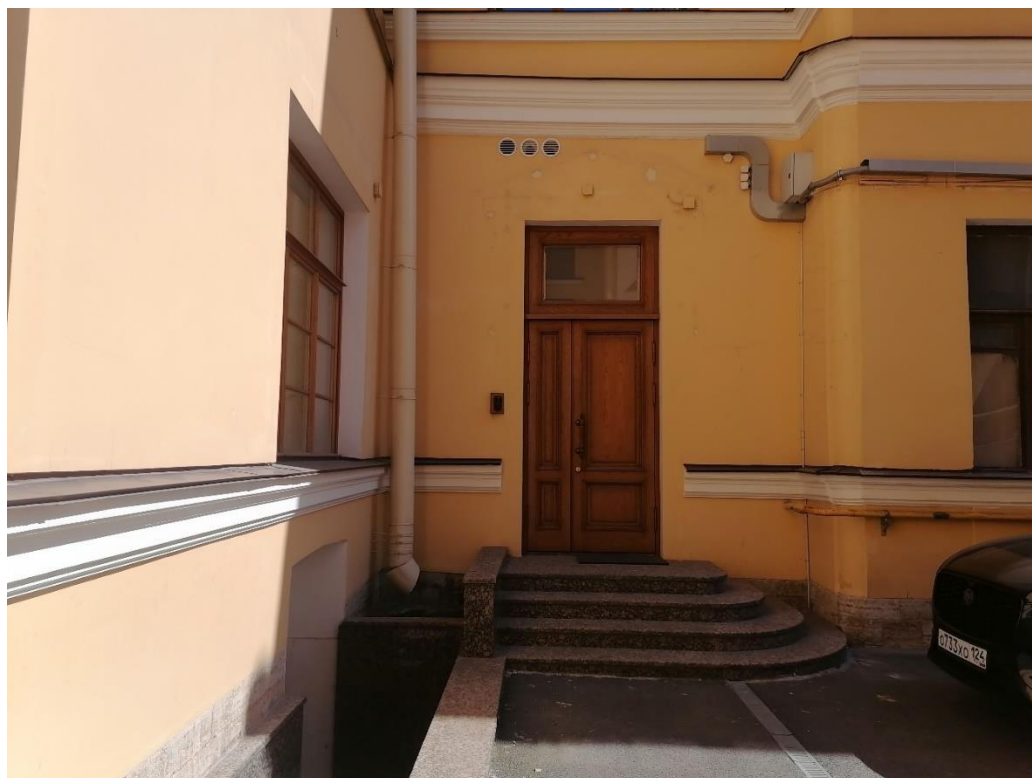
Фото 6. Служебный вход дворового фасада осях 2/Е-Ж и прямом входа в подвал в осях 2-3/Е ОКН «Дома кн. Л.Д. Вяземского» двухэтажного корпуса по Английской набережной.
