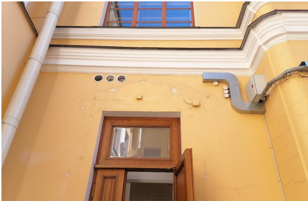
Фото 8. Межэтажная тяга над служебным входом дворового фасада осях 2/Е-Ж ОКН «Дома кн. Л.Д. Вяземского» двухэтажного корпуса по Английской набережной.
