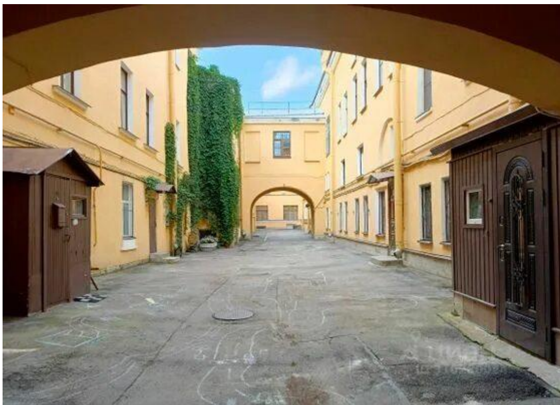
Фото 2. Дворовая территория объекта культурного наследия регионального значения «Дома кн. Л.Д. Вяземского» по адресу: Санкт-Петербург, ул. Галерная д.67 /Английская наб. д.66. Вид со стороны Галерной улицы.
