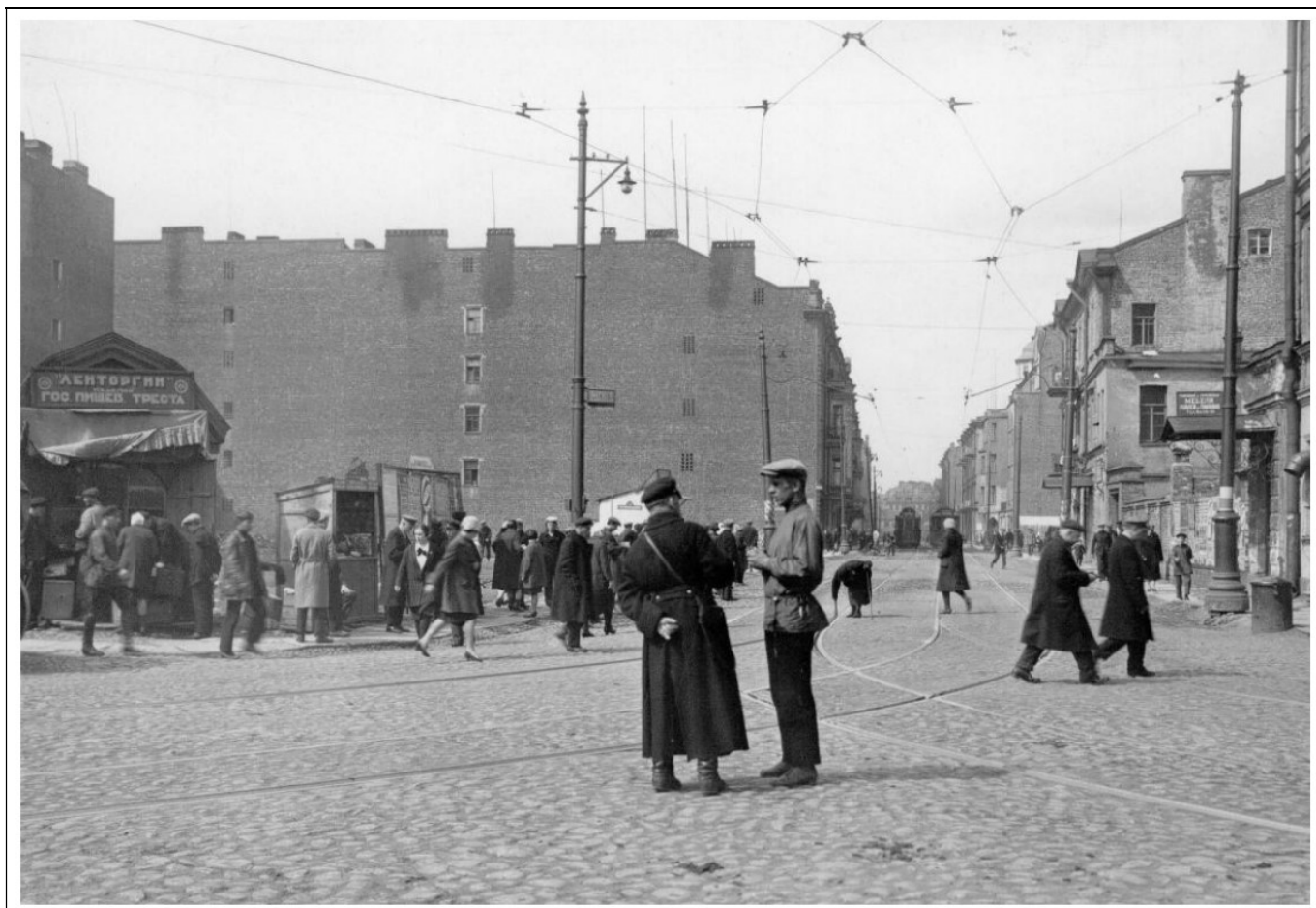
16. Натурная съёмка. Вид на улицу Розы Люксембург (совр. Введенская ул.) с Кронверкского проспекта.. 1930 г. // Электронный ресурс: https://pastvu.com/p/229945 .
