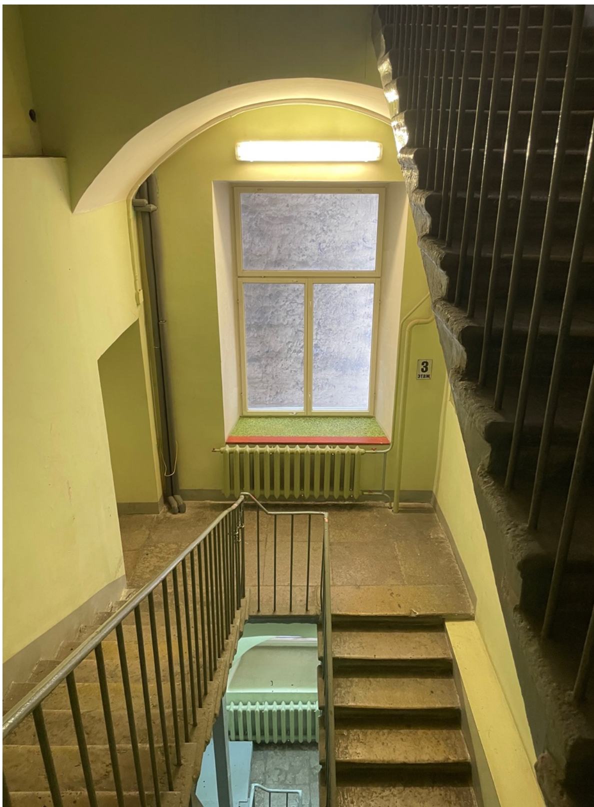
11. Фрагмент интерьера лестницы
