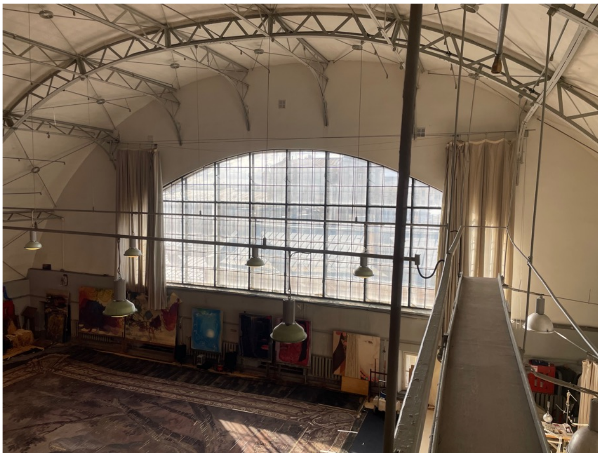
19. Фрагмент интерьера пятого этажа
