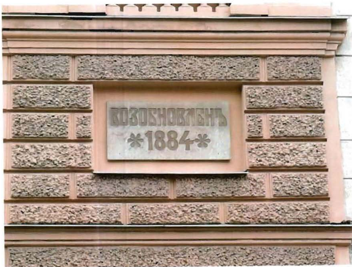
3. Фрагмент западного фасада объекта культурного наследия
