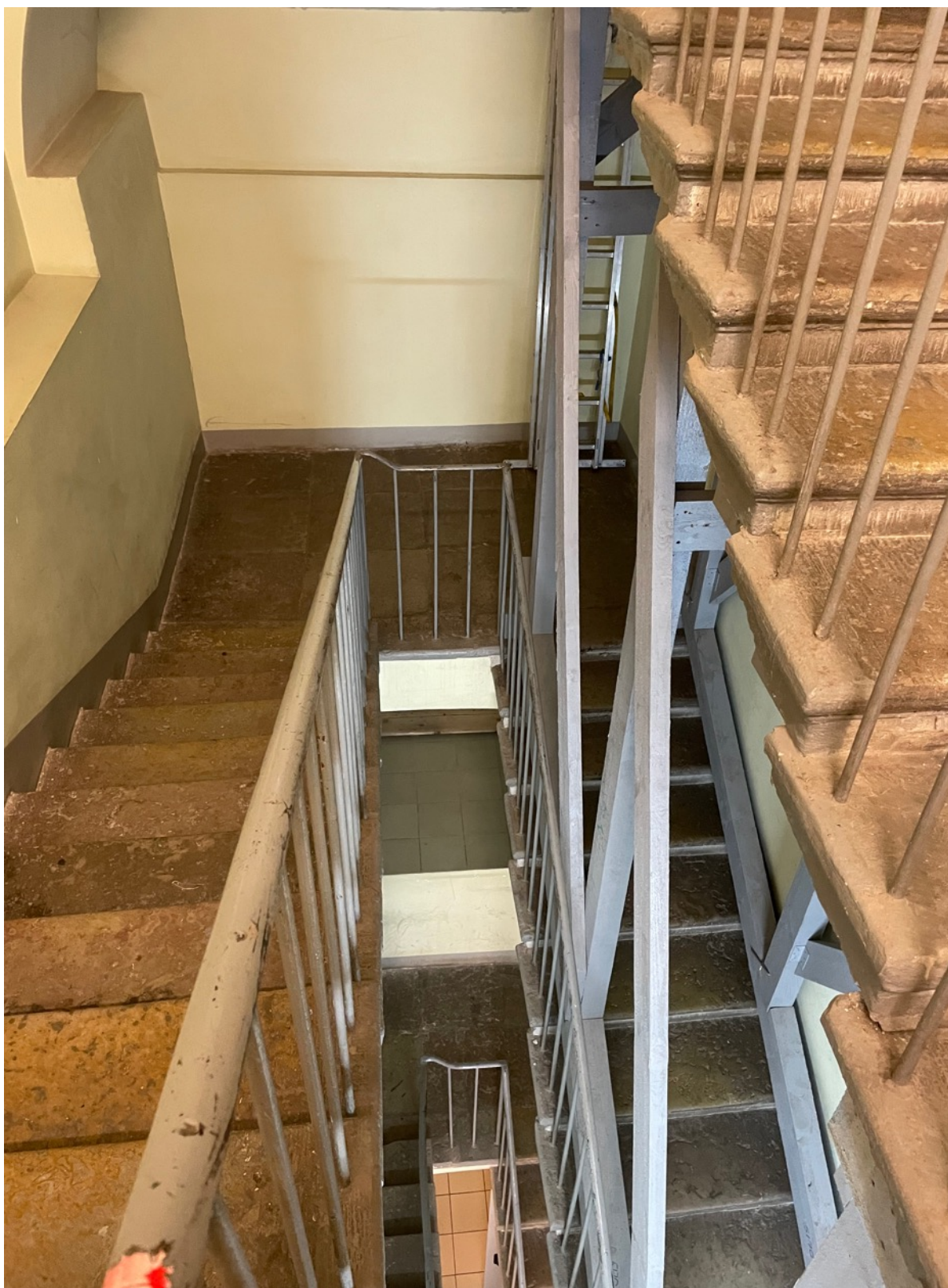
10. Фрагмент интерьера лестницы
