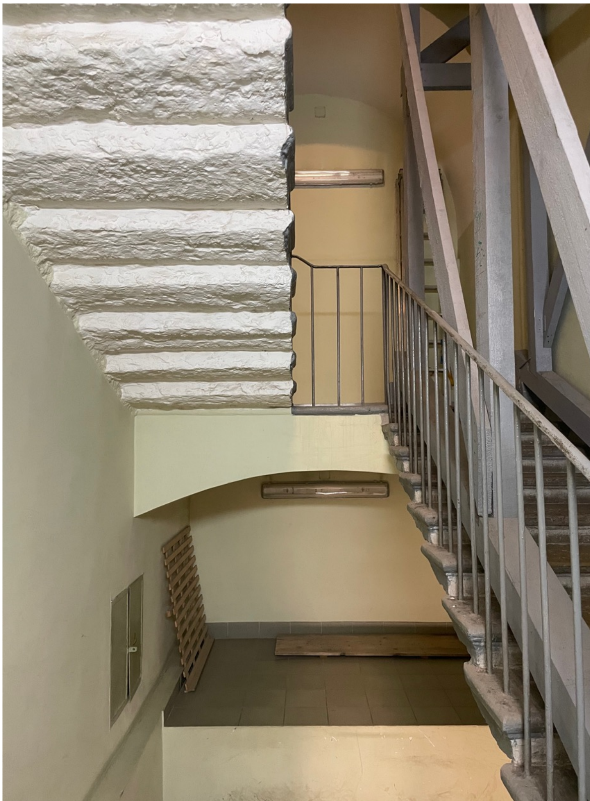
9. Фрагмент интерьера лестницы
