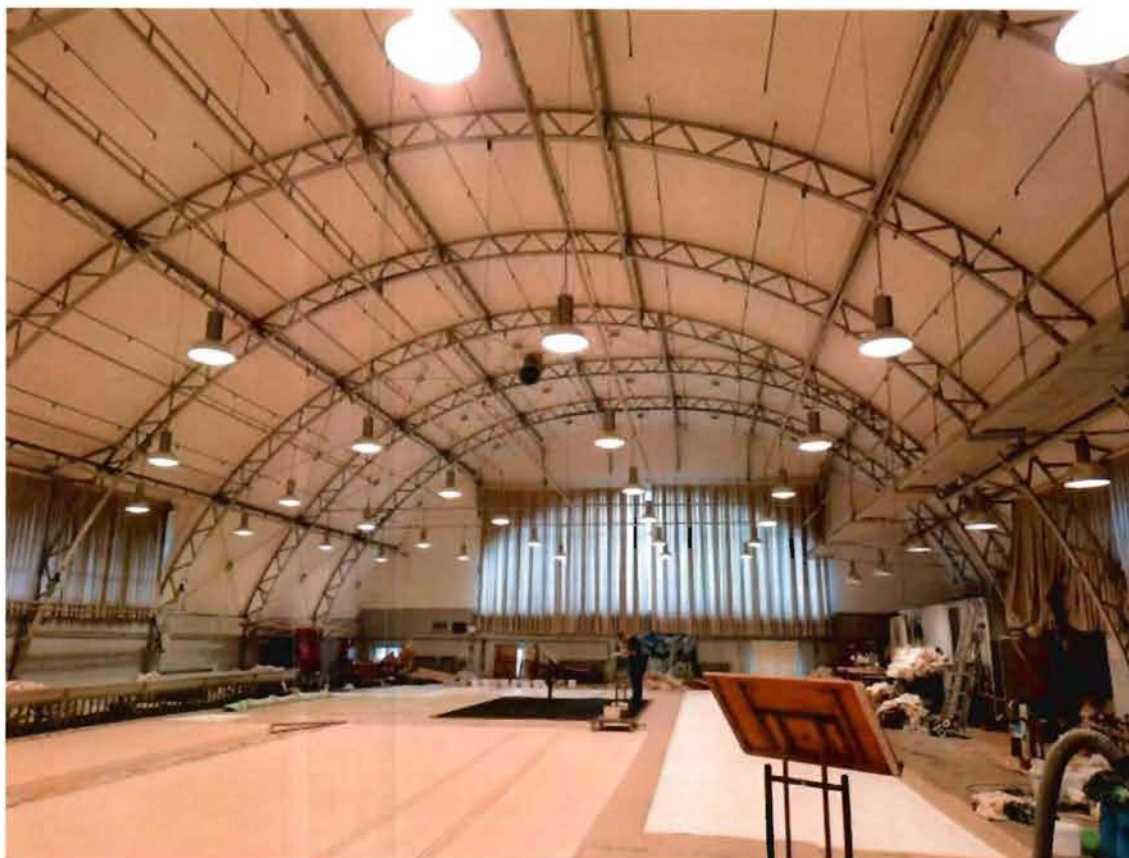
6. Интерьеры объекта культурного наследия, 5 этаж
