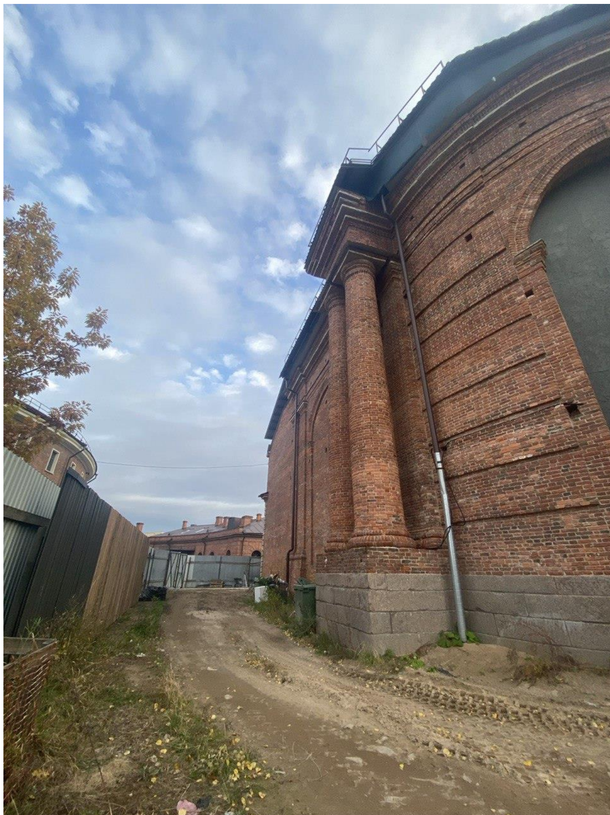
Фото 5. Вид на северо-западный участок территории.
