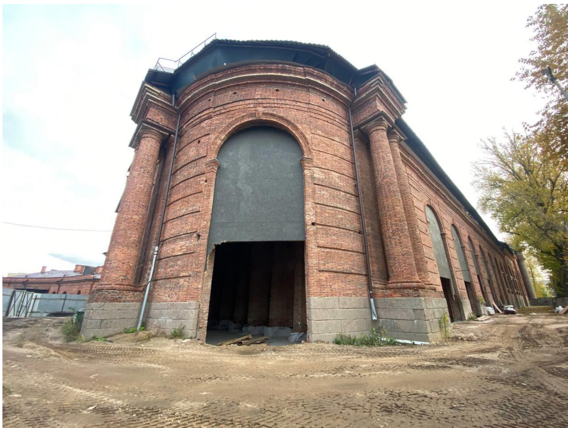
Фото 24. Вид на северо-западную часть объекта культурного наследия федерального значения «Склады лесные (три) с аркой» (корпус № 17).
