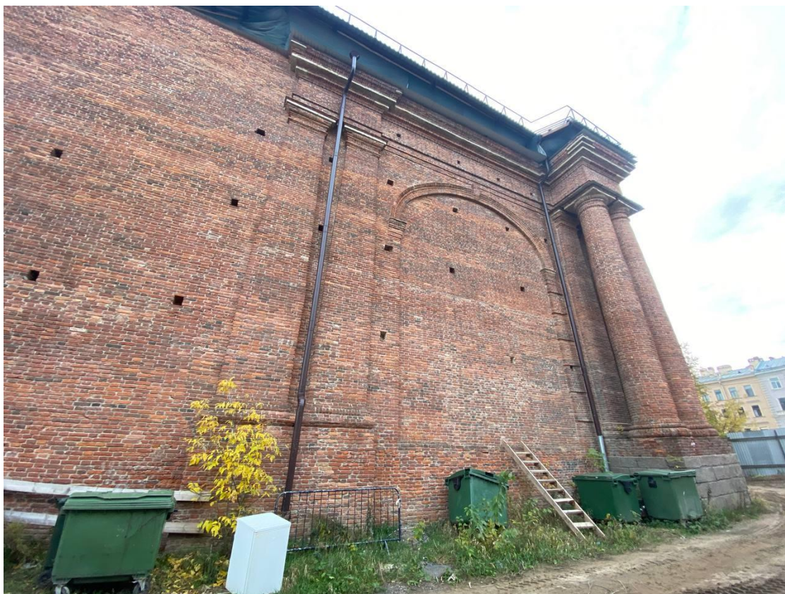
Фото 22. Вид на северо-западную часть объекта культурного наследия федерального значения «Склады лесные (три) с аркой» (корпус № 17).
