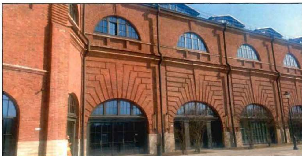
5. Фрагмент западного фасада объекта культурного наследия.
