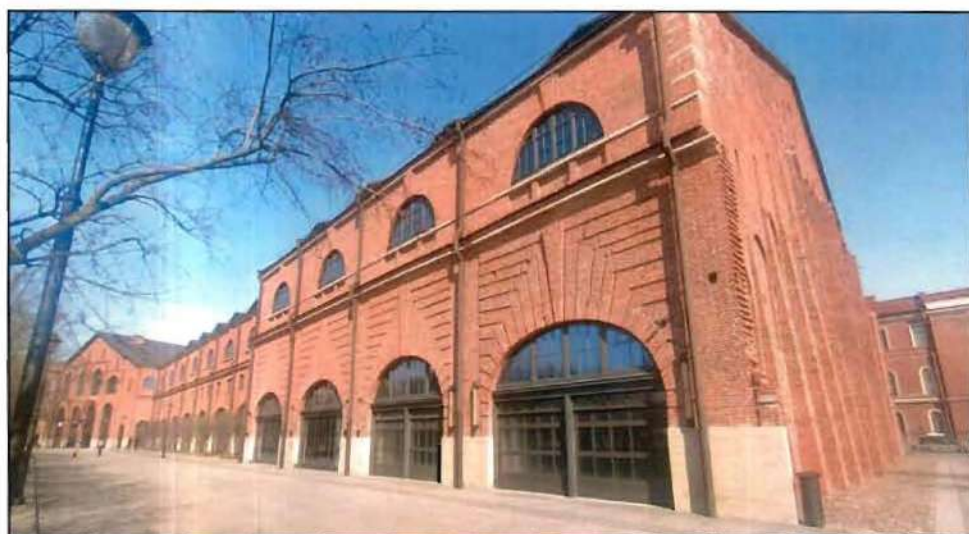
4. Западный фасад объекта культурного наследия.
