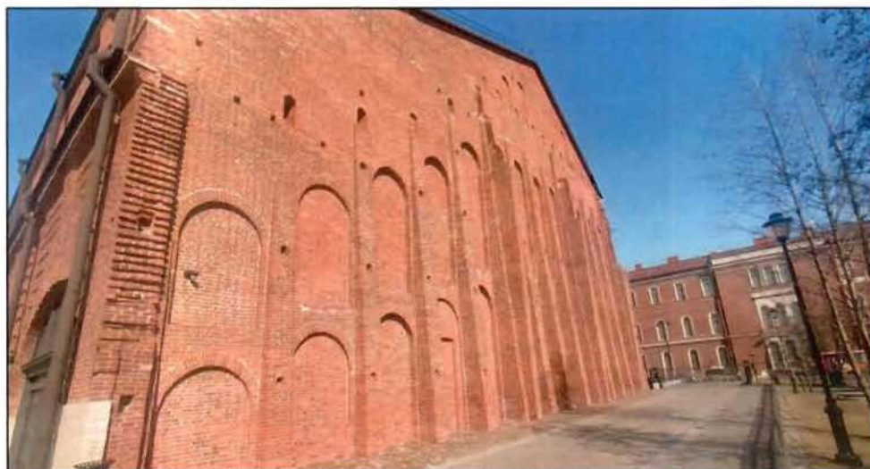
7. Южный фасад объекта культурного наследия.
