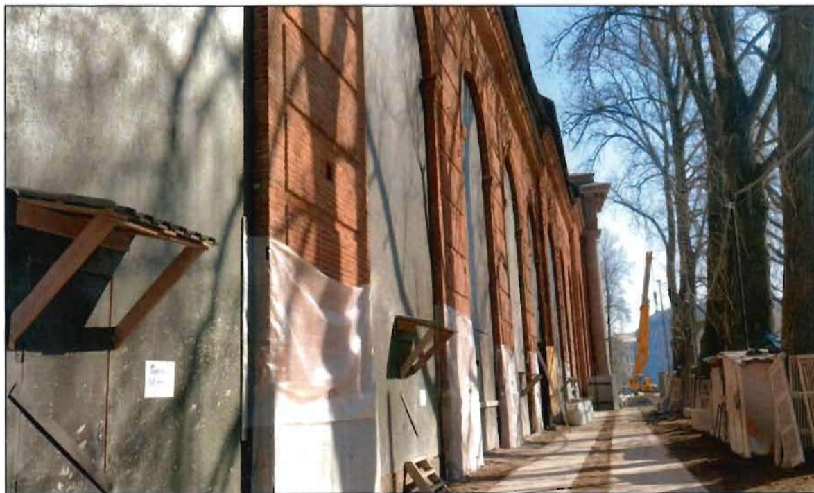
27. Фрагмент южного дворового фасада объекта культурного наследия.
