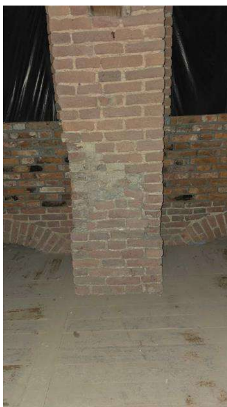
Фото 6. Вырубка в кирпичной кладке контрфорса.
