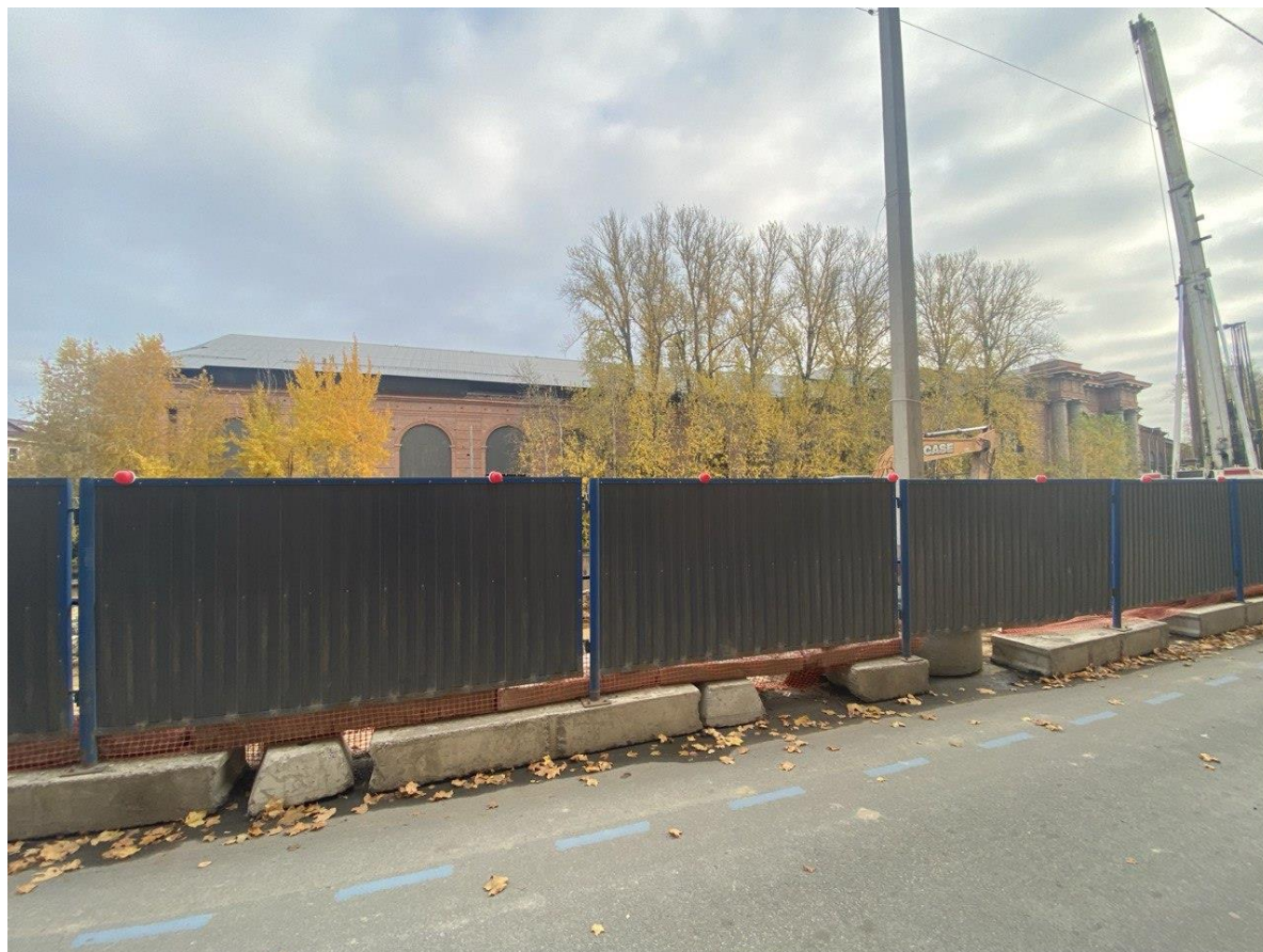
Фото 2. Вид на исследуемый объект с набережной противоположного берега реки Мойки.
