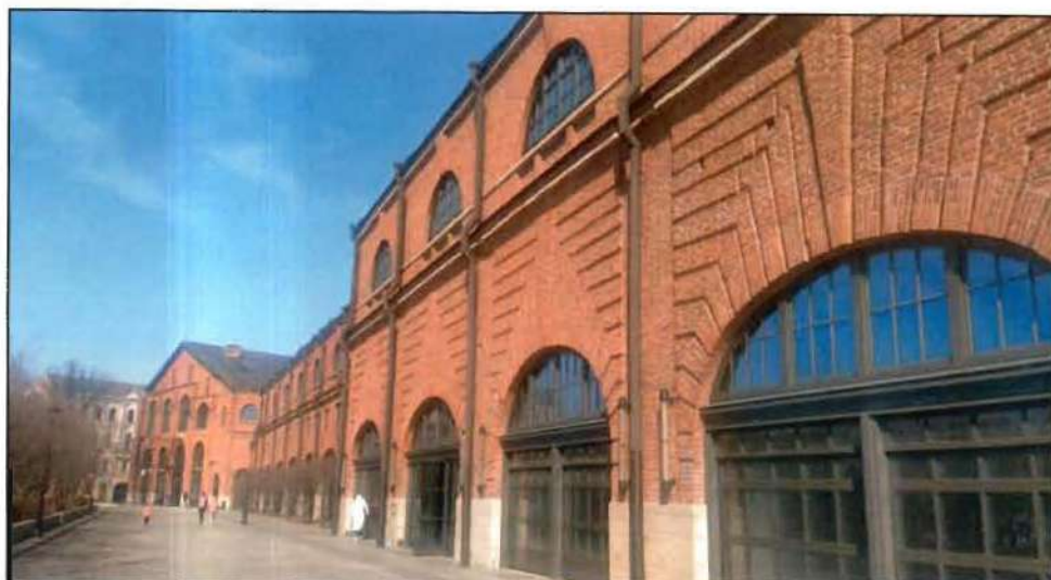
3. Западный фасад объекта культурного наследия.
