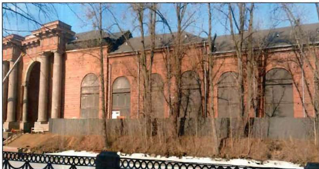
14. Фрагмент южного лицевого фасада объекта культурного наследия.
