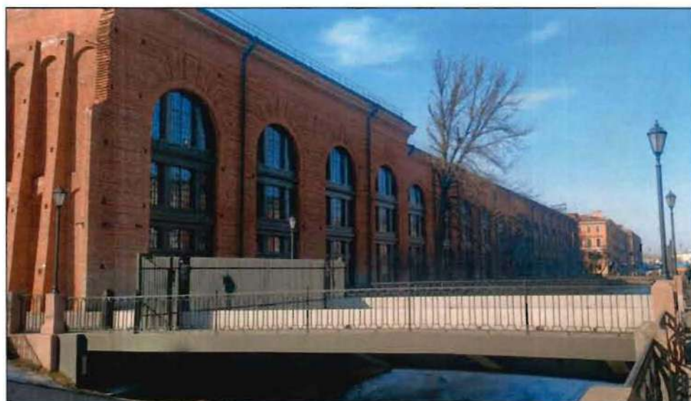
1. Лицевой фасад объекта культурного наследия.
