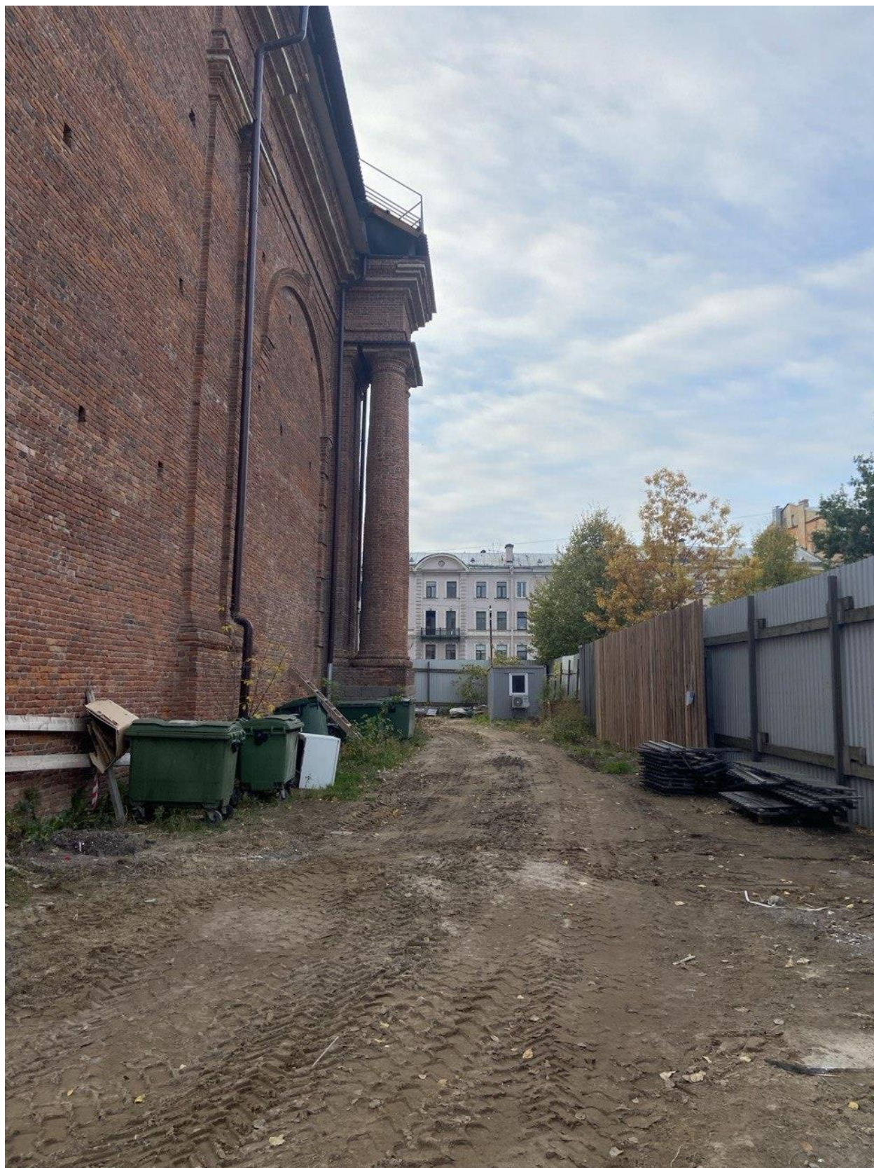
Фото 4. Вид на северо-западный участок территории.
