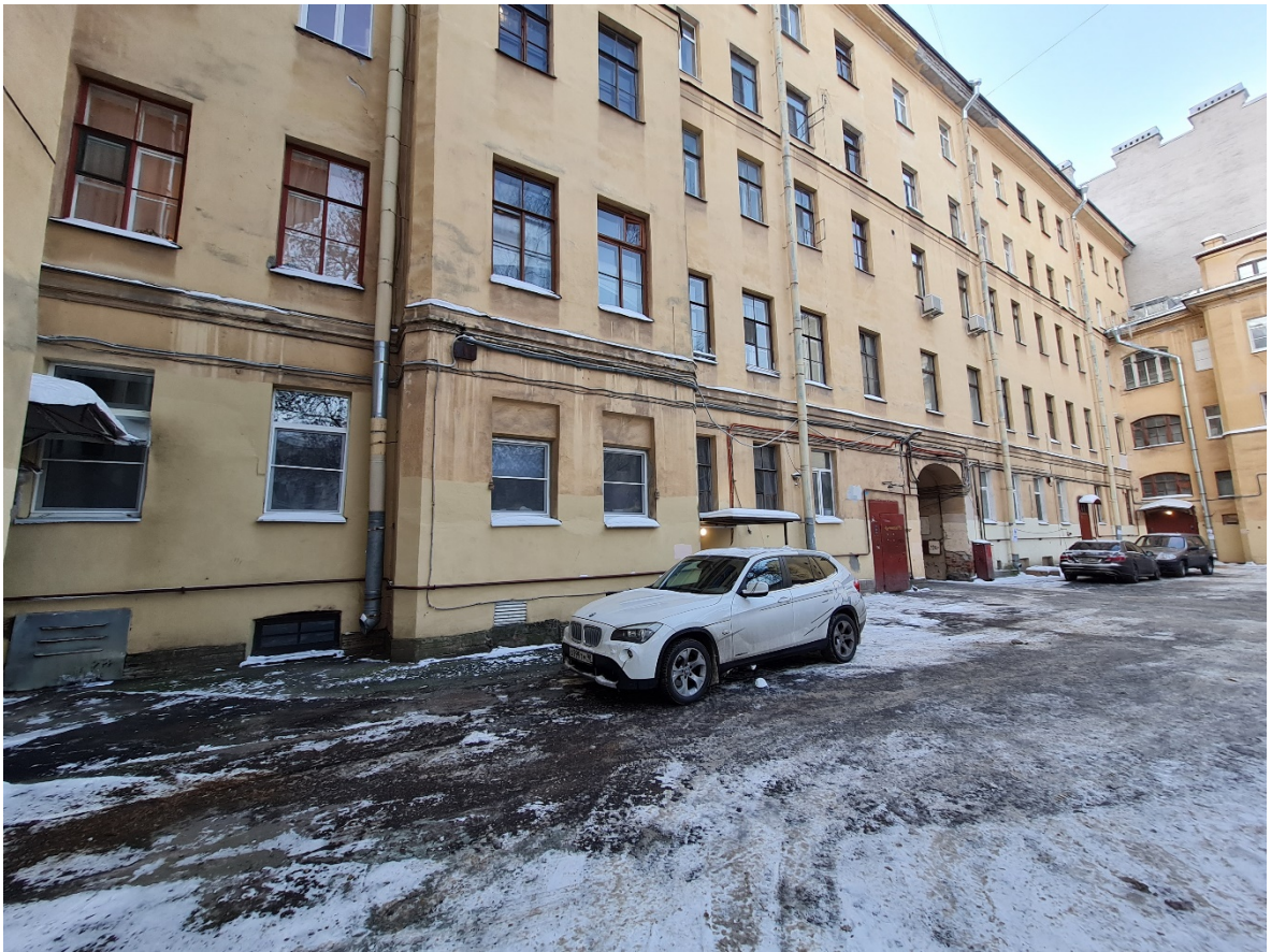
3. Фрагмент дворового фасада.
