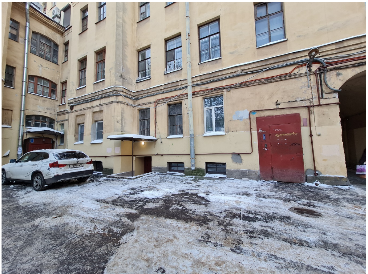
2. Фрагмент дворового фасада.
