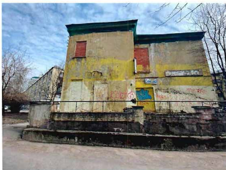
3. Западный фасад объекта культурного наследия.
