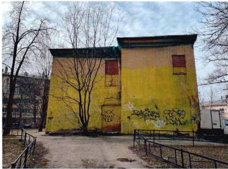
4. Восточный фасад объекта культурного наследия.
