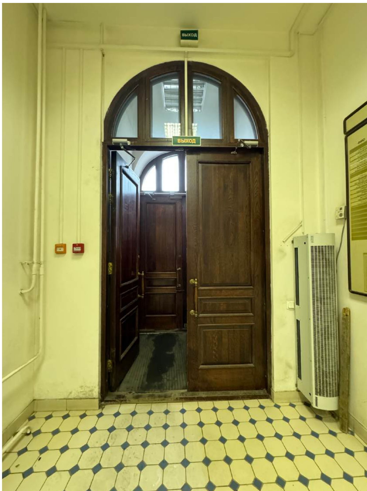
Фото 61. Вид на входное дверное заполнение объекта культурного наследия.
