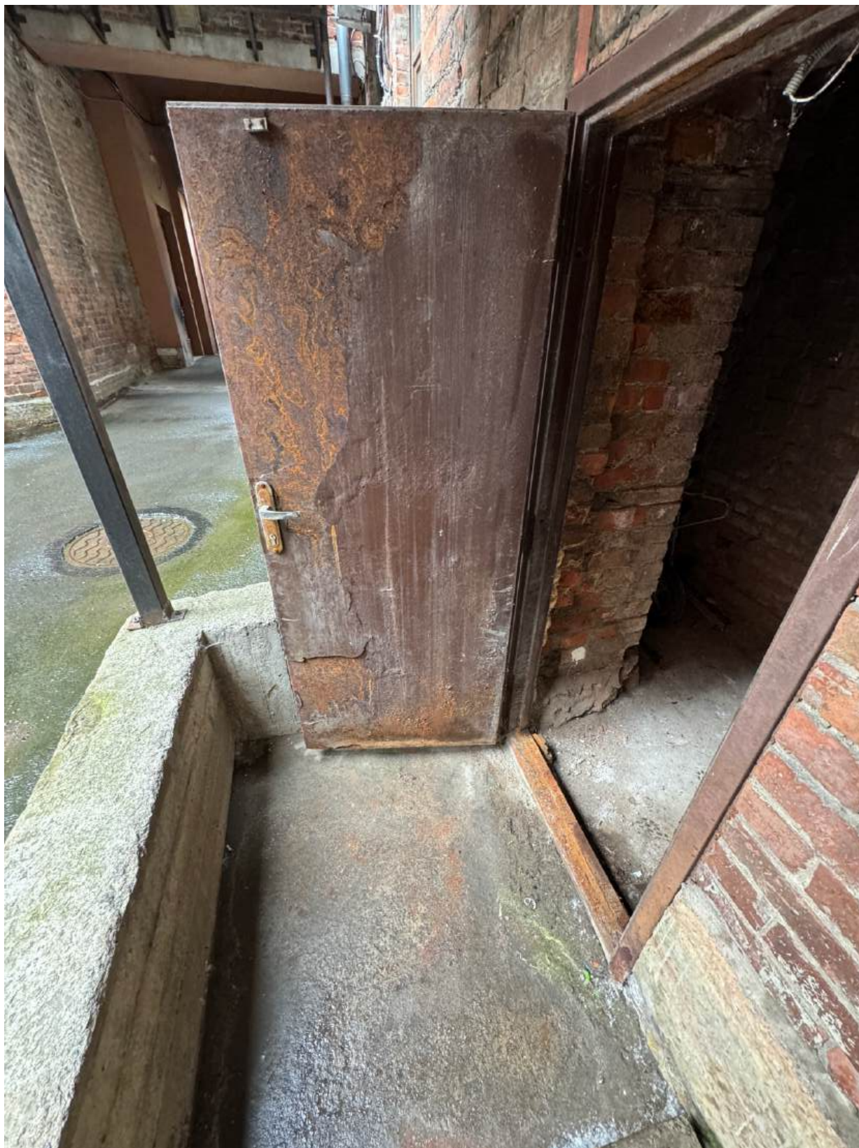
Фото 16. Вход в подвальное помещение объекта культурного наследия.
