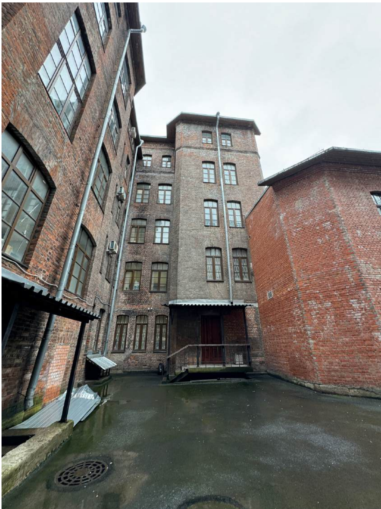
Фото 10. Общий вид дворовых фасадов объекта культурного наследия.
