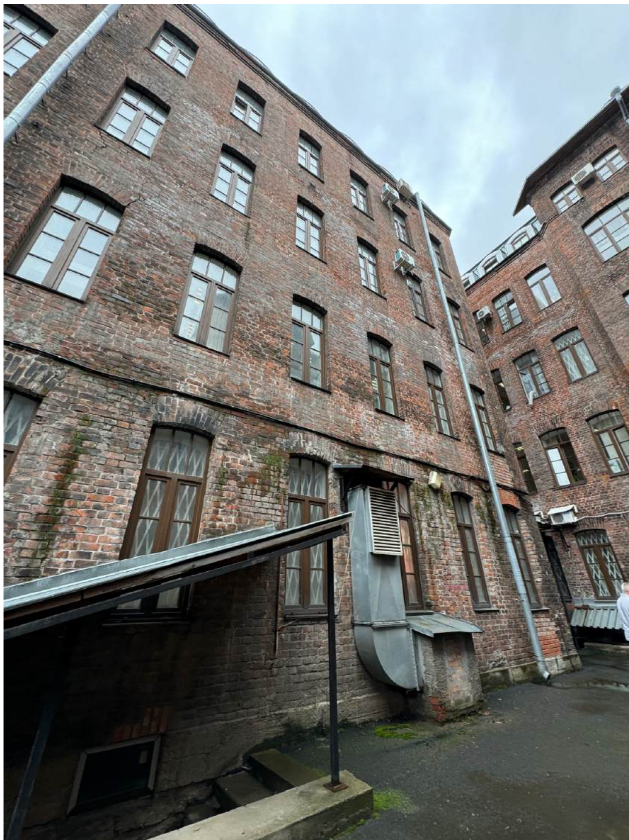
Фото 13. Общий вид дворовых фасадов объекта культурного наследия.
