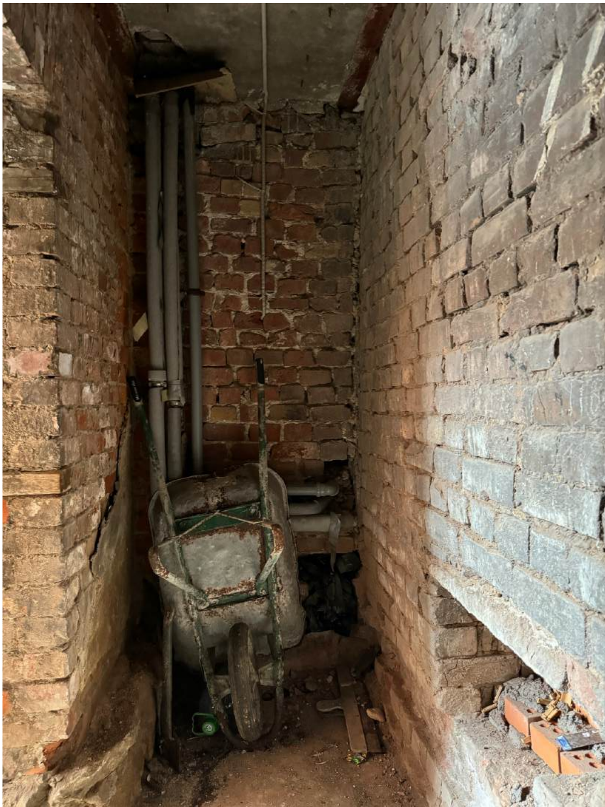
Фото 19. Вид на подвальное помещение объекта культурного наследия.
