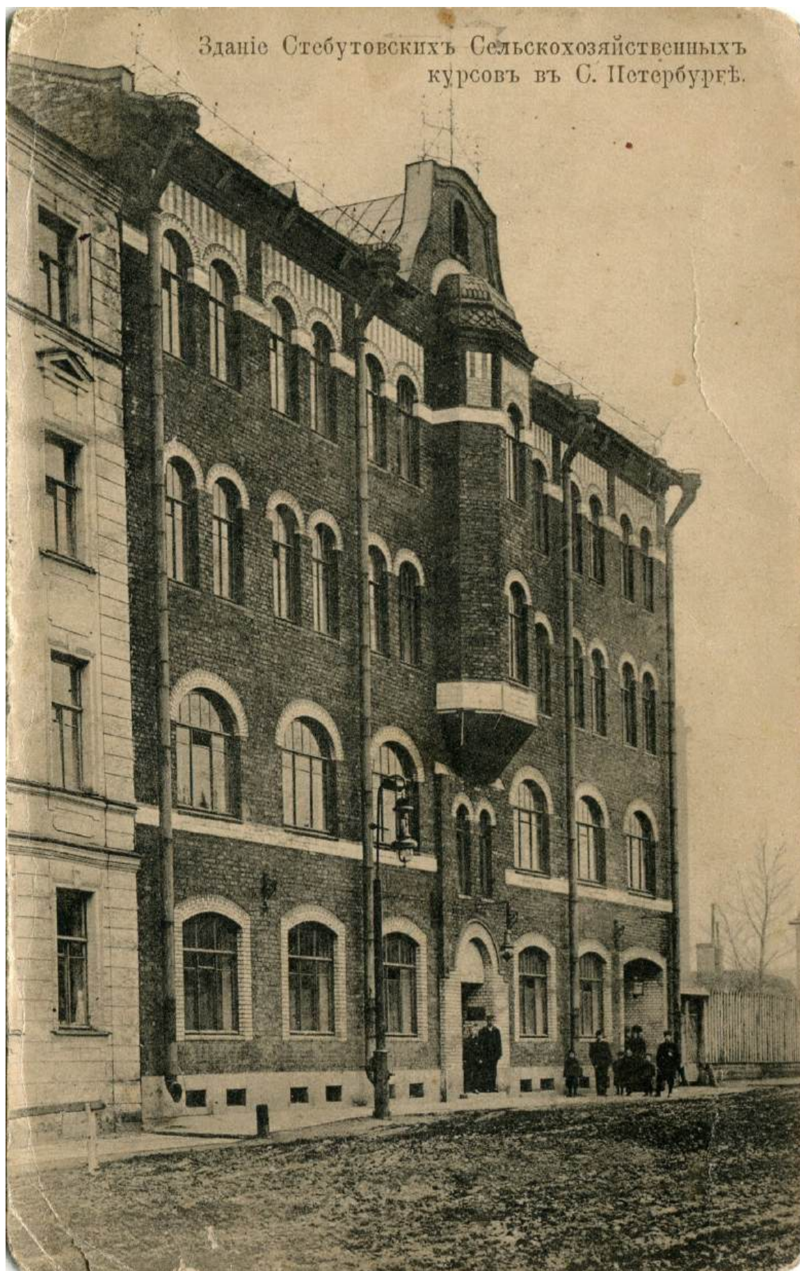
40. Здание Стебутовских Сельскохозяйственных курсов, 1909 г. [Электронный ресурс] URL: https://pastvu.com/p/1011619
