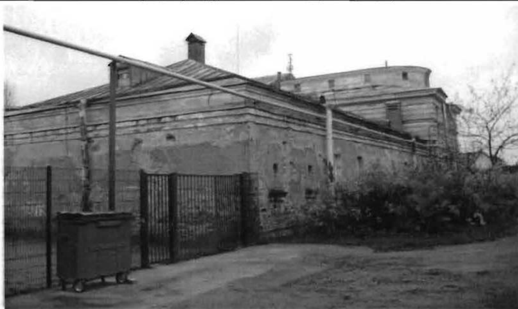
Фото 24. Западный, северный фасады. Общий вид.
