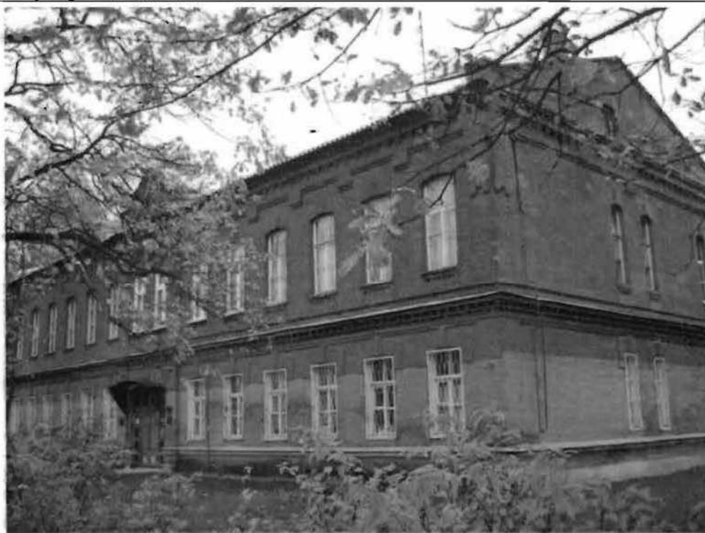
Фото 89. Западный, южный фасады. Общий вид.
