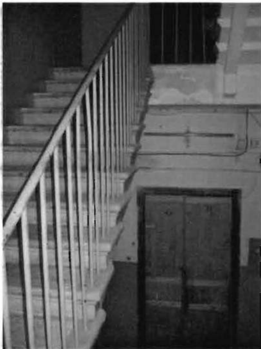
Фото 143. Лестница № 1 в северной части здания. Общий вид.
