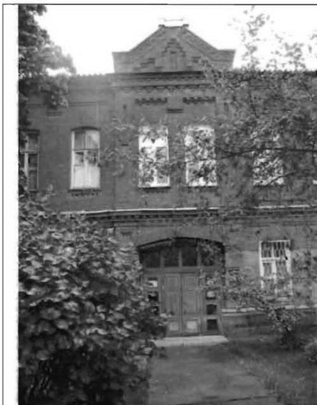
Фото 90. Восточный фасад. Центральная часть. Общий вид.
