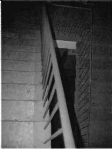
Фото 149. Лестница № 1 в северной части здания. Общий вид.
