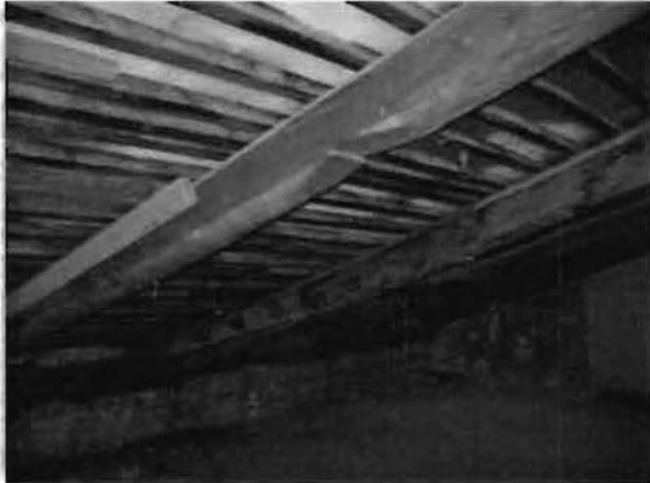
Фото 151. Конструкции крыши. Фрагмент.
