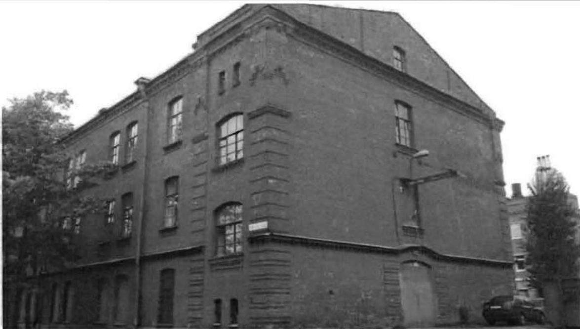
Фото 30. Северный фасад. Общий вид.
