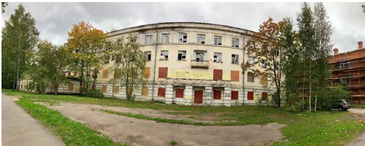
Фото 1. Здание, фасад по ул. Юты Бондаровской. Панорамный снимок (северный фасад)
