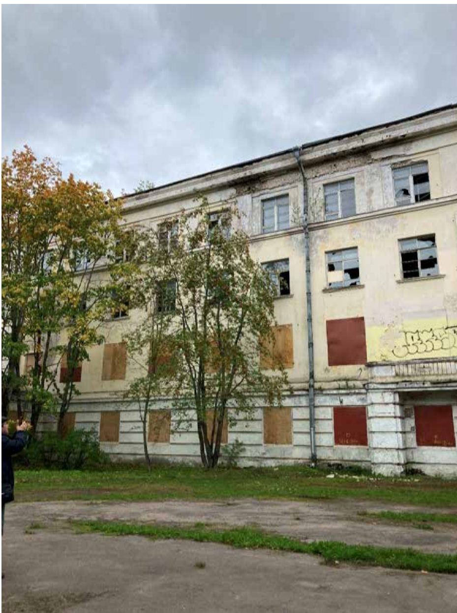
Фото 4. Здание, фасад по ул. Юты Бондаровской (северный фасад). Слева от главного входа в здание
