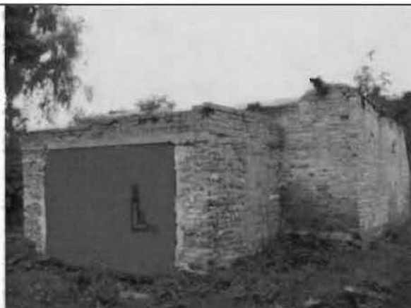
Фото 185. Восточный фасад. Общий вид.
