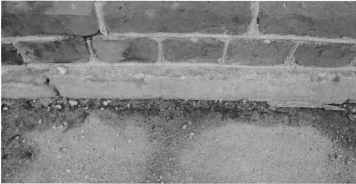
Цоколь, облицованный известняковой скобой. Съемка 20.11.2012, Воронина Н.В.
