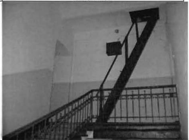
Фото 109. Парадная лестница в центральной части здания. Общий вид.
