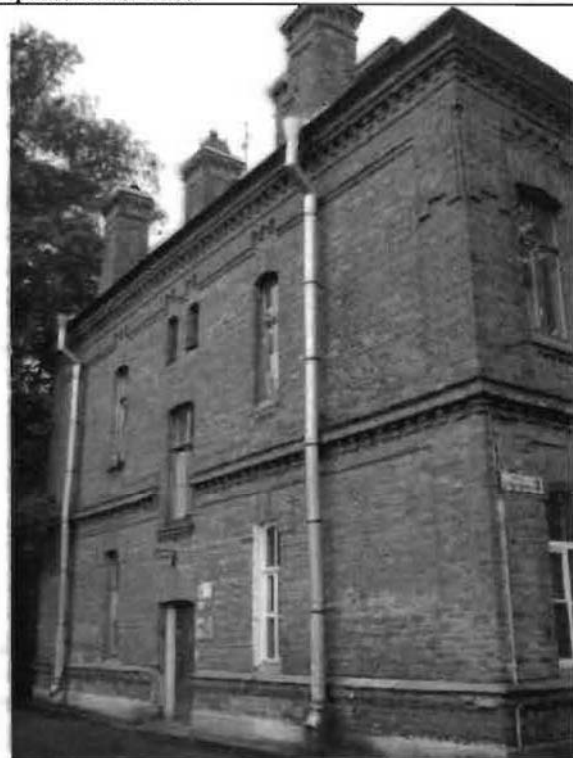
Фото 148. Северный фасад. Общий вид.
