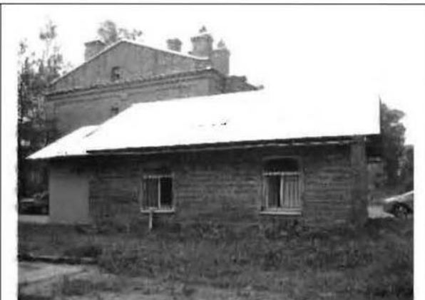
Фото 156. Западный фасад. Общий вид.
