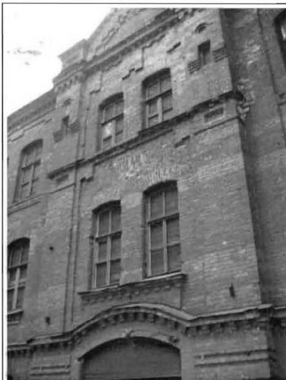
Фото 3. Западный фасад. Фрагмент центральной части фасада.
