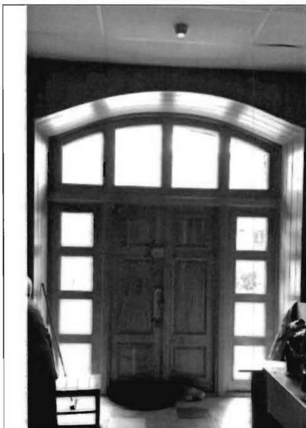
Фото 92. Помещение в уровне 1-го этажа.
