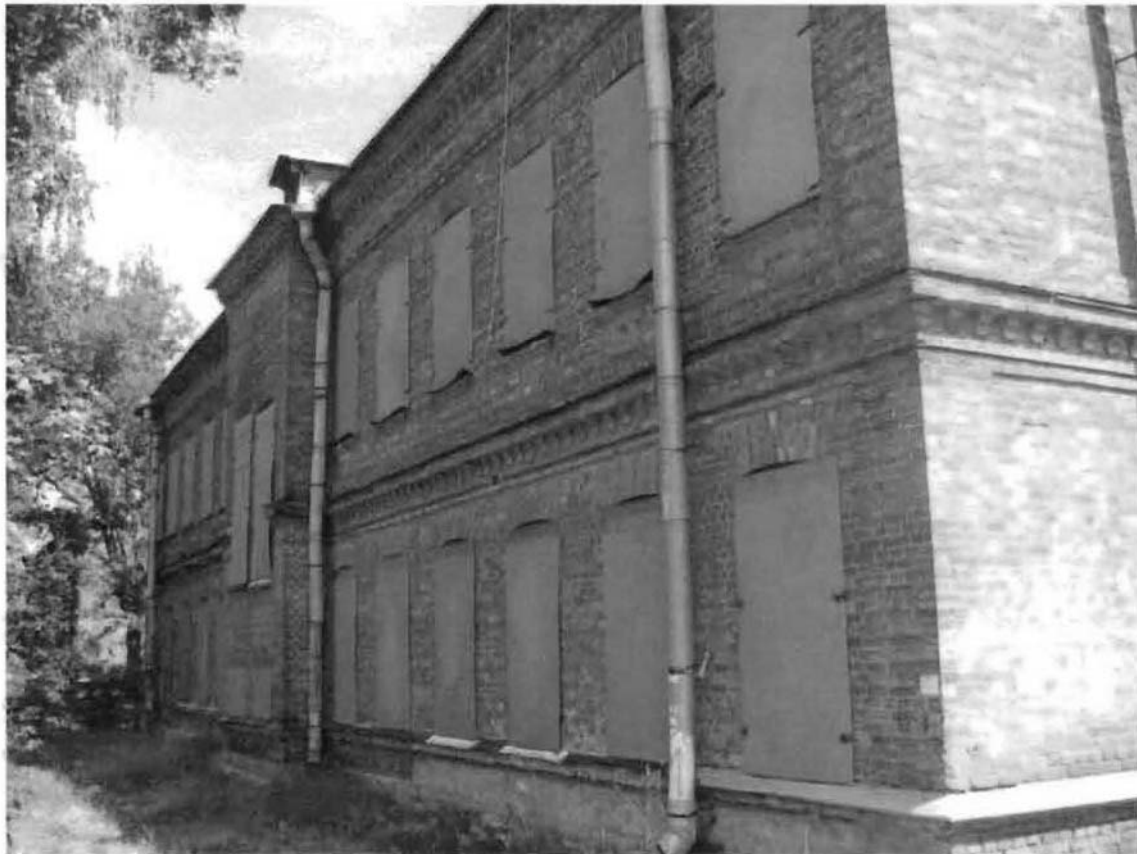
Фото 119. Западный фасад. Общий вид.
