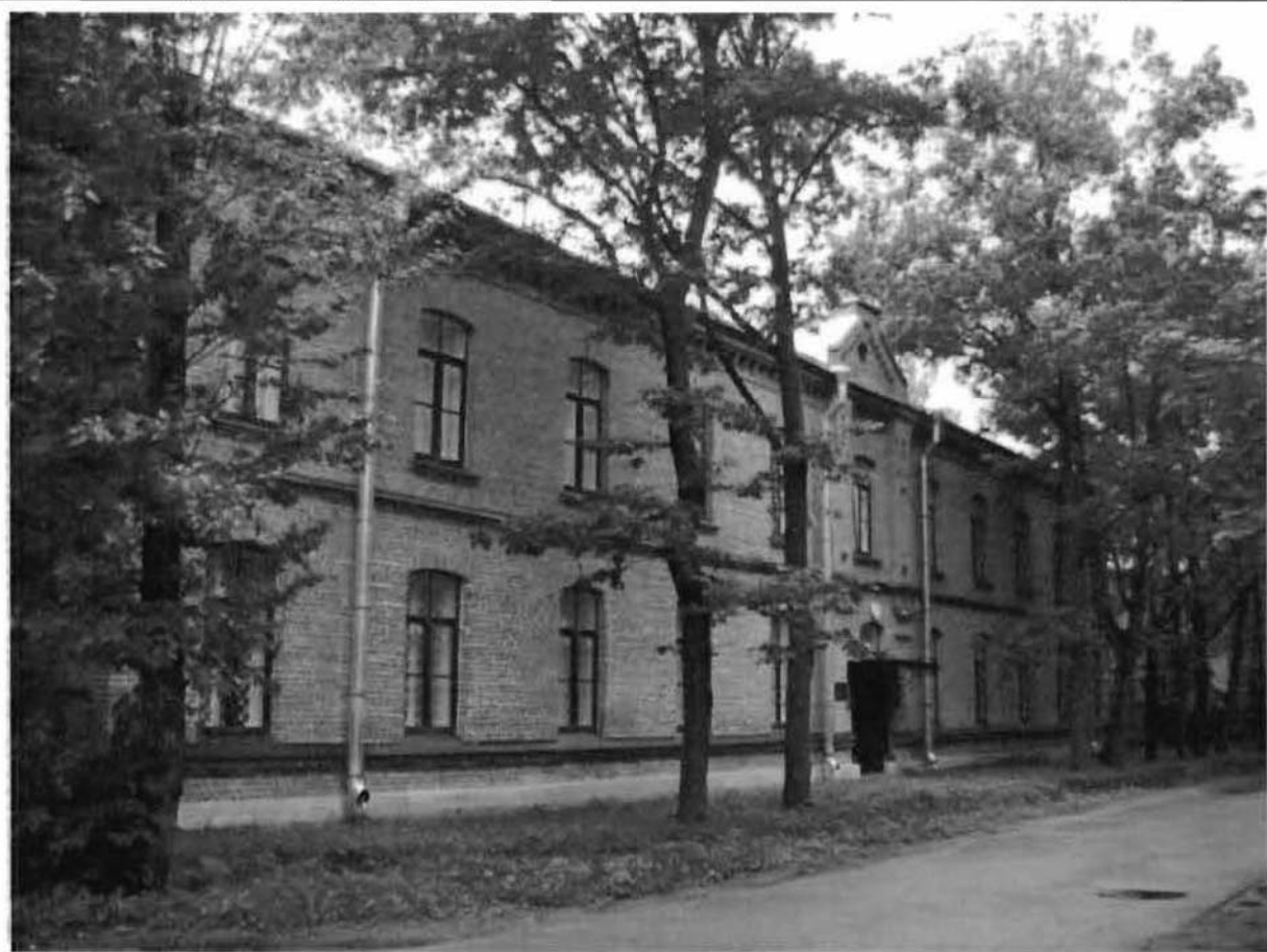
Фото 39. Восточный фасад. Общий вид.
