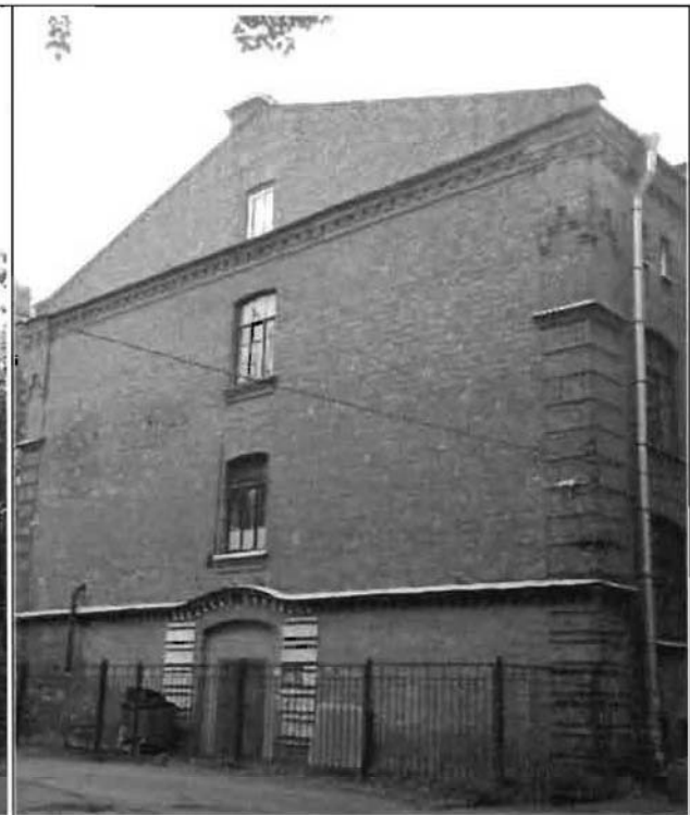
Фото 50. Южный фасад. Общий вид.
