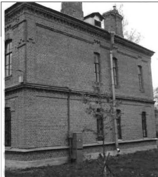
Фото 134. Южный фасад. Общий вид.
