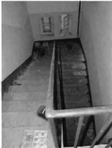
Фото 124. Лестница в южной части здания. Общий вид.
