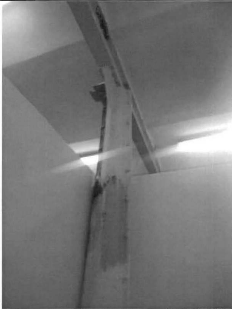
Металлические клёпаные колонны и балки, кирпичные своды. Съёмка 20.11.2012, Воронина Н.В.
