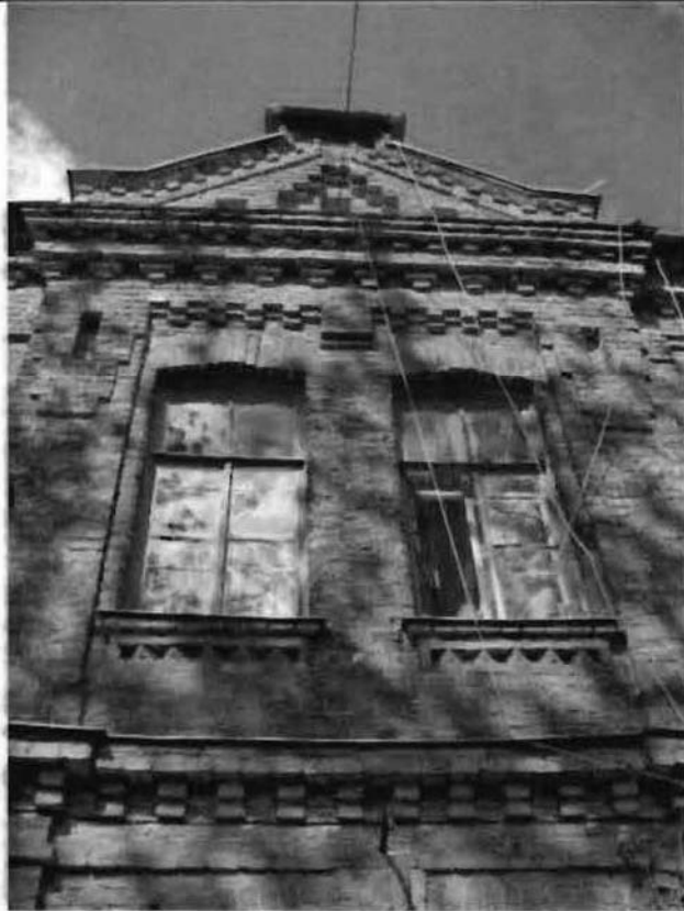
Фото 177. Восточный фасад. Центральная часть. Фрагмент.
