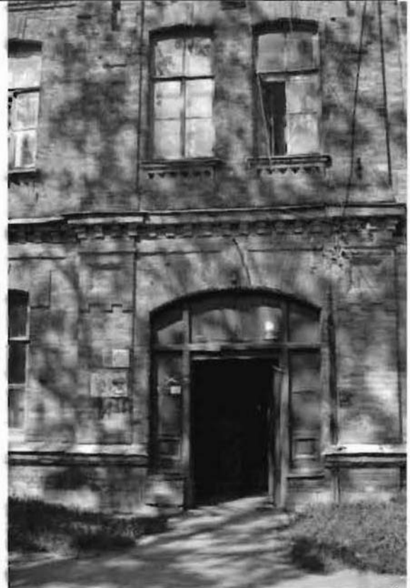
Фото 178. Восточный фасад. Центральная часть. Фрагмент.
