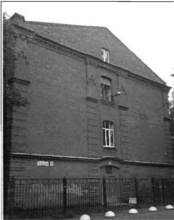
Фото 49. Северный фасад. Общий вид.
