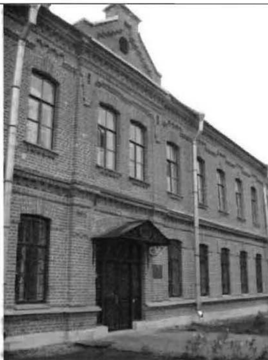
Фото 135. Западный фасад. Фрагмент центральной части фасада.
