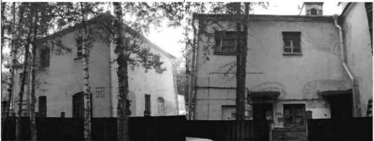
Фото 43. Северный, восточный фасады. Общий вид.
