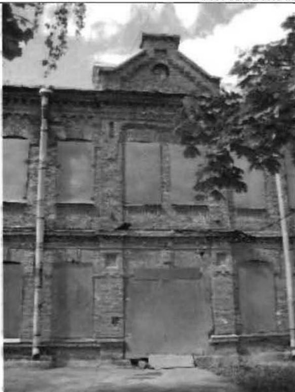
Фото 117. Восточный фасад. Фрагмент центральной части фасада.
