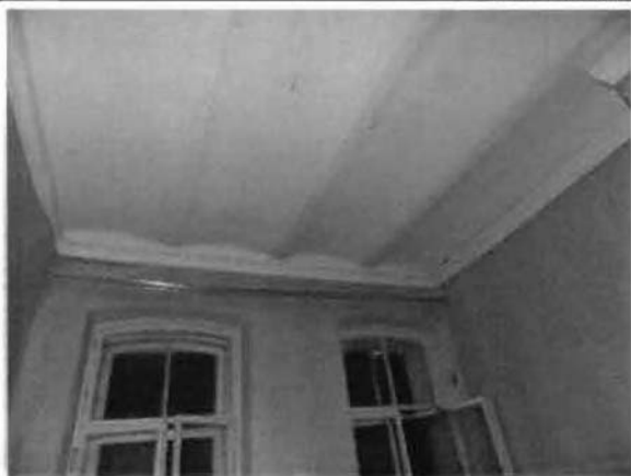
Фото 120. Помещение 1-го этажа. Общий вид.
