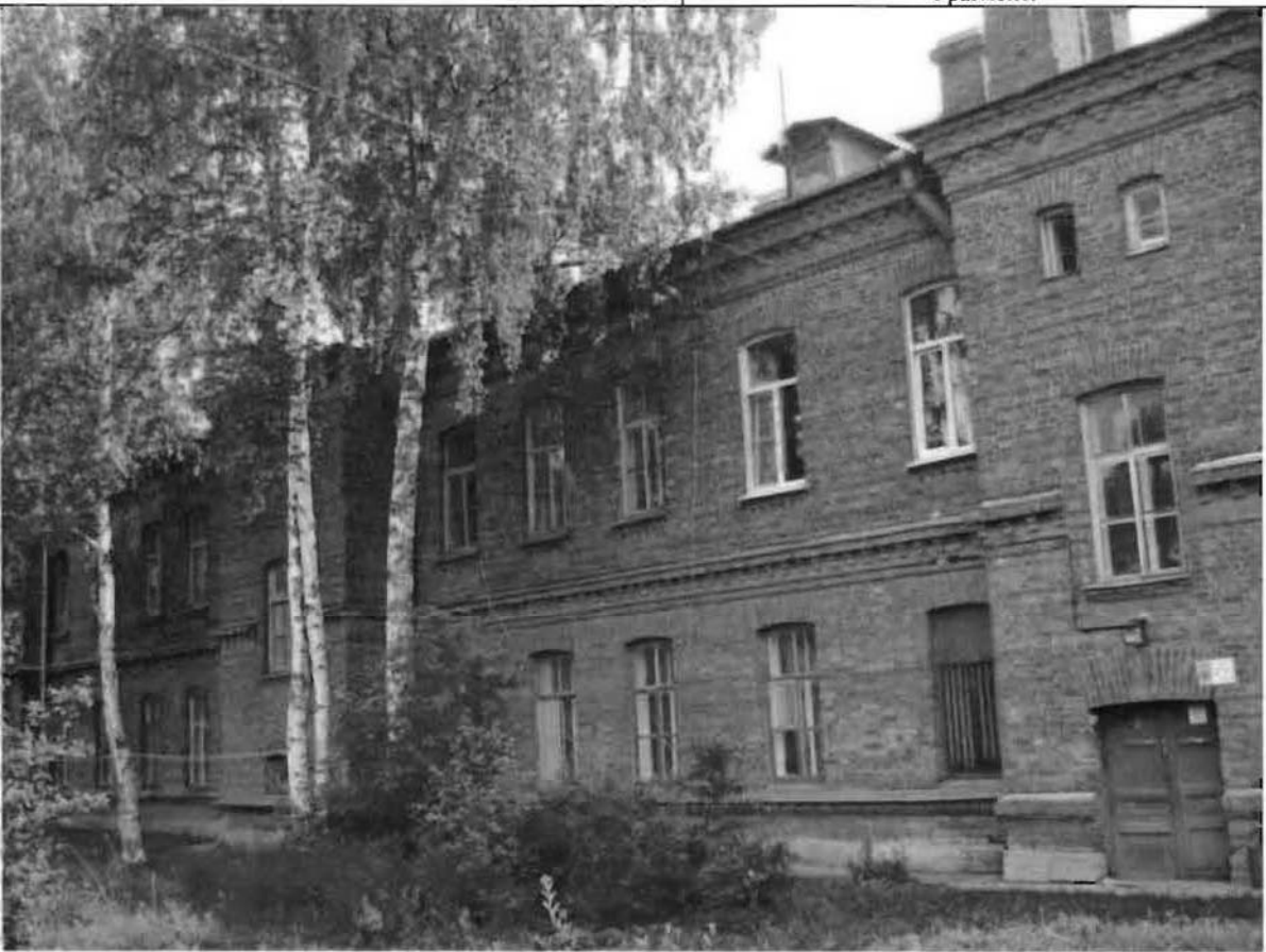
Фото 179. Западный фасад. Общий вид.
