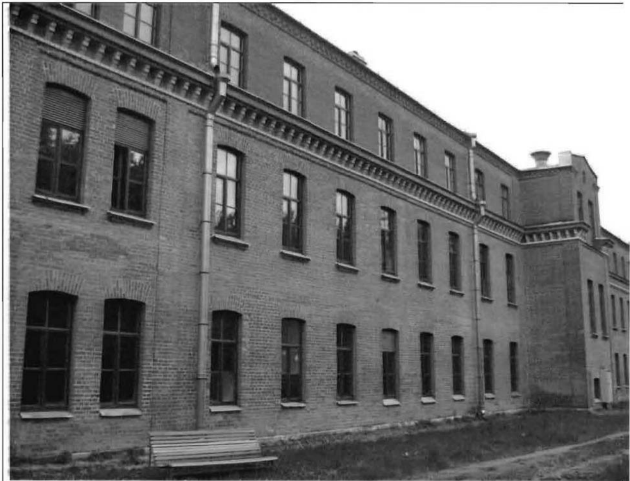
Фото 66. Южный фасад. Общий вид. 05.07.2016.
