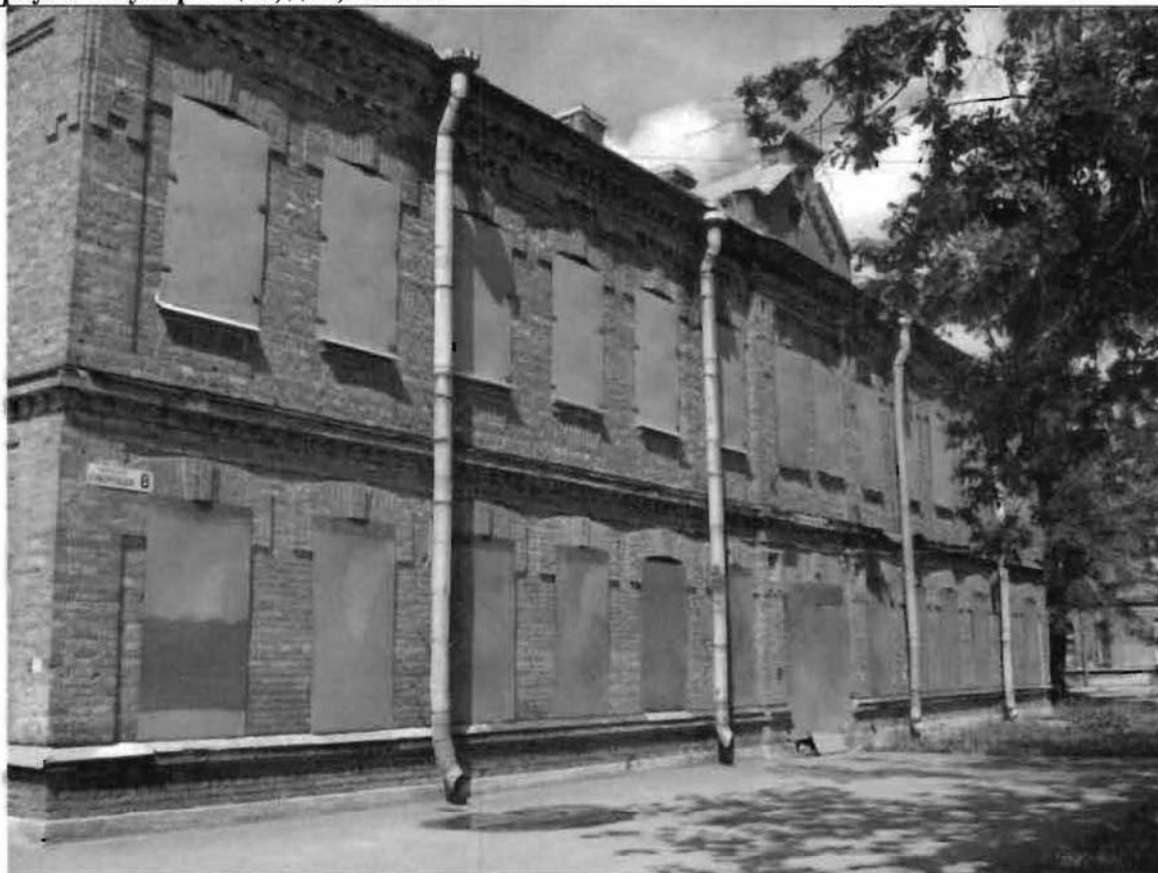
Фото 116. Восточный фасад. Общий вид.
