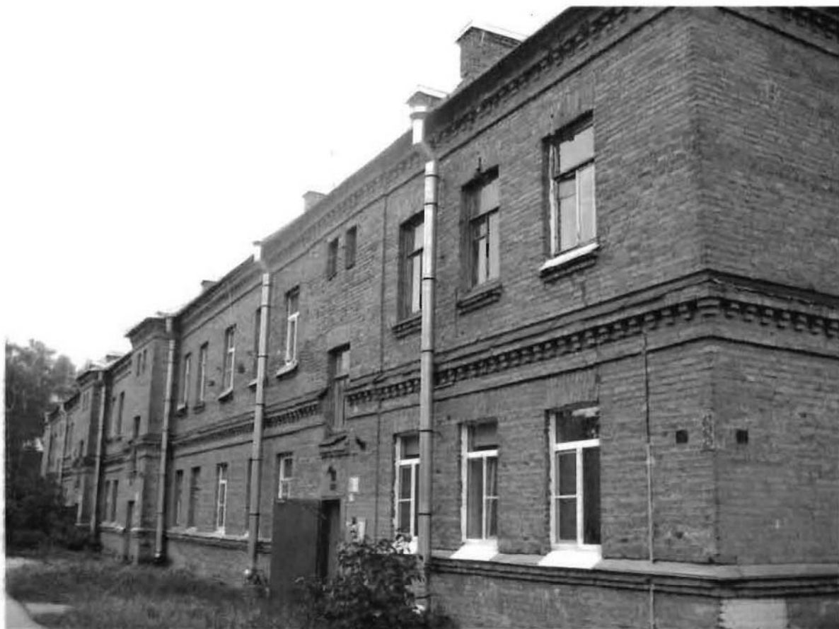
Фото 83. Северный фасад. Общий вид.
