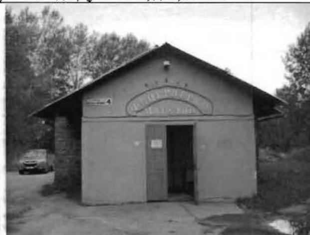
Фото 153. Восточный фасад. Общий вид.
