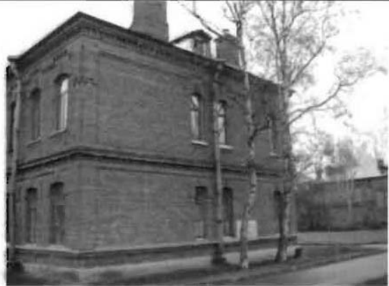
Фото 160. Северный фасад. Общий вид.
