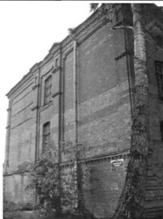
Фото 6. Северный фасад. Общий вид.
