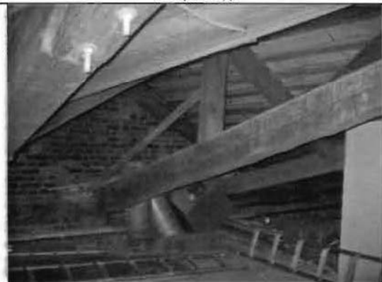
Фото 77. Конструкции крыши. Общий вид.
