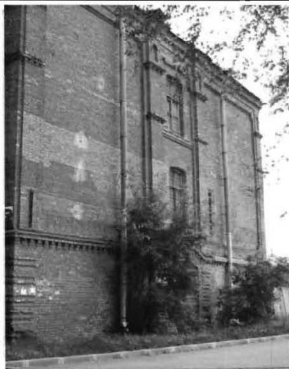
Фото 5. Южный фасад. Общий вид.
