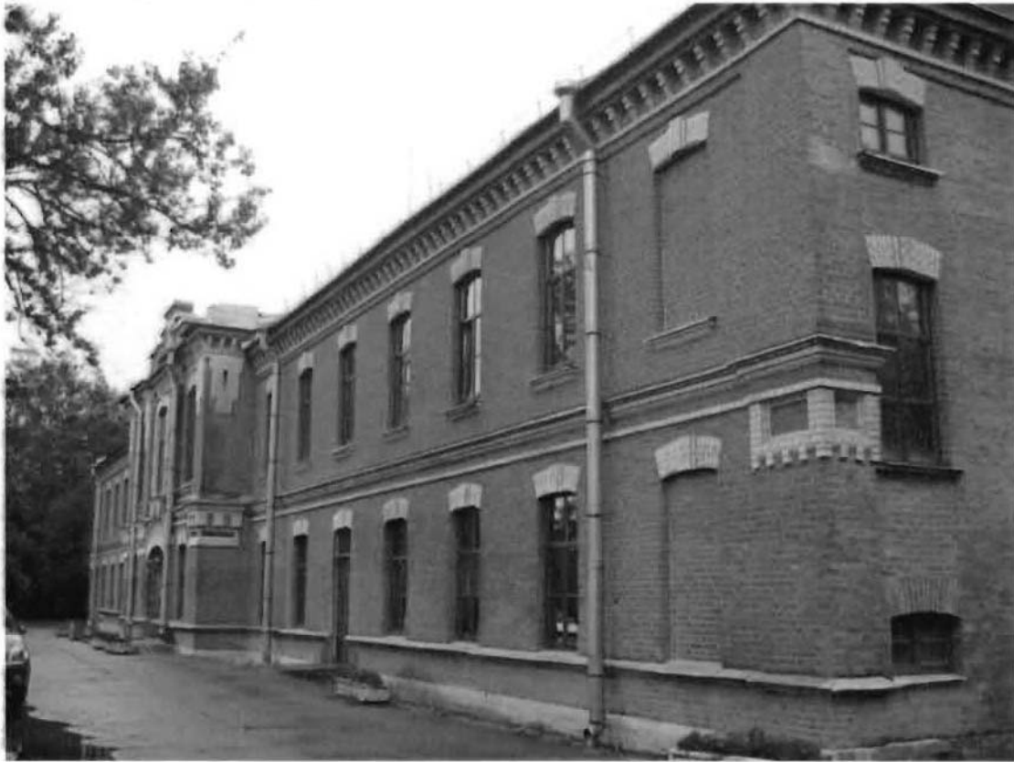
Фото 64. Северный фасад. Общий вид.
