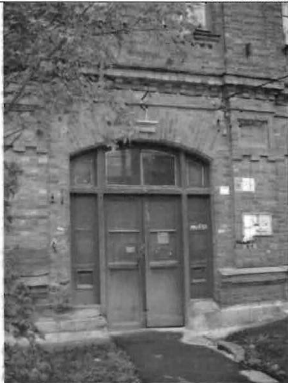
Фото 147. Дверной проем западного фасада. Общий вид.
