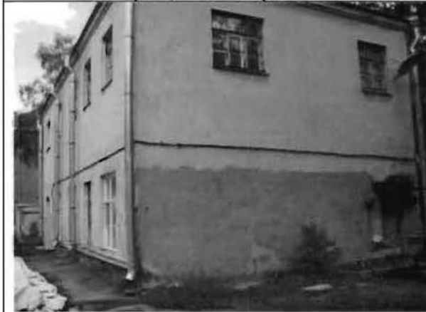
Фото 45. Южный, западный фасад. Общий вид.
