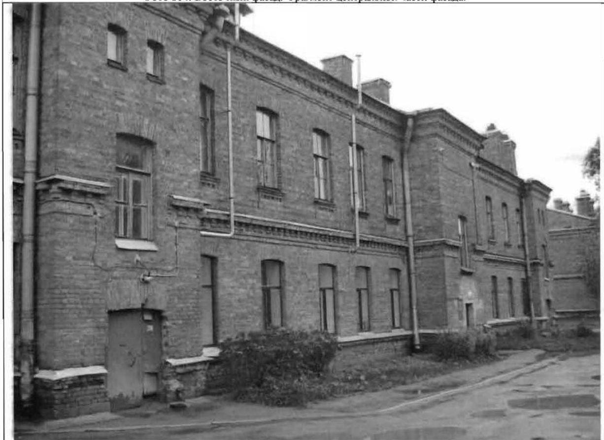
Фото 165. Западный фасад. Общий вид.
