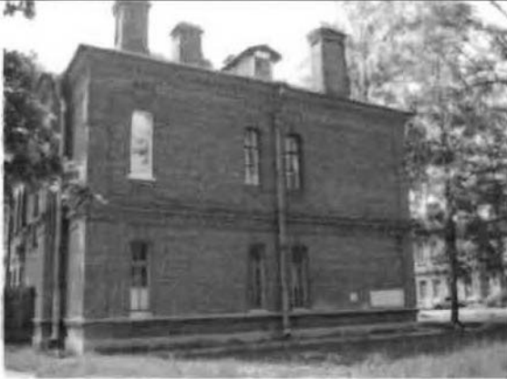
Фото 159. Северный фасад. Общий вид.
