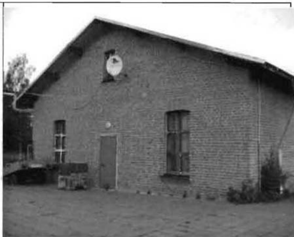
Фото 21. Южный фасад. Общий вид.
