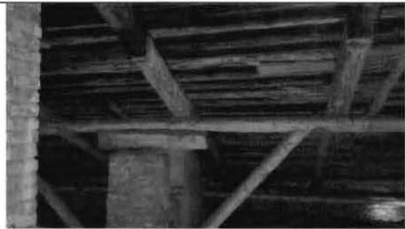
Фото 38. Конструкции крыши. Фрагмент.
