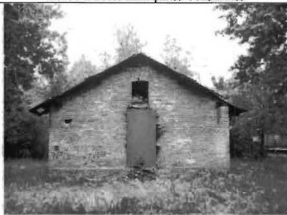
Фото 96. Западный фасад. Общий вид.
