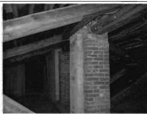
Фото 142. Конструкции крыши. Фрагмент.
