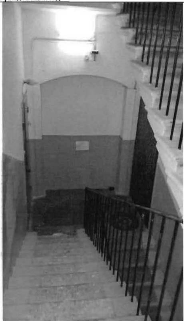
Фото 173. Лестница № 1 в северной части здания. Фрагмент.
