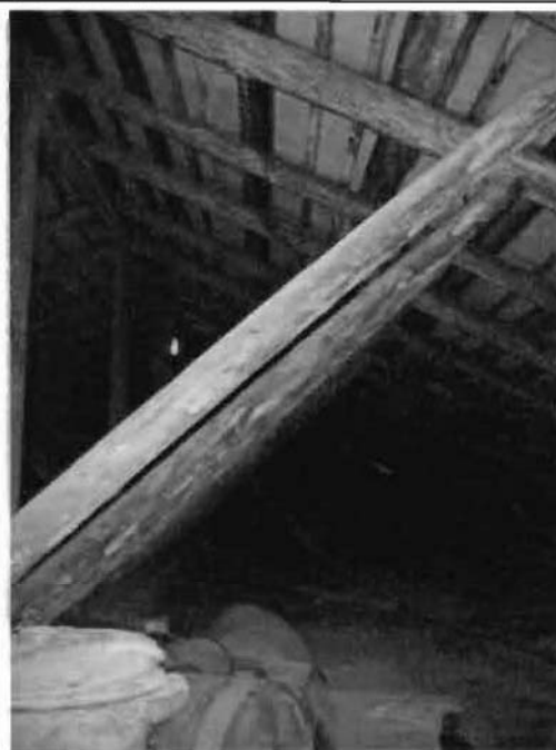
Фото 27. Конструкции крыши. Фрагмент.
