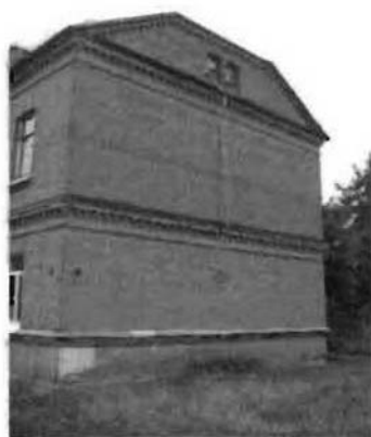
Фото 86. Западный фасад. Общий вид.
