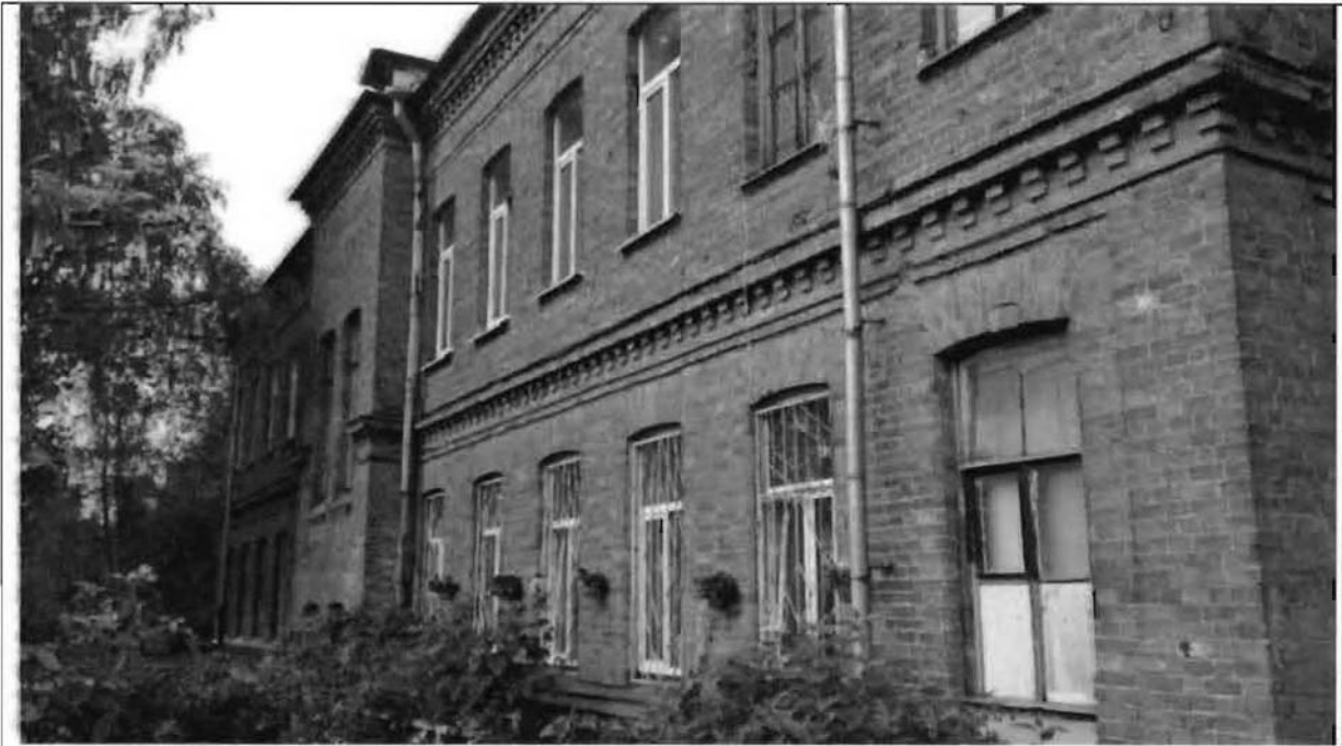
Фото 171. Восточный фасад. Общий вид.
