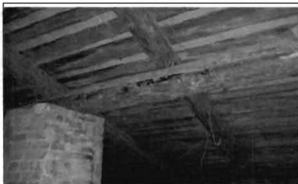
Фото 62. Конструкции крыши. Общий вид.
