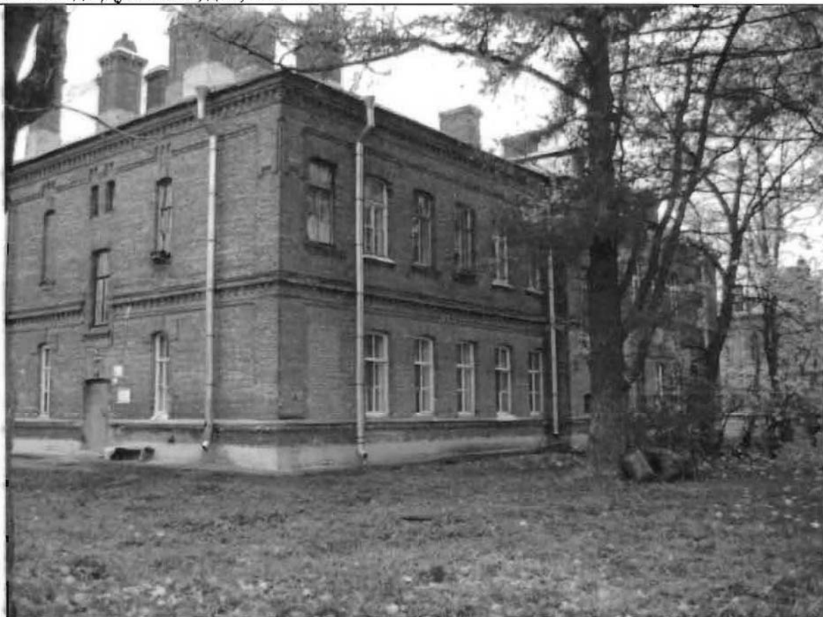
Фото 145. Восточный фасад. Общий вид.
