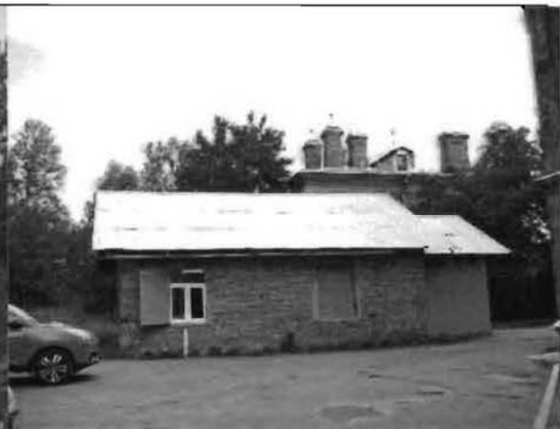
Фото 154. Южный фасад. Общий вид.
