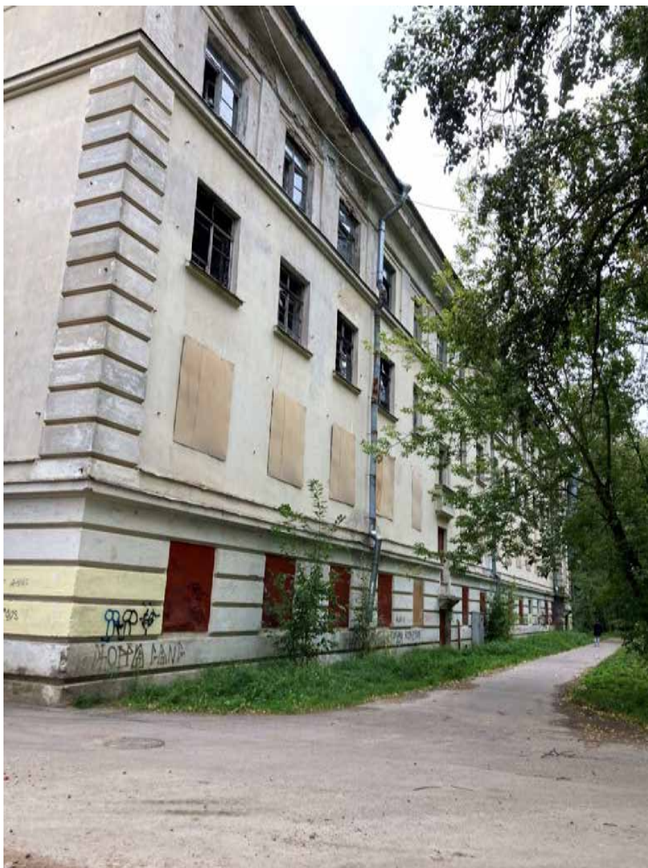
Фото 15. Здание со стороны южного фасада.
