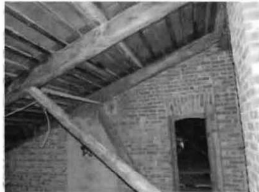
Фото 127. Конструкции крыши. Общий вид.
