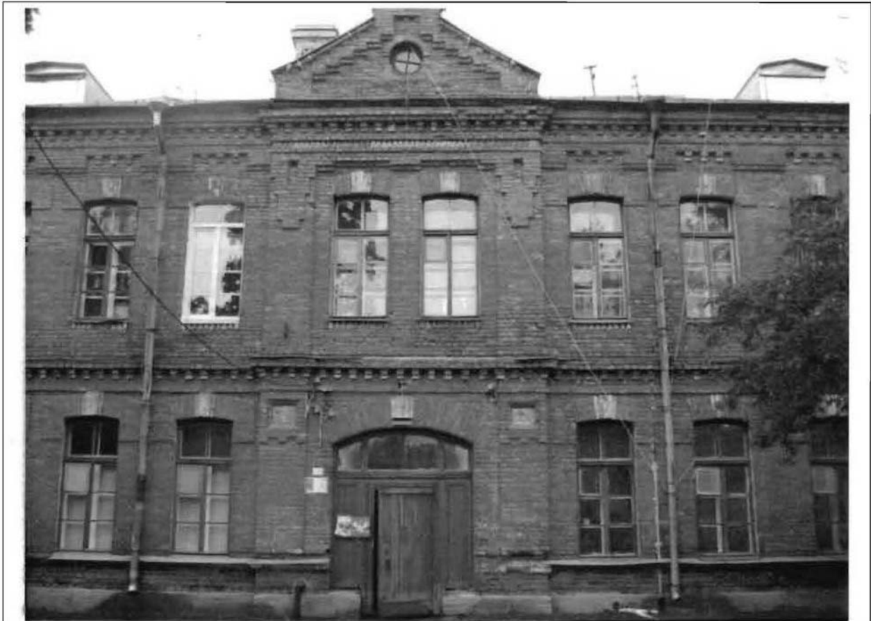
Фото 104. Восточный фасад. Центральная часть. Общий вид.
