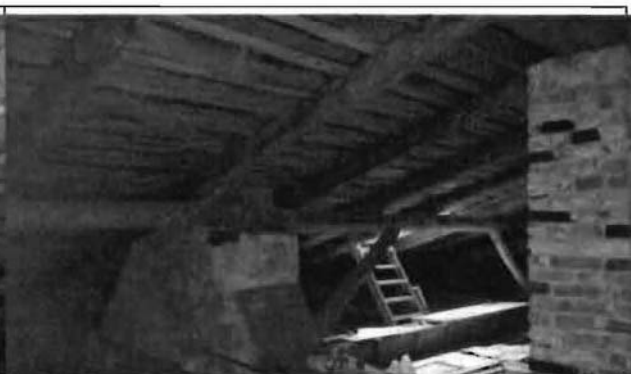
Фото 63. Конструкции крыши. Общий вид.
