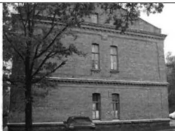
Фото 167. Северный фасад. Общий вид.
