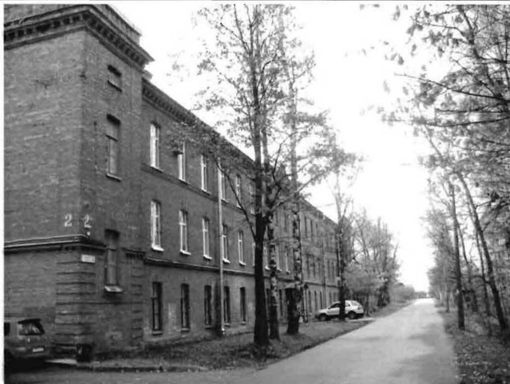
Фото 13. Западный фасад. Общий вид.
