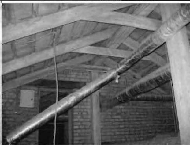
Фото 115. Конструкции крыши. Фрагмент.
