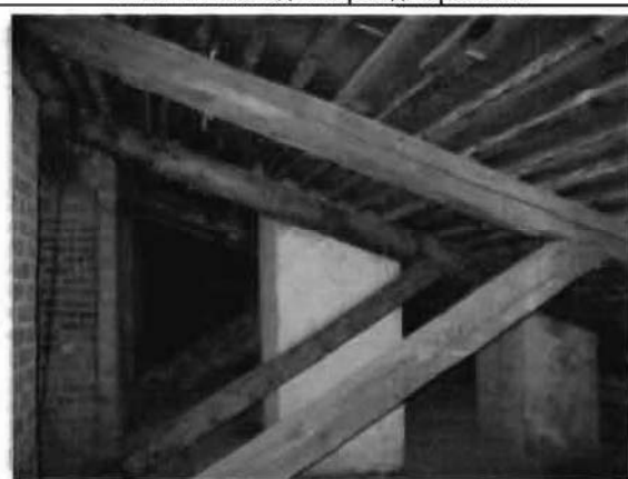
Фото 141. Конструкции крыши. Фрагмент.
