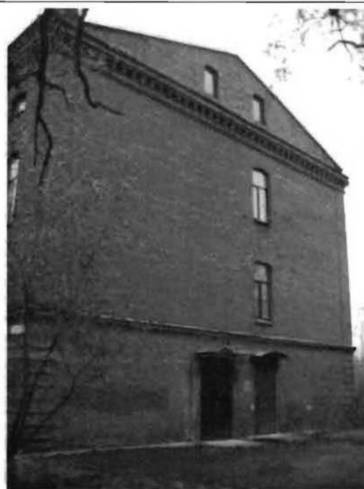
Фото 16. Южный фасад. Общий вид.
