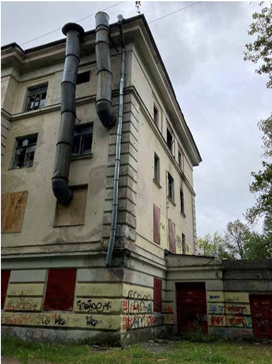
Фото 12. Здание, пристройка-столовая со стороны юго-юго-восточного фасада
