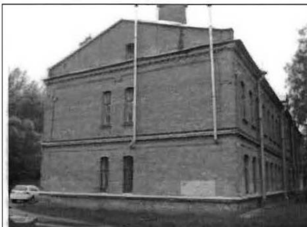
Фото 166. Южный фасад. Общий вид.
