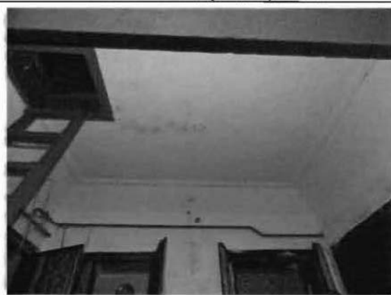
Фото 102. Отделка потолка тамбура. Общий вид.
