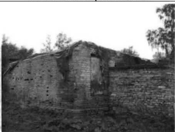
Фото 187. Северный фасад. Общий вид.
