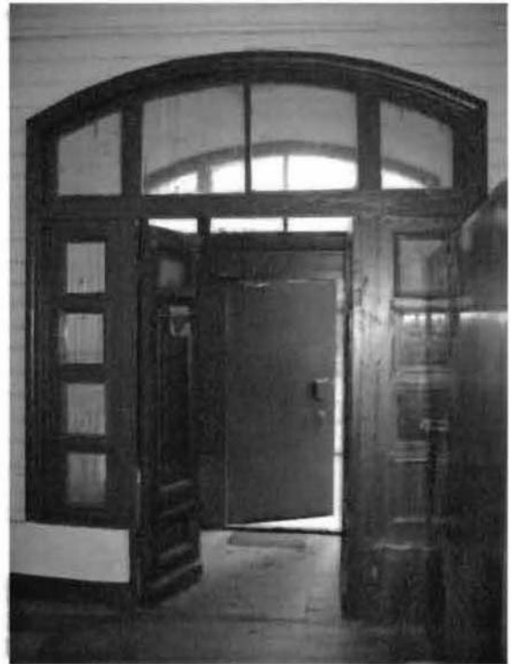
Фото 107. Дверной проем тамбура. Общий вид.
