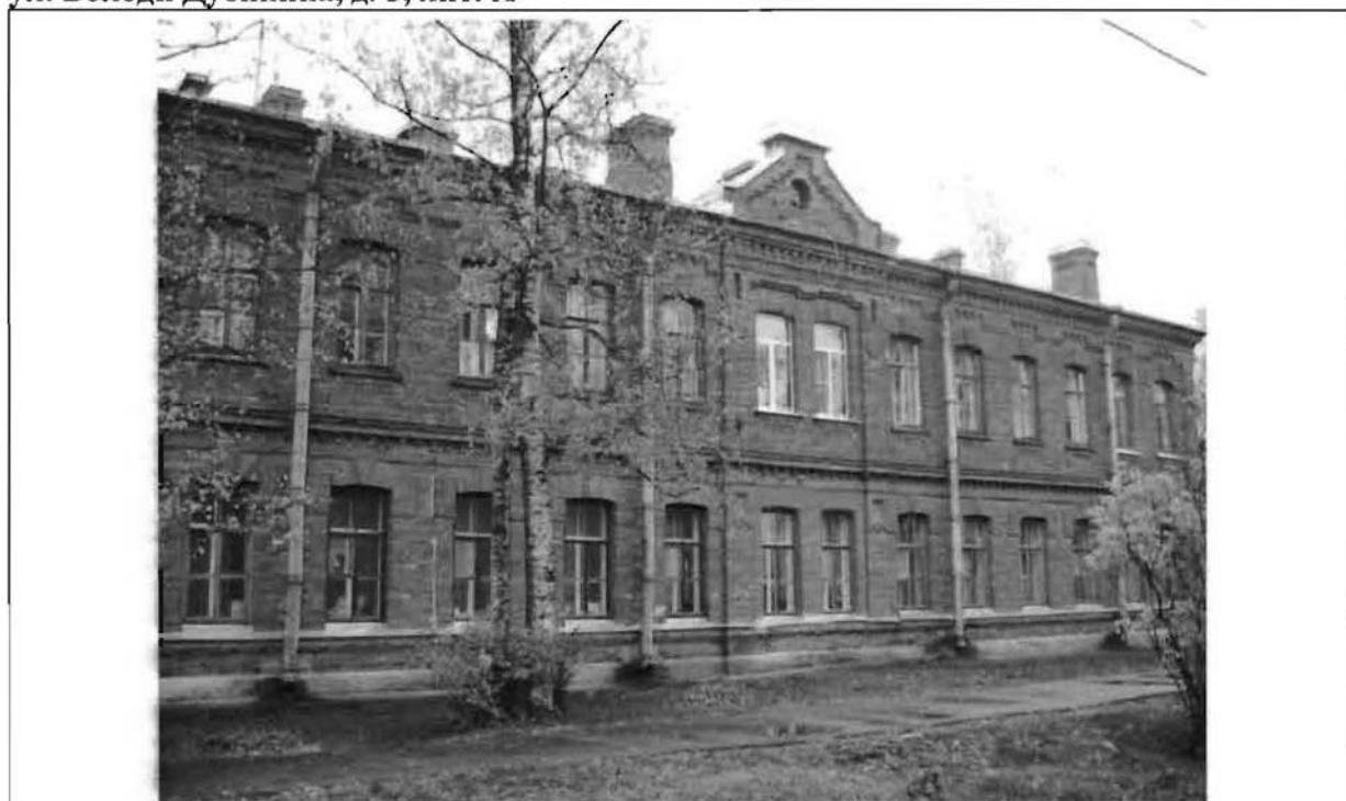
Фото 157. Западный фасад. Общий вид.
