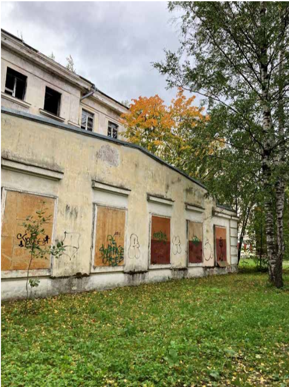
Фото 7. Пристройка-столовая со стороны юго-восточного фасада.
