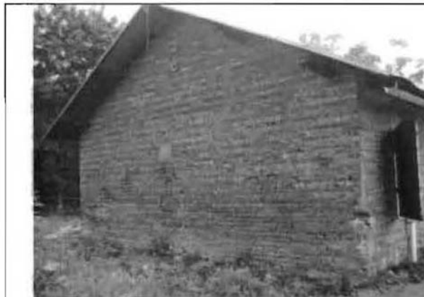
Фото 155. Северный фасад. Общий вид.
