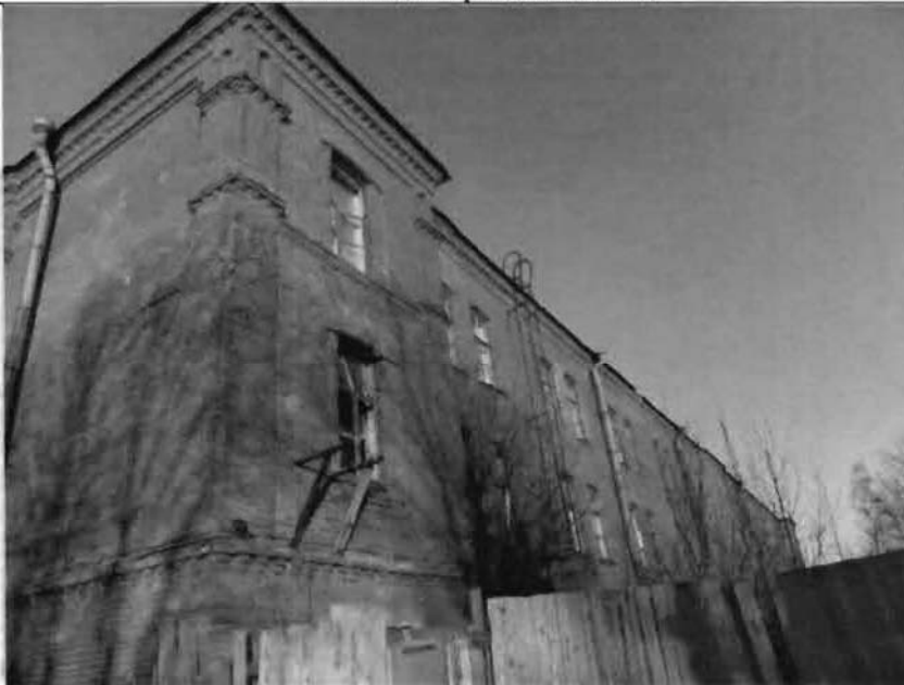
Фото 2. Восточный фасад. Общий вид. 29.12.2015.
