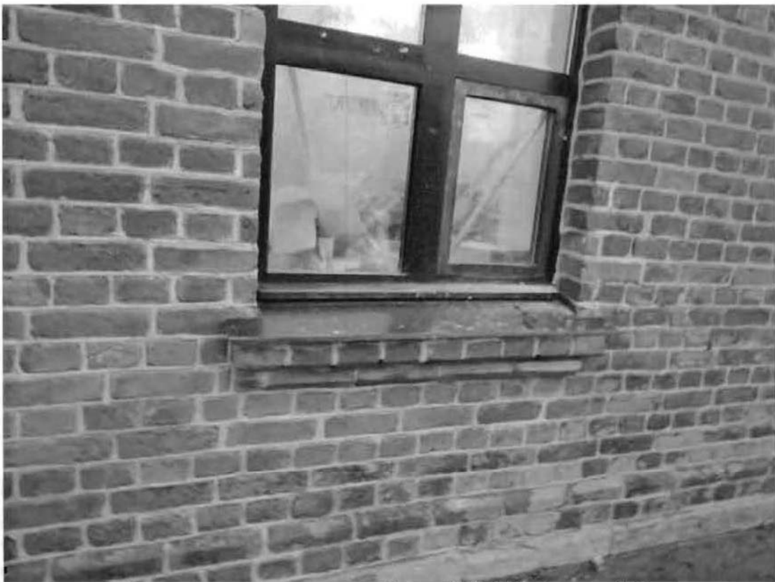
Ступенчатые подоконные доски. Съемка 20.11.2012, Воронина Н.В.
