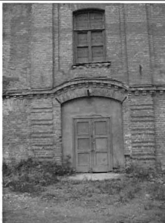
Фото 4. Западный фасад. Фрагмент центральной части фасада.
