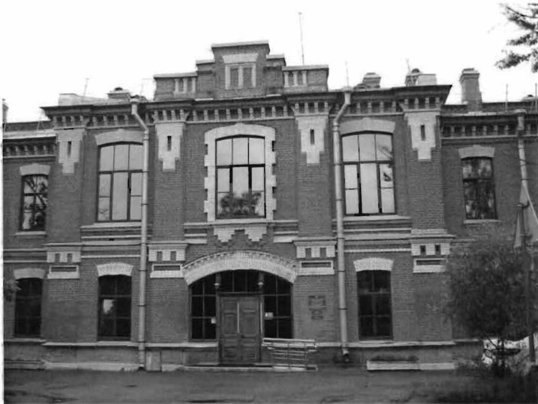
Фото 65. Северный фасад. Фрагмент центральной части фасада.
