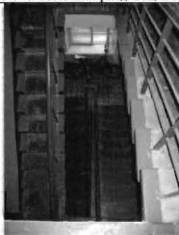
Фото 87. Лестница № 1. Общий вид.
