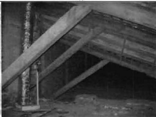
Фото 76. Конструкции крыши. Общий вид.
