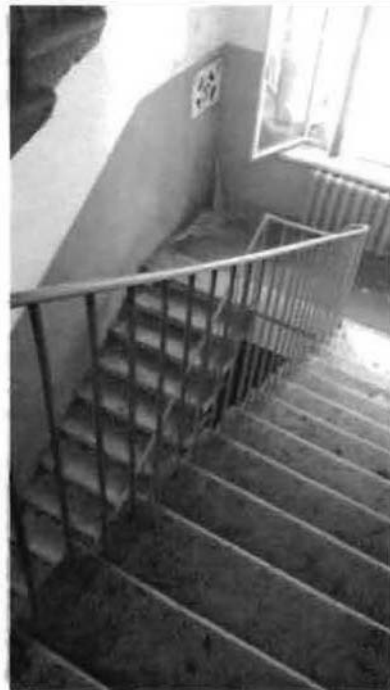
Фото 144. Лестница № 2 в южной части здания. Общий вид.
