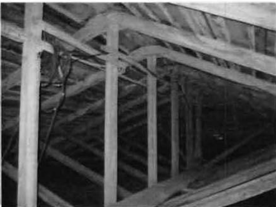
Фото 81. Конструкции крыши. Общий вид.
