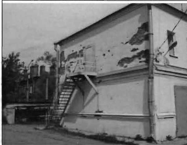
Фото 112. Южный фасад. Общий вид.
