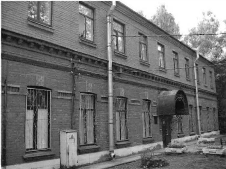
Фото 78. Западный фасад. Общий вид.
