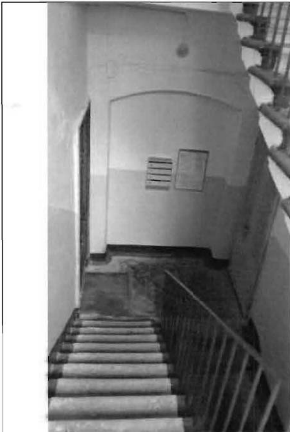
Фото 130. Лестница № 1 в южной части здания. Общий вид.
