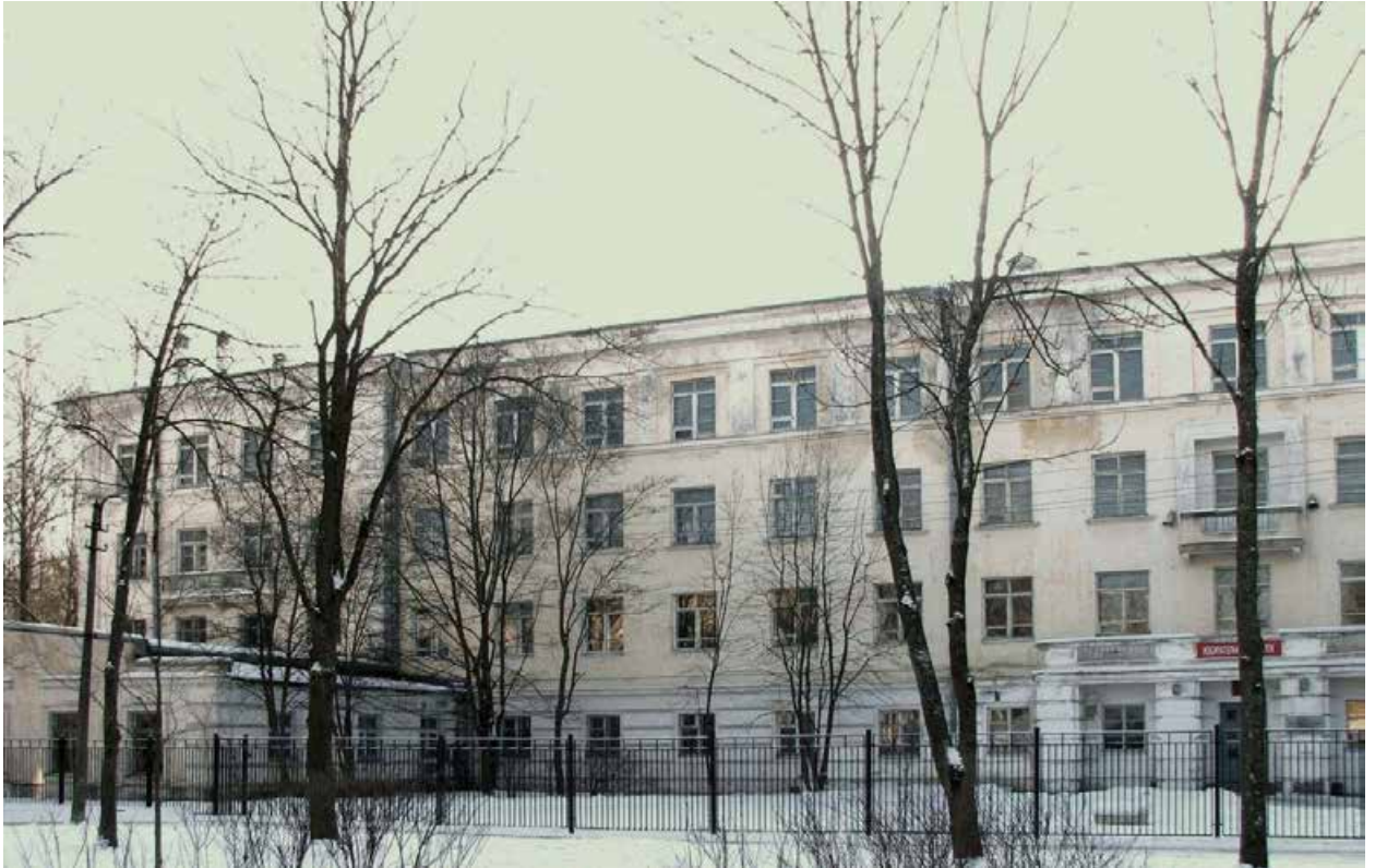
Фото 20. 2012г. Северный фасад. www.citywalls.ru
