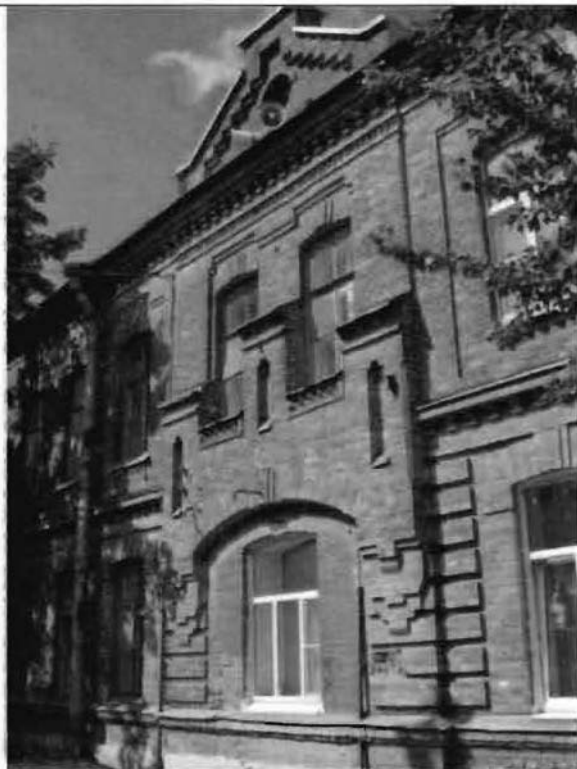
Фото 137. Восточный фасад. Фрагмент.
