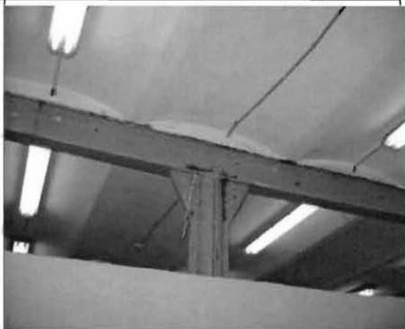
Фото 23. Интерьер. Металлические клепаные колонны и балки. Фрагмент.
