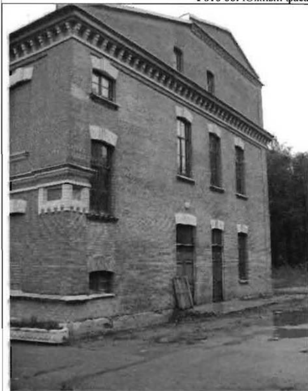
Фото 67. Западный фасад. Общий вид.
