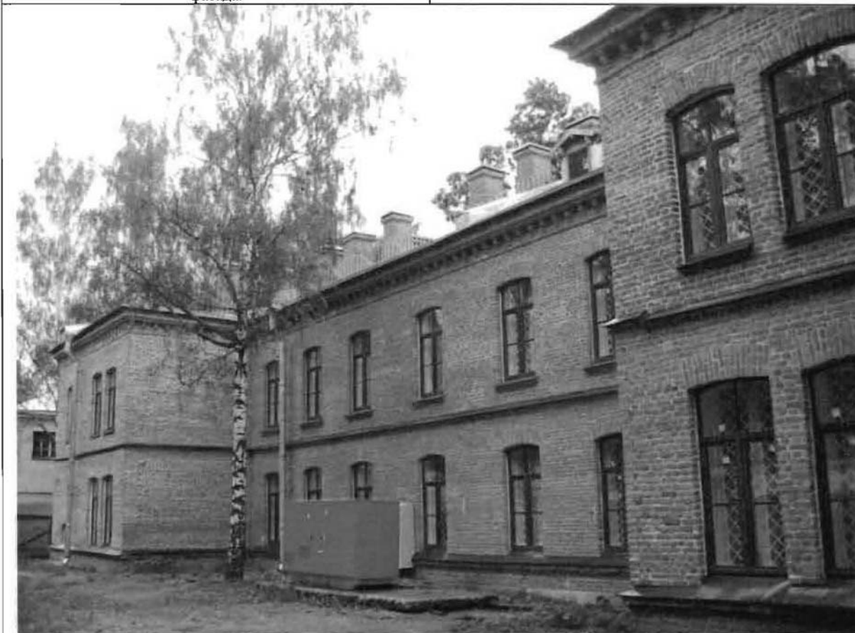
Фото 42. Западный фасад. Общий вид.
