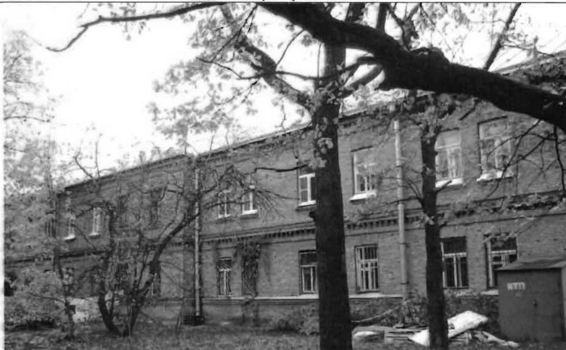
Фото 84. Южный фасад. Общий вид.
