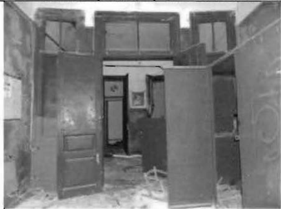
Фото 101. Дверной проем тамбура. Общий вид.
