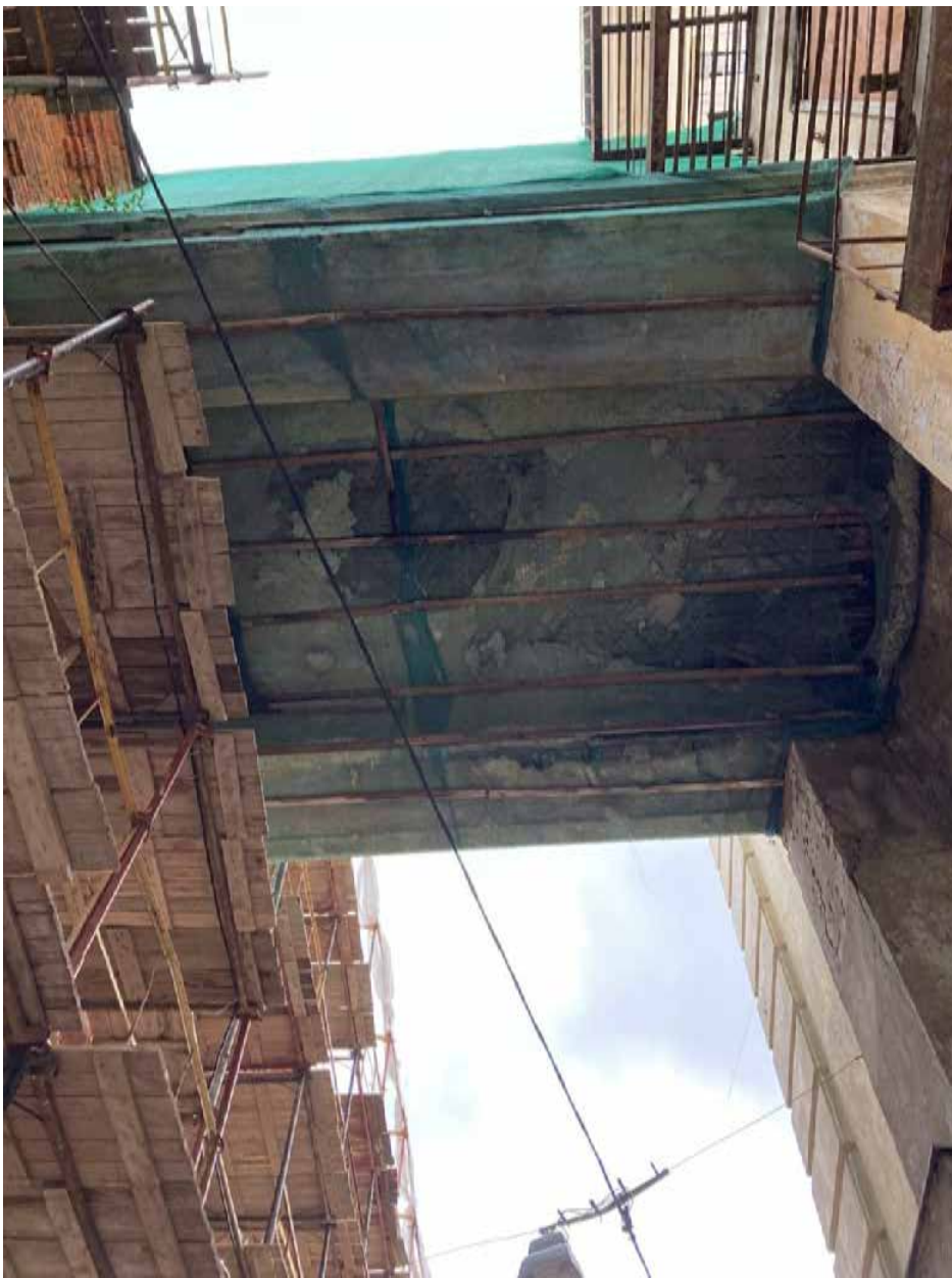
Фото 19. Галерея, примыкающая к ОКН регионального значения «Казармы 148-го пехотного Каспийского полка (с территорией) по адресу ул. Юты Бандеровской, д.21. Вид снизу
