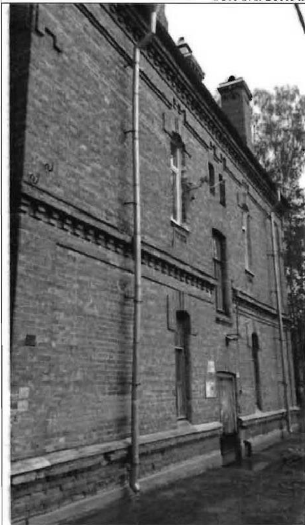
Фото 172. Южный фасад. Общий вид.
