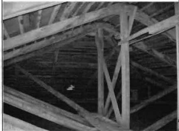
Фото 82. Конструкции крыши. Общий вид.
