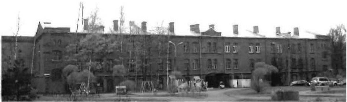
Фото 28. Восточный фасад. Общий вид.
