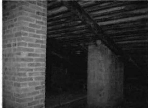
Фото 152. Конструкции крыши. Фрагмент.
