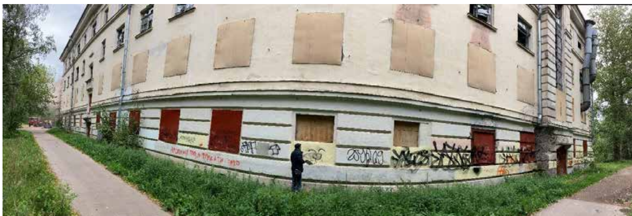
Фото 14. Здание со стороны южного фасада. Панорамный снимок
