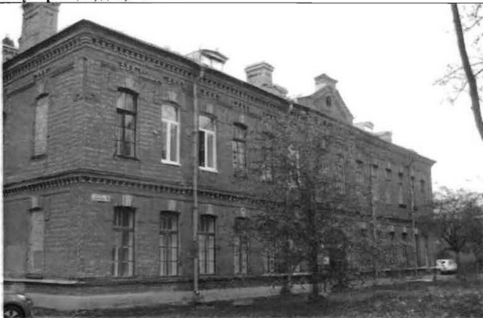
Фото 103. Восточный фасад. Общий вид.
