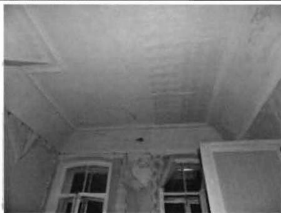
Фото 121. Помещение 1-го этажа.
