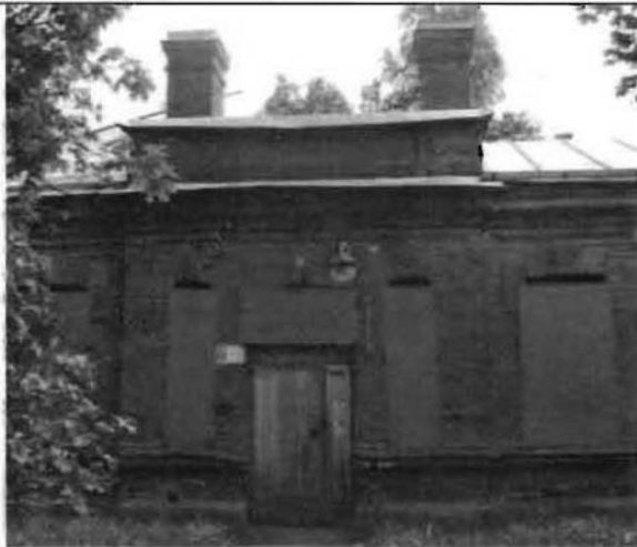
Фото 99. Западный фасад. Центральная часть. Общий вид.
