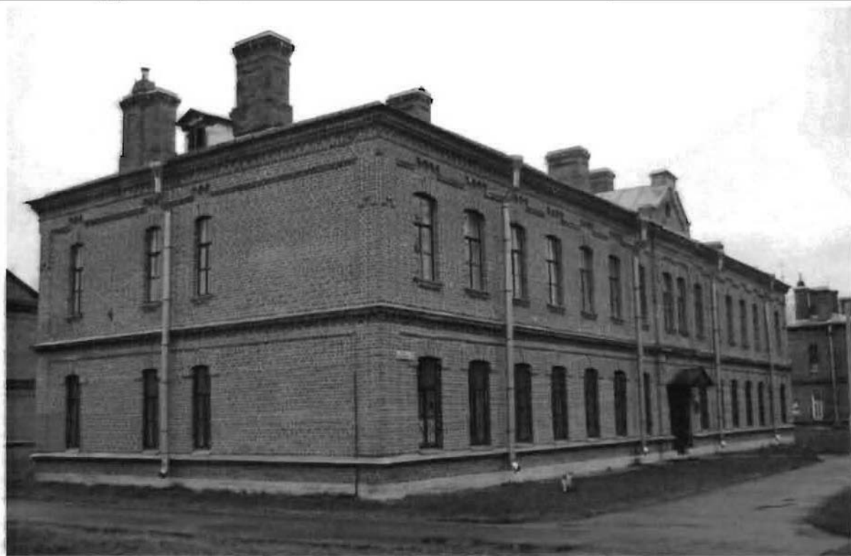
Фото 132. Западный, северный фасады. Общий вид.
