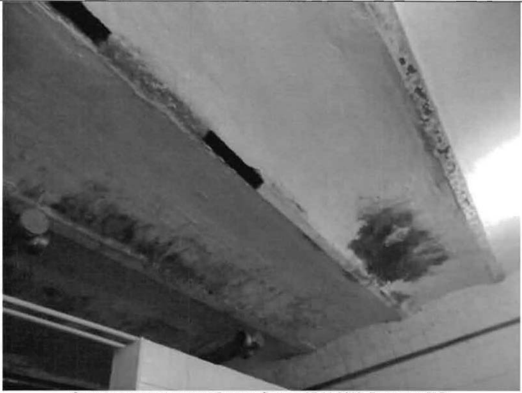
Своды по металлическим балкам. Съемка 27.11.2012, Воронина Н.В.
