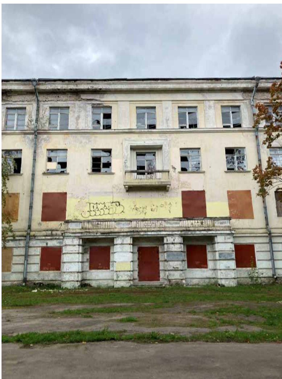
Фото 2. Здание, фасад по ул. Юты Бондаровской. Главный вход в здание (северный фасад)
