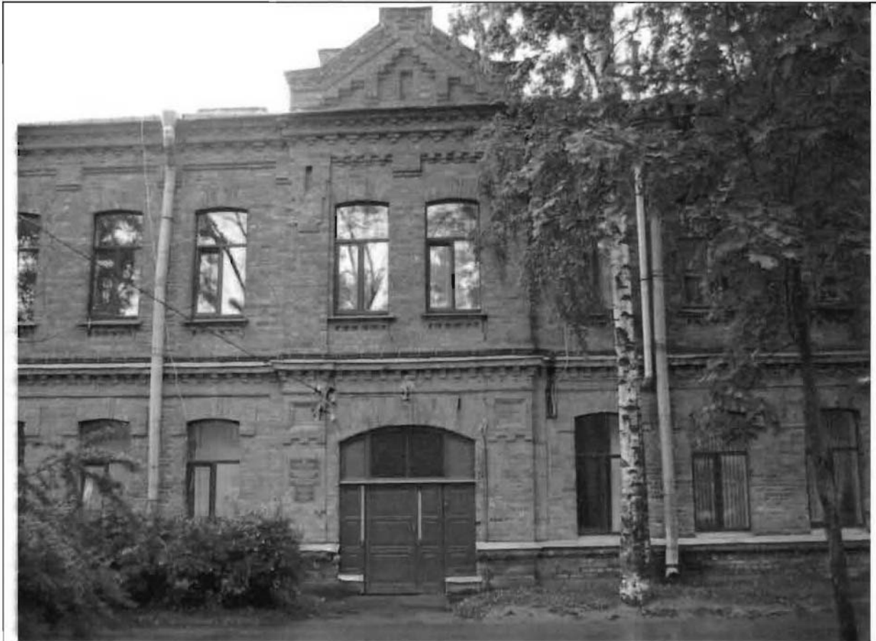
Фото 164. Восточный фасад. Фрагмент центральной части фасада.
