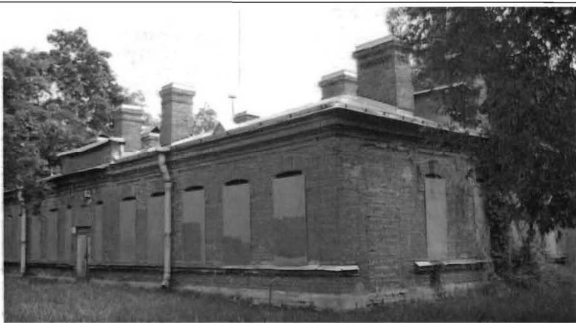
Фото 98. Западный фасад. Общий вид.
