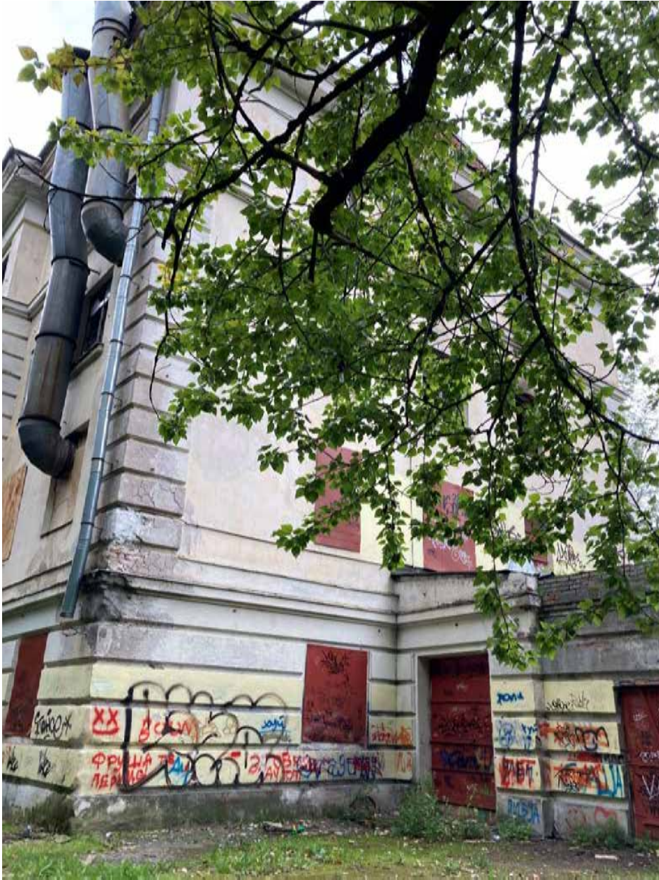
Фото 11. Пристройка-столовая со стороны юго-восточного фасада
