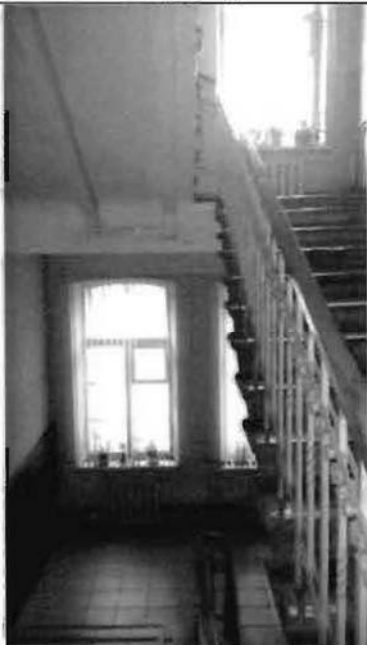
Фото 35. Интерьер. Лестница. Общий вид.
