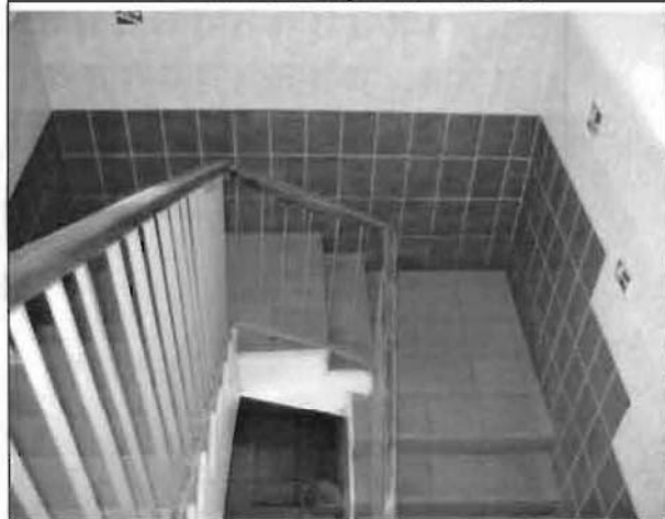
Фото 114. Лестница. Общий вид.
