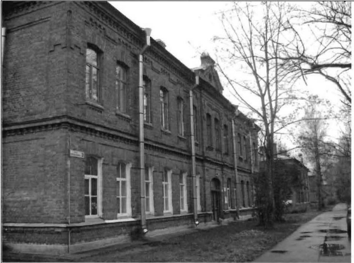
Фото 146. Западный фасад. Общий вид.
