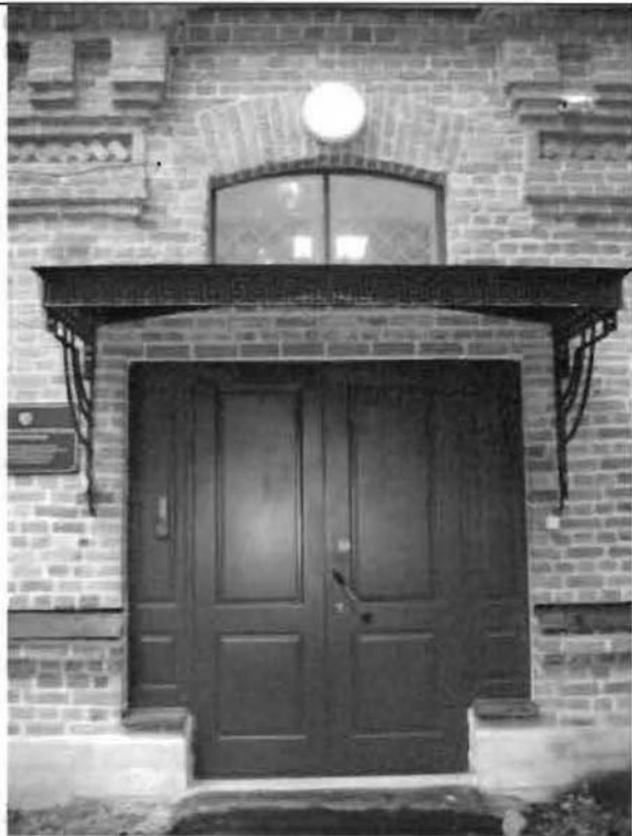
Фото 41. Дверной проем восточного фасада. Общий вид.
