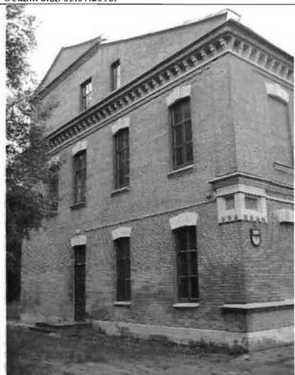
Фото 68. Восточный фасад. Общий вид.
