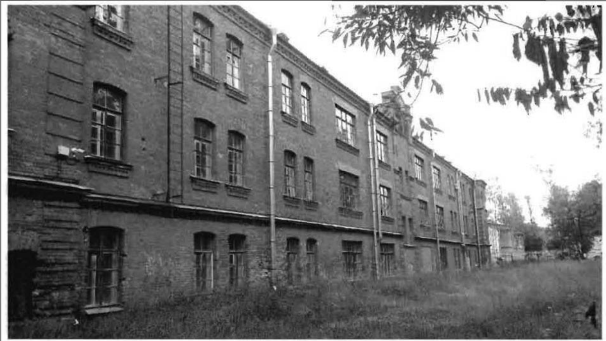
Фото 48. Западный фасад. Общий вид.
