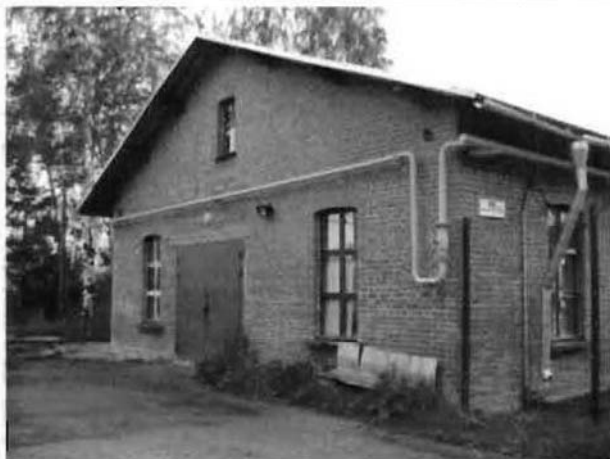
Фото 20. Северный фасад. Общий вид.
