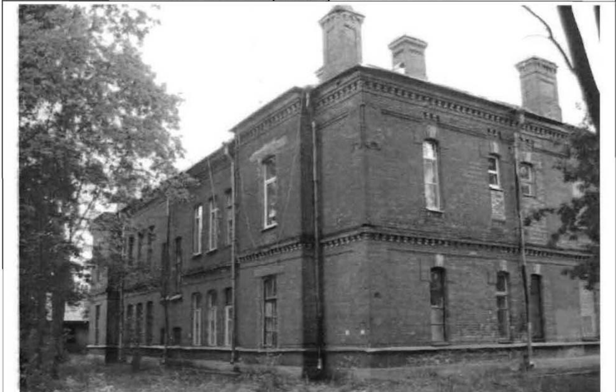
Фото 105. Западный, южный фасады. Общий вид.
