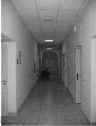
Фото 69. Интерьер. Коридор в уровне 1-го этажа. Общий вид
