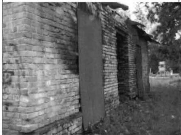
Фото 95. Северный фасад. Общий вид.
