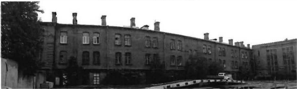
Фото 29. Западный фасад. Общий вид.
