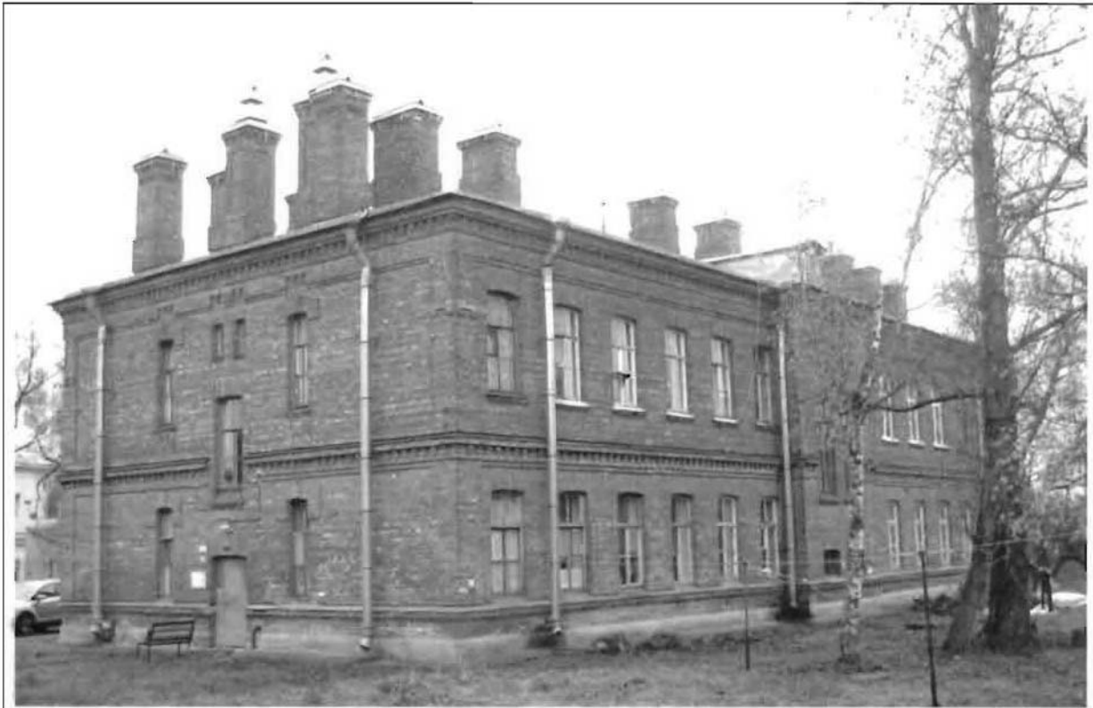
Фото 129. Западный, северный фасады. Общий вид.
