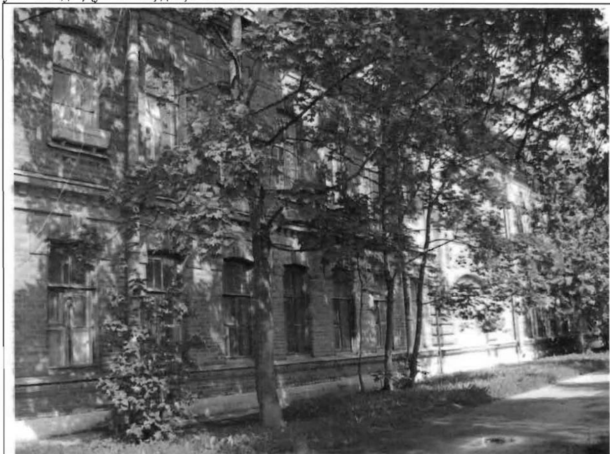
Фото 136. Восточный фасад. Общий вид.
