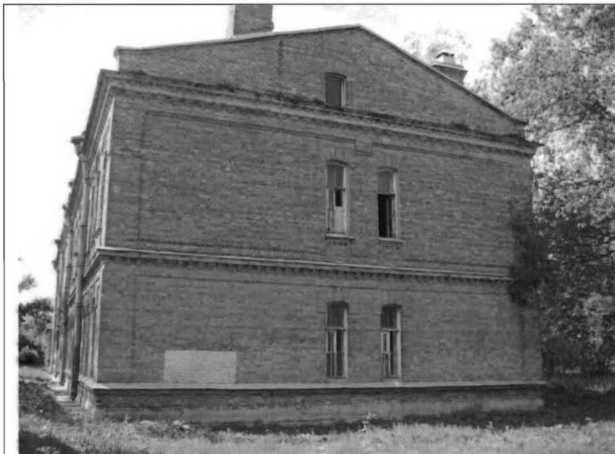
Фото 180. Северный фасад. Общий вид.
