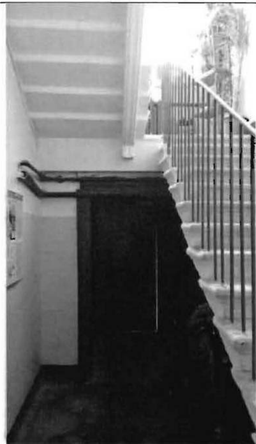
Фото 131. Лестница № 2 в северной части здания. Общий вид.
