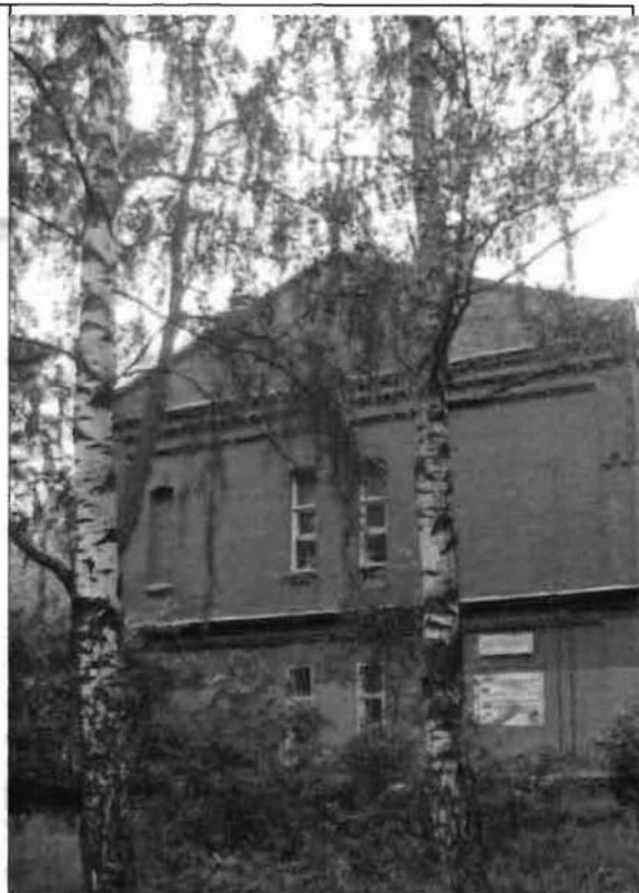
Фото 91. Северный фасад. Общий вид.
