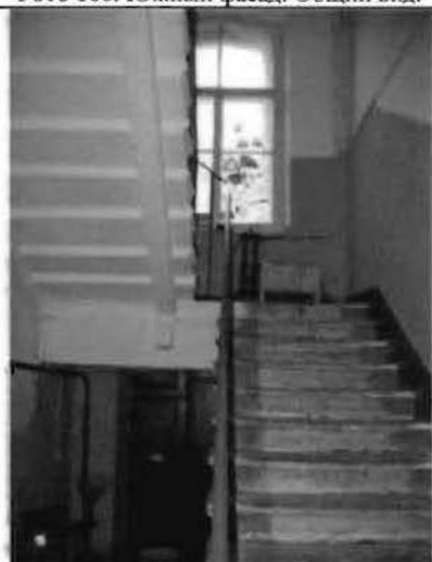
Фото 168. Лестница в южной части здания. Общий вид.
