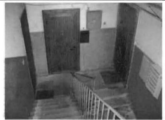
Фото 162. Лестница № 2 в северной части здания. Фрагмент.
