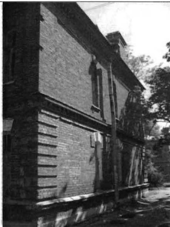
Фото 138. Южный фасад. Общий вид.
