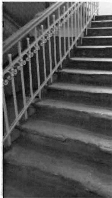
Фото 57. Лестница в центральной части здания. Фрагмент.
