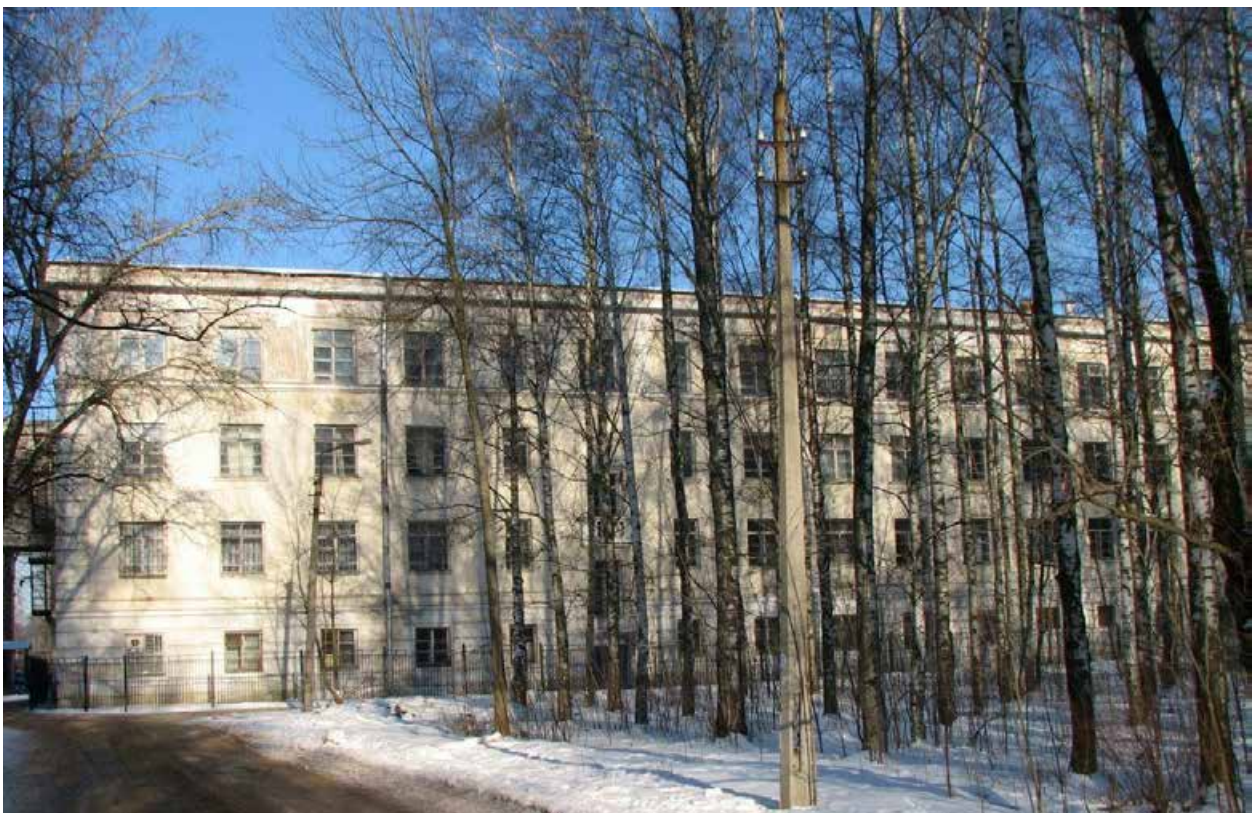
Фото 21. 2012г. Южный фасад. www.citywalls.ru
