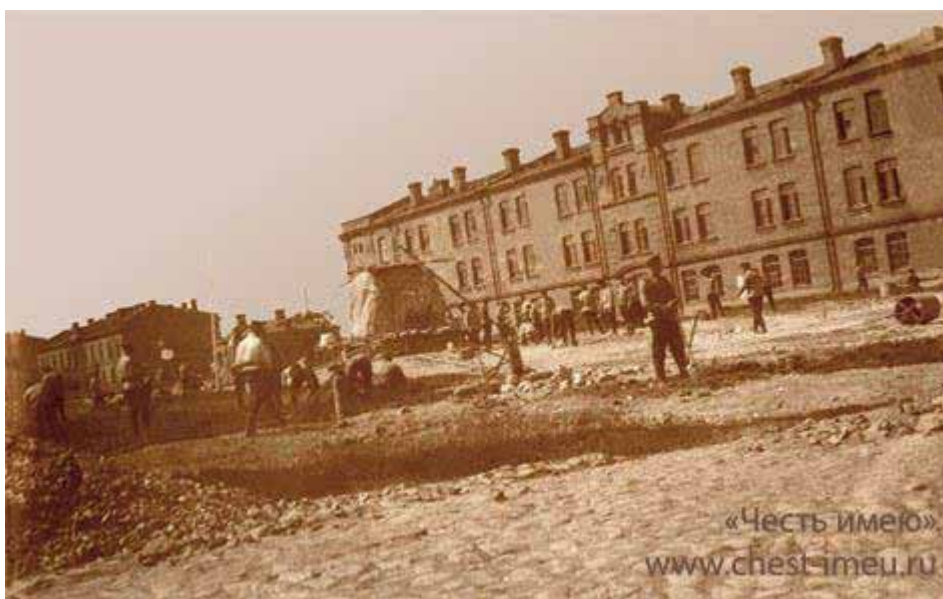
Фото 11. Строительство памятника Каспийцам. www.chet-imeu.ru
