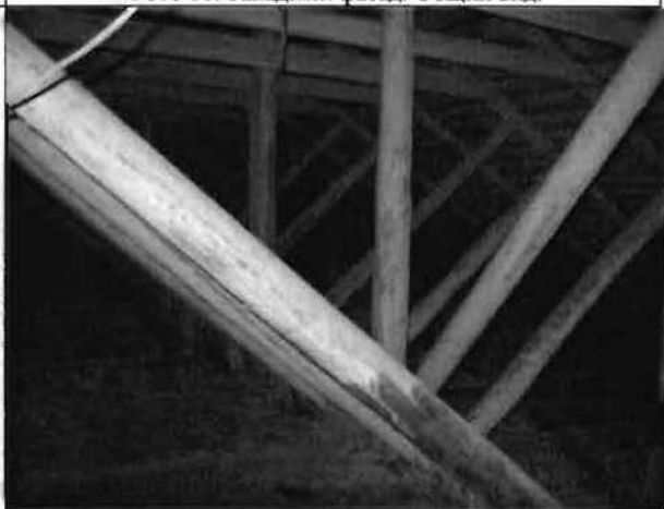
Фото 88. Конструкции крыши. Общий вид.
