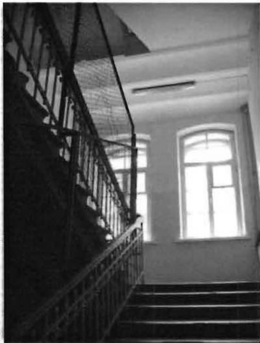
Фото 56. Лестница в центральной части здания. Фрагмент.
