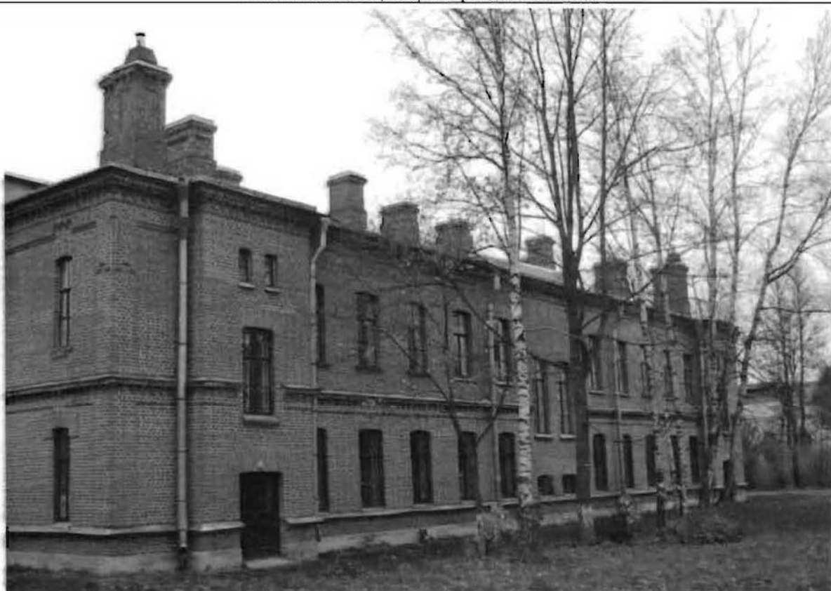
Фото 133. Восточный фасад. Общий вид.
