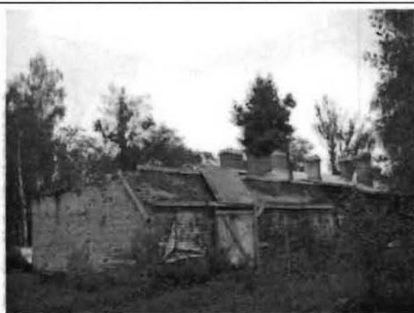
Фото 186. Западный, северный фасады. Общий вид.
