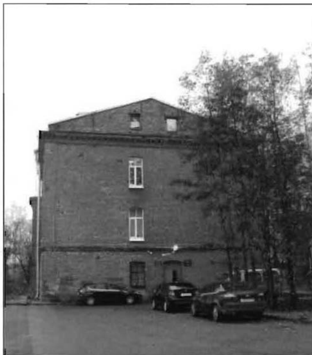
Фото 15. Северный фасад. Общий вид.
