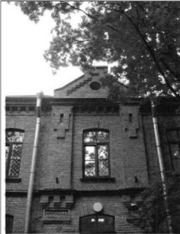
Фото 40. Восточный фасад. Фрагмент центральной части фасада.
