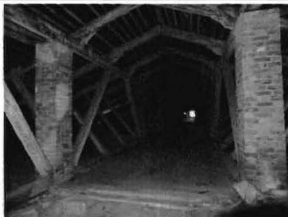
Фото 12. Конструкции крыши. Общий вид. 29.12.2015.
