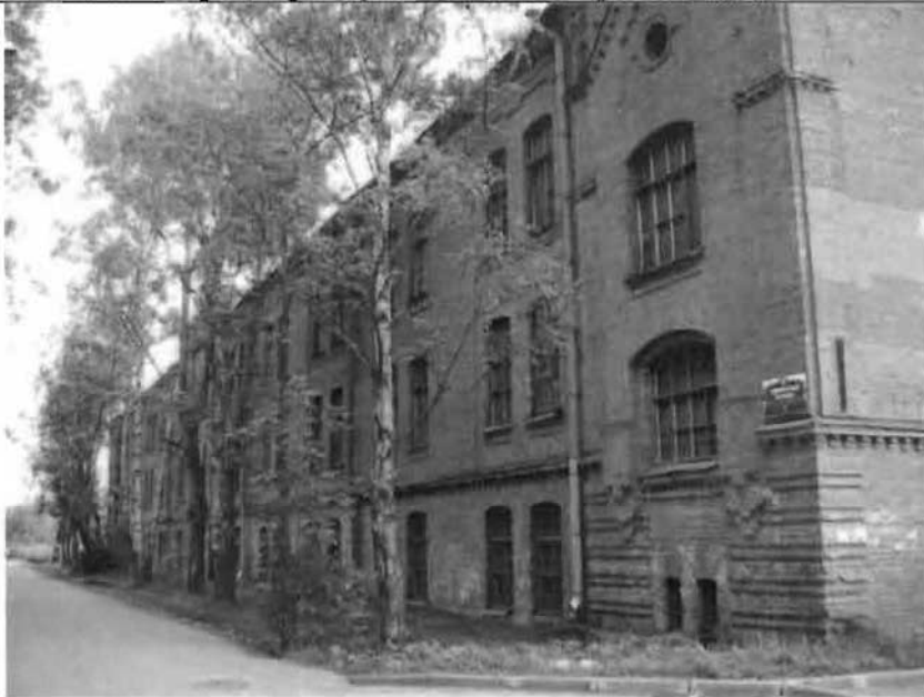
Фото 1. Западный фасад. Общий вид.
