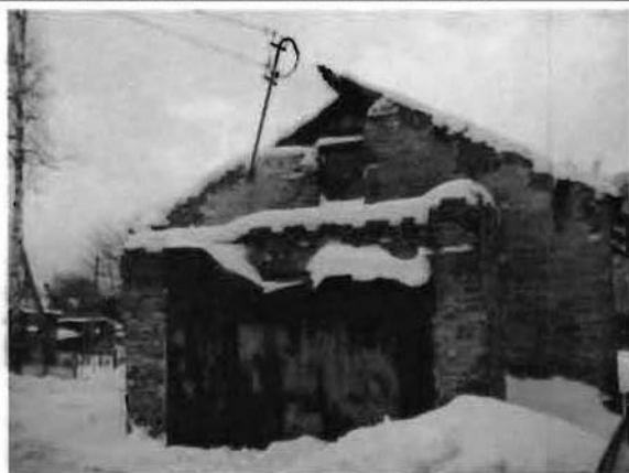
Фото 184. Восточный фасад. Общий вид. 14.01.2015.
