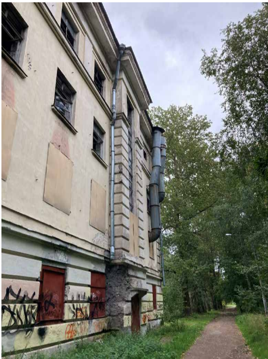
Фото 16. Здание со стороны южного фасада.
