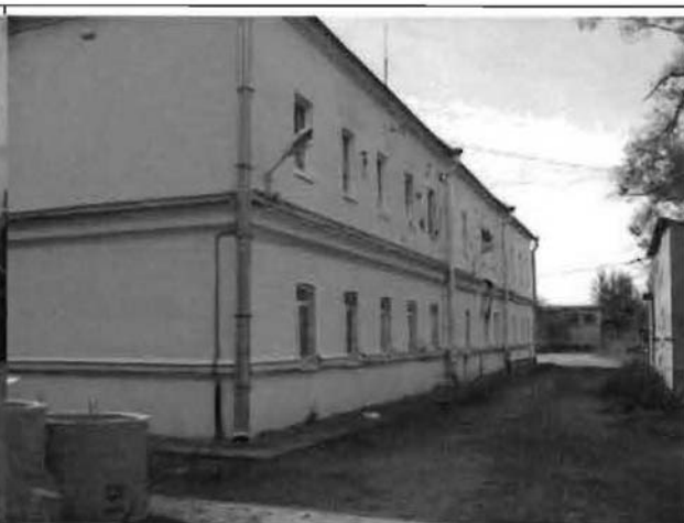
Фото 111. Западный фасад. Общий вид.
