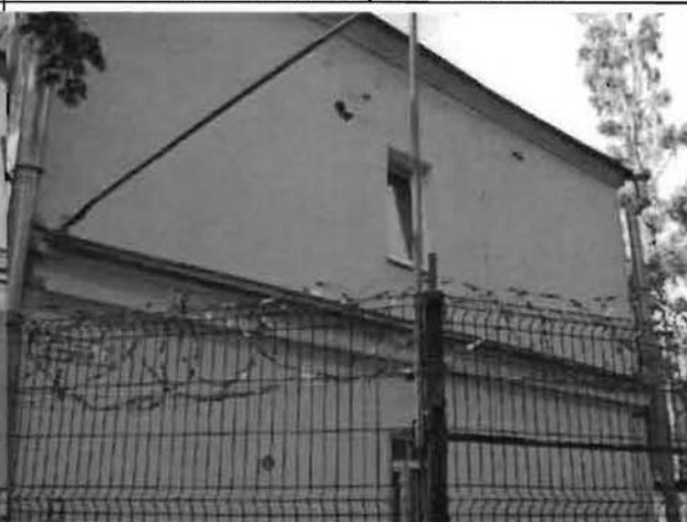
Фото 113. Северный фасад. Общий вид.
