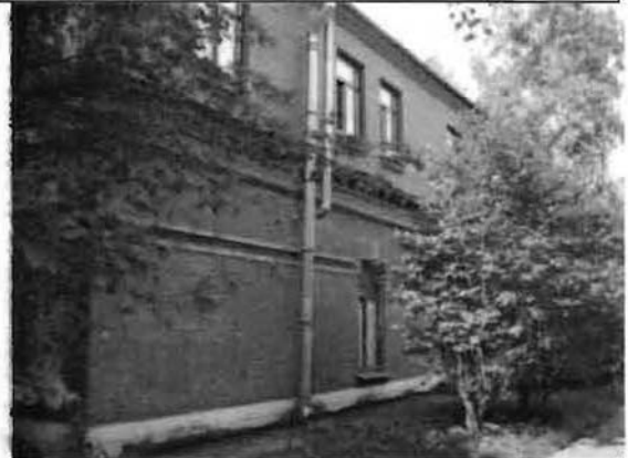
Фото 80. Северный фасад. Фрагмент.
