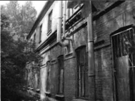
Фото 79. Восточный фасад. Общий вид.
