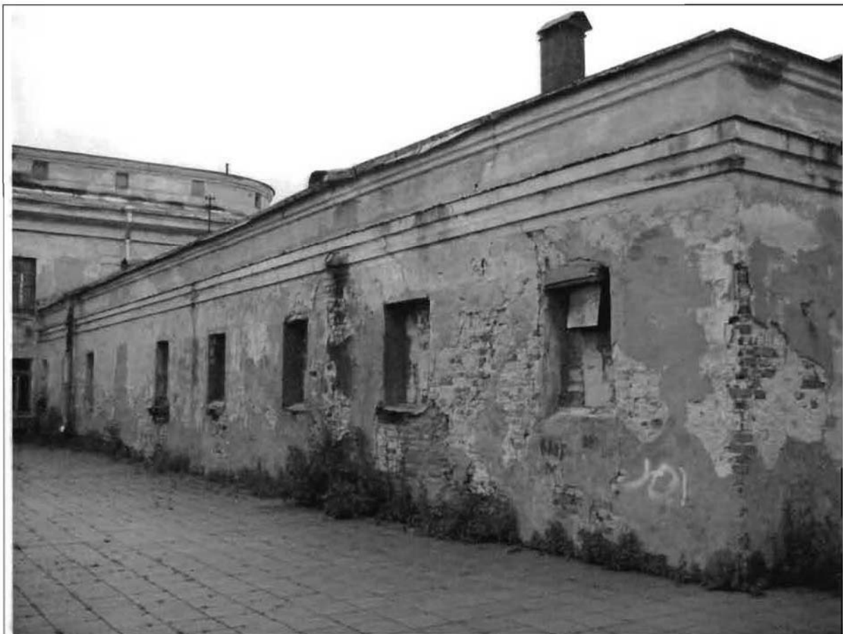
Фото 25. Восточный фасад. Общий вид.
