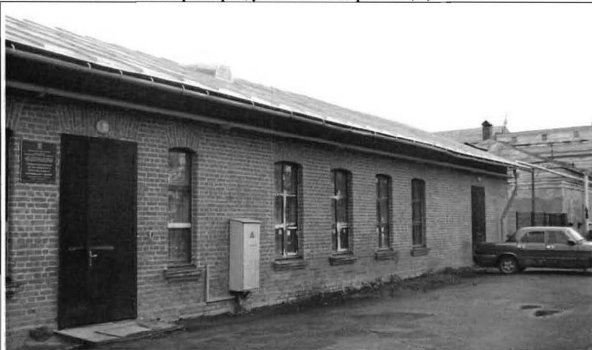
Фото 18. Западный фасад. Общий вид.
