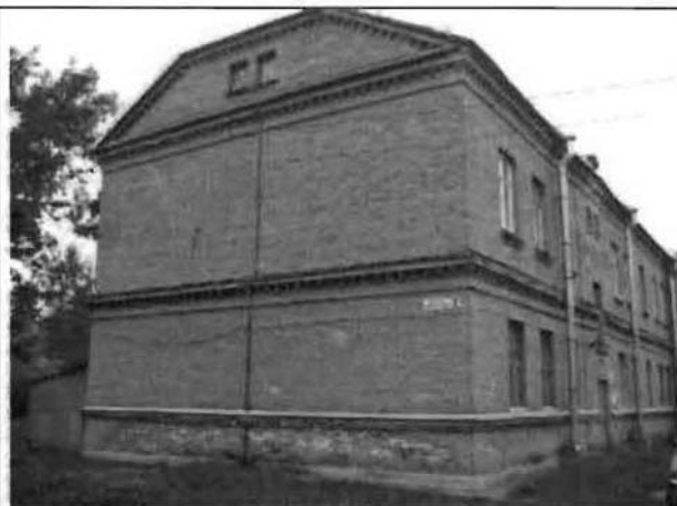
Фото 85. Восточный фасад. Общий вид.
