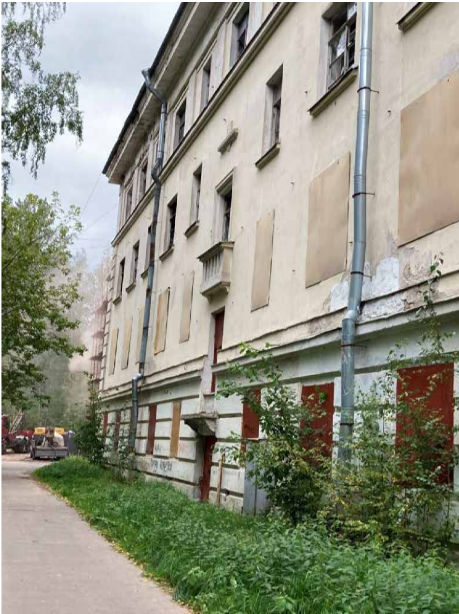
Фото 17. Здание со стороны южного фасада.
