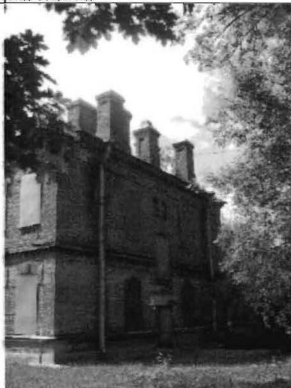
Фото 118. Северный фасад. Общий вид.
