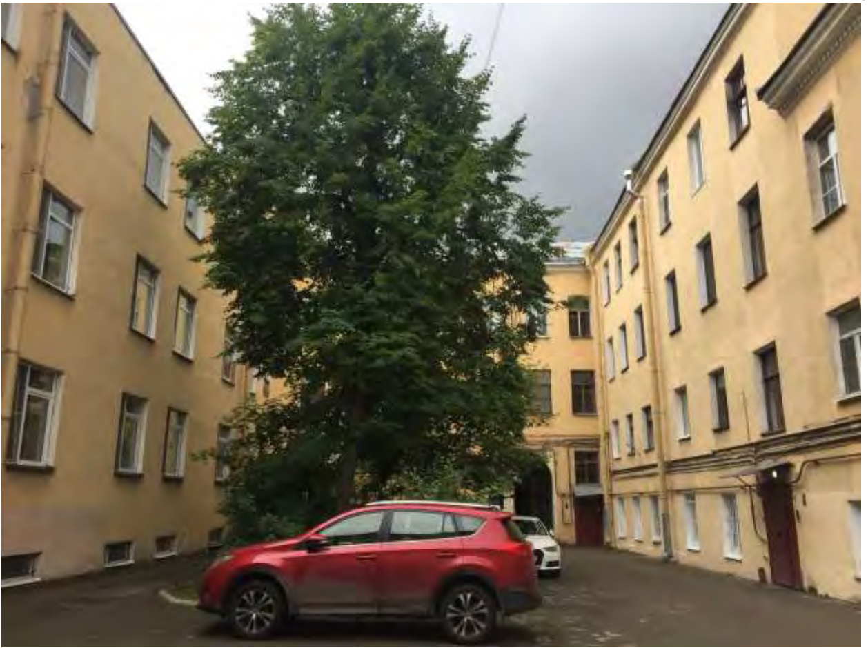
Фото 5. Общий вид северо-восточного и юго-восточного дворовых фасадов. Вид с северо-востока.
