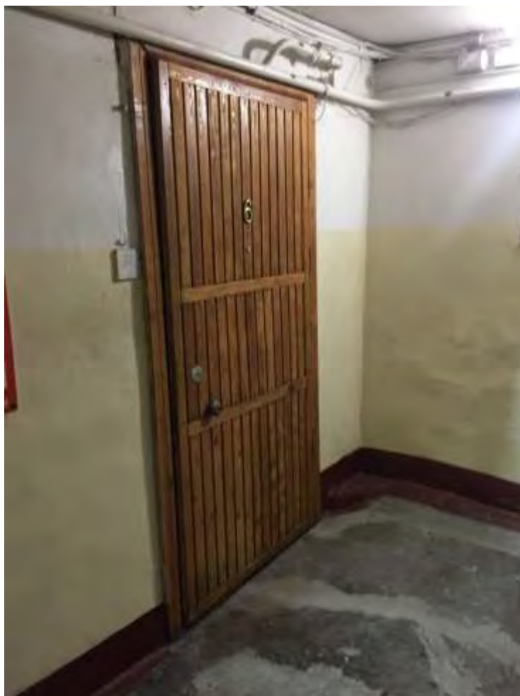
Фото 9. Вход в квартиру с лестничной клетки. Вид с востока.
