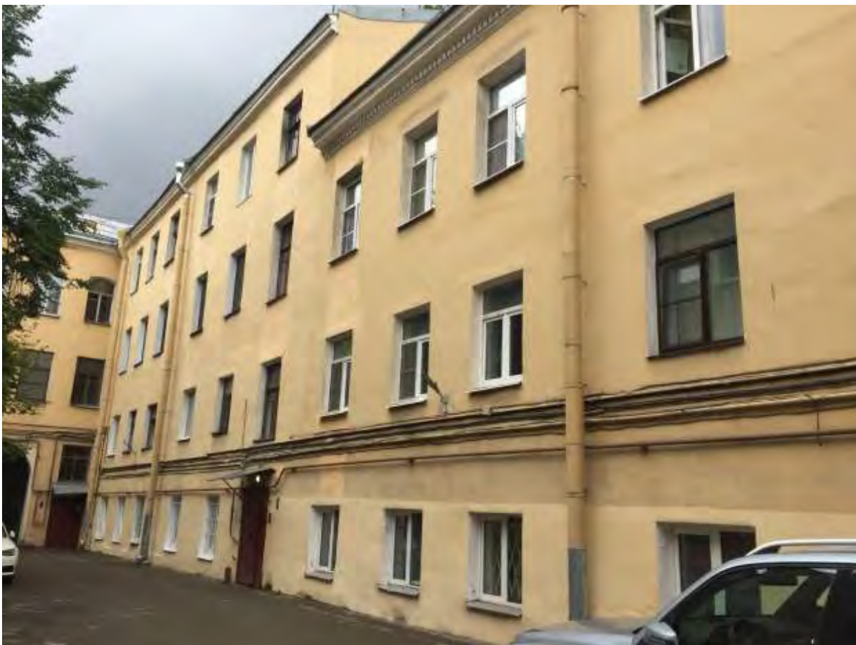
Фото 8. Юго-восточного дворовой фасад. Вид с северо-востока.
