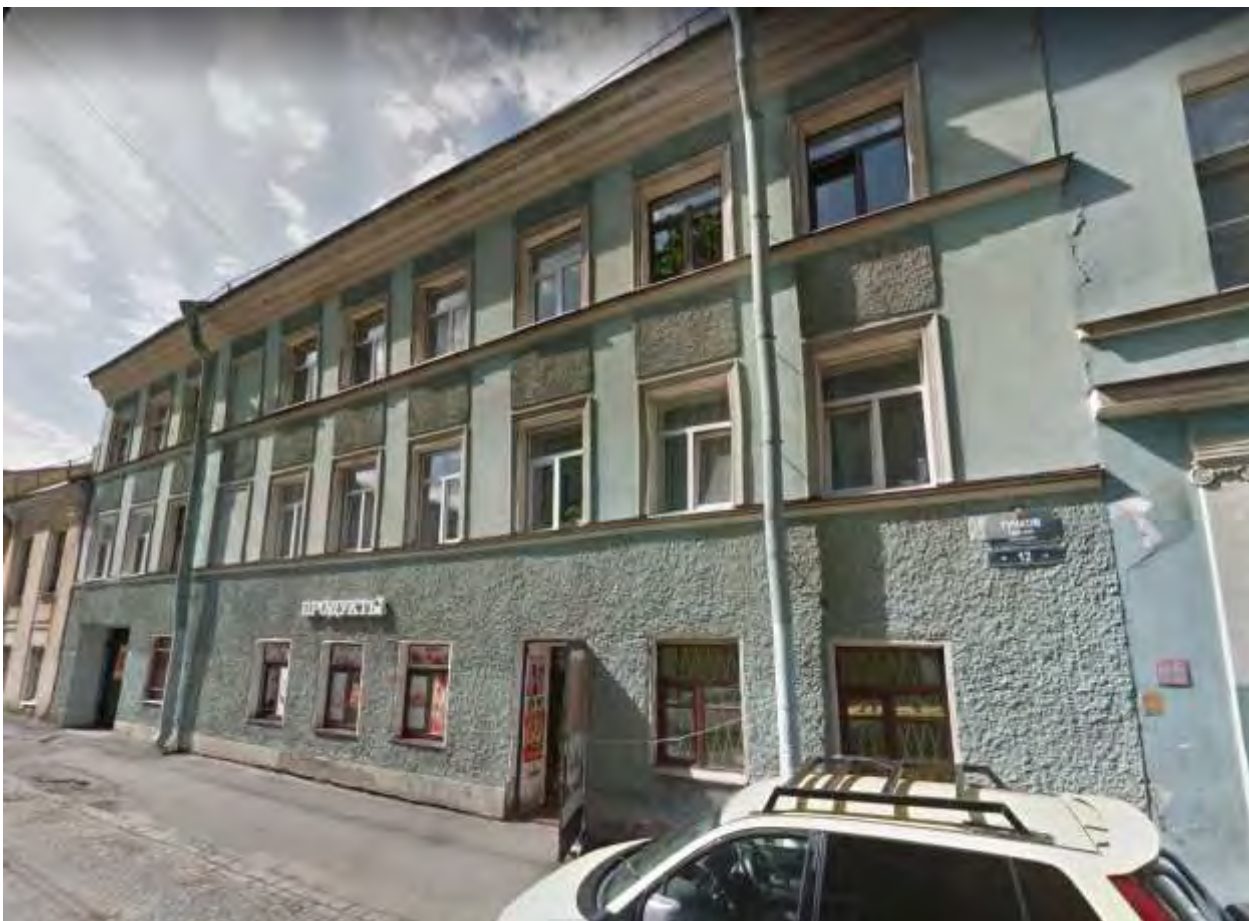
Фото 4. Лицевой фасад объекта культурного наследия по Тучкову переулку. Вид с северо-востока.
