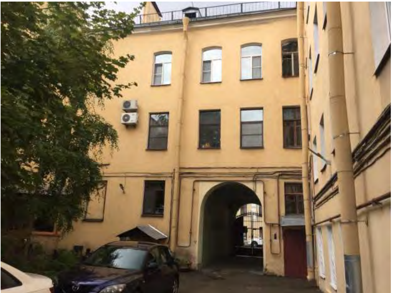
Фото 6. Северо-восточный дворовой фасад. Вид с северо-востока.
