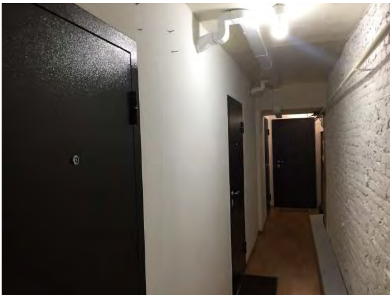
Фото 10. Общий вид коридора (бывшее помещение № 1). Вид с северо-востока.
