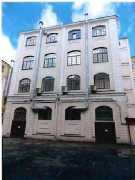
24. Вид на южный фасад (корпус 7).
