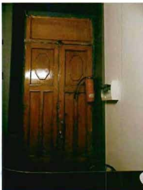
11. Дверные заполнения помещений.
