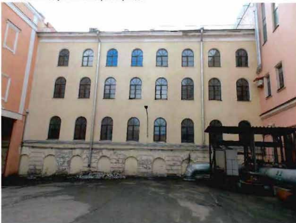
12. Вид на западную часть северного фасада.
