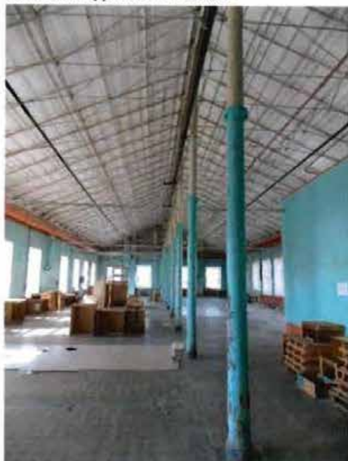
22. Конструкции крыши. Колонны в уровне 4-го этажа.
