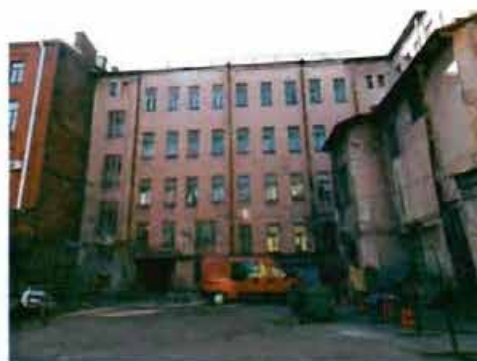
6. Северный дворовой фасад.
