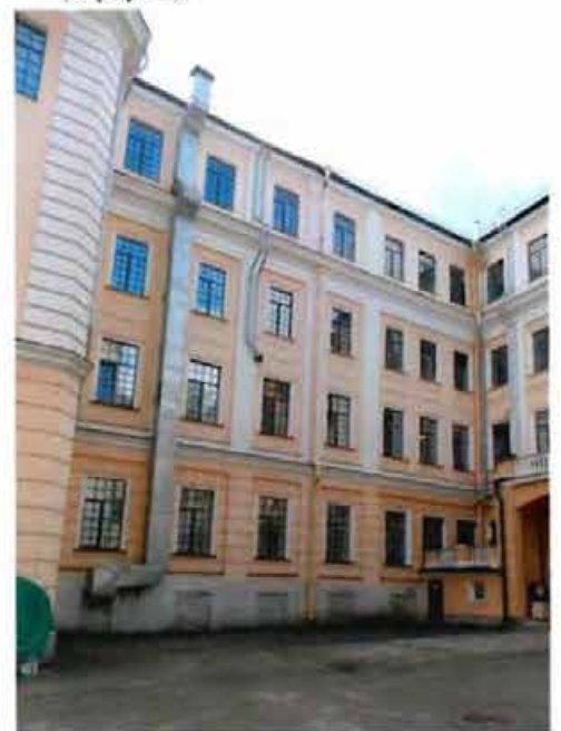
21. Вид на северный (дворовый) фасад (корпус 1).
