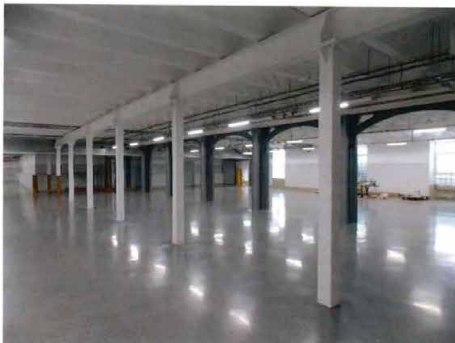
33. Колонны 2-го этажа.
