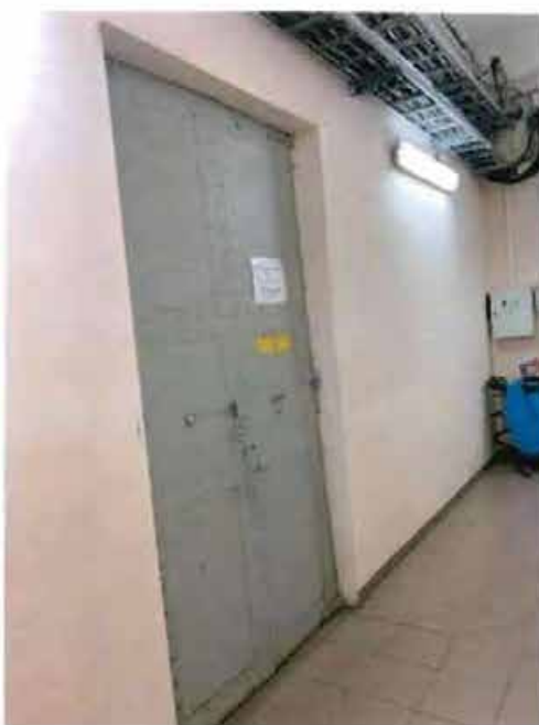
23. Дверное заполнение коридора 1-го этажа.
