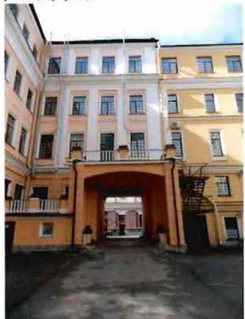
20. Вид на восточный (дворовый) фасад (корпус 1).
