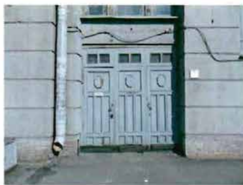
2. Фрагмент южного фасада.
