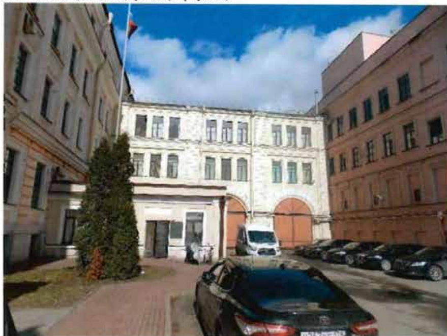
16. Вид на южный (лицевой) фасад (корпус 20).
