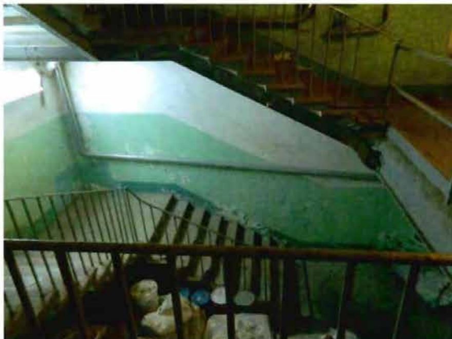
27. Трехмаршевая лестница в северной части корпуса 2.
