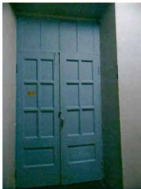
12. Дверные заполнения помещений.
