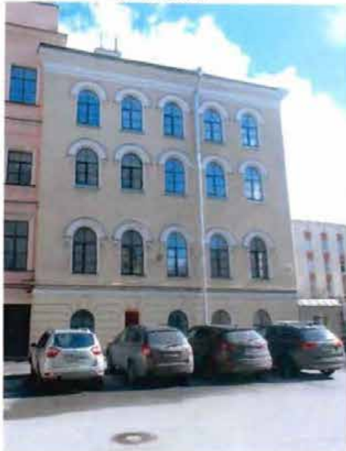
10. Вид на западный фасад
