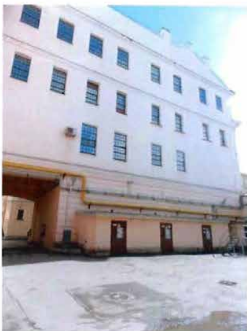
18. Вид на западный фасад (корпус 1).
