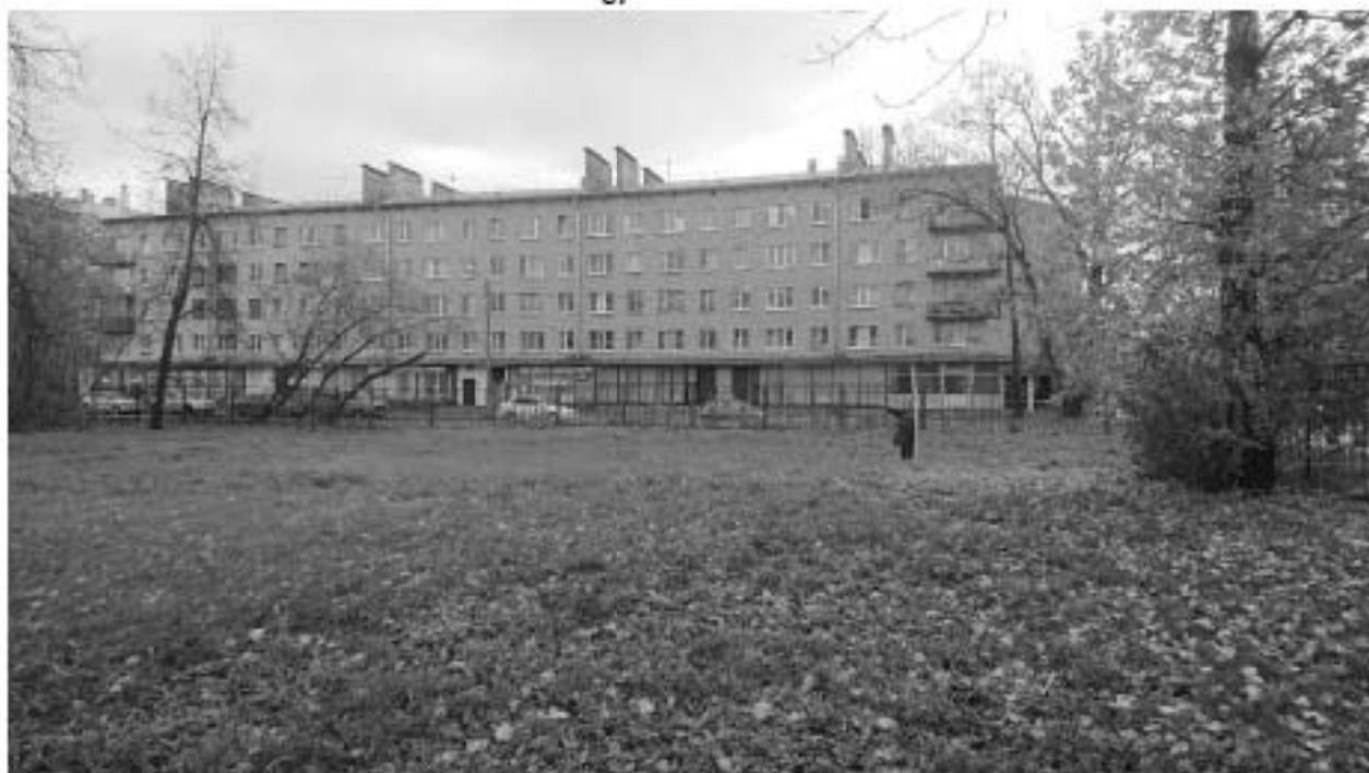
Рис. 27. Санкт-Петербург, Невский район, улица Ольминского, д. 13, литера А, «Колледж метростроя». Вид на прилегающую территорию колледжа с юго-запада (ТС 4).
