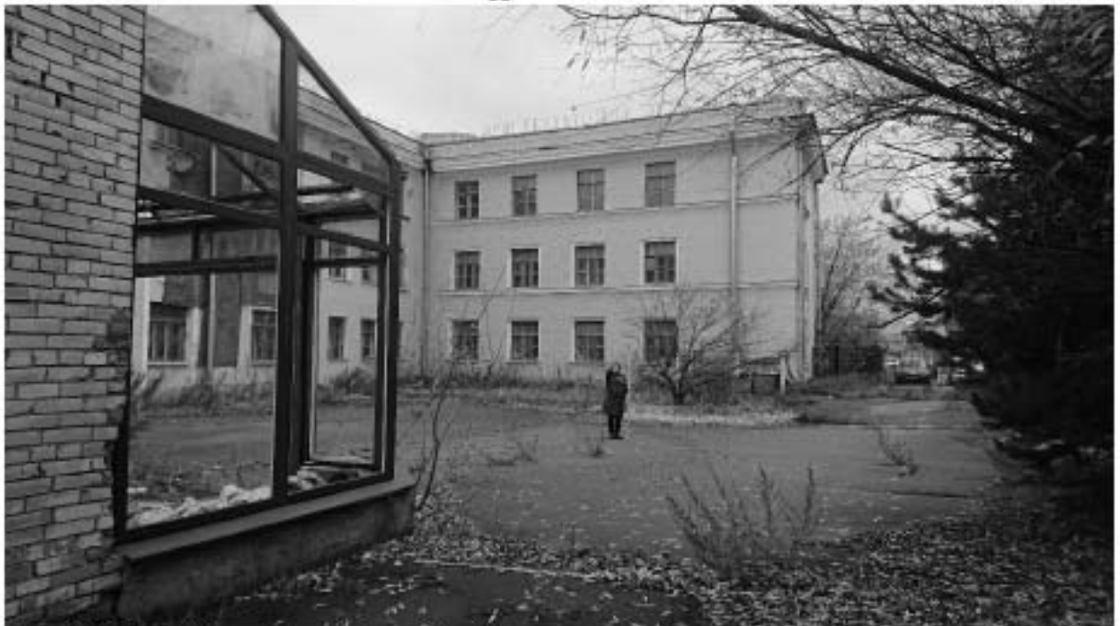
Рис. 23. Санкт-Петербург, Невский район, улица Ольминского, д. 13, литера А, «Колледж метростроя». Вид на задний двор колледжа с севера (вид на ТС 3).
