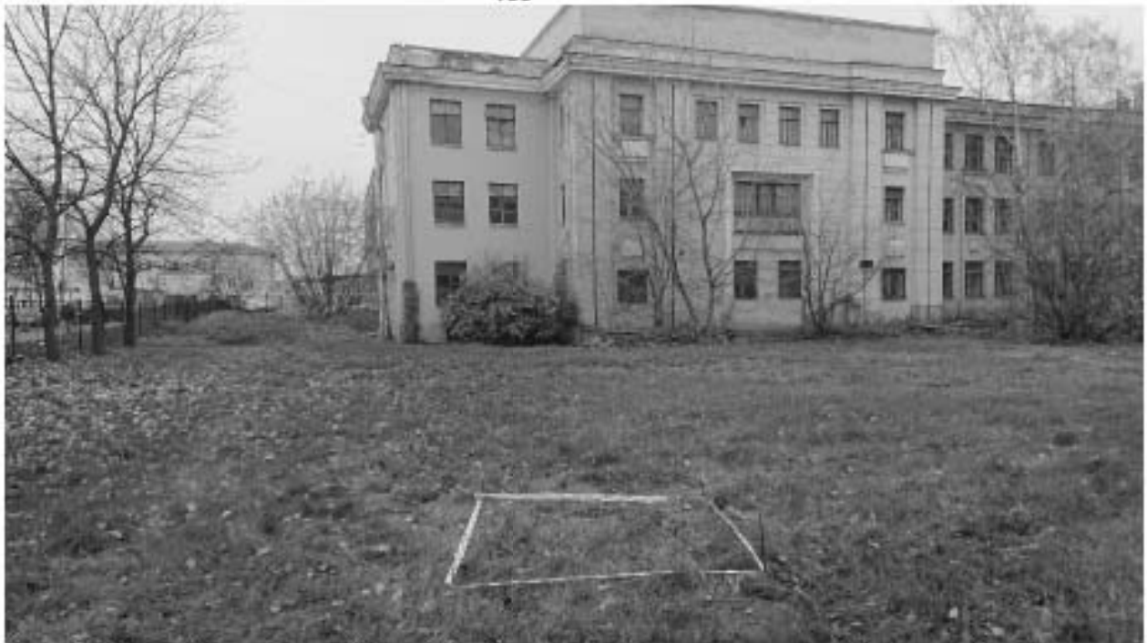
Рис. 37. Санкт-Петербург, Невский район, улица Ольминского, д. 13, литера А, «Колледж метростроя». Шурф 1. Общий вид до начала работ с юга.
