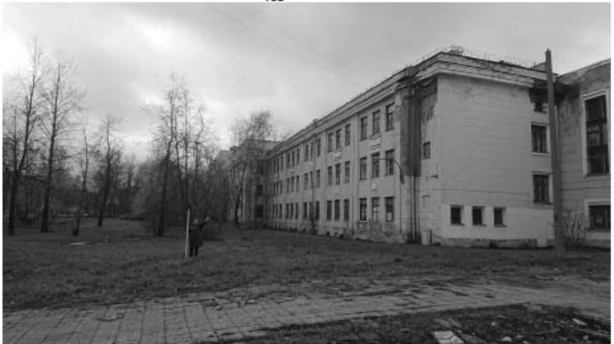
Рис. 33. Санкт-Петербург, Невский район, улица Ольминского, д. 13, литера А, «Колледж метростроя». Вид на здание колледжа и прилегающую территорию с северо-северо-востока (ТС 5).
