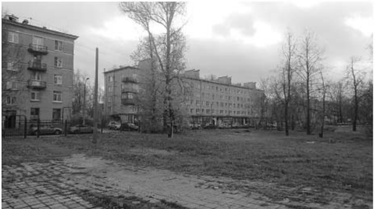
Рис. 34. Санкт-Петербург, Невский район, улица Ольминского, д. 13, литера А, «Колледж метростроя». Вид на прилегающую территорию колледжа с севера (ТС 5).
