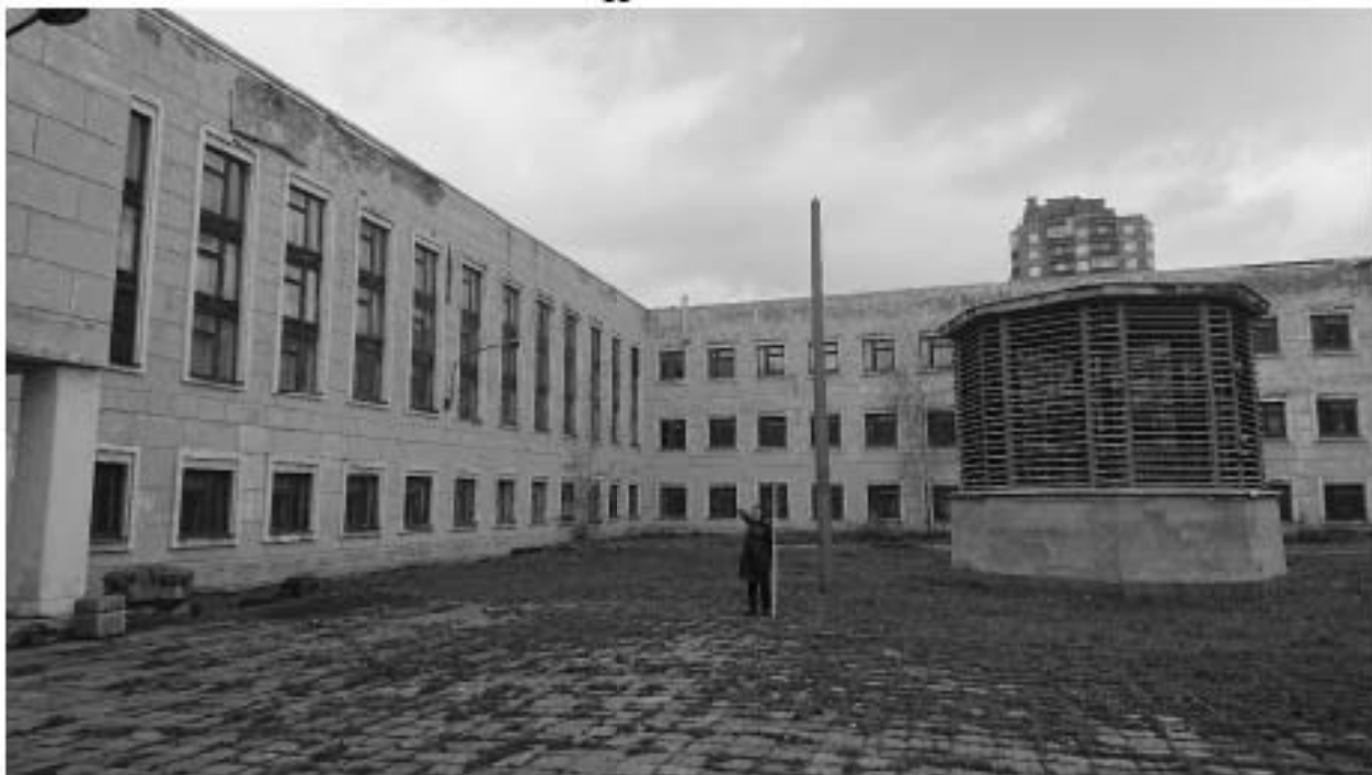
Рис. 31. Санкт-Петербург, Невский район, улица Ольминского, д. 13, литера А, «Колледж метростроя». Вид на здание колледжа и киоск вентиляционной шахты метро с юго-юго-запада (ТС 5).
