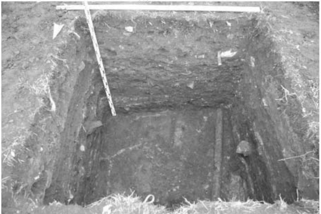
Рис. 58. Санкт-Петербург, Невский район, улица Ольминского, д. 13, литера А, «Колледж метростроя». Шурф 2. Общий вид на шурф по уровню трубы с севера.
