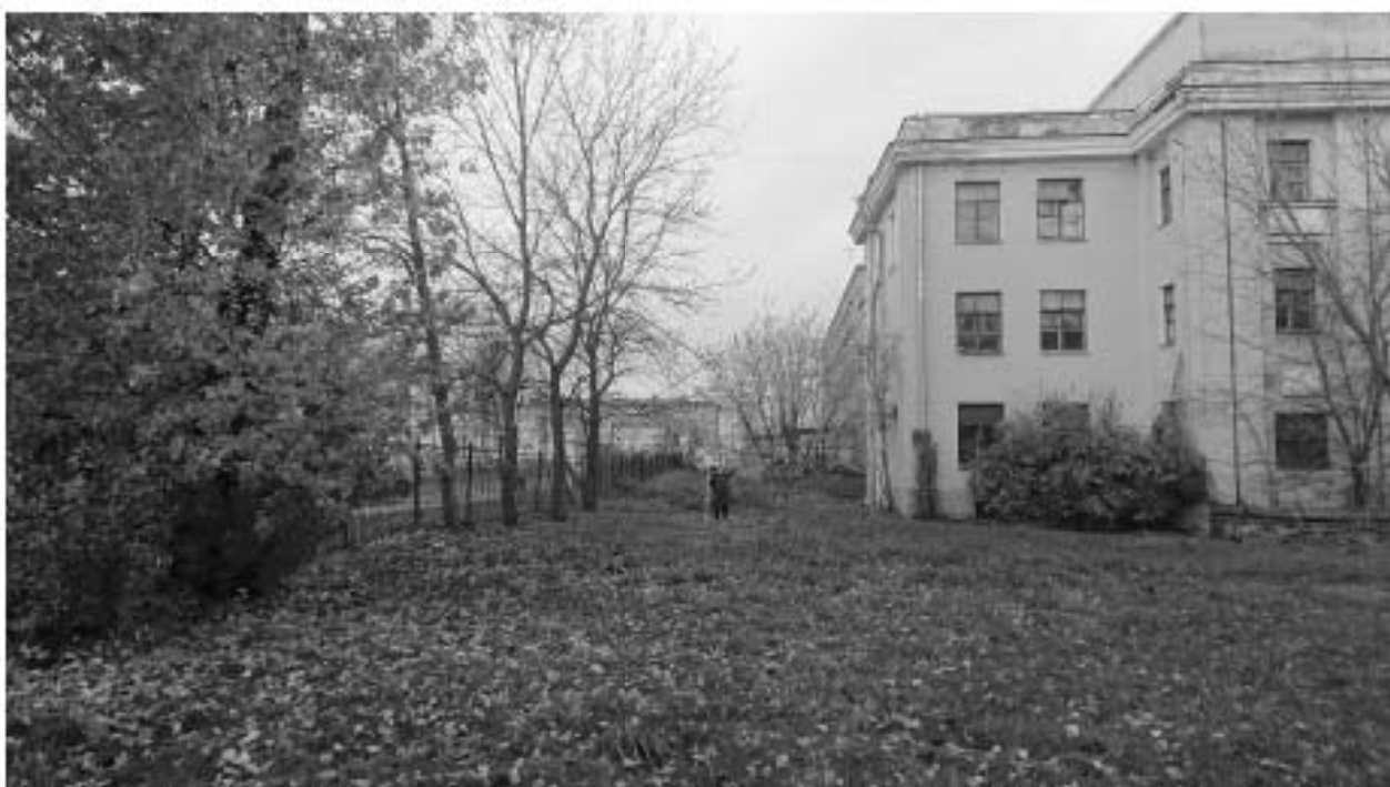
Рис. 26. Санкт-Петербург, Невский район, улица Ольминского, д. 13, литера А, «Колледж метростроя». Вид на прилегающую территорию колледжа с юго-востока (ТС 4).
