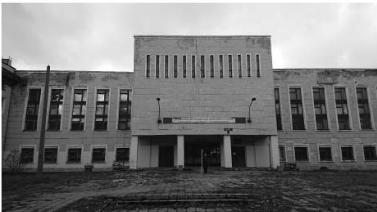
Рис. 32. Санкт-Петербург, Невский район, улица Ольминского, д. 13, литера А, «Колледж метростроя». Вид на здание колледжа с юго-востока (ТС 5).
