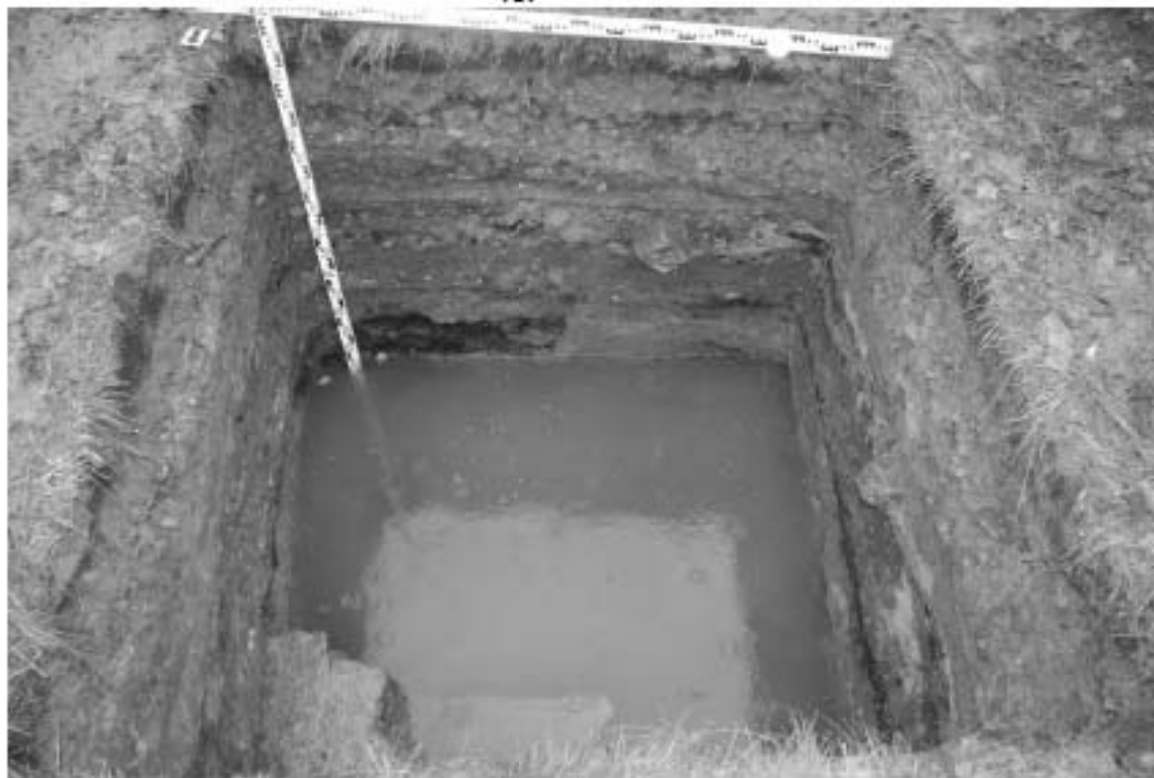
Рис. 45. Санкт-Петербург, Невский район, улица Ольминского, д. 13, литера А, «Колледж метростроя». Шурф 1. Вид на шурф на уровне остановки работ с севера.
