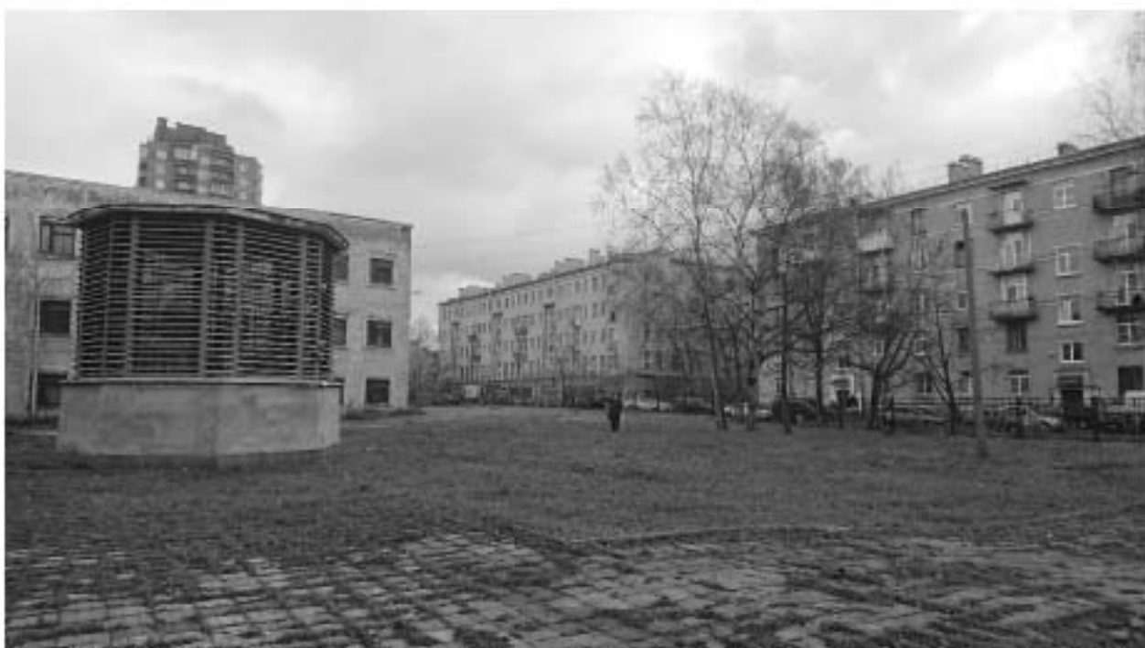
Рис. 30. Санкт-Петербург, Невский район, улица Ольминского, д. 13, литера А, «Колледж метростроя». Вид на прилегающую территорию колледжа и киоск вентиляционной шахты метро с северо-запада (ТС 5).
