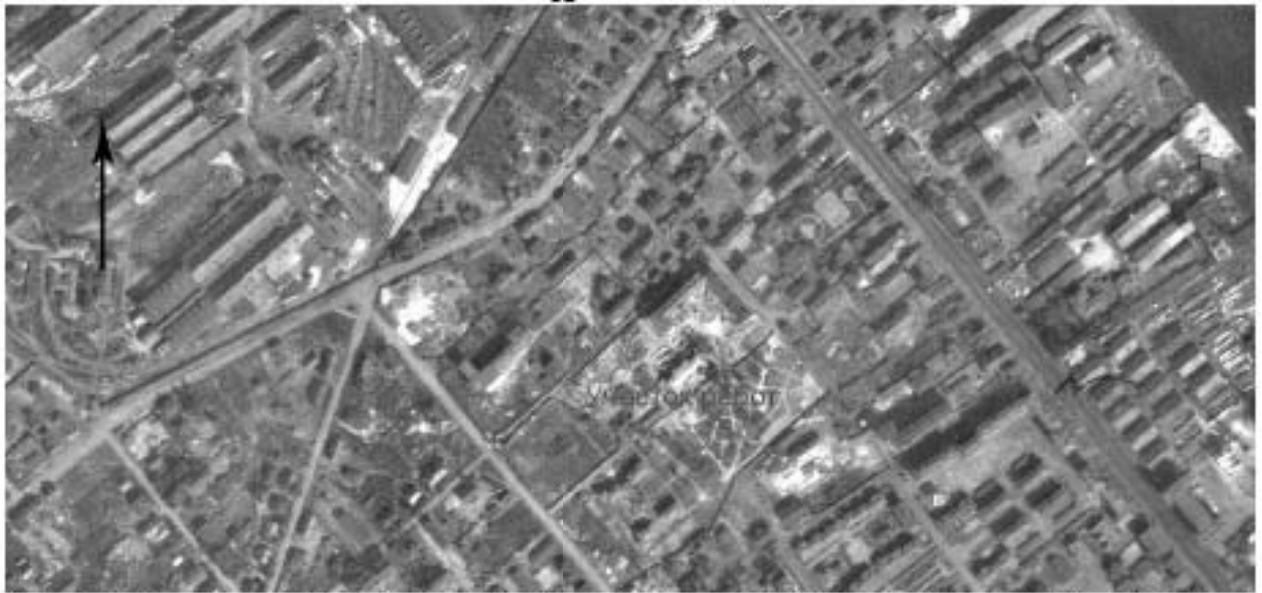
Рис. 15. Санкт-Петербург, Невский район, улица Ольминского, д. 13, литера А, «Колледж метростроя». Участок работ на немецкой аэрофотосъемке Ленинграда времен ВОВ.
