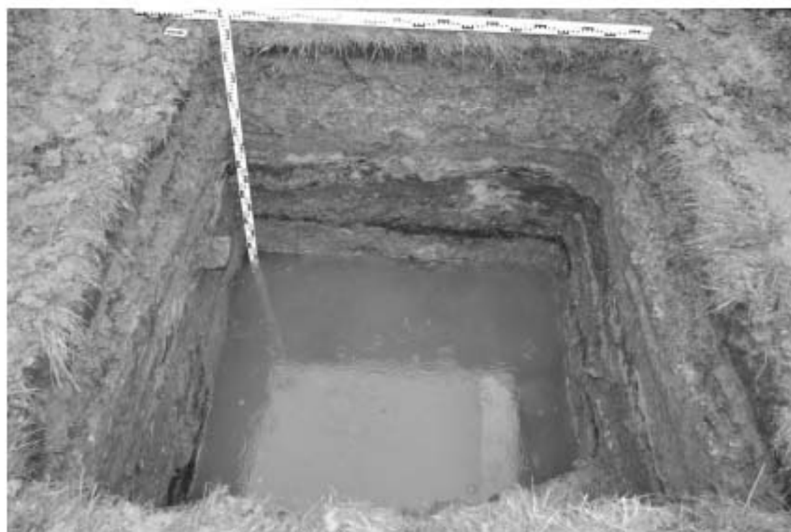
Рис. 46. Санкт-Петербург, Невский район, улица Ольминского, д. 13, литера А, «Колледж метростроя». Шурф 1. Вид на шурф на уровне остановки работ с востока.
