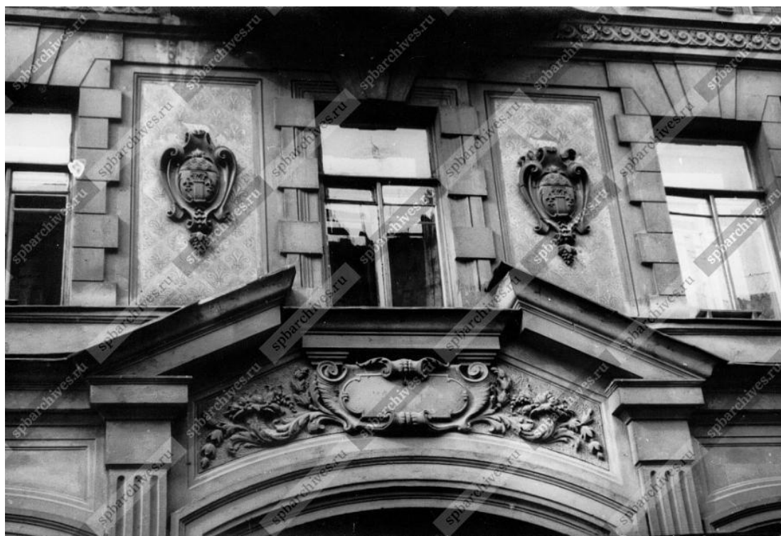
Илл. 37. Вид декоративного рельефа в разорванном фронтоне над арочным въездом главного фасада жилого дома № 20 на 3-й линии В.О. 1979 г. – ЦГАКФФД СПб Ар 217232
