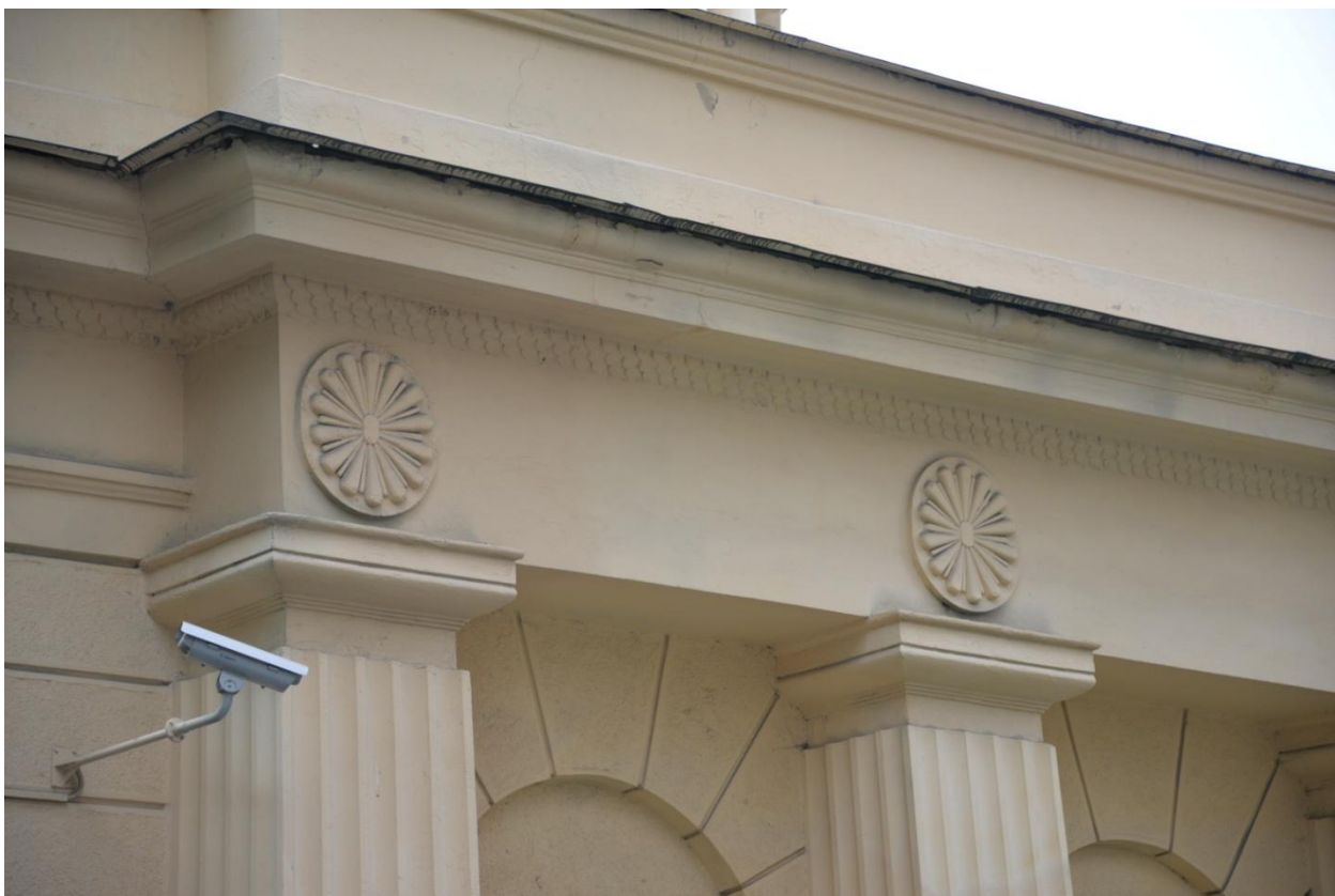
13.Фрагмент северного фасада
