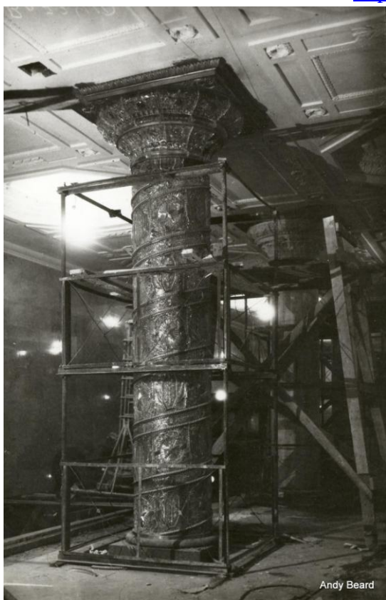
10. Отделочные работы в вестибюле станции метро Автово. 1955 г. — «PastVu» – ретро-фотографии стран и городов [Электронный ресурс]. URL:
