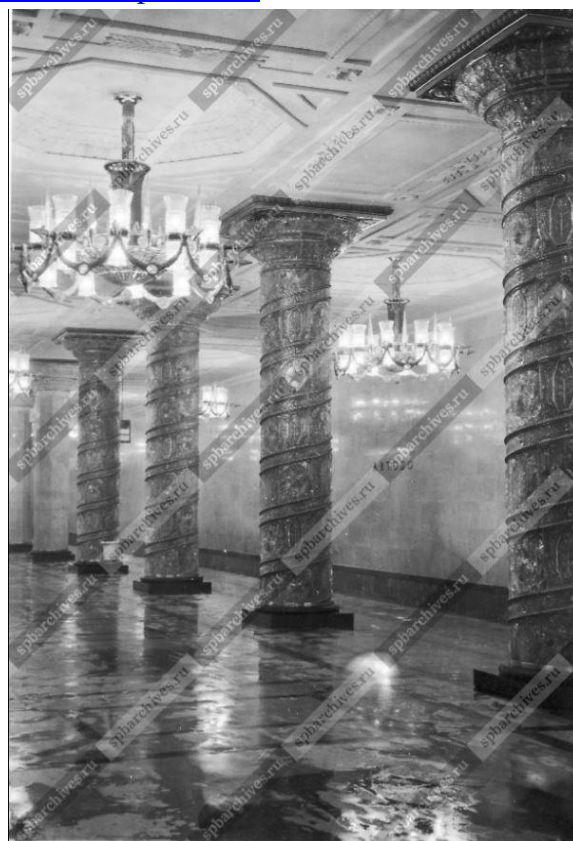
11. Вид на колонны в подземном зале станции метро "Автово", декорированные пластинами из литого стекла с обратным рельефом. Автор член-корреспондент АН СССР Н.Н. Качалов; архитекторы Е.А. Левинсон, А.А. Грушке, инж. С.М. Эпштейн,
