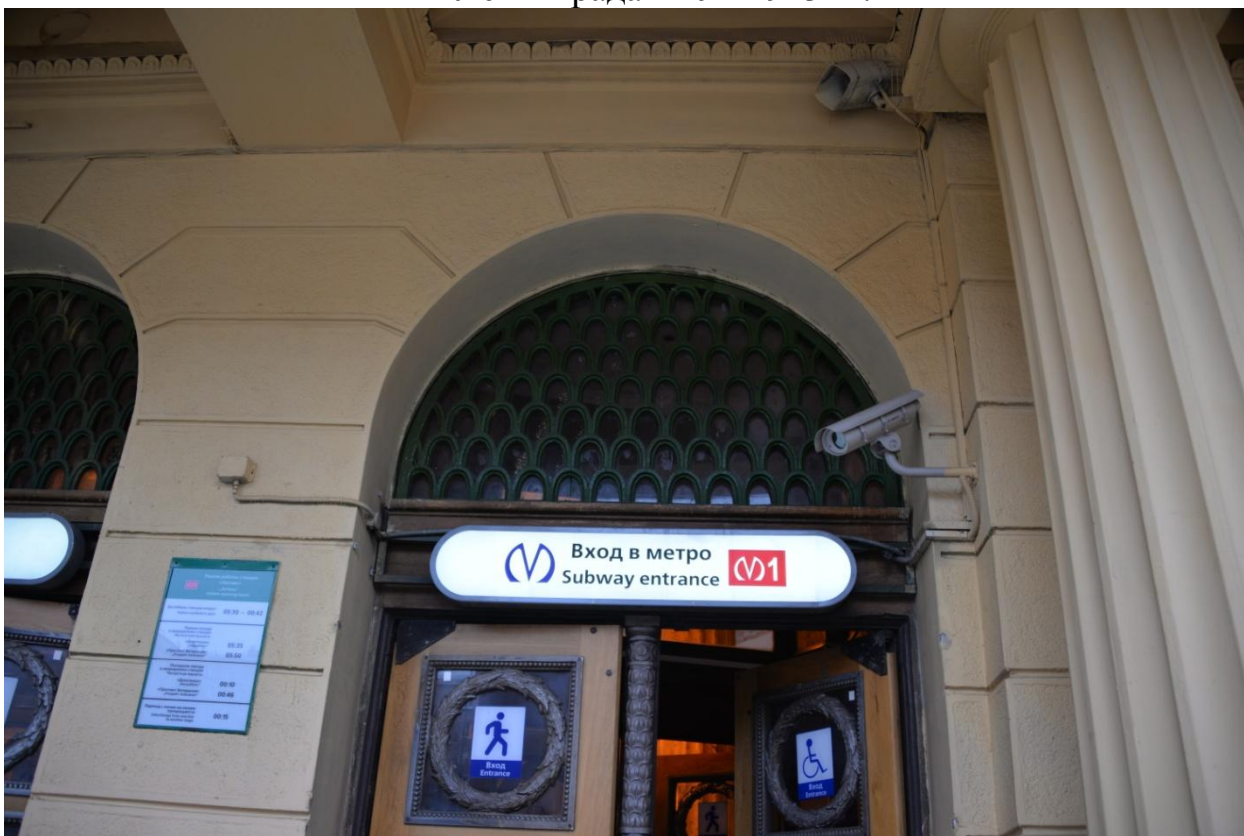
6. Фрагмент фасада со стороны проспекта Стачек. Фрагмент входной двери
