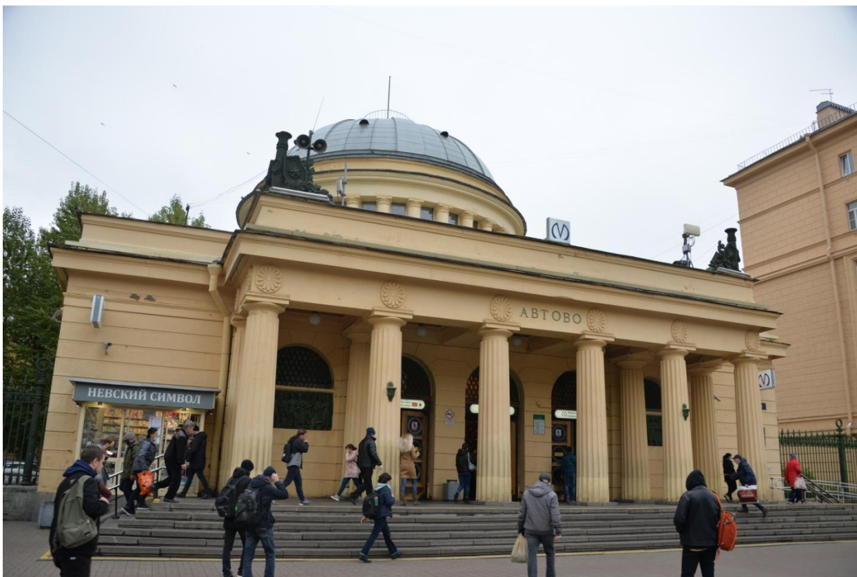
1. Фасад со стороны проспекта Стачек
