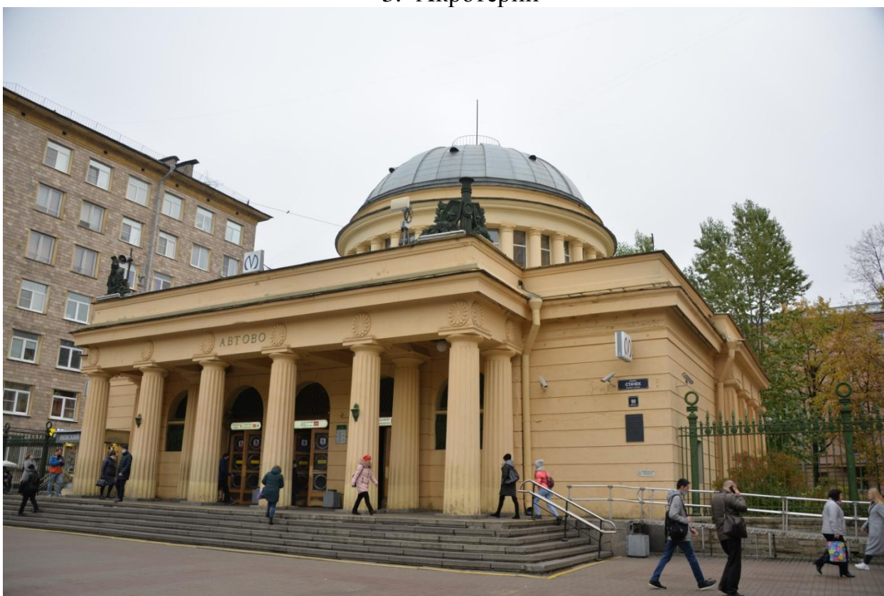
4. Фасад со стороны проспекта Стачек
