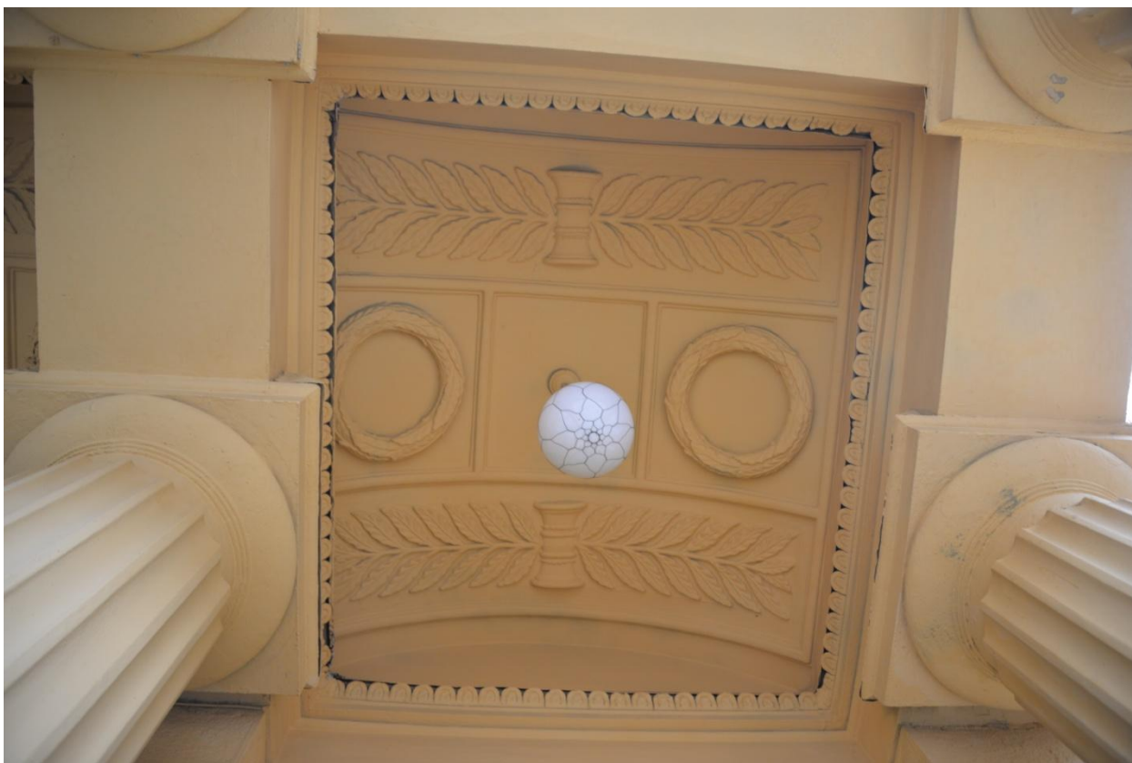
7. Фрагмент потолка портика фасада со стороны проспекта Стачек
