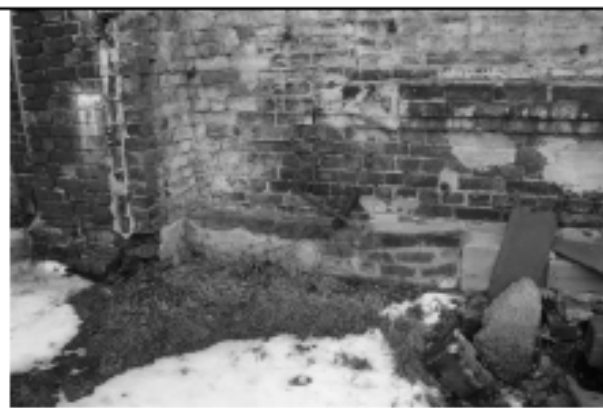
Фотофиксация цоколя со стороны машинного зала
