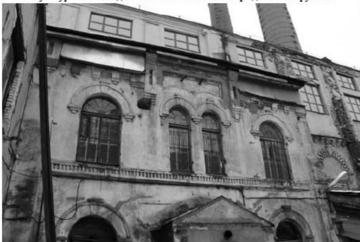
Фото 24. Вид на северо-западный фасад пристройки к выявленному объекту культурного наследия «Машинный зал и четыре дымовые трубы».
