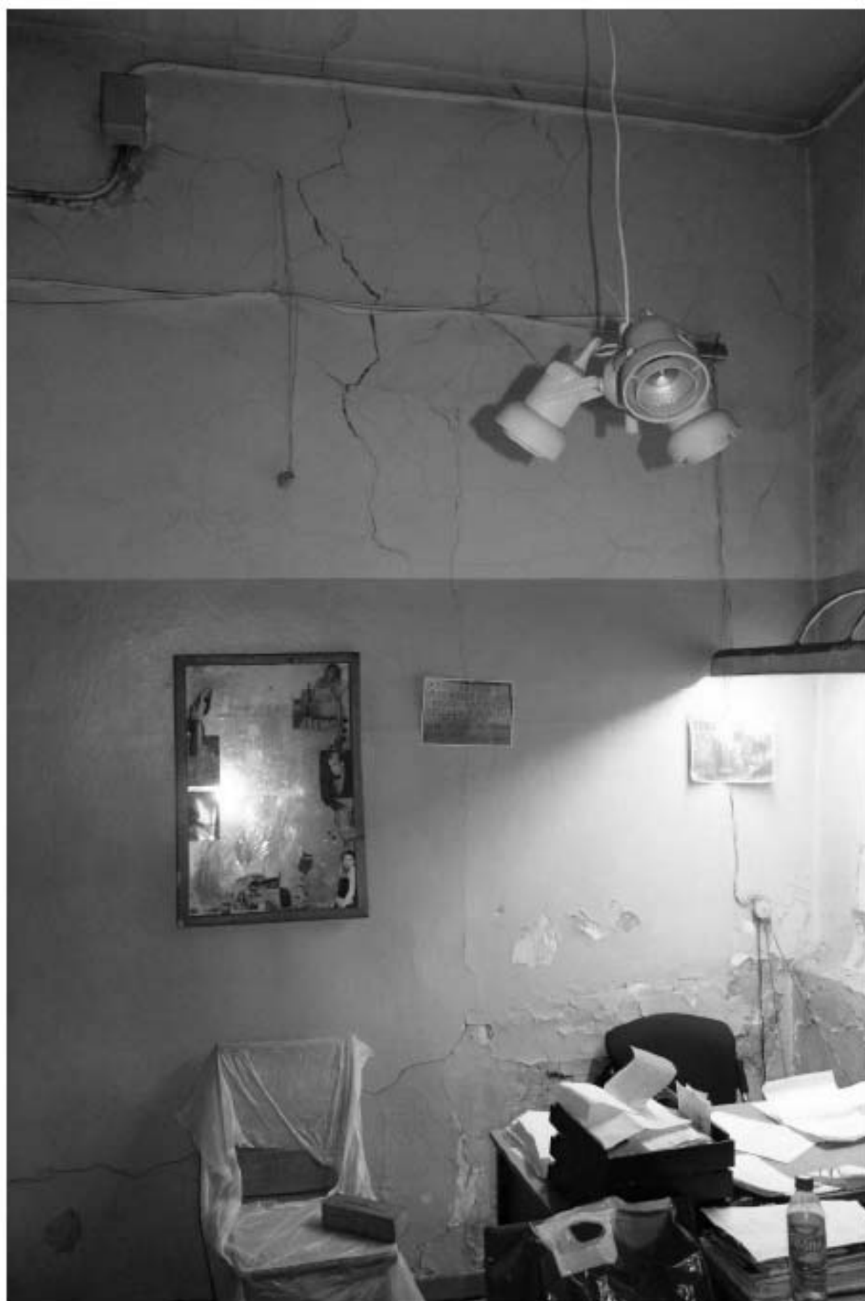
Фото 72. Внутренние помещения исторической пристройки (мастерской).
