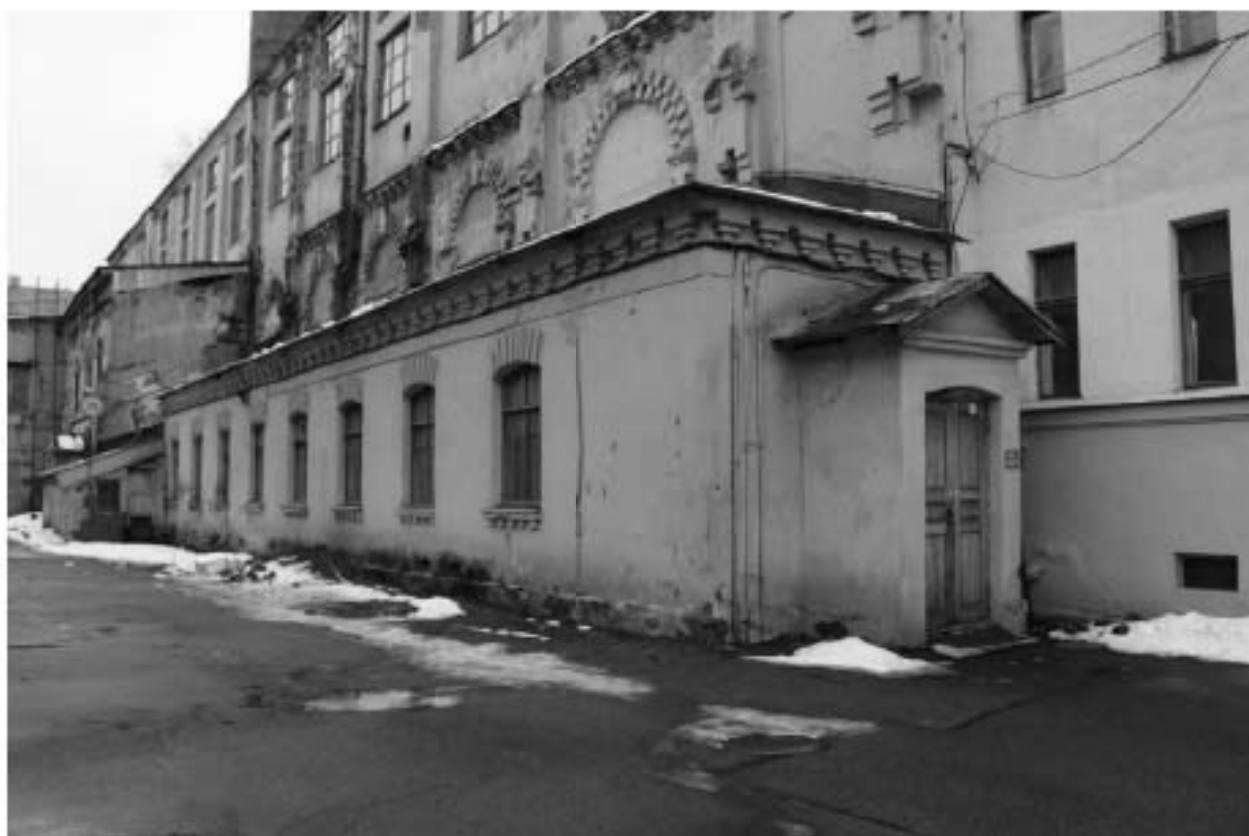
Фото 27. Вид на северо-западный фасад пристройки к выявленному объекту культурного наследия «Машинный зал и четыре дымовые трубы».
