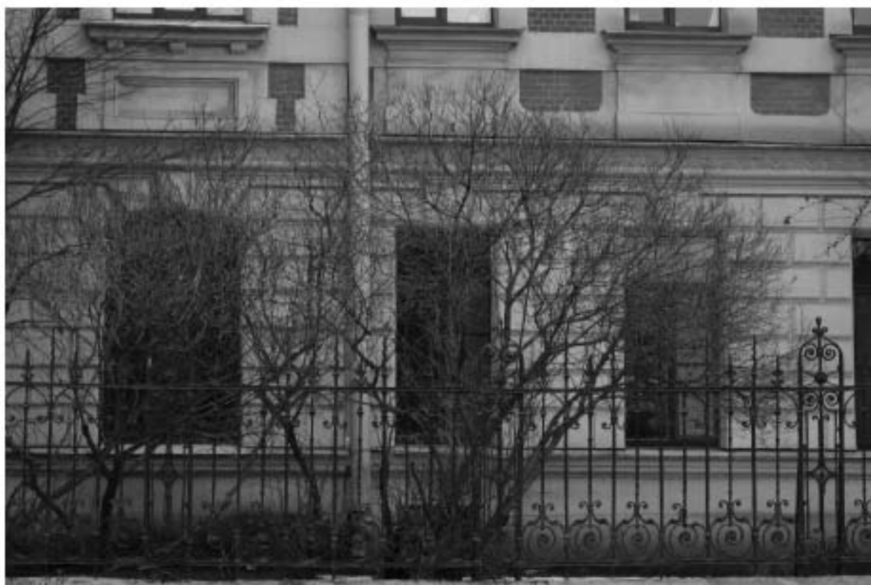
Фото 118. Вид на северо-западный фасад выявленного объекта культурного наследия «Административное здание».
