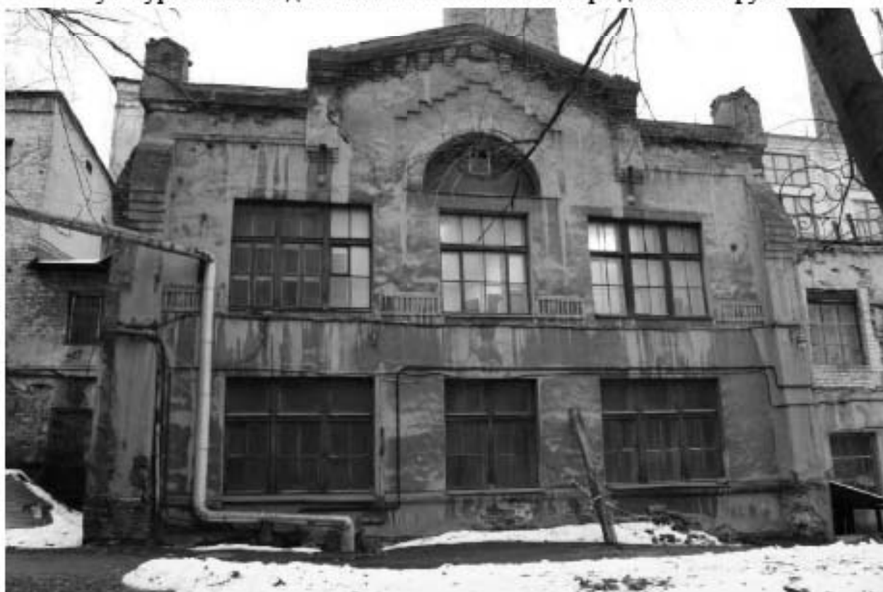
Фото 20. Вид на северо-западный фасад пристройки к выявленному объекту культурного наследия «Машинный зал и четыре дымовые трубы».
