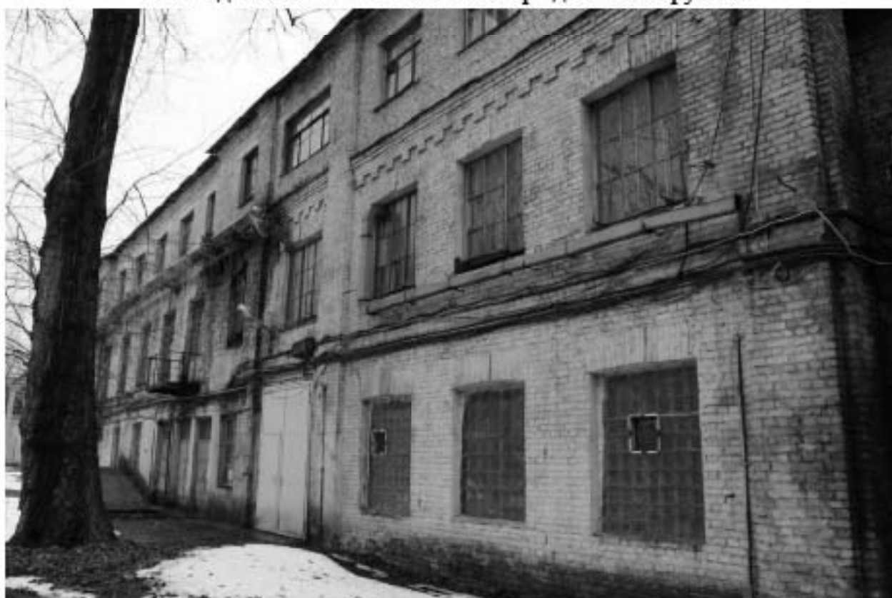
Фото 15. Вид на северо-восточный фасад выявленного объекта культурного наследия «Машинный зал и четыре дымовые трубы».
