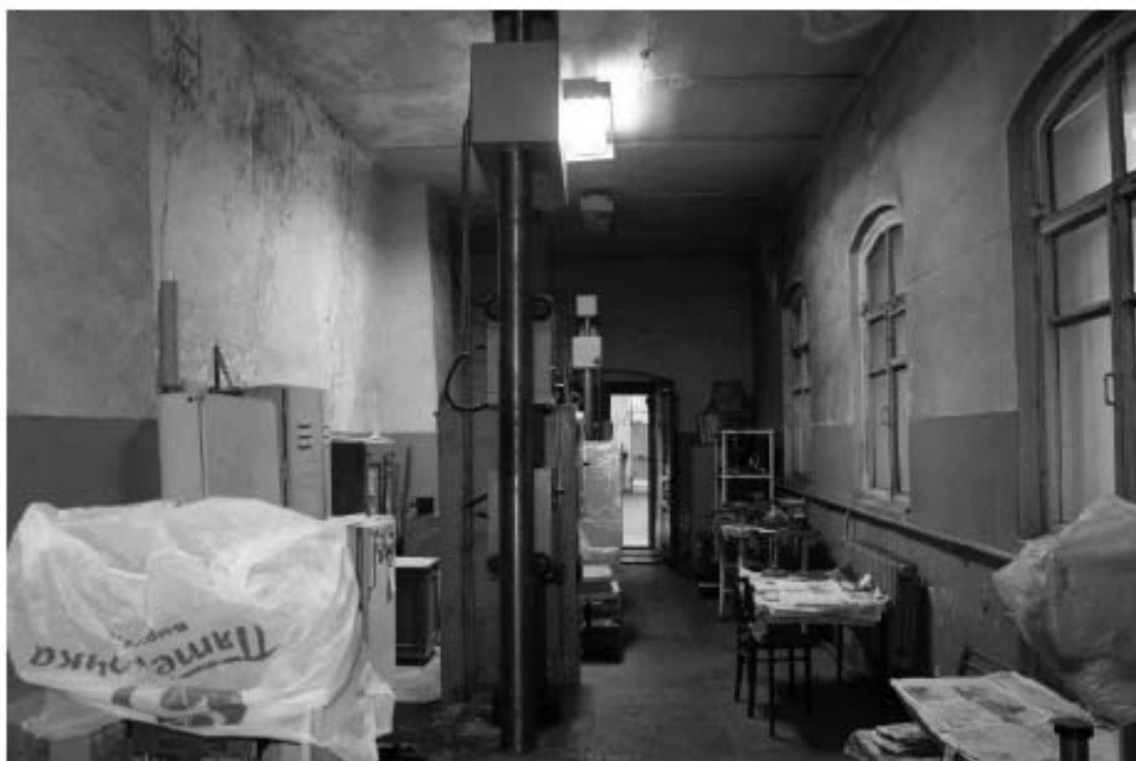
Фото 71. Внутренние помещения исторической пристройки (мастерской).
