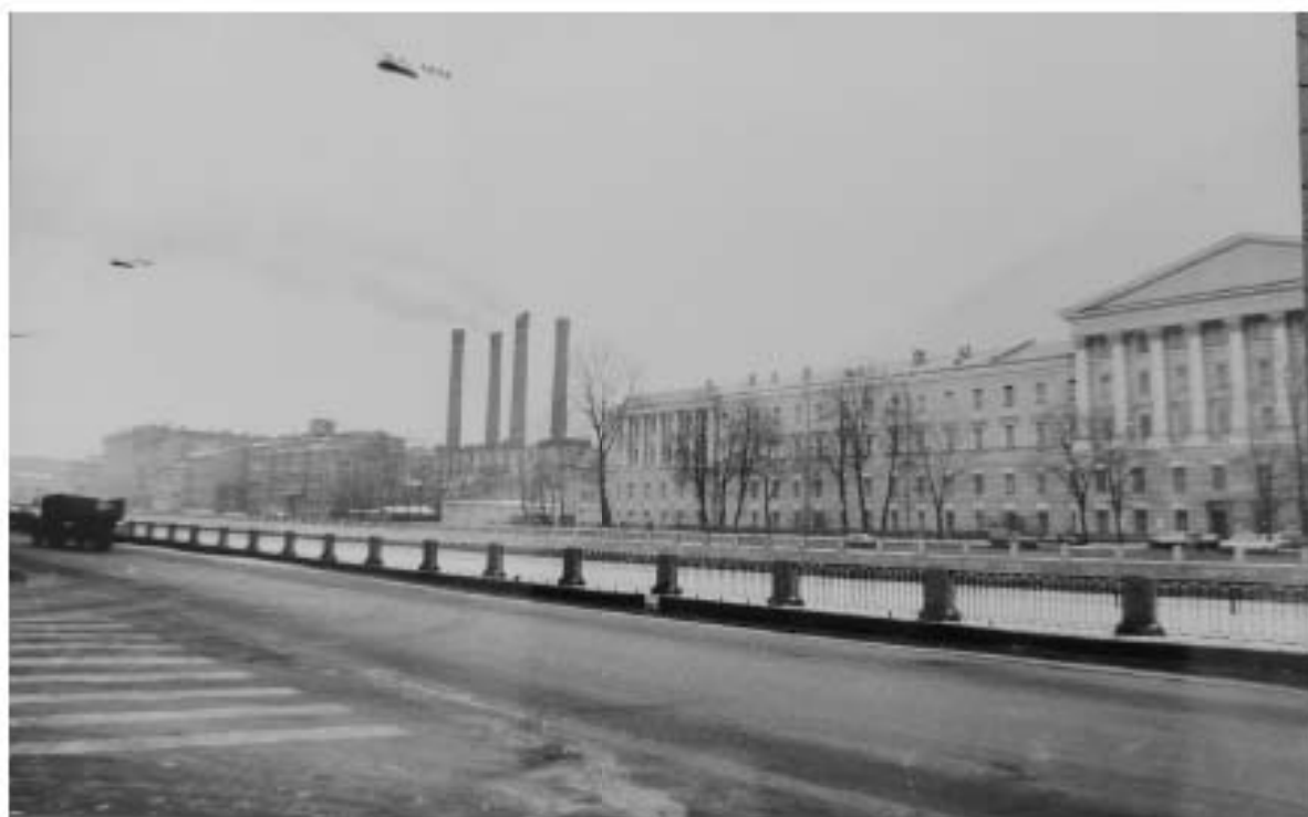
Илл. 136. Архив КГИОП. Фототека. Электростанция № 3 ТЭЦ № 2 Ленэнерго. Вид со стороны сквера у Московского проспекта [1990-е гг.] (источник: архив КГИОП. Фототека. П. 1705).
