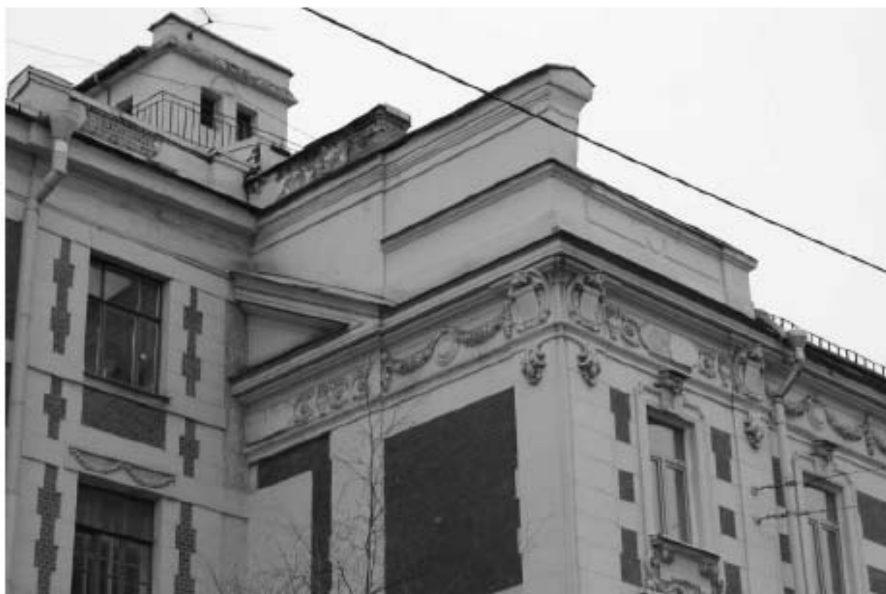
Фото 81. Вид на северо-восточный фасад выявленного объекта культурного наследия «Жилой дом».
