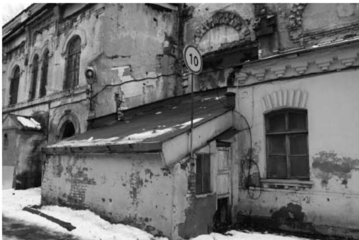
Фото 25. Вид на позднюю пристройку к выявленному объекту культурного наследия «Машинный зал и четыре дымовые трубы».
