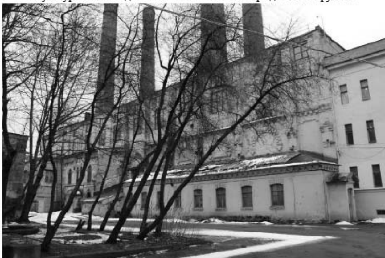
Фото 28. Вид на северо-западный фасад выявленного объекта культурного наследия «Машинный зал и четыре дымовые трубы».
