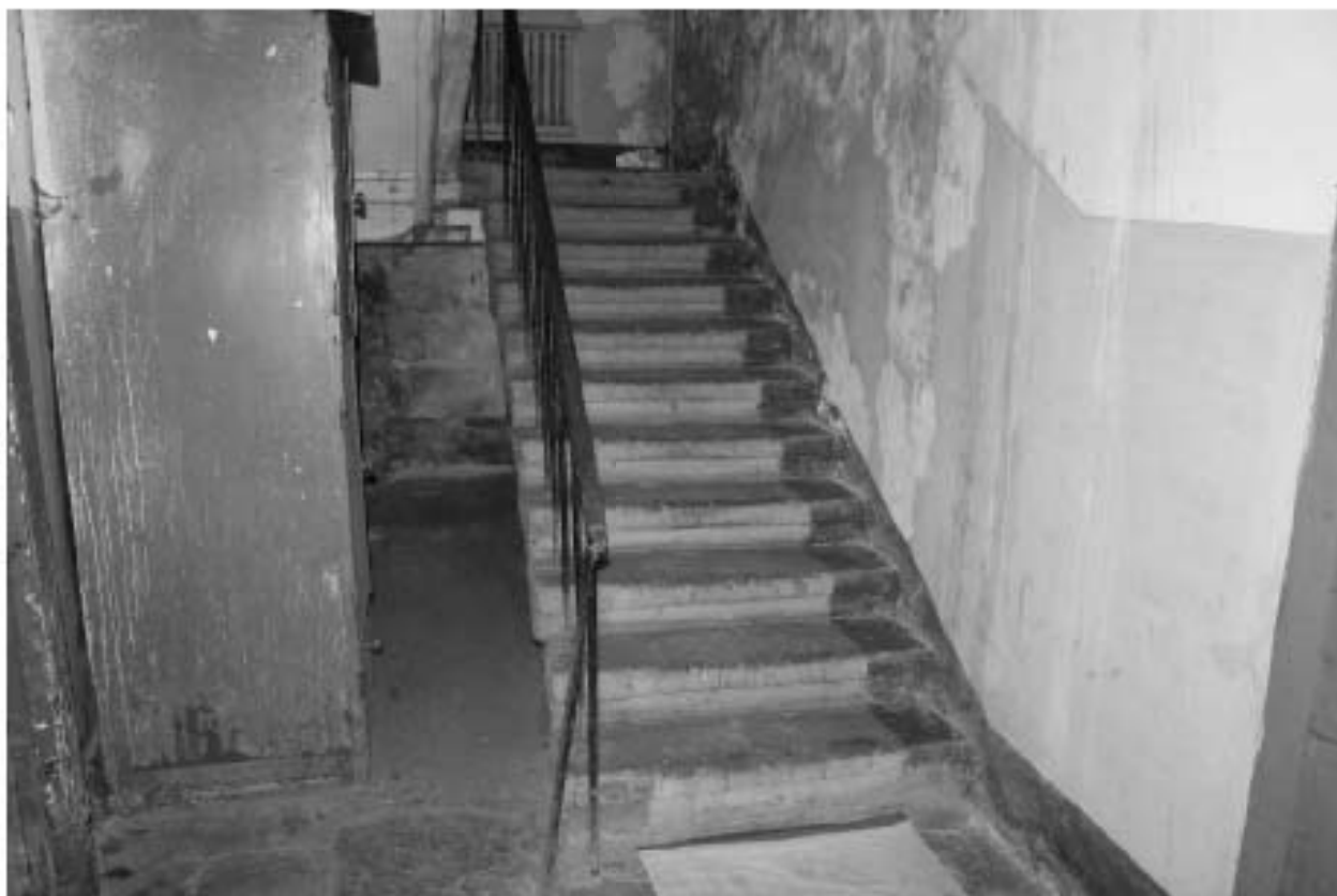
Фото 65. Лестничная клетка поздней трехэтажной части в уровне 1-го этажа.
