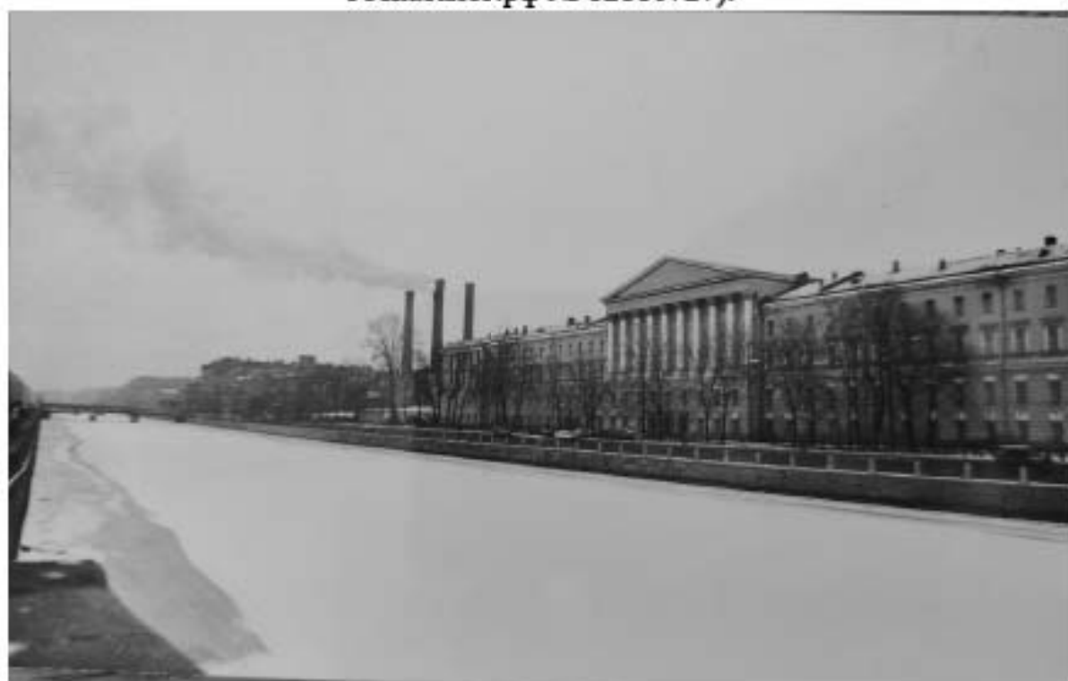
Илл. 135. Архив КГИОП. Фототека. Электростанция № 3 ТЭЦ № 2 Ленэнерго. Вид со стороны Московского проспекта (с угла моста) [1990-е гг.] (источник: архив КГИОП. Фототека. П. 1705).
