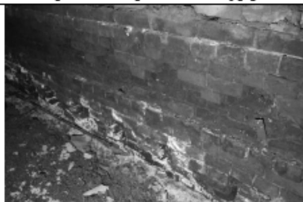
Фотофиксация цоколя исторического объема машинного зала из подвала поздней пристройки
