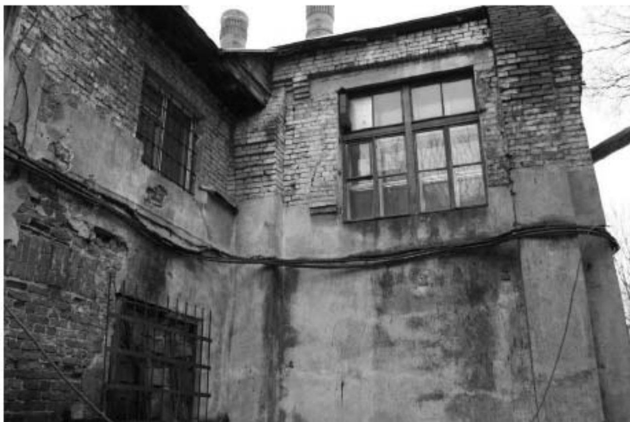
Фото 19. Вид на северо-восточный фасад пристройки к выявленному объекту культурного наследия «Машинный зал и четыре дымовые трубы».
