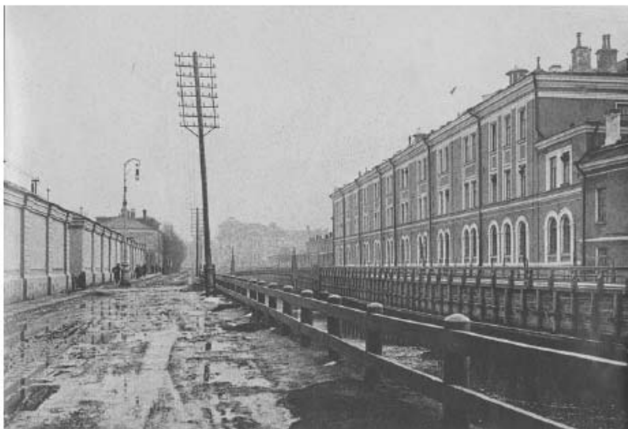
Илл. 101. Вид на Введенский канал со стороны набережной реки Фонтанки. 1927 г. (источник: госкаталог.рф № 25840939).
