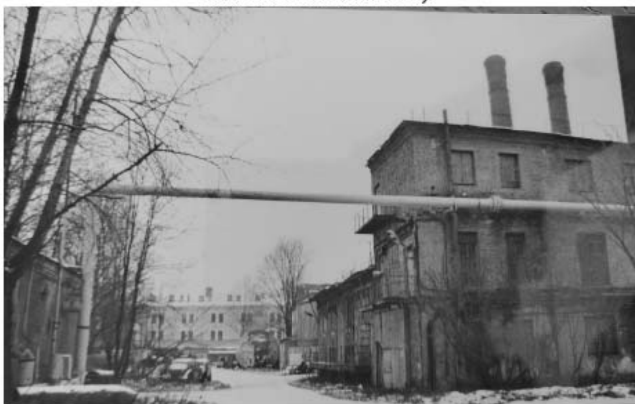
Илл. 143. Архив КГИОП. Фототека. Электростанция № 3 ТЭЦ № 2 Ленэнерго. Вид в сторону Введенского проезда. 6/д [1990-е гг.] (источник: архив КГИОП. Фототека. П. 1705).
