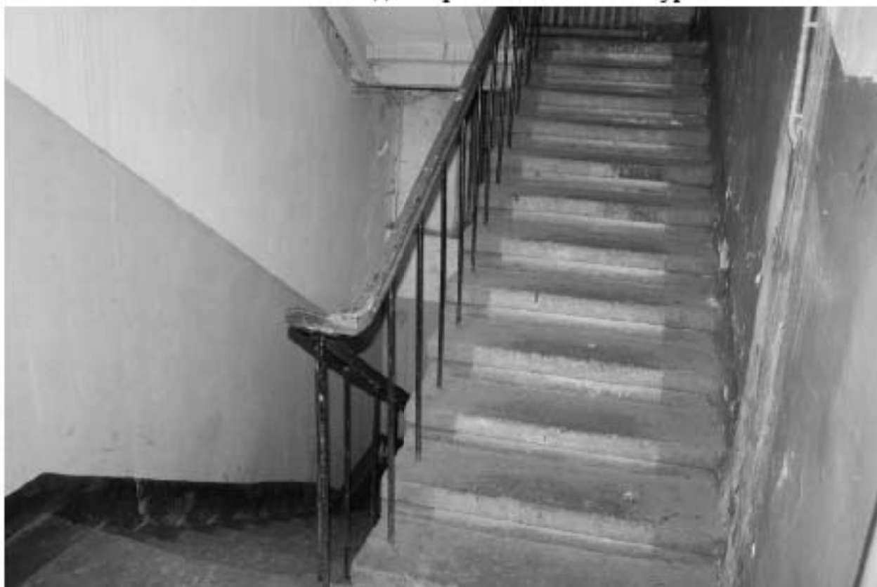
Фото 66. Лестничная клетка поздней трехэтажной части в уровне 2-го этажа.
