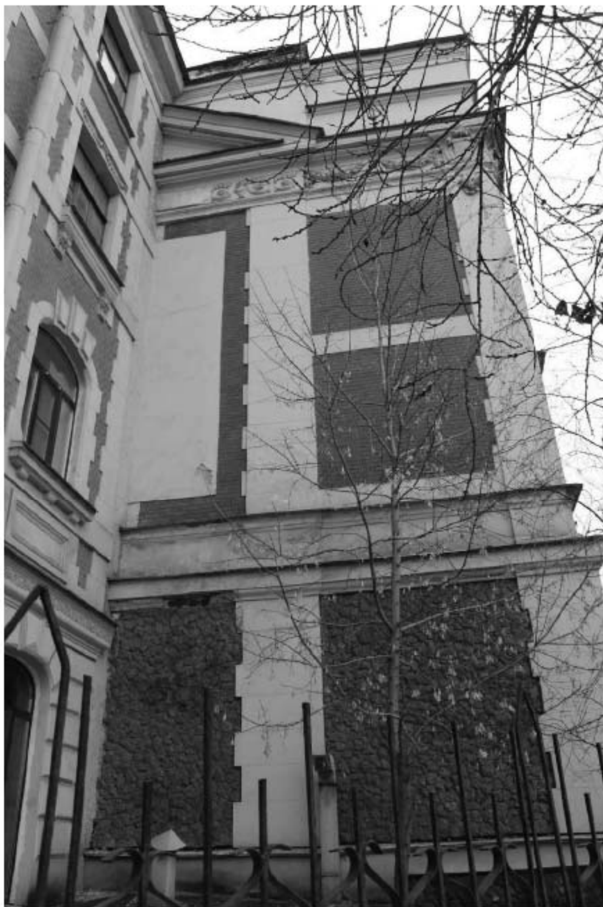
Фото 82. Вид на северо-восточный фасад выявленного объекта культурного наследия «Жилой дом».
