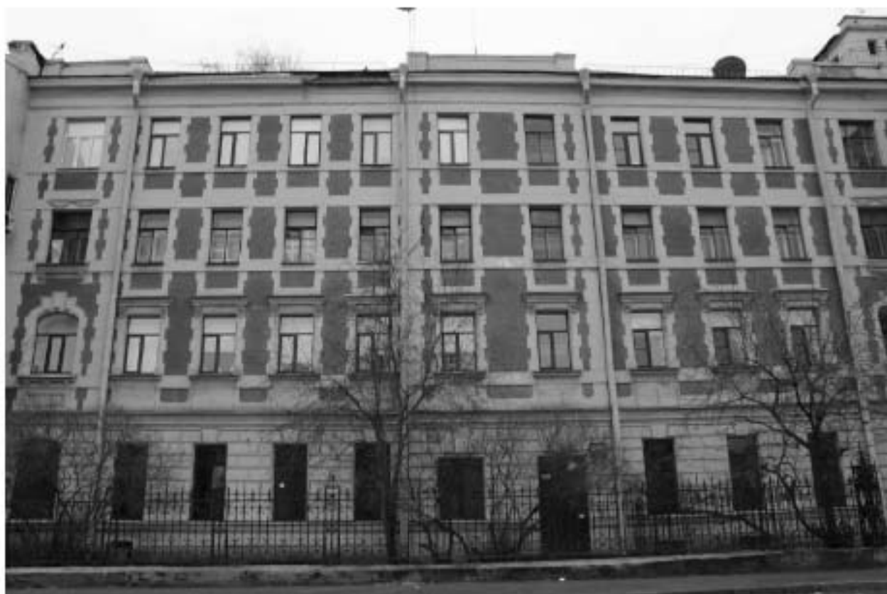
Фото 116. Вид на северо-западный фасад выявленного объекта культурного наследия «Административное здание».
