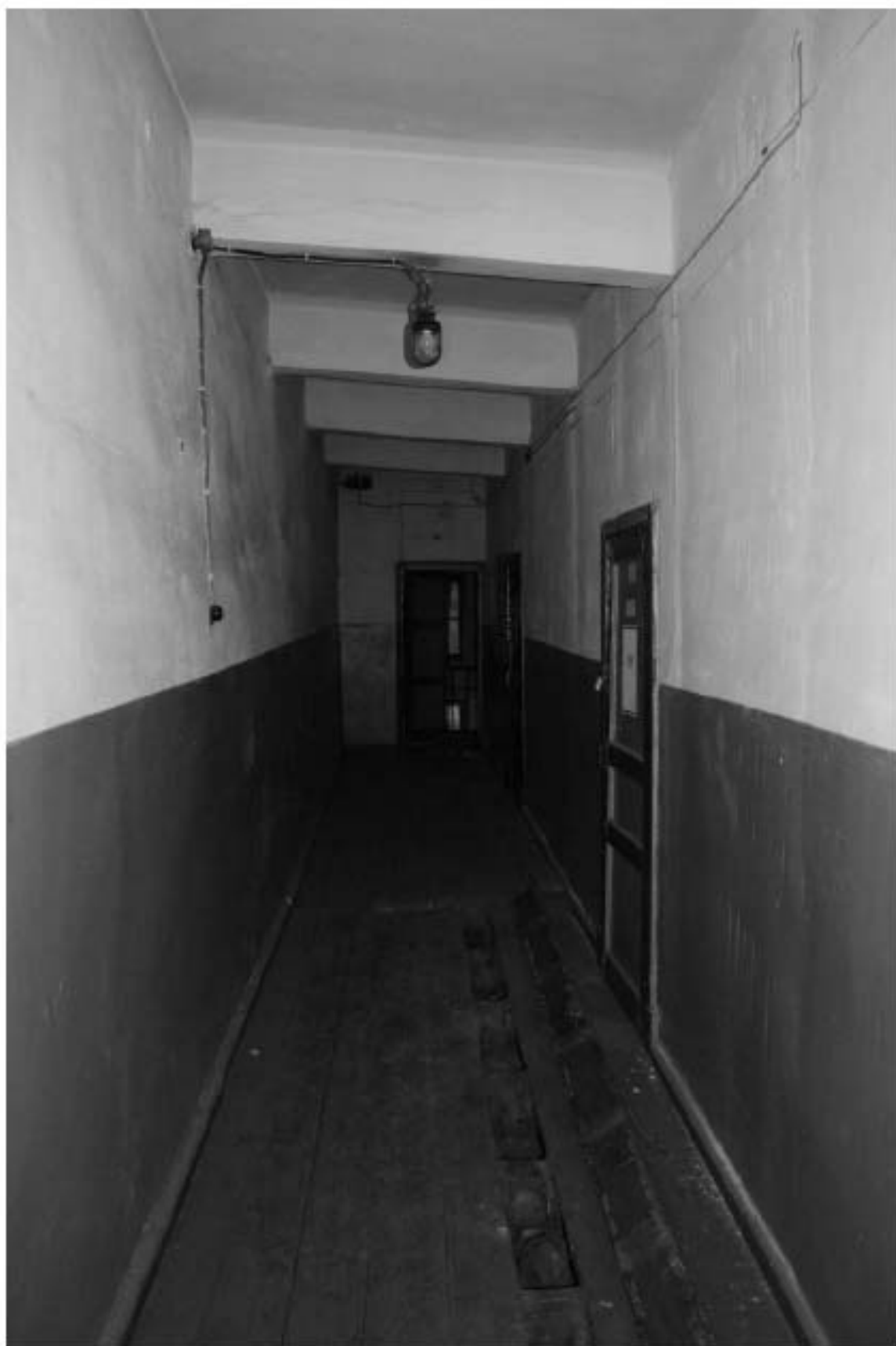
Фото 69. Внутренние помещения 3-го этажа поздней трехэтажной части.
