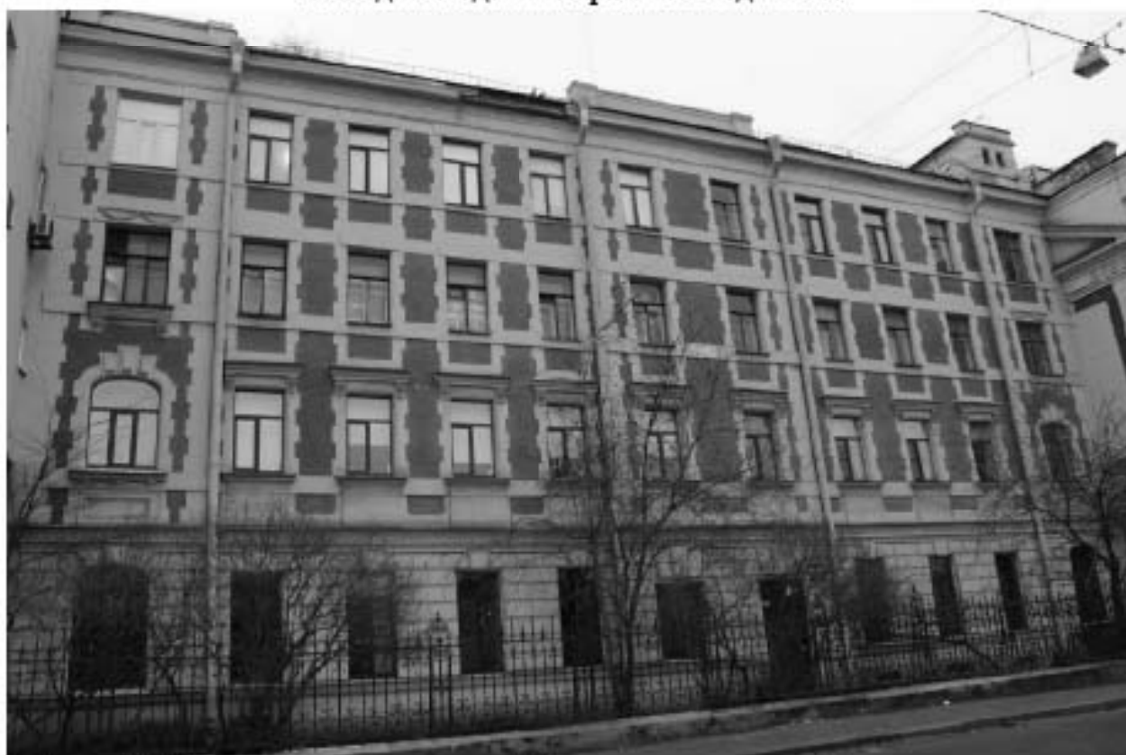
Фото 117. Вид на северо-западный фасад выявленного объекта культурного наследия «Административное здание».
