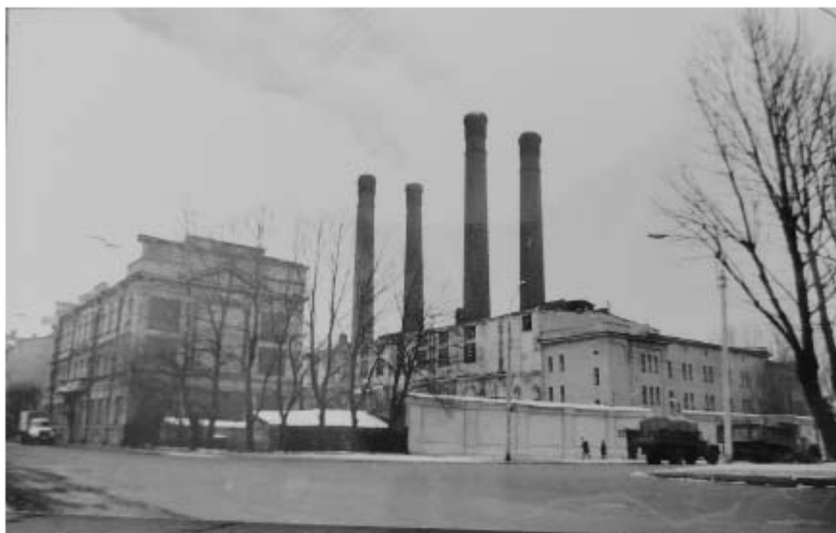
Илл. 138. Архив КГИОП. Фототека. Электростанция № 3 ТЭЦ № 2 Ленэнерго. Вид с угла набережной реки Фонтанки и Введенского канала б/д [1990-е гг.] (источник: архив КГИОП. Фототека. П. 1705).
