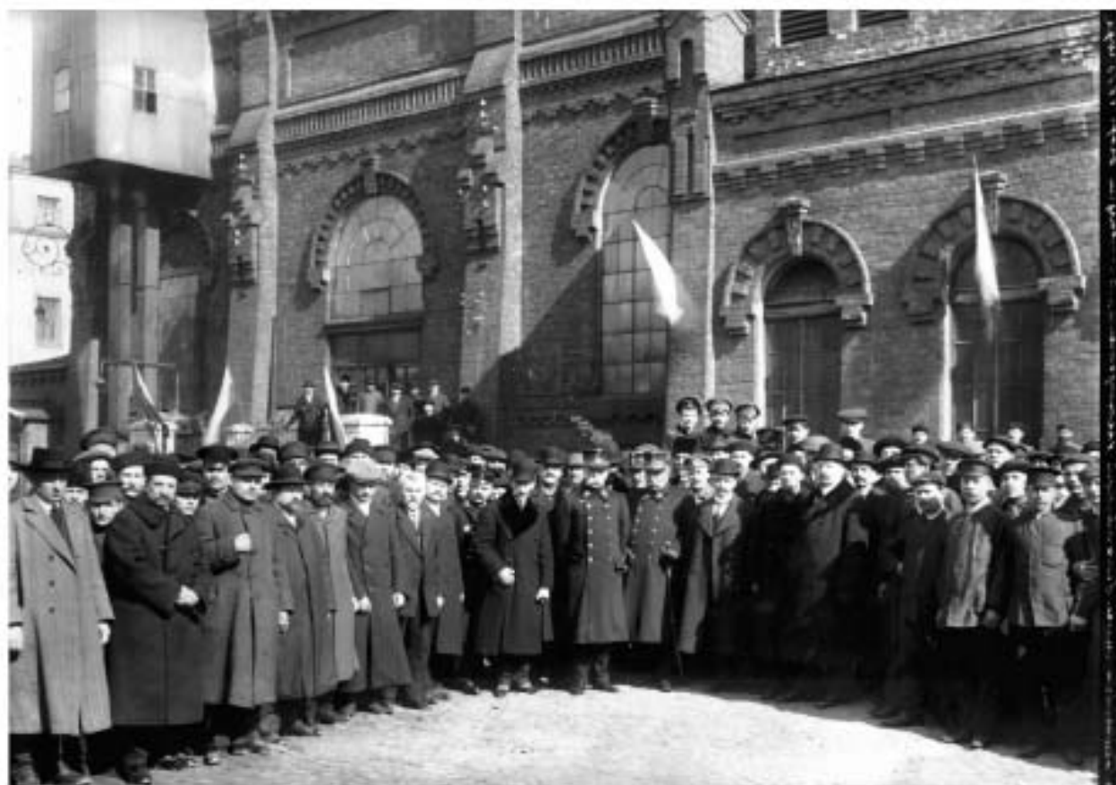
Илл. 99. Сотрудники бельгийской миссии в группе служащих у здания электростанции. 06.04.1915 г. (источник: https://www.tgc1.ru/central120/istoricheskie-foto/ ).
