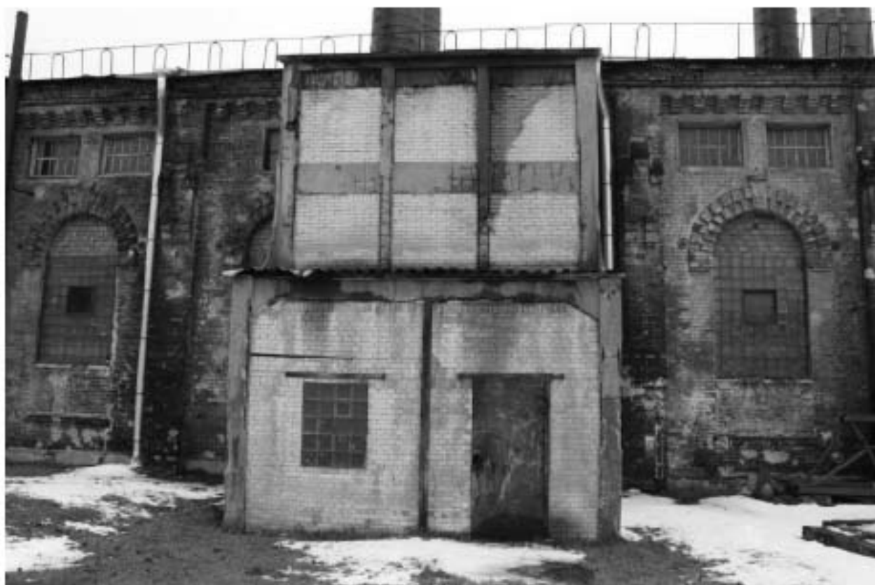
Фото 8. Вид на юго-восточный фасад выявленного объекта культурного наследия «Машинный зал и четыре дымовые трубы».
