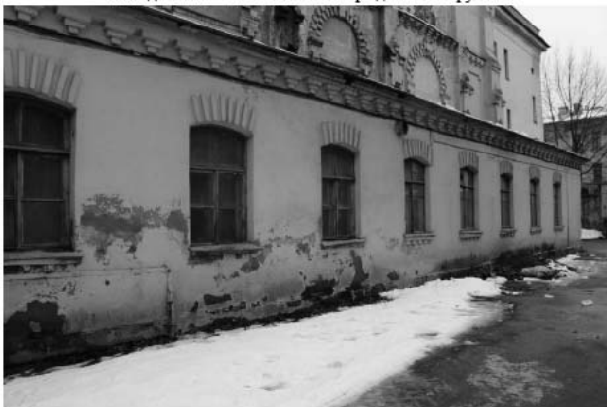
Фото 26. Вид на северо-западный фасад пристройки к выявленному объекту культурного наследия «Машинный зал и четыре дымовые трубы».
