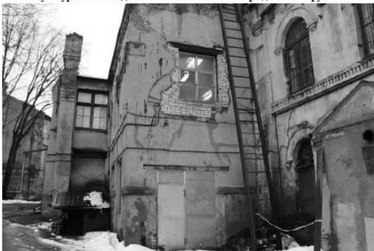
Фото 22. Вид на юго-западный фасад пристройки к выявленному объекту культурного наследия «Машинный зал и четыре дымовые трубы».
