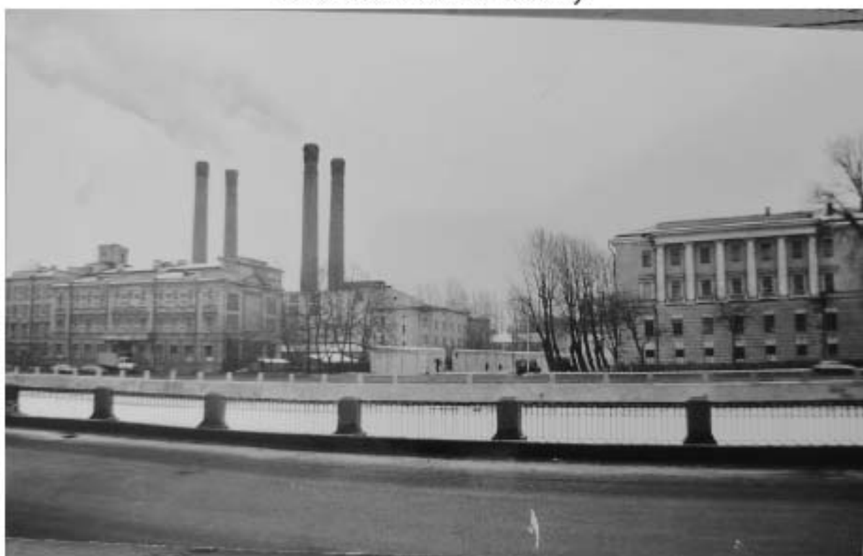
Илл. 137. Архив КГИОП. Фототека. Электростанция № 3 ТЭЦ № 2 Ленэнерго. Вид со стороны Фонтанки (с правого берега) в сторону Введенского канала [1990-е гг.] (источник: архив КГИОП. Фототека. П. 1705).
