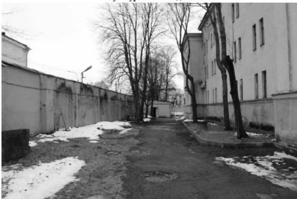
Фото 4. Вид на позднюю ограду по Введенскому каналу со стороны двора и юго-западный фасад выявленного объекта культурного наследия «Машинный зал и четыре дымовые трубы».
