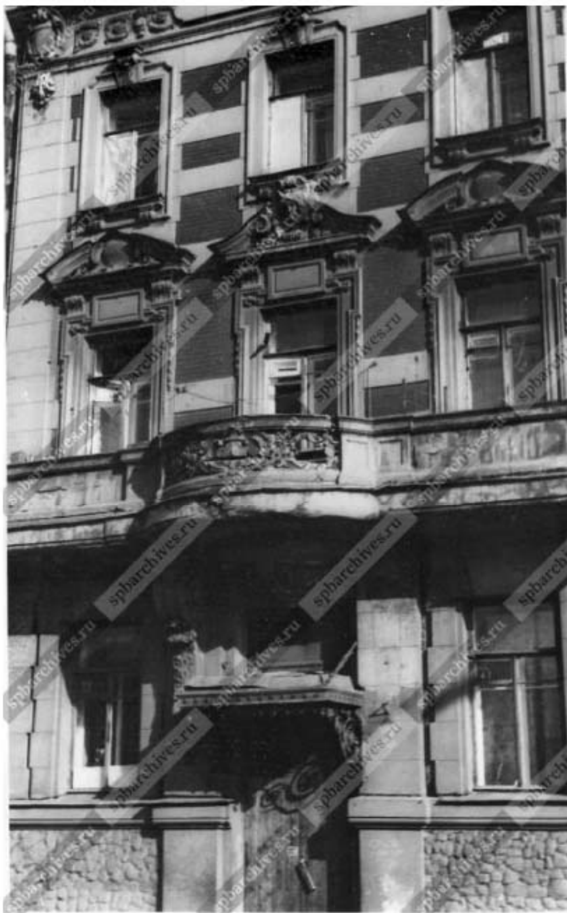
Илл. 133. Вид центральной части фасада дома № 104 по набережной Фонтанки, выделенного каменным балконом. 16.07.1992 г. (источник: ЦГАКФФД СПб. Фотодокументы. Опись 1АР-157. Ед.хр.225943).
