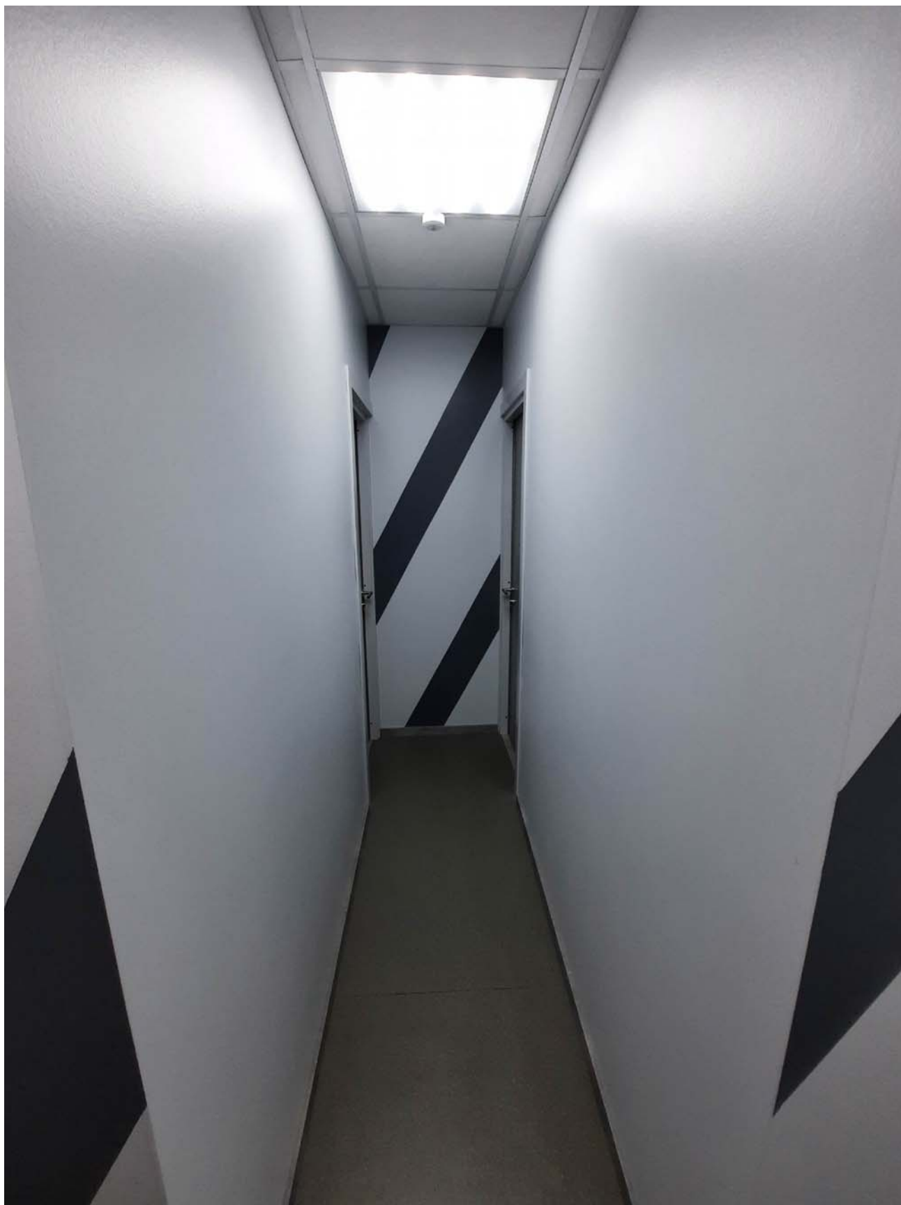
Фото 8. Фрагмент общего коридора.
