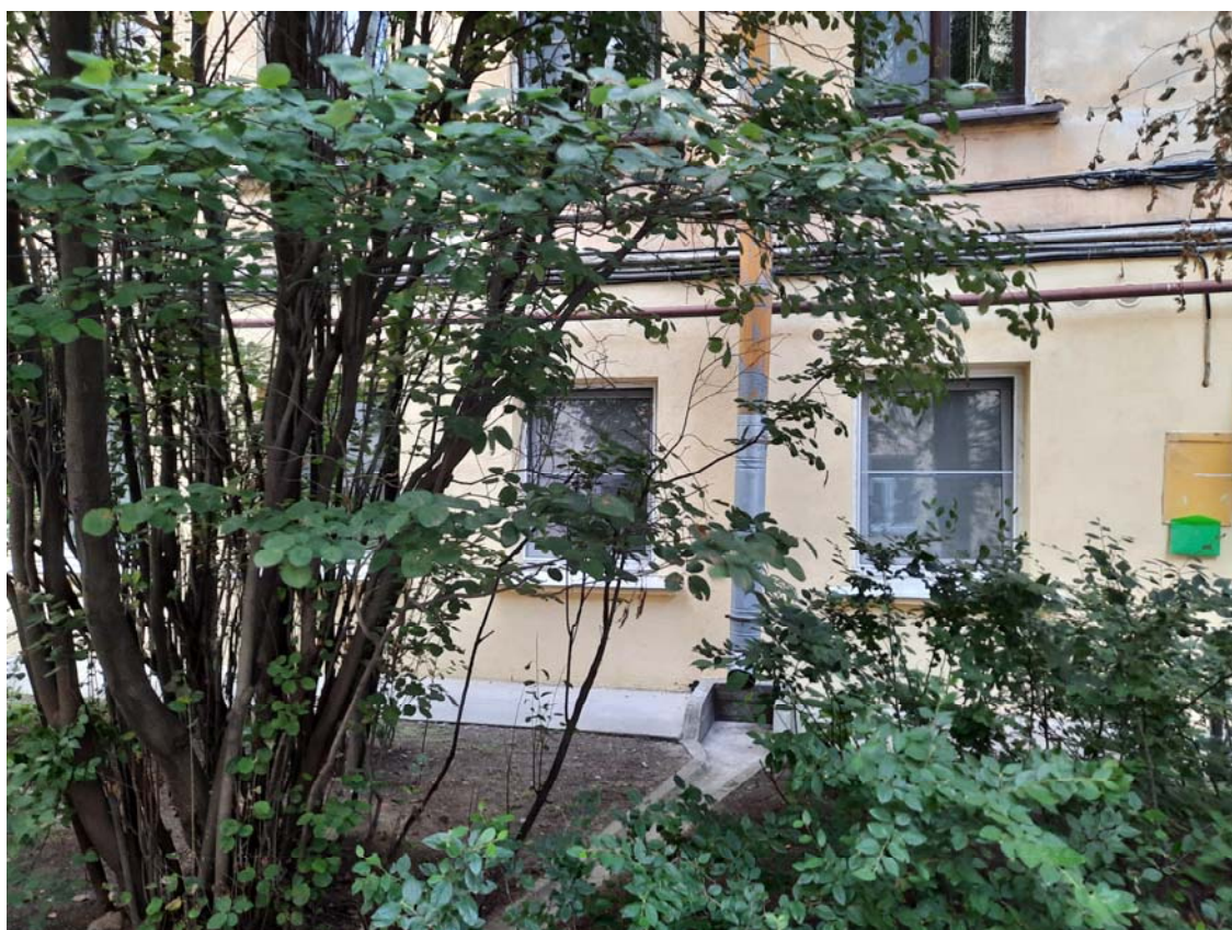
Фото 2. Общий вид оконных заполнений со стороны улицы.
