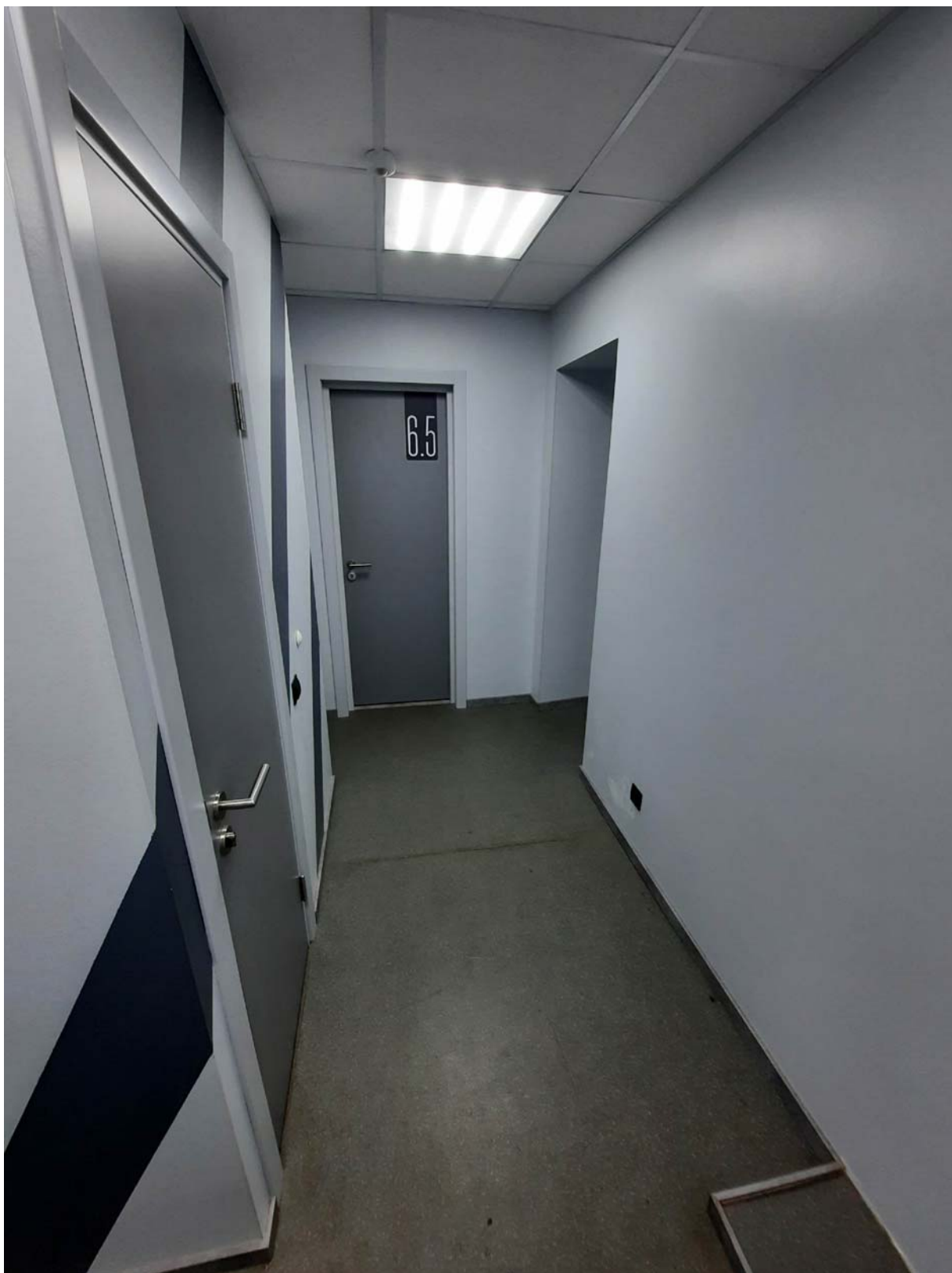
Фото 11. Фрагмент общего коридора.
