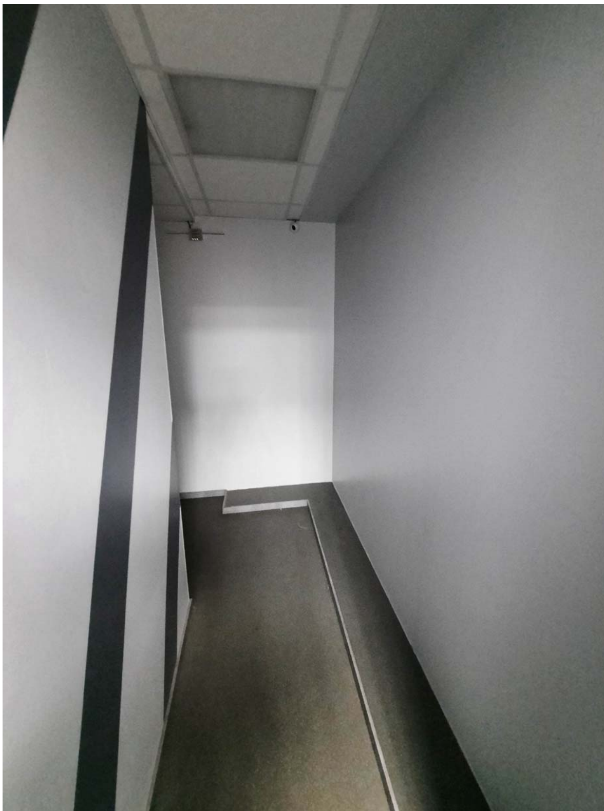
Фото 10. Фрагмент общего коридора.
