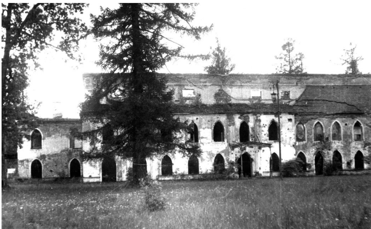
Илл. 69. Фрагмент бокового (северо-восточного) фасада. 1955 г. Фото из архива КГИОП.
