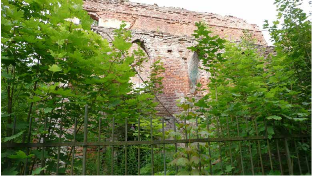
Фото 13. Вид на фрагмент стены восточного фасада здания.
