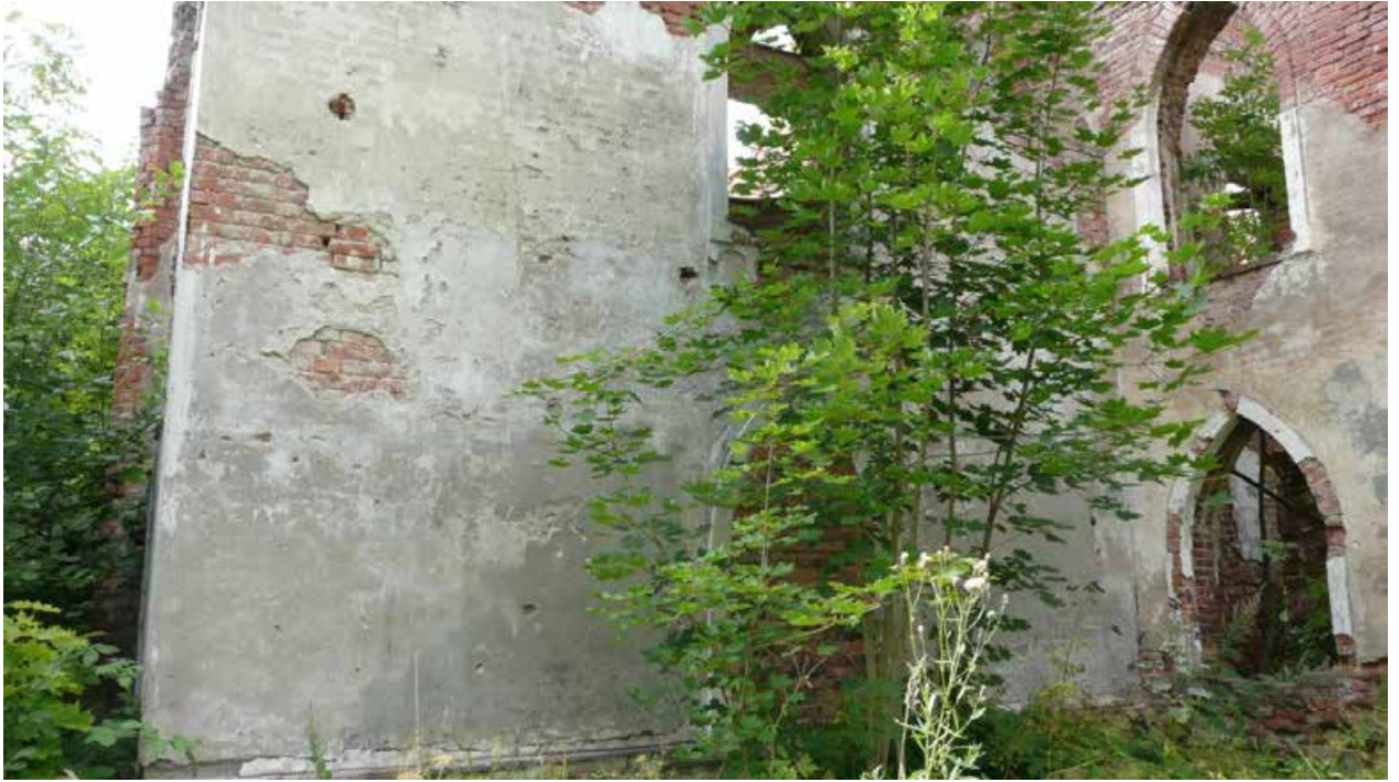
Фото 9. Вид на фрагмент стены восточного фасада здания.
