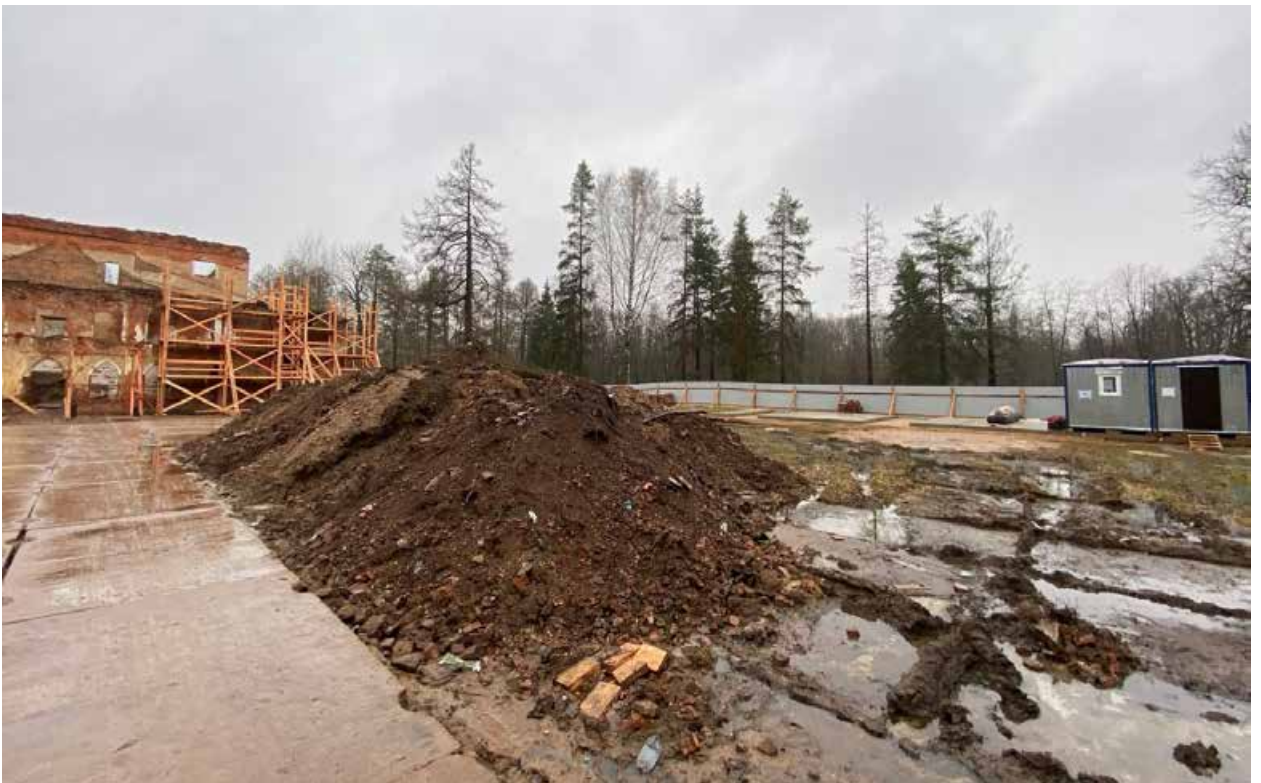
Фото 4. Вид на территорию перед юго-восточным фасадом здания «Китайского театра».
