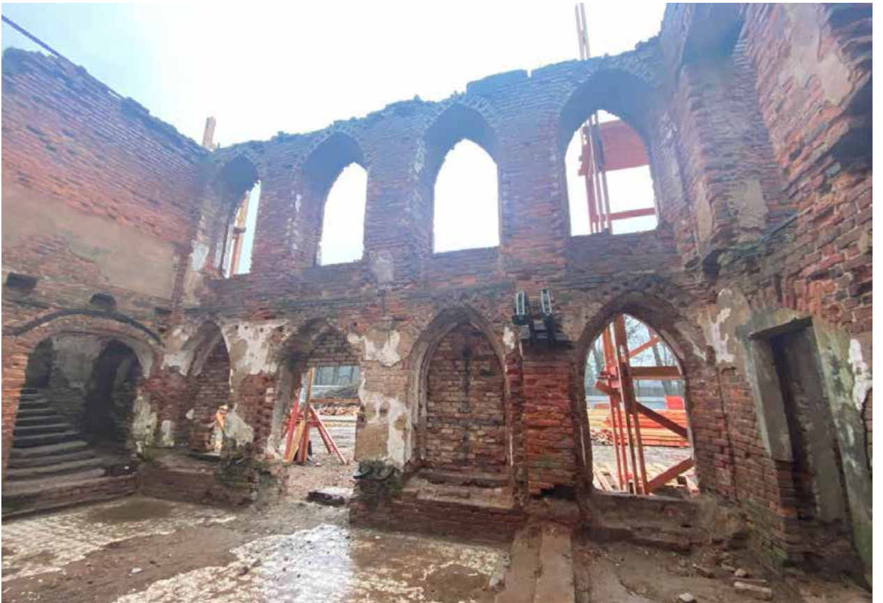
Фото 8. Вид на внутренние помещения здания «Китайского театра».
