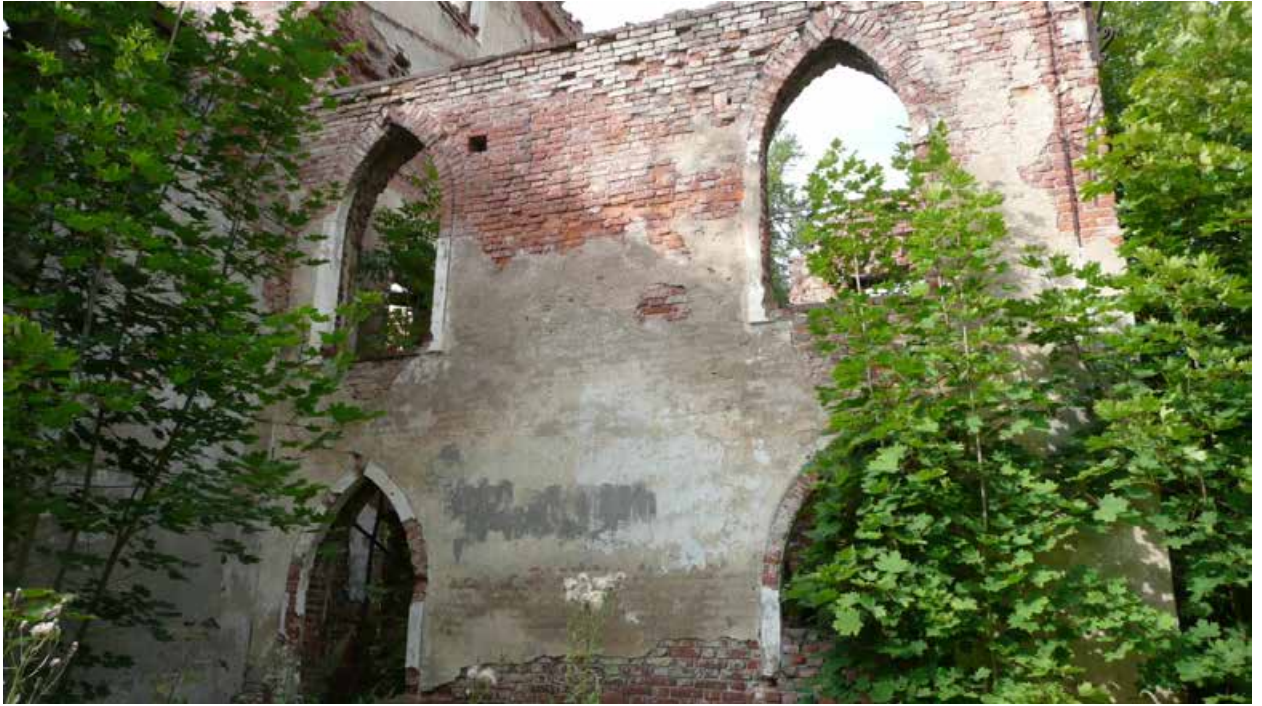
Фото 7. Вид на фрагмент западного фасада, сохранились стрельчатые окна.
