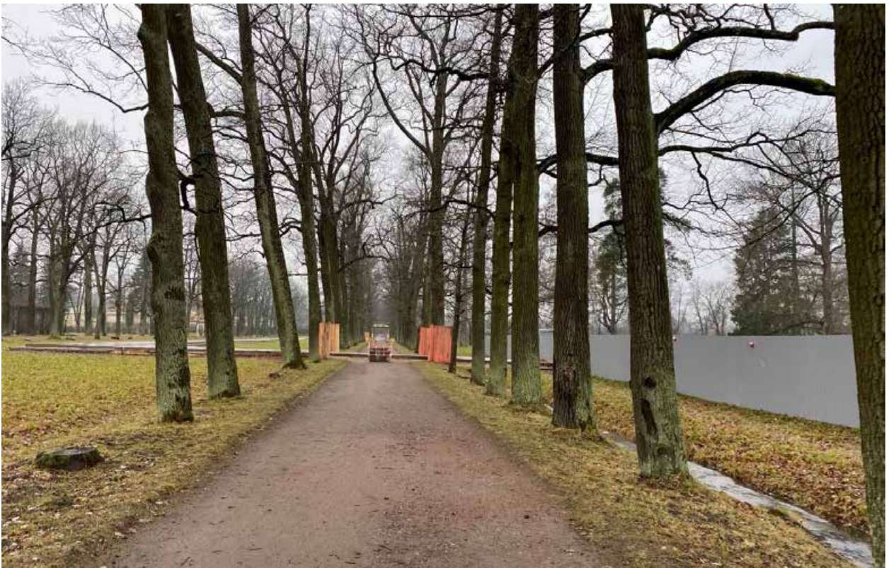
Фото 2. Вид на по оси аллеи в сторону центрального входа на территорию куртины с «Китайским театром».
