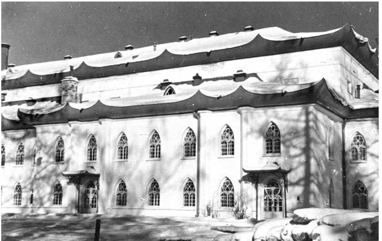
Илл. 61. Юго-западный фасад. Фрагмент (пристройка 1909-1912 гг.). 1940 г. Фото С.Н. Давыдова. Архив КГИОП.
