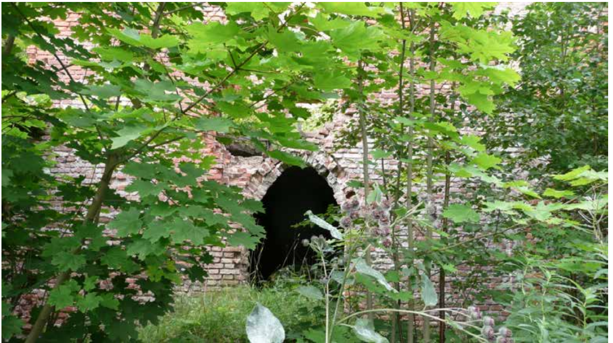
Фото 12. Вид на фрагмент стены восточного фасада здания.
