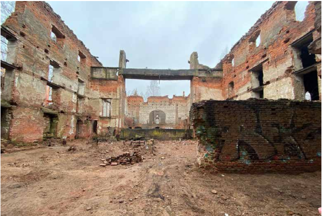
Фото 10. Вид на внутренние помещения здания «Китайского театра».
