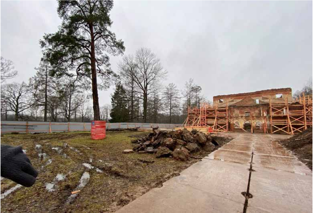
Фото 3. Вид на юго-восточный фасад здания «Китайского театра», ведутся противоаварийные работы.
