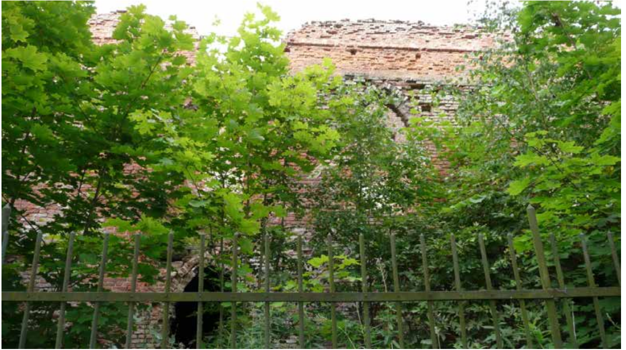
Фото 11. Вид на фрагмент стены восточного фасада здания.
