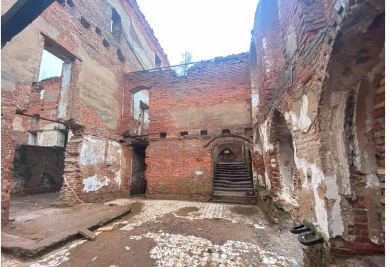
Фото 7. Вид на внутренние помещения здания «Китайского театра».
