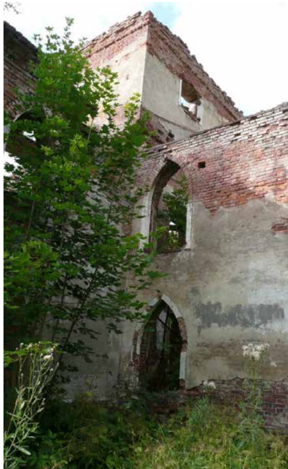
Фото 10. Вид на фрагмент восточного фасада здания.
