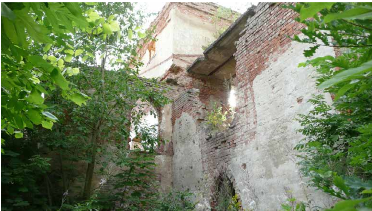
Фото 23. Вид на фрагмент северо-восточного фасада здания театра.
