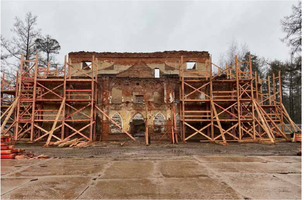
Фото 5. Вид по оси здания «Китайского театра» (юго-восточный фасад).
