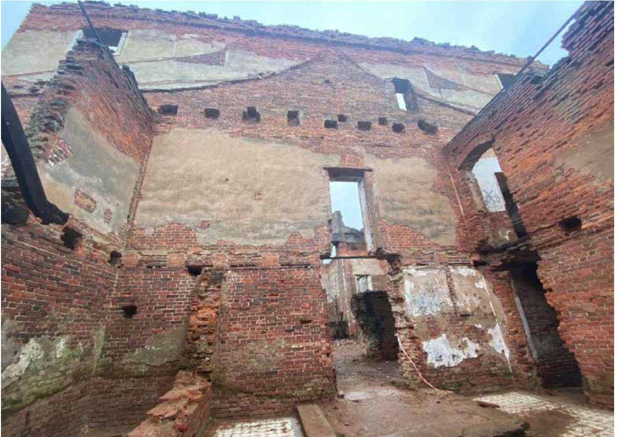
Фото 9. Вид на внутренние помещения здания «Китайского театра».
