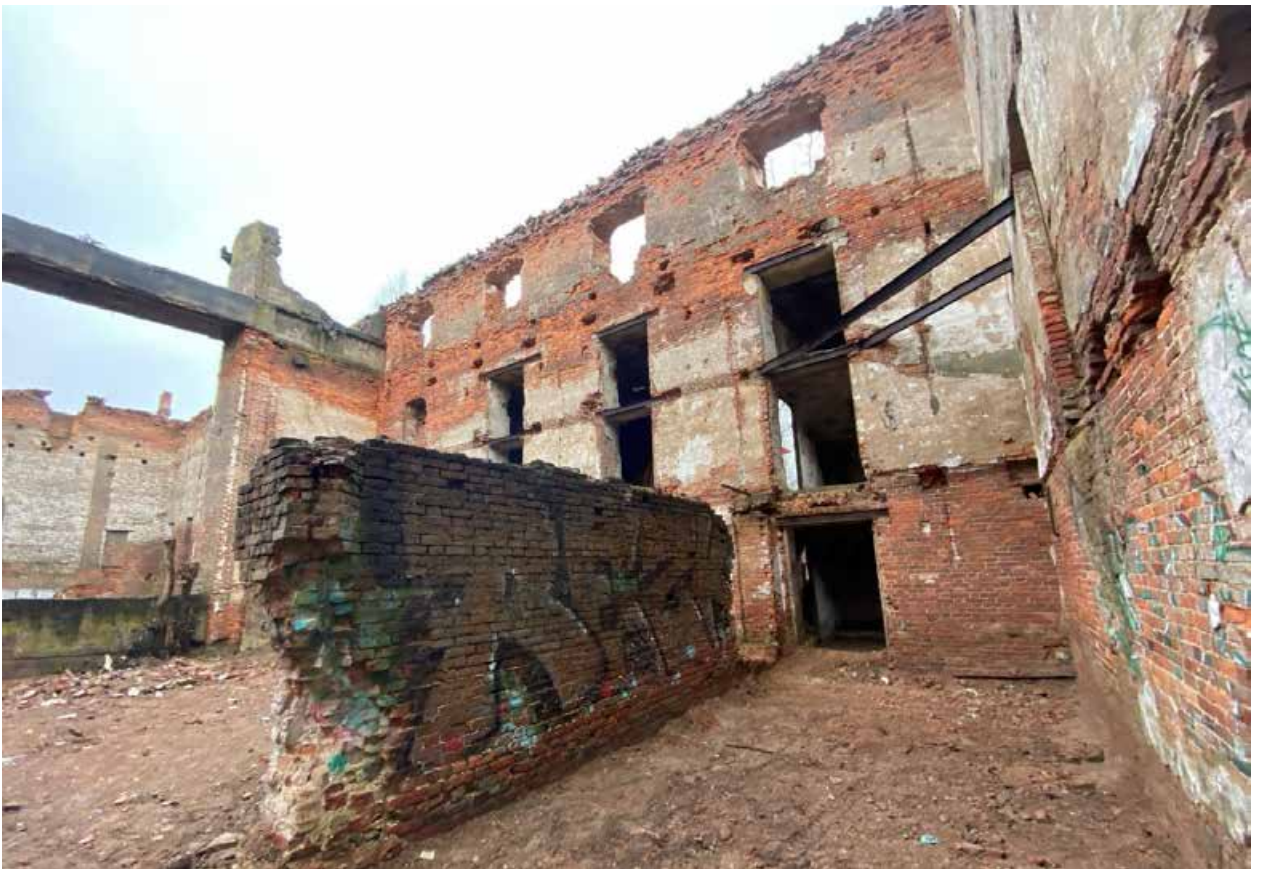
Фото 12. Вид на внутренние помещения здания «Китайского театра».
