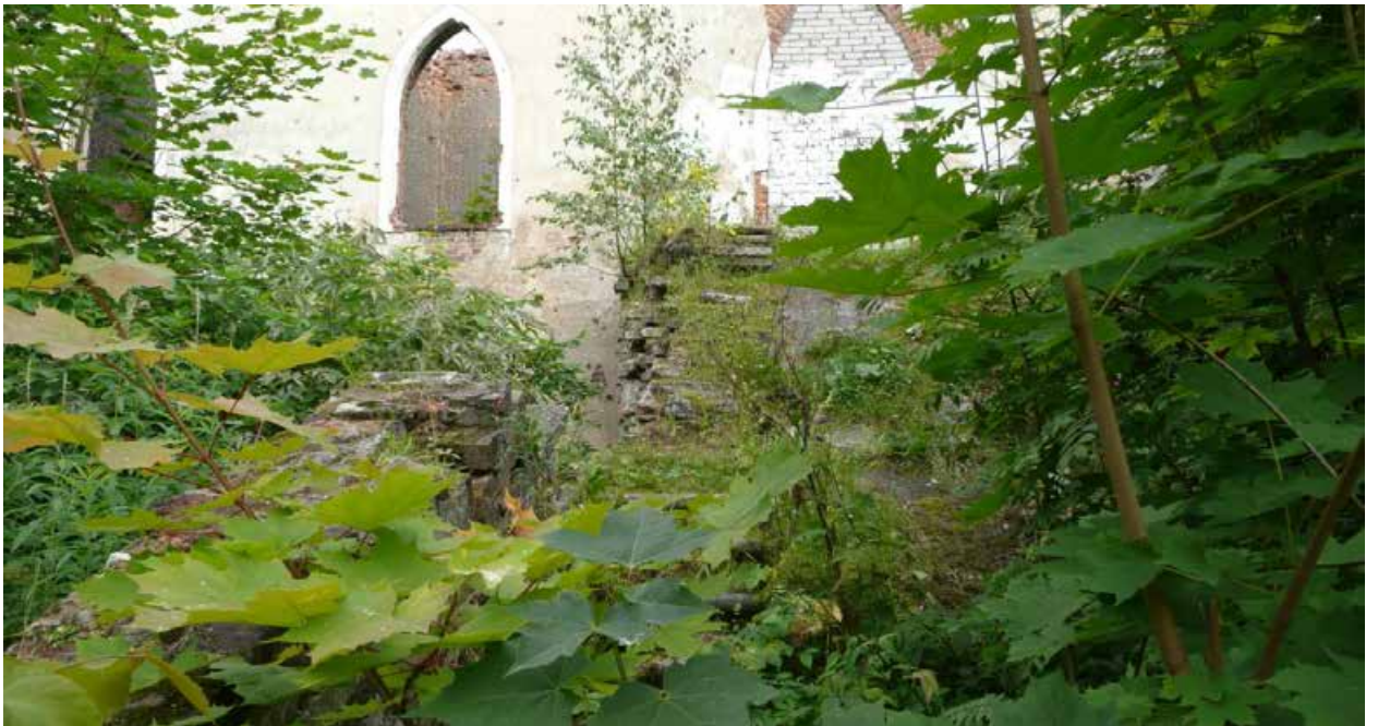
Фото 16. Вид на фрагмент крыльца, расположенного по центру северного фасада здания.
