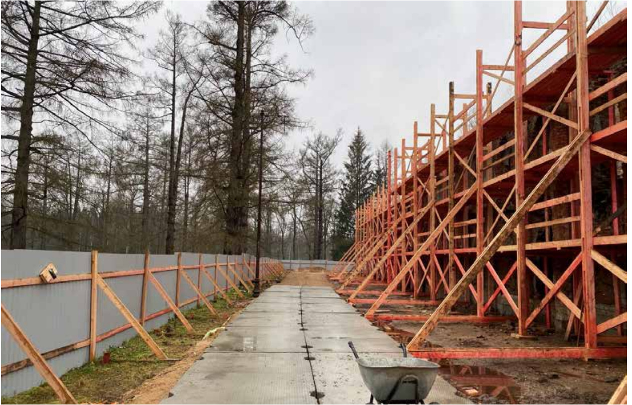
Фото 13. Вид на территорию вдоль юго-западного фасада «Китайского театра» в северном направлении.
