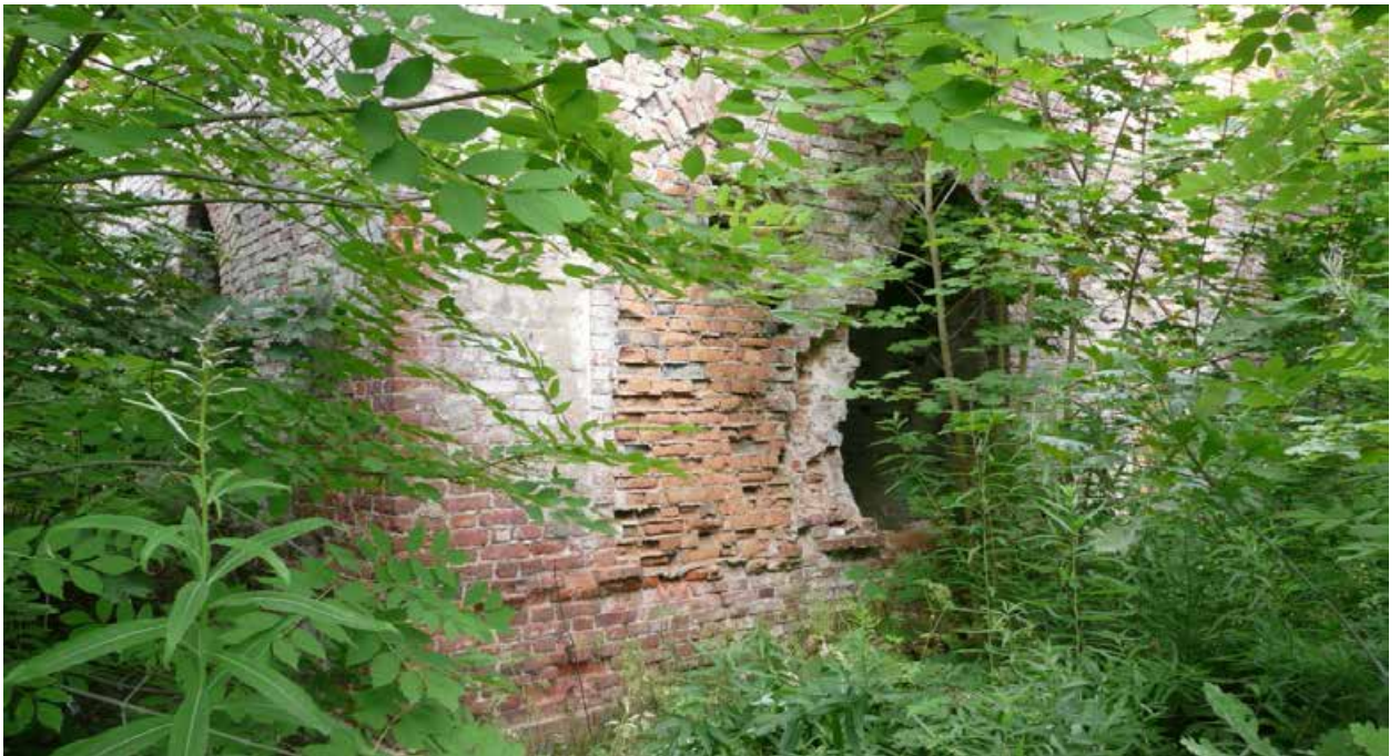
Фото 14. Вид на фрагмент стены восточного фасада здания.
