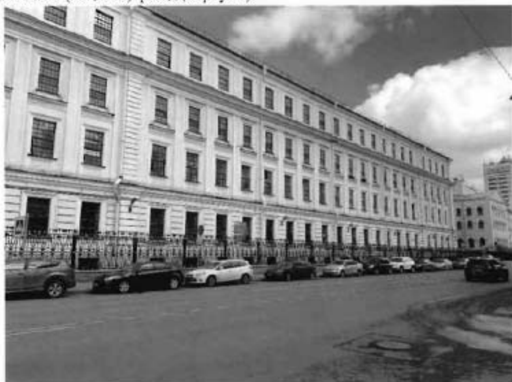
15. Вид на южный (лицевой) фасад (корпус 1).
