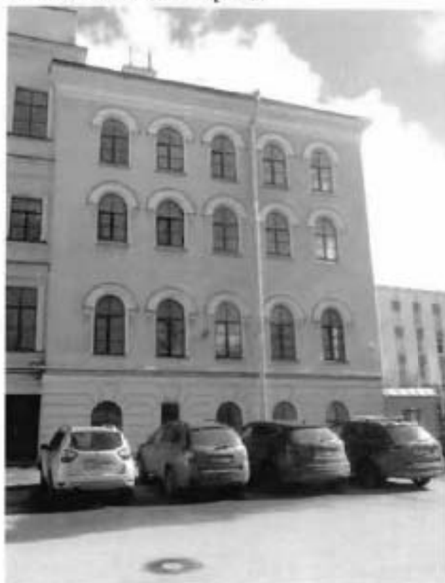
10. Вид на западный фасад
