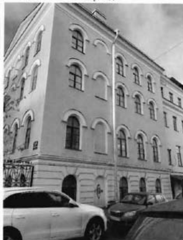
11. Вид на восточный фасад.
