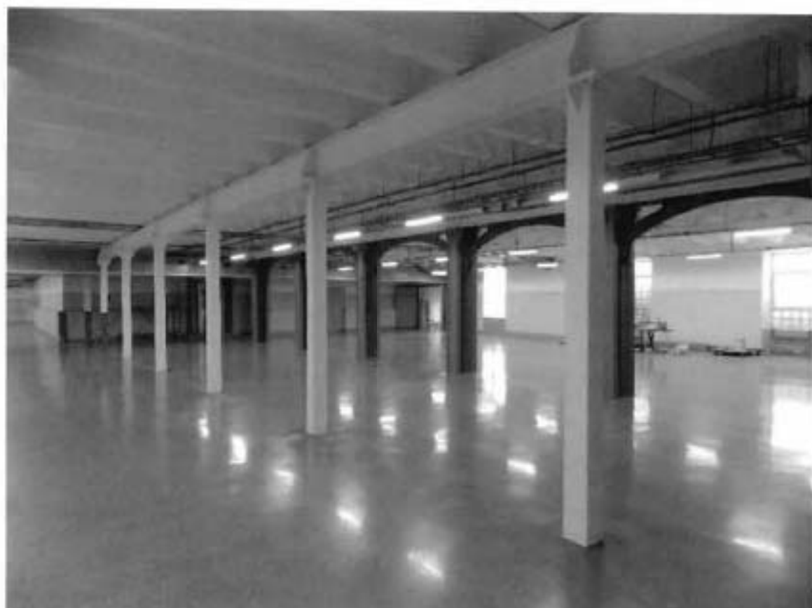
33. Колонны 2-го этажа.
