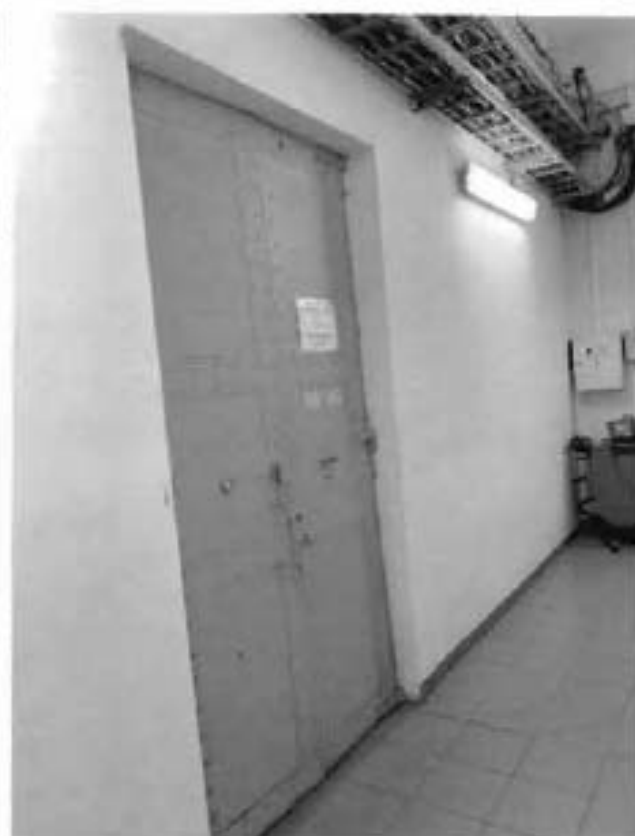
23. Дверное заполнение коридора 1-го этажа.
