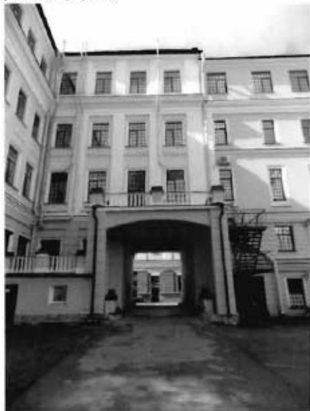
20. Вид на восточный (дворовый) фасад (корпус 1).
