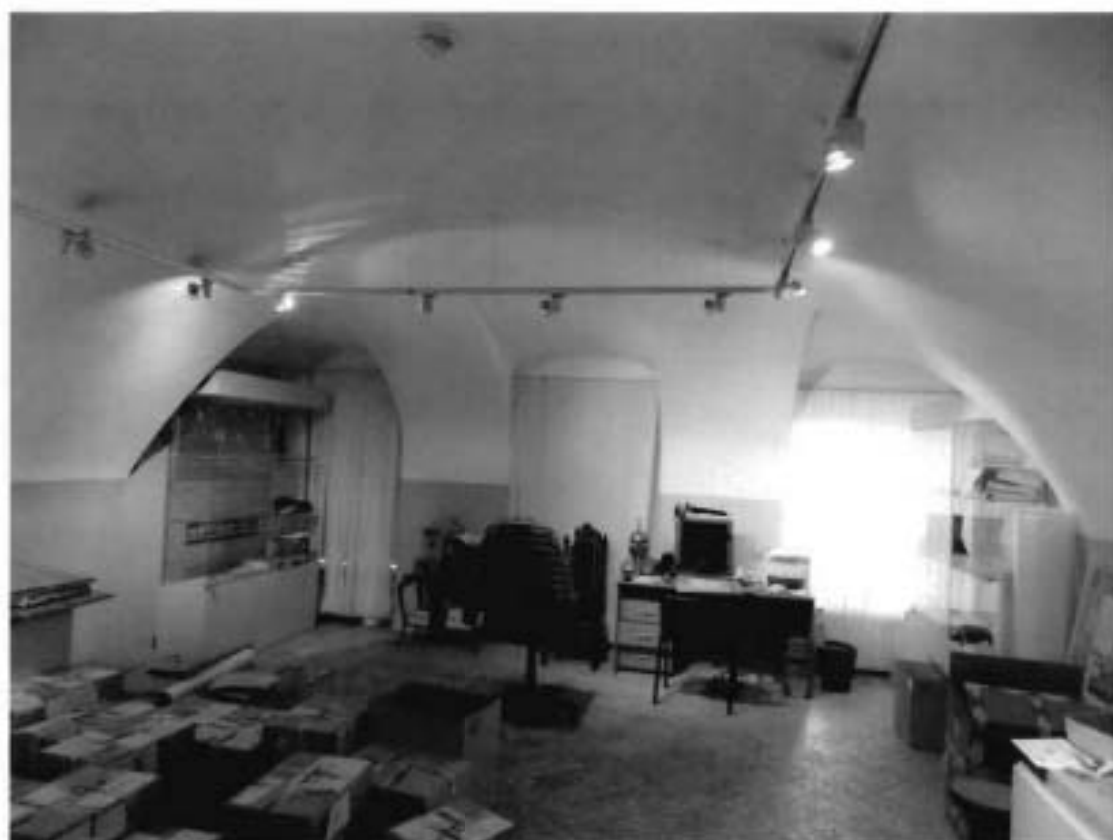
10. Помещение музея «Гознака». Сомкнутый с распалубками свол (дата съемки 23.05.2022).
