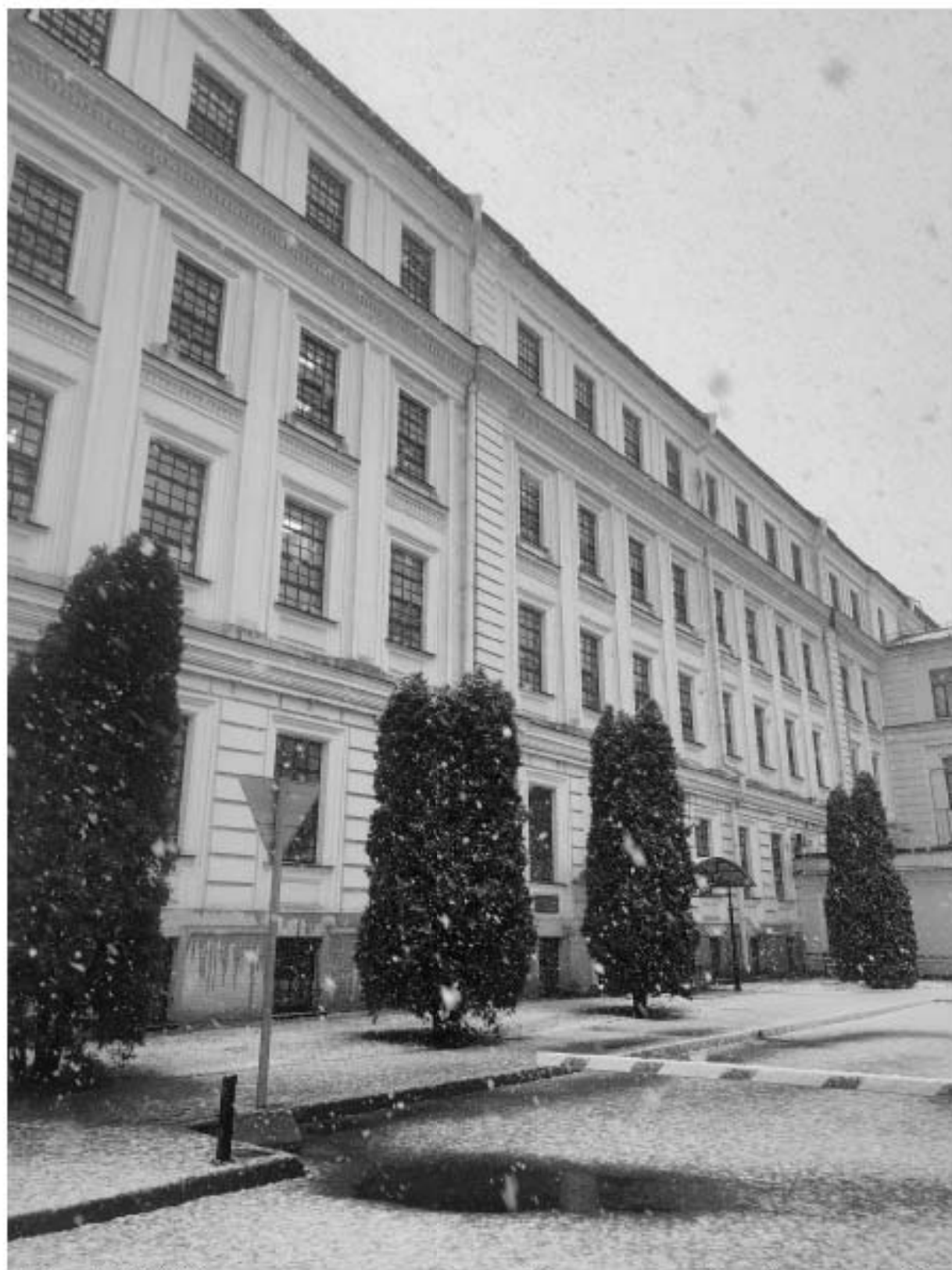
Фото. 3. ОКН «Корпуса производственные и служебные, казармы рабочих (девять зданий)», корпус 1.
