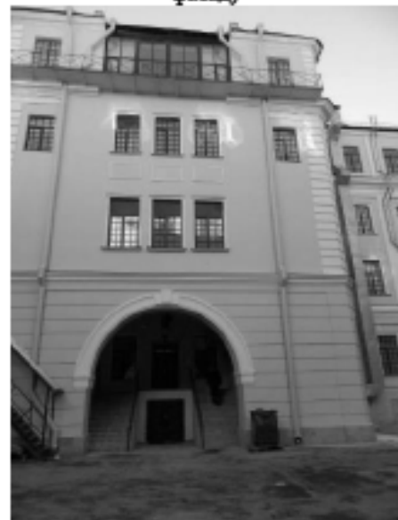
корпус 1, литера Б (северный дворовый фасад)
