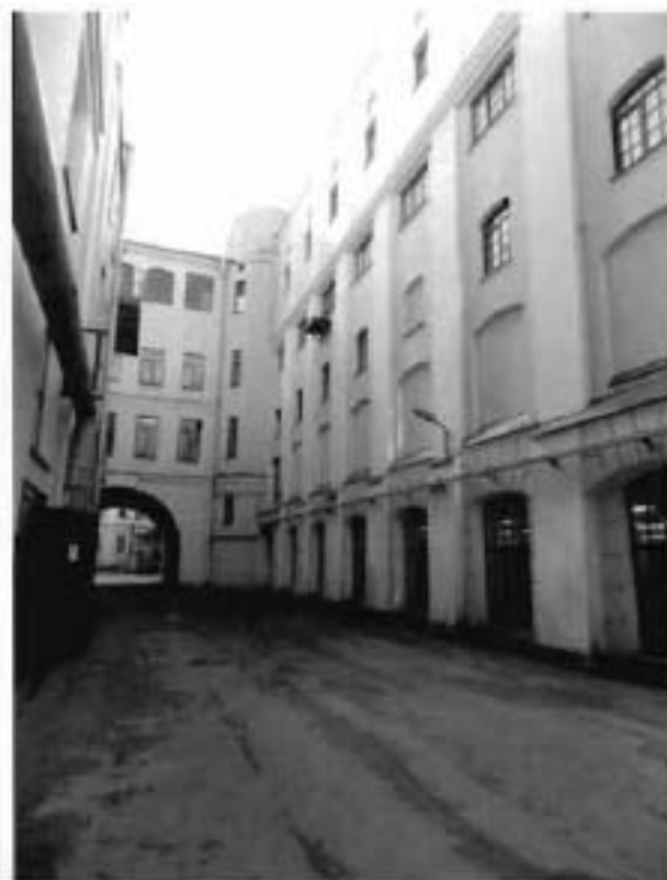
35. Вид на восточный дворовый фасад.
