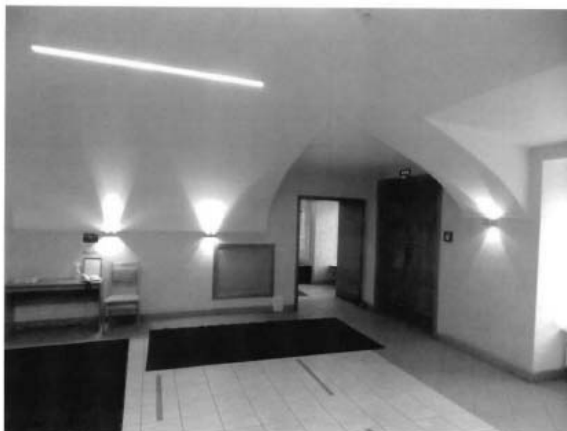
10. Помещение музея «Гознака». Сомкнутый с распалубками свол (дата съемки 23.05.2022).
