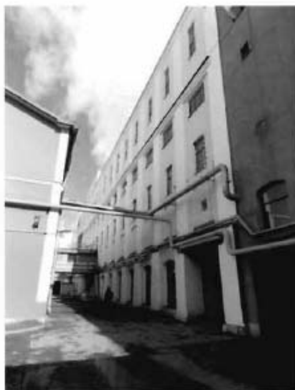
34. Вид на западный дворовый фасад.
