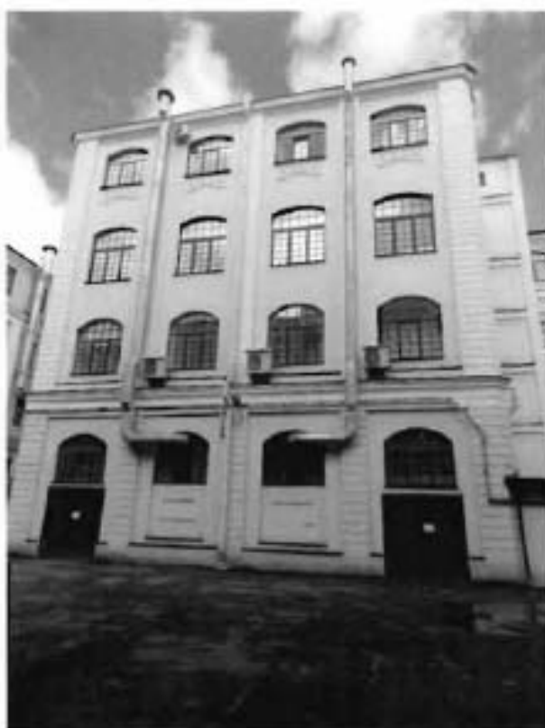
24. Вид на южный фасад (корпус 7).
