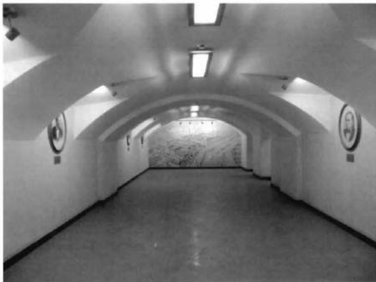
32. Коробовые своды с распалубками (переход из корпуса 4 в корпус 1).
