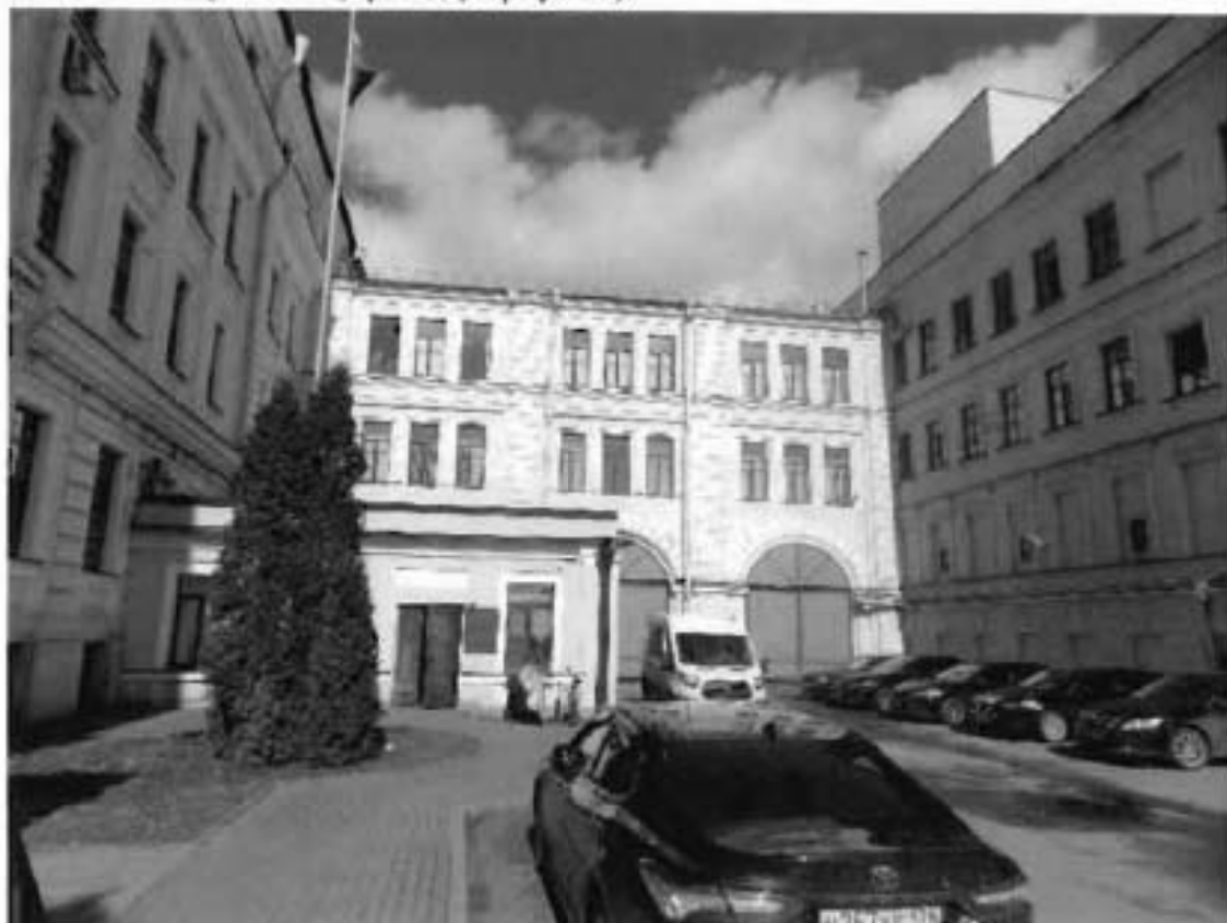
16. Вид на южный (лицевой) фасад (корпус 20).
