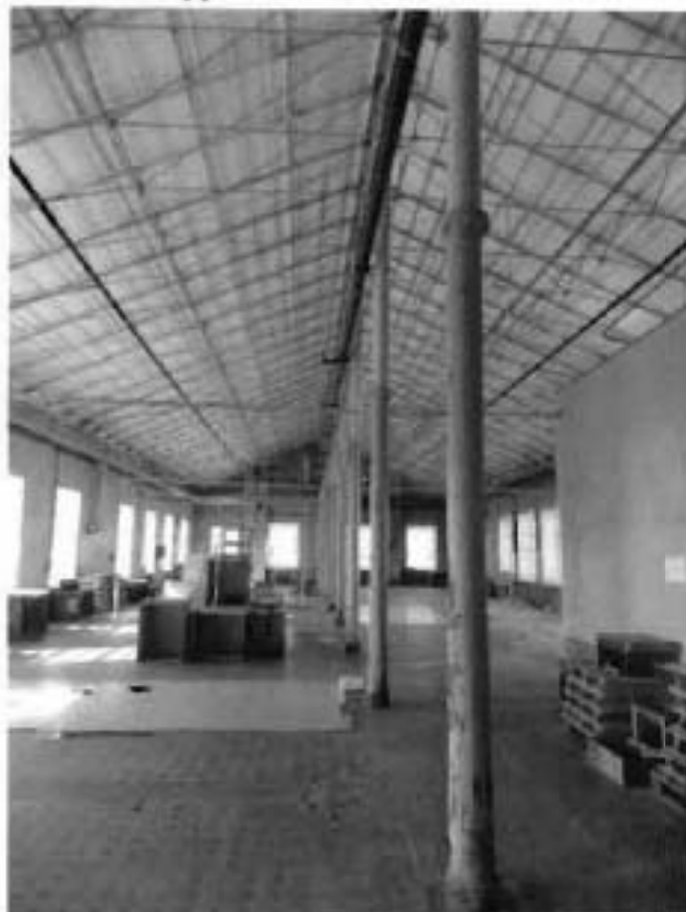
22. Конструкции крыши. Колонны в уровне 4-го этажа.
