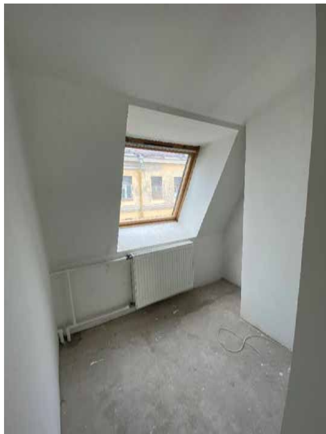
Фото 80. Помещение № 47. 4-й этаж. Вид с юга.
