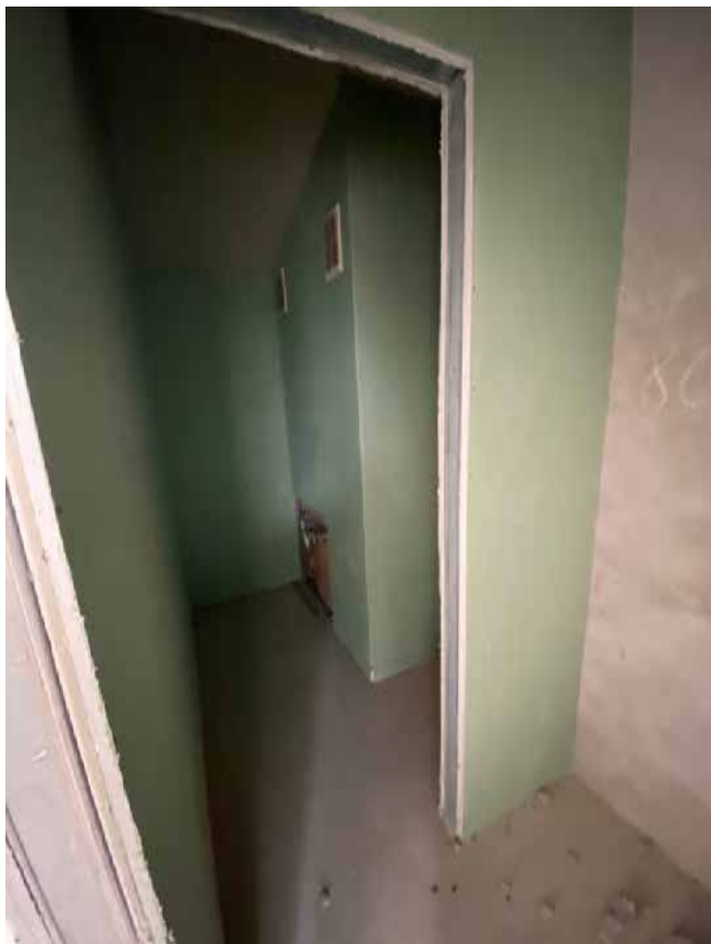
Фото 79. Помещение № 48. 4-й этаж. Вид с юга.
