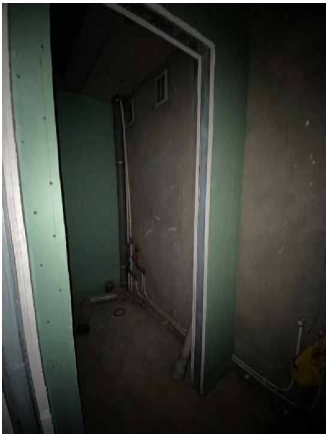
Фото 52. Помещение № 43, 44. 3-й этаж. Вид с юго-востока.
