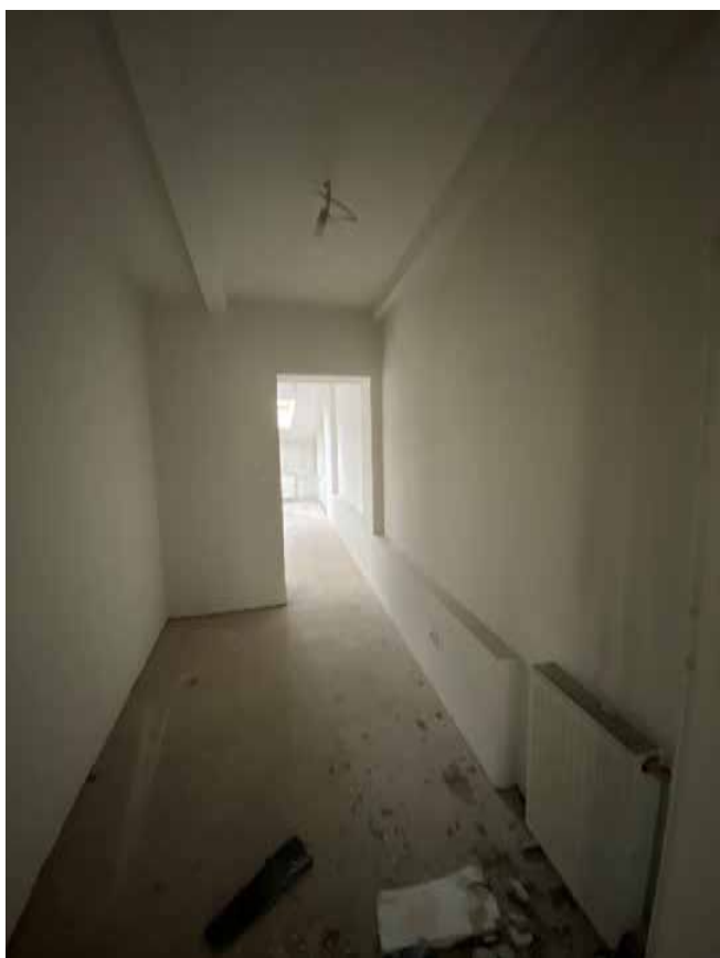
Фото 58. Помещение № 39. 3-й этаж. Вид с северо-запада.
