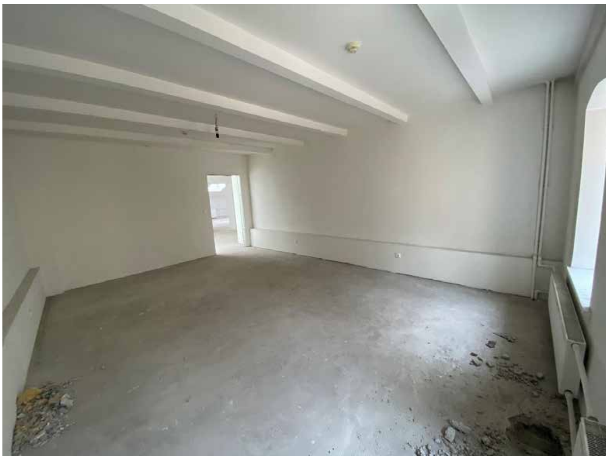
Фото 72. Помещение № 35. 3-й этаж. Вид с севера.
