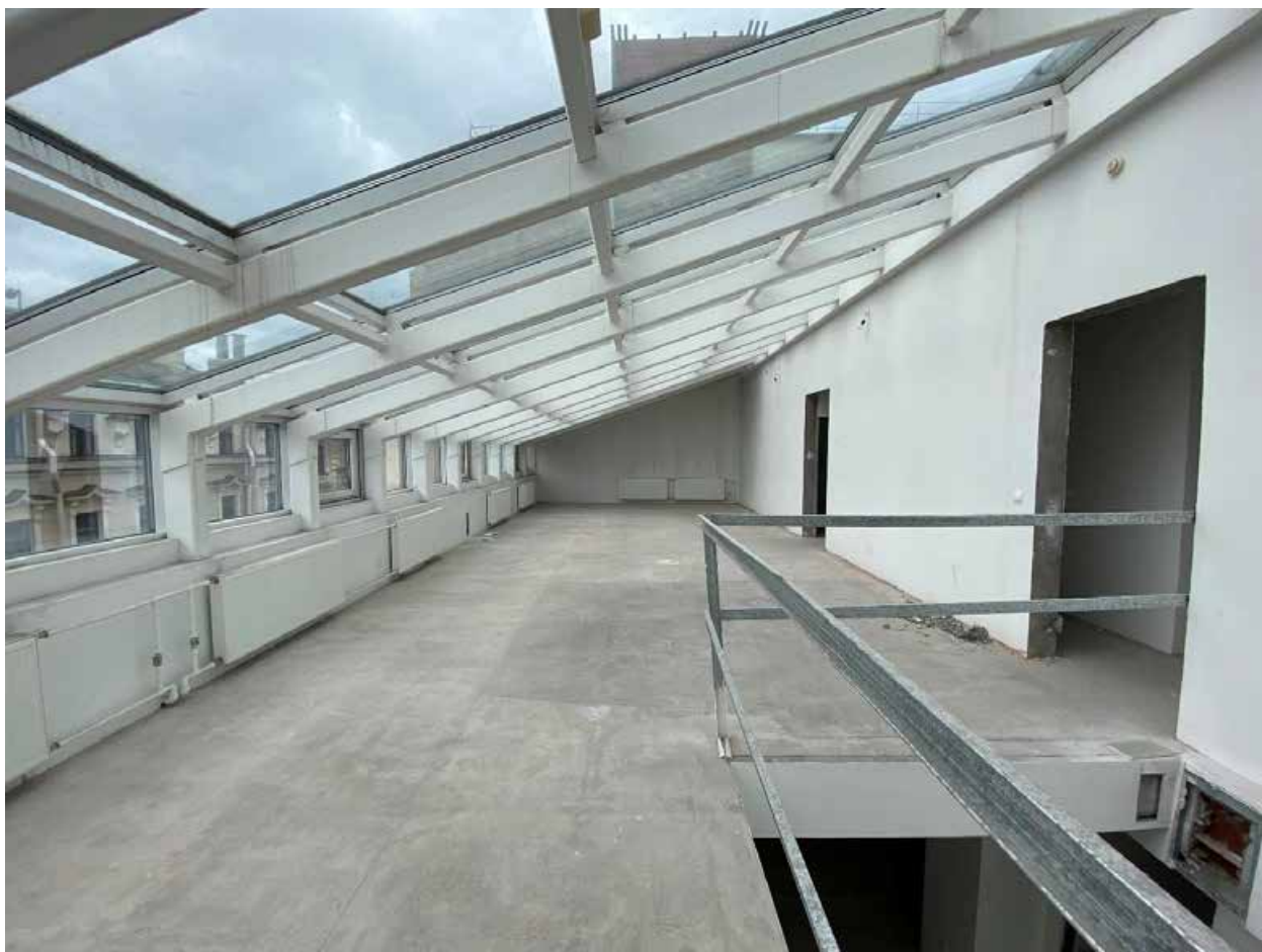
Фото 84. Помещение № 51. 4-й этаж. Вид с северо-востока.
