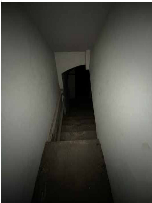
Фото 10. Лестница, ведущая в подвал. Вид с северо-запада.
