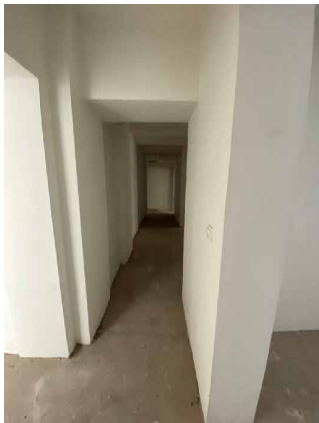
Фото 50. Помещение № 40. 3-й этаж. Вид с северо-востока.
