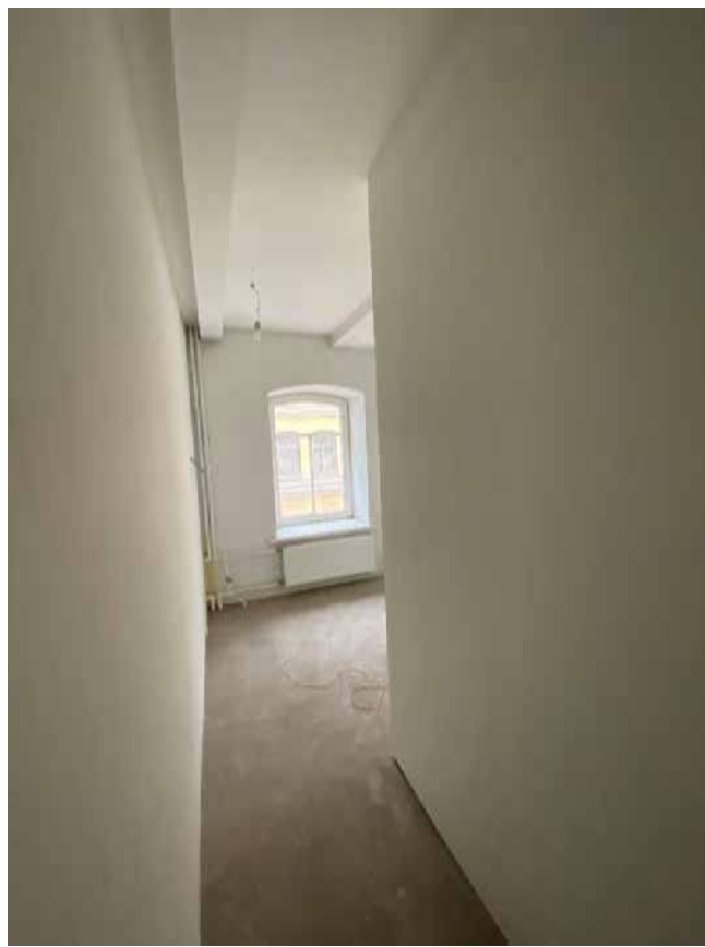
Фото 53. Помещение № 40. 3-й этаж. Вид с юго-востока.
