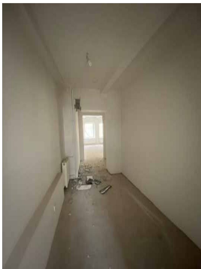
Фото 59. Помещение № 39. 3-й этаж. Вид с юго-востока.
