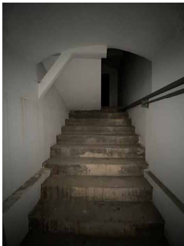
Фото 11. Лестница, ведущая в подвал. Вид с юго-востока.
