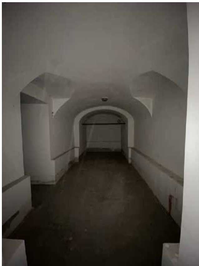
Фото 16. Подвальное помещение № 5. Вид с северо-востока.
