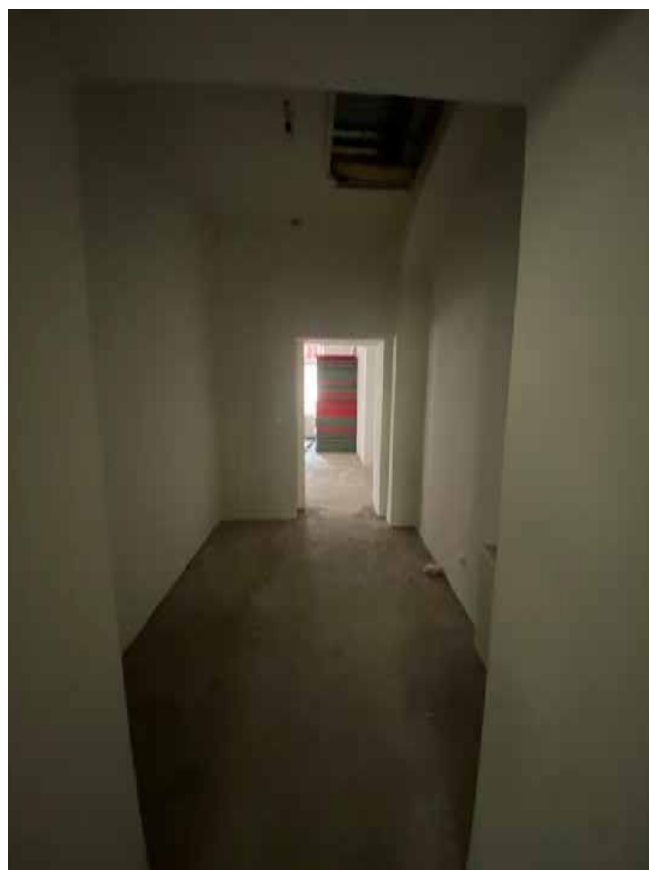
Фото 34. Помещение № 27. 2-й этаж. Вид с юго-востока.
