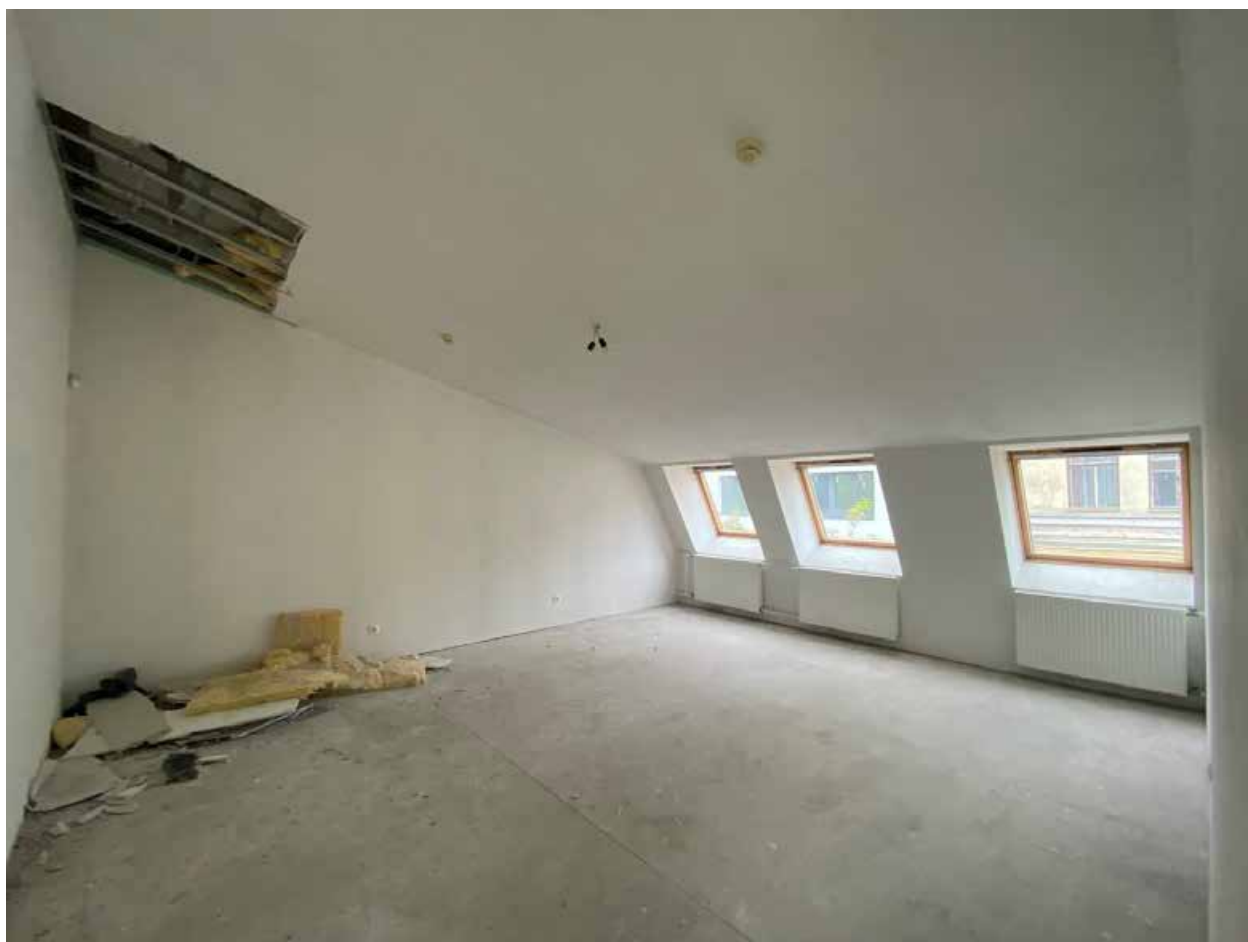
Фото 81. Помещение № 50. 4-й этаж. Вид с северо-востока.
