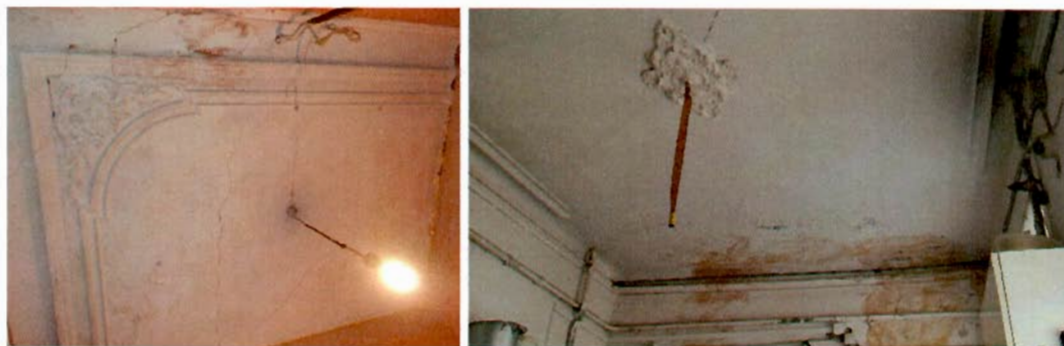
24, 25, 26. лестница Л-2 дворового корпуса
