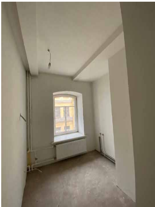
Фото 54. Помещение № 42. 3-й этаж. Вид с юго-востока.
