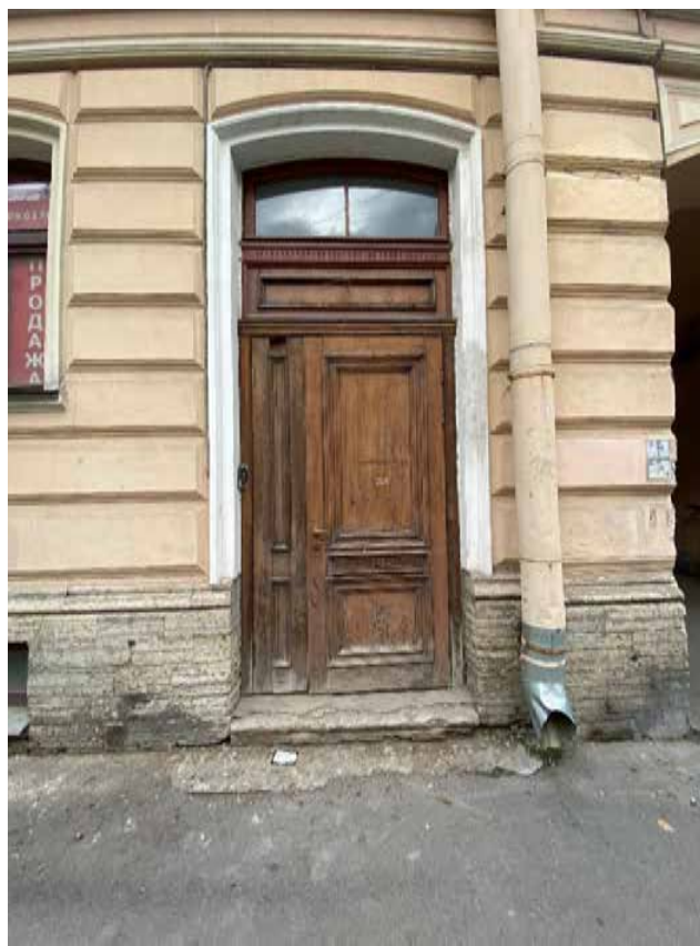
Фото 4. Входное дверное заполнение. Вид с юго-востока.
