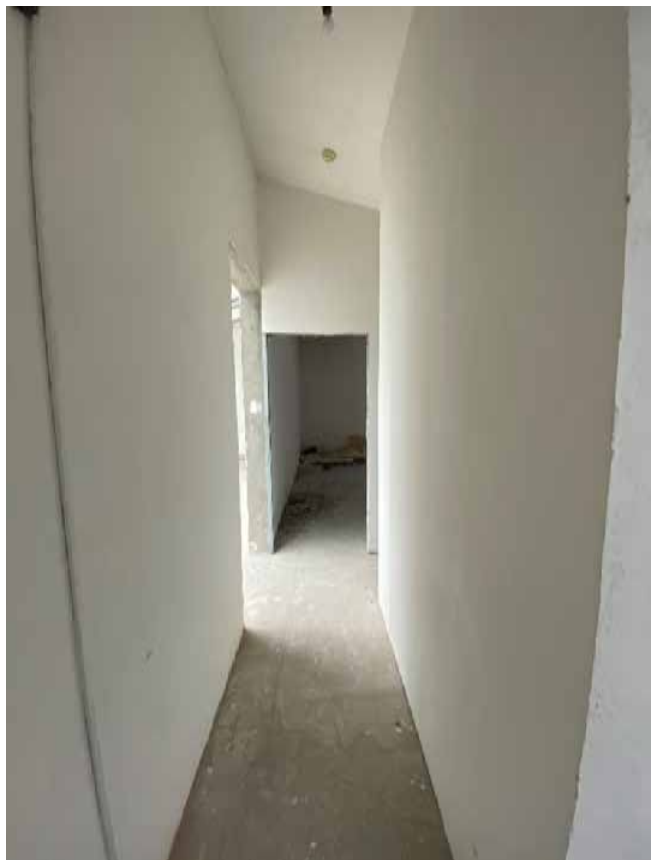
Фото 77. Помещение № 46. 4-й этаж. Вид с северо-востока.
