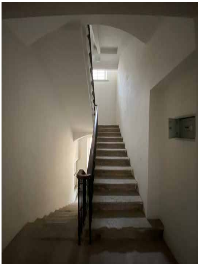
Фото 47. Лестничная клетка 1-Н. 2-й этаж. Вид с юго-востока.
