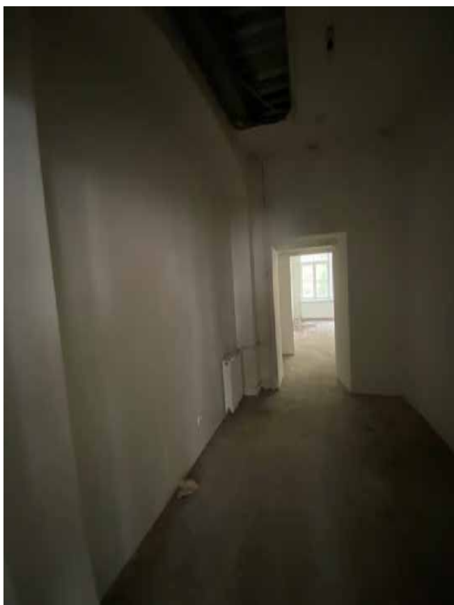
Фото 33. Помещение № 27. 2-й этаж. Вид с юго-востока.
