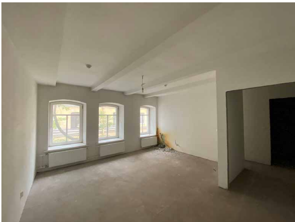
Фото 56. Помещение № 41. 3-й этаж. Вид с юга.
