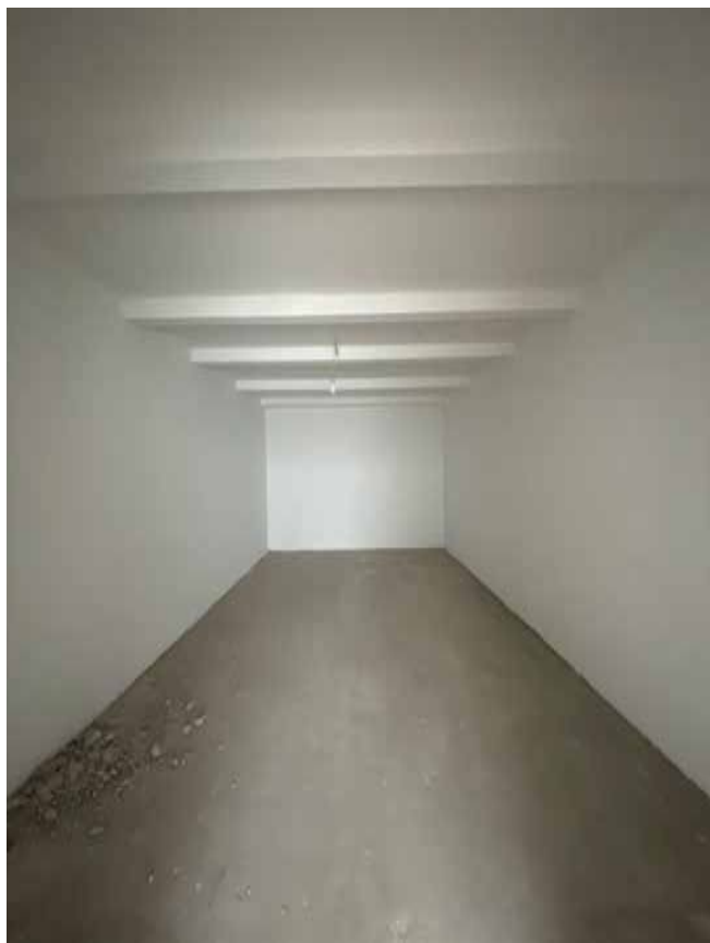
Фото 63. Помещение № 37. 3-й этаж. Вид с северо-востока.
