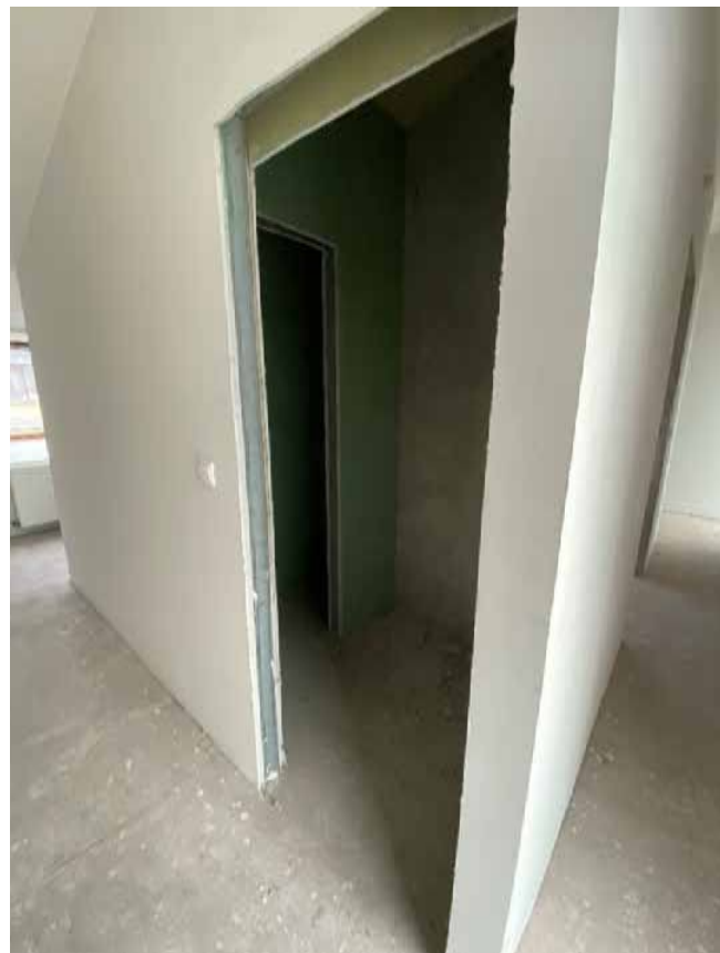
Фото 78. Помещение № 49. 4-й этаж. Вид с юга.
