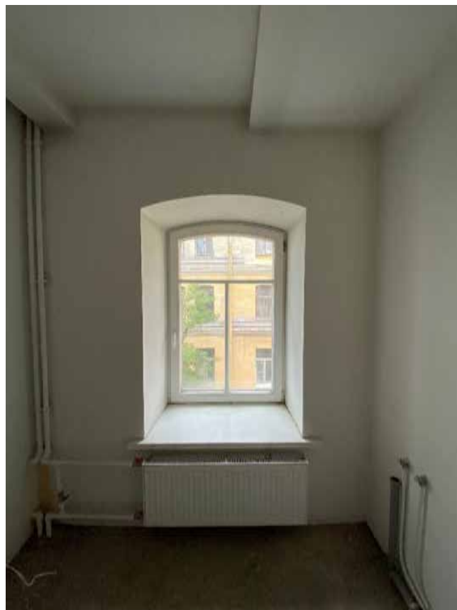
Фото 55. Помещение № 42. 3-й этаж. Вид с юго-востока.
