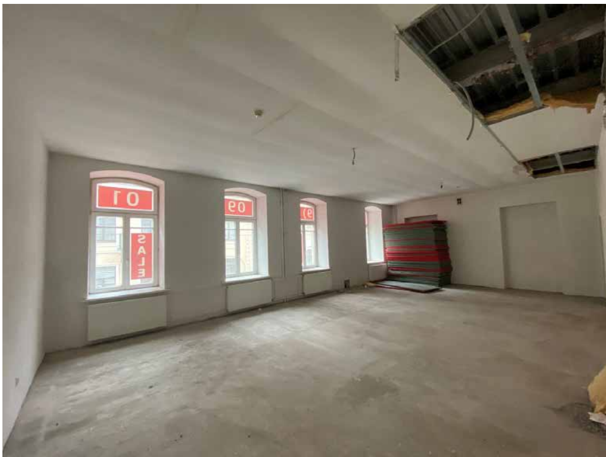
Фото 36. Помещение № 28. 2-й этаж. Вид с севера.
