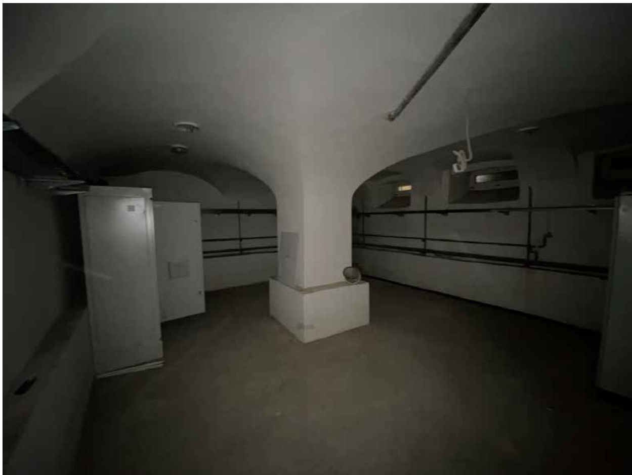
Фото 14. Подвальное помещение № 6. Вид с северо-востока.
