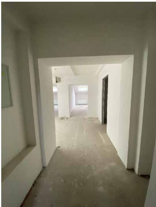
Фото 49. Помещение № 34. 3-й этаж. Вид с северо-запада.
