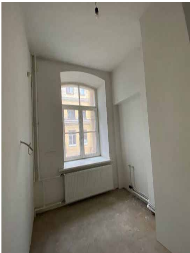
Фото 29. Помещение № 25. 2-й этаж. Вид с юга.
