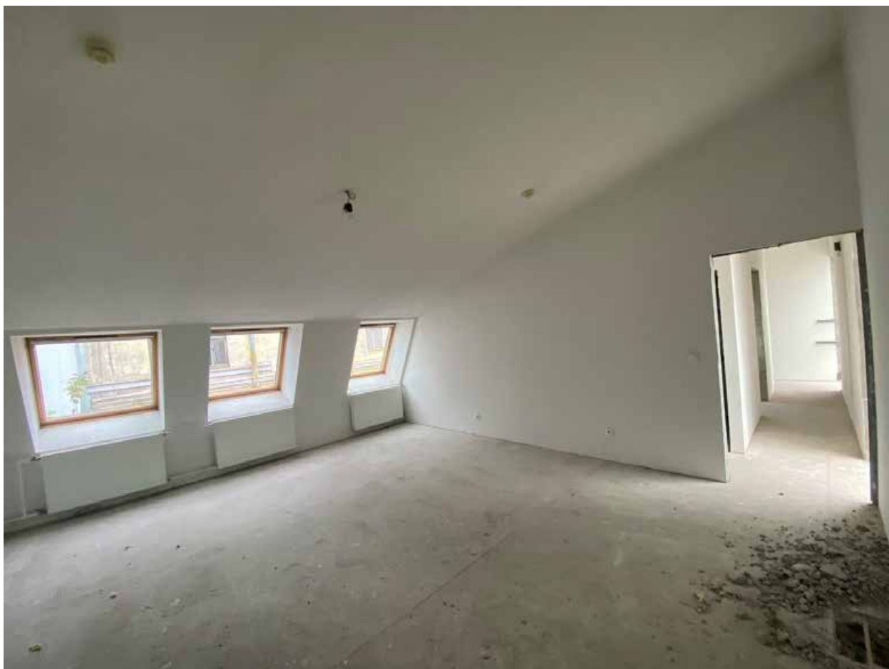
Фото 82. Помещение № 50. 4-й этаж. Вид с юго-запада.
