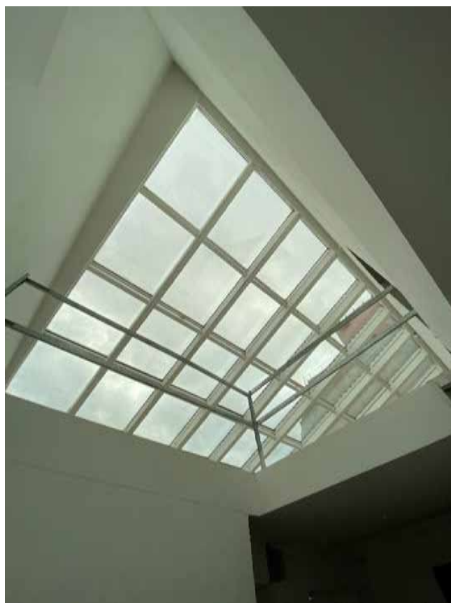
Фото 70. Помещение № 34. 3-й этаж. Вид с севера.
