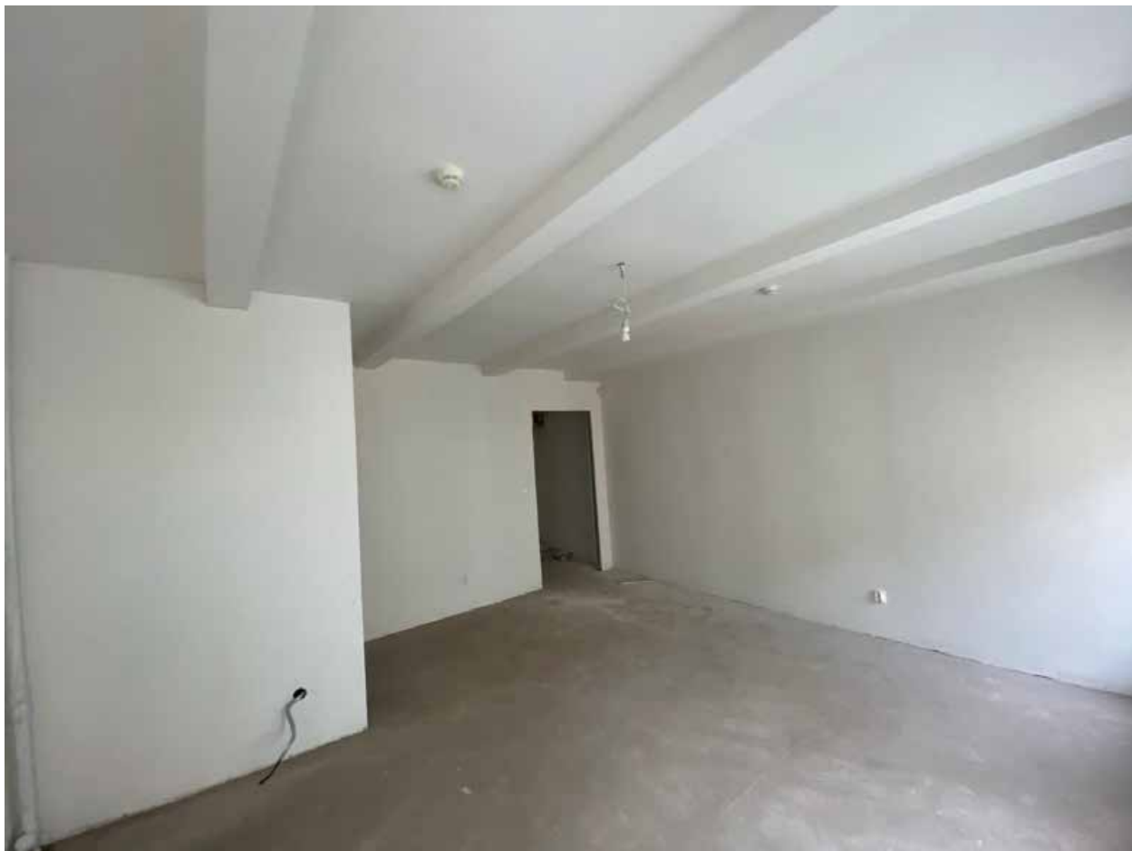
Фото 57. Помещение № 41. 3-й этаж. Вид с севера.
