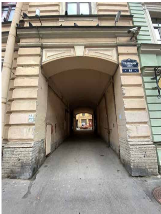
Фото 3. Арка воротного проезда. Вид с юго-востока.
