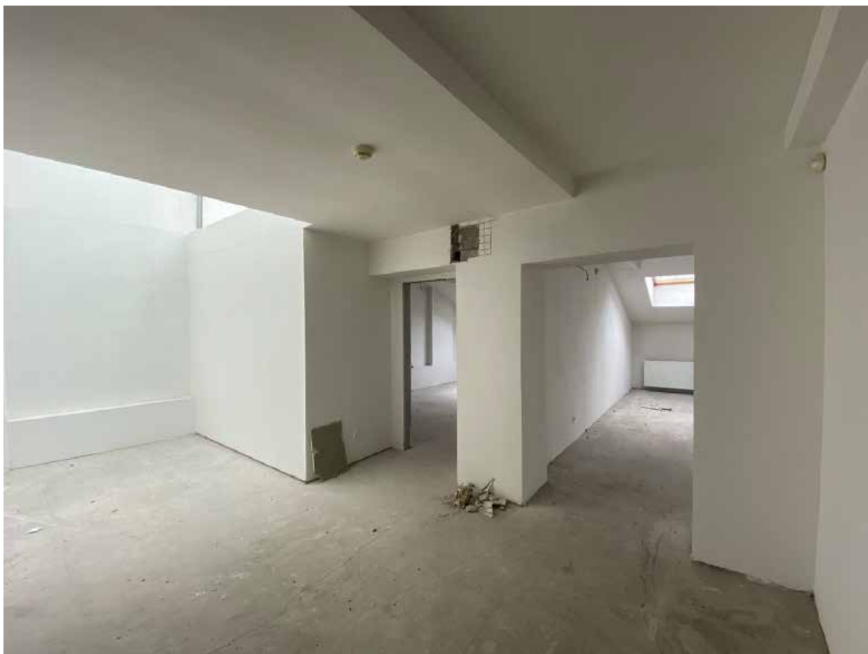
Фото 65. Помещение № 34. 3-й этаж. Вид с запада.
