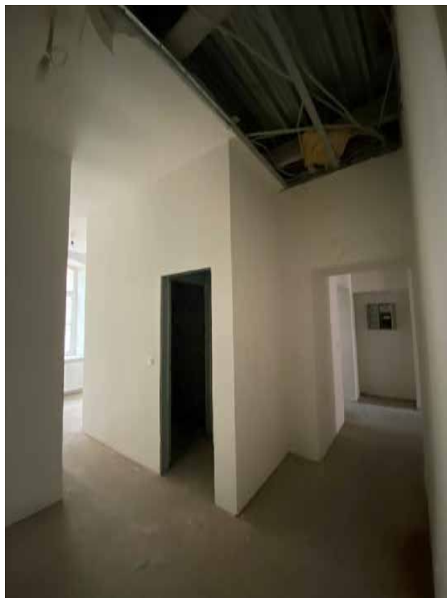
Фото 26. Помещение № 22. 2-й этаж. Вид с юга.
