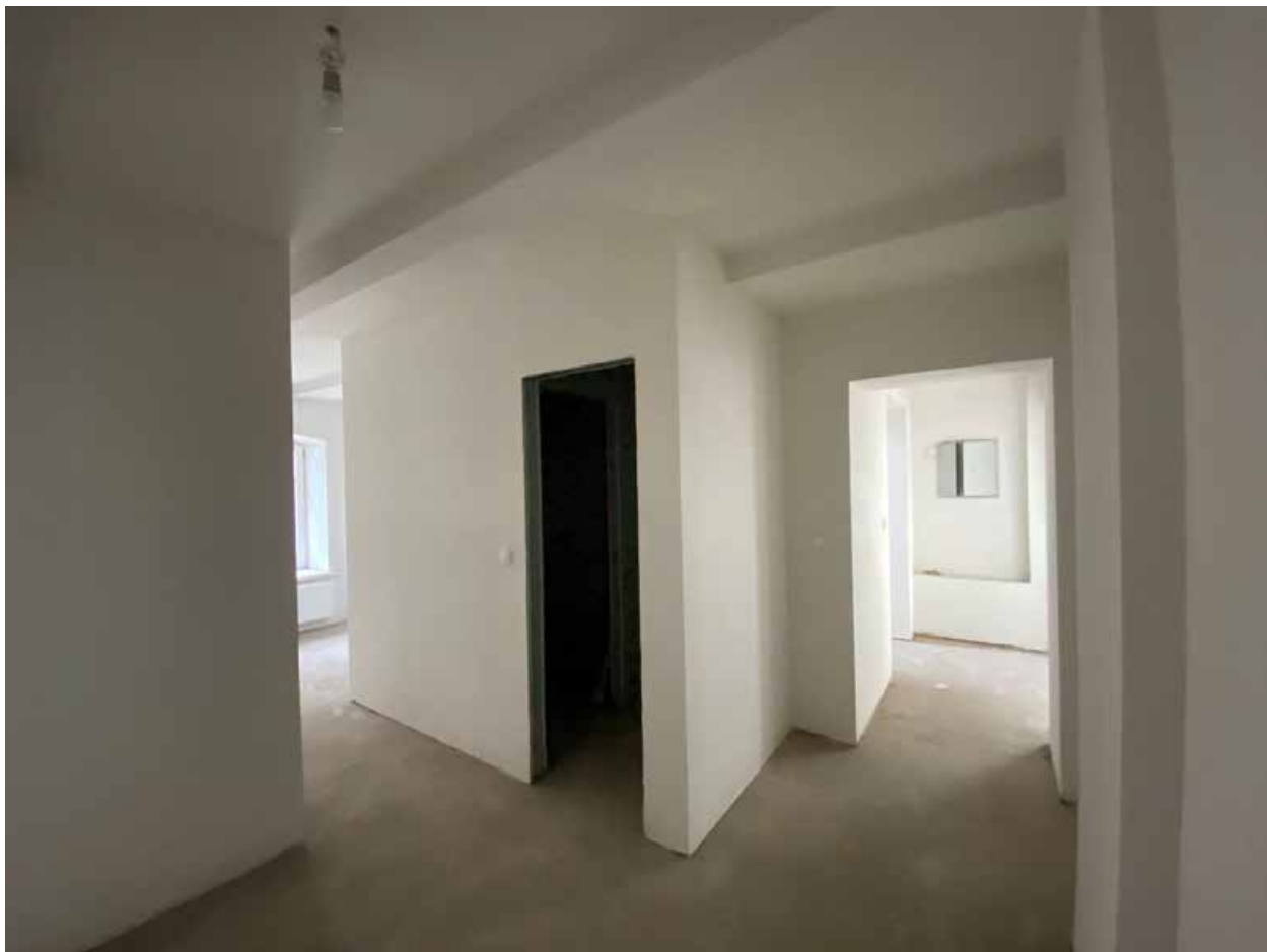
Фото 51. Помещение № 40. 3-й этаж. Вид с юга.
