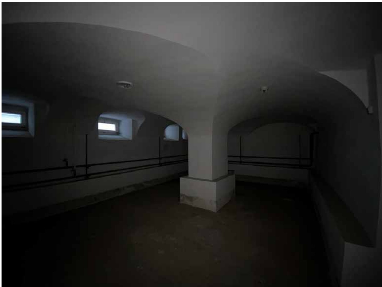
Фото 17. Подвальное помещение № 4. Вид с северо-востока.
