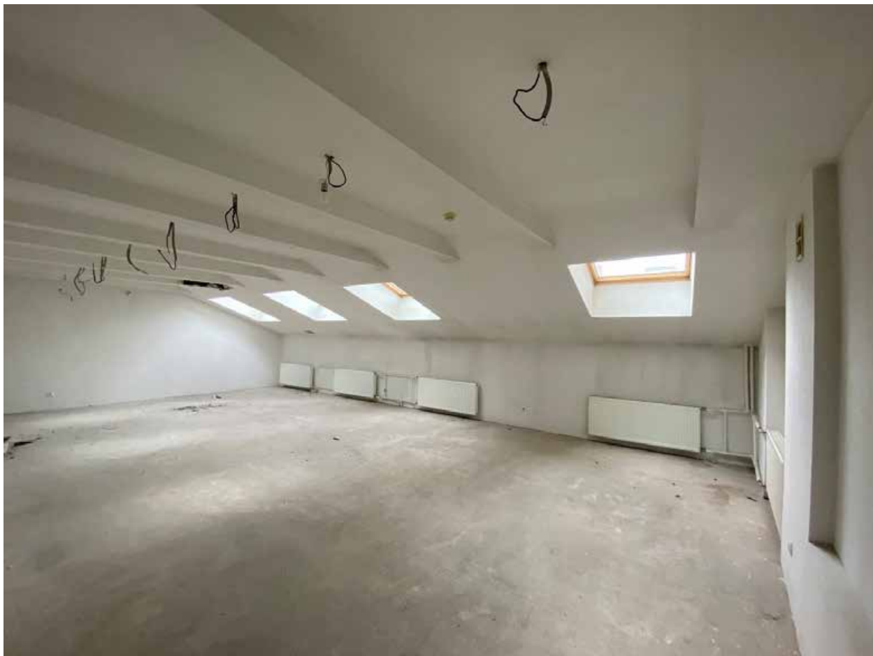
Фото 60. Помещение № 38. 3-й этаж. Вид с запада.
