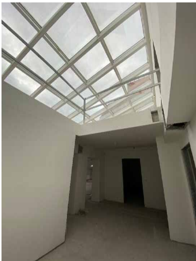
Фото 69. Помещение № 34. 3-й этаж. Вид с северо-востока.
