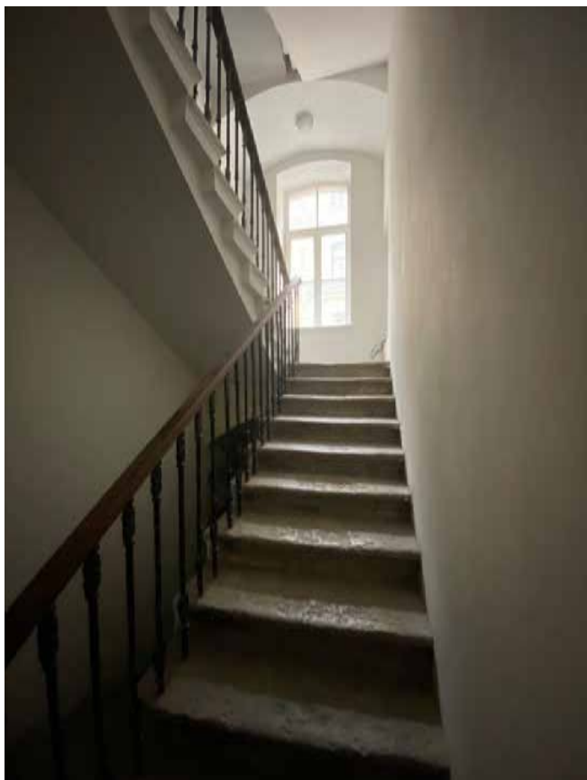
Фото 23. Лестничная клетка 1-Н. 1-й этаж. Вид с севера.
