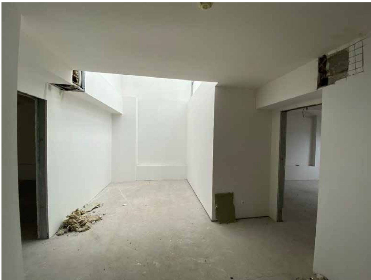
Фото 66. Помещение № 34. 3-й этаж. Вид с юго-запада.
