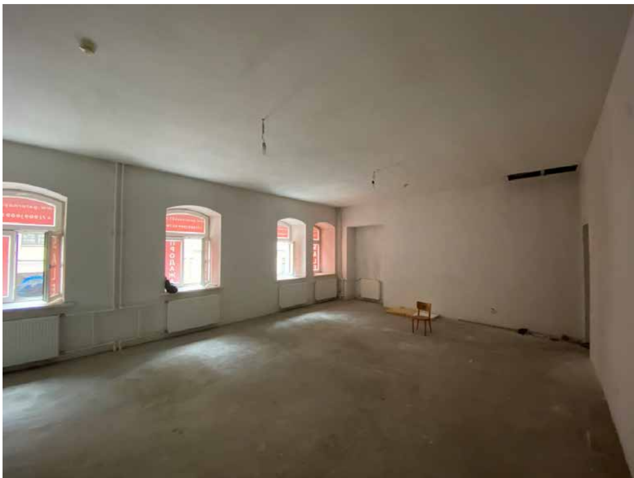
Фото 20. Помещение № 10. Вид с северо-востока.
