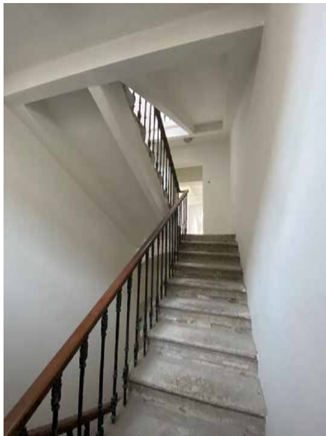
Фото 48. Лестничная клетка 1-Н. 2-й этаж. Вид с северо-запада.
