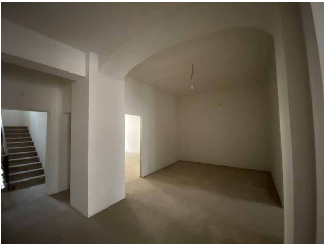
Фото 38. Помещение № 30. 2-й этаж. Вид с юго-запада.
