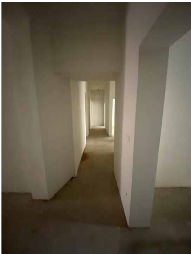
Фото 25. Помещение № 22. 2-й этаж. Вид с северо-востока.
