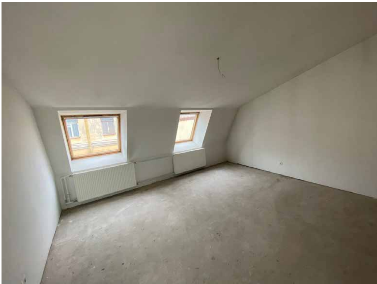
Фото 86. Помещение № 52. 4-й этаж. Вид с юга.
