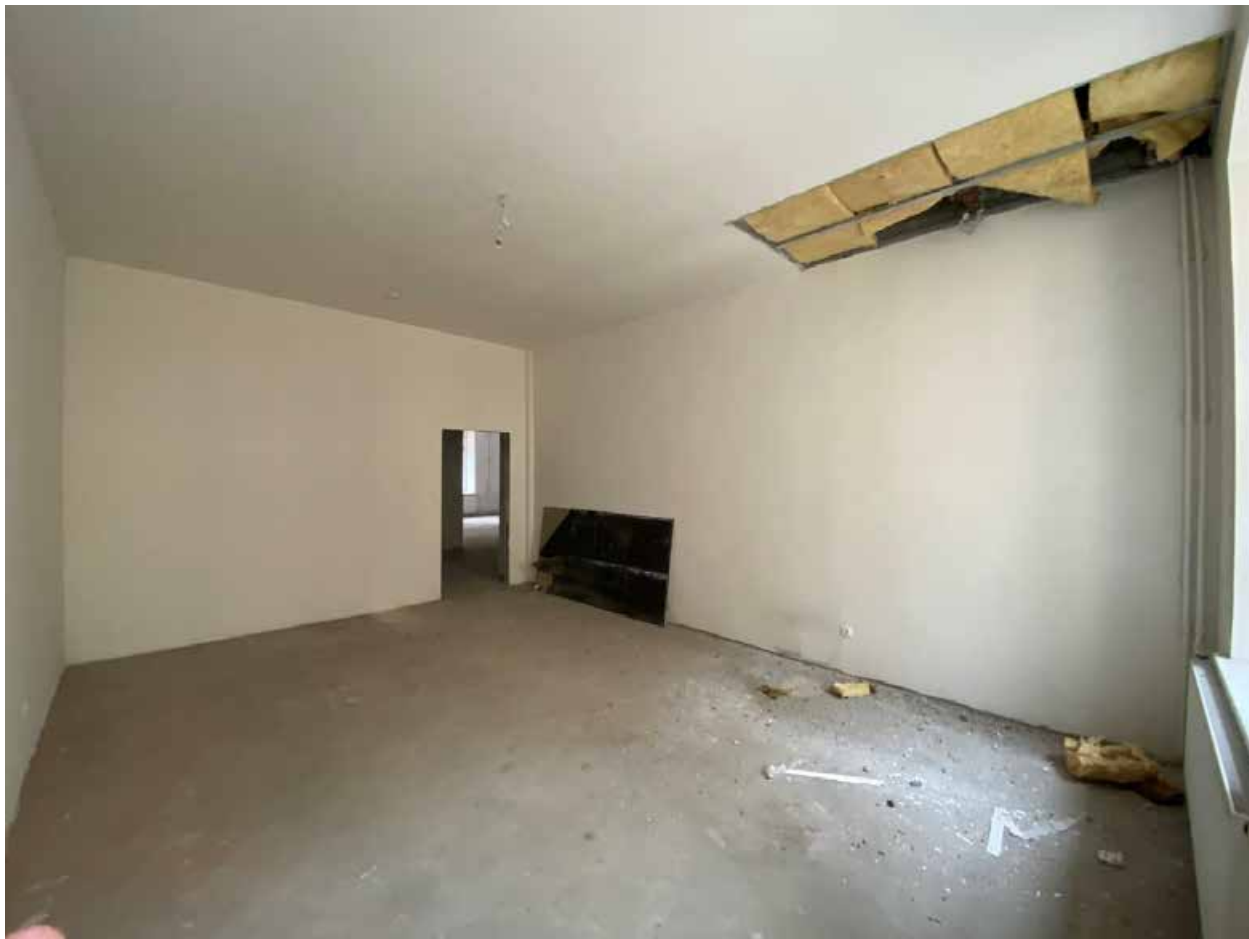
Фото 43. Помещение № 32. 2-й этаж. Вид с севера.
