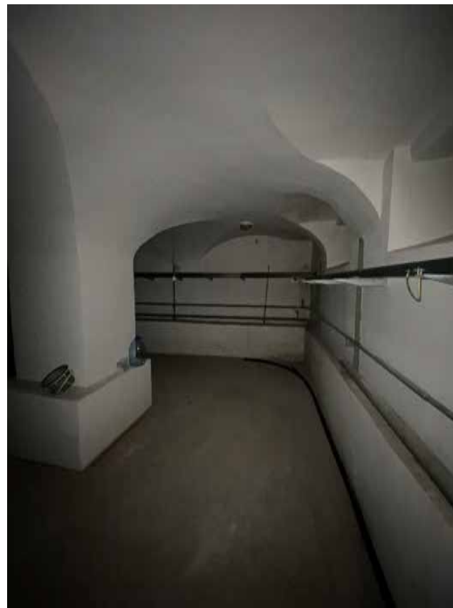
Фото 13. Подвальное помещение № 6. Вид с северо-востока.
