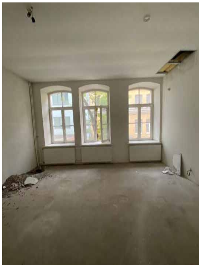
Фото 30. Помещение № 26. 2-й этаж. Вид с юго-востока.
