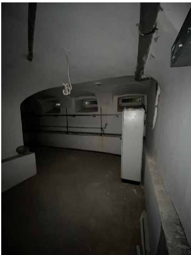
Фото 12. Подвальное помещение № 6. Вид с юга.
