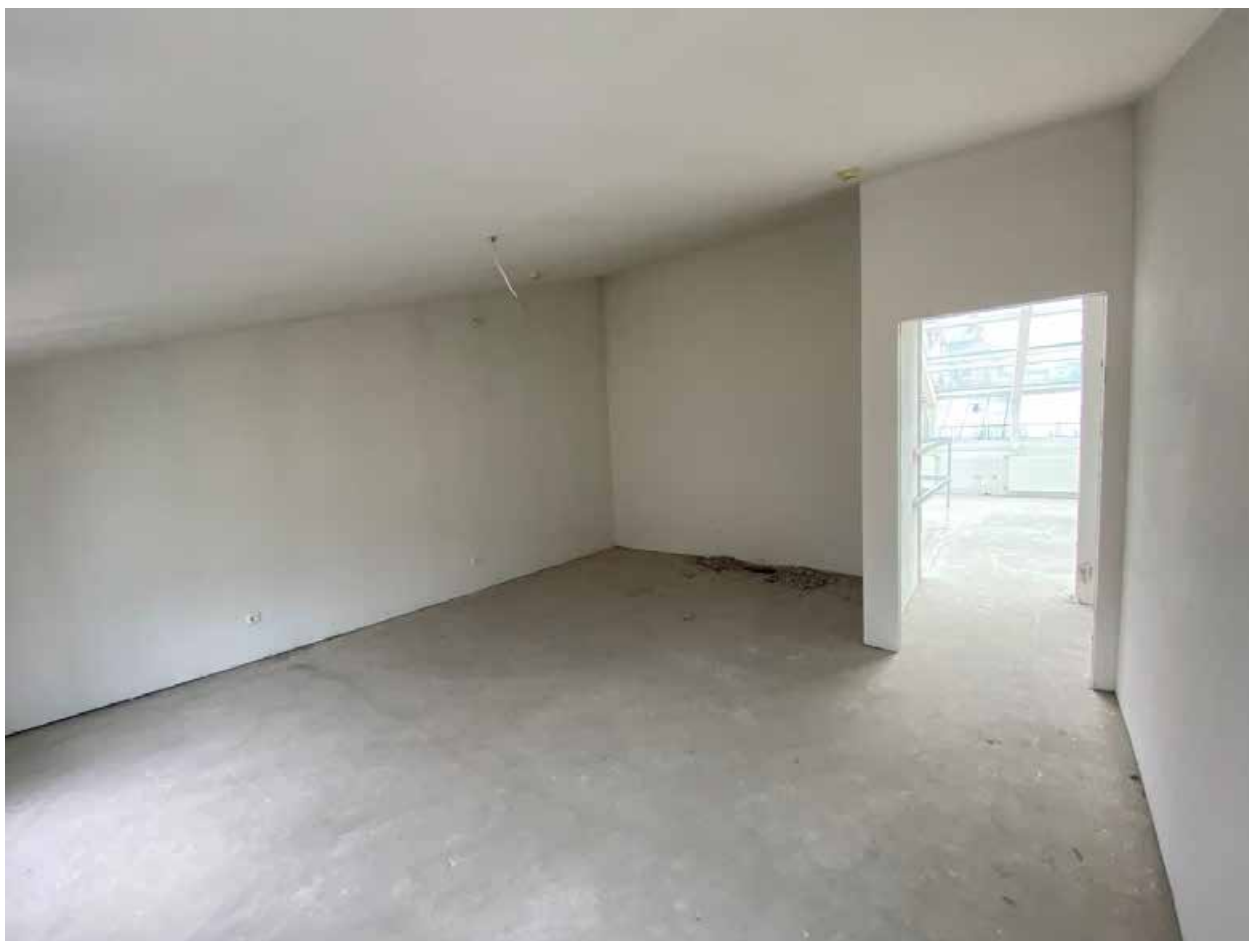
Фото 87. Помещение № 52. 4-й этаж. Вид с запада.
