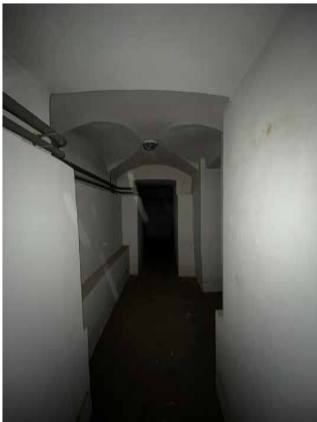
Фото 15. Подвальное помещение № 5. Вид с юго-запада.
