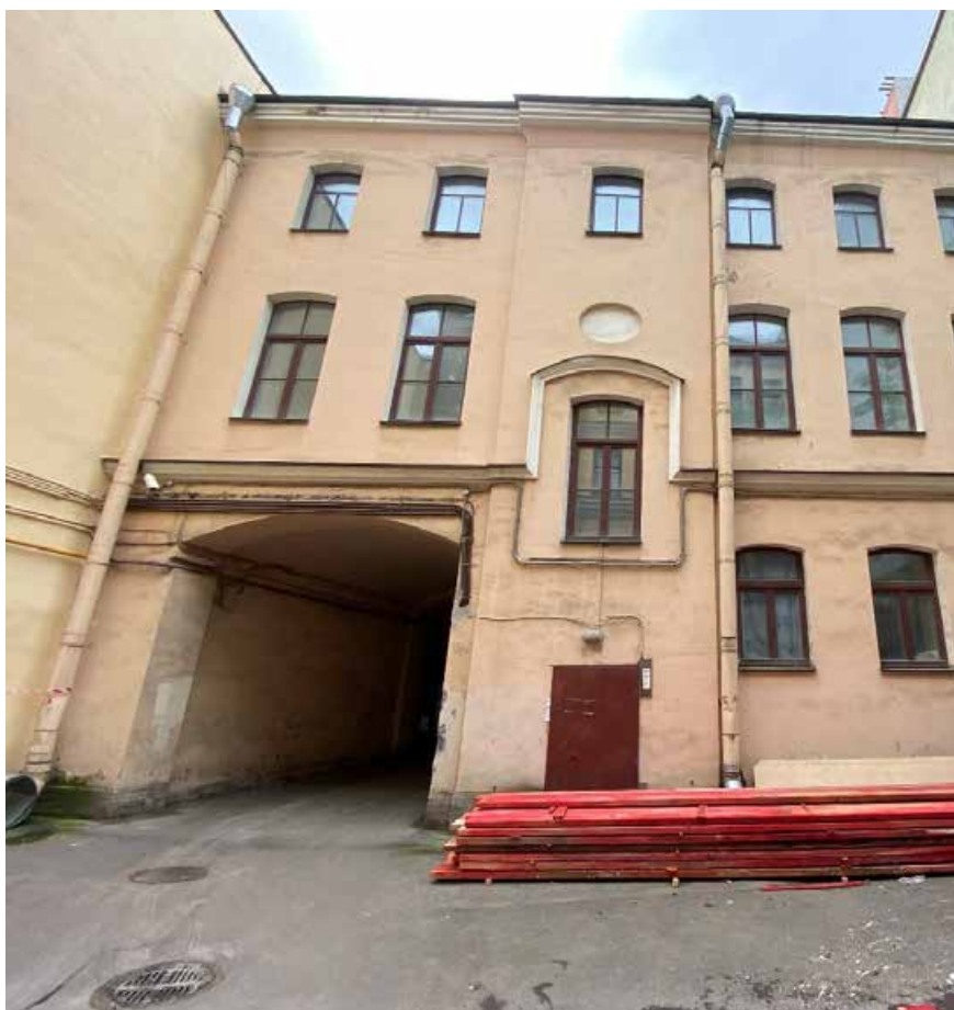
Фото 2. Дворовой северо-западный фасад литеры А. Вид с северо-запада.
