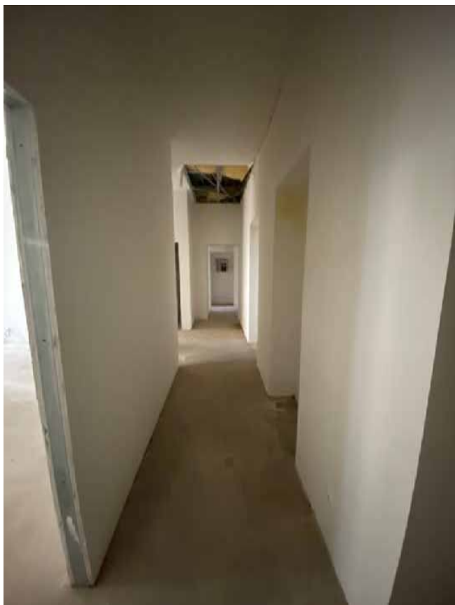
Фото 39. Помещение № 22. 2-й этаж. Вид с юго-запада.
