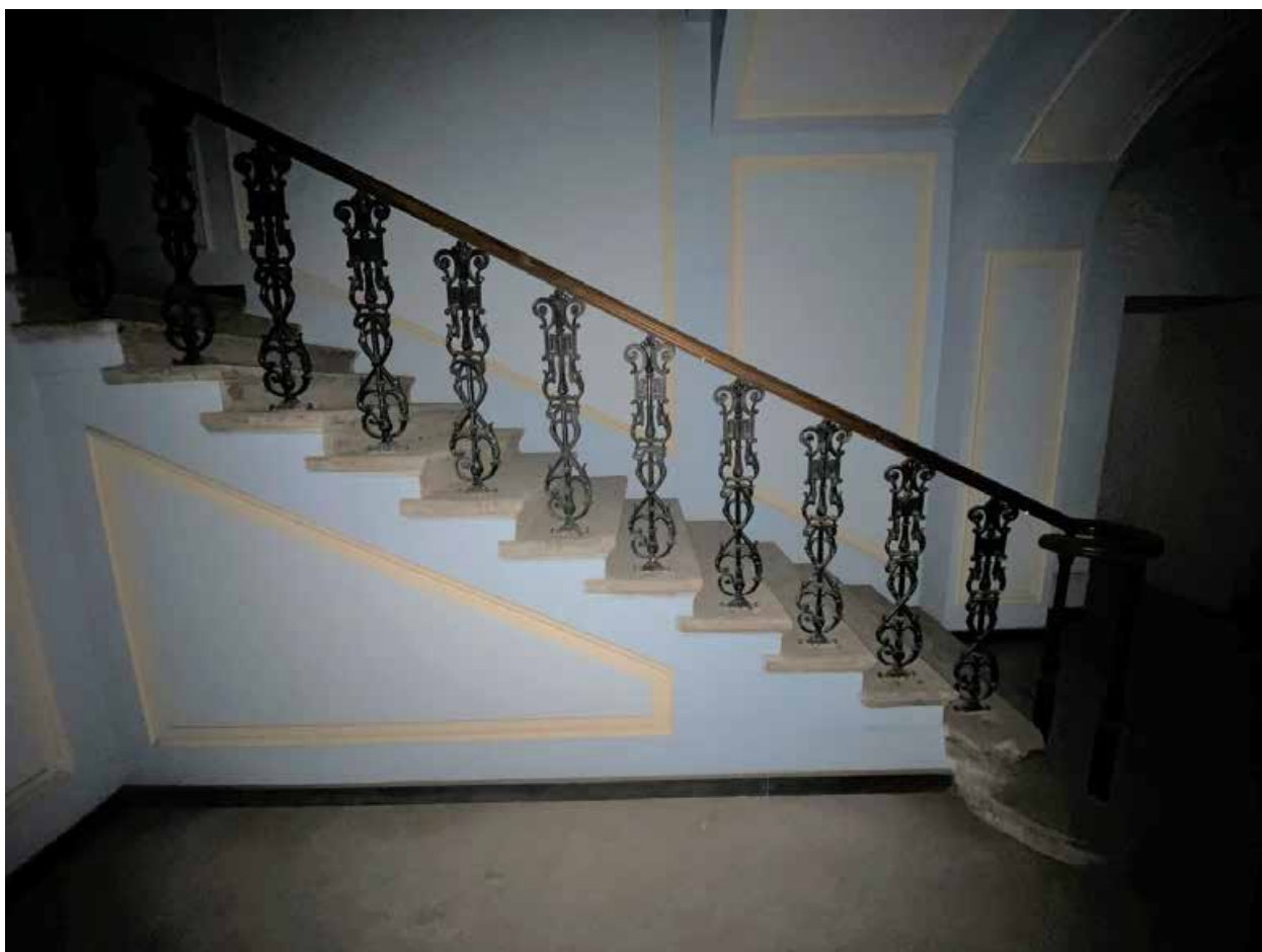
Фото 9. Кованое ограждение парадной лестницы южного лицевого корпуса. 1-й этаж. Вид с юга.
