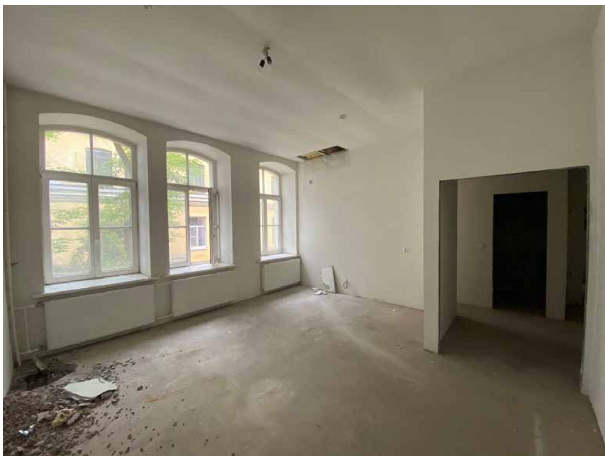
Фото 31. Помещение № 26. 2-й этаж. Вид с юго-запада.
