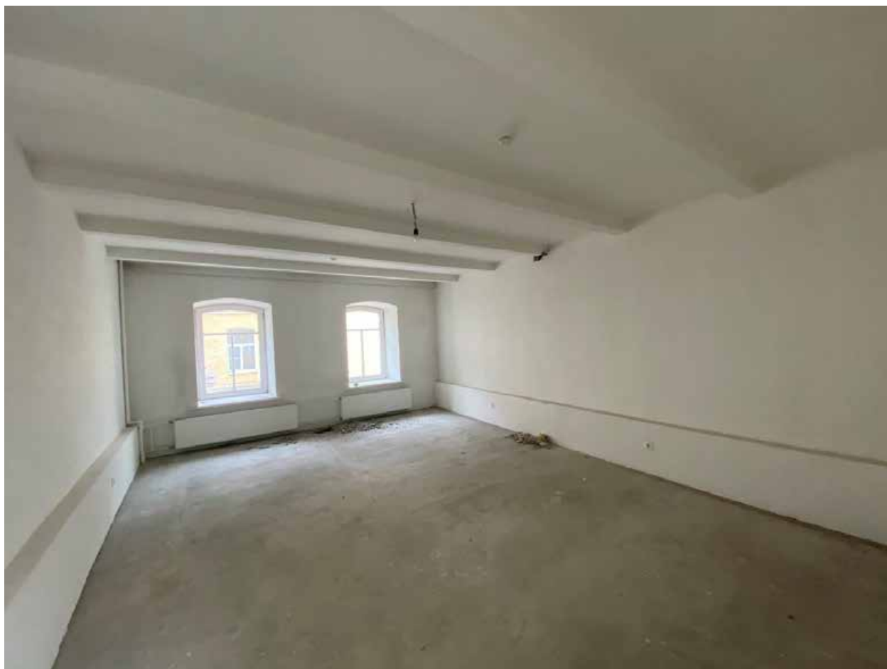
Фото 71. Помещение № 35. 3-й этаж. Вид с юга.
