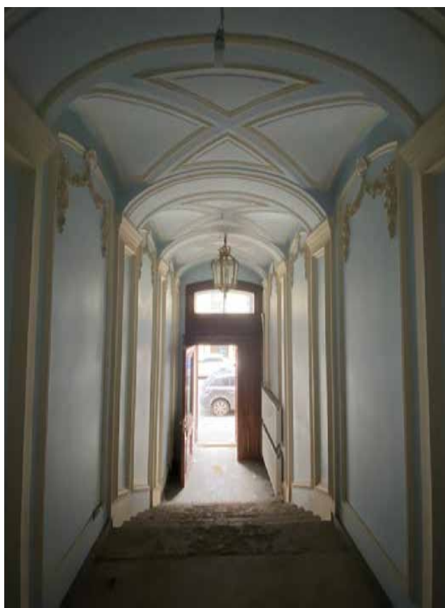
Фото 6. Парадный вестибюль. Оформление стен и потолка. 1-й этаж. Вид с северо-запада.
