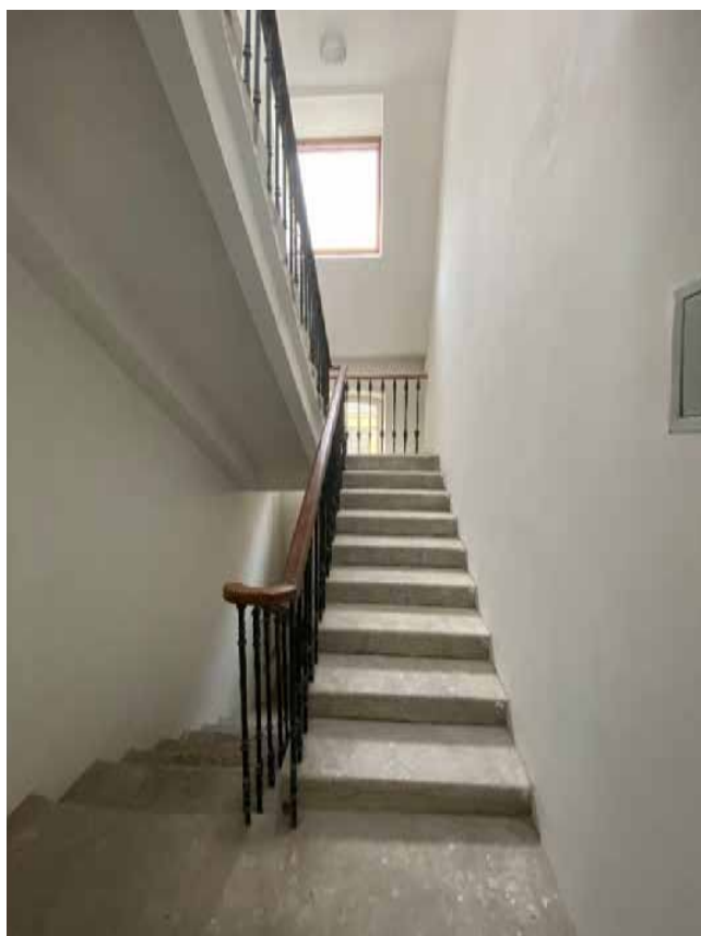
Фото 73. Лестничная клетка 1-Н. 3-й этаж. Вид с юго-востока.
