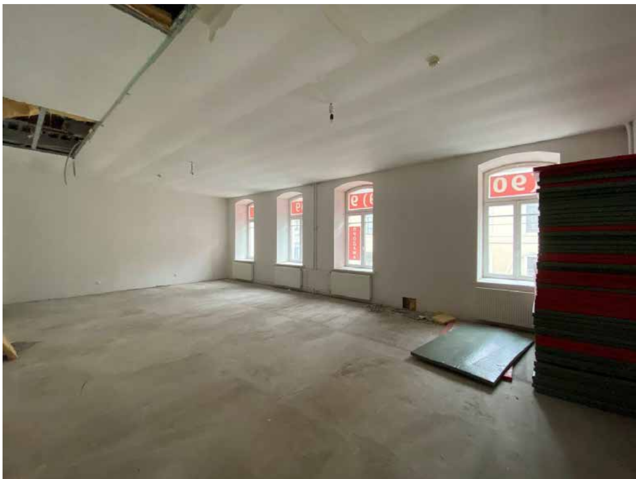
Фото 35. Помещение № 28. 2-й этаж. Вид с запада.
