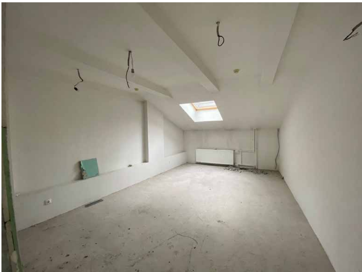
Фото 67. Помещение № 36. 3-й этаж. Вид с северо-запада.
