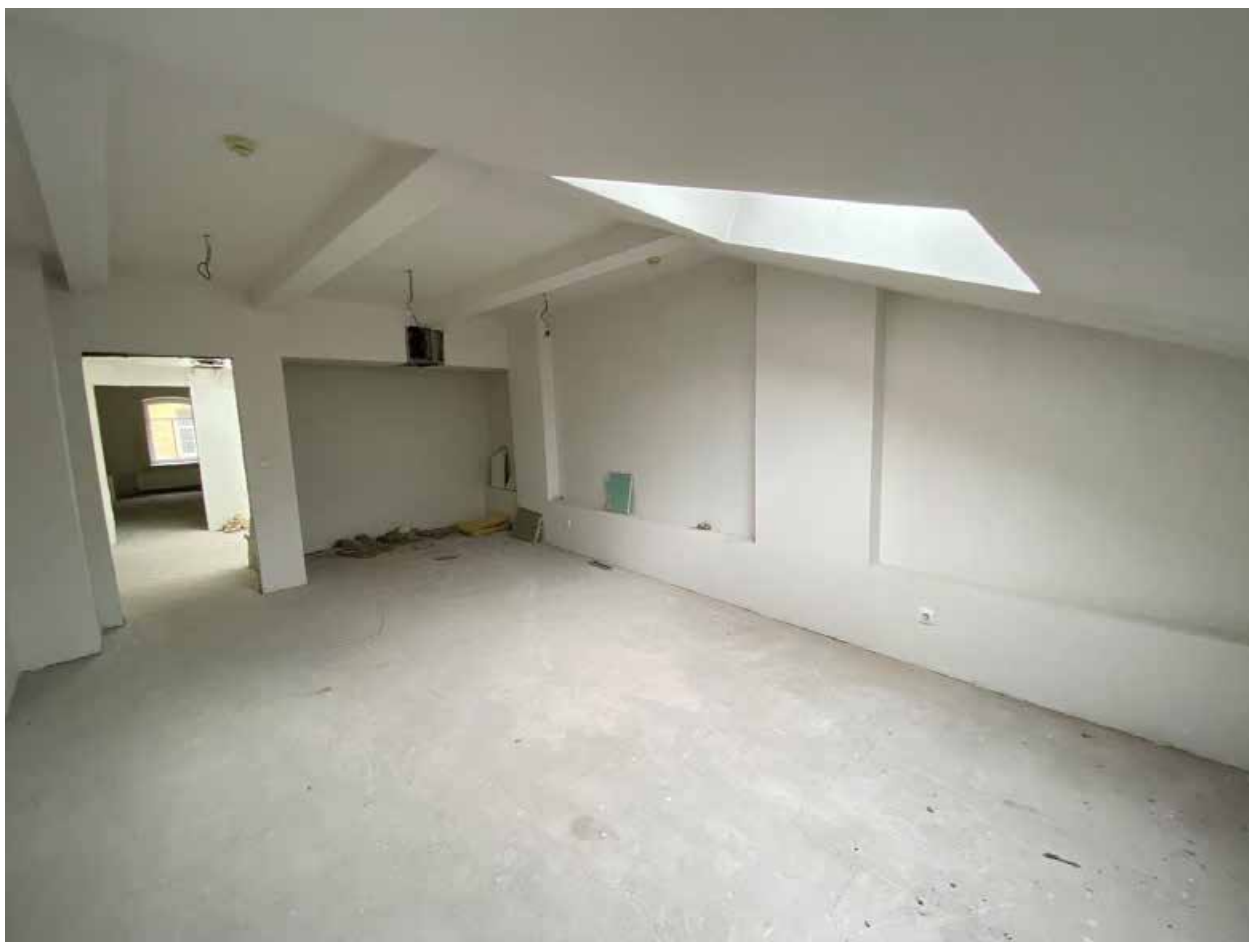
Фото 68. Помещение № 36. 3-й этаж. Вид с юго-востока.
