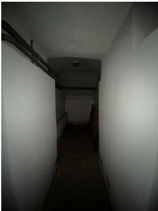
Фото 18. Подвальное помещение № 3. Вид с севера.
