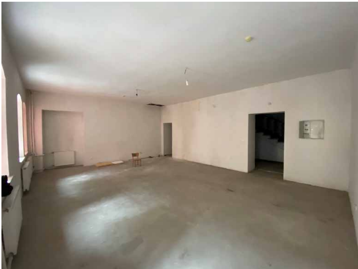
Фото 22. Помещение № 10. Вид с юго-востока.
