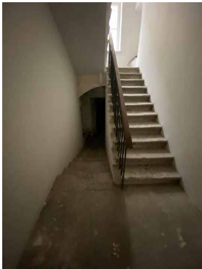
Фото 19. Лестничная клетка 1-Н. 1-й этаж. Вид с юго-востока.
