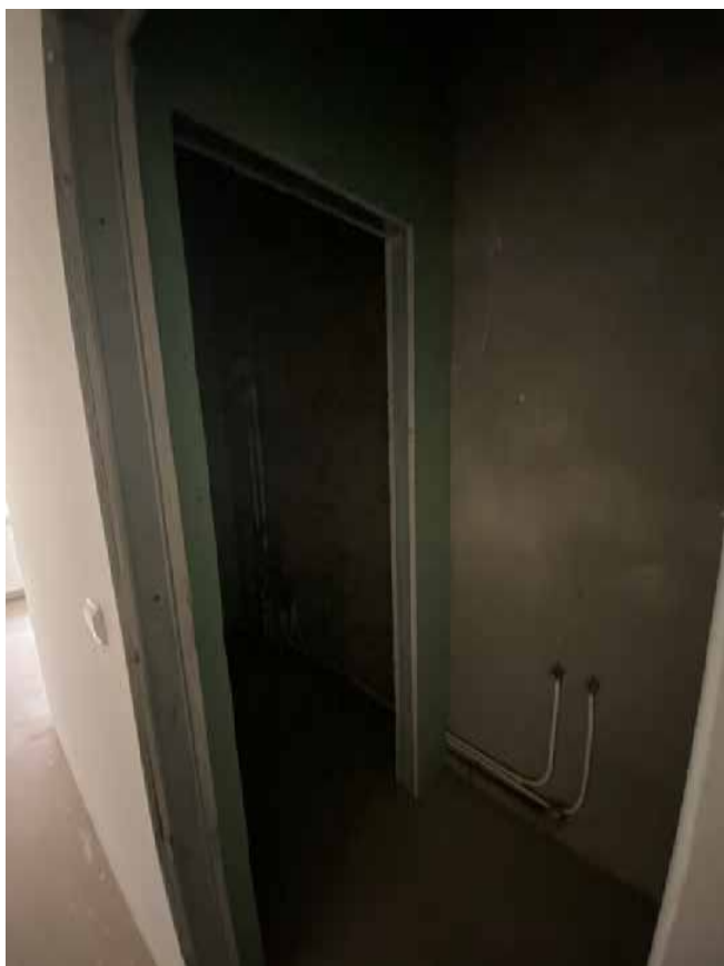
Фото 27. Помещение № 23, 24. 2-й этаж. Вид с юга.
