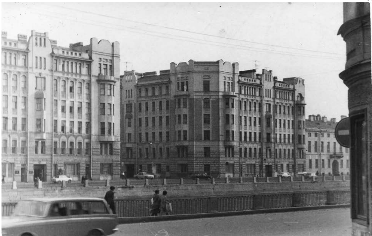
19. Набережная реки Фонтанки, дома № 86-88. Август 1979. ГМИ СПб (материалы арх. Б.Л. Васильева, серия «парные эркеры») Источник: https://pastvu.com/p/927552 .
