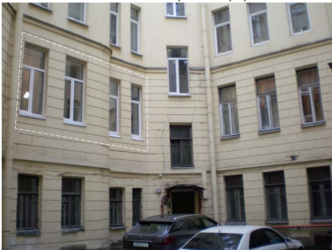
Фото 6. Фрагмент дворового фасада с обозначением окон квартиры № 9.
