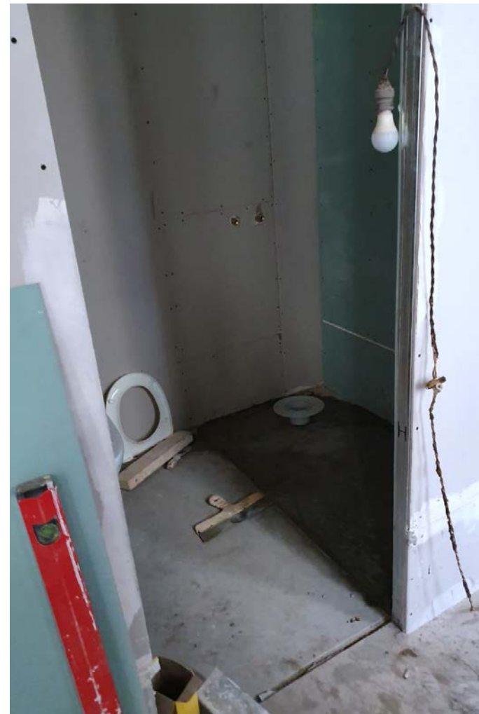
Фото 25. Квартира № 9. Возведение перегородок в помещении комнаты № 13 (по техпаспорту).
