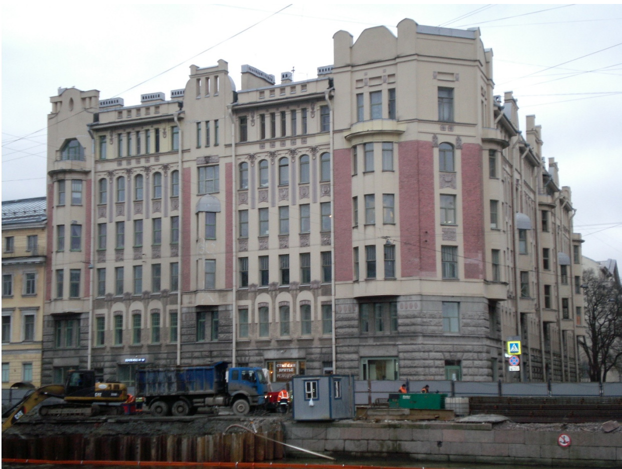
Фото 3. Вид здания с северо-запада.
