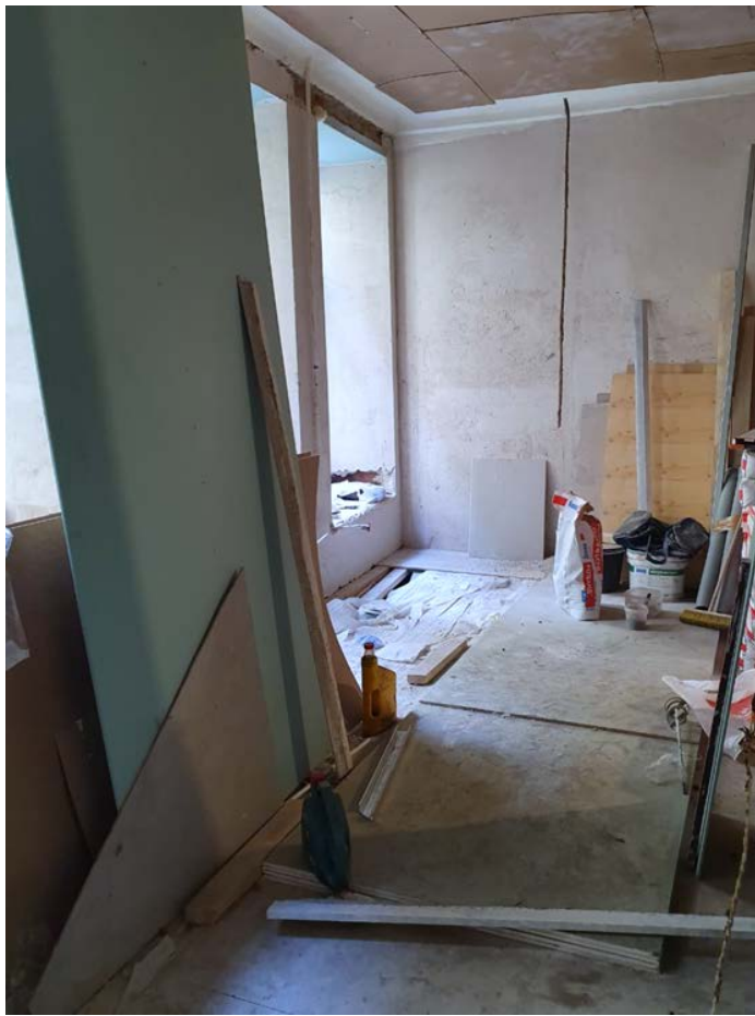
Фото 26. Квартира № 9. В помещении, устроенном при объединении комнат № 14 и № 13 (по техпаспорту), ведутся ремонтные работы.
