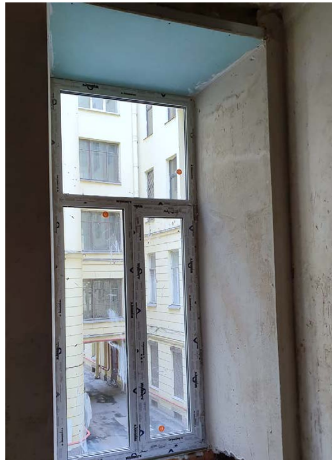
Фото 27. Квартира № 9. Оконный проем в помещении комнаты № 14.
