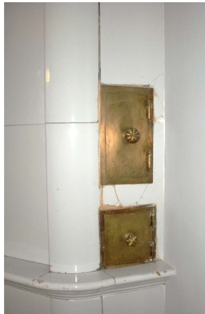
Фото 19. Квартира № 9. Помещение комнаты № 6. Латунная фурнитура верхнего яруса печи.
