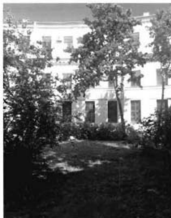
6. Фрагмент внутреннего двора. Вид на восточную часть.
