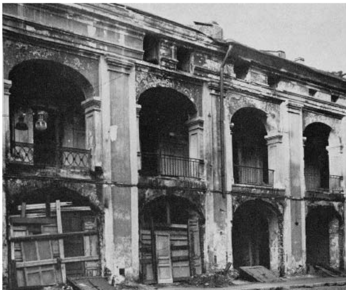
Илл. 178. Повреждения Перинной линии Большого Гостиного двора. 1944 г. (источник: https://pastvu.com/p/775907 ).
