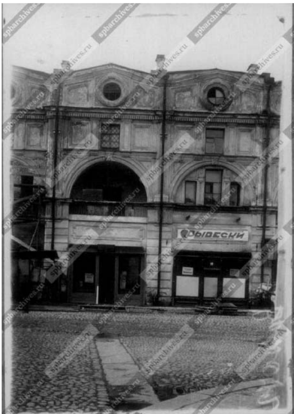
Илл. 180. Вид части главного фасада Малого Гостиного двора (дом № 1 на улице Ломоносова). Б/д. Ориентировочно середина 1950-х гг. (источник: ЦГАКФФД СПб. Фотодокументы. Оп. 1ВР-10. Ед.хр.10072).
