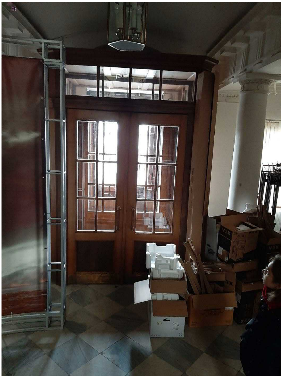
Фото 15. СПбГИК. Входной вестибюль по ул. Миллионной
