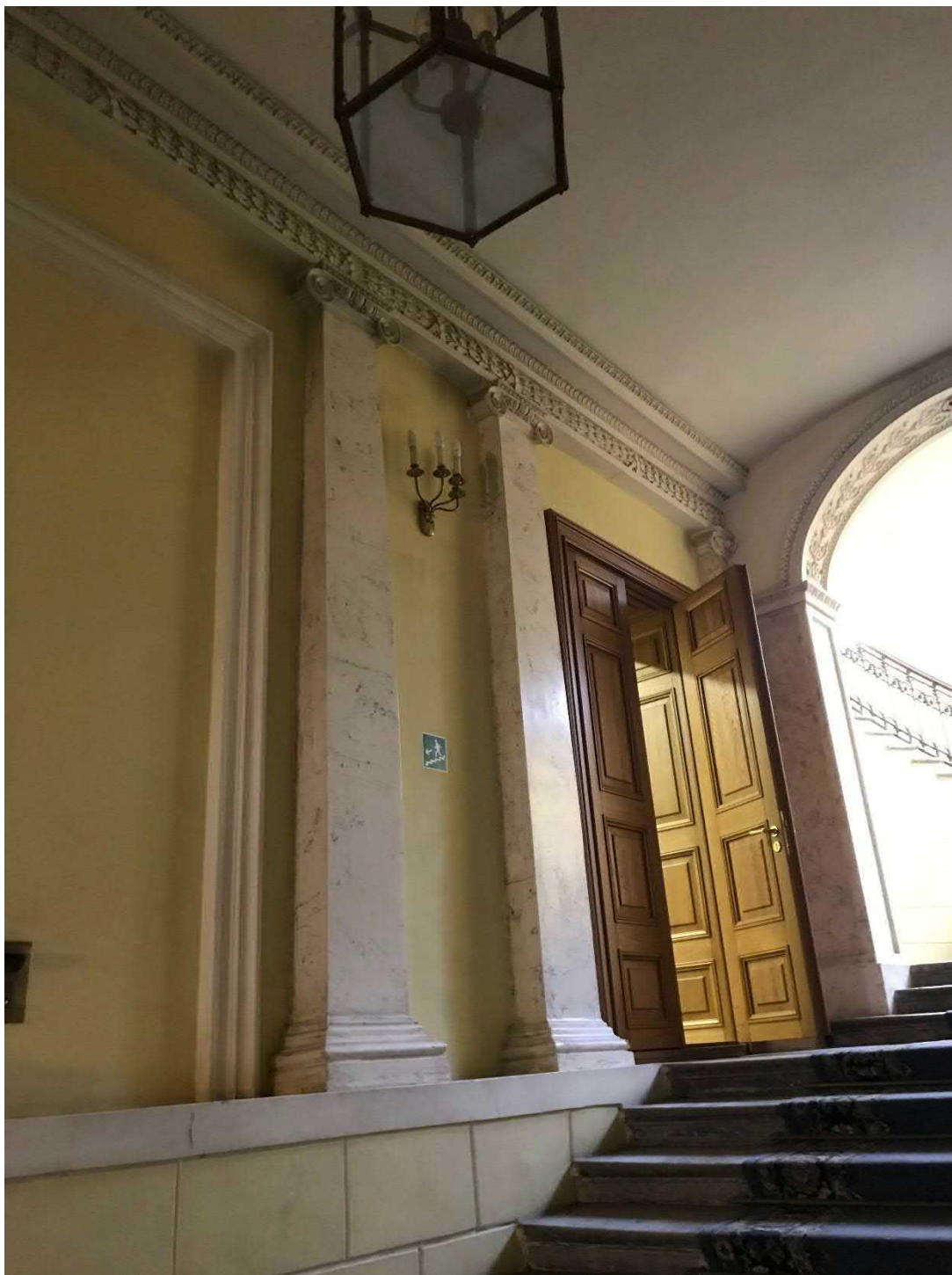
Фото 30. СПбГИК. Проход с лестницы в помещения 2 этажа
