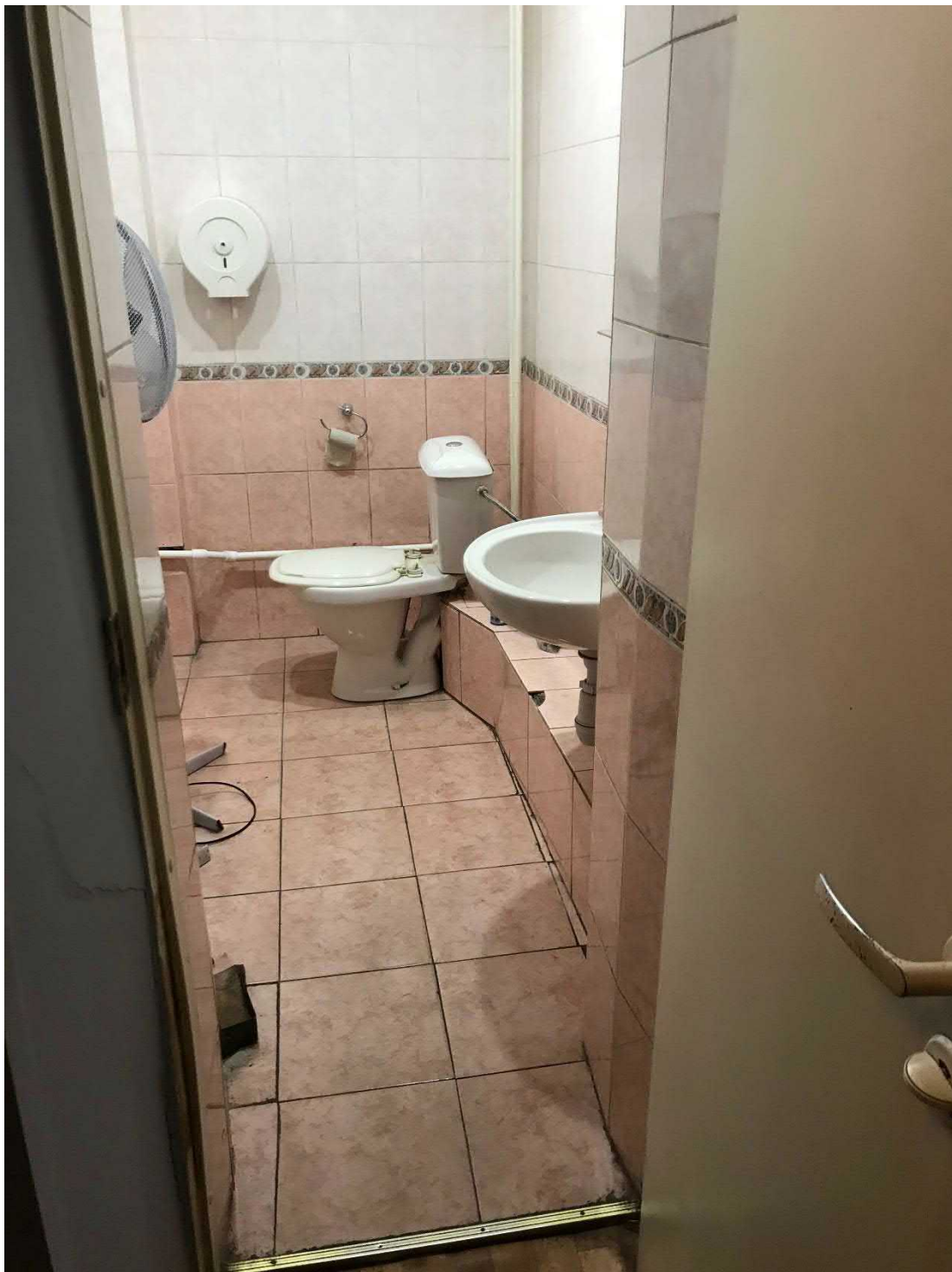
Фото 24. СПБГИК. Сан.узел 1 этажа
