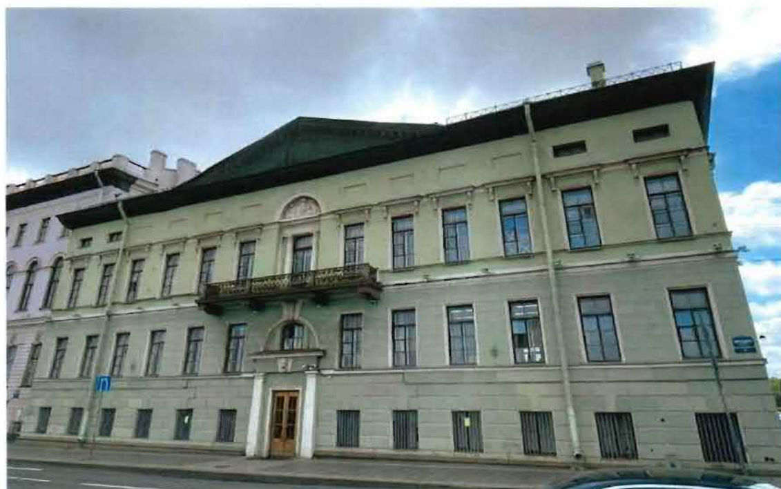
2. Общий вид на объект культурного наследия.
