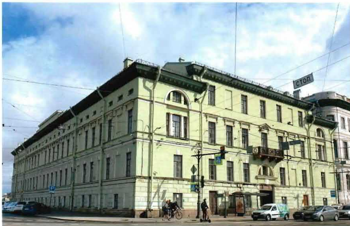
1. Общий вид на объект культурного наследия.
