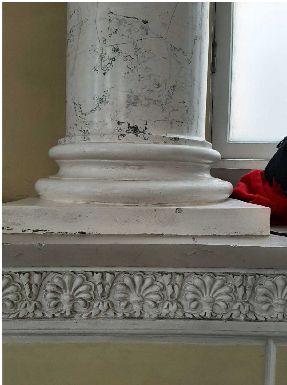
Фото 13. СПбГИК. Лестница ротонды. Основание колонны. 3 этаж
