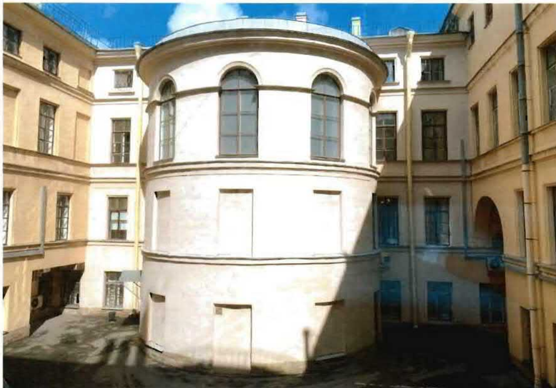
3. Общий вид на объект культурного наследия.
