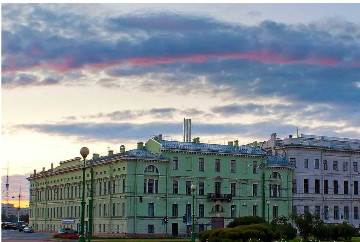
Фото 4. СПБГИК. Лицевой фасад со стороны ул.Миллионная
